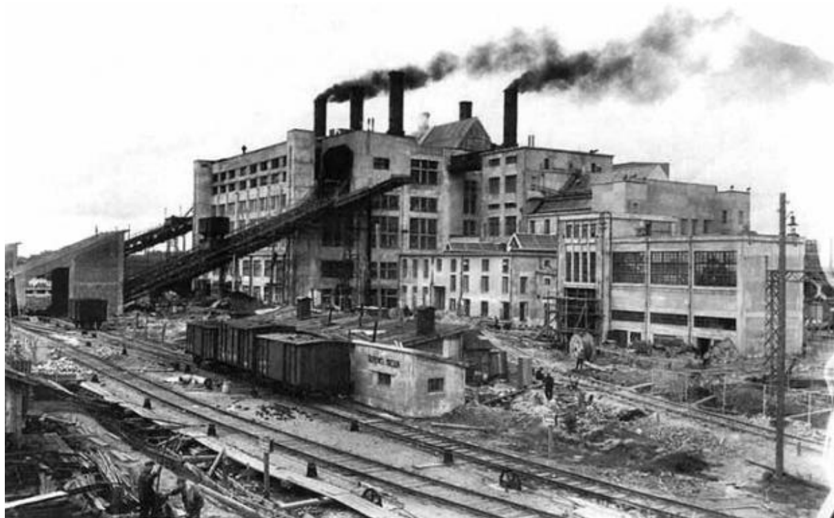
38. ГРЭС «Красный Октябрь». 1930. // Архитектурный сайт Санкт-Петербурга. URL: http://p0.citywalls.ru/photo_31-32376.jpg?mt=1273625807 .
