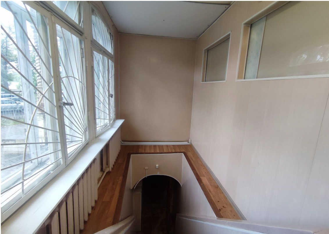
30. Объект культурного наследия регионального значения «Дом А. Гейрота», расположенный по адресу: Санкт-Петербург, город Петергоф, улица Бородачёва, дом 12, литера А, входящий в состав объекта культурного наследия регионального значения «Дом А. Гейрота с беседкой, садом и оградой». Общий вид пом. 1-Н (2) в уровне 1-го этажа.
