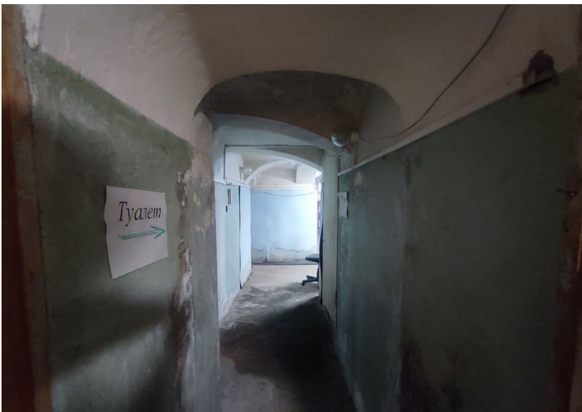
11. Объект культурного наследия регионального значения «Дом А. Гейрота», расположенный по адресу: Санкт-Петербург, город Петергоф, улица Бородачёва, дом 12, литера А, входящий в состав объекта культурного наследия регионального значения «Дом А. Гейрота с беседкой, садом и оградой». Фрагмент пом. 1-Н (40) в уровне подвала.
