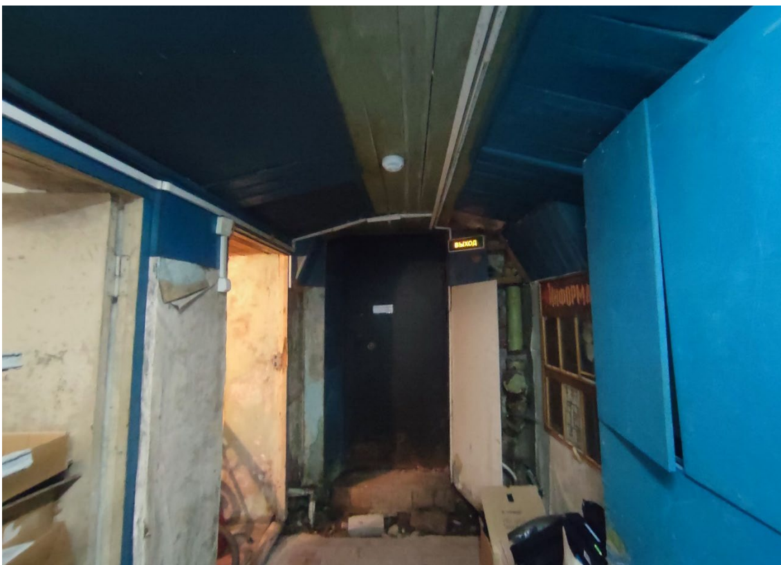
15. Объект культурного наследия регионального значения «Дом А. Гейрота», расположенный по адресу: Санкт-Петербург, город Петергоф, улица Бородачёва, дом 12, литера А, входящий в состав объекта культурного наследия регионального значения «Дом А. Гейрота с беседкой, садом и оградой». Фрагмент пом. 1-Н (47) в уровне подвала.
