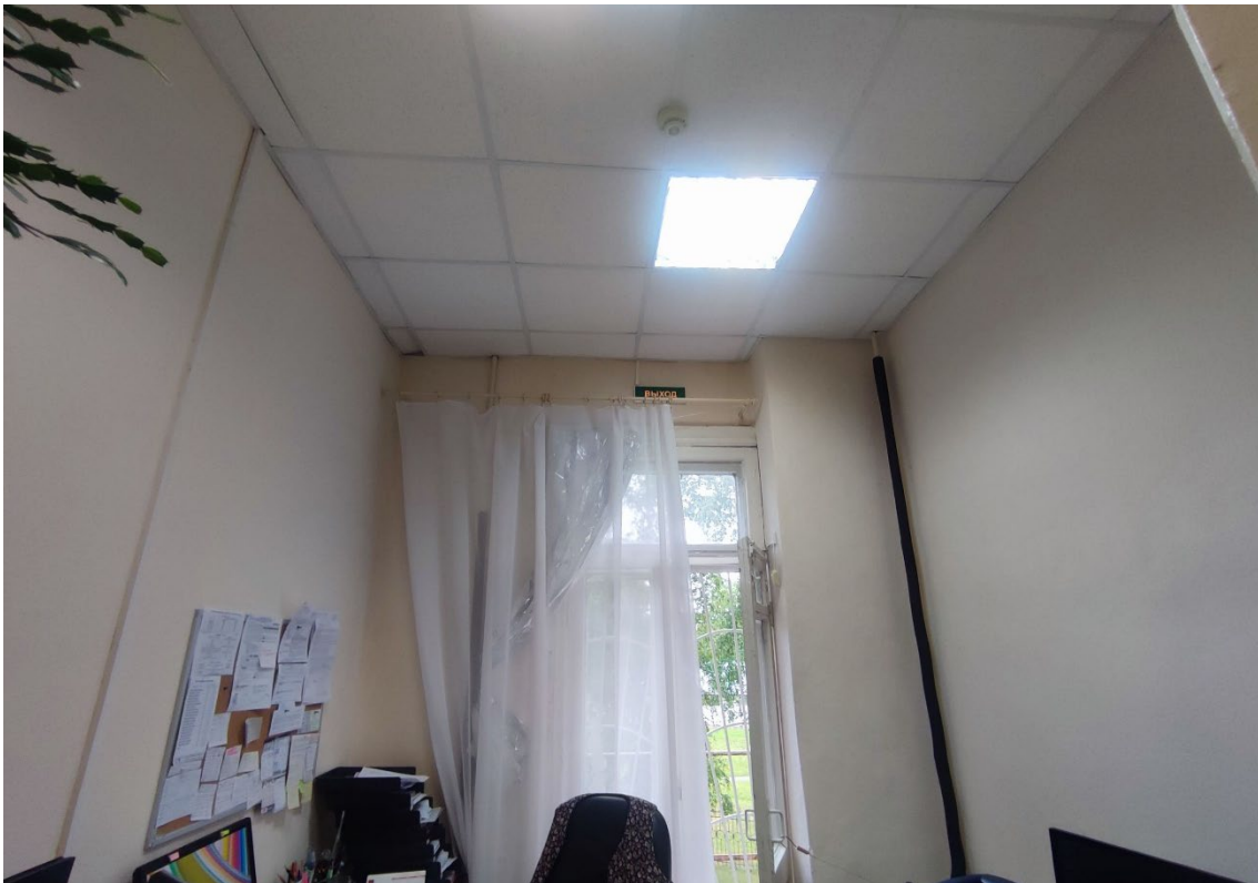
40. Объект культурного наследия регионального значения «Дом А. Гейрота», расположенный по адресу: Санкт-Петербург, город Петергоф, улица Бородачёва, дом 12, литера А, входящий в состав объекта культурного наследия регионального значения «Дом А. Гейрота с беседкой, садом и оградой». Общий вид пом. 1-Н (29) в уровне 2-го этажа.
