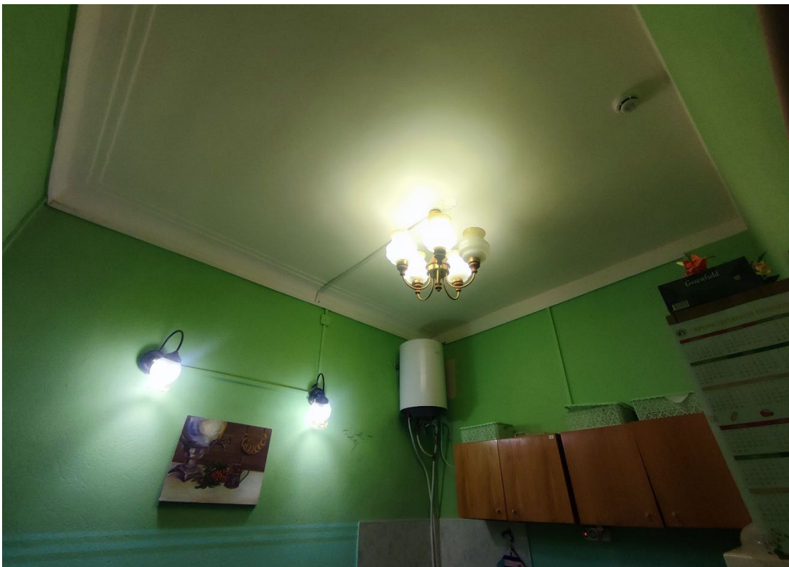
25. Объект культурного наследия регионального значения «Дом А. Гейрота», расположенный по адресу: Санкт-Петербург, город Петергоф, улица Бородачёва, дом 12, литера А, входящий в состав объекта культурного наследия регионального значения «Дом А. Гейрота с беседкой, садом и оградой». Общий вид пом. 1-Н (19) в уровне 1-го этажа.
