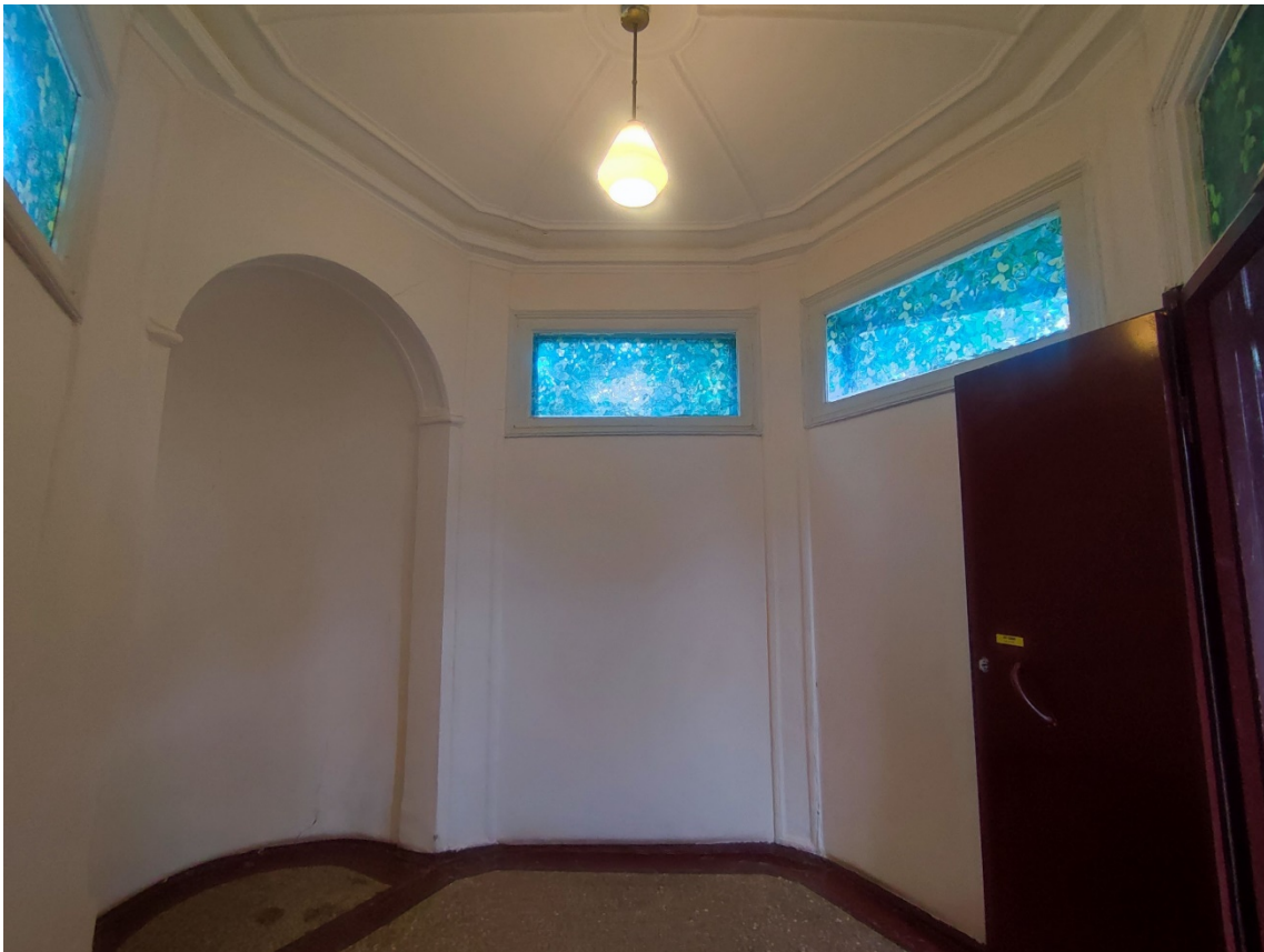
31. Объект культурного наследия регионального значения «Дом А. Гейрота», расположенный по адресу: Санкт-Петербург, город Петергоф, улица Бородачёва, дом 12, литера А, входящий в состав объекта культурного наследия регионального значения «Дом А. Гейрота с беседкой, садом и оградой». Общий вид пом. 1-Н (1) в уровне 1-го этажа.
