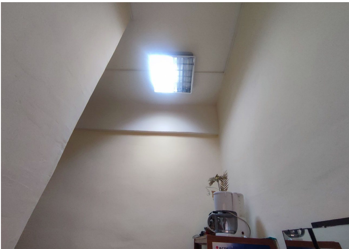
43. Объект культурного наследия регионального значения «Дом А. Гейрота», расположенный по адресу: Санкт-Петербург, город Петергоф, улица Бородачёва, дом 12, литера А, входящий в состав объекта культурного наследия регионального значения «Дом А. Гейрота с беседкой, садом и оградой». Фрагмент пом. 1-Н (25) в уровне 2-го этажа.
