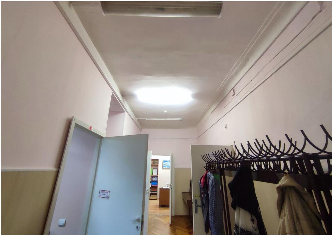
27. Объект культурного наследия регионального значения «Дом А. Гейрота», расположенный по адресу: Санкт-Петербург, город Петергоф, улица Бородачёва, дом 12, литера А, входящий в состав объекта культурного наследия регионального значения «Дом А. Гейрота с беседкой, садом и оградой». Общий вид пом. 1-Н (4) в уровне 1-го этажа.
