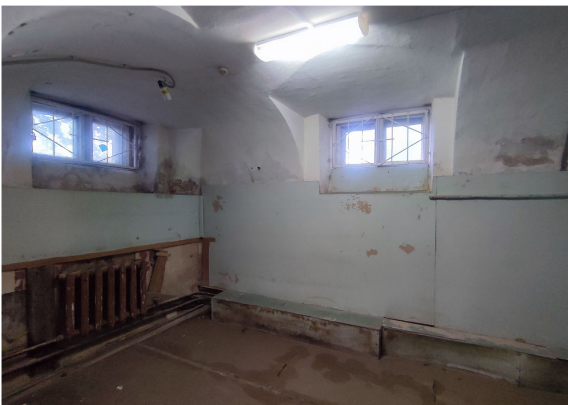
13. Объект культурного наследия регионального значения «Дом А. Гейрота», расположенный по адресу: Санкт-Петербург, город Петергоф, улица Бородачёва, дом 12, литера А, входящий в состав объекта культурного наследия регионального значения «Дом А. Гейрота с беседкой, садом и оградой». Фрагмент пом. 1-Н (45) в уровне подвала.
