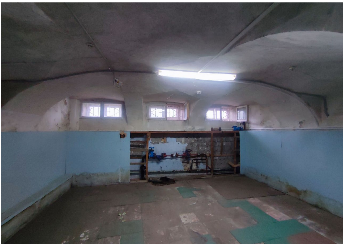
14. Объект культурного наследия регионального значения «Дом А. Гейрота», расположенный по адресу: Санкт-Петербург, город Петергоф, улица Бородачёва, дом 12, литера А, входящий в состав объекта культурного наследия регионального значения «Дом А. Гейрота с беседкой, садом и оградой». Общий вид пом. 1-Н (46) в уровне подвала.
