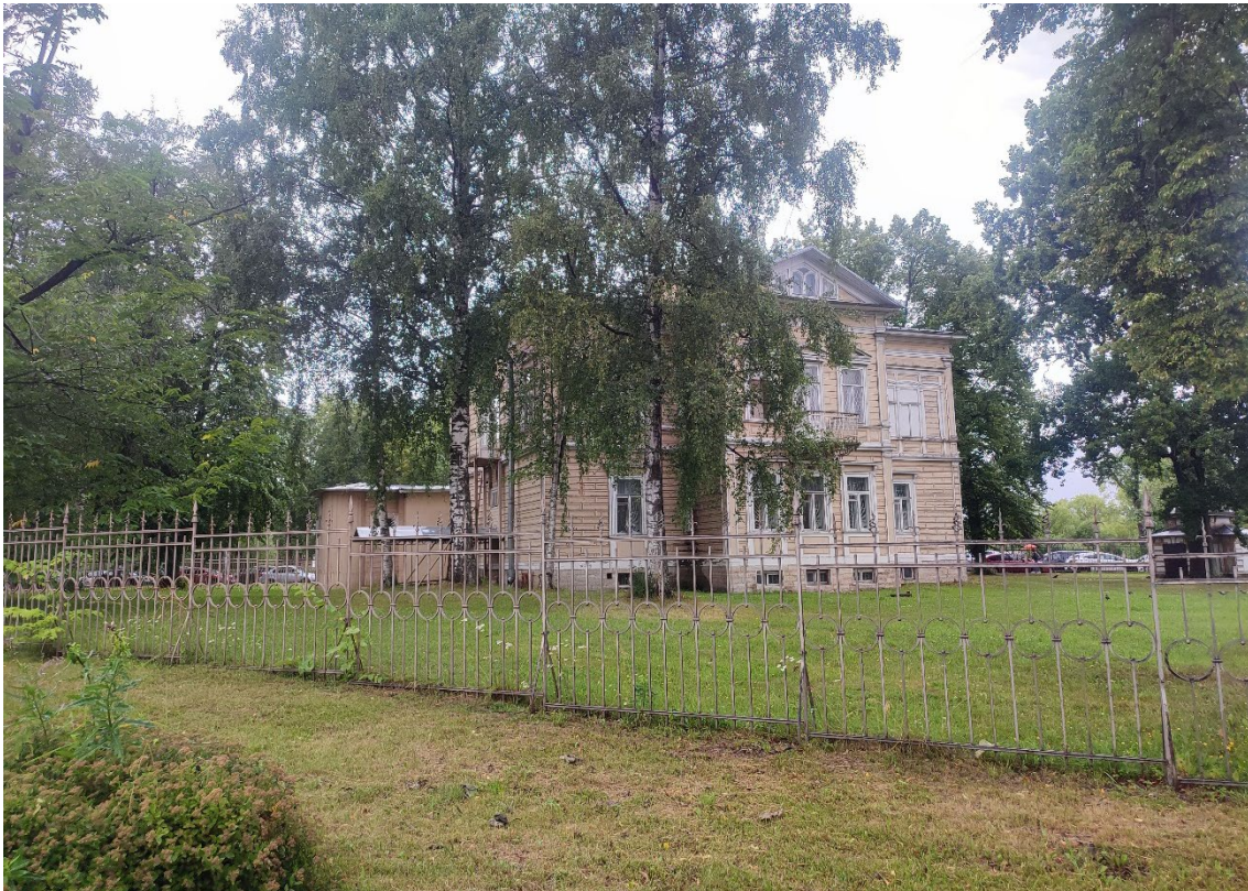
6. Объект культурного наследия регионального значения «Дом А. Гейрота», расположенный по адресу: Санкт-Петербург, город Петергоф, улица Бородачёва, дом 12, литера А, входящий в состав объекта культурного наследия регионального значения «Дом А. Гейрота с беседкой, садом и оградой». Общий вид здания с востока.
