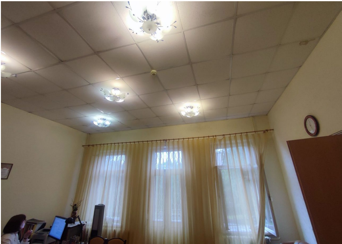
42. Объект культурного наследия регионального значения «Дом А. Гейрота», расположенный по адресу: Санкт-Петербург, город Петергоф, улица Бородачёва, дом 12, литера А, входящий в состав объекта культурного наследия регионального значения «Дом А. Гейрота с беседкой, садом и оградой». Общий вид пом. 1-Н (26) в уровне 2-го этажа.
