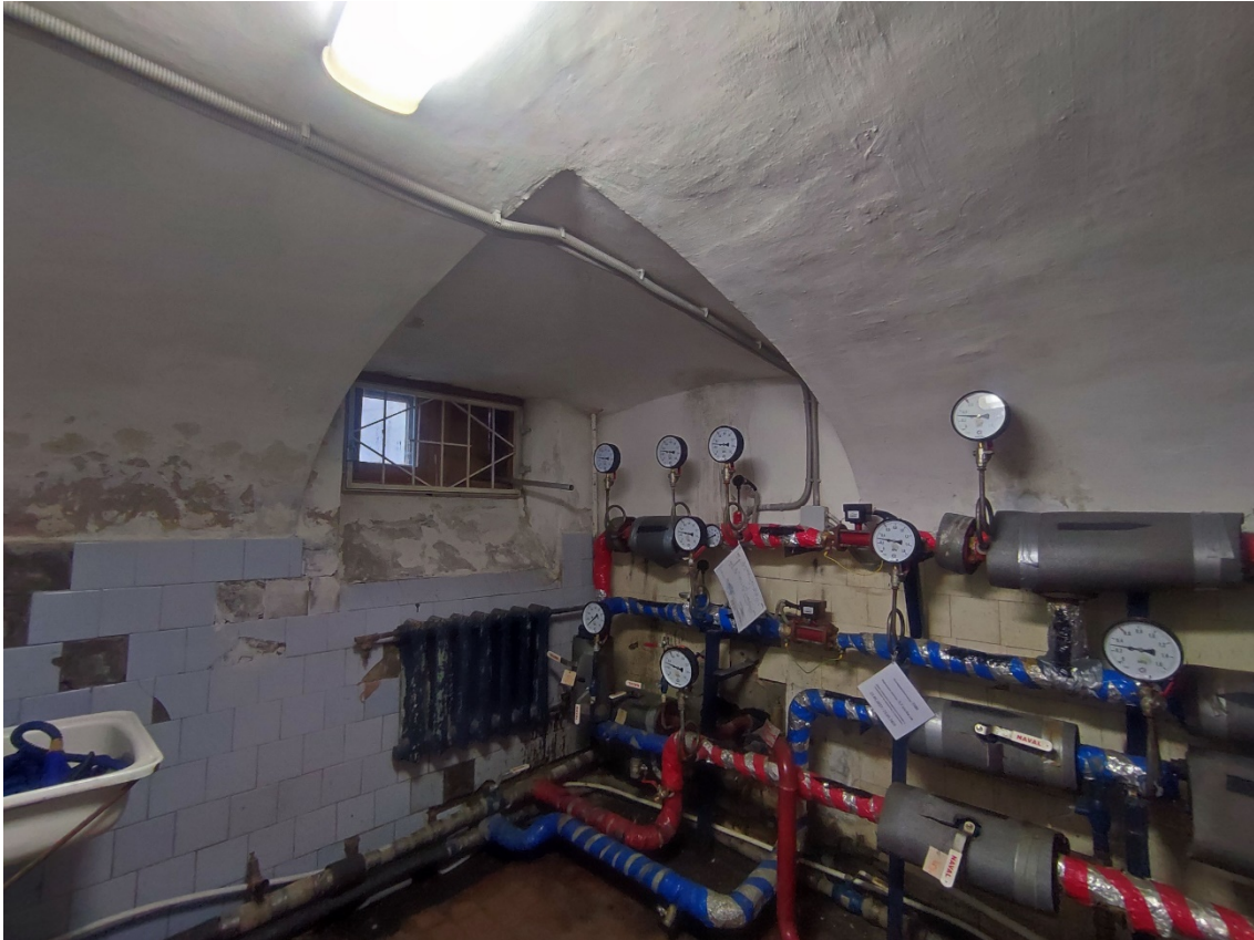
16. Объект культурного наследия регионального значения «Дом А. Гейрота», расположенный по адресу: Санкт-Петербург, город Петергоф, улица Бородачёва, дом 12, литера А, входящий в состав объекта культурного наследия регионального значения «Дом А. Гейрота с беседкой, садом и оградой». Фрагмент пом. 1-Н (50) в уровне подвала.
