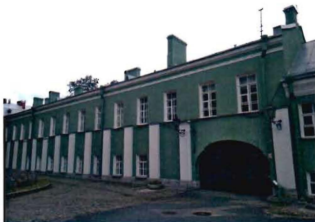
2. Вид на объект культурного наследия с северо-западной стороны.
