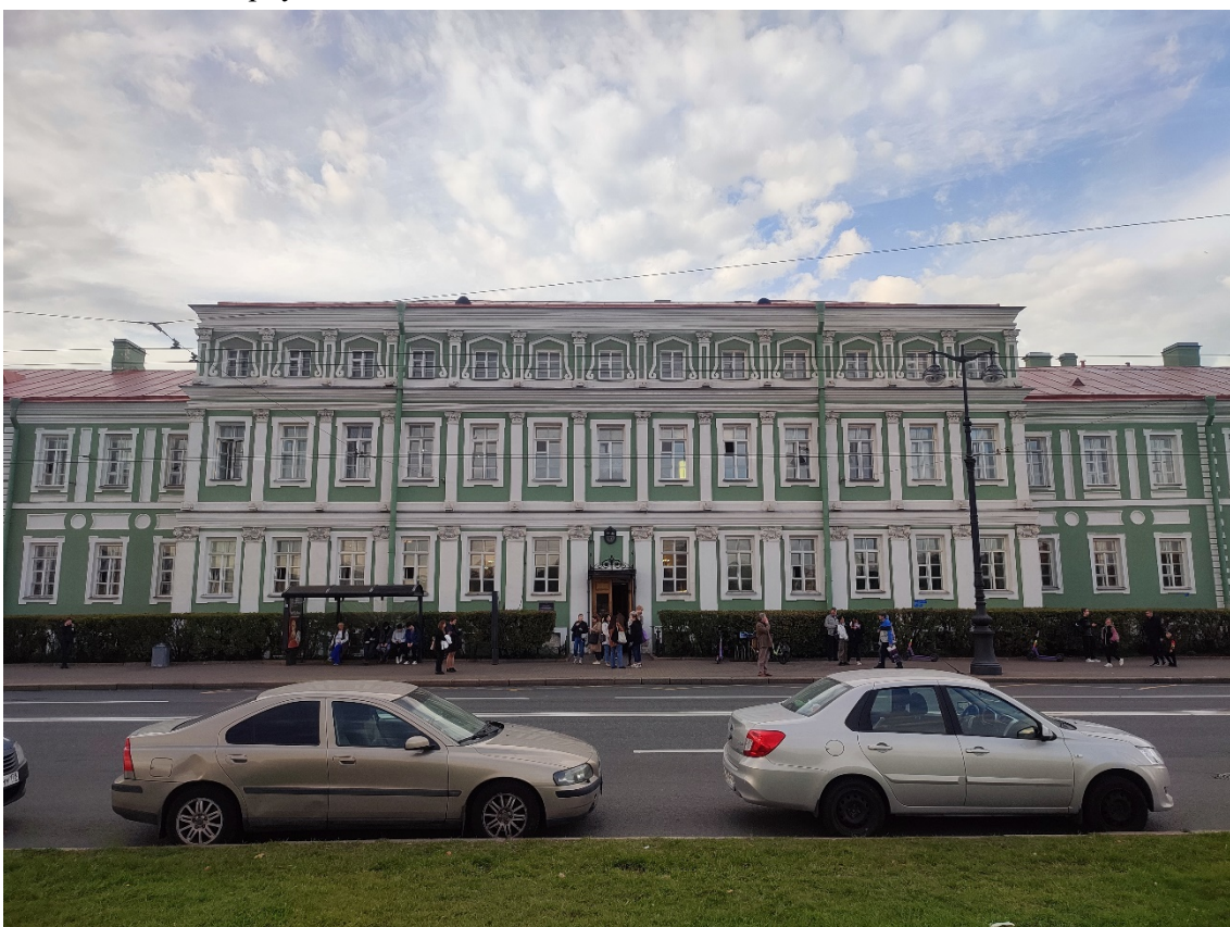
4. Объект культурного наследия федерального значения «Дворец императора Петра II». Фрагмент юго-восточного лицевого фасада объекта культурного наследия. Центральная часть лицевого корпуса.
