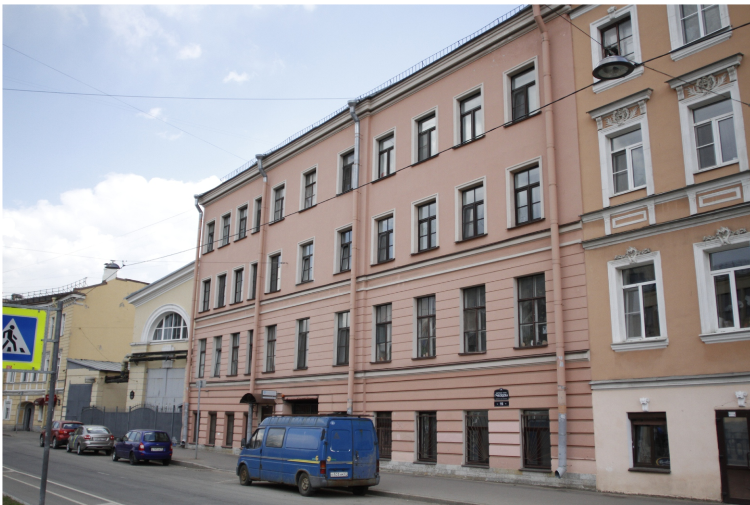
7. Вид на выявленный ОКН «Дом Ф. Демидовой». Фото: 05.05.2023.
