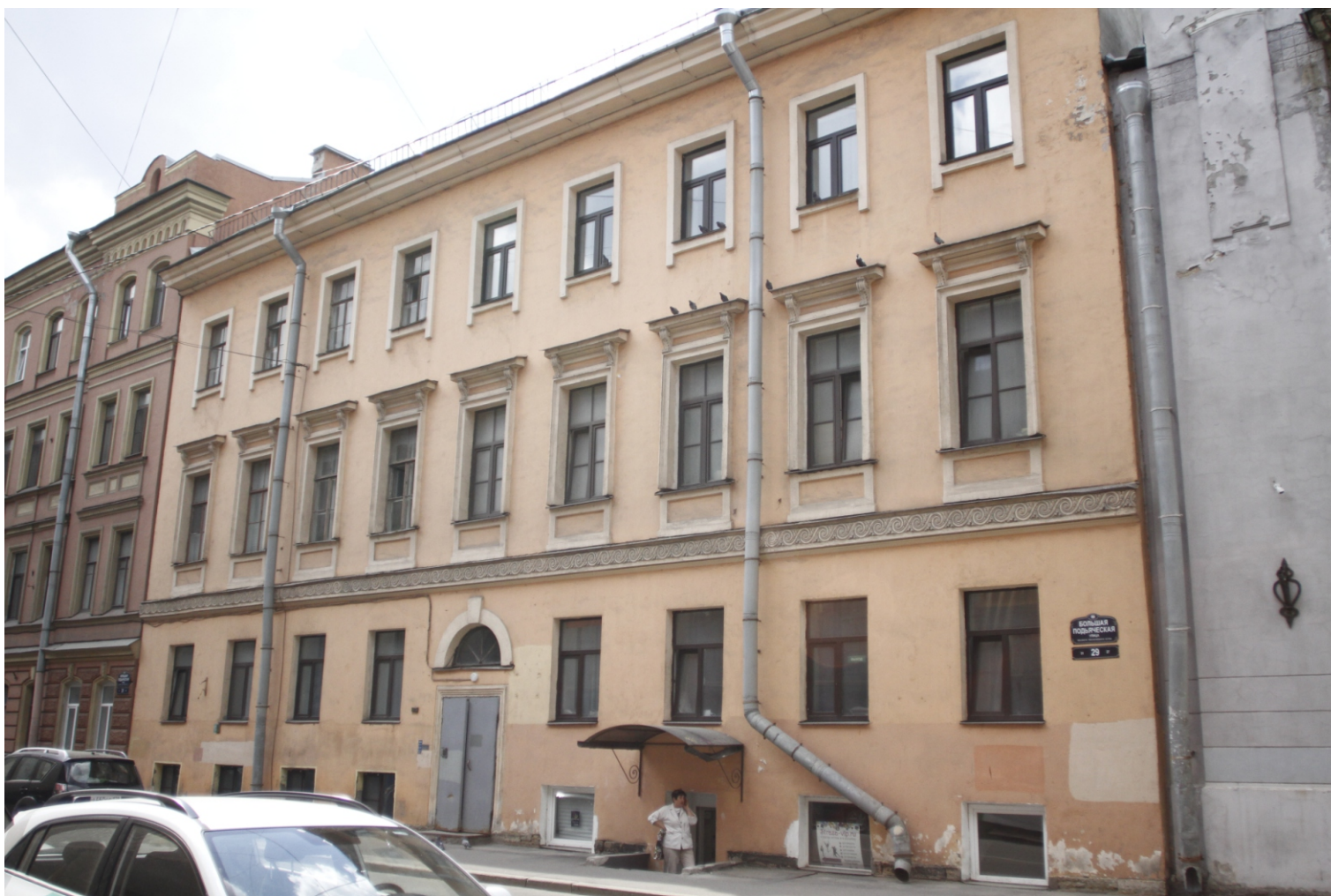
13. Вид на выявленный ОКН «Дом Ф.Демидовой». Фото: 05.05.2023.
