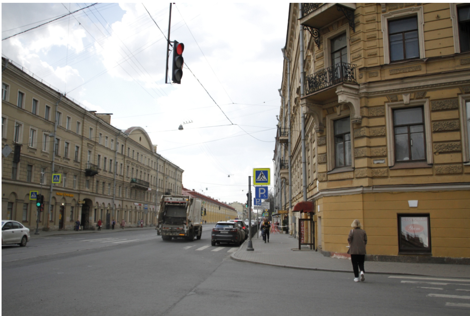
15. Вид на трассу Садовой ул. Фото: 05.05.2023.
