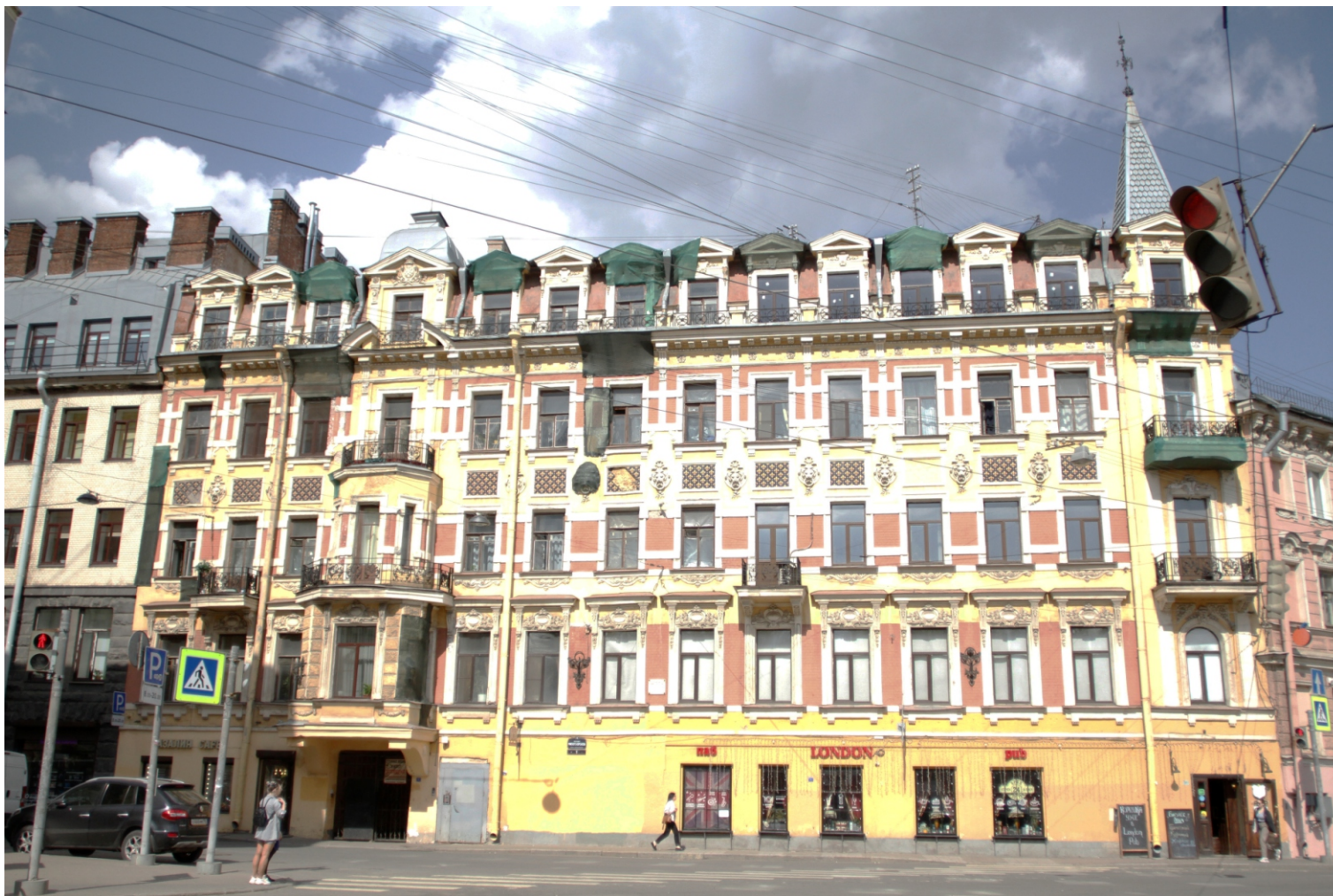
22. Вид на выявленный ОКН «Дом А.А. Кушелева». Фото: 05.05.2023.
