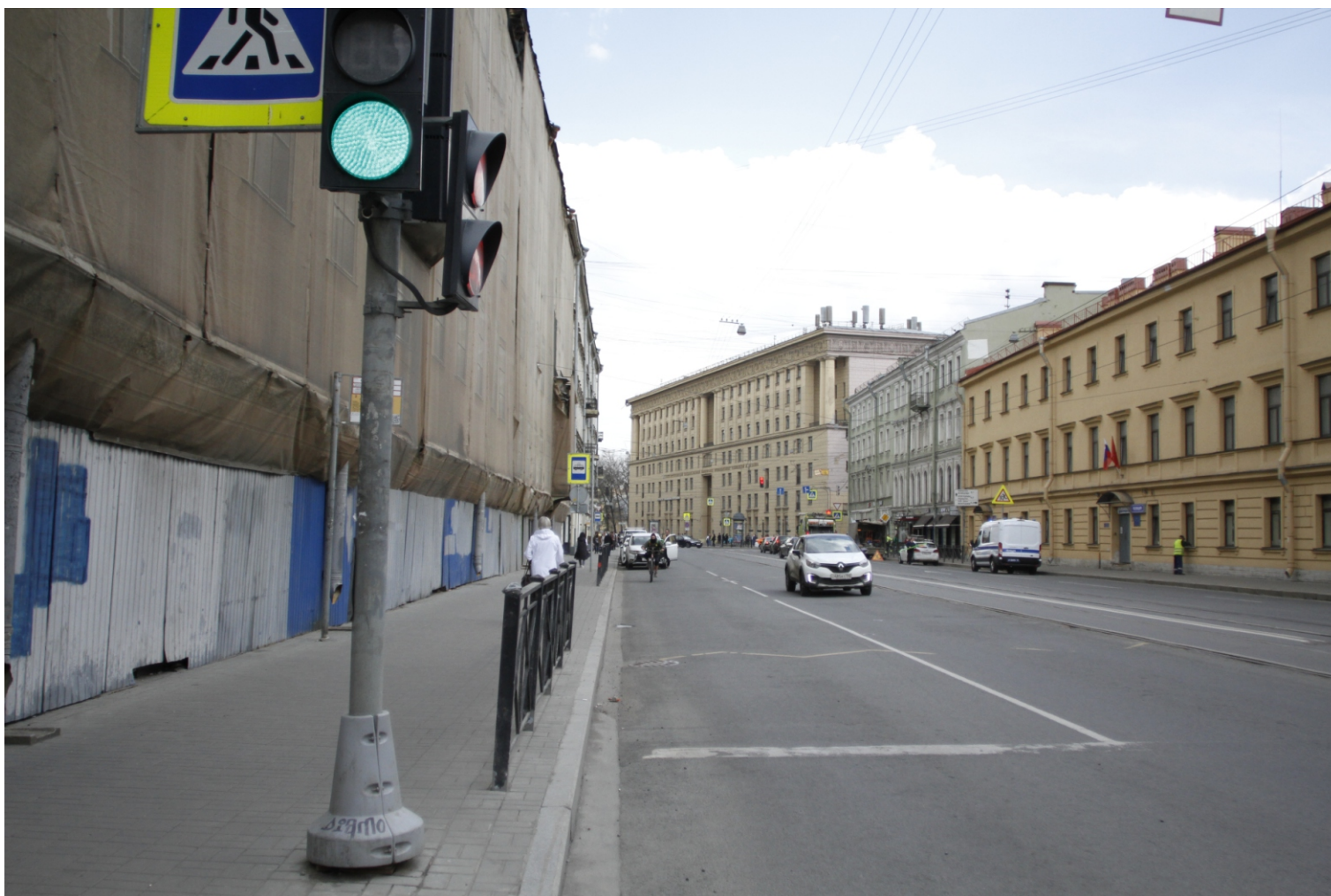
16. Вид на трассу Садовой ул. Фото: 05.05.2023.
