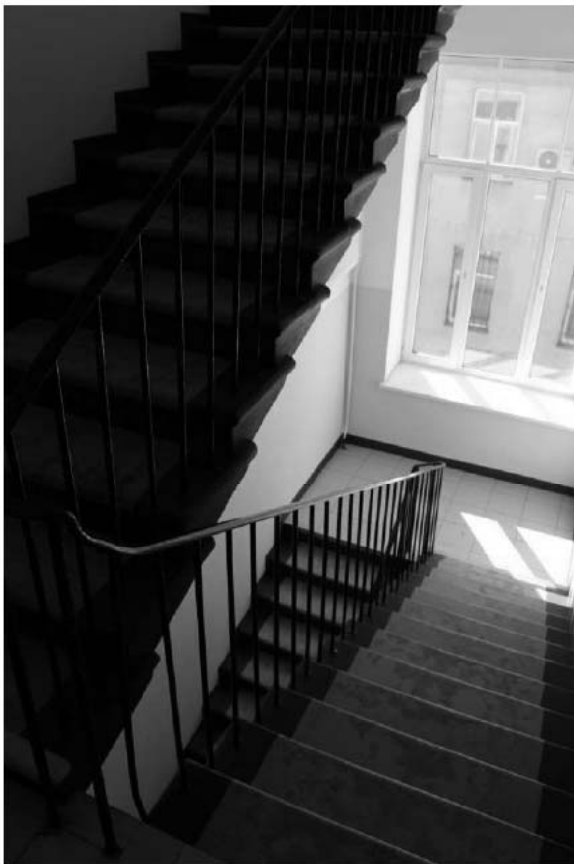
Фото 173. Выявленный объект культурного наследия «Патологоанатомический павильон». Южная служебная лестница в уровне 2-го этажа. Фото 12.05.2023 г.
