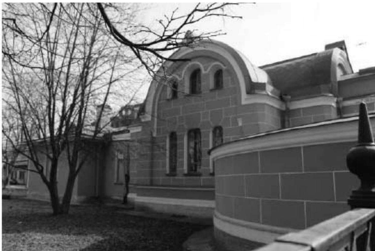
Фото 174. Вид на северный фасад выявленного объекта культурного наследия «Часовня». Фото 17.04.2023 г.
