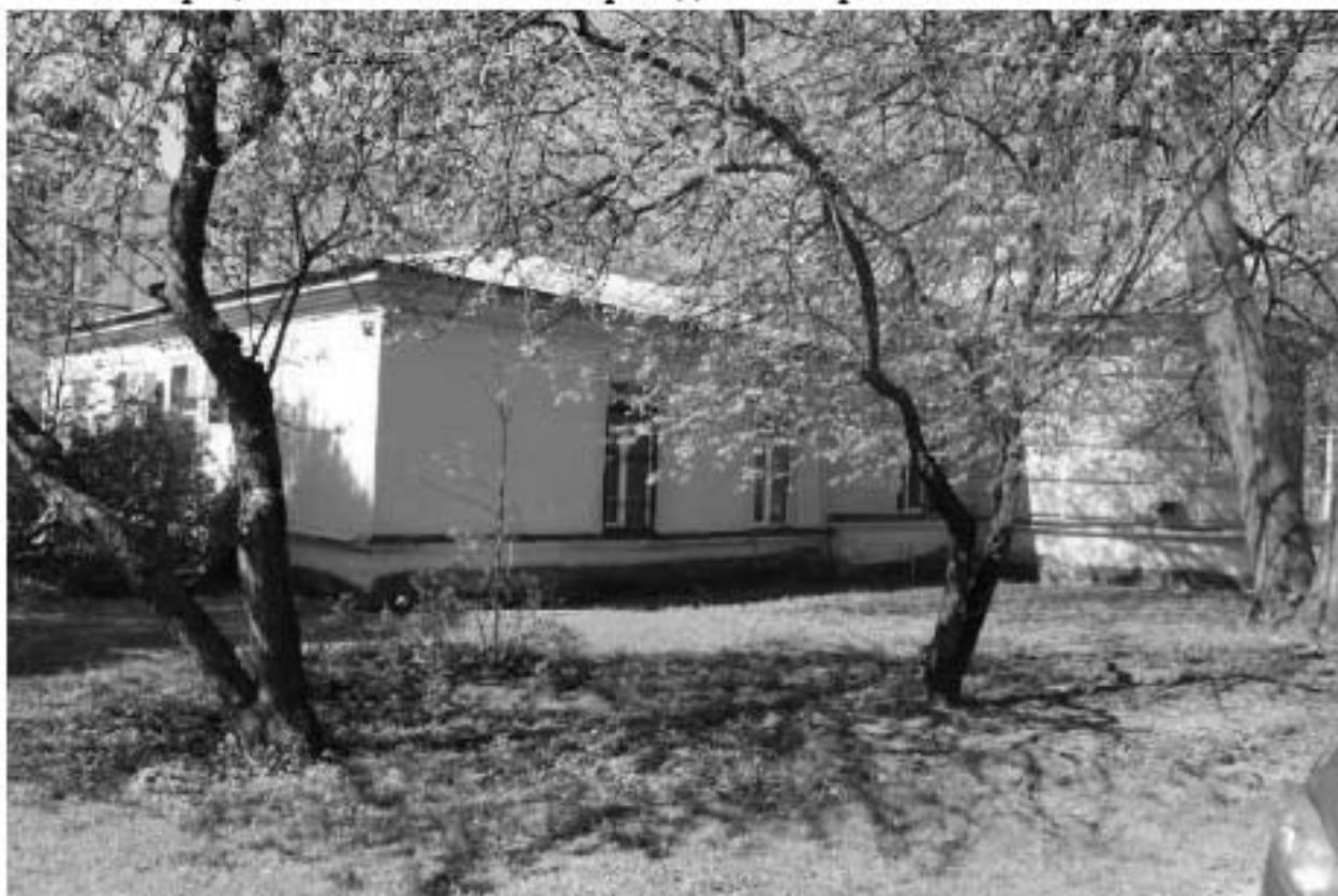
Фото 109. Вид на пристройку к выявленному объекту культурного наследия «Операционный павильон с переходной галереей». Фото 12.05.2023 г.
