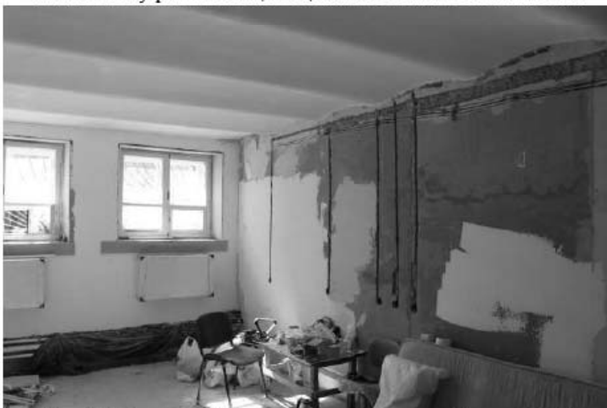
Фото 152. Выявленный объект культурного наследия «Изоляционный павильон». Внутренние помещения цокольного этажа. Фото 12.05.2023 г.
