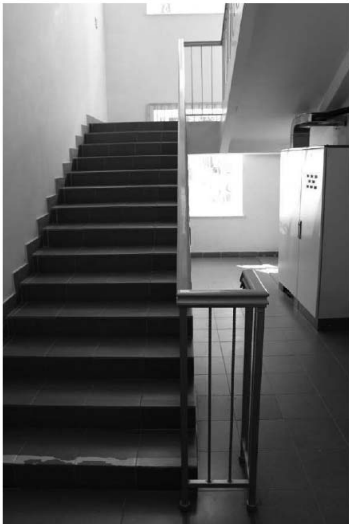
Фото 138. Выявленный объект культурного наследия «Амбулаторный корпус». Л-1. Вид на лестницу в уровне 1-го этажа. Фото 12.05.2023 г.
