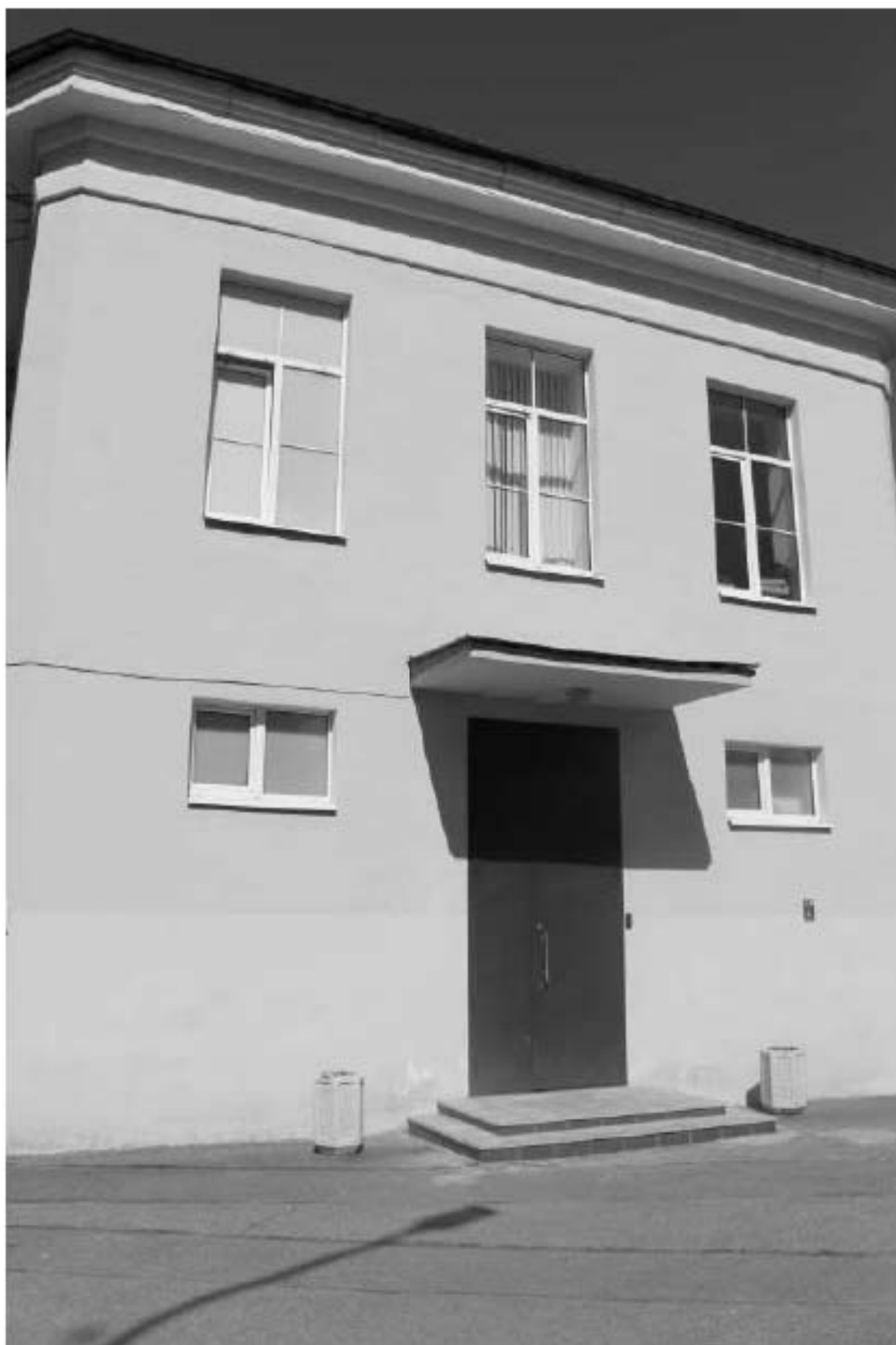
Фото 76. Вид на южный фасад выявленного объекта культурного наследия «Павильон гинекологических и глазных болезней с переходной галереей». Фото 12.05.2023 г.
