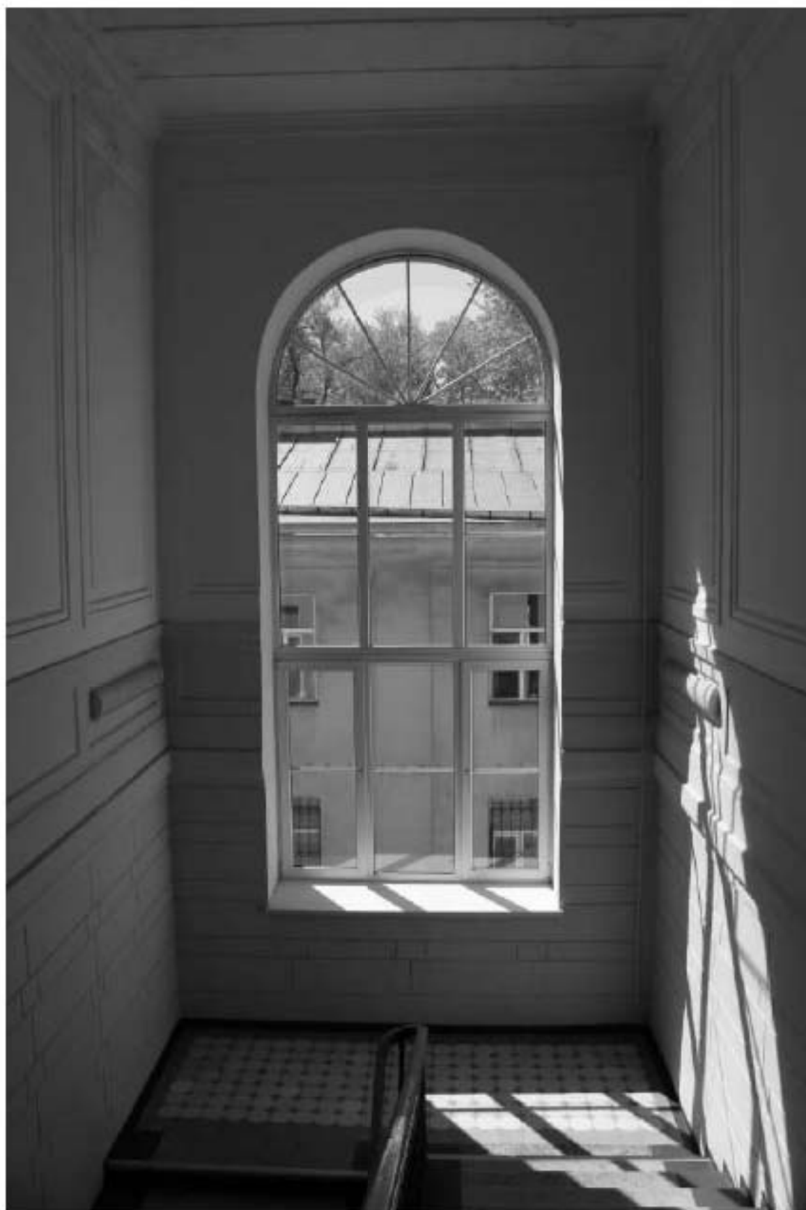
Фото 171. Выявленный объект культурного наследия «Патологоанатомический павильон». Центральная (парадная) лестница. Вид на лестничную клетку в уровне 2-го этажа. Фото 12.05.2023 г.
