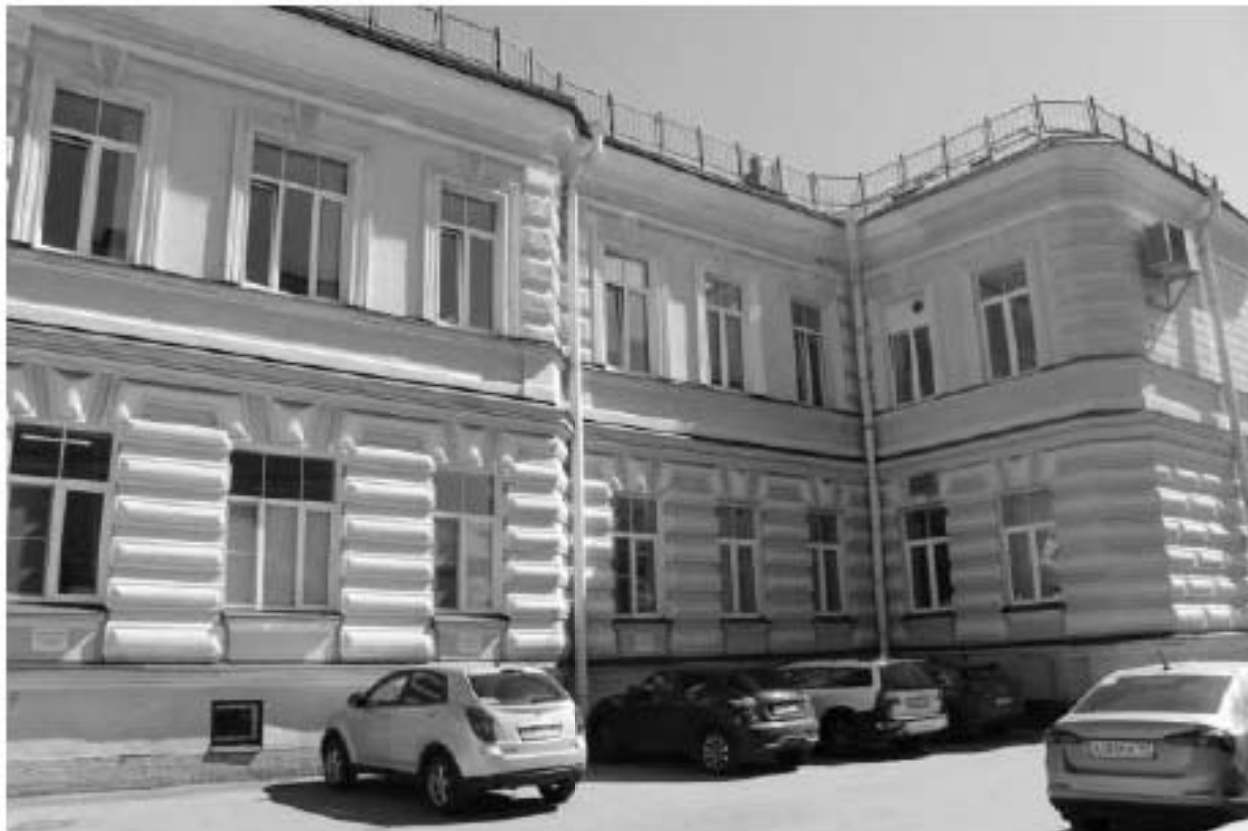
Фото 92. Вид на западный фасад выявленного объекта культурного наследия «Павильон-приют им. Н.И. Жуковской с переходной галереей». Фото 12.05.2023 г.
