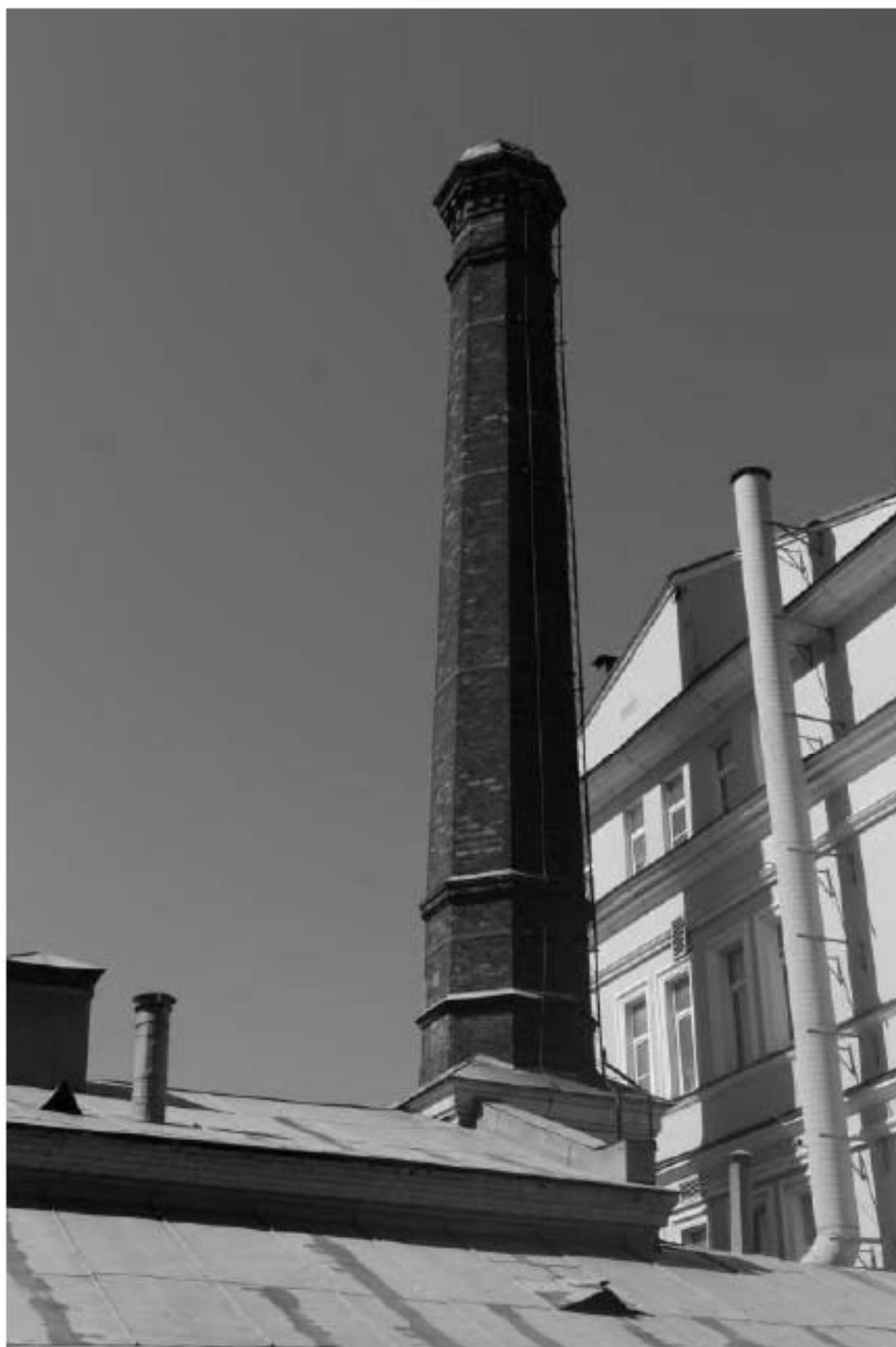
Фото 63. Вид на дымовую трубу выявленного объекта культурного наследия «Котельная» с юго-востока. Фото 12.05.2023 г.
