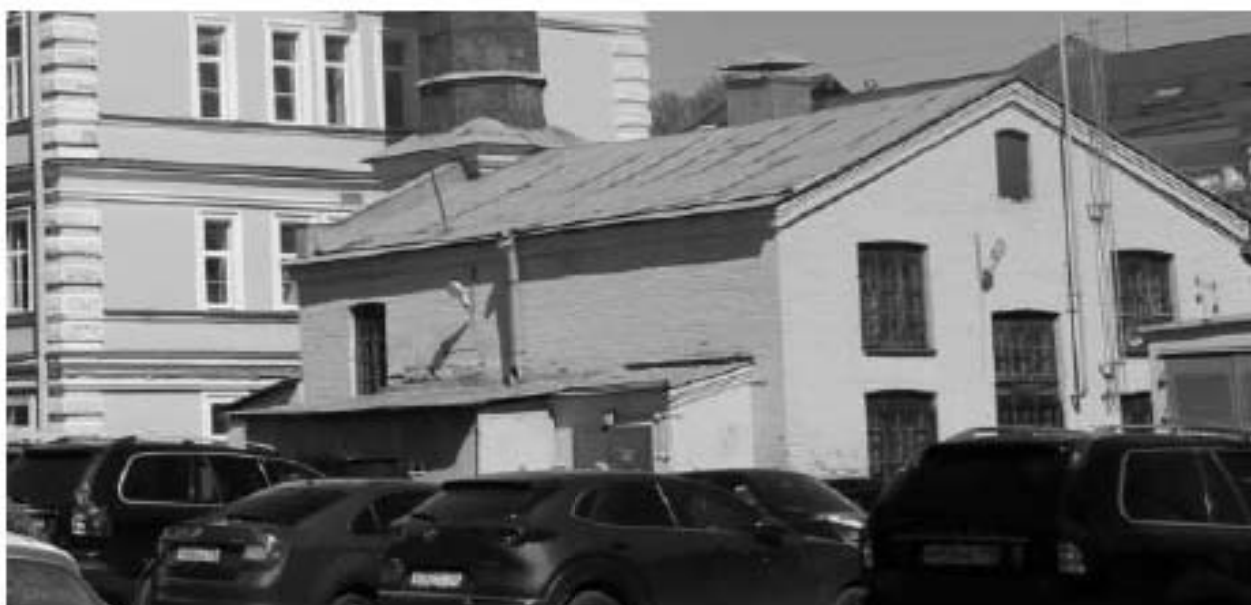
Фото 66. Вид на западный и южный фасады выявленного объекта культурного наследия «Котельная». Фото 12.05.2023 г.
