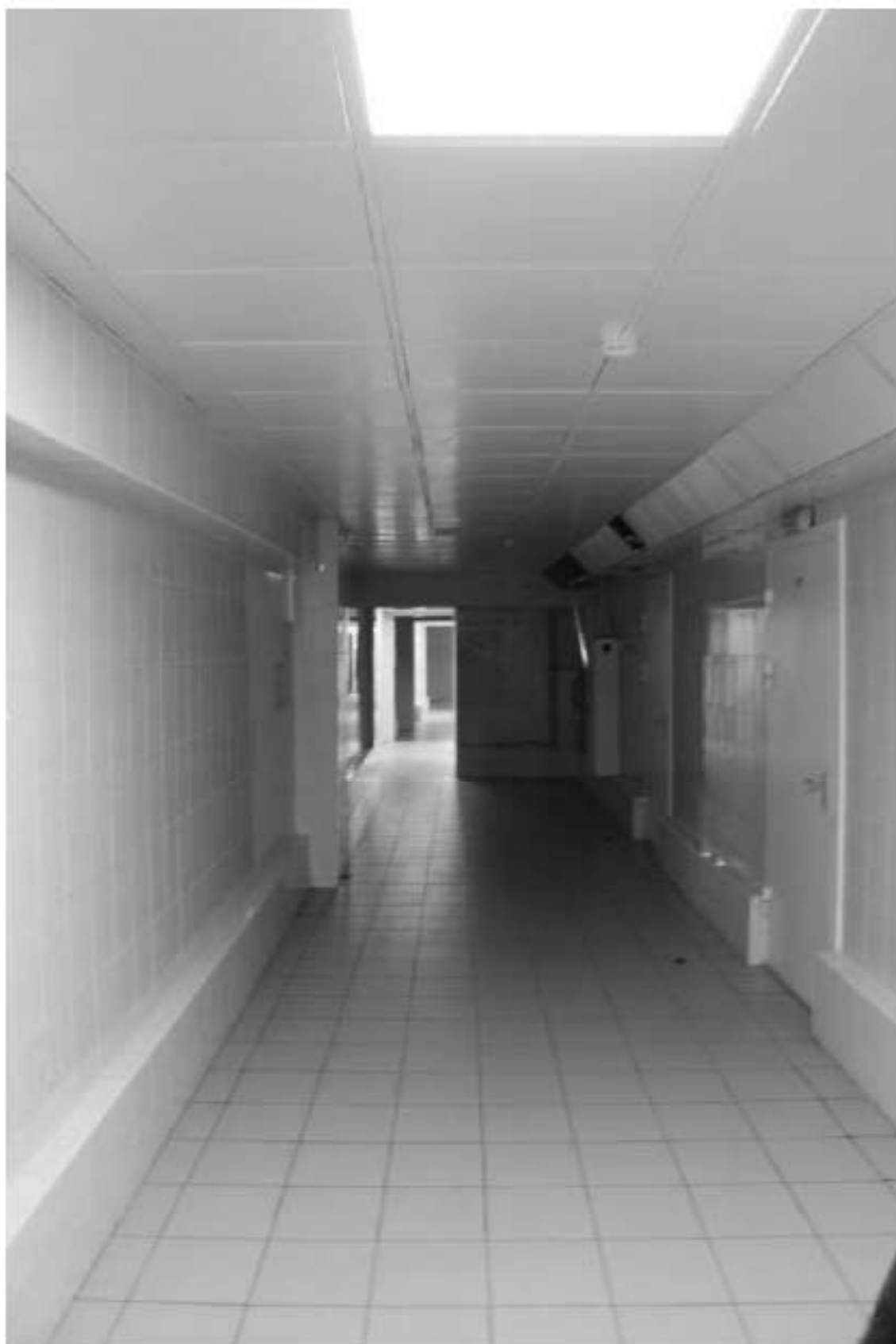
Фото 162. Выявленный объект культурного наследия «Патологоанатомический павильон». Внутренние помещения цокольного этажа. Фото 12.05.2023 г.
