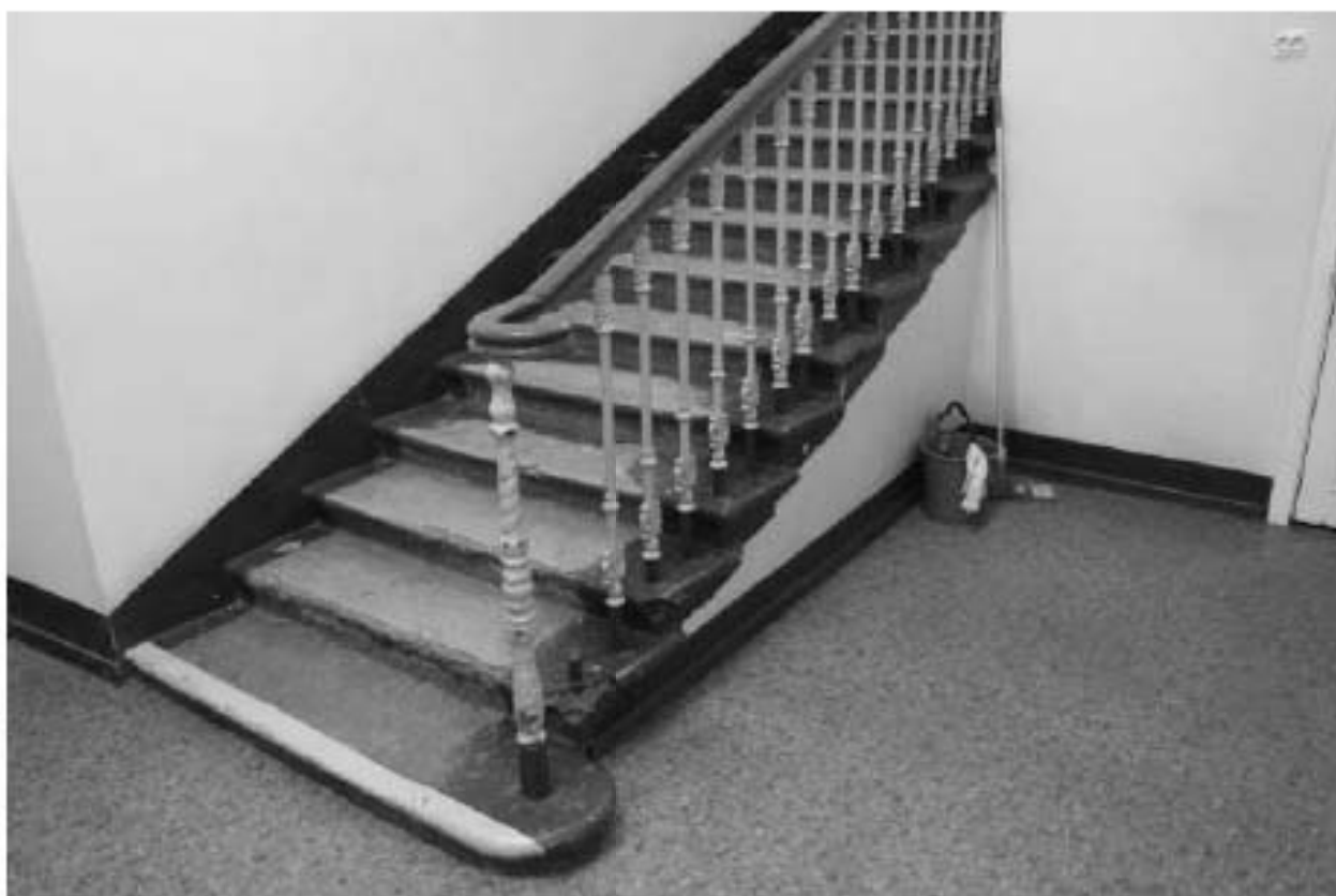
Фото 52. Выявленный объект культурного наследия «Кухонный корпус с переходной галереей». 2ЛК. Вид на лестницу в уровне 1-го этажа. Фото 12.05.2023 г.
