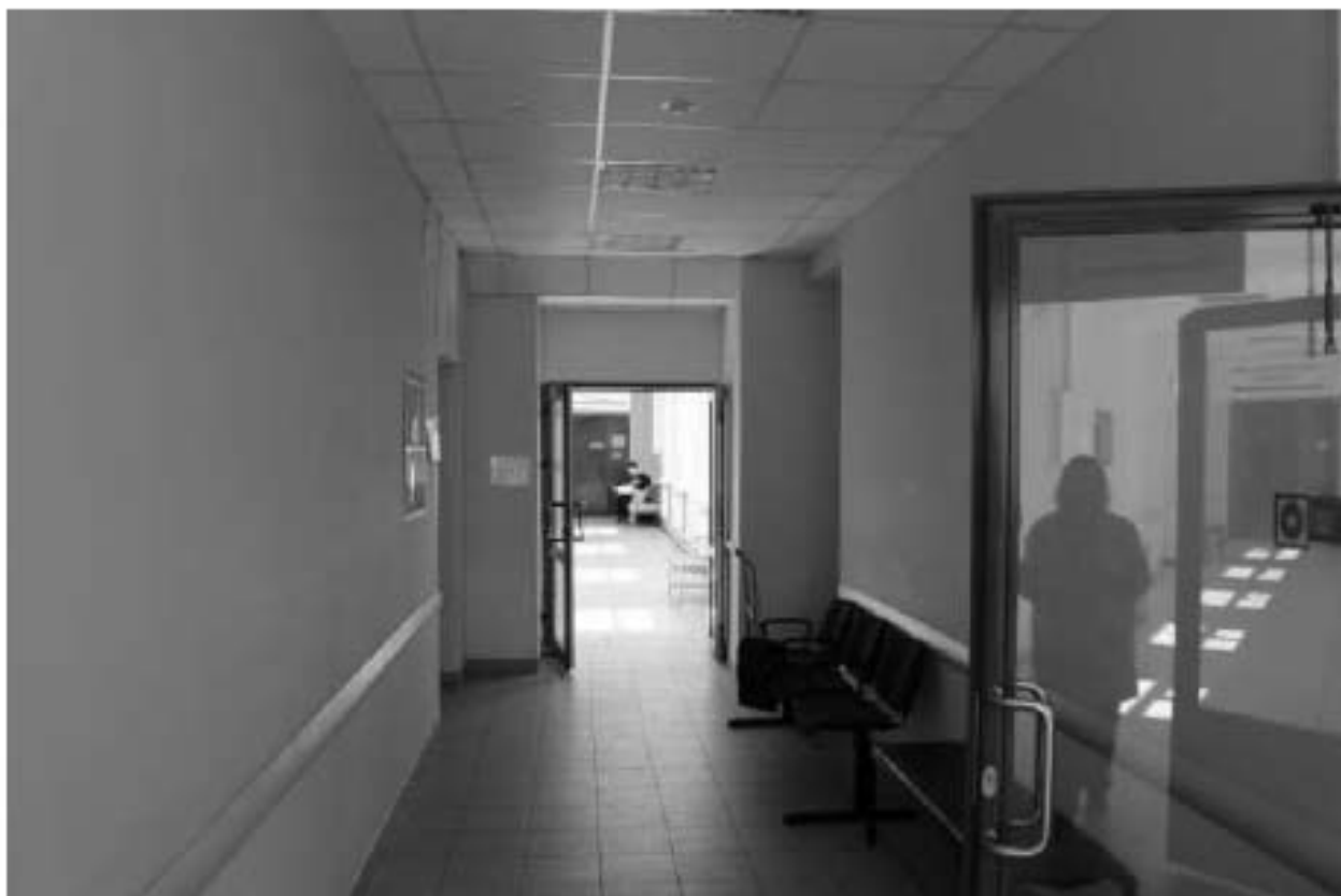
Фото 98. Выявленный объект культурного наследия «Павильон-приют им. Н.И. Жуковской с переходной галереей». Внутренние помещения 1-го этажа. Фото 12.05.2023 г.
