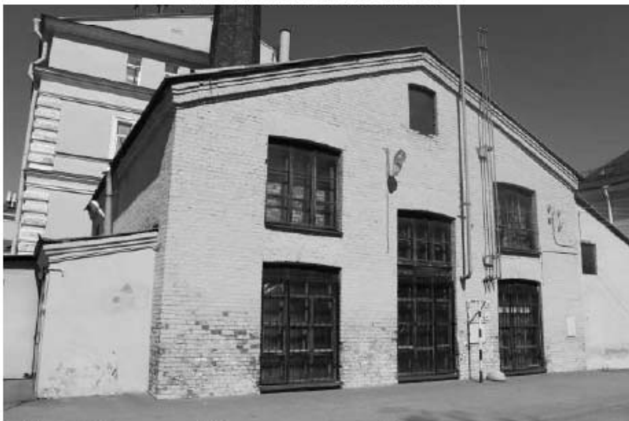
Фото 65. Вид на южный фасад выявленного объекта культурного наследия «Котельная». Фото 12.05.2023 г.
