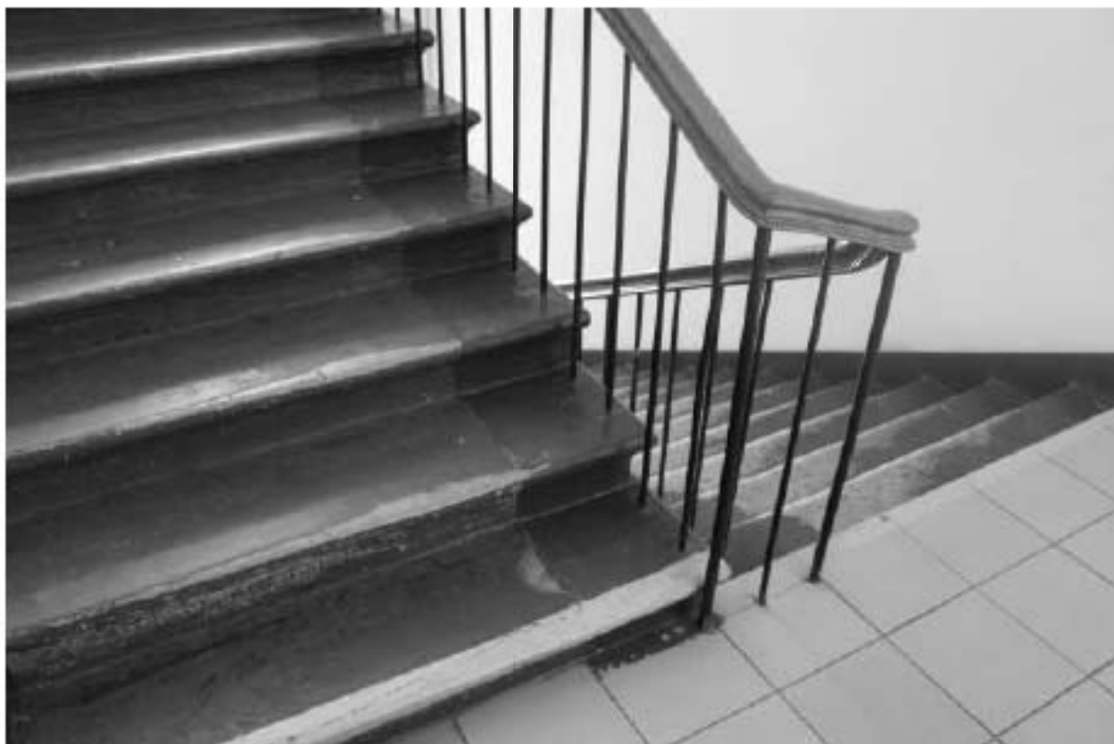
Фото 38. Выявленный объект культурного наследия «Главное здание». 2ЛК. Вид на лестницу в уровне 2-го этажа. Фото 12.05.2023 г.
