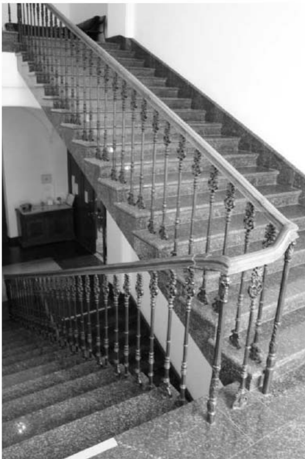
Фото 26. Выявленный объект культурного наследия «Главное здание». 1ЛК. Междуэтажная площадка в уровне 2-го – 3-го этажей. Фото 12.05.2023 г.
