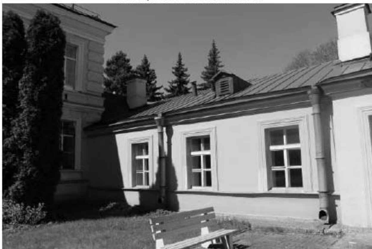
Фото 72. Вид на южный фасад переходной галерей выявленного объекта культурного наследия «Павильон гинекологических и глазных болезней с переходной галереей». Фото 12.05.2023 г.
