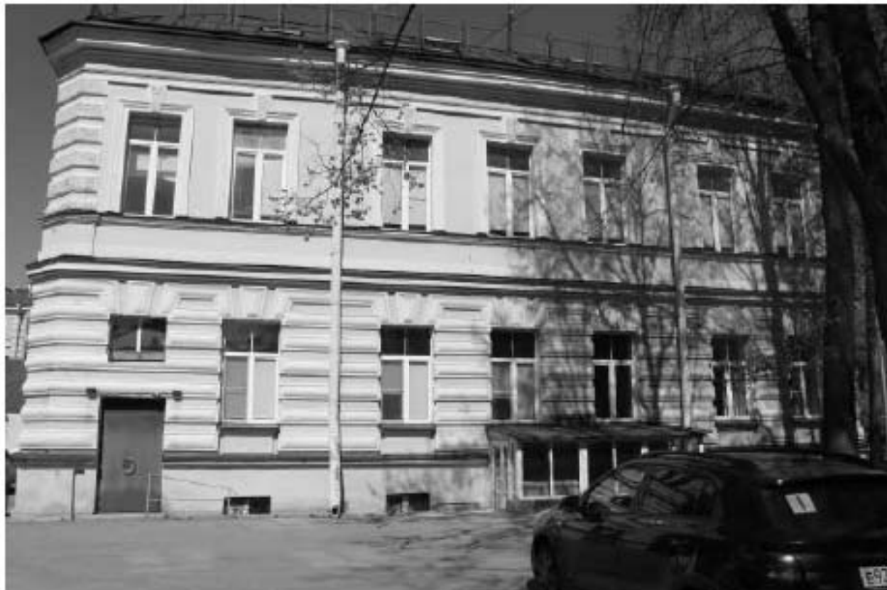
Фото 90. Вид на южный фасад выявленного объекта культурного наследия «Павильон-приют им. Н.И. Жуковской с переходной галереей». Фото 12.05.2023 г.
