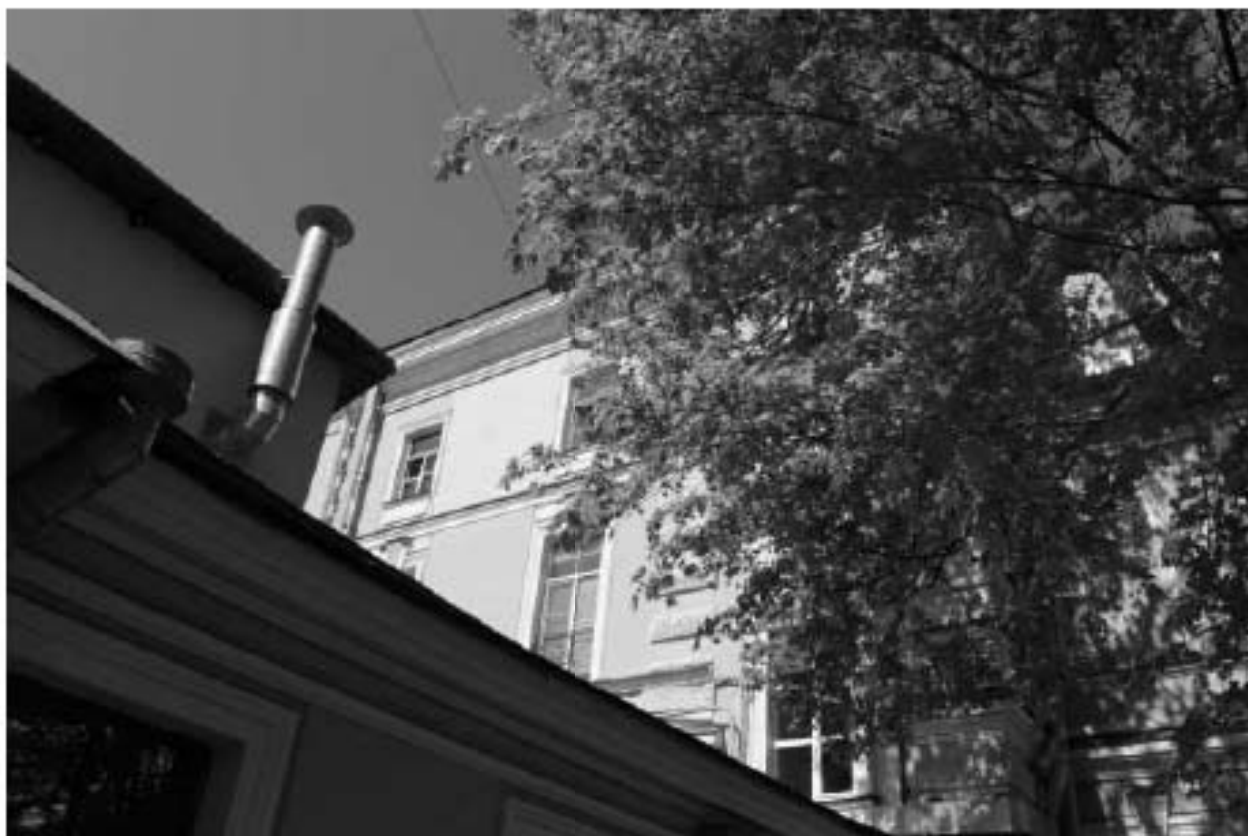
Фото 10. Вид на южный фасад центрального корпуса выявленного объекта культурного наследия «Главное здание». Фото 12.05.2023 г.
