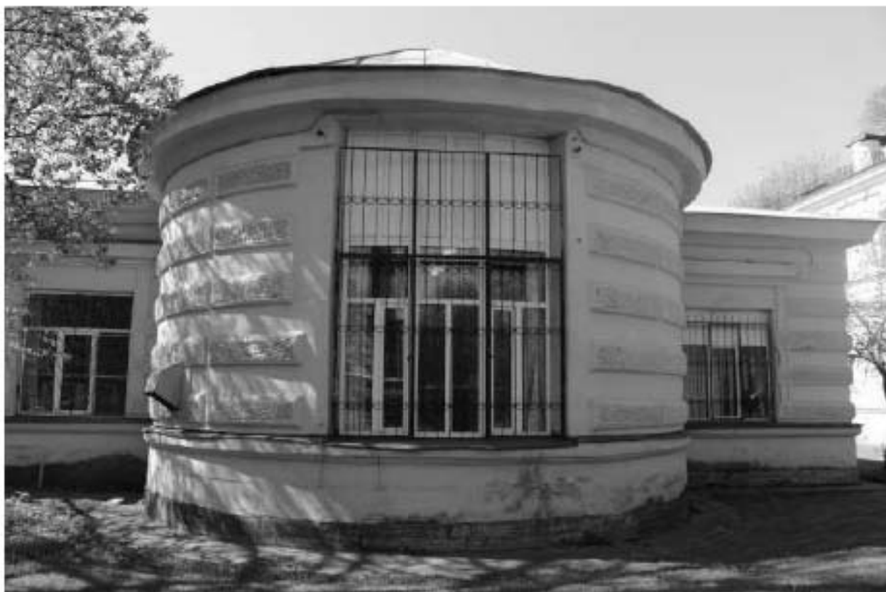
Фото 108. Вид на восточный фасад выявленного объекта культурного наследия «Операционный павильон с переходной галереей». Фото 12.05.2023 г.
