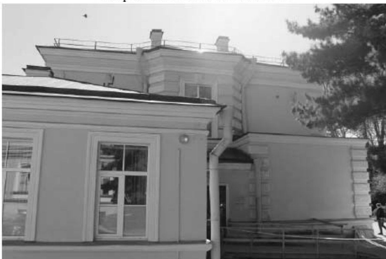
Фото 80. Вид на северный фасад выявленного объекта культурного наследия «Павильон гинекологических и глазных болезней с переходной галереей». Фото 12.05.2023 г.
