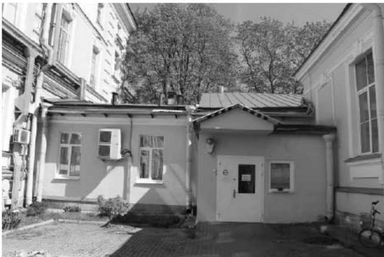
Фото 49. Вид на западный фасад переходной галерей выявленного объекта культурного наследия «Кухонный корпус с переходной галереей». Фото 12.05.2023 г.
