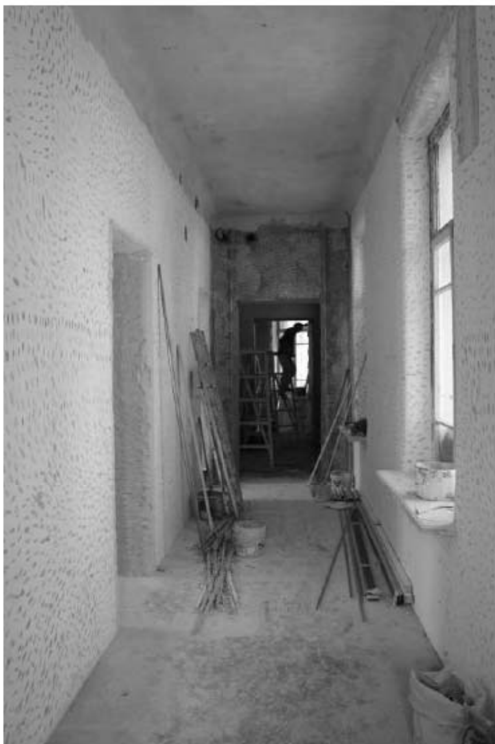
Фото 154. Выявленный объект культурного наследия «Изоляционный павильон». Внутренние помещения 1-го этажа. Фото 12.05.2023 г.
