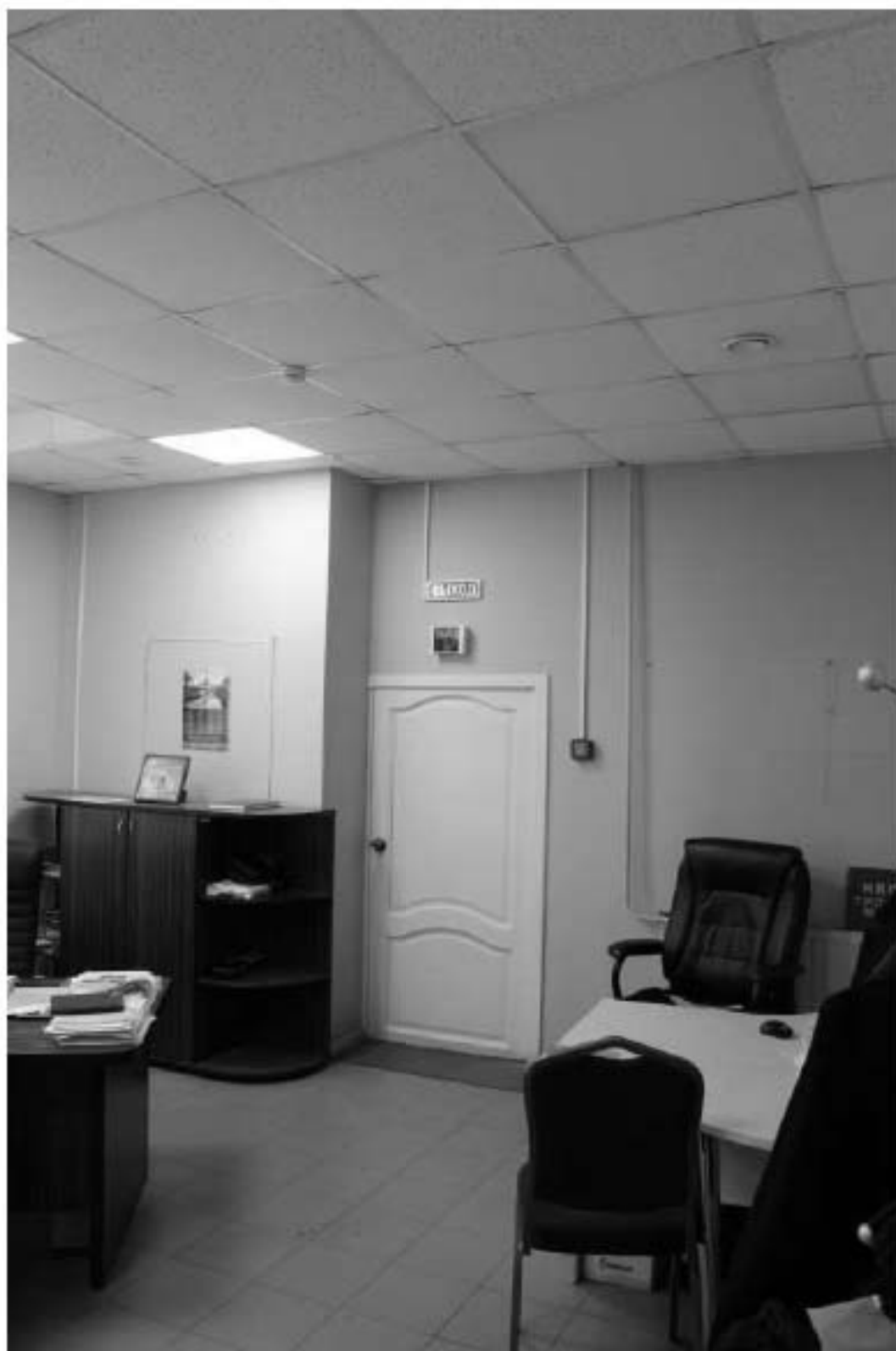
Фото 188. Выявленный объект культурного наследия «Часовня». Внутренние помещения. Фото 12.05.2023 г.
