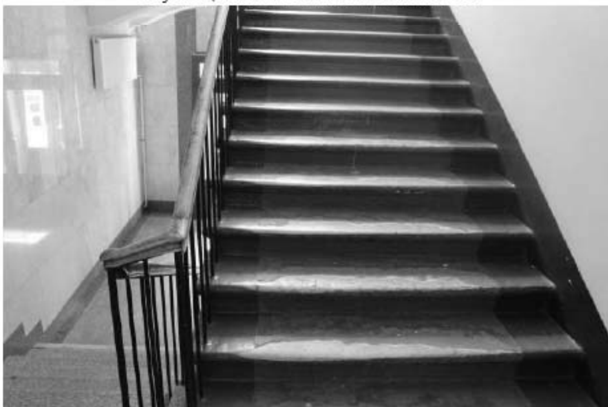
Фото 41. Выявленный объект культурного наследия «Главное здание». 6ЛК. Вид на лестницу в уровне 1-го этажа. Фото 12.05.2023 г.
