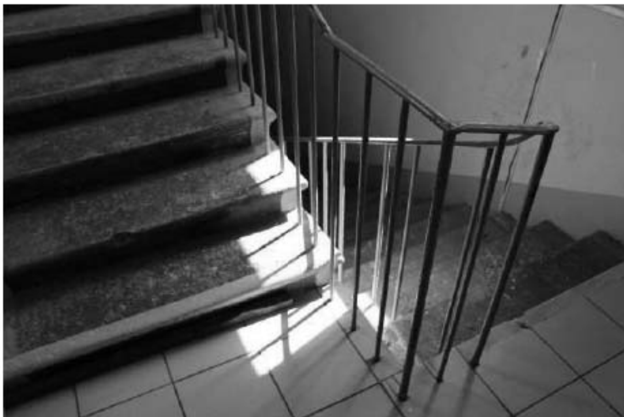
Фото 59. Выявленный объект культурного наследия «Кухонный корпус с переходной галереей». 5ЛК. Вид на лестницу в уровне 1-го этажа. Фото 12.05.2023 г.
