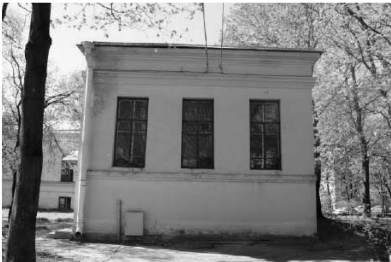
Фото 147. Вид на восточный фасад пристройки к выявленному объекту культурного наследия «Изоляционный павильон». Фото 12.05.2023 г.
