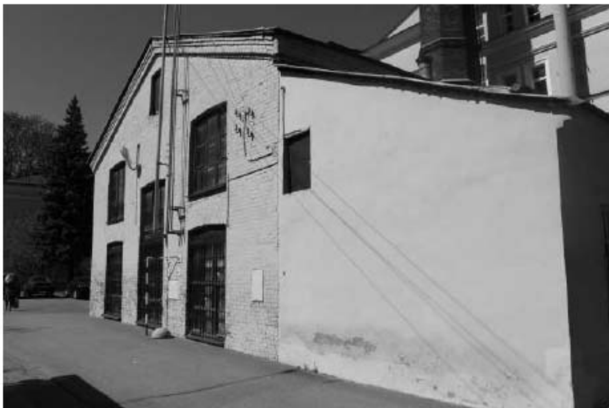
Фото 64. Вид на южный фасад выявленного объекта культурного наследия «Котельная». Фото 12.05.2023 г.
