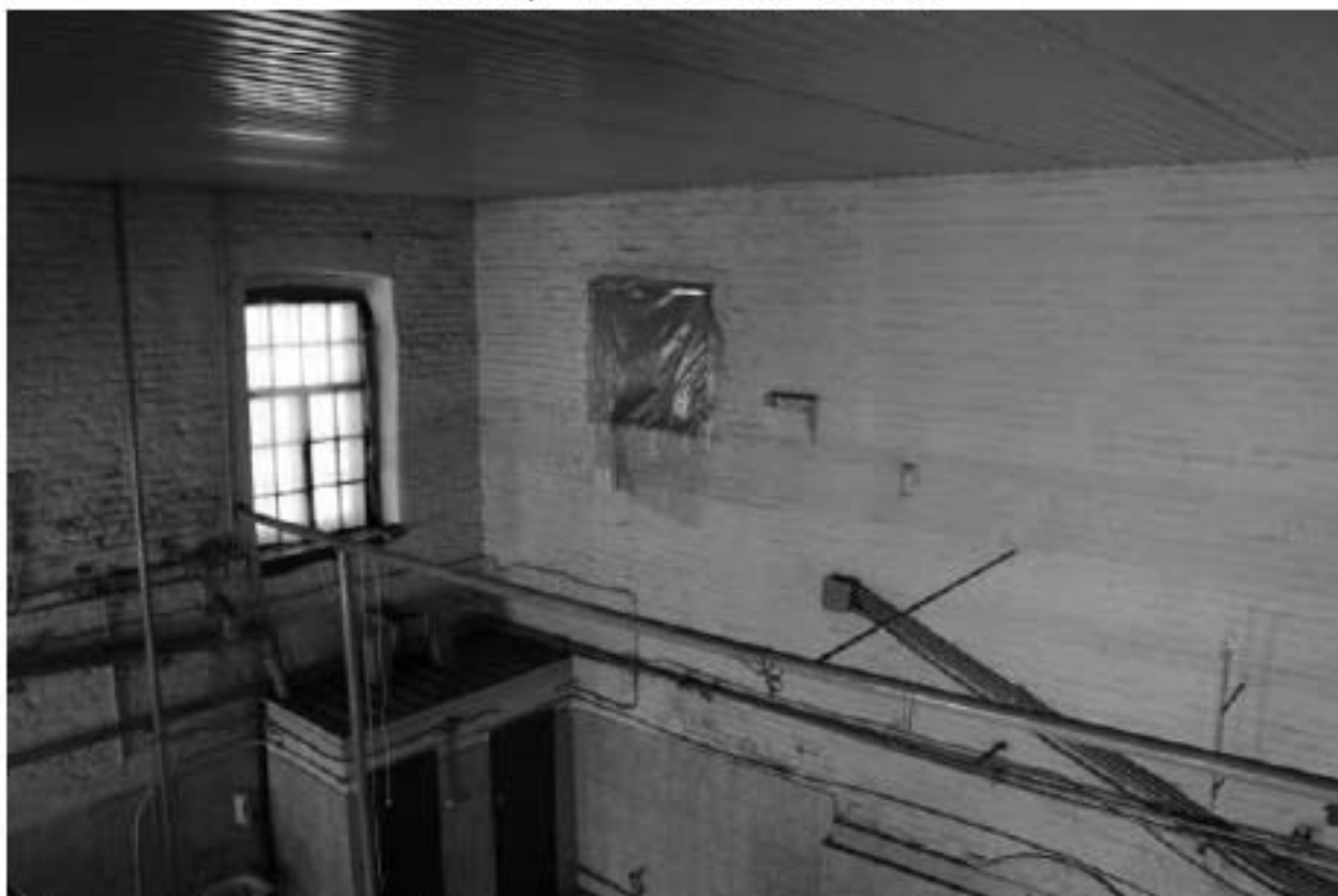
Фото 70. Выявленный объект культурного наследия «Котельная». Внутренние помещения. Фото 12.05.2023 г.
