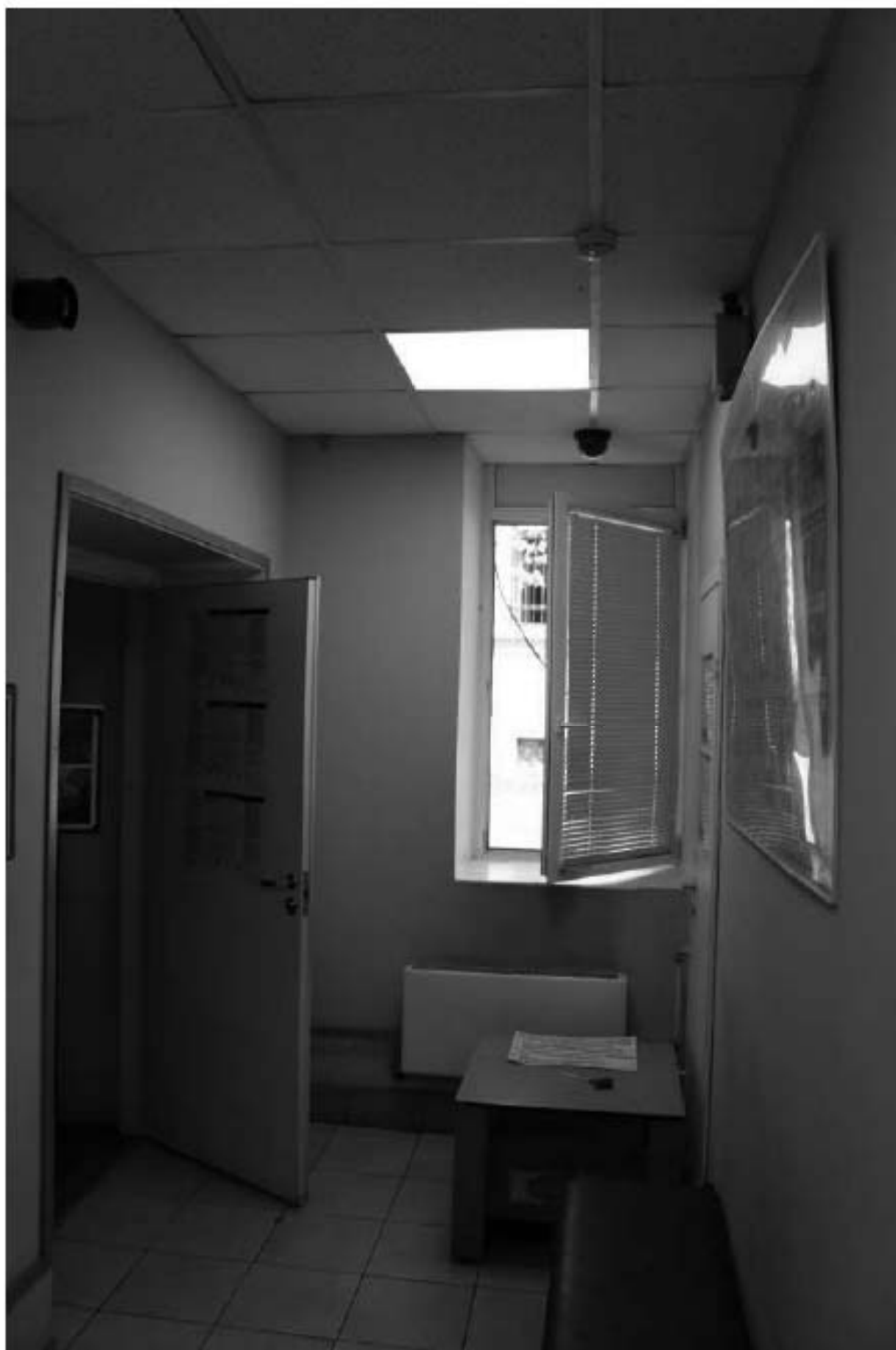
Фото 187. Выявленный объект культурного наследия «Часовня». Внутренние помещения. Фото 12.05.2023 г.
