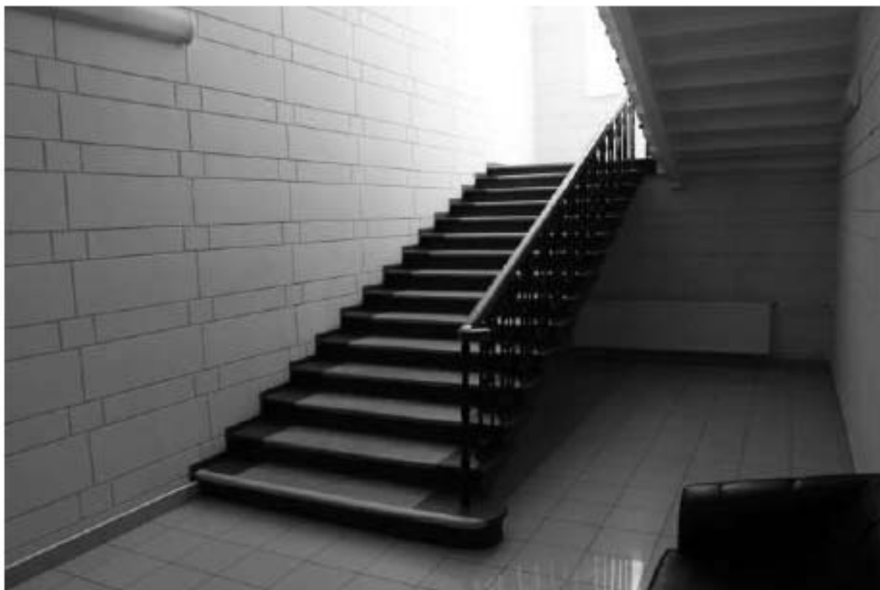
Фото 168. Выявленный объект культурного наследия «Патологоанатомический павильон». Центральная (парадная) лестница в уровне 1-го этажа. Фото 12.05.2023 г.
