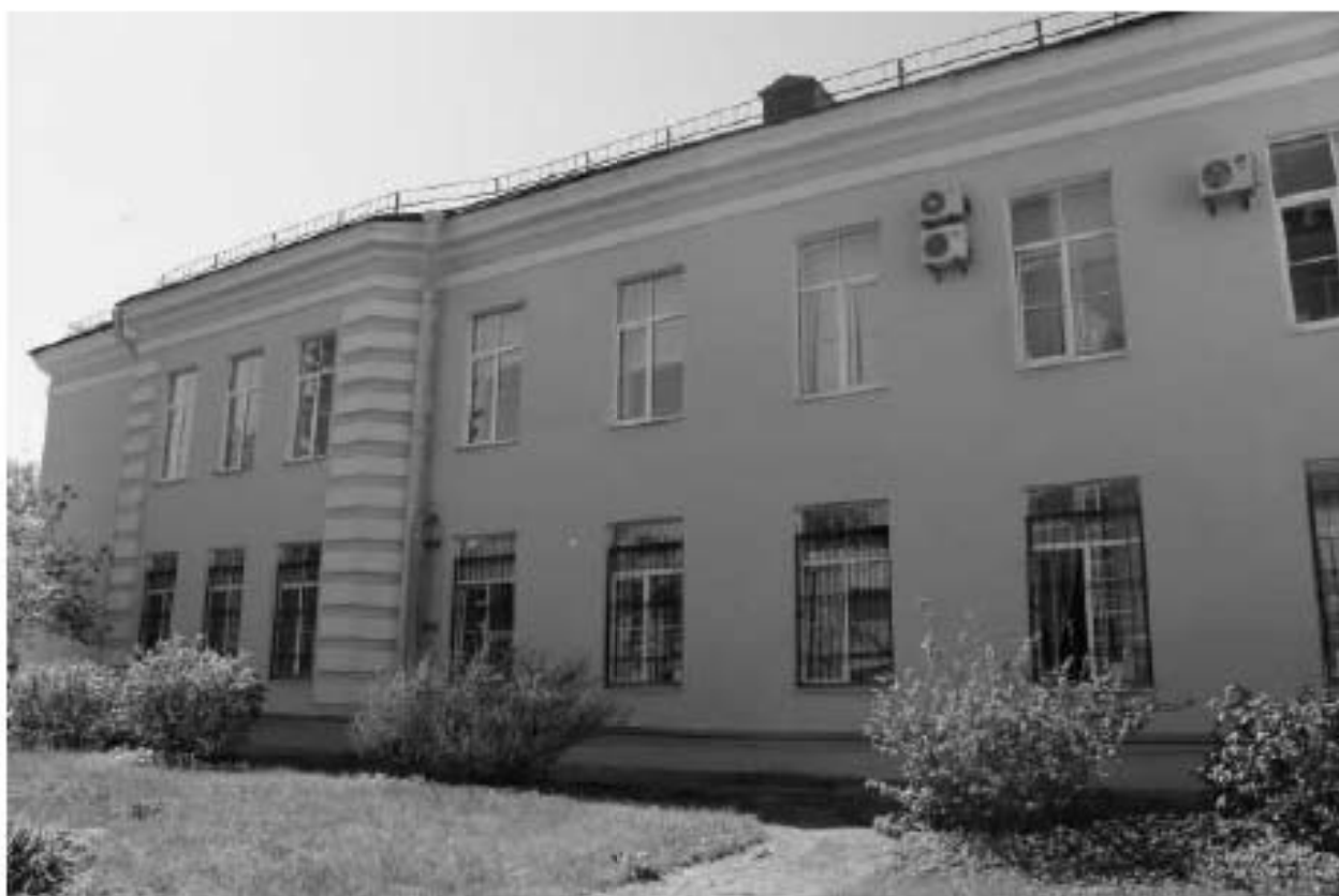
Фото 75. Вид на восточный фасад выявленного объекта культурного наследия «Павильон гинекологических и глазных болезней с переходной галереей». Фото 12.05.2023 г.
