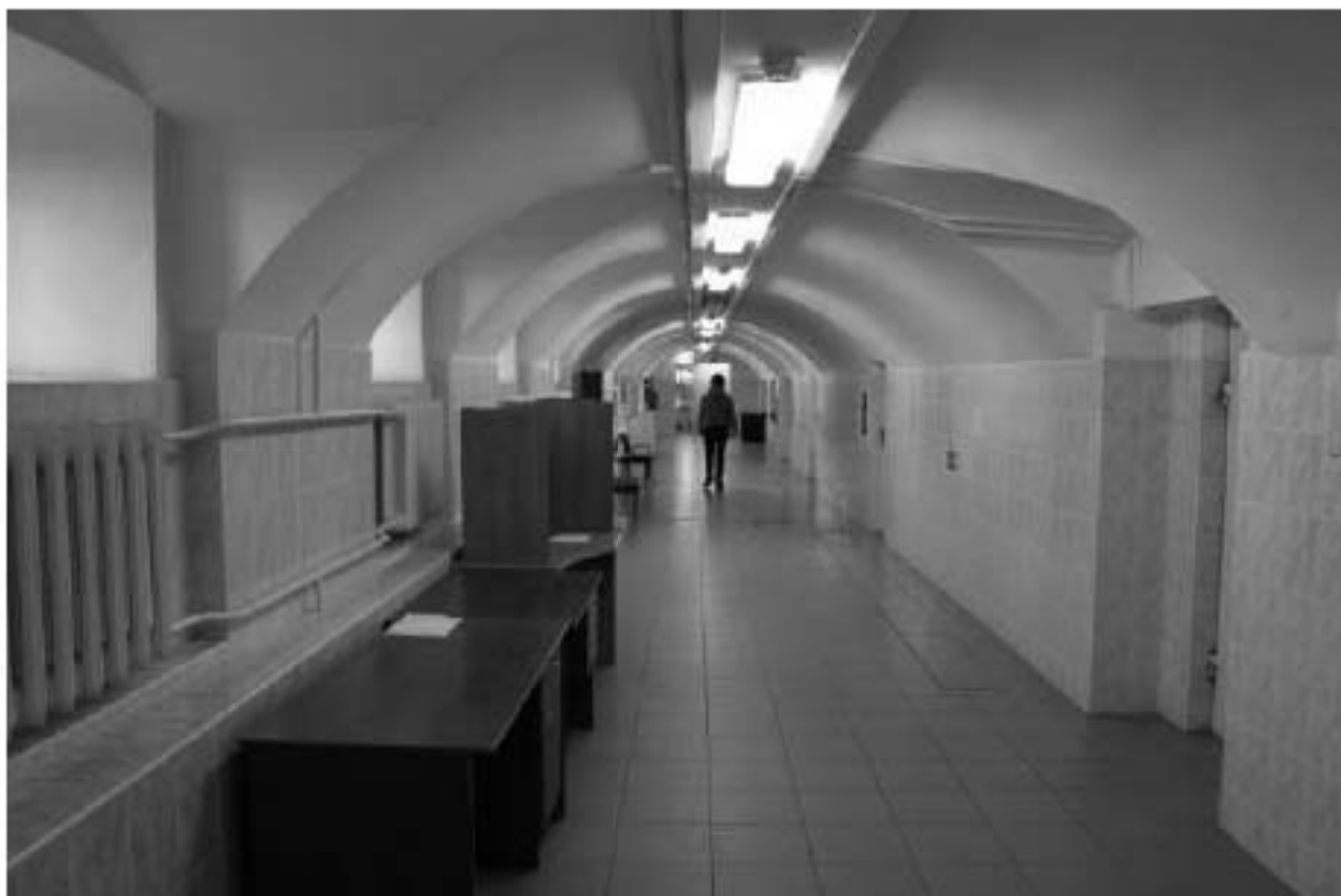
Фото 21. Выявленный объект культурного наследия «Главное здание». Внутренние помещения цокольного этажа. Фото 12.05.2023 г.
