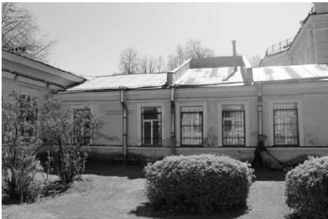
Фото 104. Вид на северный фасад переходной галереи выявленного объекта культурного наследия «Операционный павильон с переходной галереей». Фото 12.05.2023 г.
