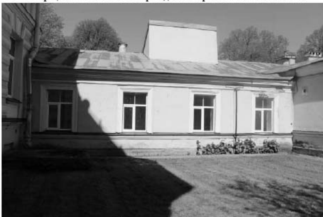
Фото 111. Вид на южный фасад переходной галереи выявленного объекта культурного наследия «Операционный павильон с переходной галереей». Фото 12.05.2023 г.
