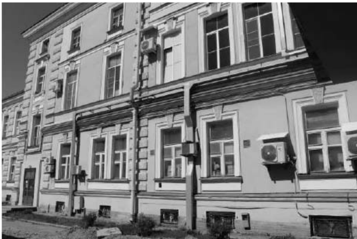
Фото 8. Вид на южный фасад центрального корпуса выявленного объекта культурного наследия «Главное здание». Фото 12.05.2023 г.
