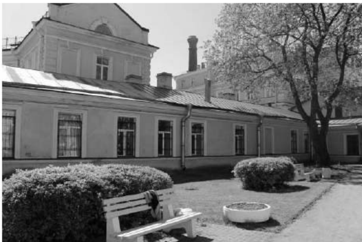
Фото 87. Вид на северный фасад переходной галерей выявленного объекта культурного наследия «Павильон-приют им. Н.И. Жуковской с переходной галереей». Фото 12.05.2023 г.
