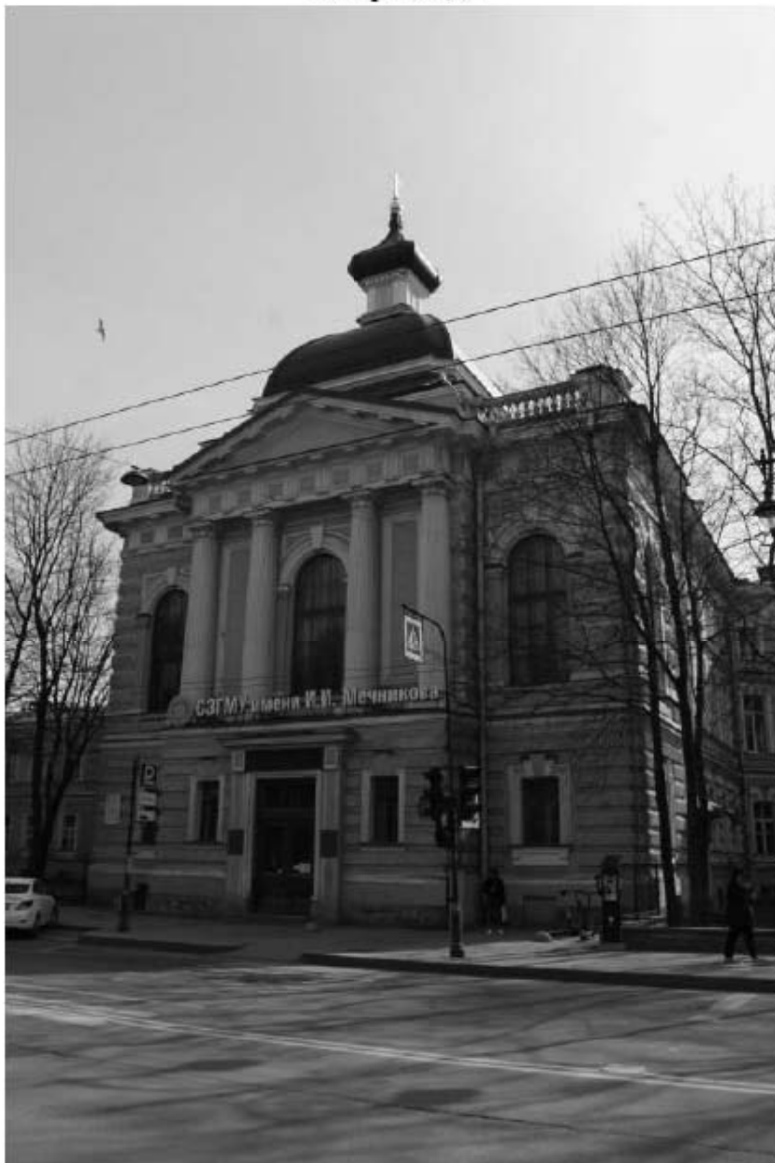
Фото 1. Вид на северный фасад центрального корпуса выявленного объекта культурного наследия «Главное здание». Фото 17.04.2023 г.
