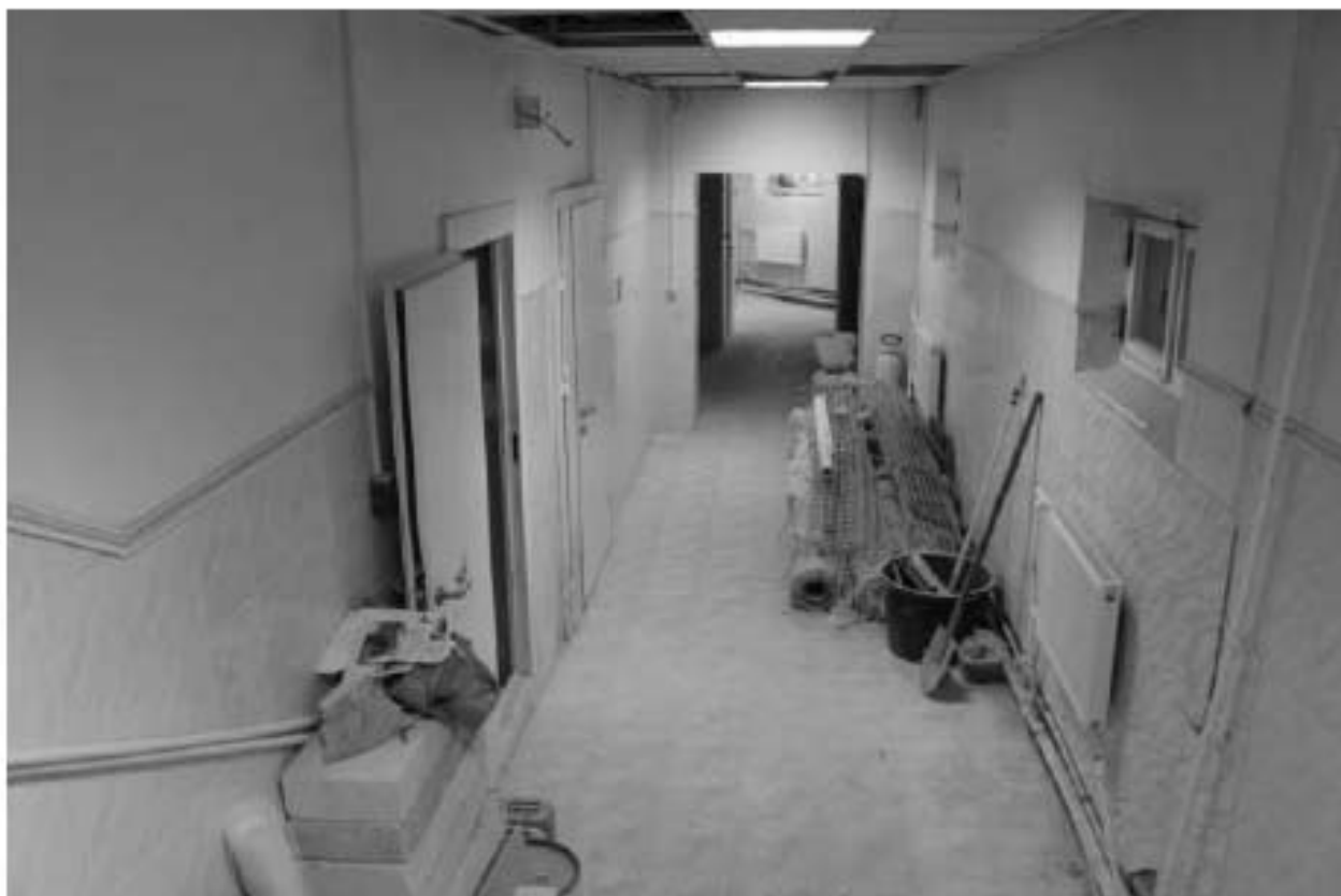
Фото 151. Выявленный объект культурного наследия «Изоляционный павильон». Внутренние помещения цокольного этажа. Фото 12.05.2023 г.
