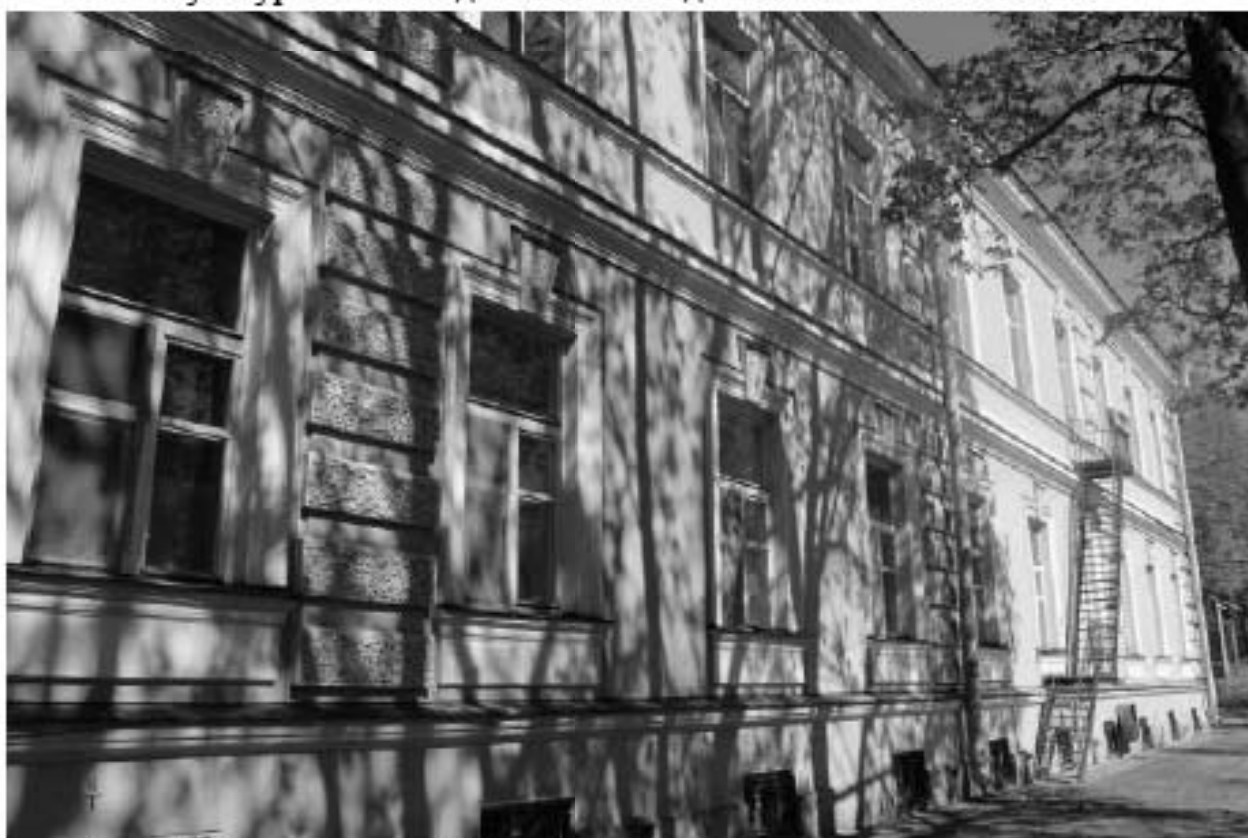
Фото 11. Вид на южный фасад восточного крыла выявленного объекта культурного наследия «Главное здание». Фото 12.05.2023 г.
