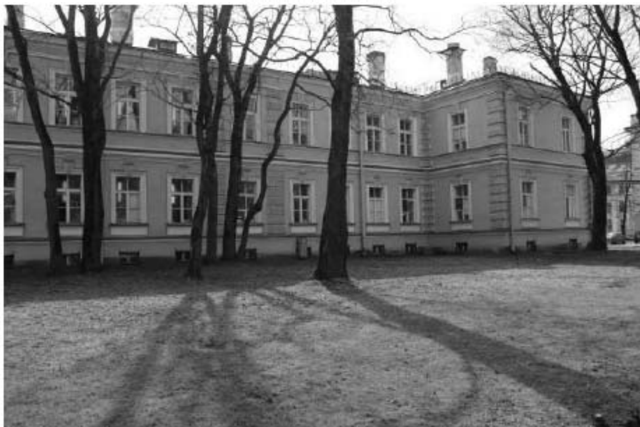
Фото 5. Вид на северный фасад западного крыла выявленного объекта культурного наследия «Главное здание». Фото 17.04.2023 г.
