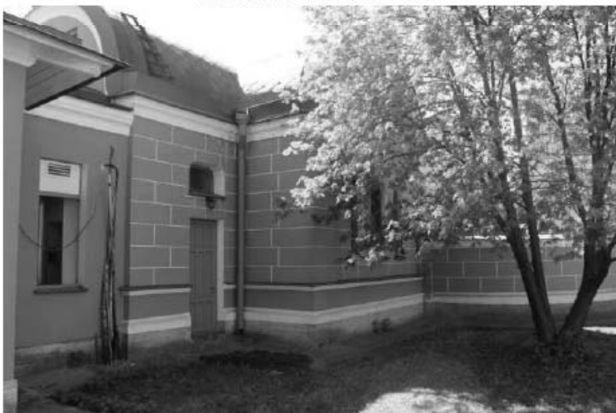
Фото 179. Вид на северный фасад выявленного объекта культурного наследия «Часовня». Фото 12.05.2023 г.
