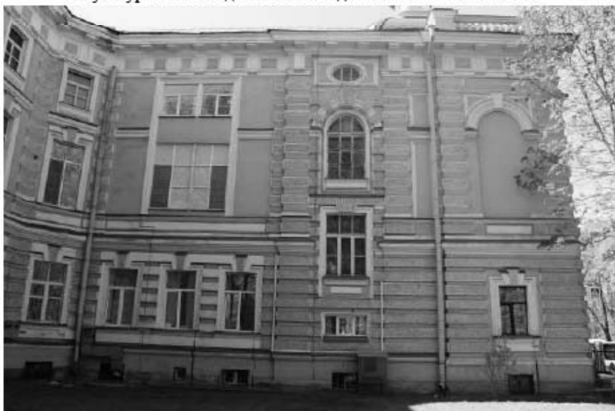
Фото 17. Вид на восточный фасад центрального корпуса выявленного объекта культурного наследия «Главное здание». Фото 12.05.2023 г.
