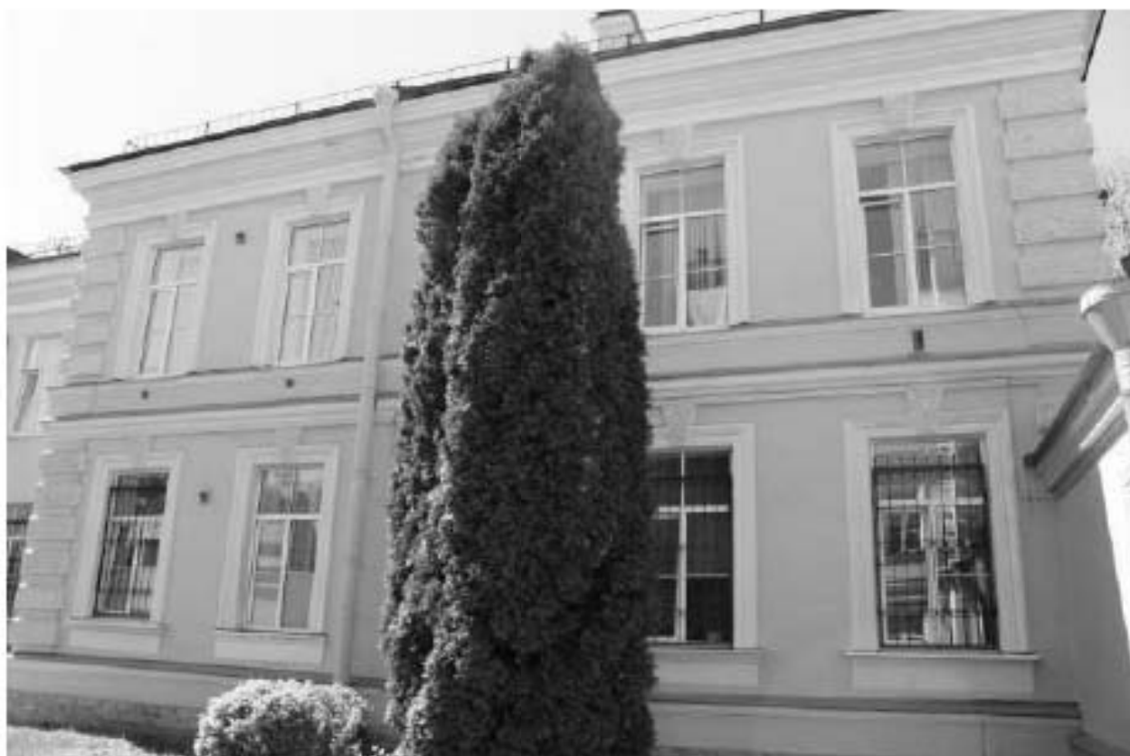
Фото 73. Вид на восточный фасад выявленного объекта культурного наследия «Павильон гинекологических и глазных болезней с переходной галереей». Фото 12.05.2023 г.
