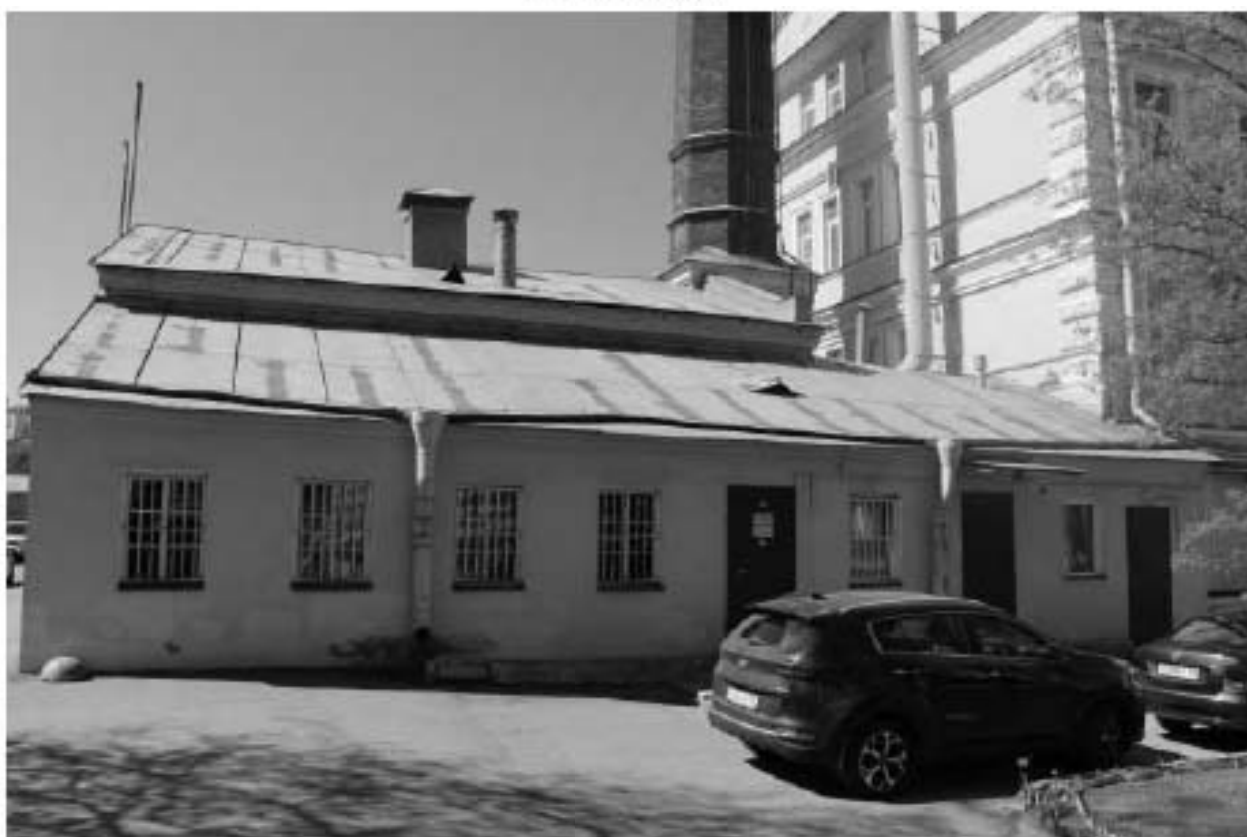
Фото 62. Вид на восточный фасад выявленного объекта культурного наследия «Котельная». Фото 12.05.2023 г.
