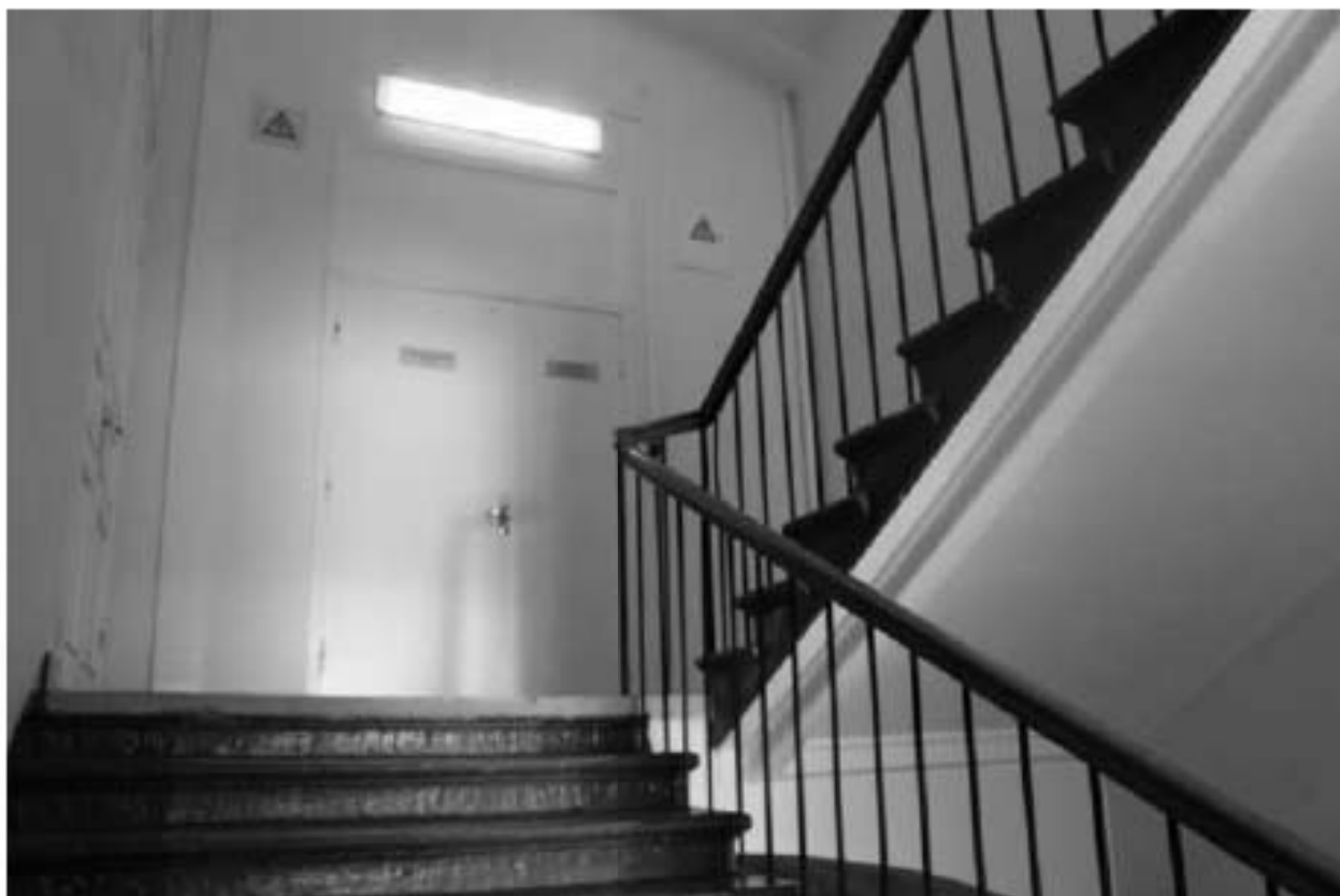
Фото 42. Выявленный объект культурного наследия «Главное здание». 6ЛК. Вид на лестничную площадку в уровне 2-го этажа. Фото 12.05.2023 г.
