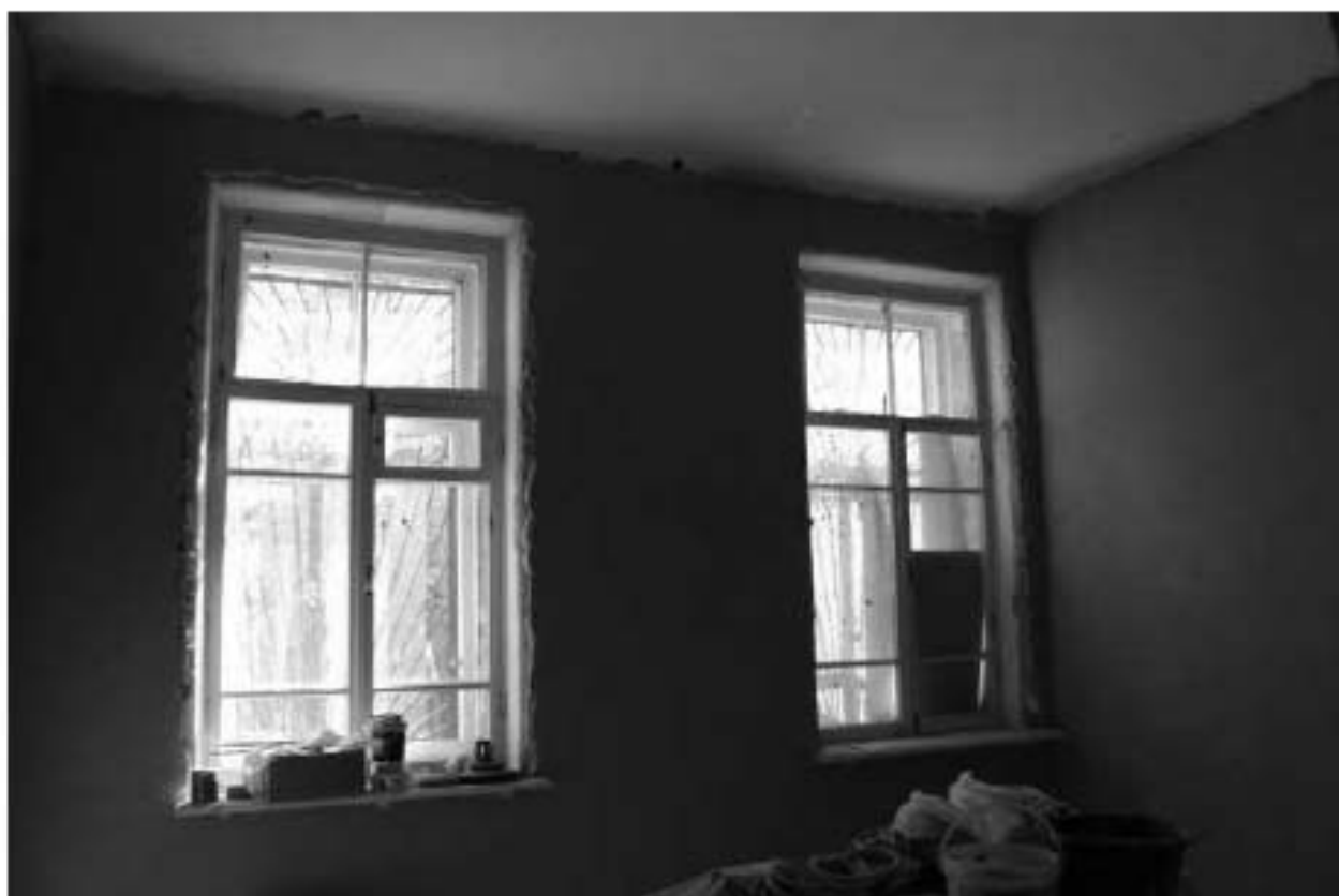
Фото 155. Выявленный объект культурного наследия «Изоляционный павильон». Внутренние помещения 1-го этажа. Фото 12.05.2023 г.
