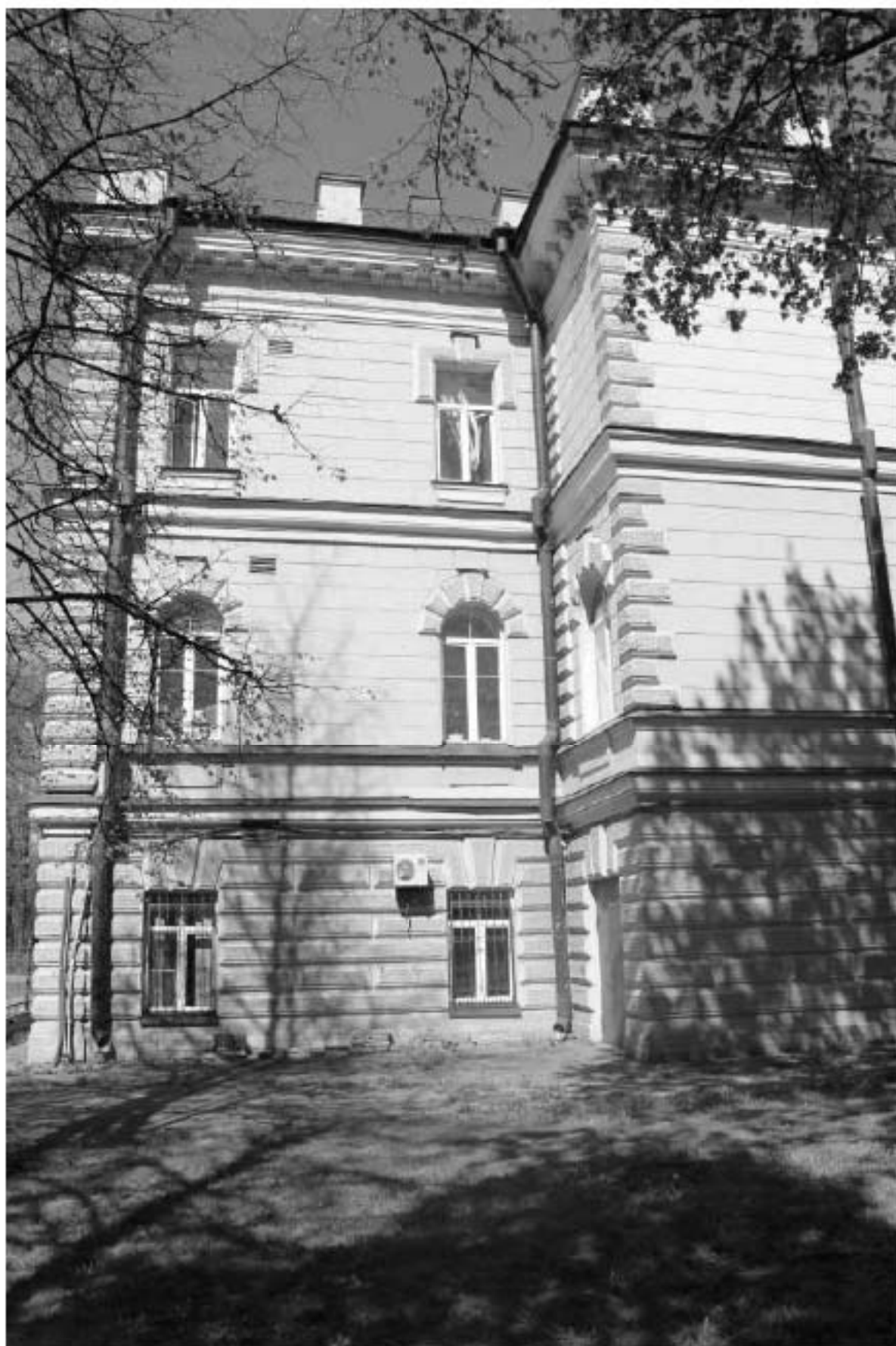
Фото 125. Вид на южный фасад выявленного объекта культурного наследия «Амбулаторный корпус». Фото 12.05.2023 г.
