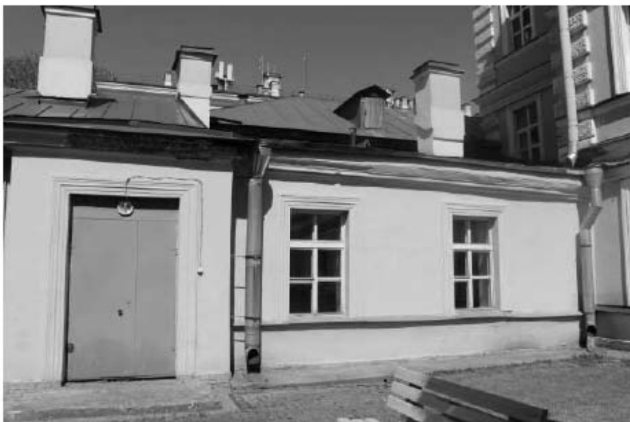
Фото 48. Вид на южный фасад переходной галерей выявленного объекта культурного наследия «Кухонный корпус с переходной галереей». Фото 12.05.2023 г.
