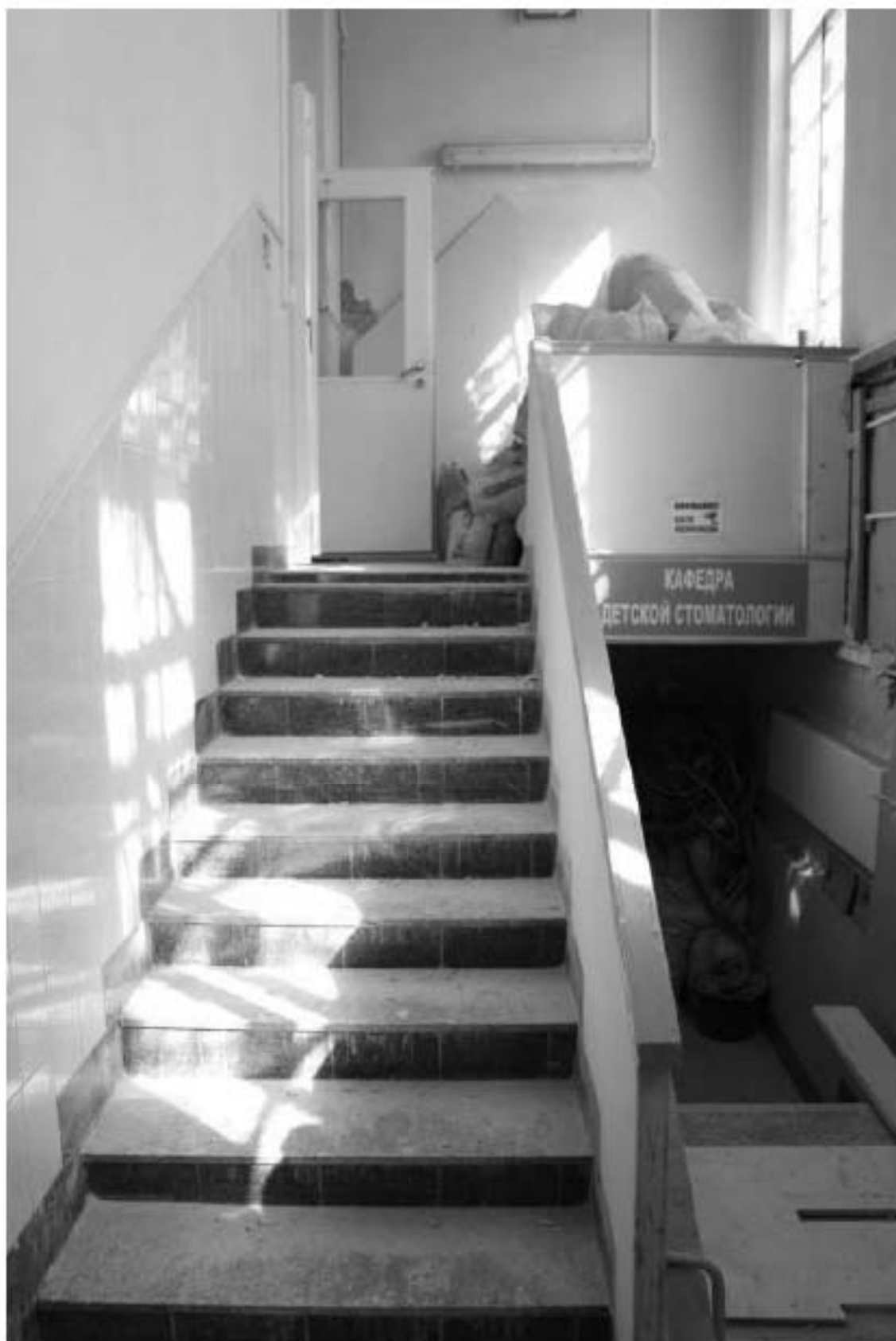
Фото 150. Лестница в пристройке к выявленному объекту культурного наследия «Изоляционный павильон». Фото 12.05.2023 г.
