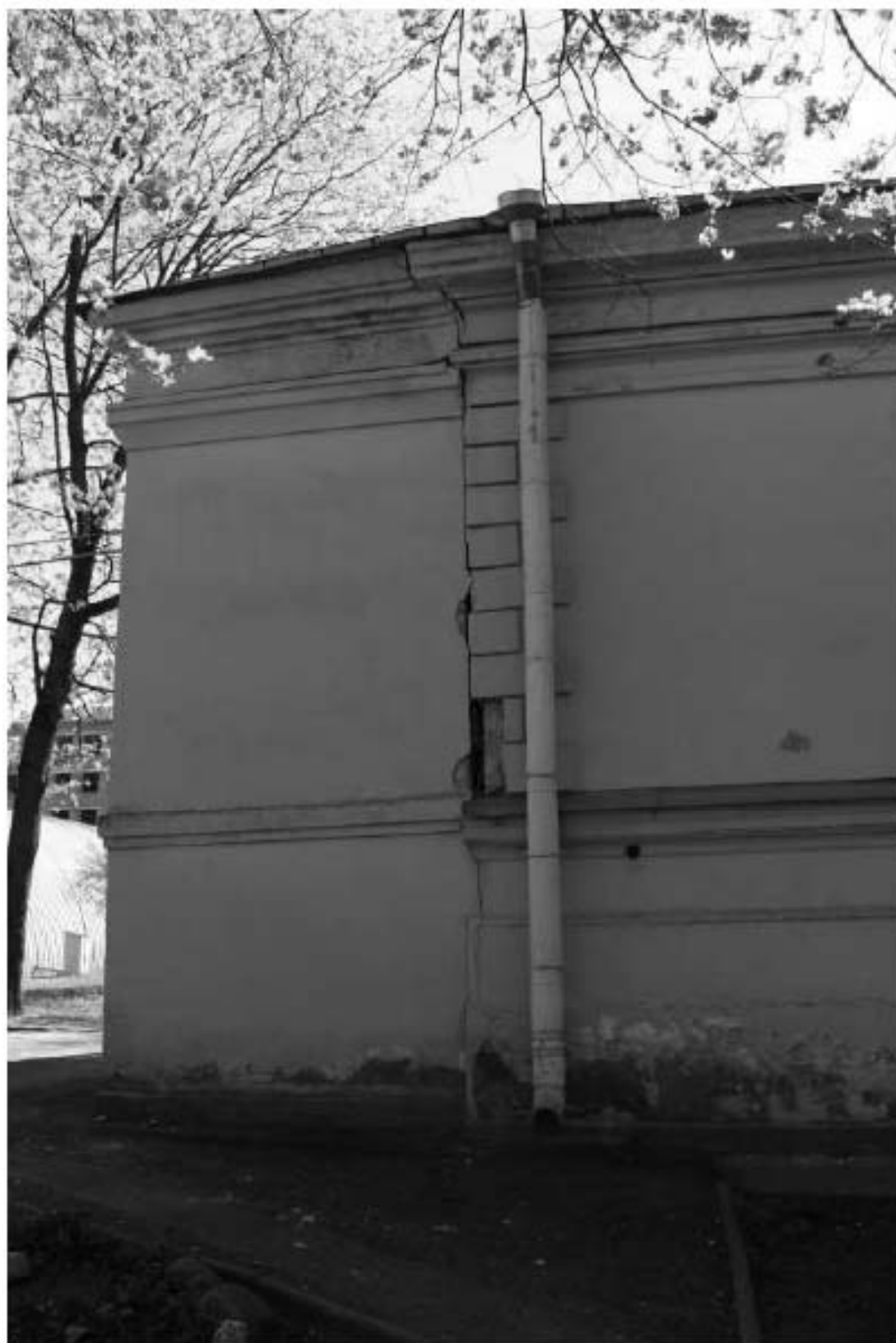
Фото 148. Вид на северный фасад пристройки к выявленному объекту культурного наследия «Изоляционный павильон». Фото 12.05.2023 г.
