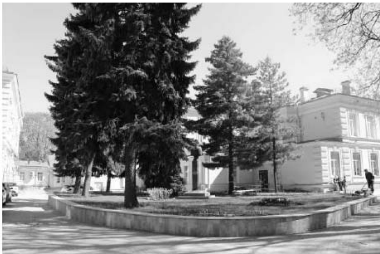
Фото 213. Вид на северо-западную часть территории выявленного объекта культурного наследия «Сад». Фото 12.05.2023 г.
