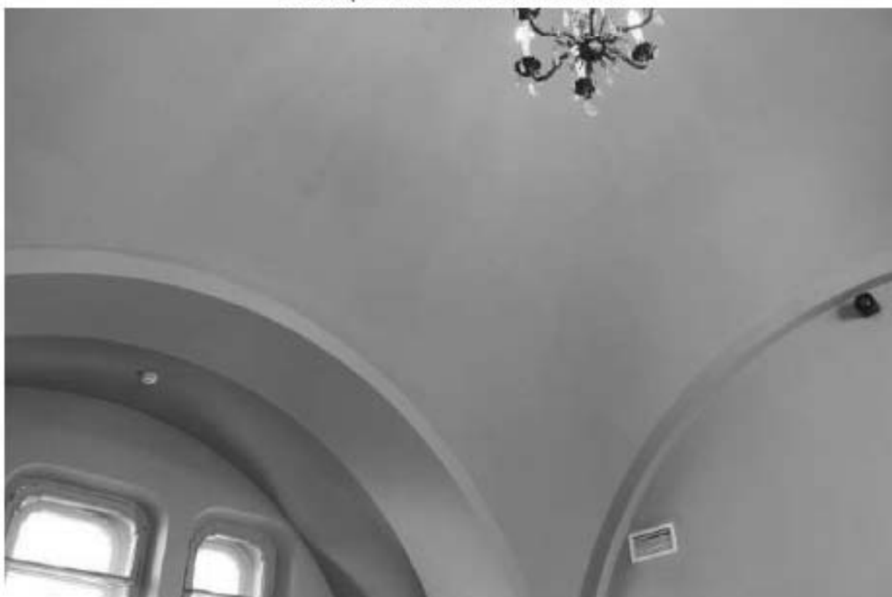
Фото 184. Выявленный объект культурного наследия «Часовня». Внутренние помещения. Фото 12.05.2023 г.
