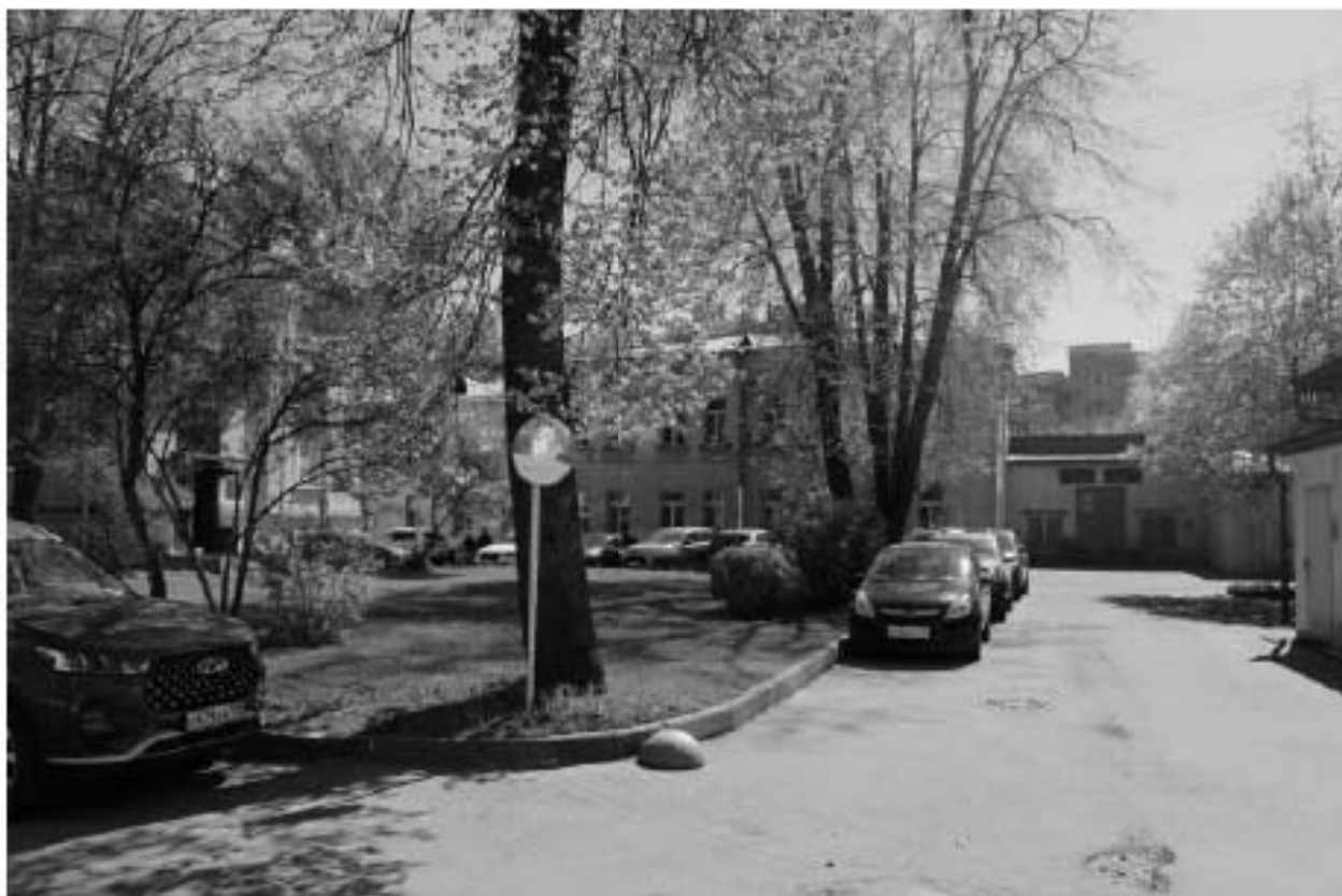
Фото 199. Вид на южную часть территории выявленного объекта культурного наследия «Сад». Фото 12.05.2023 г.
