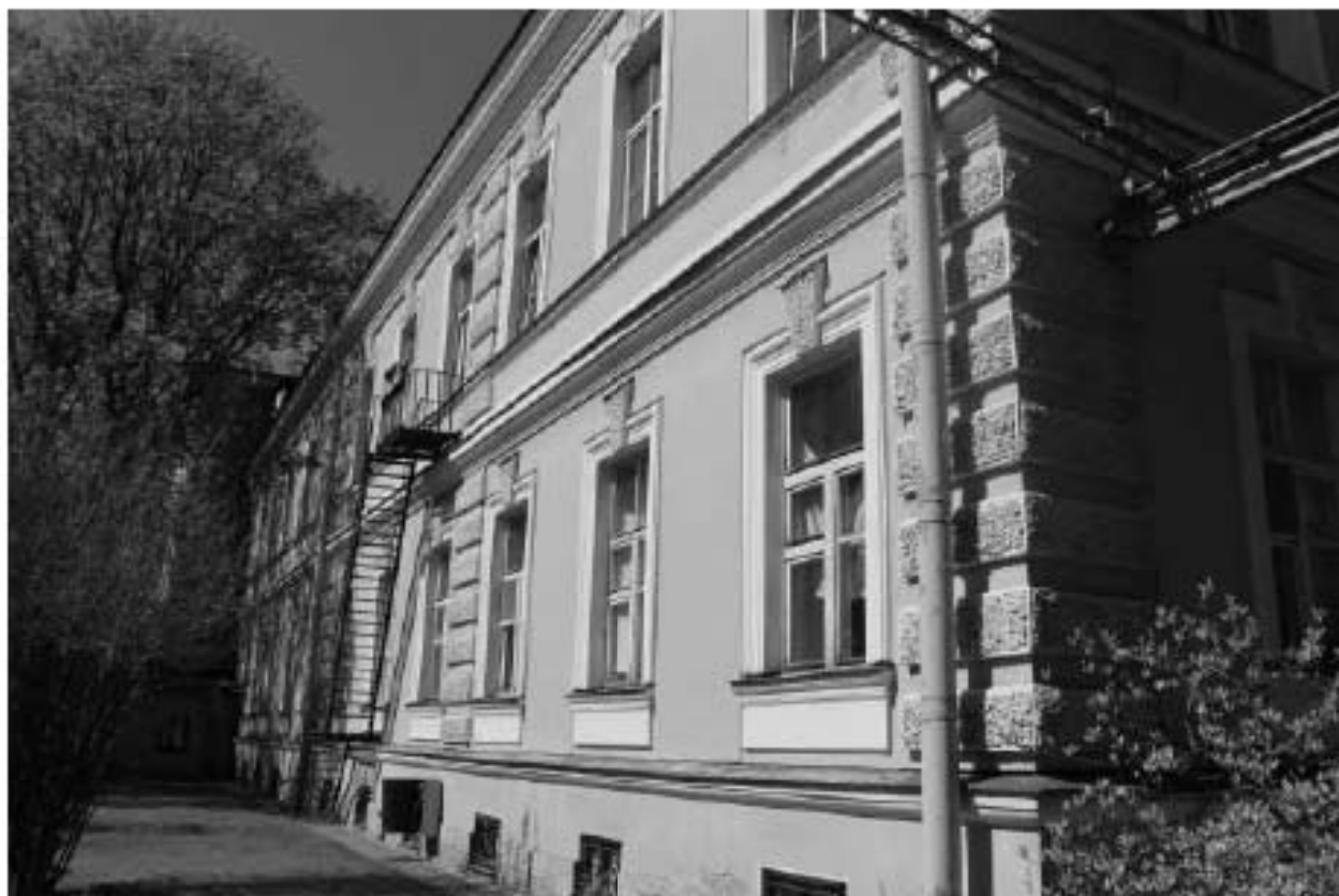
Фото 12. Вид на южный фасад восточного крыла выявленного объекта культурного наследия «Главное здание». Фото 12.05.2023 г.
