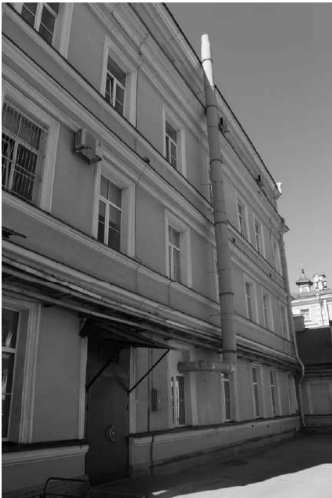
Фото 45. Вид на восточный фасад выявленного объекта культурного наследия «Кухонный корпус с переходной галереей». Фото 12.05.2023 г.
