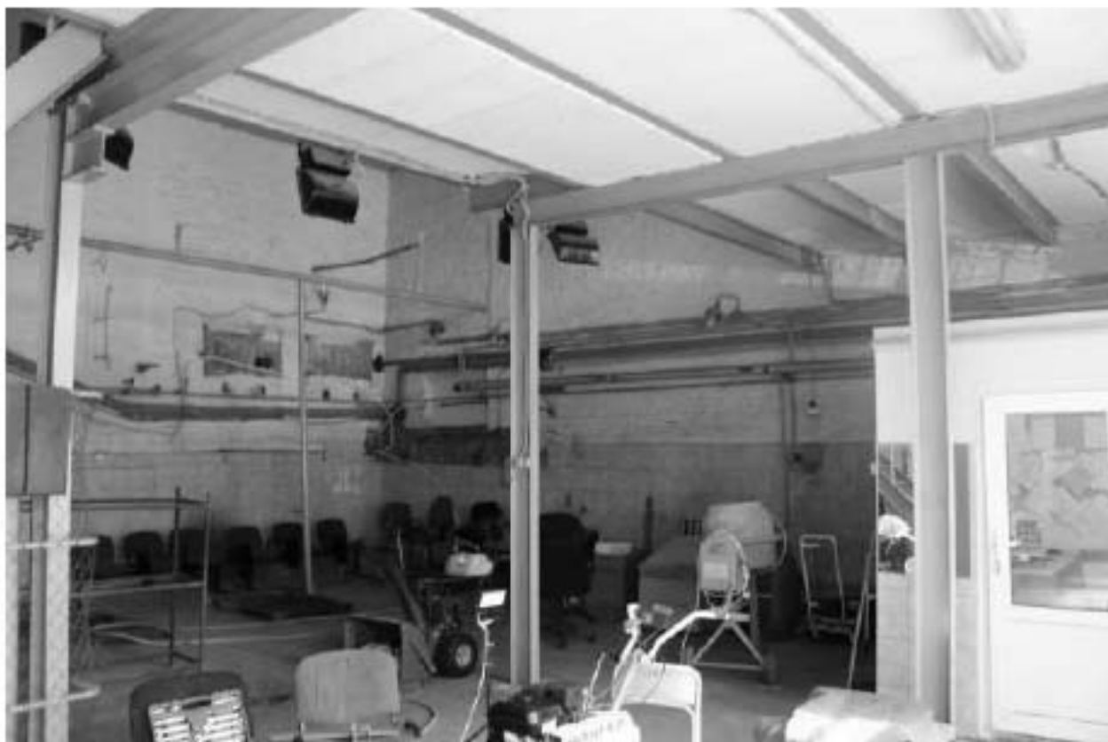
Фото 69. Выявленный объект культурного наследия «Котельная». Внутренние помещения. Фото 12.05.2023 г.
