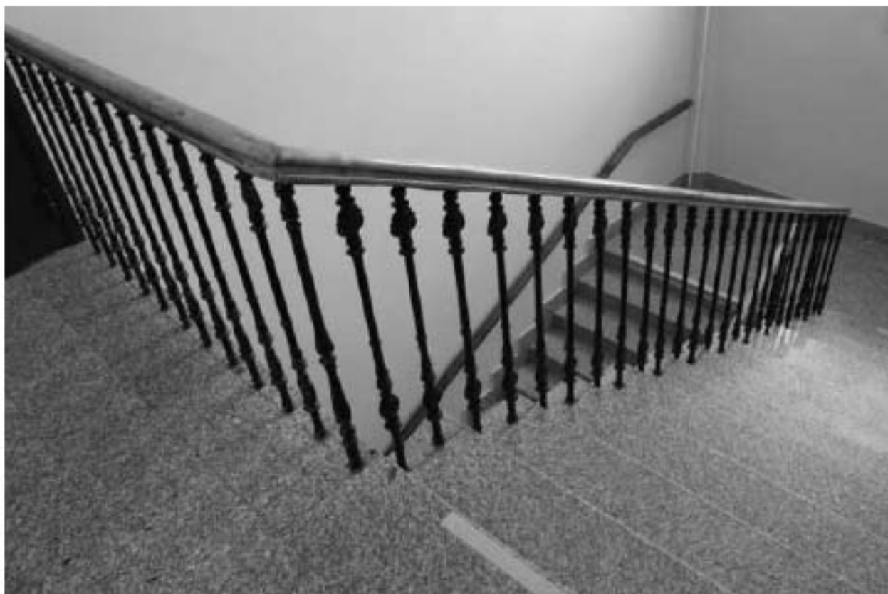
Фото 85. Выявленный объект культурного наследия «Павильон гинекологических и глазных болезней с переходной галереей». 2ЛК. Вид на лестницу в уровне 2-го этажа. Фото 12.05.2023 г
