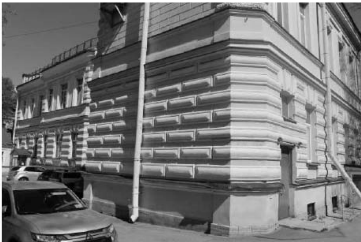
Фото 91. Вид на западный фасад выявленного объекта культурного наследия «Павильон-приют им. Н.И. Жуковской с переходной галереей». Фото 12.05.2023 г.
