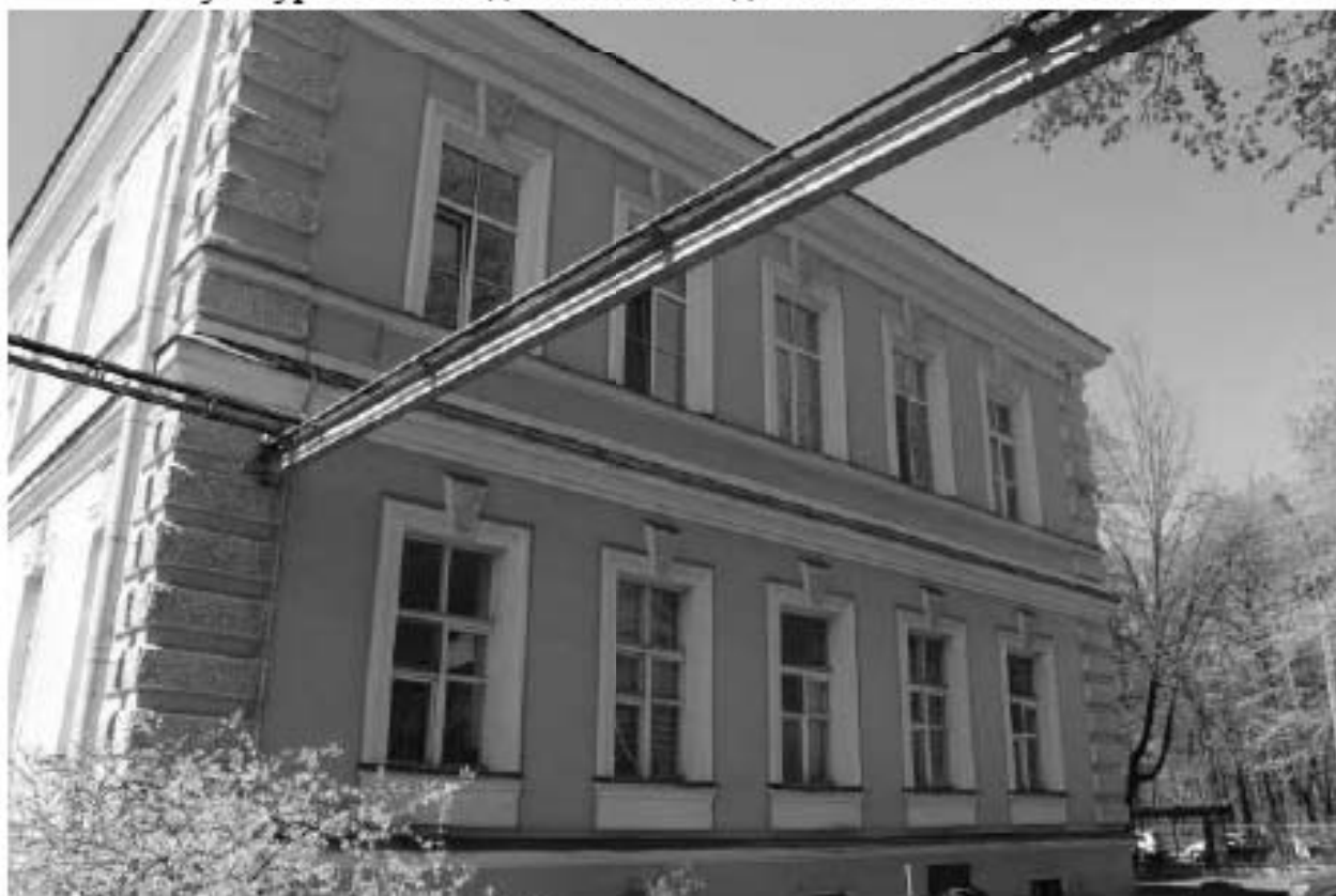
Фото 13. Вид на восточный фасад восточного крыла выявленного объекта культурного наследия «Главное здание». Фото 12.05.2023 г.
