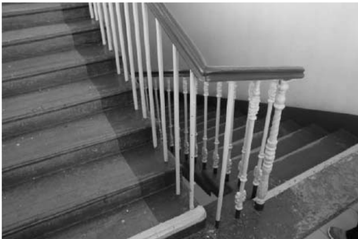
Фото 56. Выявленный объект культурного наследия «Кухонный корпус с переходной галереей». 2ЛК. Вид на лестницу в уровне 3-го этажа. Фото 12.05.2023 г.
