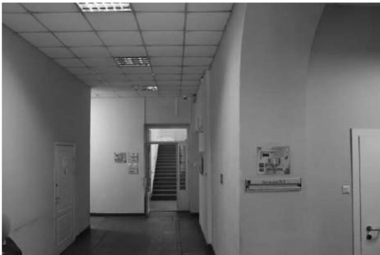
Фото 127. Выявленный объект культурного наследия «Амбулаторный корпус». Внутренние помещения 1-го этажа. Фото 12.05.2023 г.
