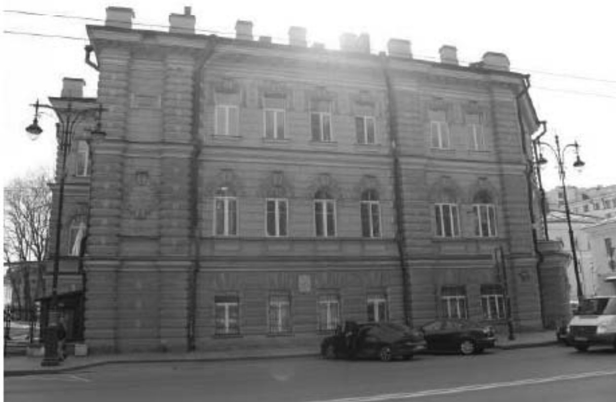
Фото 120. Вид на северный фасад выявленного объекта культурного наследия «Амбулаторный корпус». Фото 17.04.2023 г.
