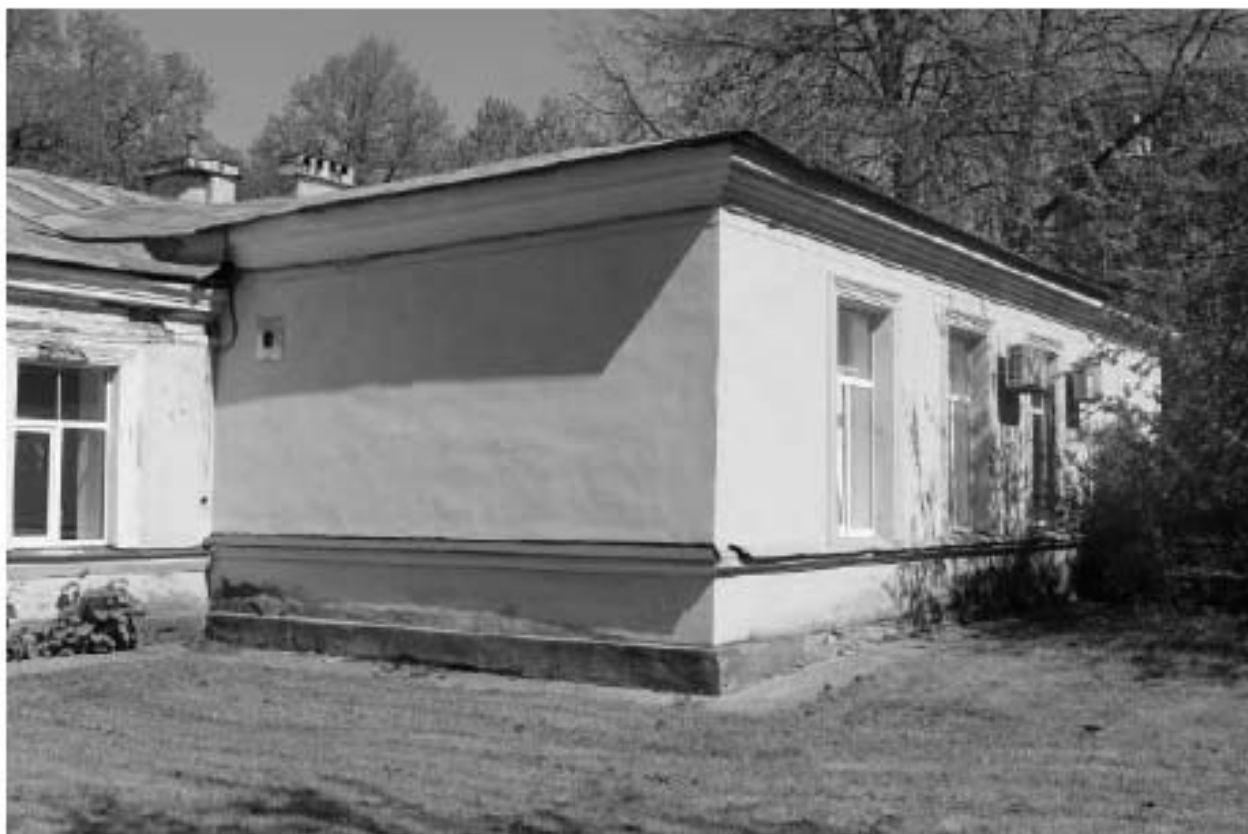
Фото 110. Вид на пристройку к выявленному объекту культурного наследия «Операционный павильон с переходной галереей». Фото 12.05.2023 г.
