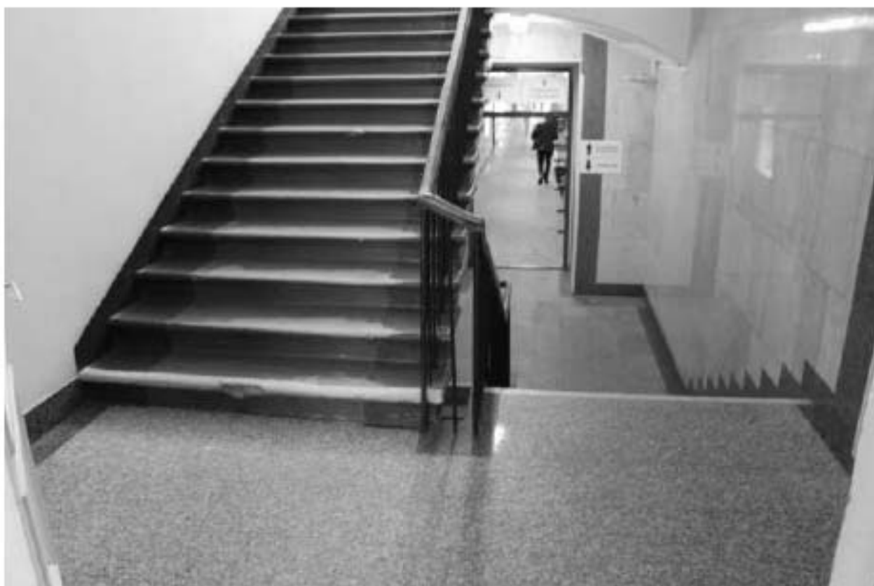
Фото 36. Выявленный объект культурного наследия «Главное здание». 2ЛК. Вид на лестницу в уровне 1-го этажа. Фото 12.05.2023 г.
