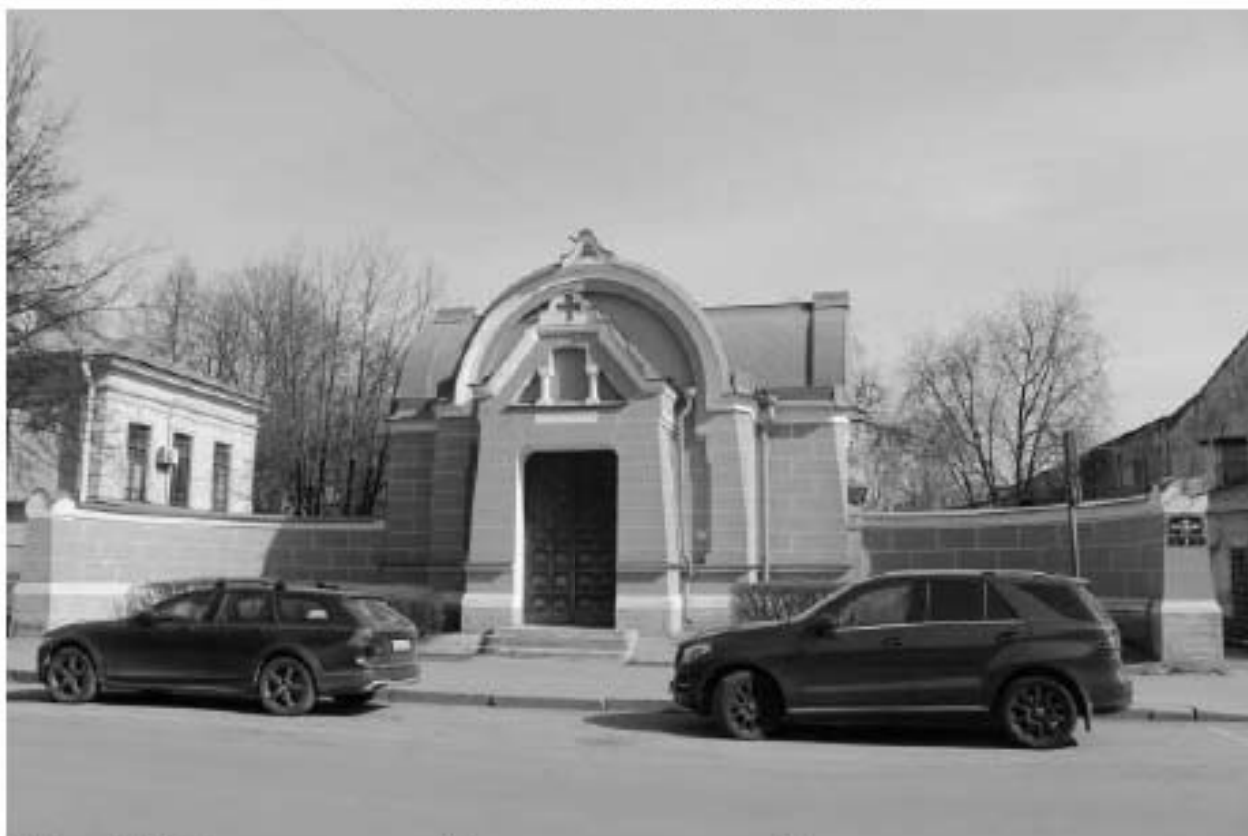
Фото 175. Вид на западный фасад выявленного объекта культурного наследия «Часовня». Фото 17.04.2023 г.
