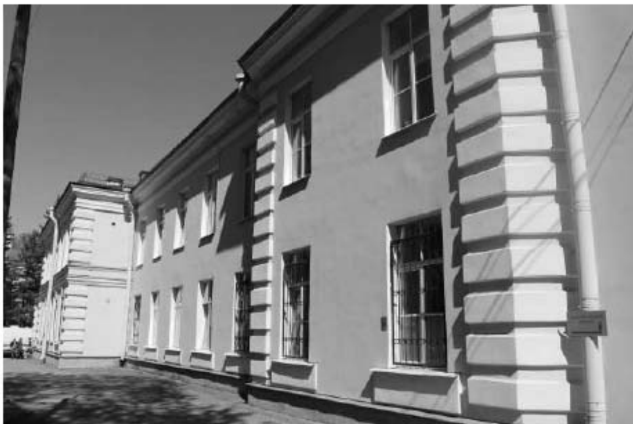
Фото 77. Вид на западный фасад выявленного объекта культурного наследия «Павильон гинекологических и глазных болезней с переходной галереей». Фото 12.05.2023 г.
