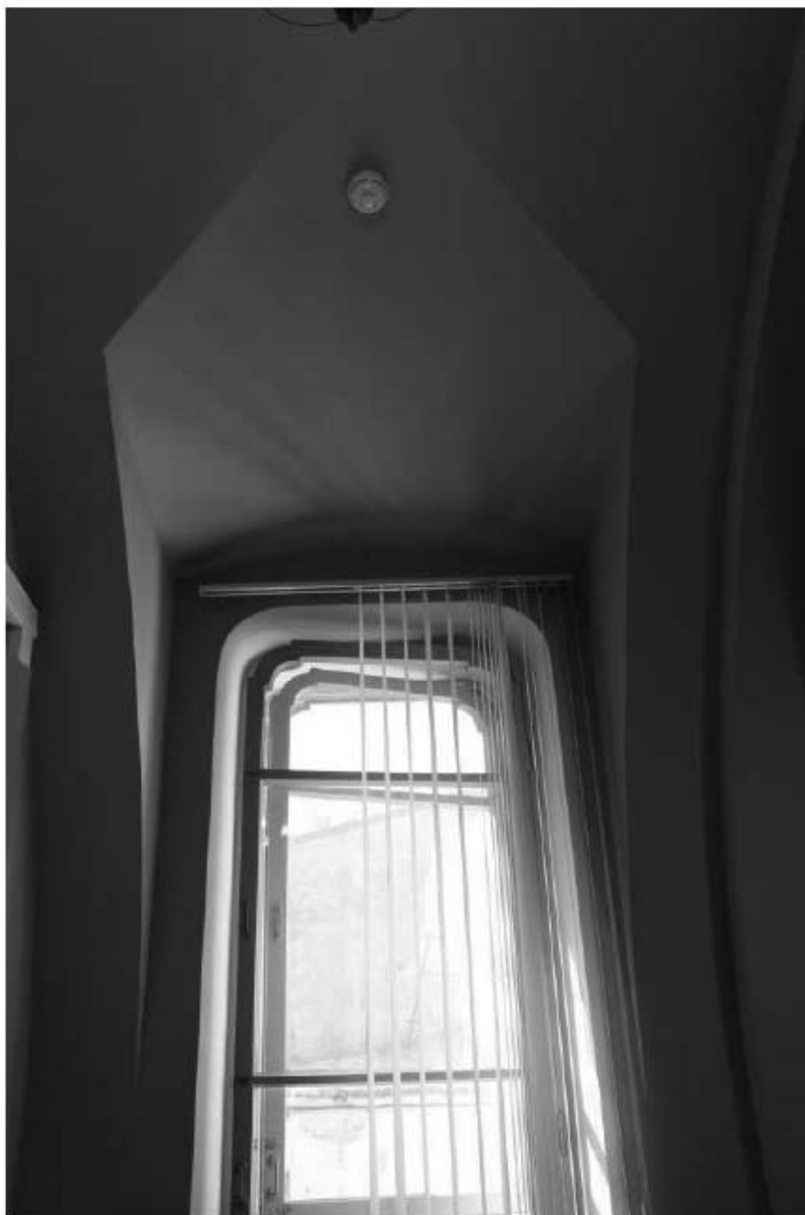
Фото 185. Выявленный объект культурного наследия «Часовня». Внутренние помещения. Фото 12.05.2023 г.
