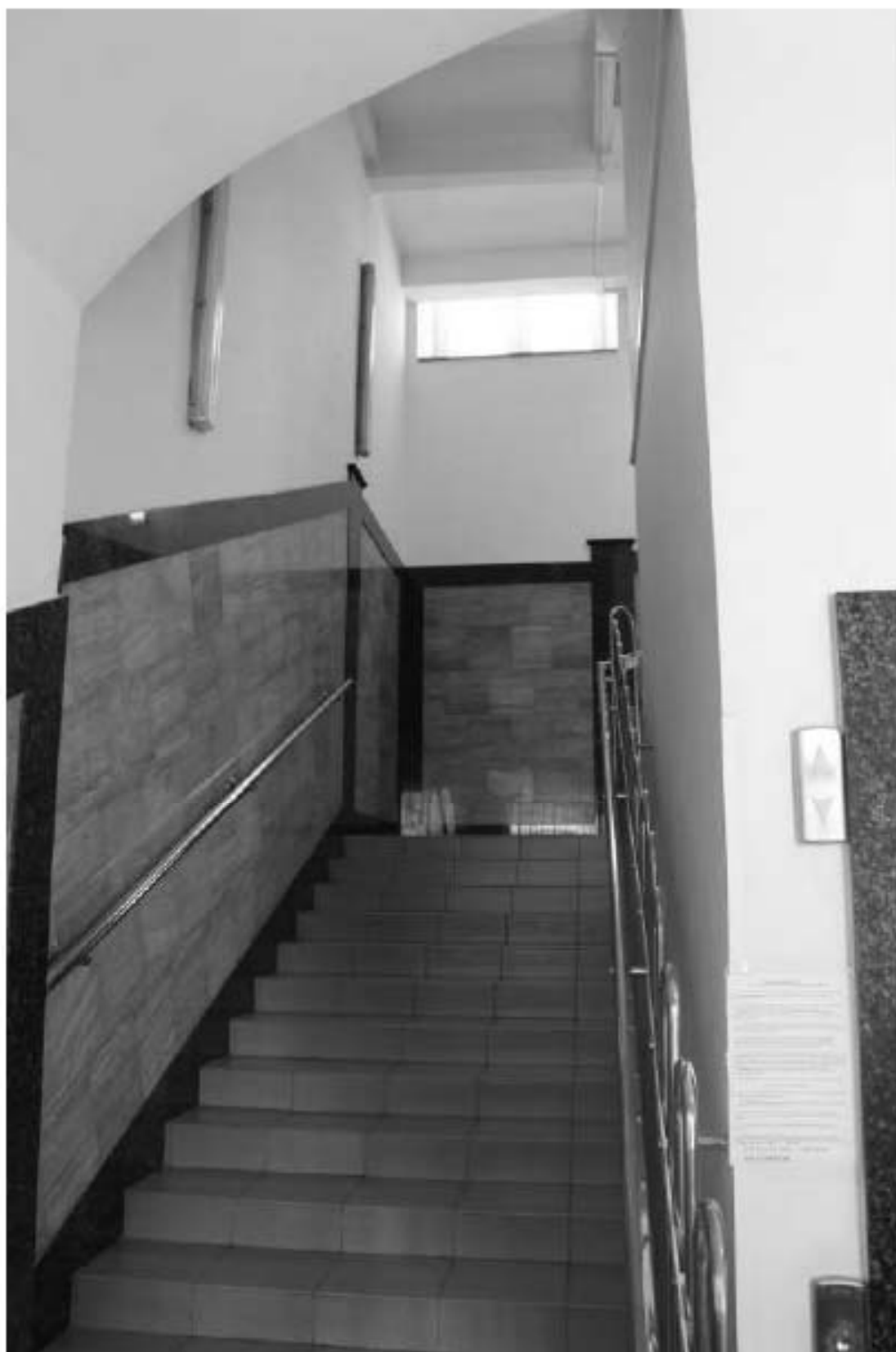
Фото 101. Выявленный объект культурного наследия «Павильон-приют им. Н.И. Жуковской с переходной галереей». ЗЛК. Междуэтажная площадка в уровне 2-го – 3-го этажей. Фото 12.05.2023 г.
