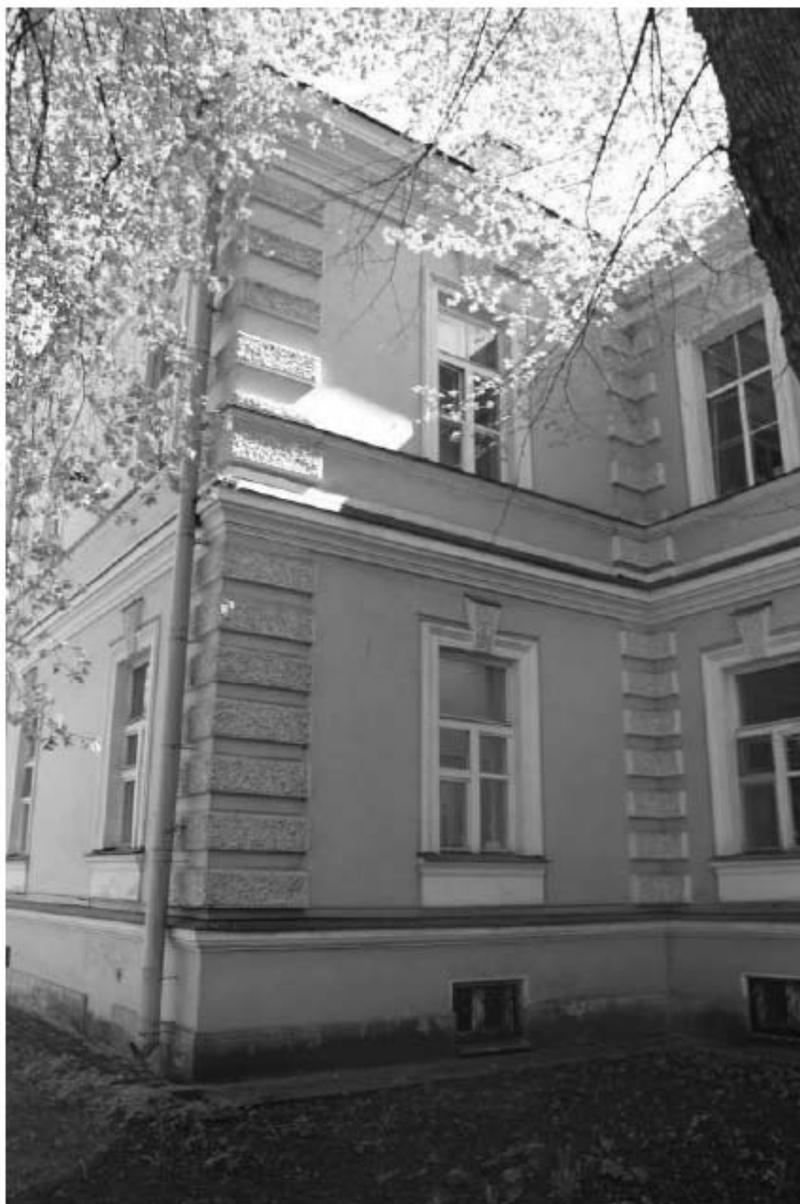
Фото 15. Вид на западный фасад ризалита восточного крыла выявленного объекта культурного наследия «Главное здание». Фото 12.05.2023 г.
