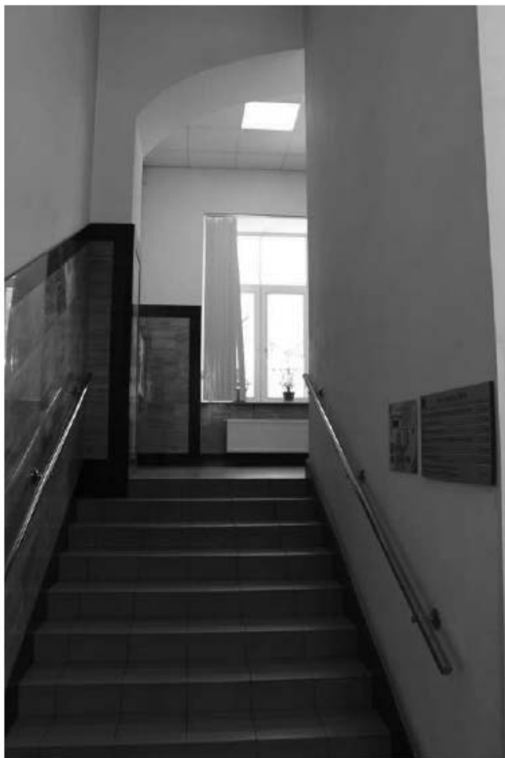
Фото 100. Выявленный объект культурного наследия «Павильон-приют им. Н.И. Жуковской с переходной галереей». ЗЛК. Лестничная площадка в уровне 2-го этажа. Фото 12.05.2023 г.
