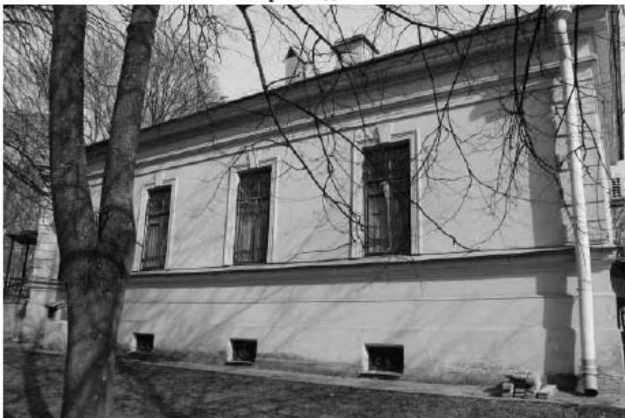
Фото 142. Вид на западный фасад выявленного объекта культурного наследия «Изоляционный павильон». Фото 17.04.2023 г.
