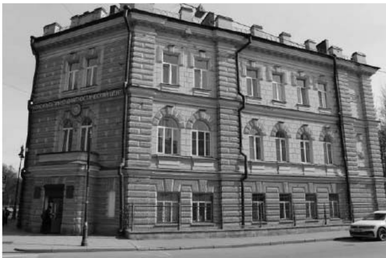
Фото 119. Вид на западный фасад выявленного объекта культурного наследия «Амбулаторный корпус». Фото 17.04.2023 г.
