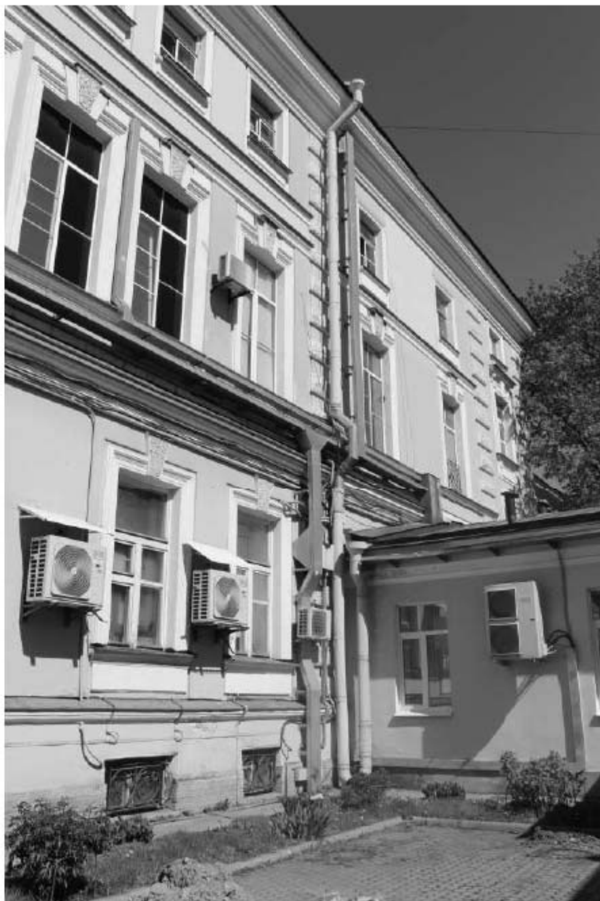
Фото 9. Вид на южный фасад центрального корпуса выявленного объекта культурного наследия «Главное здание». Фото 12.05.2023 г.
