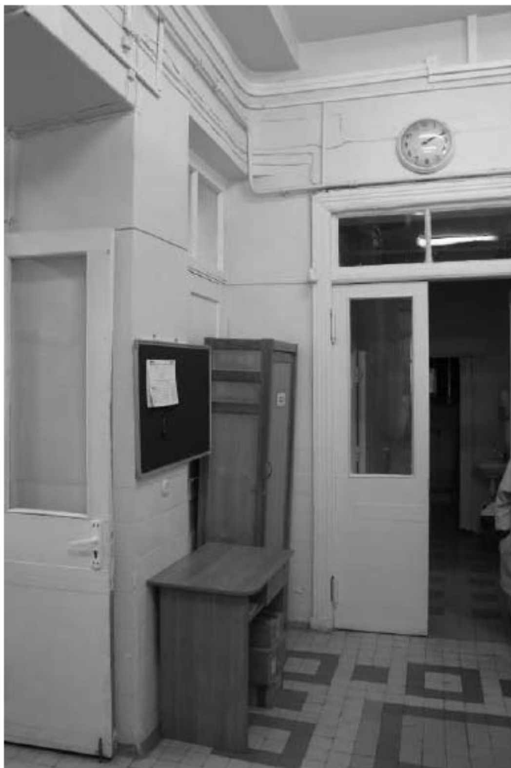
Фото 117. Выявленный объект культурного наследия «Операционный павильон с переходной галереей». Внутренние помещения. Фото 12.05.2023 г.
