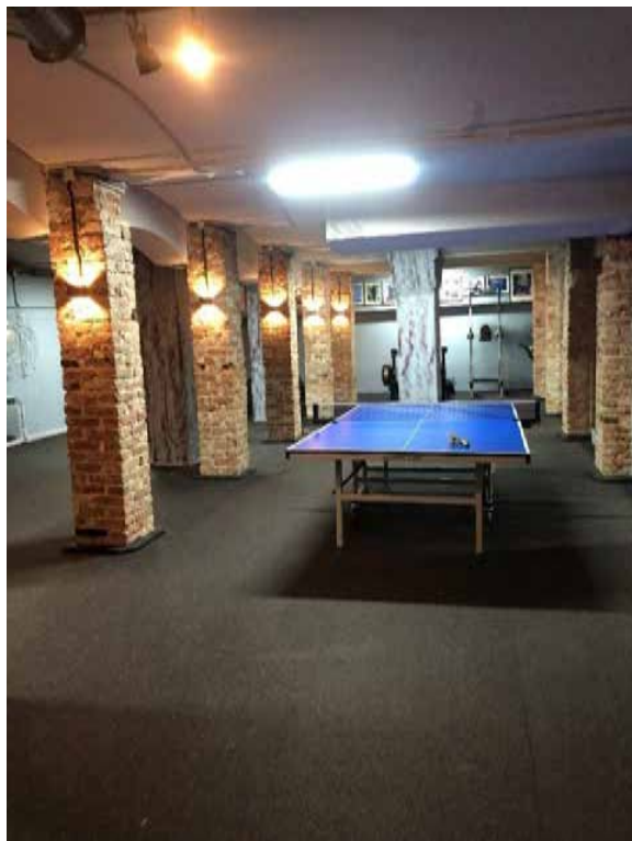
Фото 5. Вид на подвальное помещение 1Н (21). Автор фото: Штиглиц М.С. Дата: 17.04.2023.
