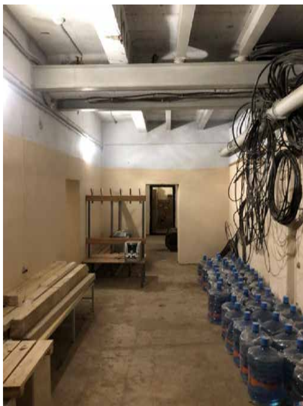
Фото 3. Вид на подвальное помещение. Автор фото: Штиглиц М.С. Дата: 17.04.2023.
