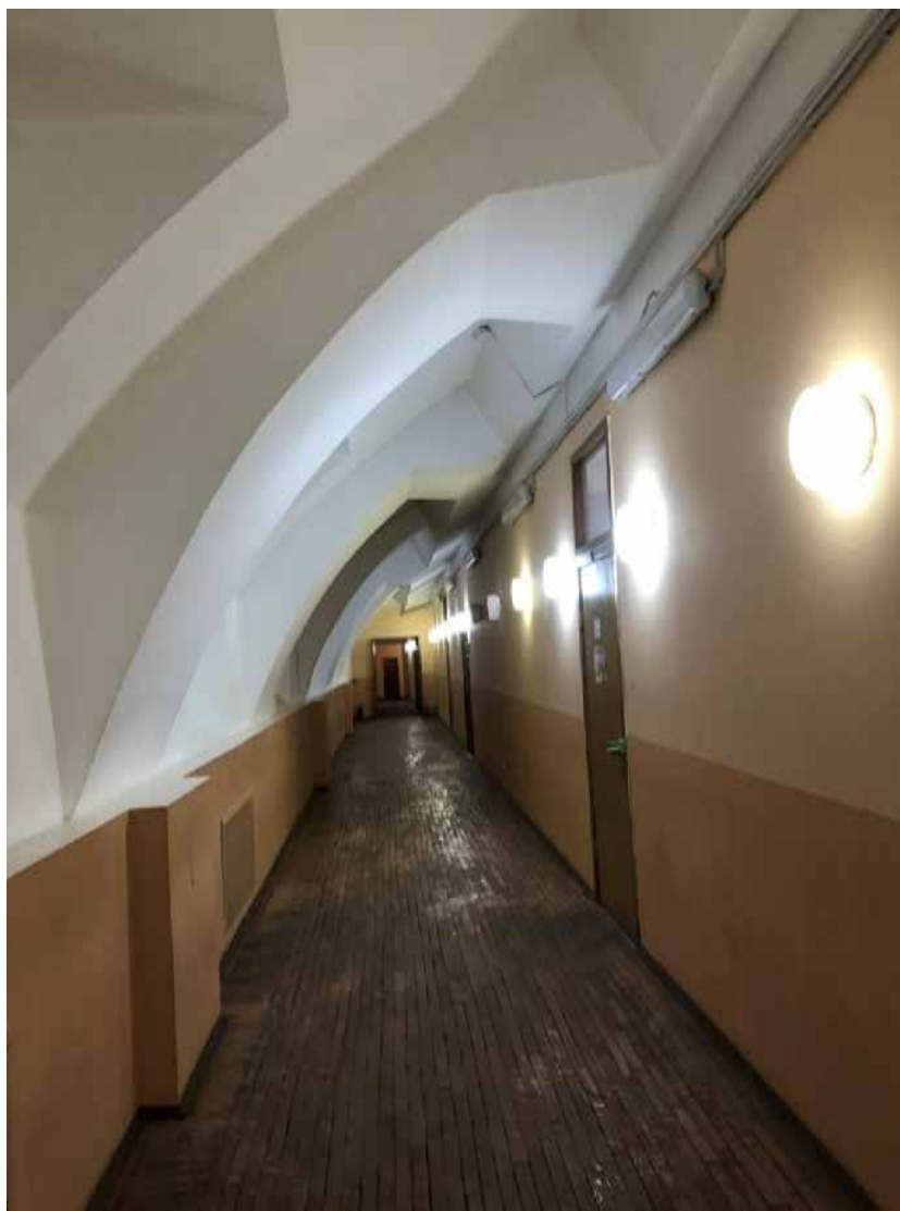
Фото 30. Пятый этаж. Вид на коридор. Автор фото: Штиглиц М.С. Дата: 17.04.2023.
