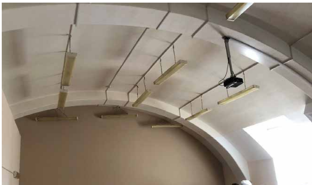
Фото 31. Пятый этаж. Вид на свод аудитории. Автор фото: Штиглиц М.С. Дата: 17.04.2023.
