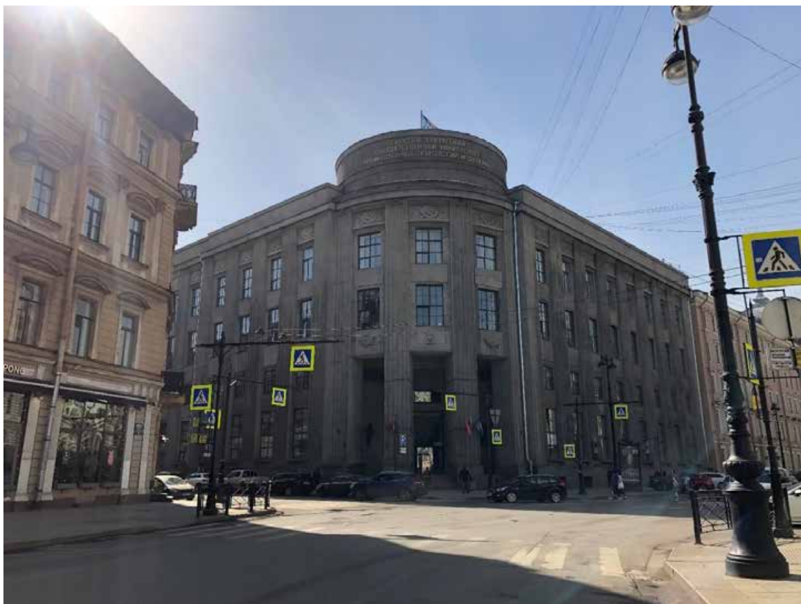
Фото 1. Вид на здание с пересечения Большой Морской улицы и Кирпичного переулка. Автор фото: Штиглиц М.С. Дата: 17.04.2023.
