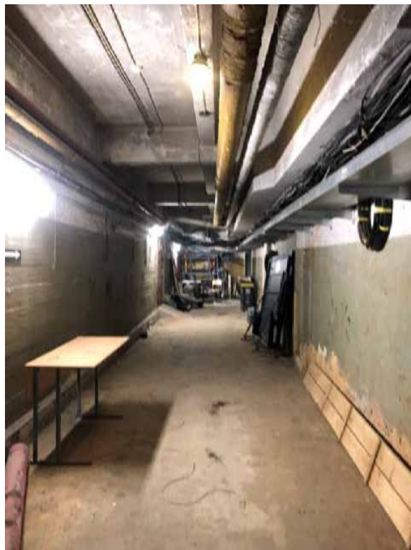
Фото 2. Вид на подвальное помещение. Автор фото: Штиглиц М.С. Дата: 17.04.2023.
