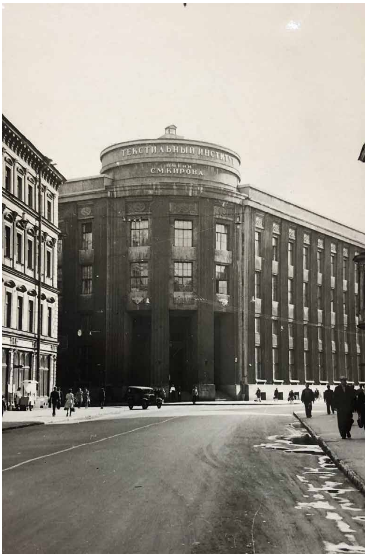
Илл. 42. Текстильный институт на ул. Герцена. Дата: 1962 г. Источник: архив КГИОП.
