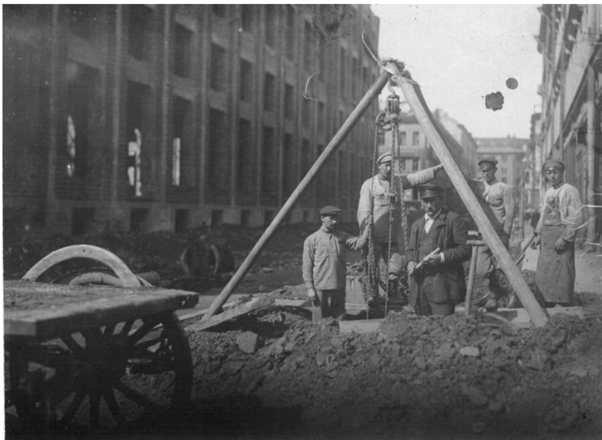
Илл. 28. Восстановление Петрограда. Ремонт подземных коммуникаций. Дата: 1922 г. Источник: госкаталог.рф, № 5442445.
