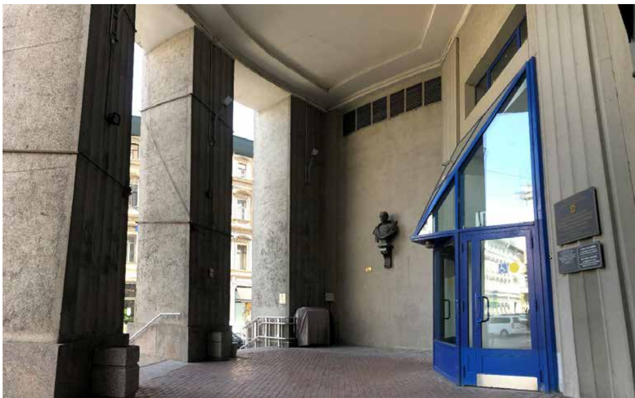
Фото 5. Вид на входную группу объекта культурного наследия. Автор фото: Штиглиц М.С. Дата: 17.04.2023.
