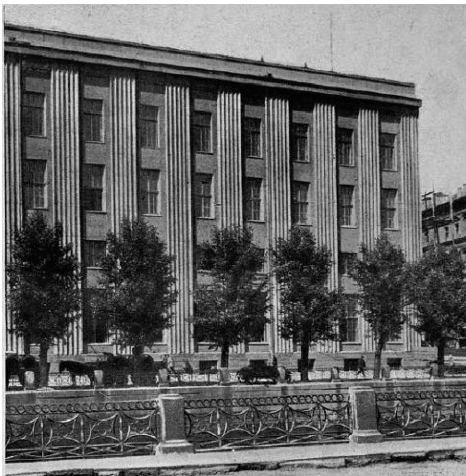
Илл. 35. Вид на фасад со стороны Мойки. Источник: Выкопировка из журнала «Архитектура СССР», 1934 (№ 10).
