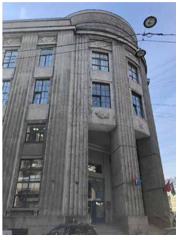
Фото 4. Вид на фрагмент исследуемого объекта (входная группа). Автор фото: Штиглиц М.С. Дата: 17.04.2023.
