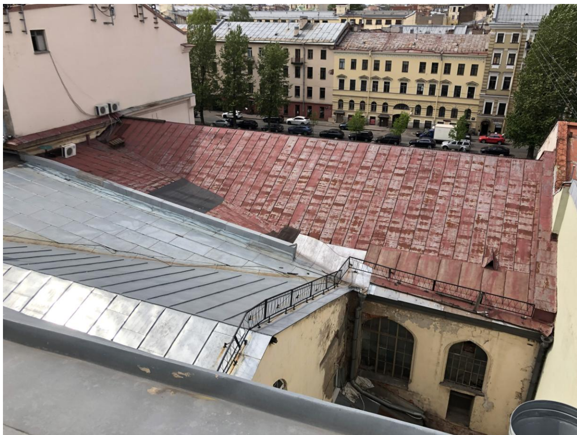
Фото 31. Вид на крышу объекта.
