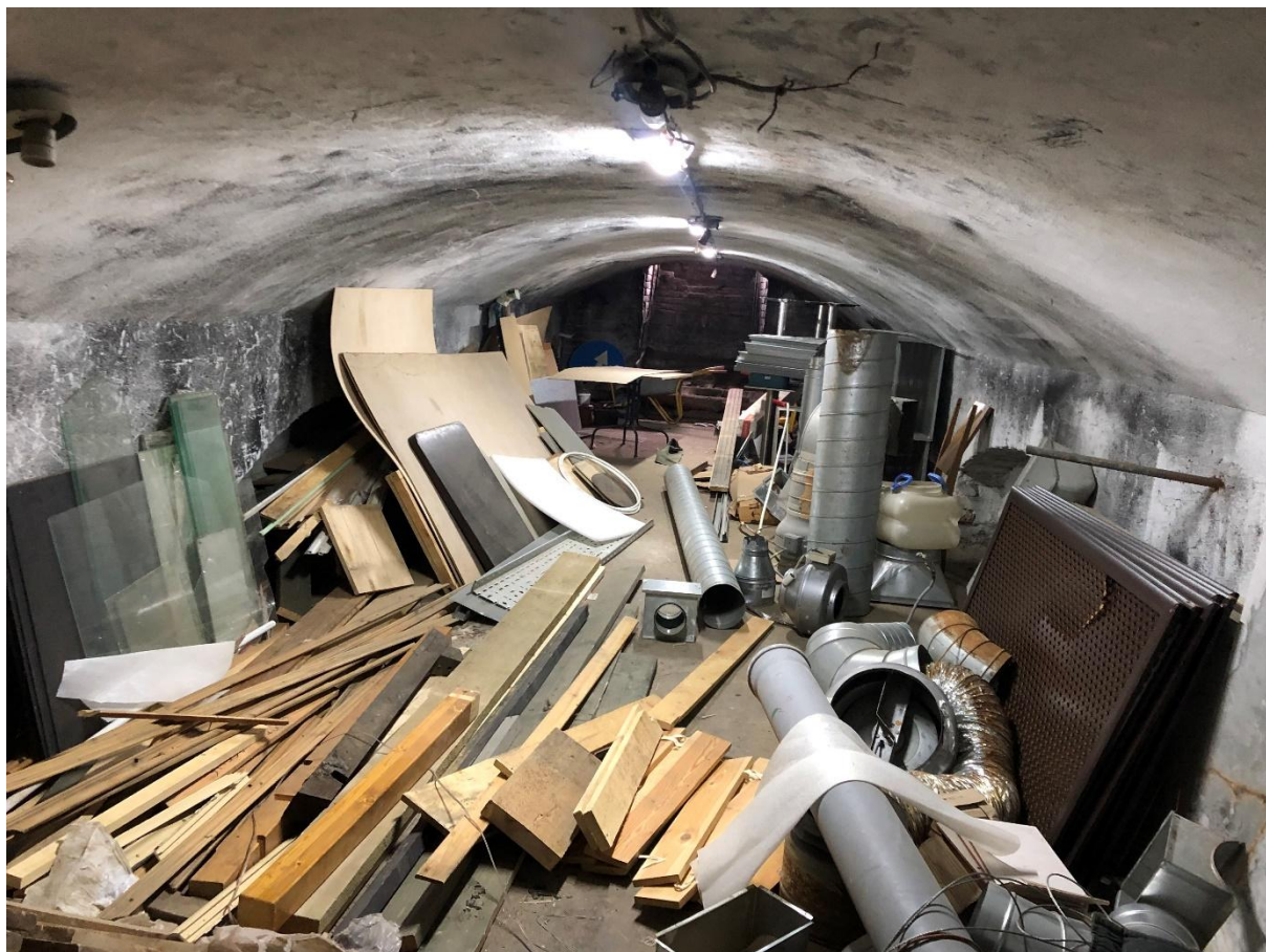
Фото 2. Вид на подвальное помещение.
