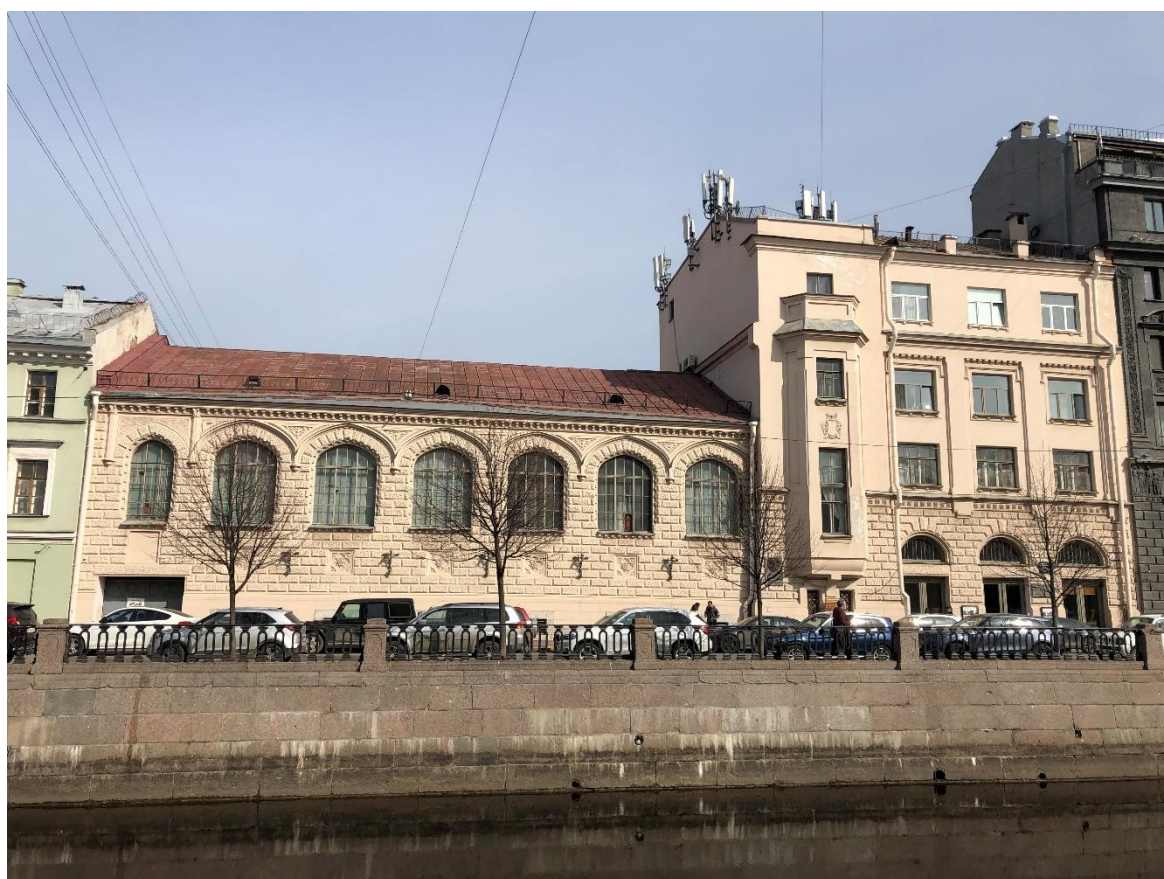
Фото 4. Вид на исследуемое здание с противоположной стороны Крюкова канала.
