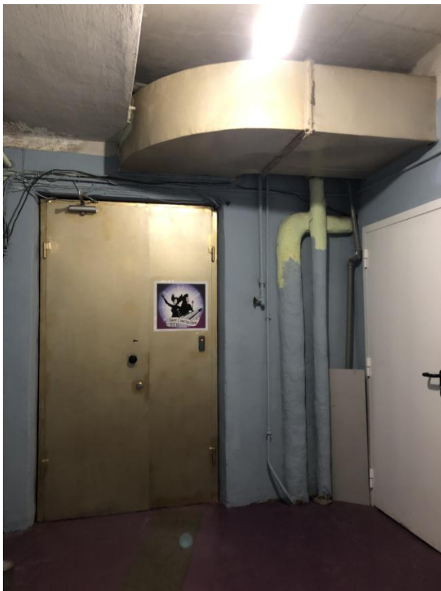
Фото 27. Вид на помещение пятого этажа.
