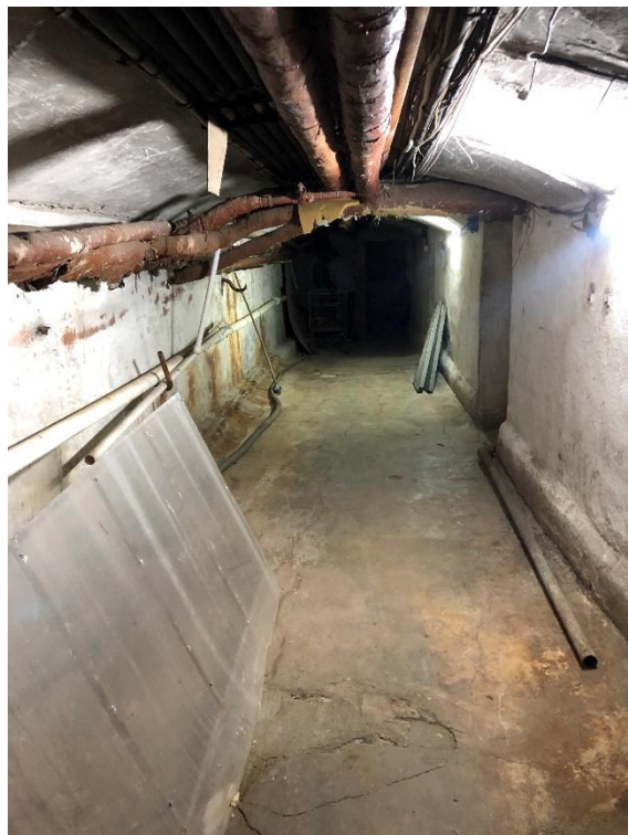
Фото 4. Вид на подвальное помещение.
