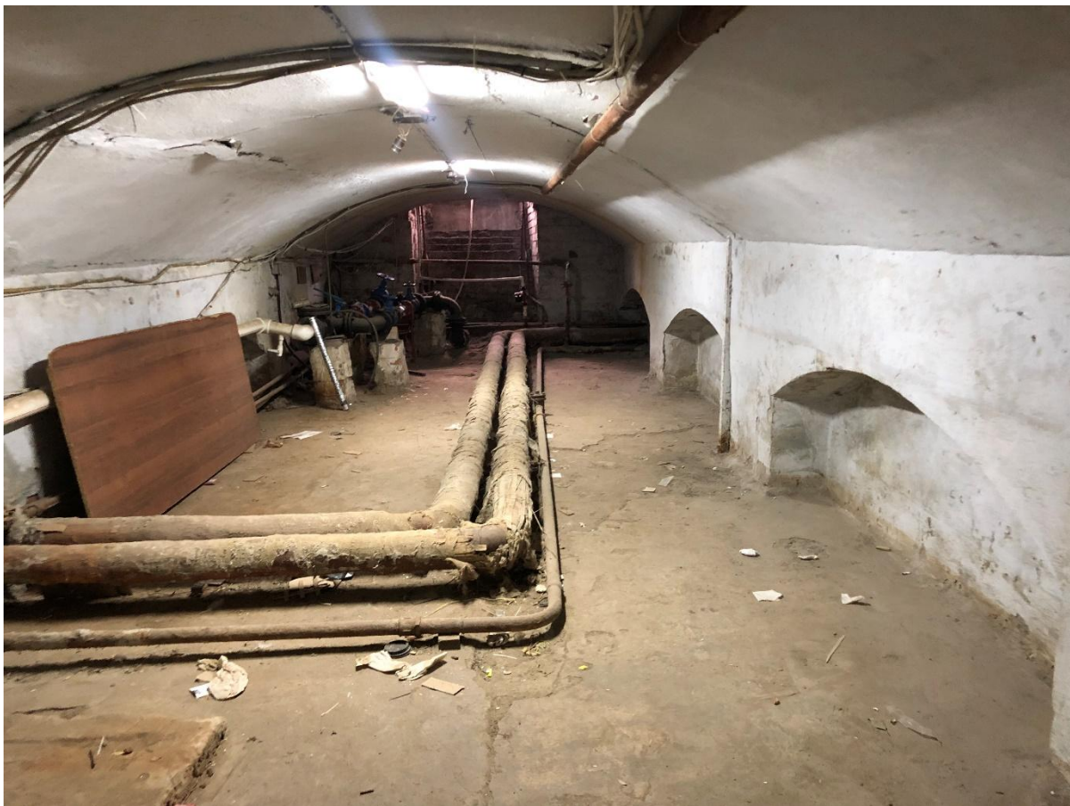
Фото 1. Вид на подвальное помещение.
