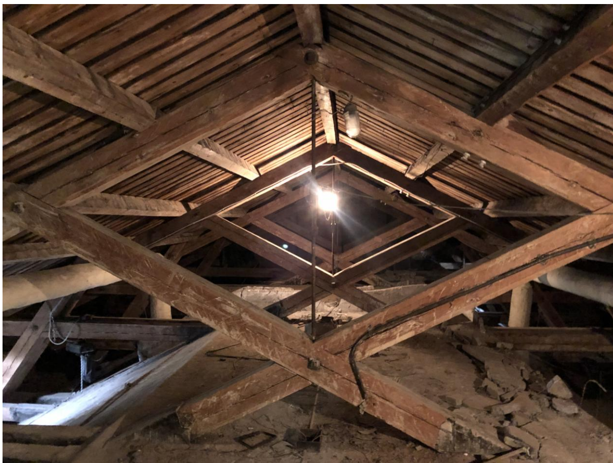
Фото 30. Вид на чердачное помещение над манежем.
