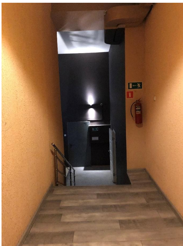
Фото 21. Вид на помещение второго этажа.
