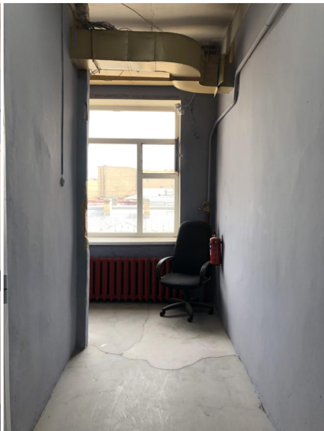
Фото 28. Вид на помещение шестого этажа.
