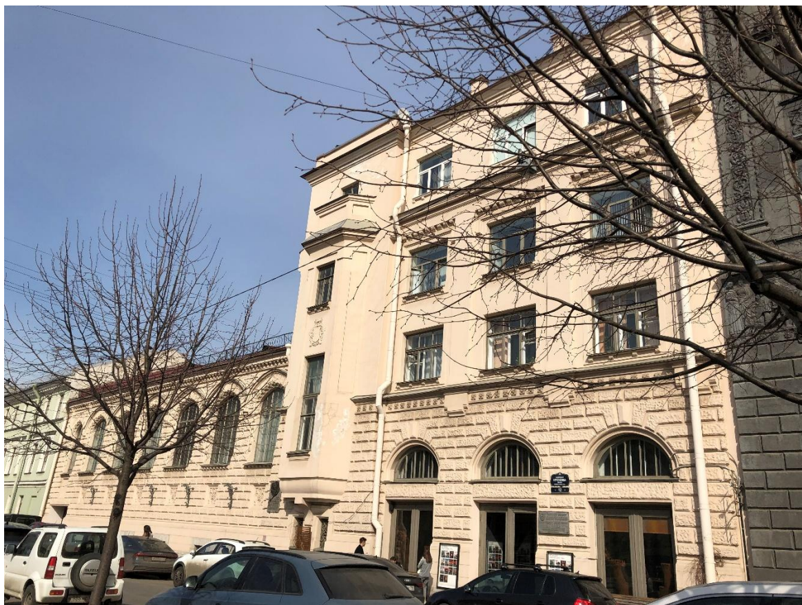
Фото 3. Вид на дом № 12 по набережной Крюкова канала.
