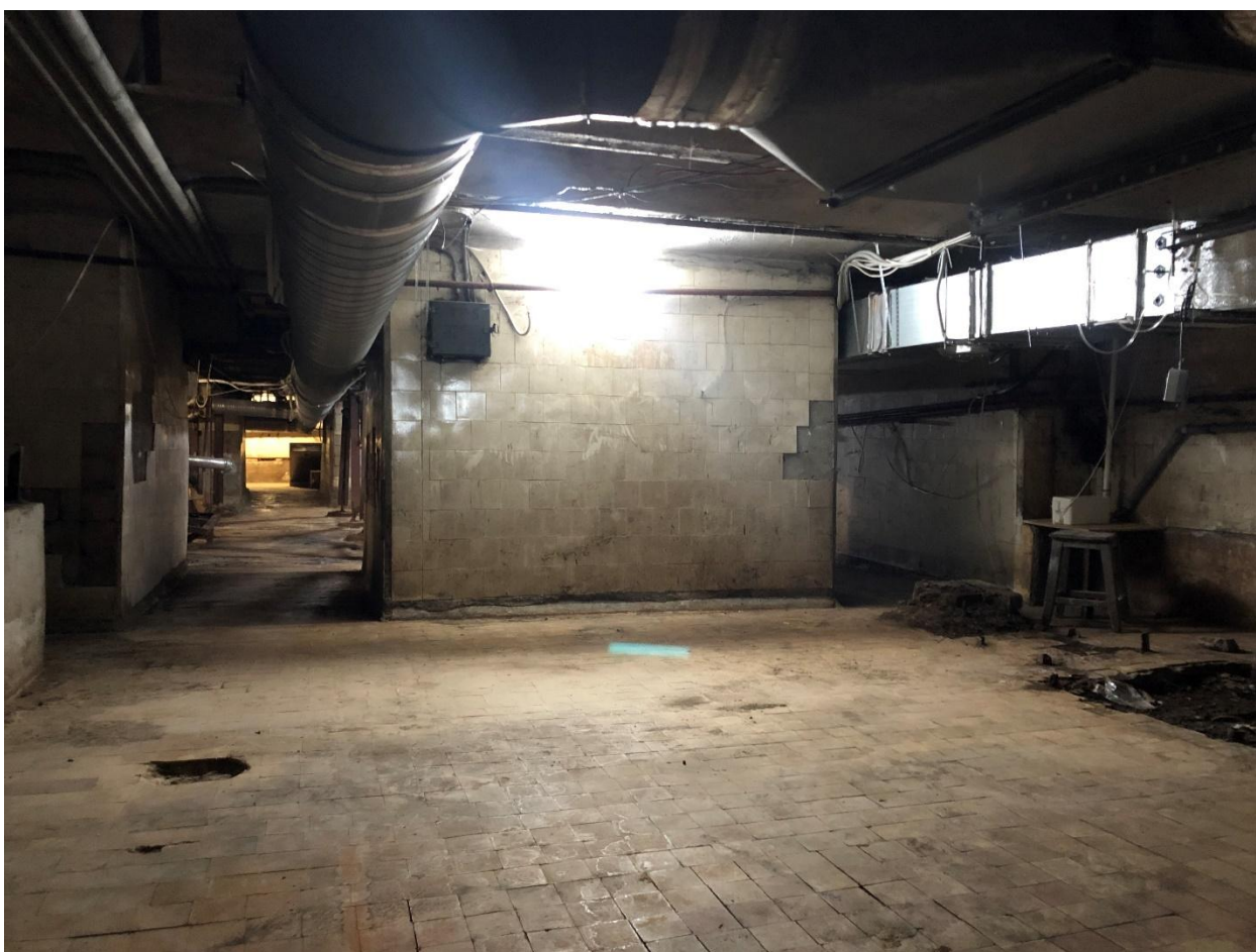
Фото 5. Вид на подвальное помещение.
