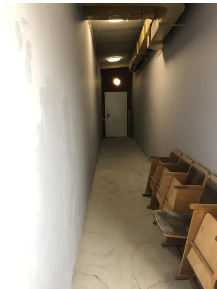
Фото 29. Вид на помещение шестого этажа.
