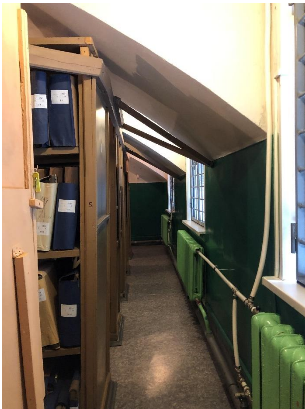
Фото 16. Первый этаж. Помещение № 4 (8-Н).
