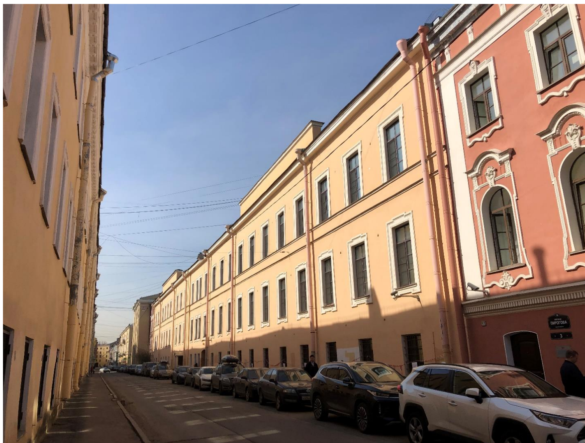
Фото 3. Перспективный вид лицевого фасада. Лицевой фасад выявленного объекта культурного наследия «Корпус по Максимилиановскому переулку», расположенный по адресу: пер. Пирогова, 5.
