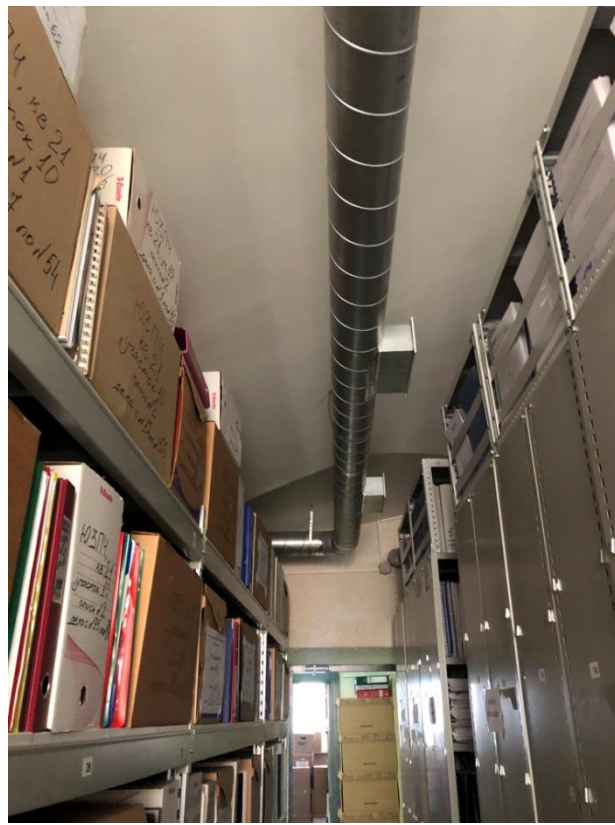
Фото 8. Первый этаж. Помещение № 15 (7-Н).
