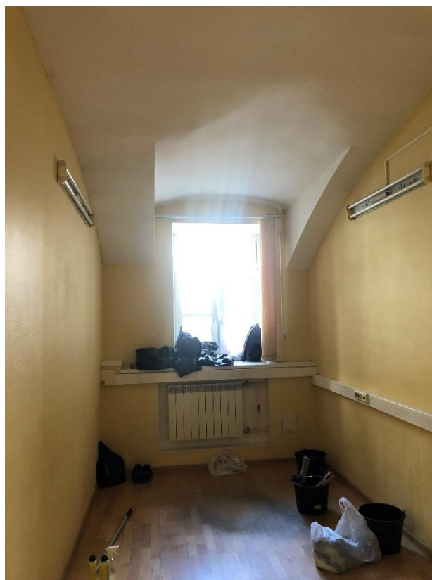
Фото 6. Первый этаж. Помещение № 24 (7-Н).
