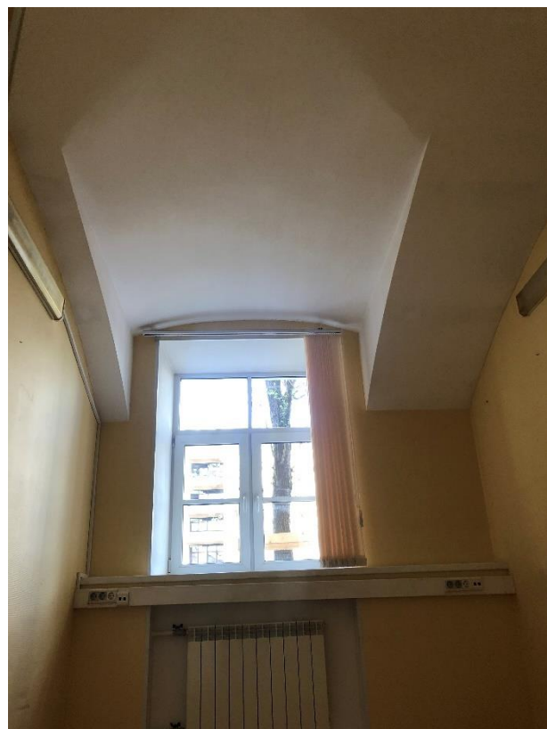
Фото 2. Первый этаж. Помещение № 22 (7-Н).
