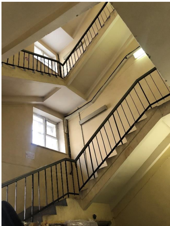
Фото 11. Первый этаж. Западная лестница 7-Н.
