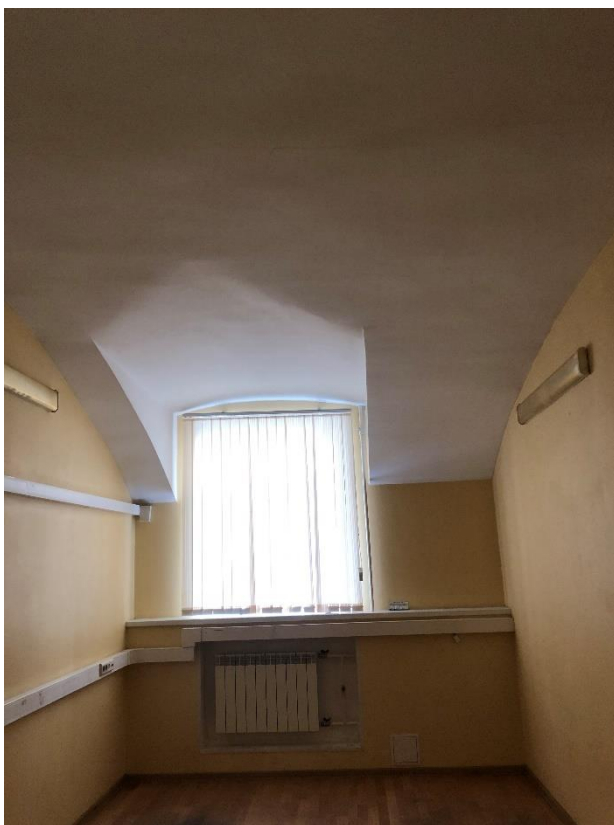
Фото 5. Первый этаж. Помещение № 23 (7-Н).
