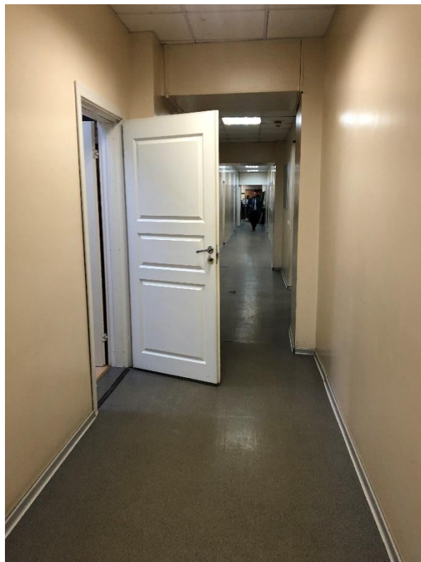
Фото 19. Второй этаж. Коридор.
