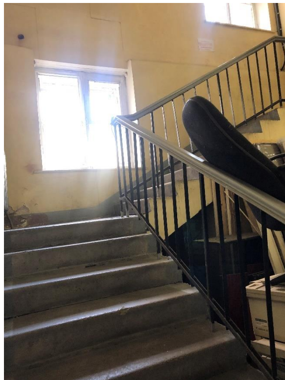
Фото 12. Первый этаж. Западная лестница 7-Н.
