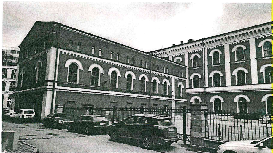
3. Здание института. Южный фасад
