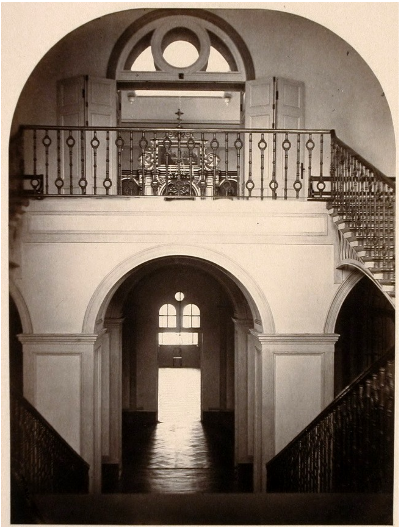
Илл. 10. Вид части вестибюля и лестницы в здании института. Фото 1890-1900 г. ЦГАКФФД СПб. Фотоальбом П 375. Павловский институт. Сн. 3.
