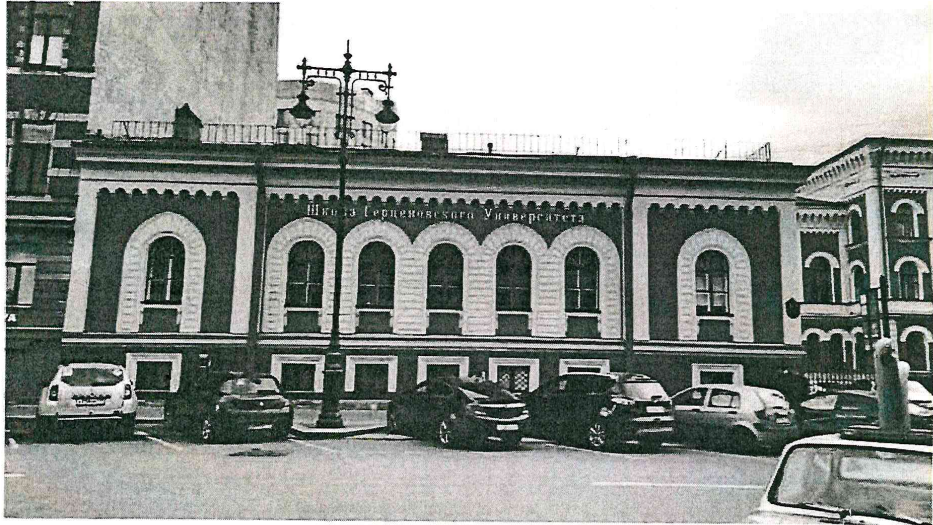
10. Флигель. Восточный фасад
