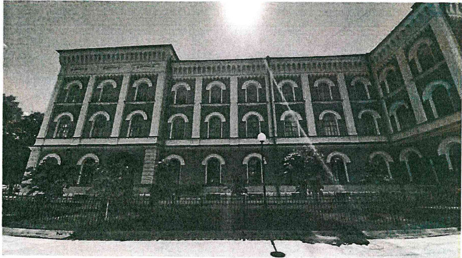
4. Здание института. Фрагмент северного фасада
