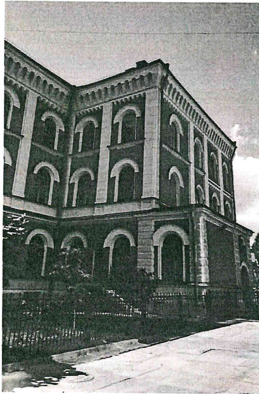
5. Здание института. Фрагмент северного фасада
