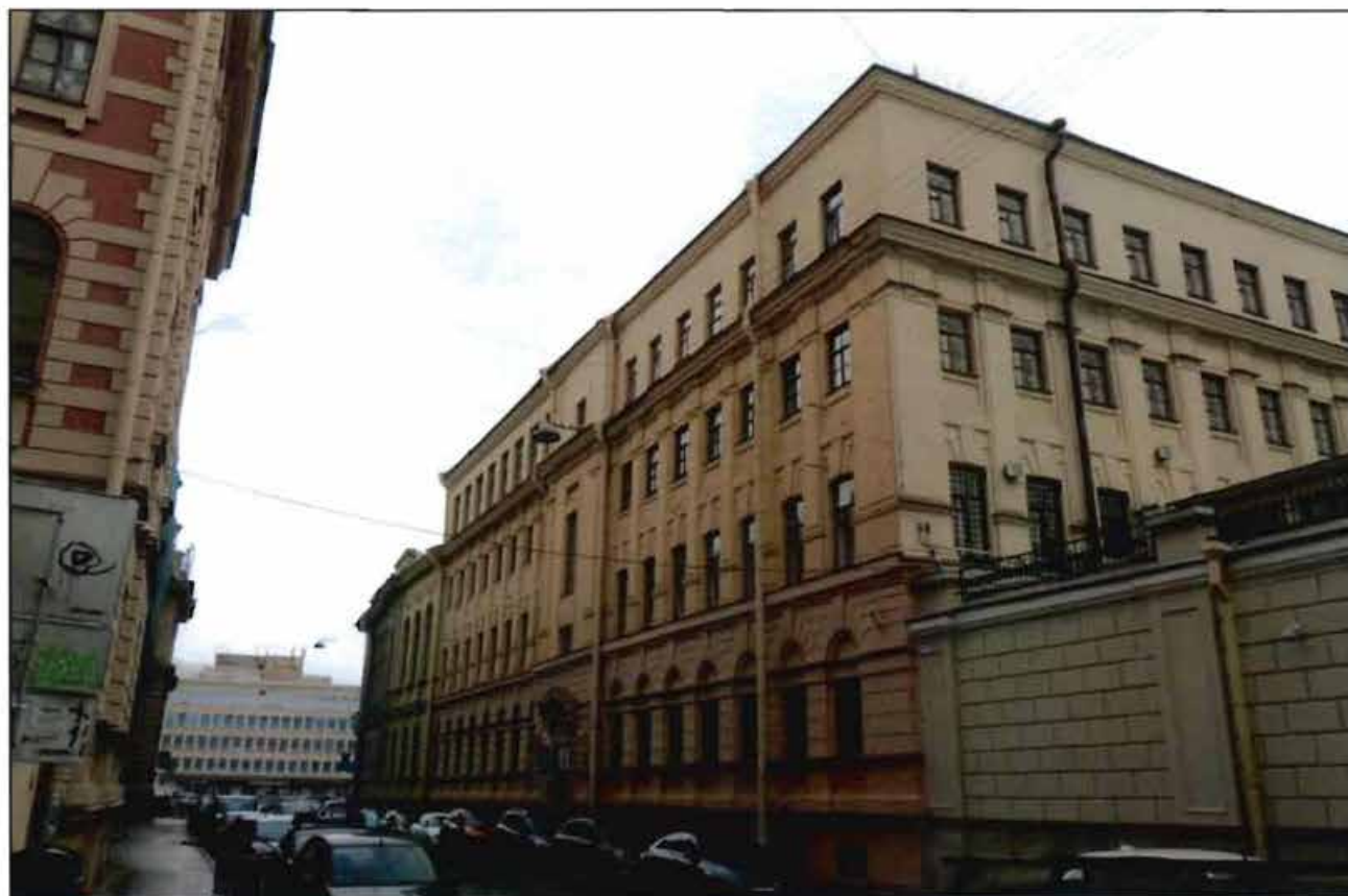
3. Общий вид с юга на лицевой фасад объекта культурного наследия по Банковскому пер.
