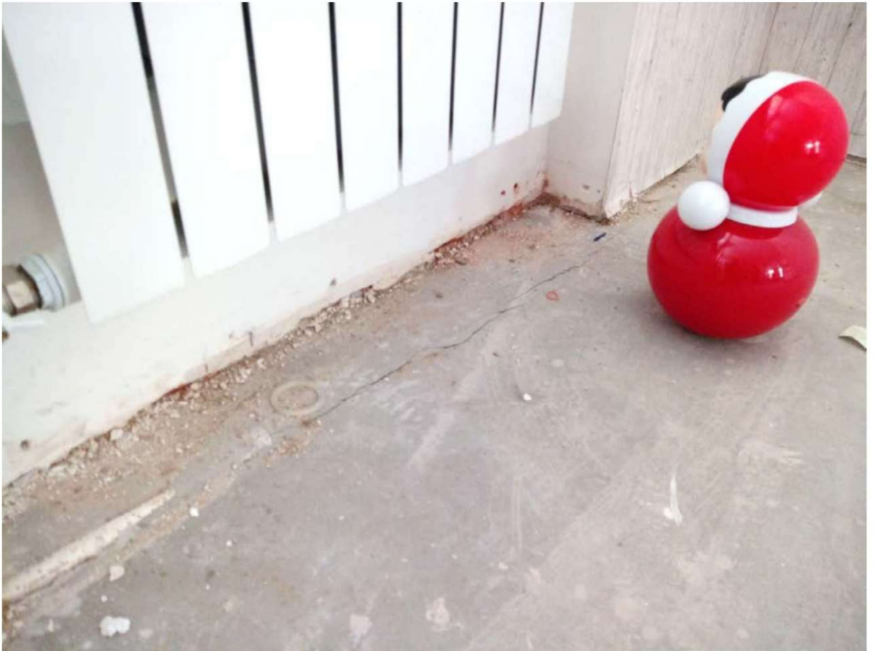
8. Квартира №50, юго-восточная комната, трещины на бетонной стяжке.
