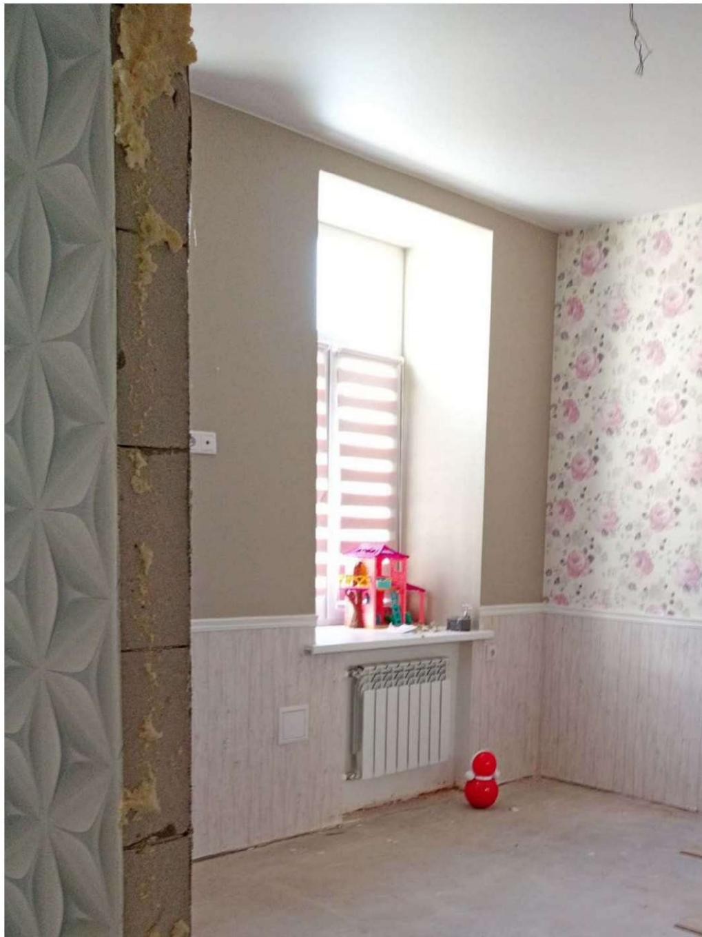
6. Квартира №50, перегородка из пеноблоков, отделяющая юго-восточную комнату.
