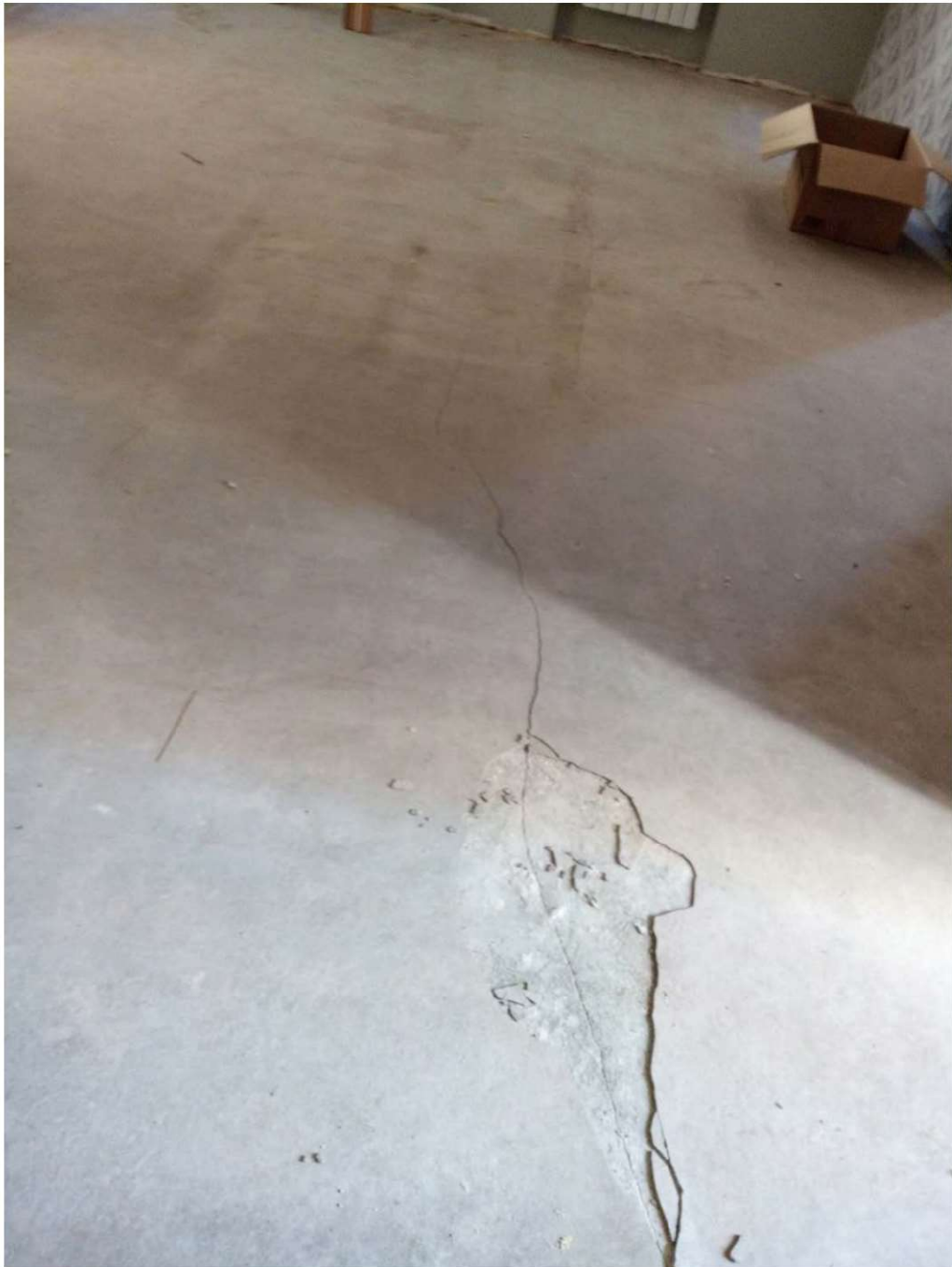
7. Квартира №50, центральная комната, трещины на бетонной стяжке.
