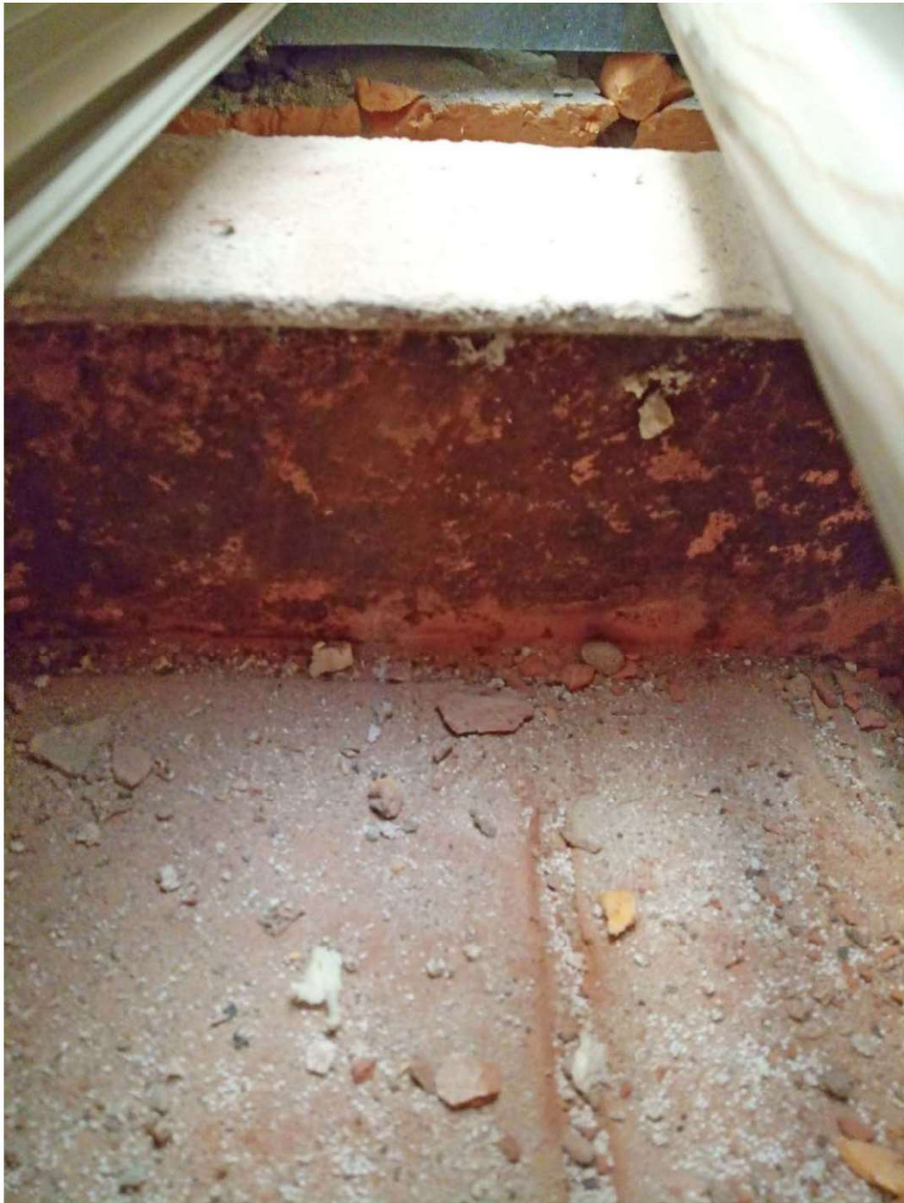
9. Квартира №50. Северо-восточная комната. Коррозия балки перекрытия.
