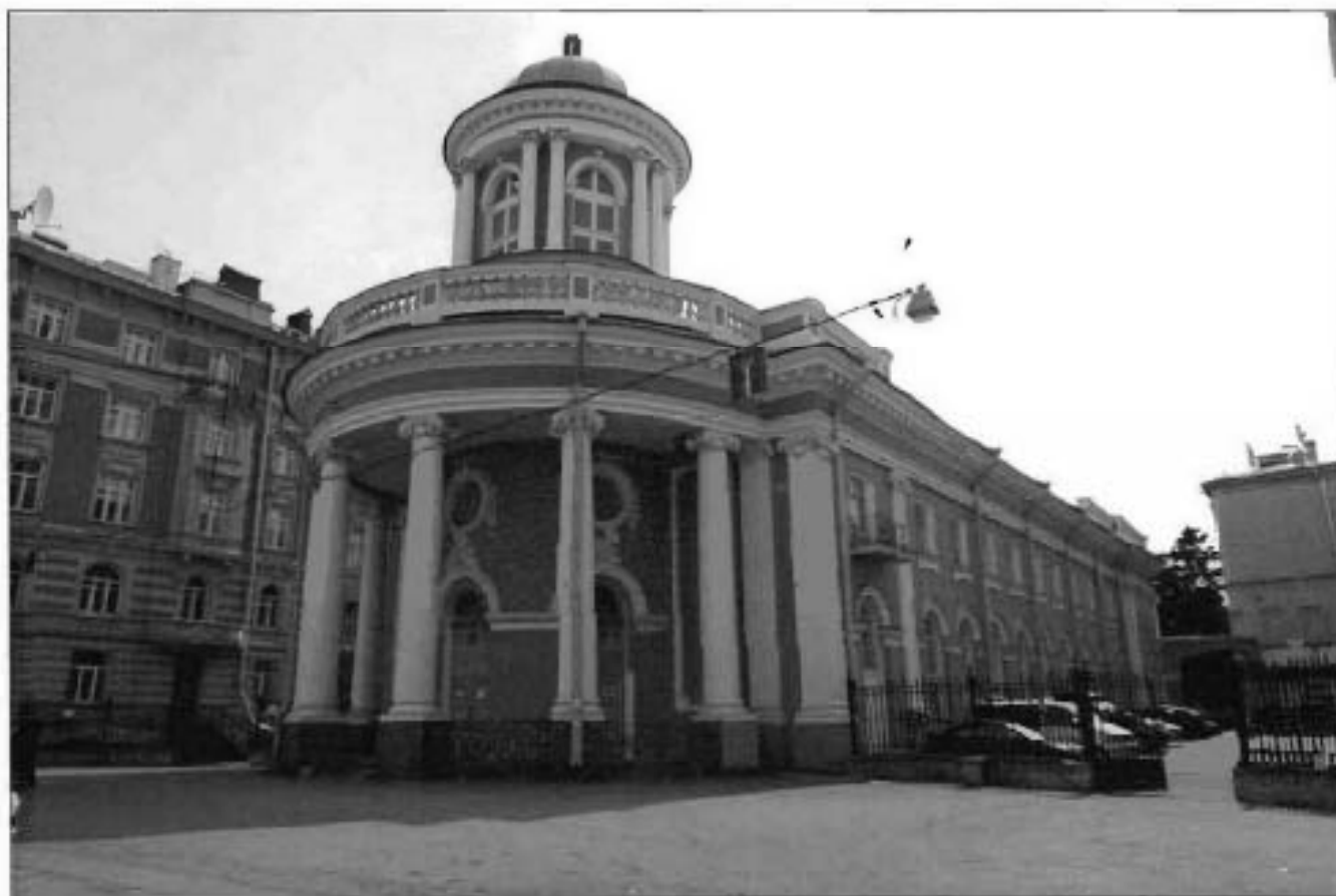
1. Общий вид с северо-запада.
