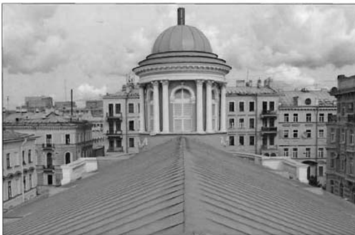
3. Общий вид кровли здания.
