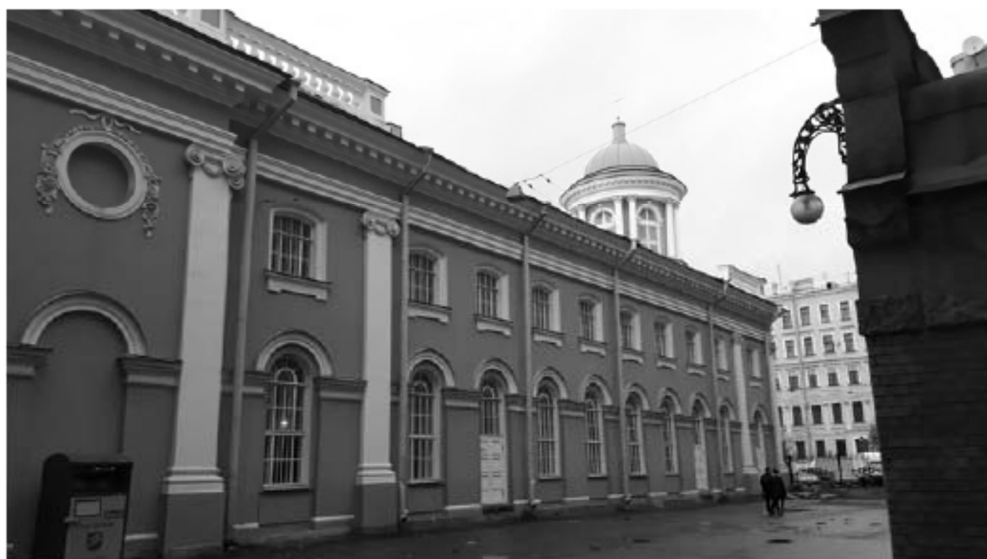
Фото 2. Объект культурного значения федерального значения «Церковь», 1775-1779гг, арх. Фельтон Ю.М., 1939г. арх. Гегелло А.И, арх. Косвен Л.С., по адресу: г. Санкт-Петербург, ул. Кирочная, дом 8, лит. В, входящего в состав объекта культурного наследия федерального значения "Церковь евангелическо-лютеранская Святой Анны" по адресу: г. Санкт-Петербург, Кирочная ул., дом 8, Фуриштатская ул., между домами 7 и 9.
