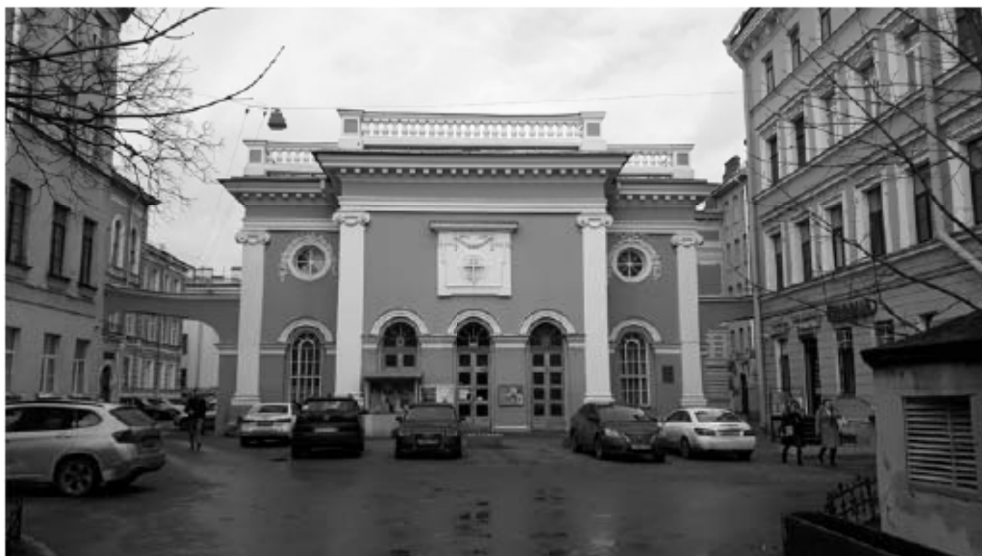
Фото 1. Объект культурного значения федерального значения «Церковь», 1775-1779гг, арх. Фельтон Ю.М., 1939г. арх. Гегелло А.И, арх. Косвен Л.С., по адресу: г. Санкт-Петербург, ул. Кирочная, дом 8, лит. В, входящего в состав объекта культурного наследия федерального значения "Церковь евангелическо-лютеранская Святой Анны" по адресу: г. Санкт-Петербург, Кирочная ул., дом 8, Фурштатская ул., между домами 7 и 9.
