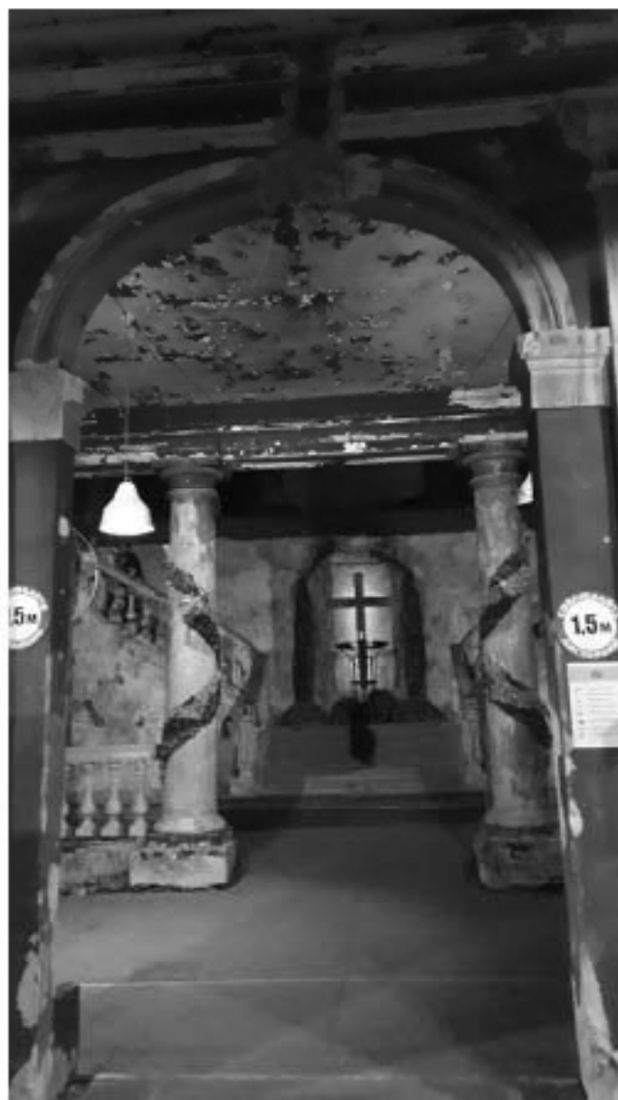
Фото 6. Объект культурного значения федерального значения «Церковь», 1775-1779гг., арх. Фельтон Ю.М., 1939г. арх. Гегелло А.И, арх. Косвен Л.С., по адресу: г. Санкт-Петербург, ул. Кирочная, дом 8, лит. В, входящего в состав объекта культурного наследия федерального значения "Церковь евангелическо-лютеранская Святой Анны" по адресу: г. Санкт-Петербург, Кирочная ул., дом 8, Фурштатская ул., между домами 7 и 9.
