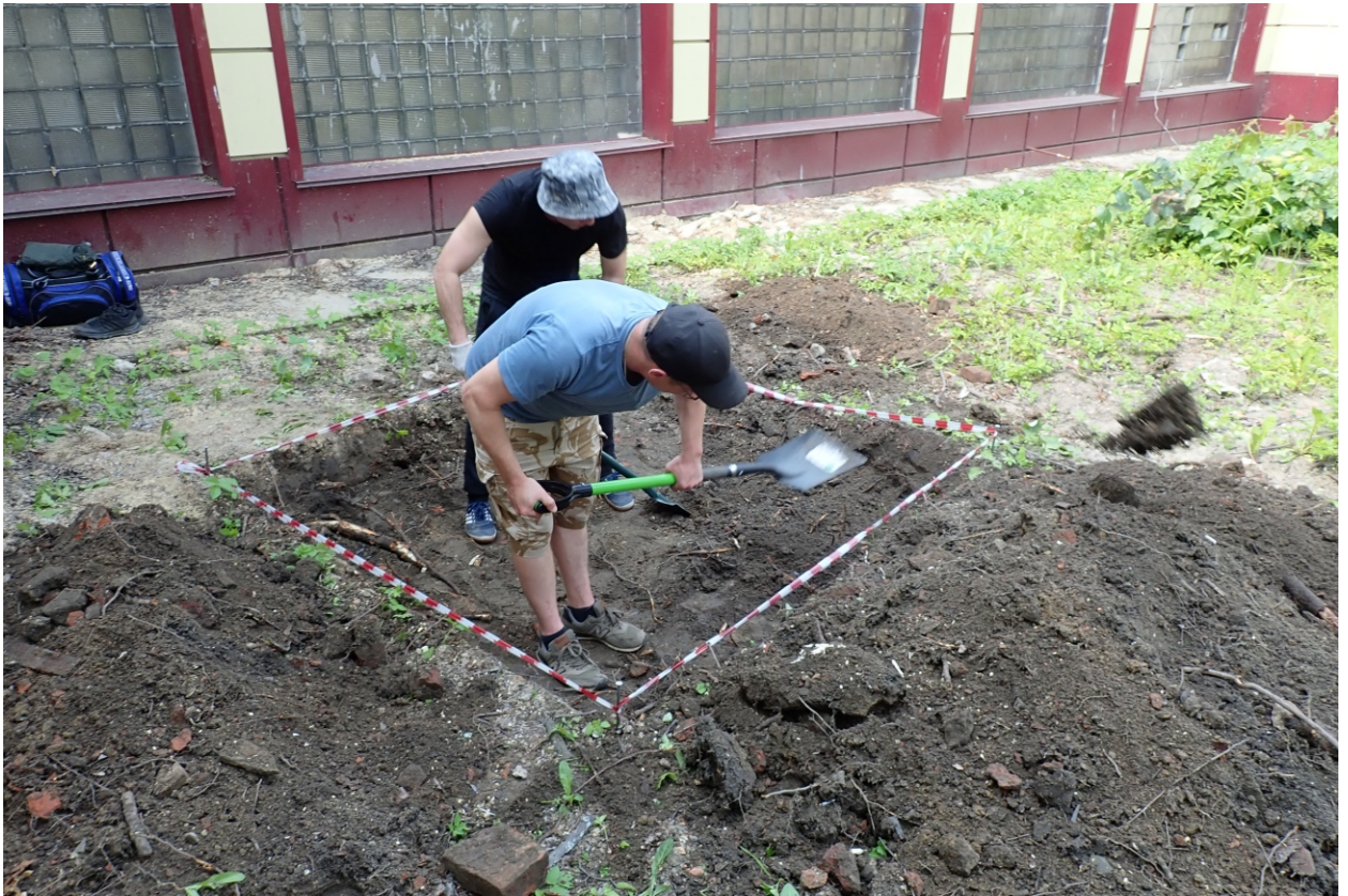
Илл. 12. г. Санкт-Петербург. «Реконструкция производственного здания инв. № 147;136 расположенного на территории АО «НПП «Краснознамёнец» по ул. Челябинской, д.46 АЖ». Выборка напластований шурфа. Рабочий момент.
