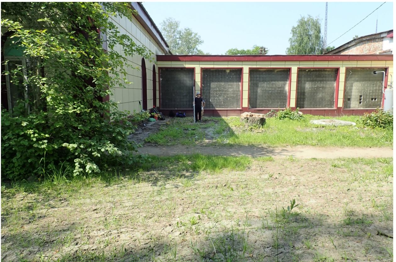
Илл. 13. г. Санкт-Петербург. «Реконструкция производственного здания инв. № 147;136 расположенного на территории АО «НПП «Краснознамёнец» по ул. Челябинской, д.46 АЖ». Шурф. Месторасположение. Вид с востока.
