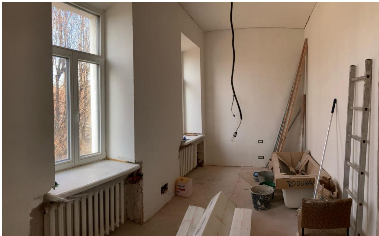
Фото 17. Интерьер помещения 23-Н выявленного объекта культурного наследия «Дом причта», входящего в состав выявленного объекта культурного наследия «Дома Никольского морского собора»
