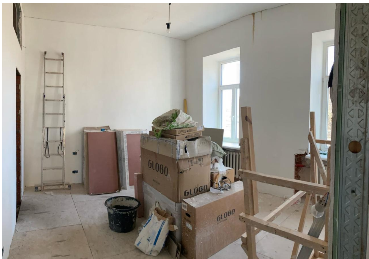
Фото 20. Интерьер помещения 23-Н выявленного объекта культурного наследия «Дом причта», входящего в состав выявленного объекта культурного наследия «Дома Никольского морского собора»
