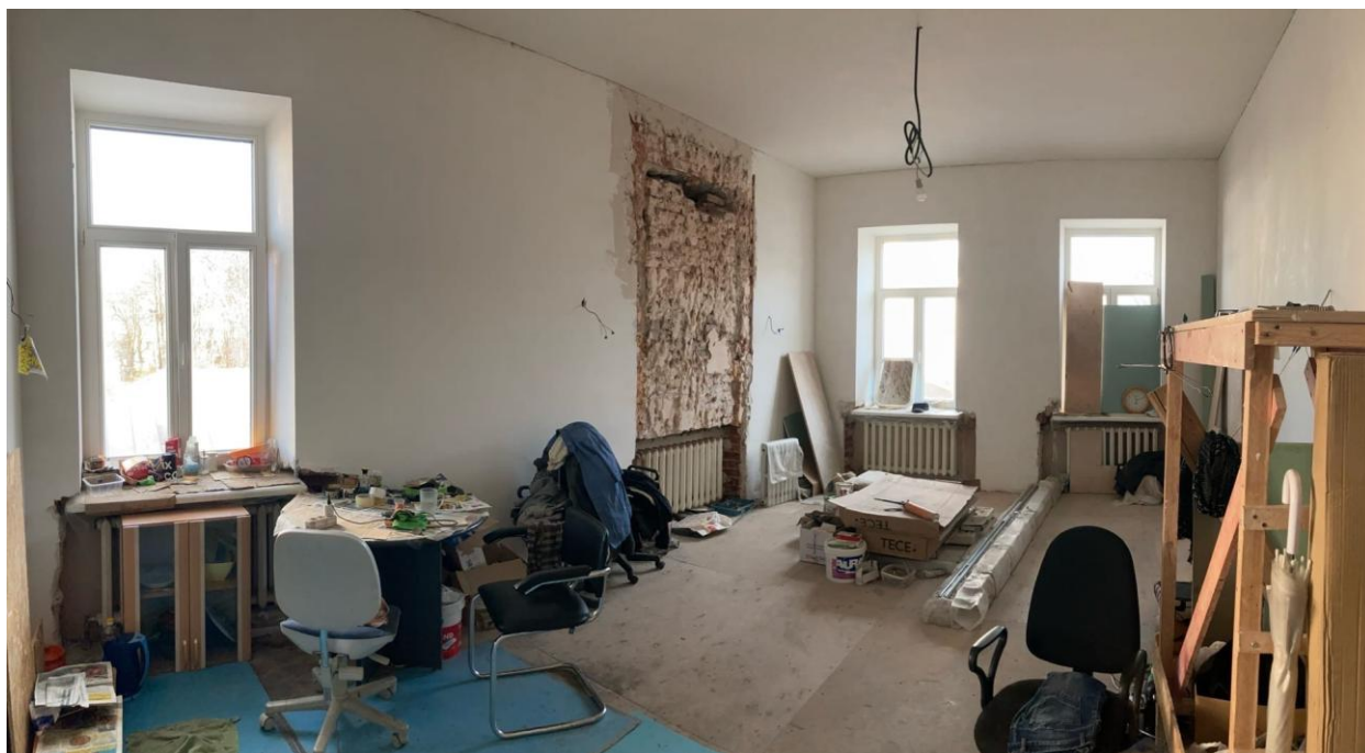
Фото 11. Интерьер помещения 23-Н выявленного объекта культурного наследия «Дом причта», входящего в состав выявленного объекта культурного наследия «Дома Никольского морского собора»
