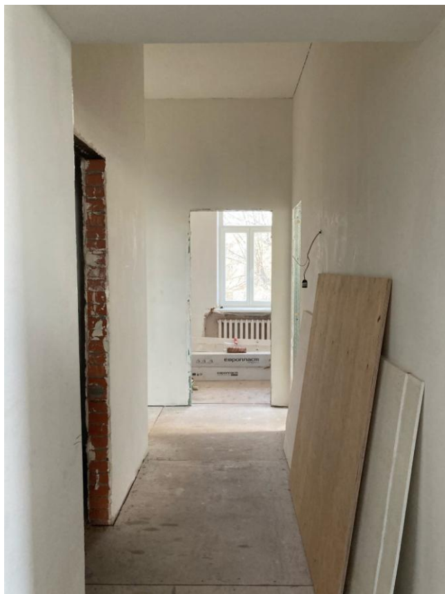
Фото 13. Интерьер помещения 23-Н выявленного объекта культурного наследия «Дом причта», входящего в состав выявленного объекта культурного наследия «Дома Никольского морского собора»
