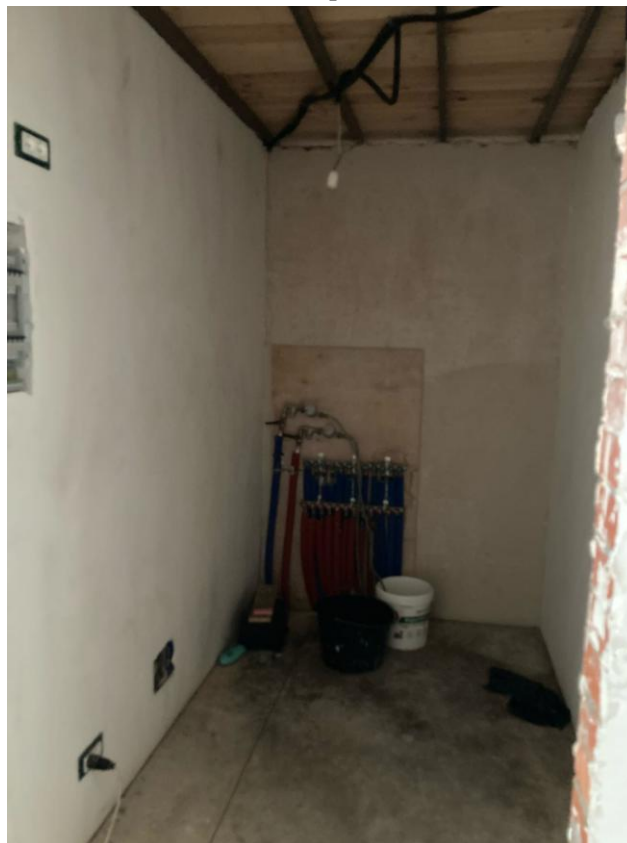
Фото 14. Интерьер помещения 23-Н выявленного объекта культурного наследия «Дом причта», входящего в состав выявленного объекта культурного наследия «Дома Никольского морского собора»
