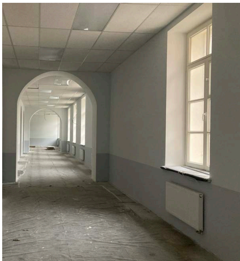
Фото 34. Интерьер помещений 2 этажа объекта культурного наследия регионального значения «Здание Дворянского полка»
