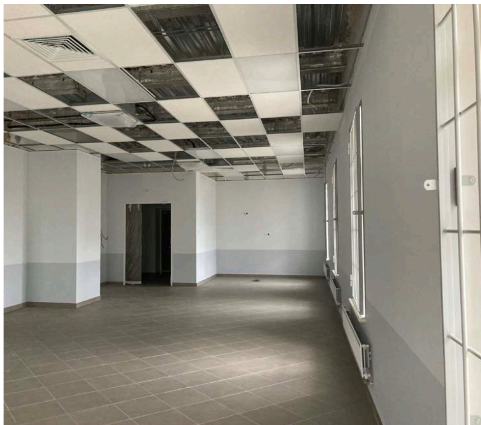
Фото 50. Интерьер помещений 4 этажа объекта культурного наследия регионального значения «Здание Дворянского полка»
