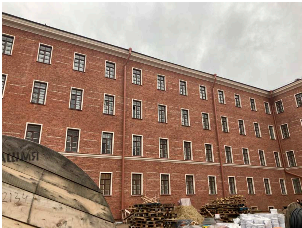
Фото 15. Фрагмент дворового фасада объекта культурного наследия регионального значения «Здание Дворянского полка»
