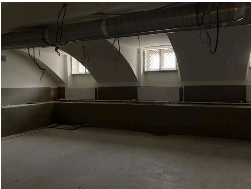
Фото 22. Интерьер помещений подвального этажа объекта культурного наследия регионального значения «Здание Дворянского полка»
