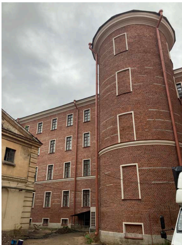
Фото 8. Фрагмент дворового фасада объекта культурного наследия регионального значения «Здание Дворянского полка»
