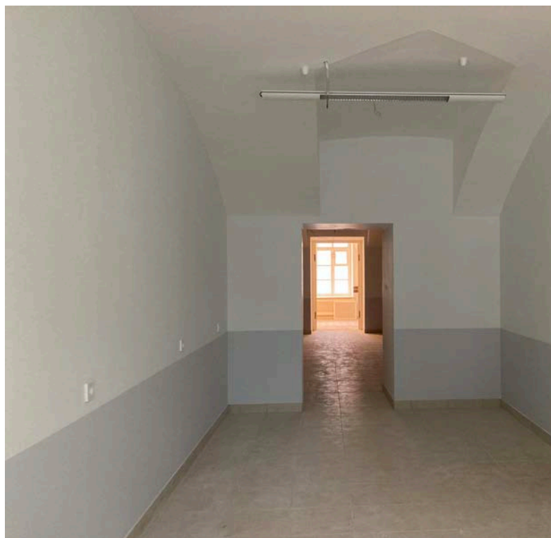
Фото 28. Интерьер помещений 1 этажа объекта культурного наследия регионального значения «Здание Дворянского полка»
