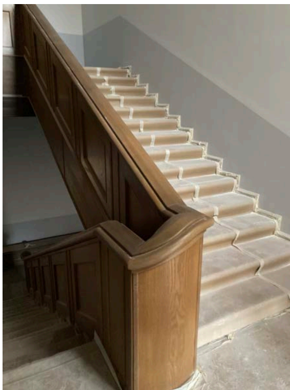
Фото 47. Интерьер помещений 4 этажа объекта культурного наследия регионального значения «Здание Дворянского полка»
