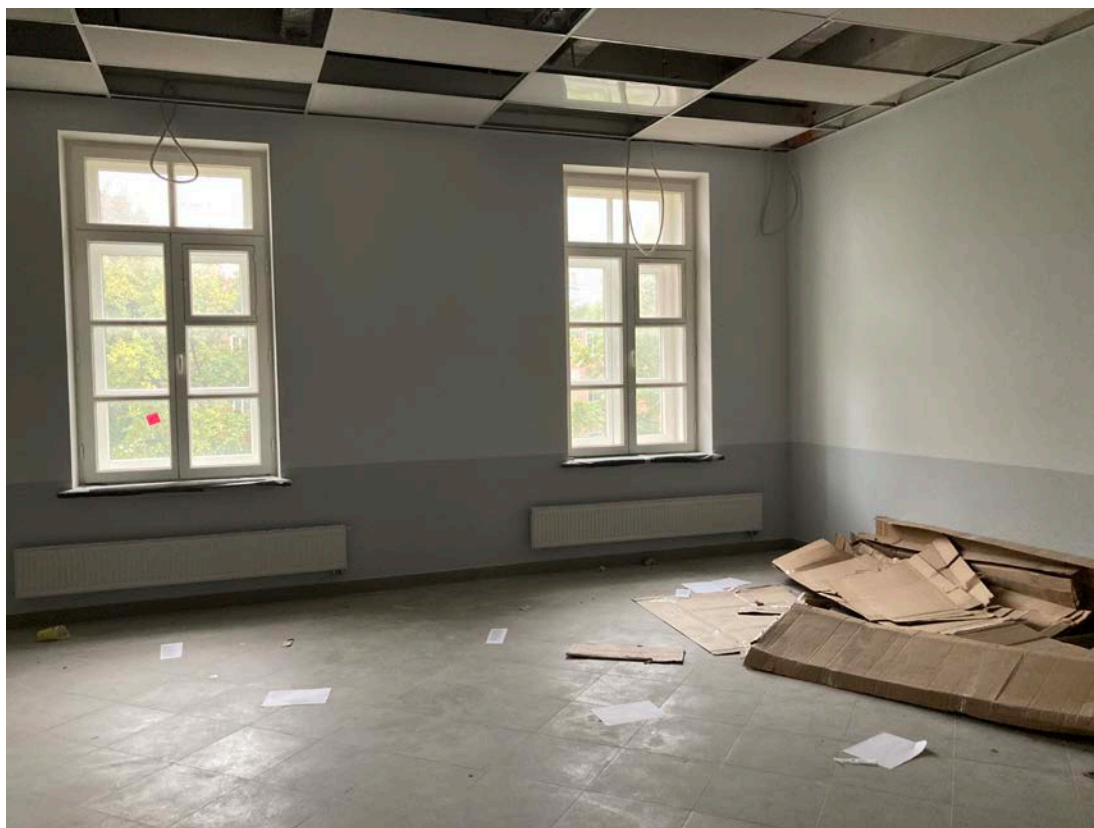
Фото 42. Интерьер помещений 3 этажа объекта культурного наследия регионального значения «Здание Дворянского полка»
