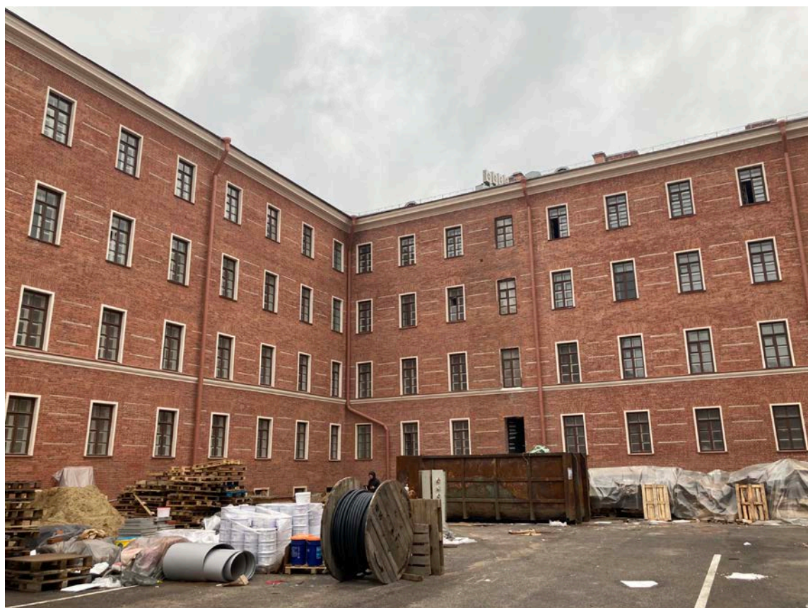
Фото 14. Фрагмент дворового фасада объекта культурного наследия регионального значения «Здание Дворянского полка»
