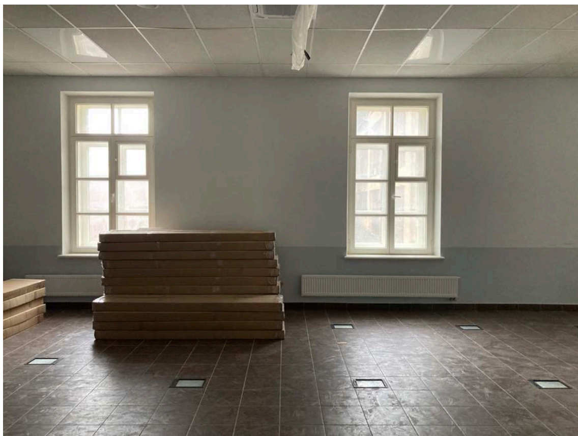
Фото 44. Интерьер помещений 3 этажа объекта культурного наследия регионального значения «Здание Дворянского полка»
