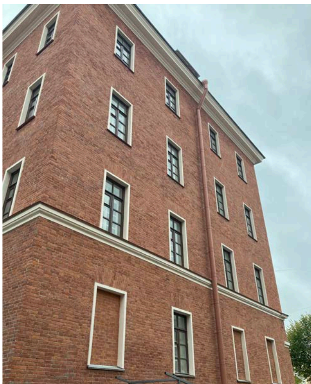
Фото 7. Фрагмент дворового фасада объекта культурного наследия регионального значения «Здание Дворянского полка»
