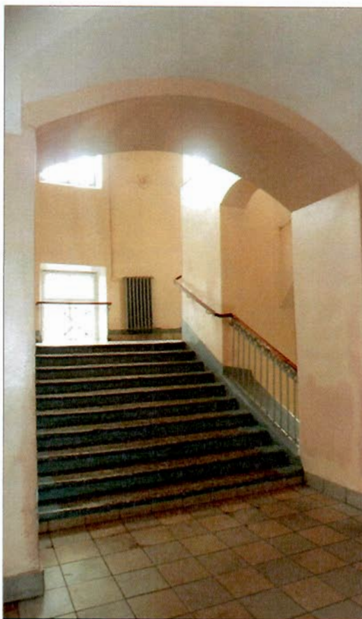
9. Парадная лестница в уровне 1-го этажа.
