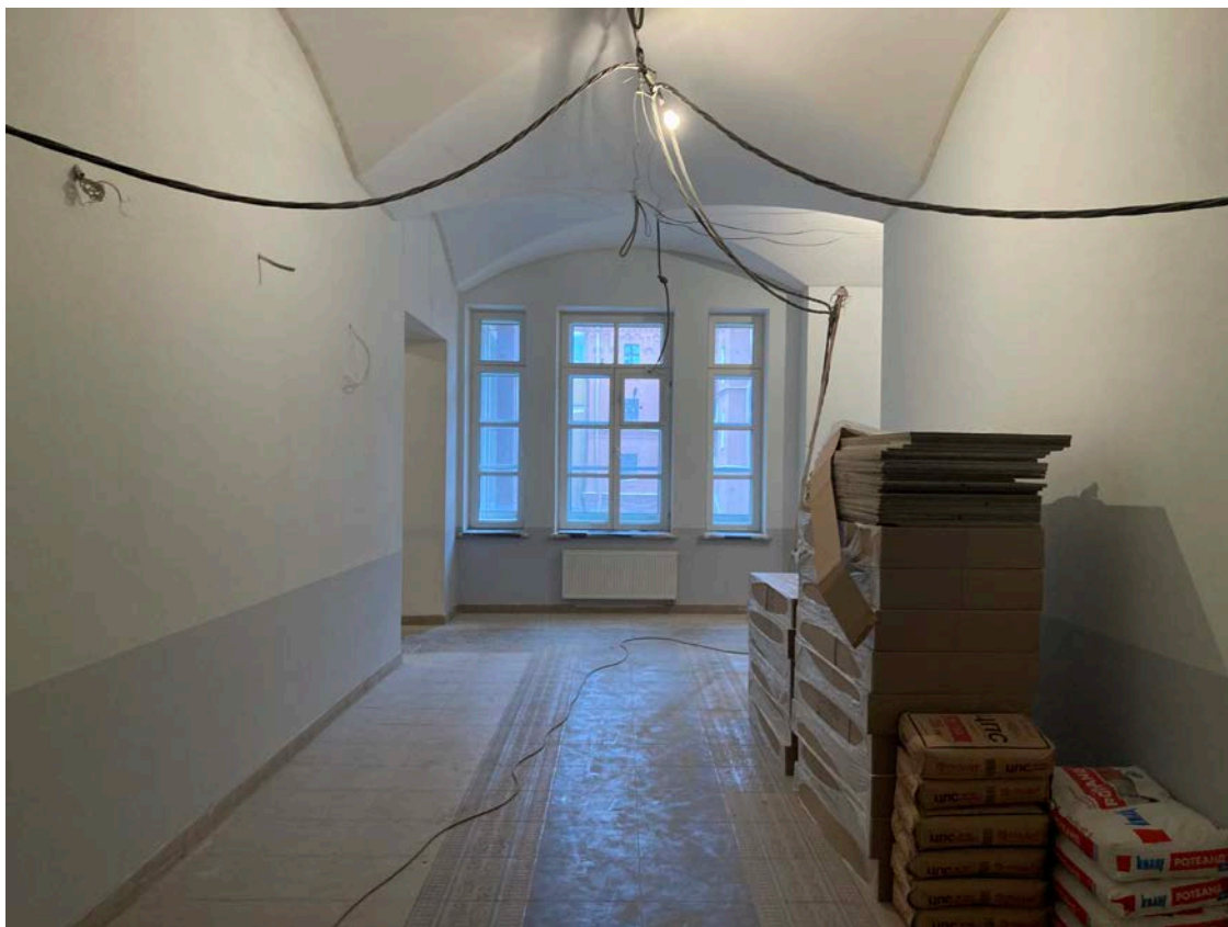
Фото 36. Интерьер помещений 2 этажа объекта культурного наследия регионального значения «Здание Дворянского полка»
