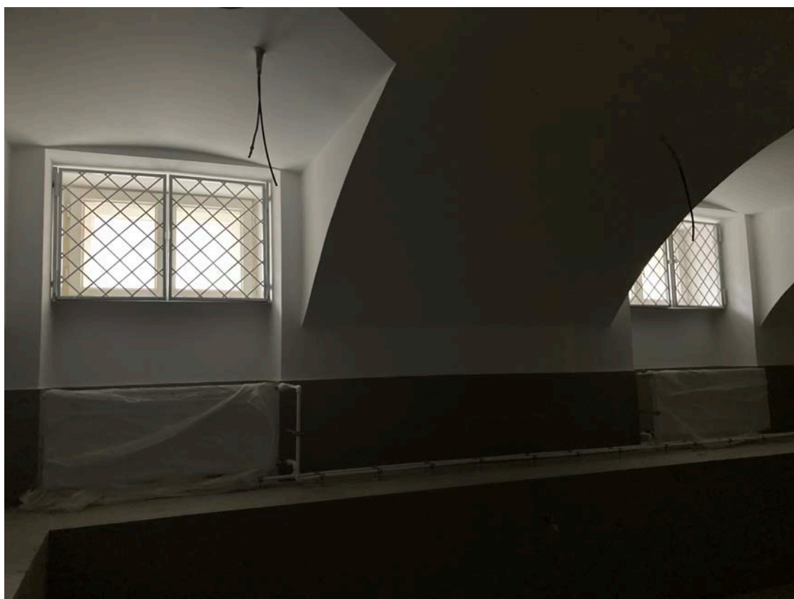
Фото 24. Интерьер помещений подвального этажа объекта культурного наследия регионального значения «Здание Дворянского полка»
