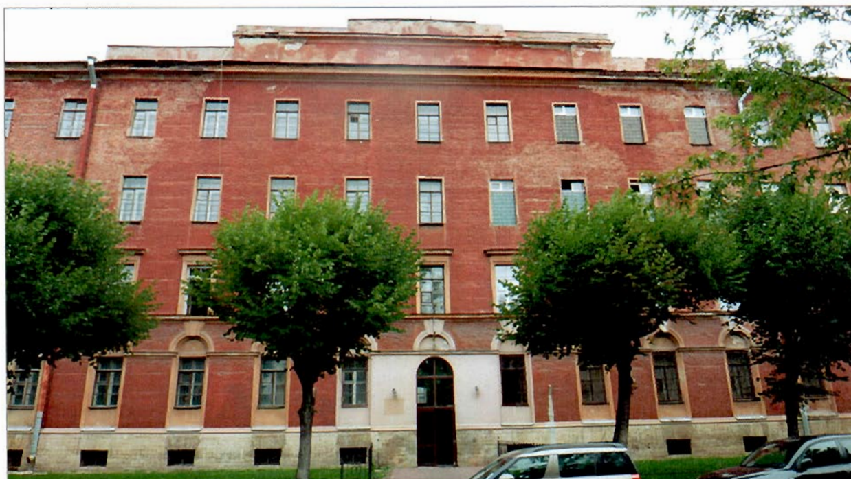
2. «Здание Дворянского полка». Западный фасад лицевого корпуса. Фрагмент.
