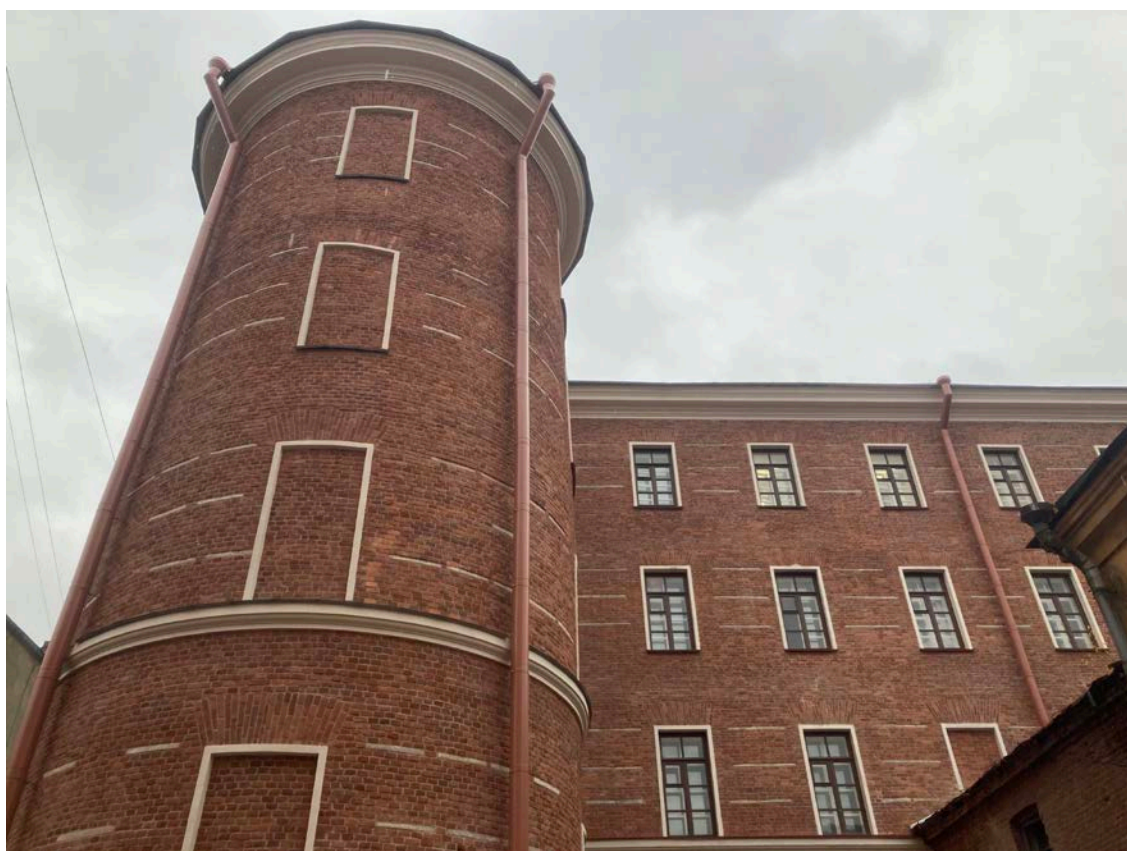
Фото 10. Фрагмент дворового фасада объекта культурного наследия регионального значения «Здание Дворянского полка»
