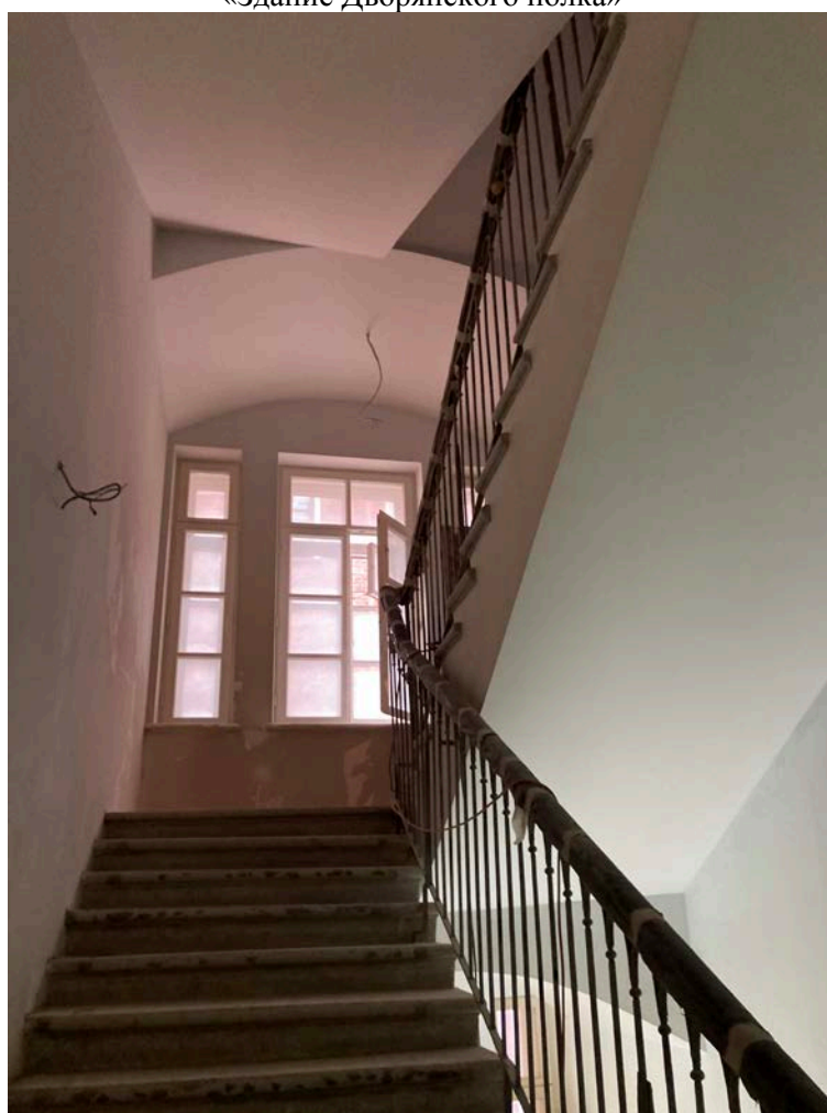
Фото 40. Интерьер помещений 3 этажа объекта культурного наследия регионального значения «Здание Дворянского полка»
