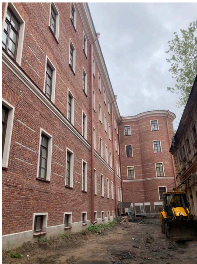
Фото 11. Фрагмент дворового фасада объекта культурного наследия регионального значения «Здание Дворянского полка»
