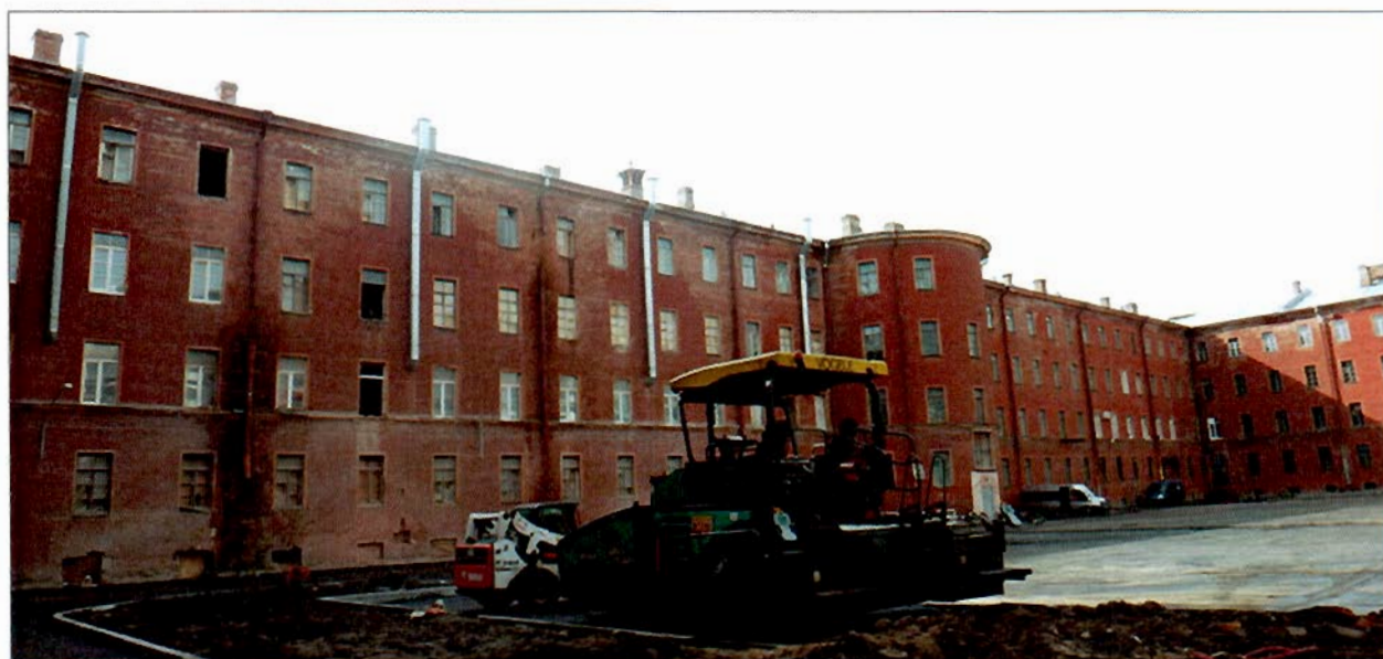
6. «Здание Дворянского полка». Дворовые фасады. Вид с востока.
