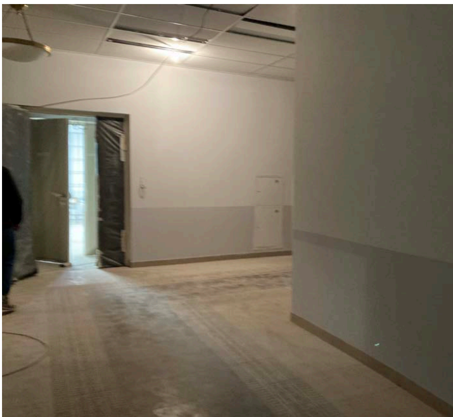
Фото 51. Интерьер помещений 4 этажа объекта культурного наследия регионального значения «Здание Дворянского полка»
