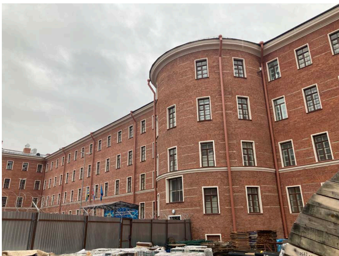
Фото 16. Фрагмент дворового фасада объекта культурного наследия регионального значения «Здание Дворянского полка»
