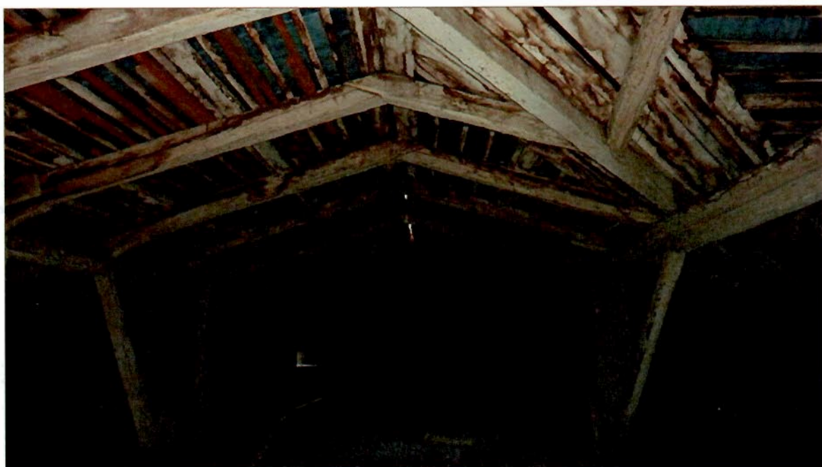
7. Чердак. Стропильная система.
