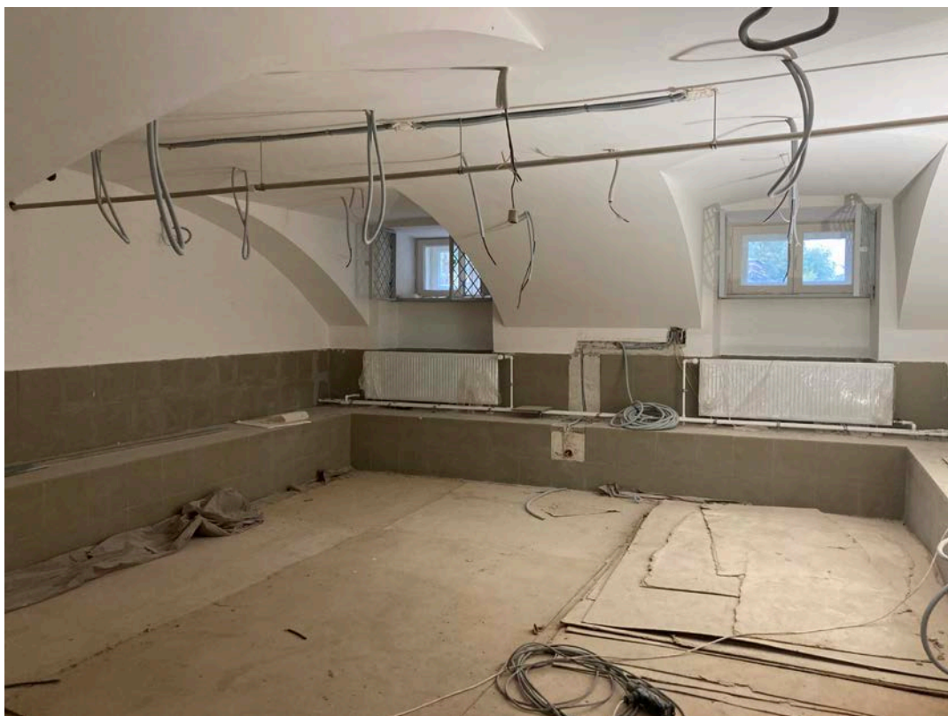
Фото 21. Интерьер помещений подвального этажа объекта культурного наследия регионального значения «Здание Дворянского полка»
