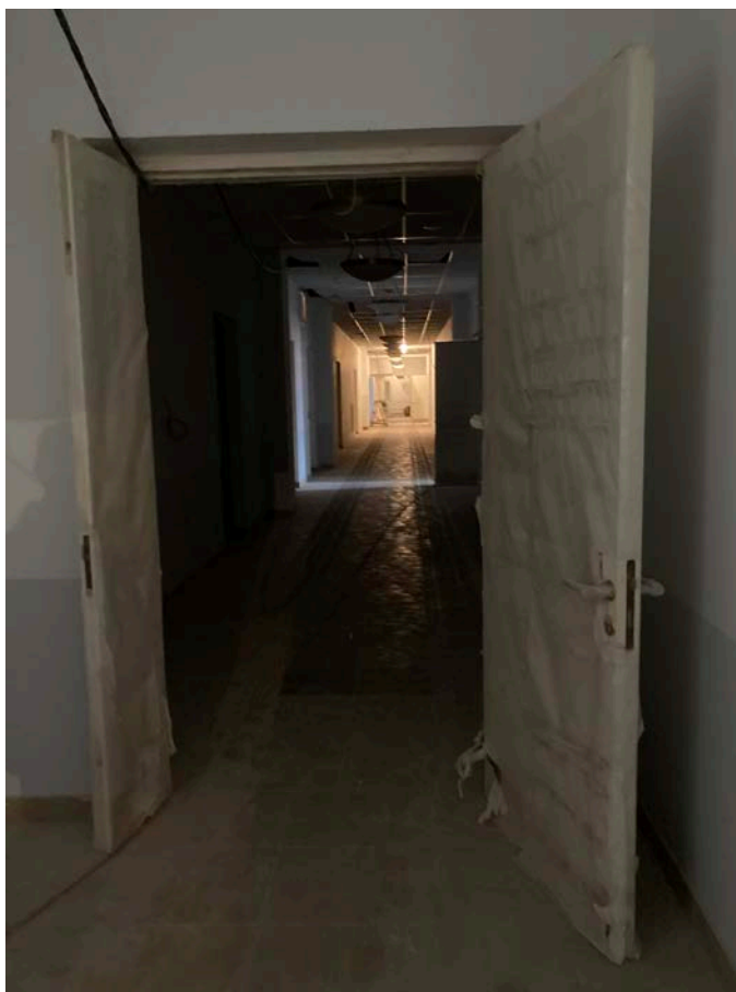
Фото 49. Интерьер помещений 4 этажа объекта культурного наследия регионального значения «Здание Дворянского полка»
