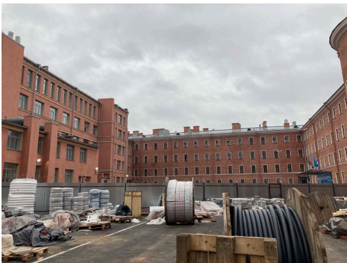
Фото 12. Фрагмент дворового фасада объекта культурного наследия регионального значения «Здание Дворянского полка»
