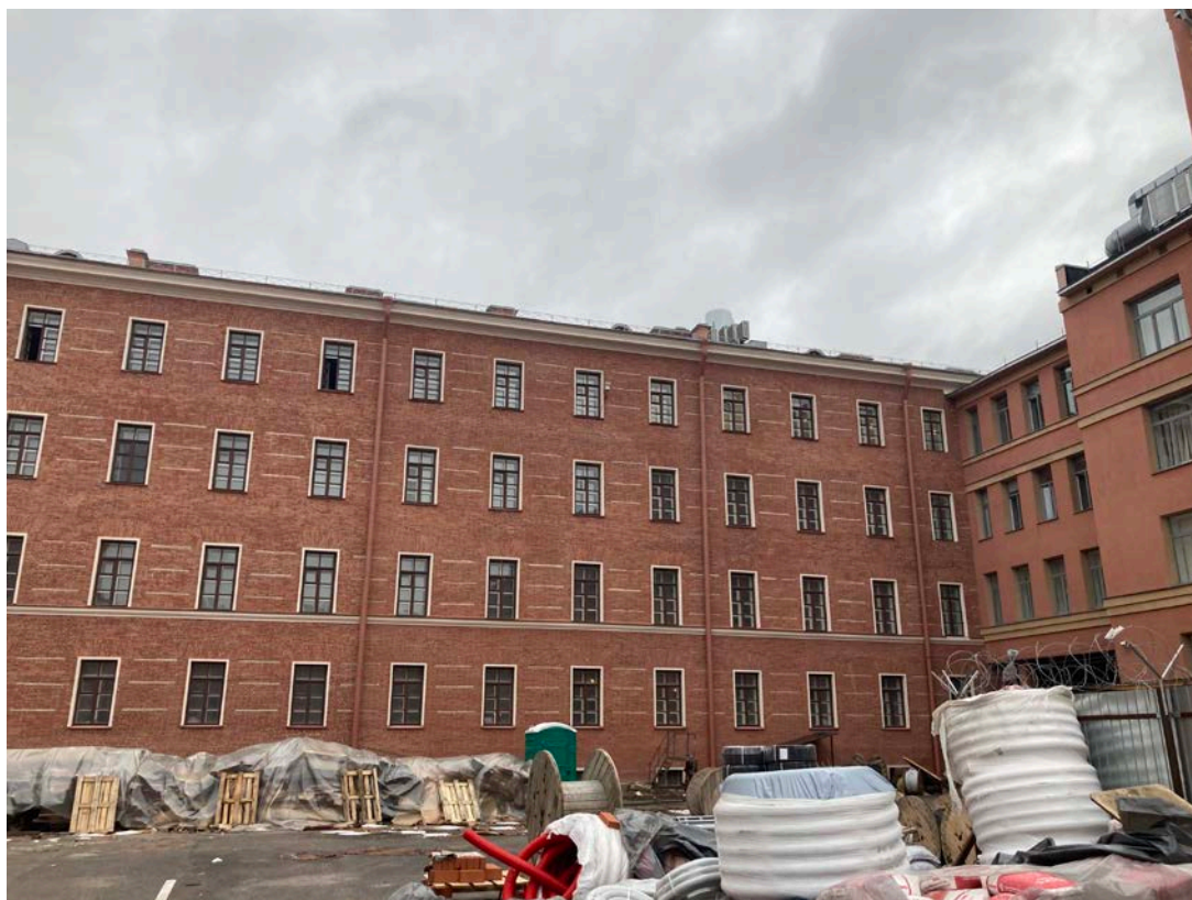
Фото 13. Фрагмент дворового фасада объекта культурного наследия регионального значения «Здание Дворянского полка»
