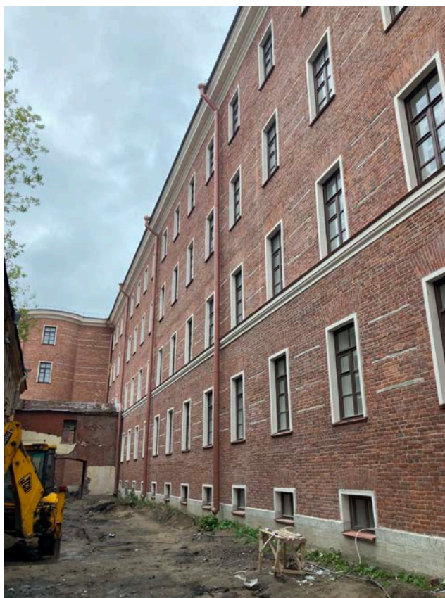
Фото 9. Фрагмент дворового фасада объекта культурного наследия регионального значения «Здание Дворянского полка»
