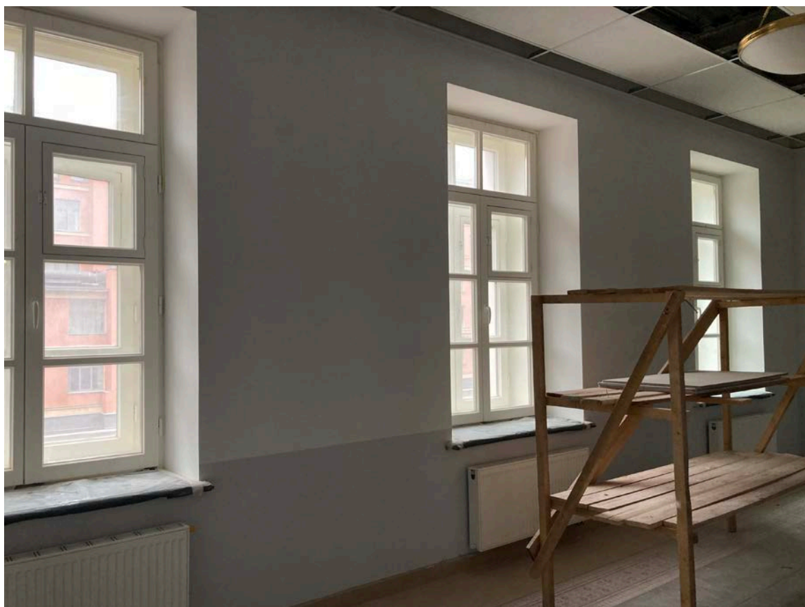
Фото 38. Интерьер помещений 2 этажа объекта культурного наследия регионального значения «Здание Дворянского полка»
