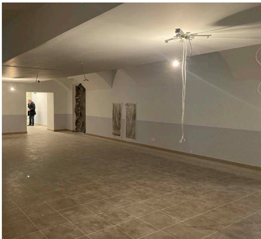
Фото 27. Интерьер помещений 1 этажа объекта культурного наследия регионального значения «Здание Дворянского полка»
