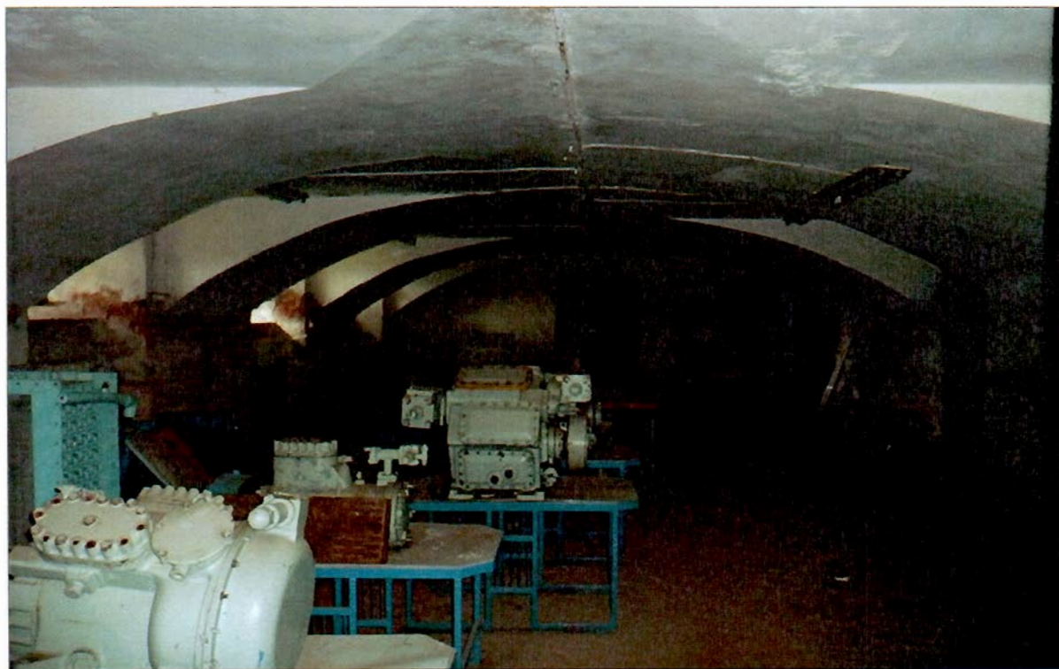
14. Сводчатые перекрытия. Цокольный этаж.
