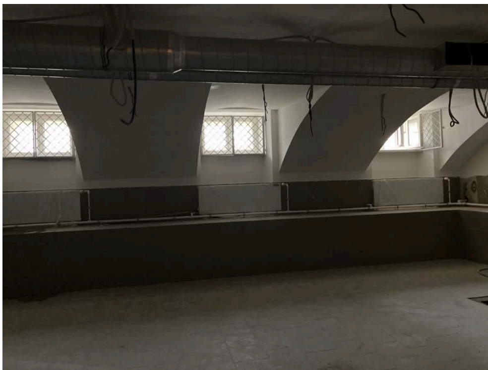
Фото 23. Интерьер помещений подвального этажа объекта культурного наследия регионального значения «Здание Дворянского полка»
