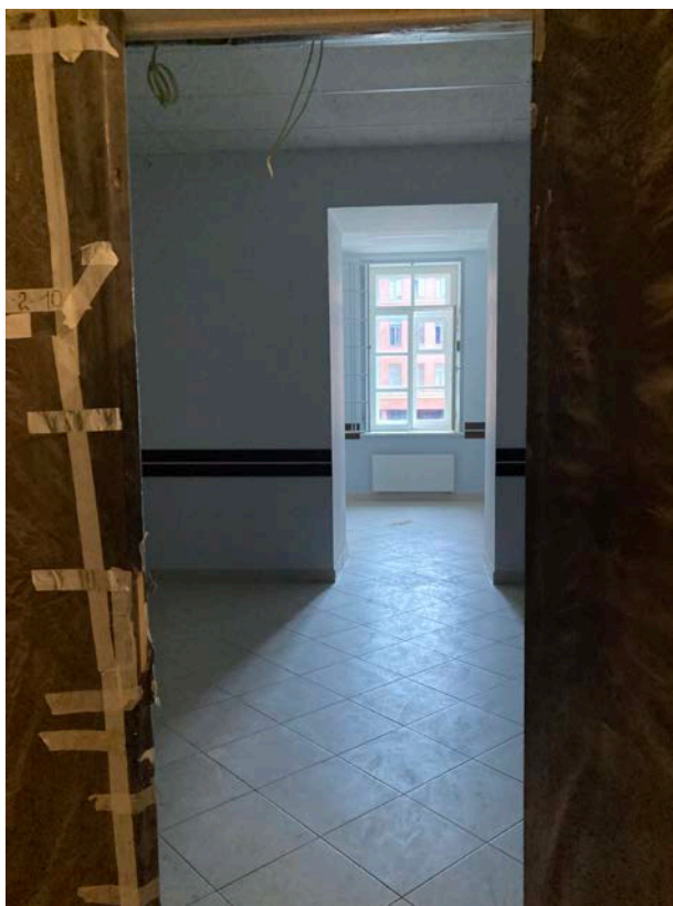
Фото 37. Интерьер помещений 2 этажа объекта культурного наследия регионального значения «Здание Дворянского полка»
