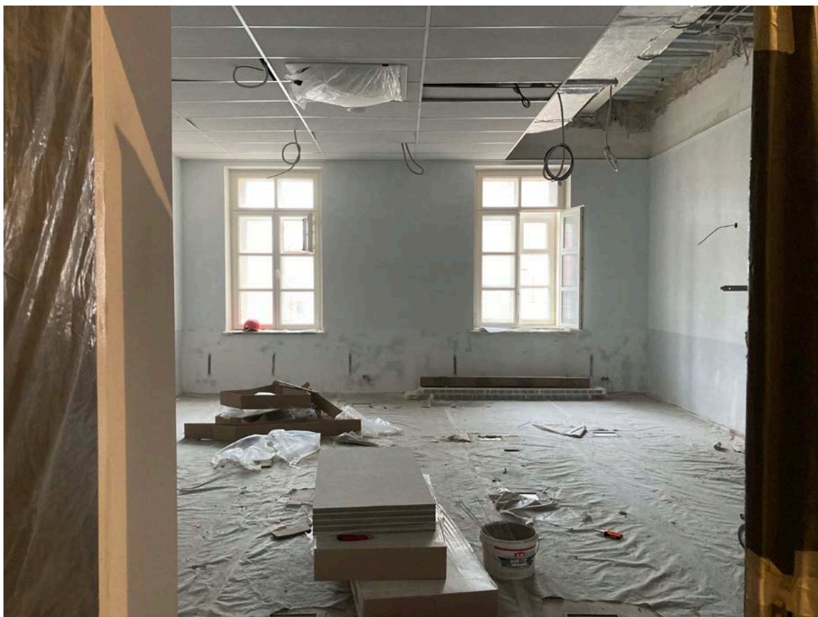
Фото 43. Интерьер помещений 3 этажа объекта культурного наследия регионального значения «Здание Дворянского полка»
