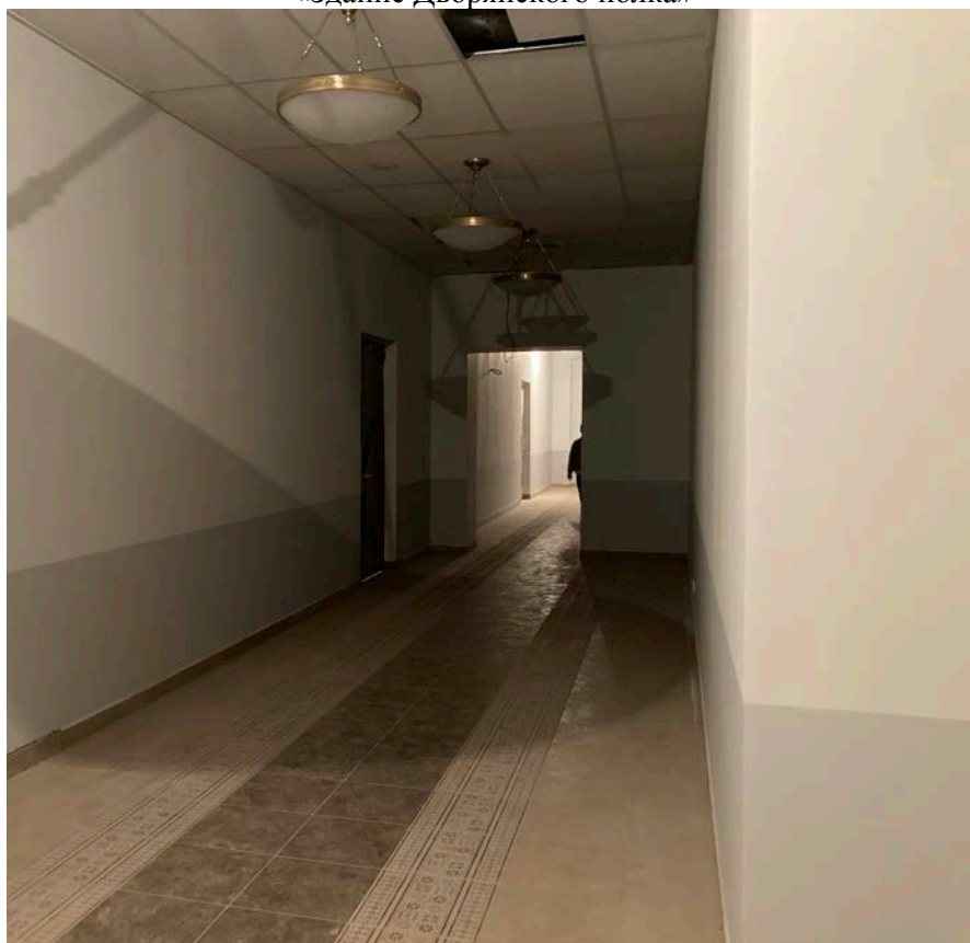
Фото 32. Интерьер помещений 2 этажа объекта культурного наследия регионального значения «Здание Дворянского полка»
