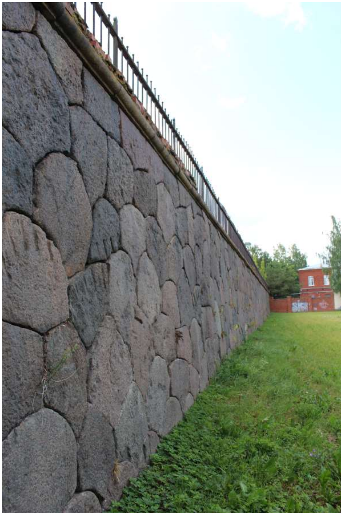
Фото 23. Общий вид объекта культурного наследия федерального значения «Стена эскарповая».
