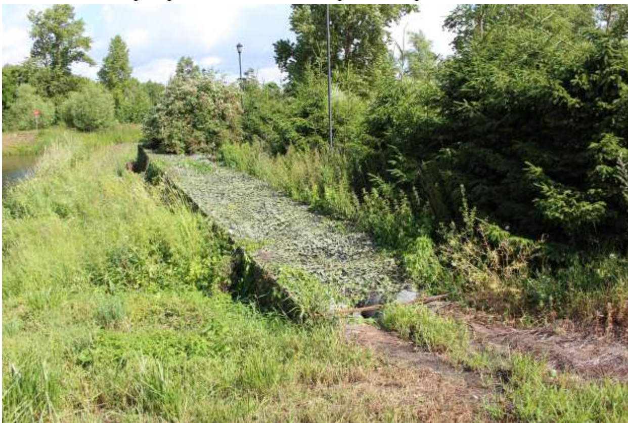
Фото 33. Вид на трубы теплосети вдоль западной границы сквера на территории объекта культурного наследия федерального значения «Крепость Кронштадт».
