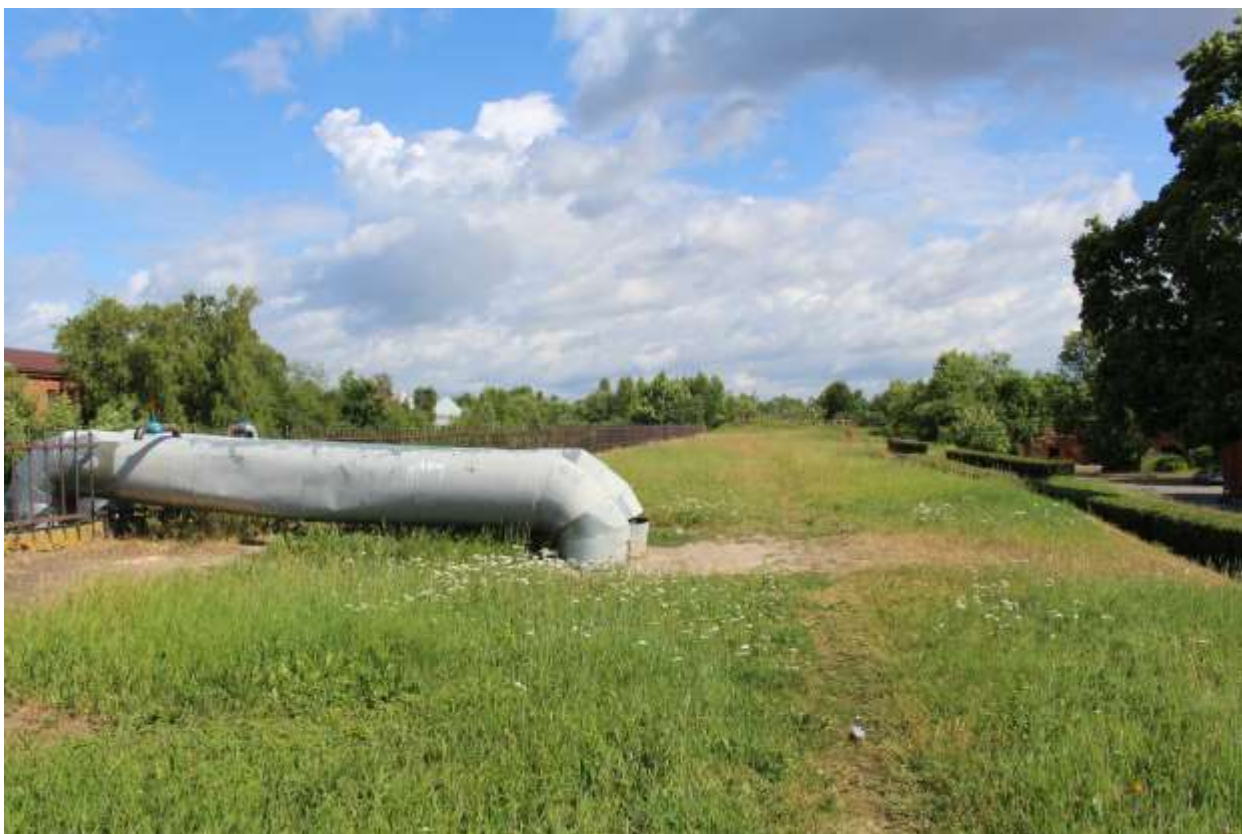
Фото 15. Вид на надземные трубы теплосети, проходящие в центральной части объектов культурного наследия федерального значения «Стена эскарповая» и «Вал земляной Главный» с юга.
