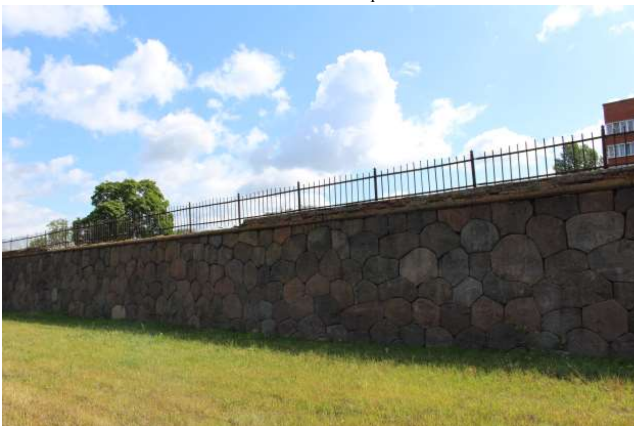
Фото 20. Общий вид объекта культурного наследия федерального значения «Стена эскарповая» с юга.
