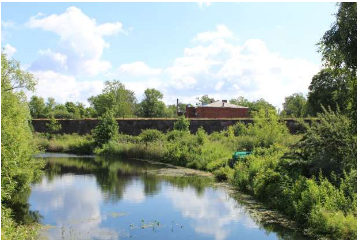
Фото 26. Вид на объект культурного наследия федерального значения «Ров крепостной оборонительный» к западу от объекта культурного наследия федерального значения «Стена эскарповая».
