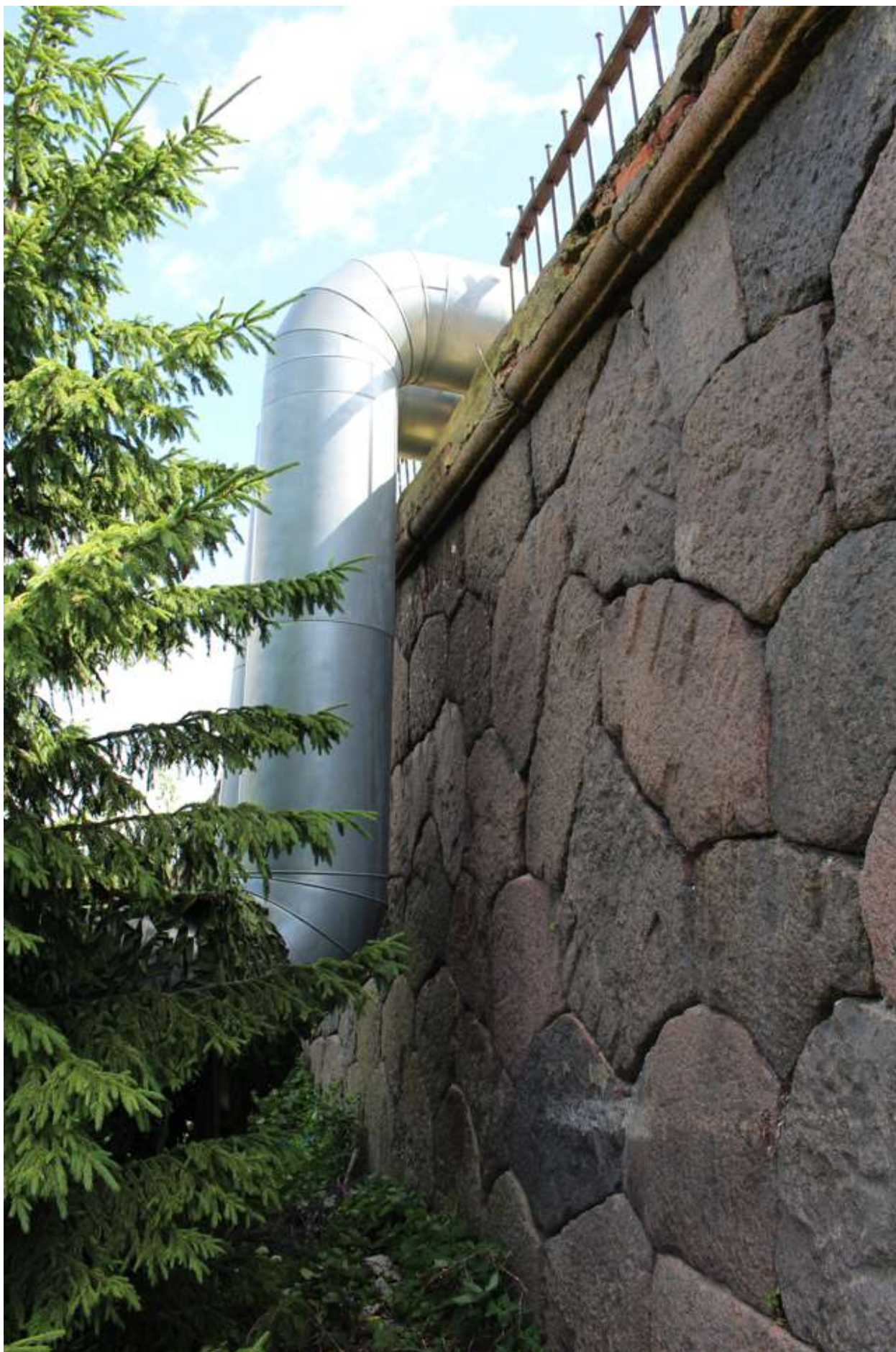
Фото 22. Вид на трубы теплосети, проходящие в центральной части объекта культурного наследия федерального значения «Стена эскарповая».
