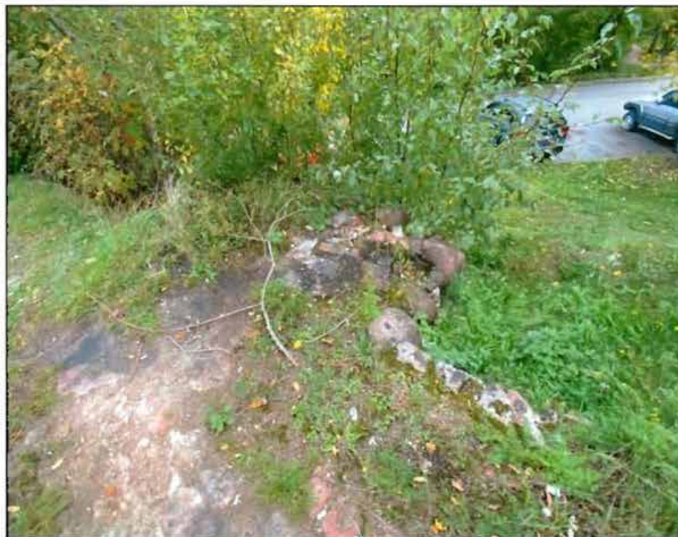
8. Конструктивные элементы: поздние укрепления части вала (кирпич, гранит) в центральной части (вблизи гаражного кооператива).
