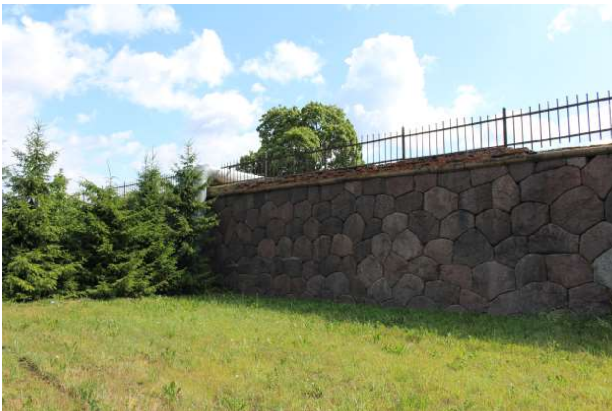
Фото 21. Вид на центральную часть объекта культурного наследия федерального значения «Стена эскарповая».
