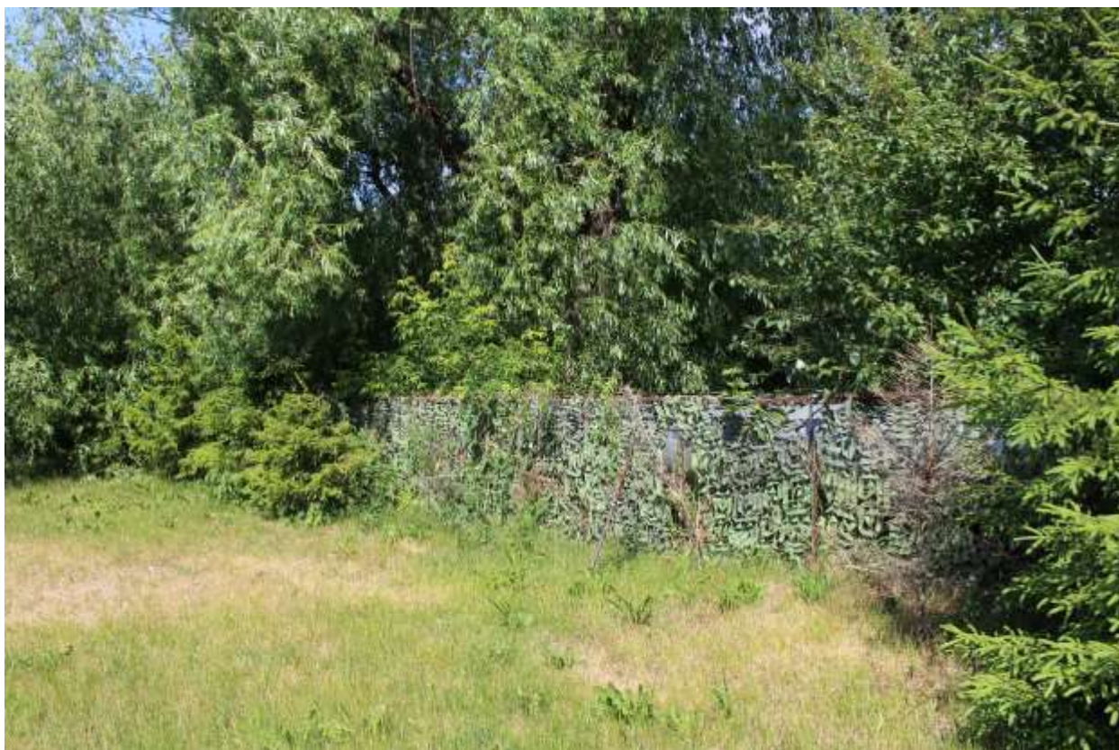
Фото 30. Вид на трубы теплосети, проходящие вдоль территории объекта культурного наследия федерального значения «Крепость Кронштадт».
