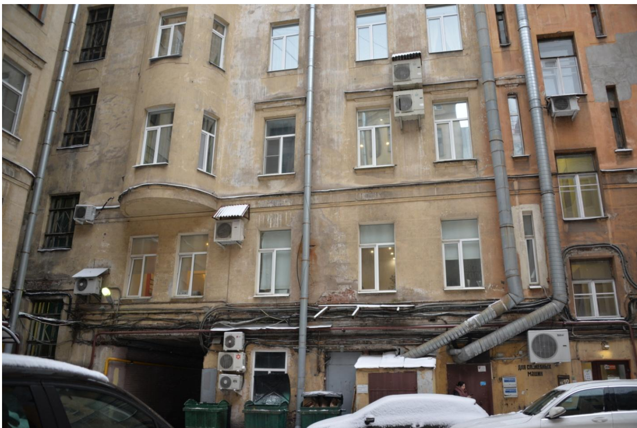
Фото 5. Фрагмент дворового фасада выявленного объекта культурного наследия «Дом А.М. Александрова» (04.03.2022 г.)
