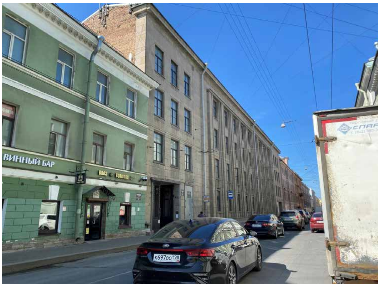
6. Общий вид лицевого фасада объекта культурного наследия по Гороховой улице.
