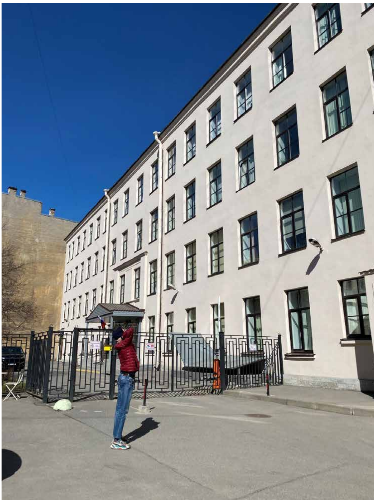
10. Фрагмент центральной и северной частей дворового фасада объекта культурного наследия.
