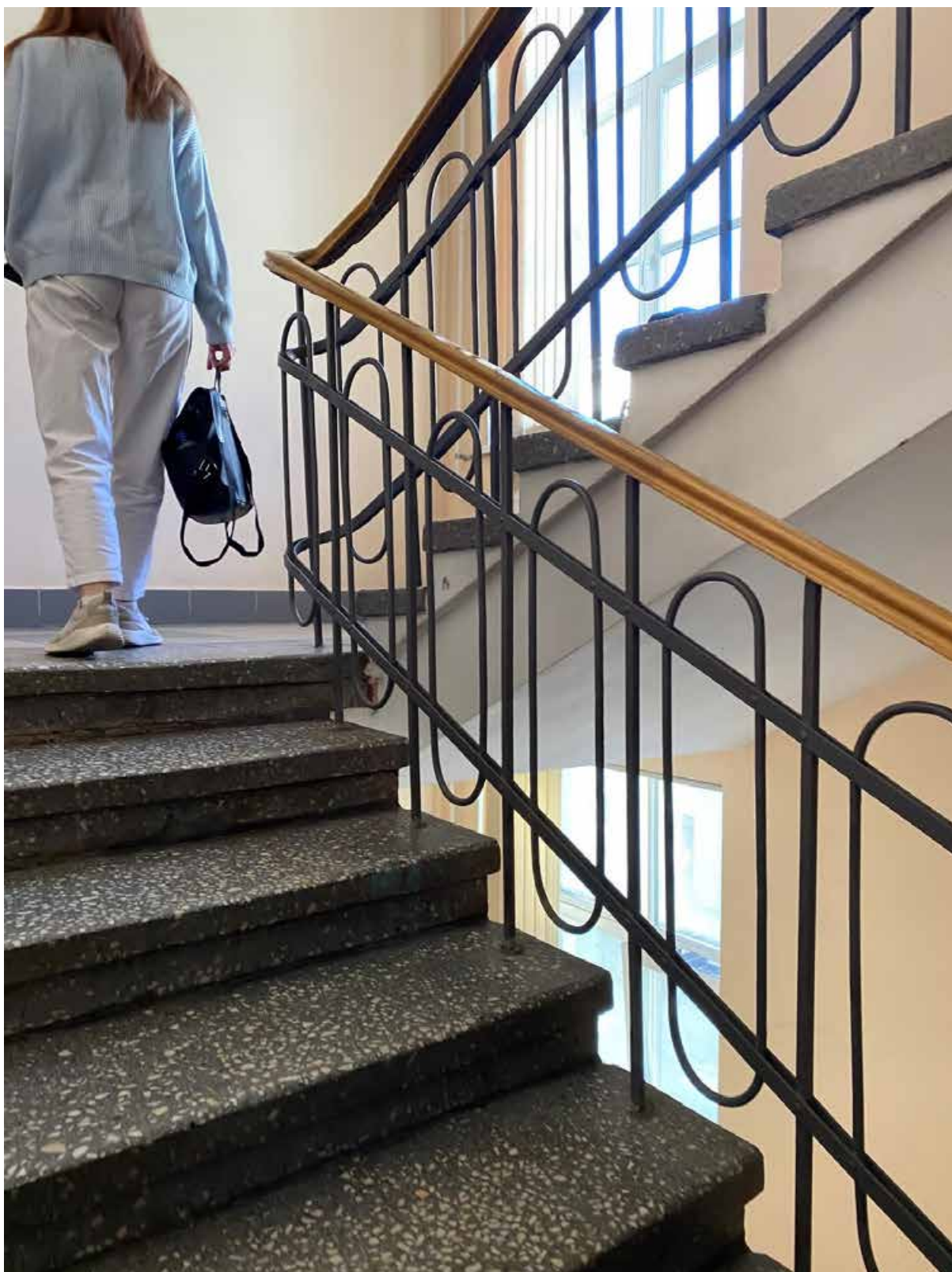
35. Фрагмент южной лестницы объекта культурного наследия в уровне 3-го этажа.
