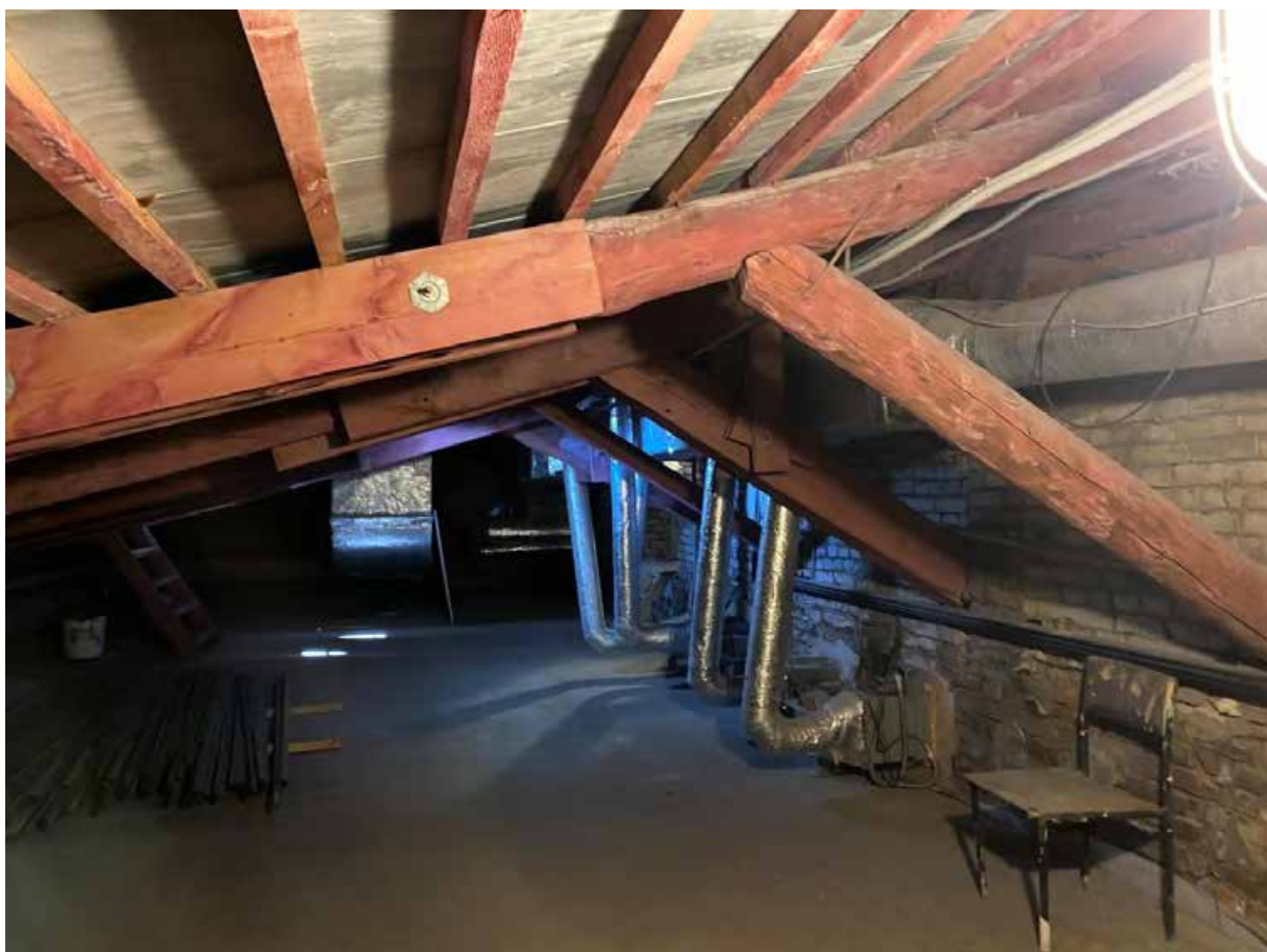
51. Стропильная система объекта культурного наследия.
