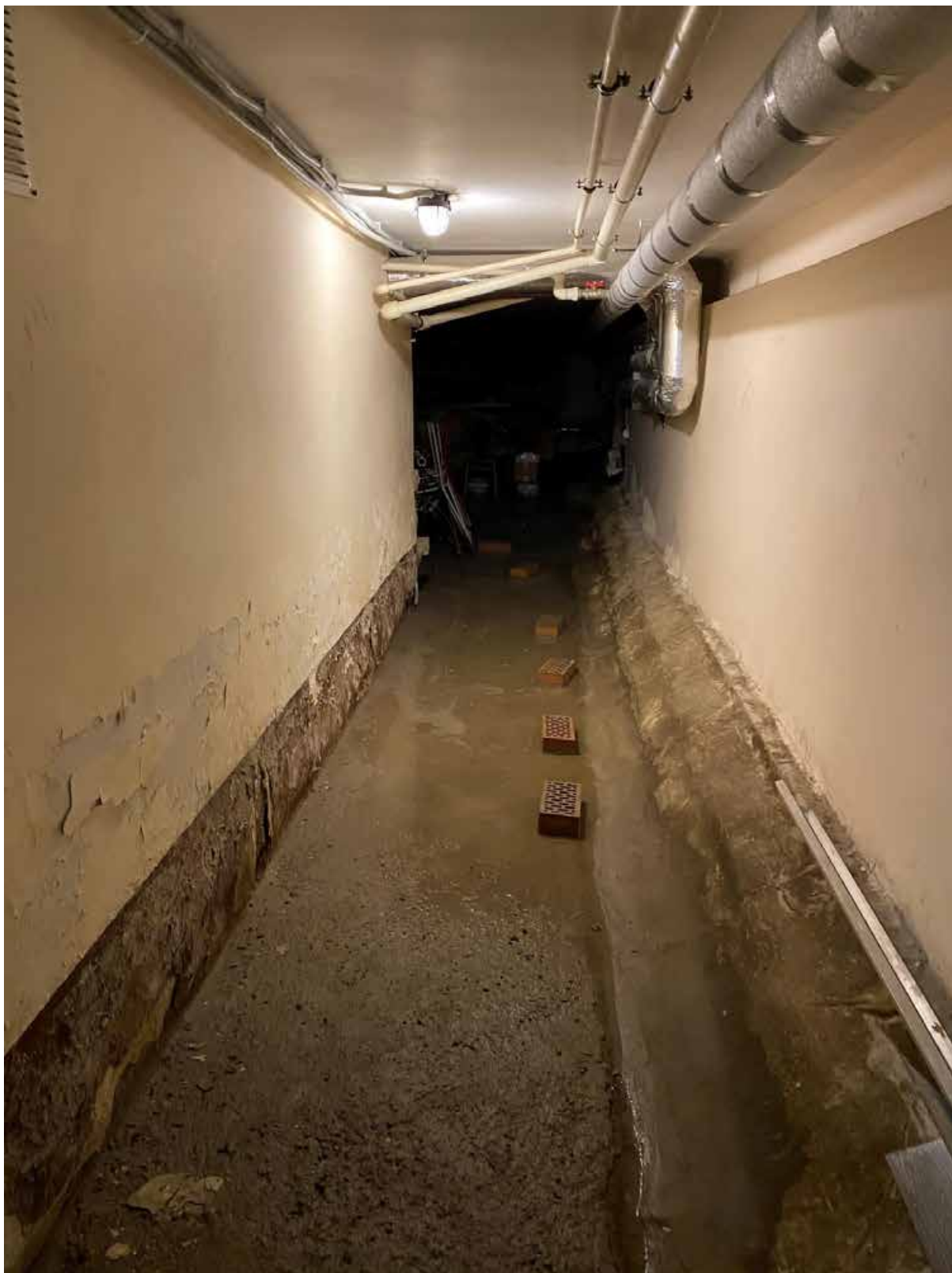
25. Помещение подвального этажа объекта культурного наследия.
