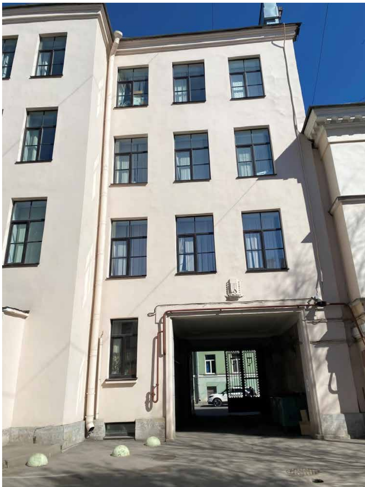
9. Фрагмент южной части дворового фасада объекта культурного наследия.
