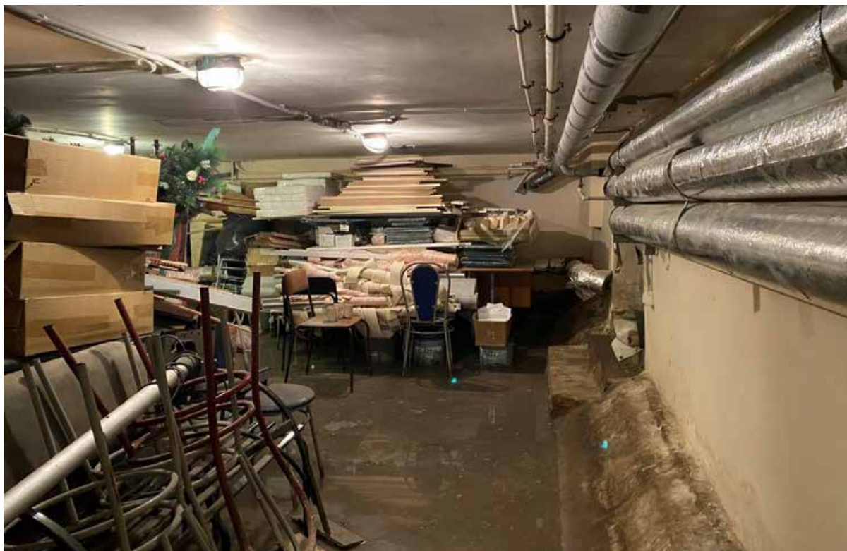
26. Помещение подвального этажа объекта культурного наследия.
