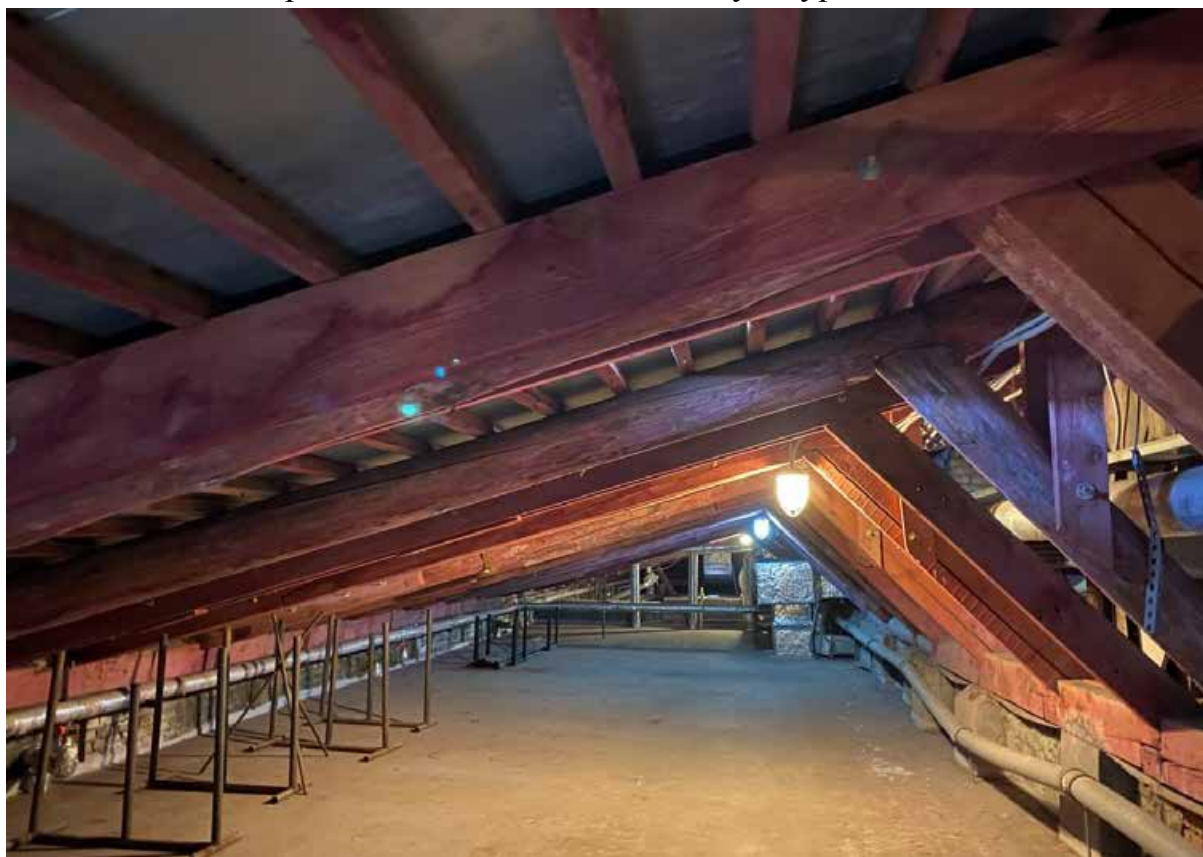
50. Стропильная система объекта культурного наследия.
