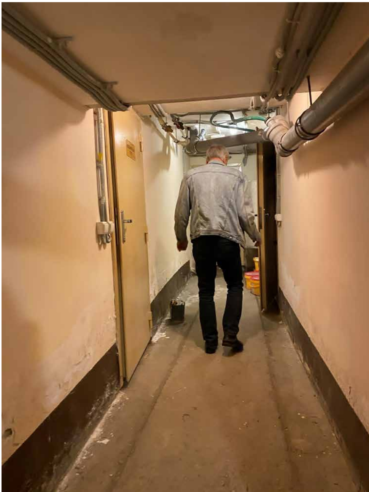
20. Помещение подвального этажа объекта культурного наследия.
