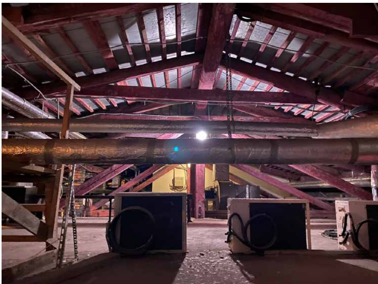
49. Стропильная система объекта культурного наследия.
