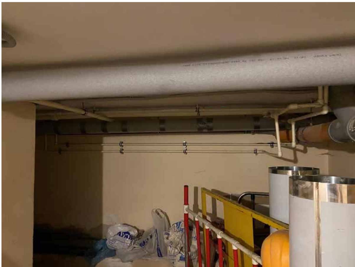
19. Помещение подвального этажа объекта культурного наследия.
