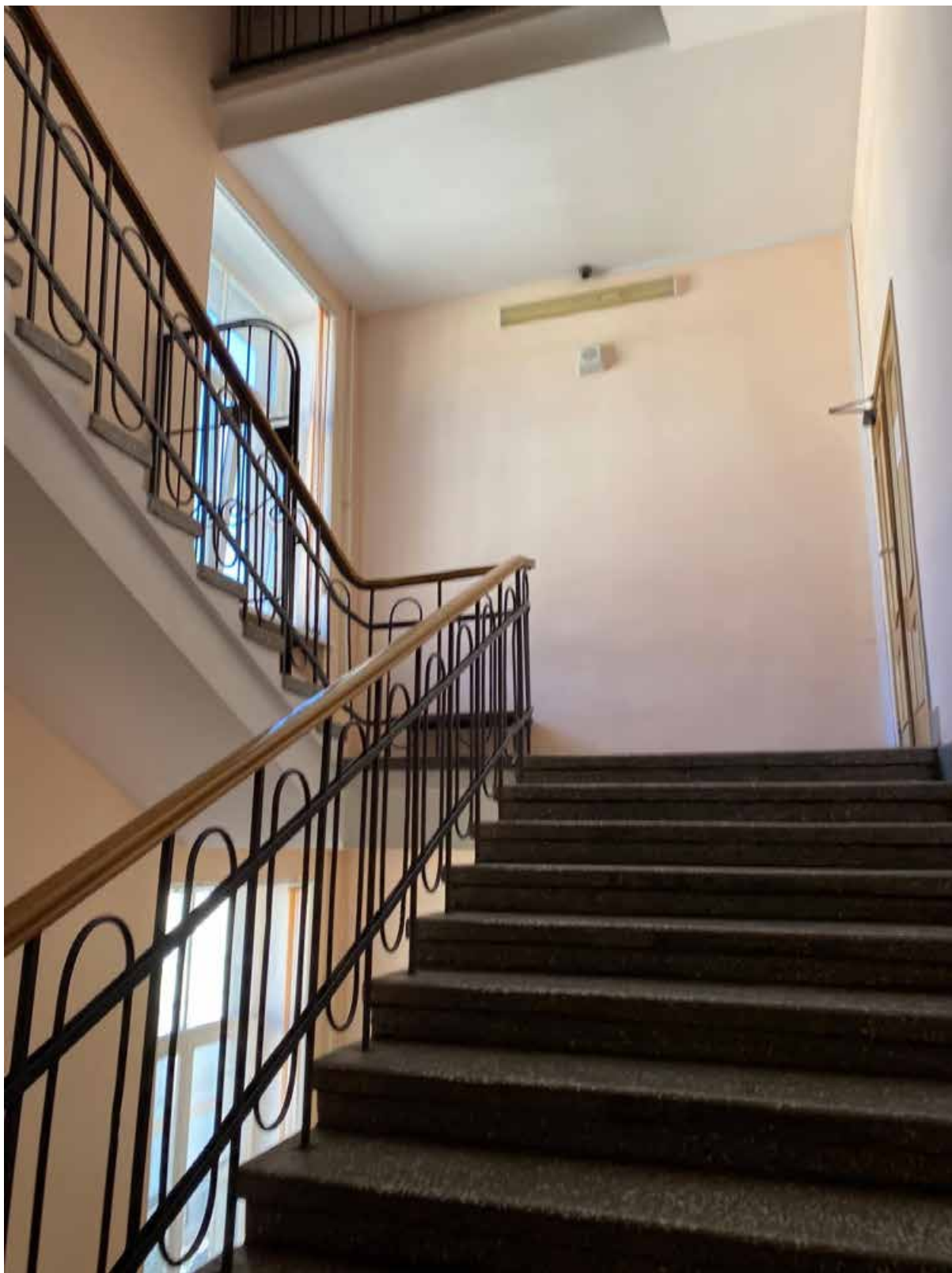
41. Общий вид южной северной объекта культурного наследия в уровне 4-го этажа.
