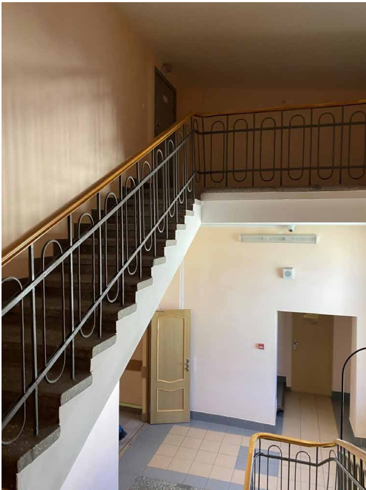
48. Общий вид южной лестницы объекта культурного наследия в уровне 4-го этажа.
