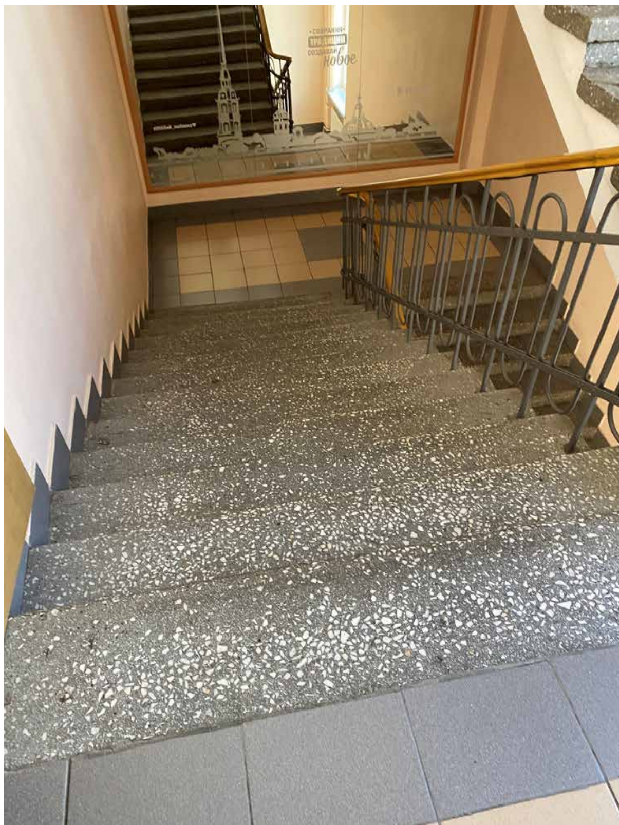
39. Общий вид южной северной объекта культурного наследия в уровне 3-го этажа.
