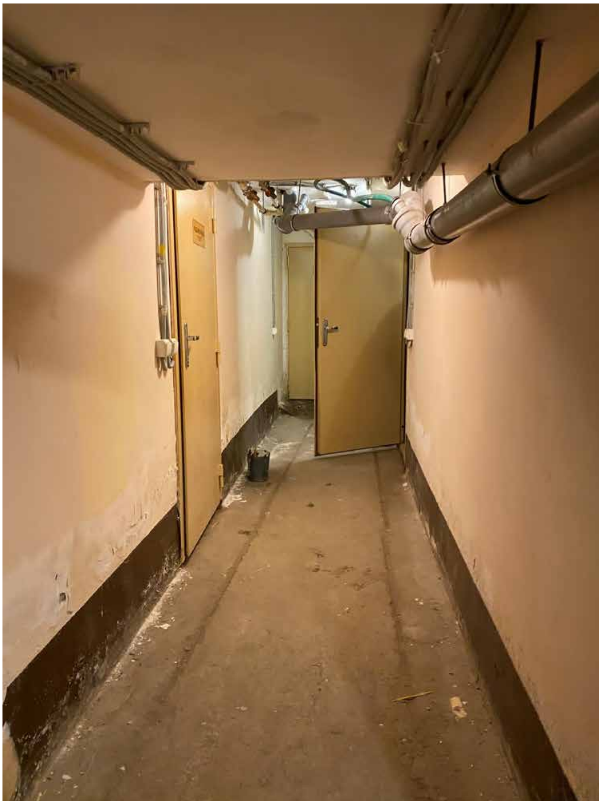
23. Помещение подвального этажа объекта культурного наследия.
