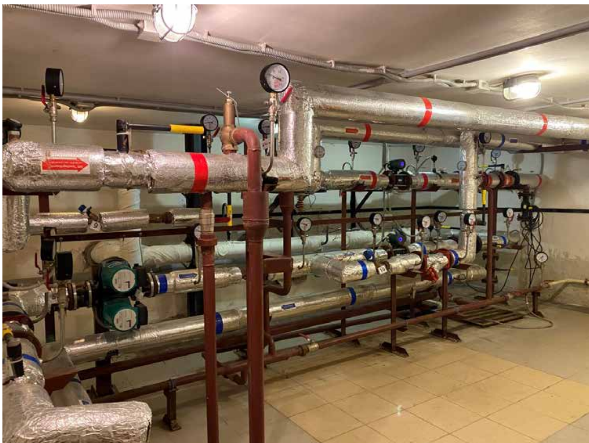
24. Помещение подвального этажа объекта культурного наследия.
