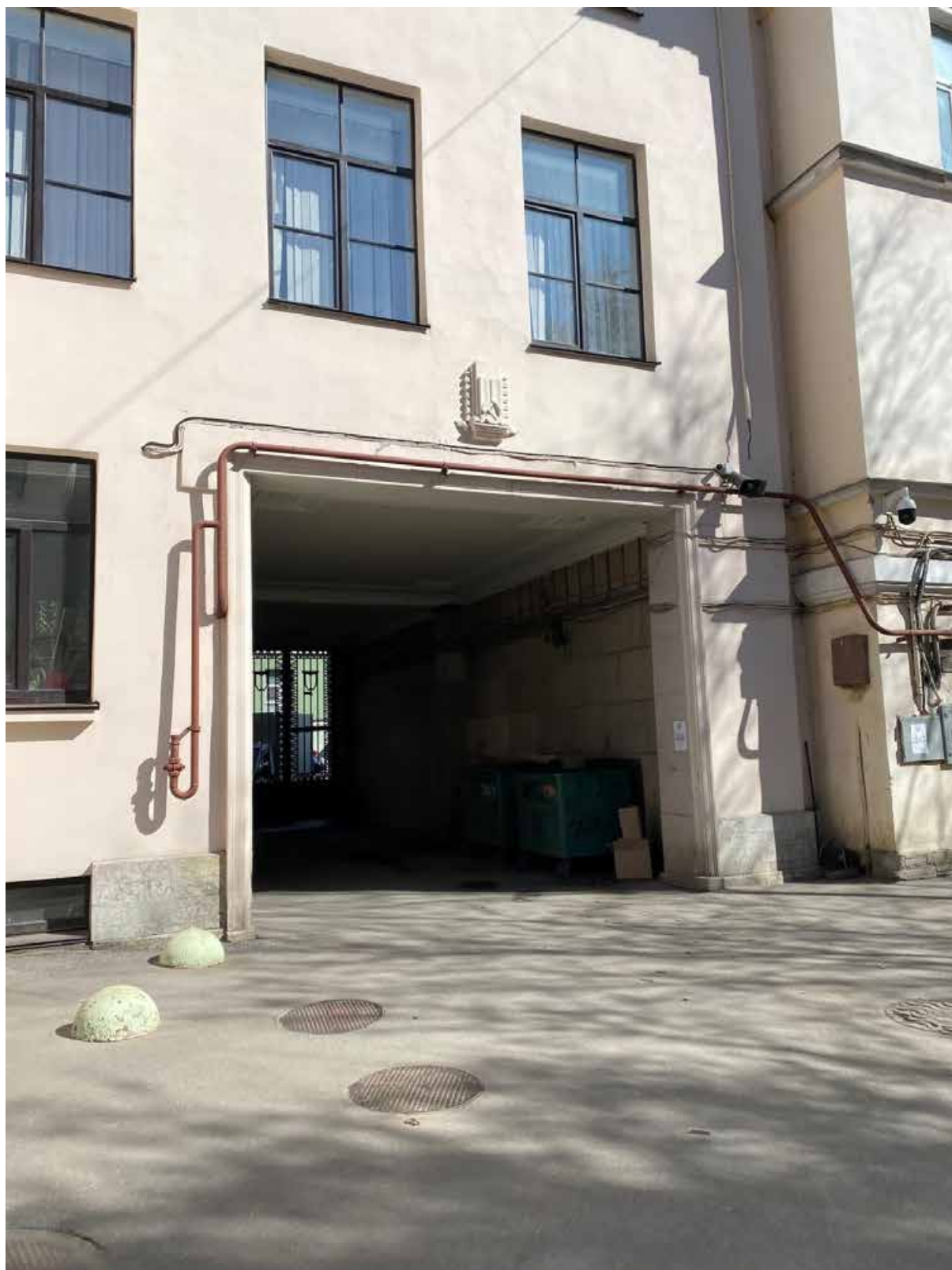
11. Воротный проезд (южный) объекта культурного наследия.
