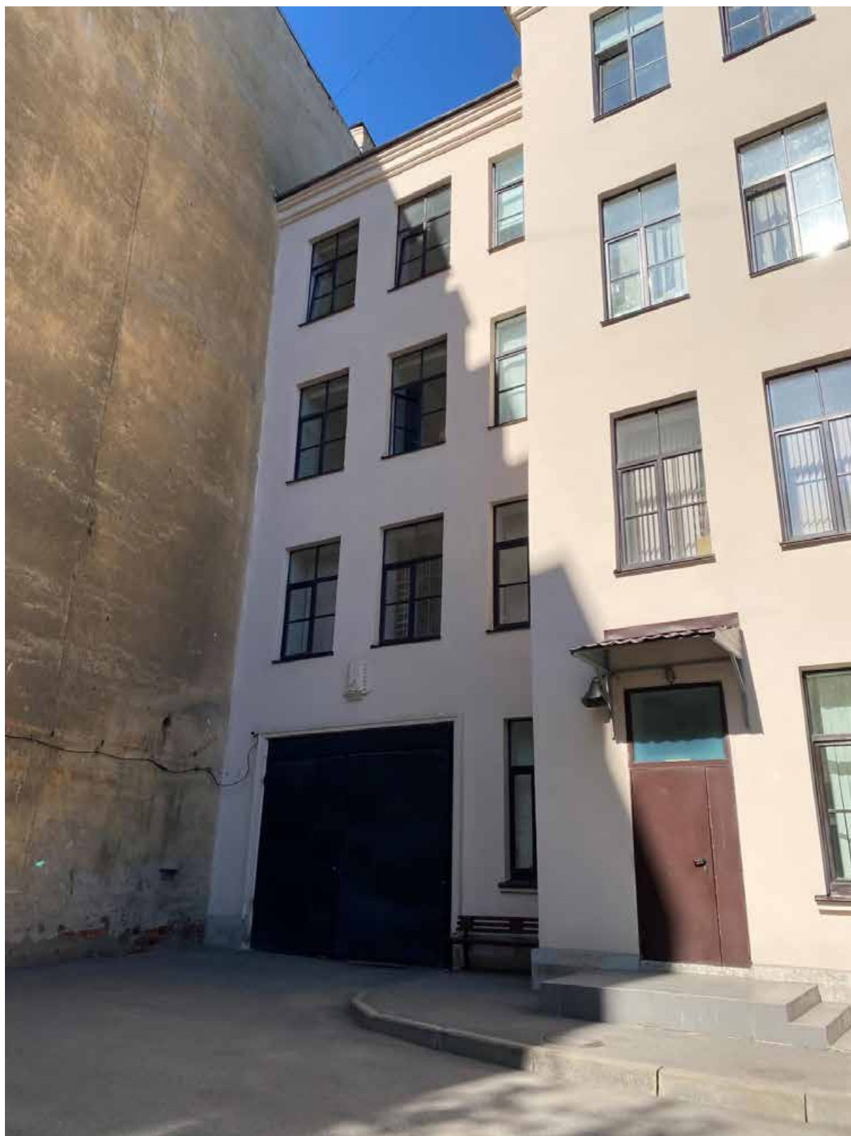
13. Воротный проезд с воротным заполнением (северный) объекта культурного наследия.
