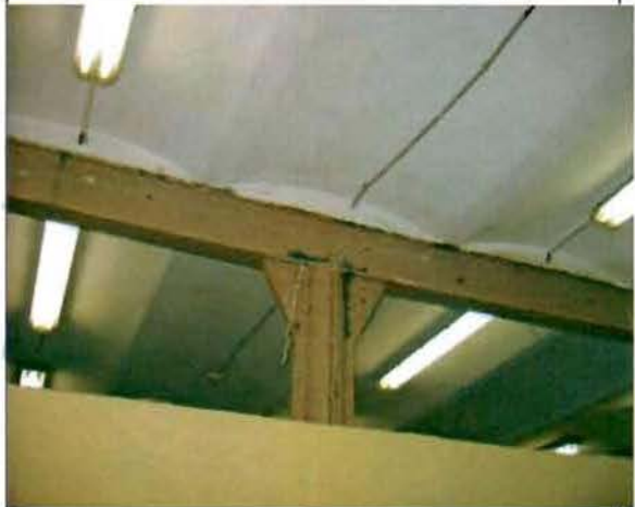
Фото 23. Интерьер. Металлические клепанные колонны и балки. Фрагмент.
