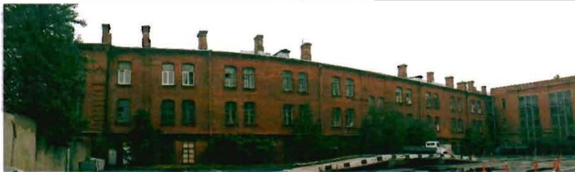
Фото 29. Западный фасад. Общий вид.
