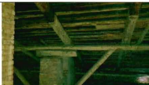
Фото 38. Конструкции крыши. Фрагмент.
