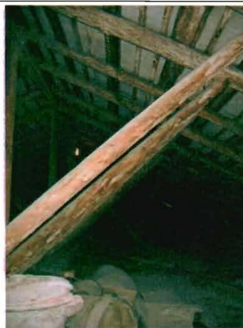
Фото 27. Конструкции крыши. Фрагмент.
