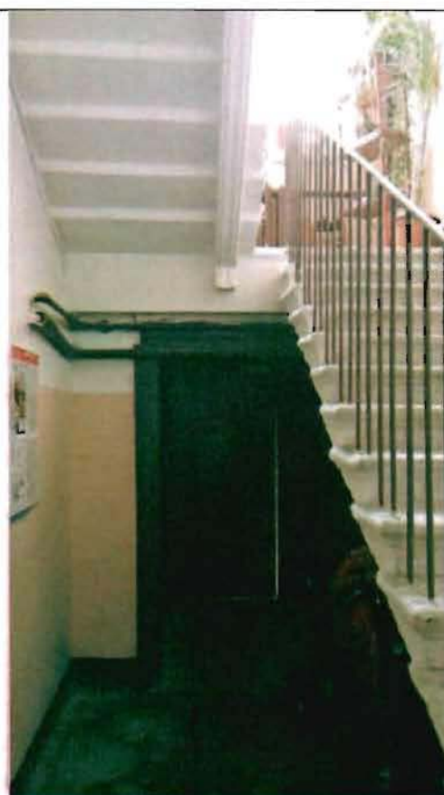
Фото 131. Лестница № 2 в северной части здания. Общий вид.
