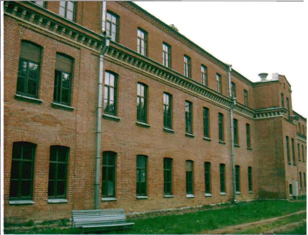
Фото 66. Южный фасад. Общий вид. 05.07.2016.
