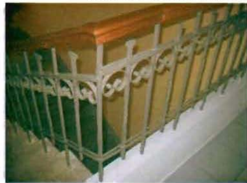
Фото 73. Интерьер. Лестница в центральной части здания. Фрагмент перильного ограждения.
