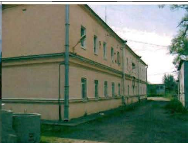
Фото 111. Западный фасад. Общий вид.
