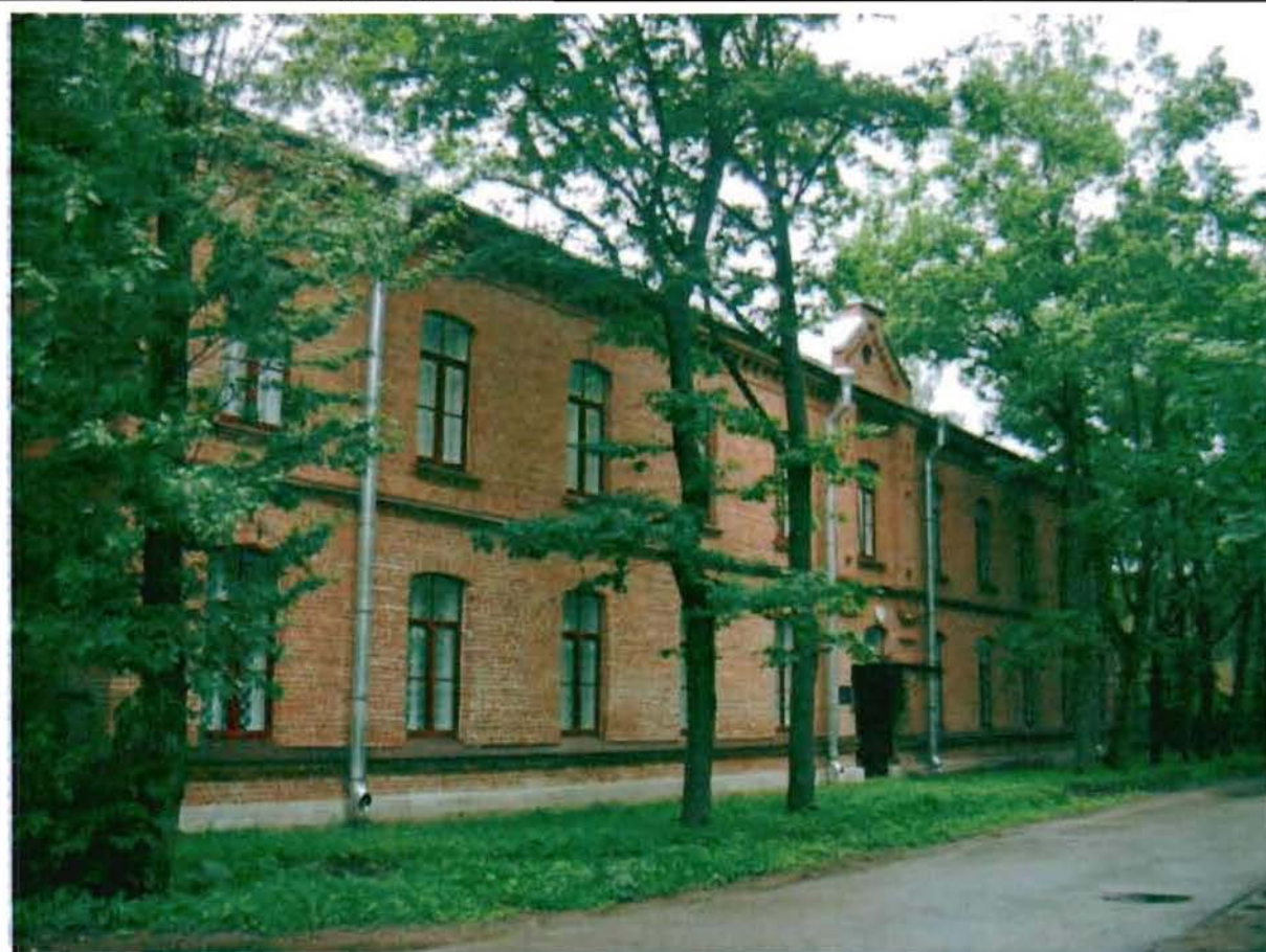
Фото 39. Восточный фасад. Общий вид.
