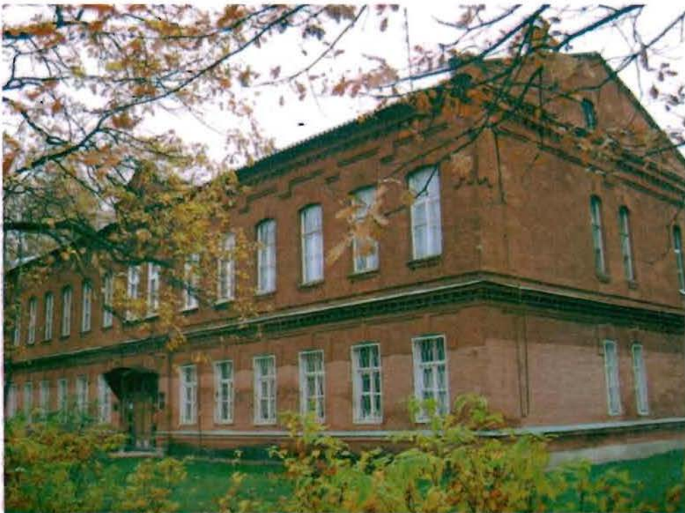
Фото 89. Западный, южный фасады. Общий вид.
