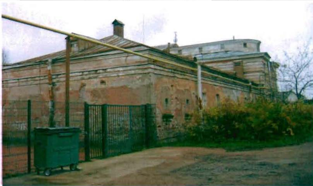
Фото 24. Западный, северный фасады. Общий вид.
