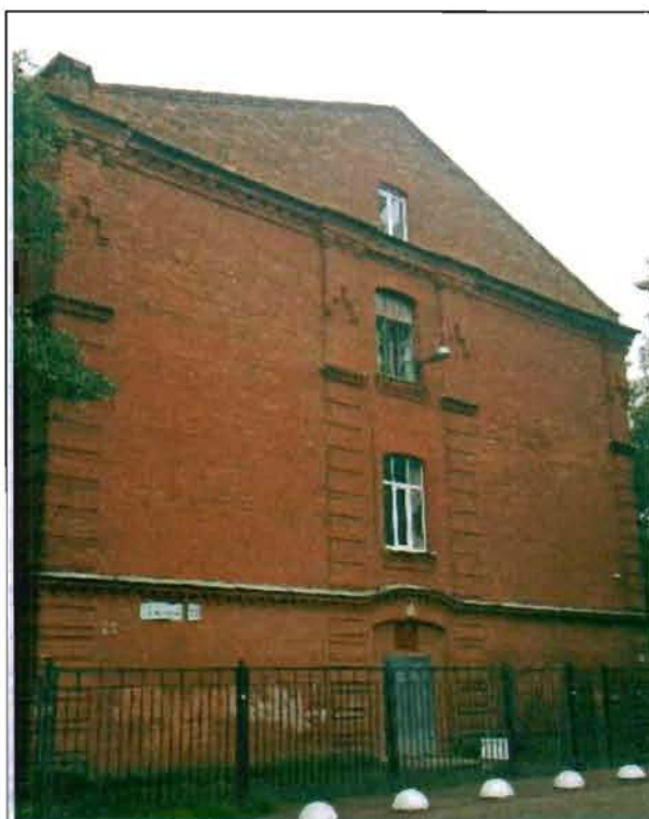
Фото 49. Северный фасад. Общий вид.
