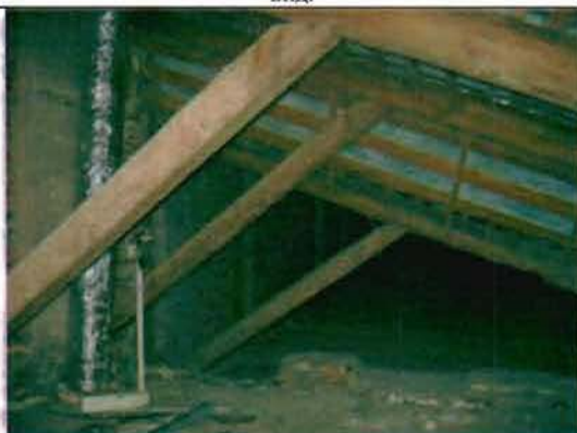
Фото 76. Конструкции крыши. Общий вид.
