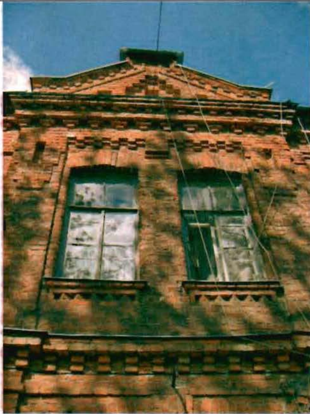
Фото 177. Восточный фасад. Центральная часть. Фрагмент.
