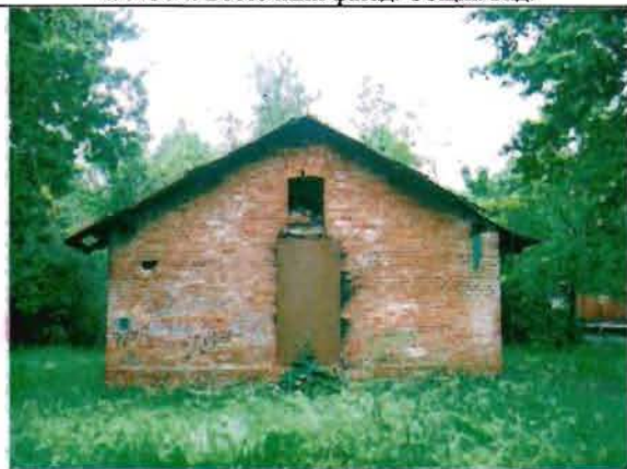
Фото 96. Западный фасад. Общий вид.
