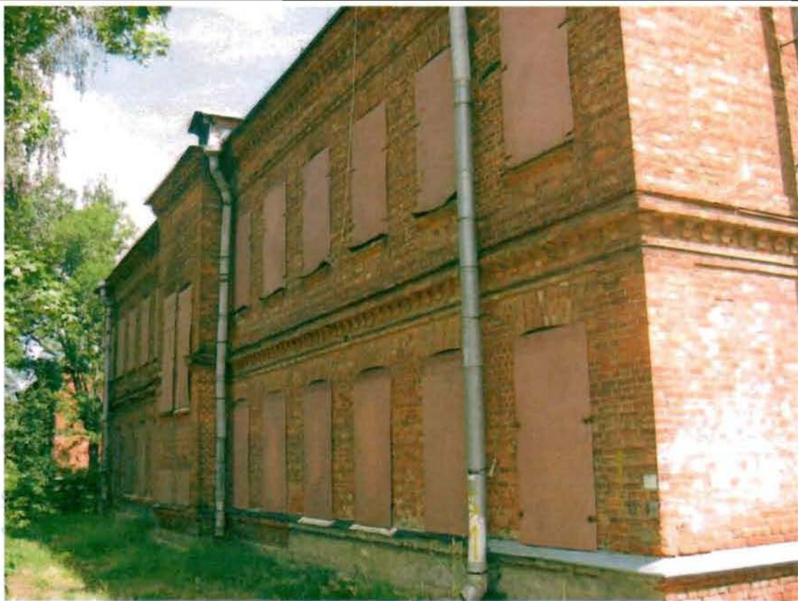
Фото 119. Западный фасад. Общий вид.
