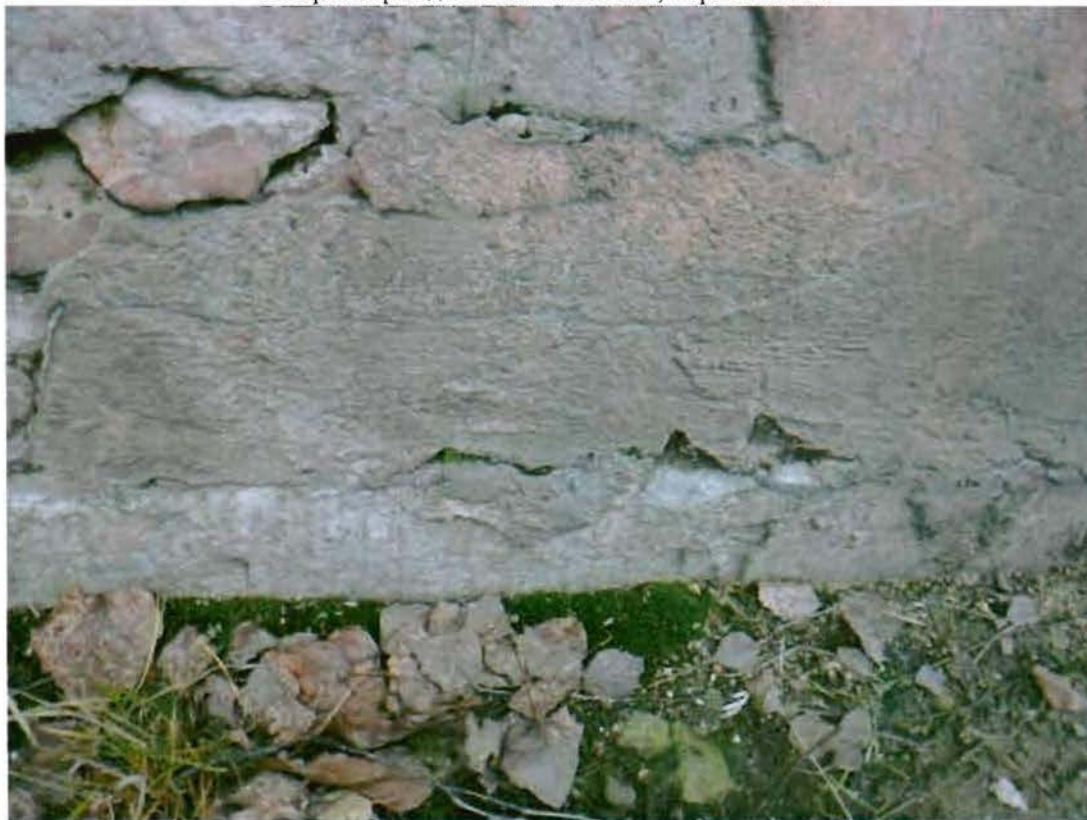
Цоколь, облицованный известняковой скобой. Съемка 27.11.2012, Воронина Н.В.
