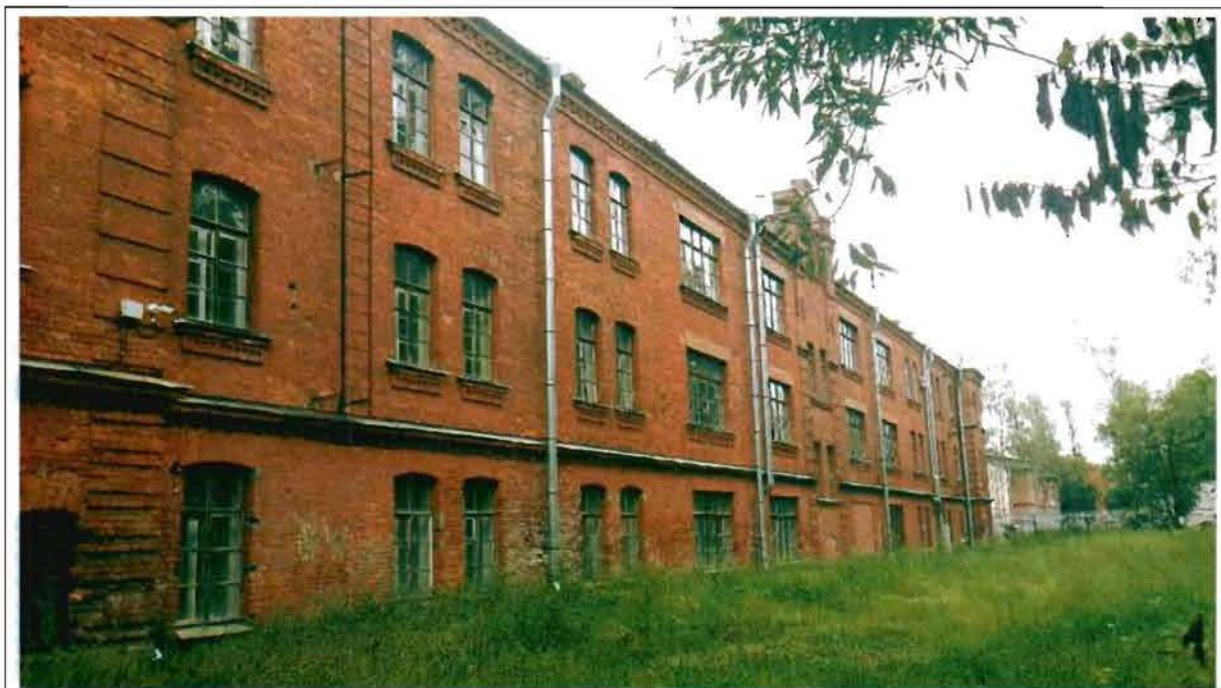
Фото 48. Западный фасад. Общий вид.
