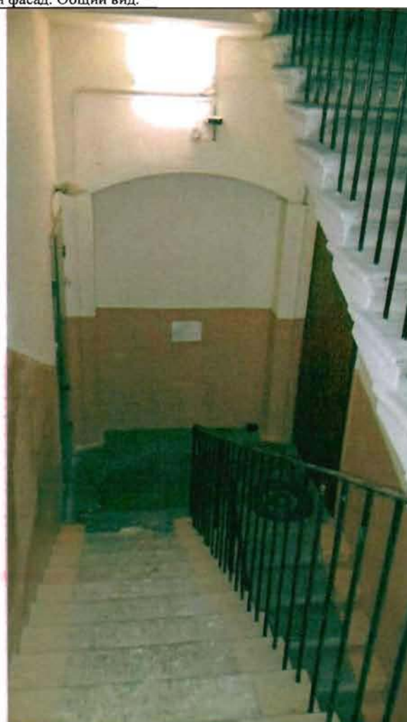
Фото 173. Лестница № 1 в северной части здания. Фрагмент.
