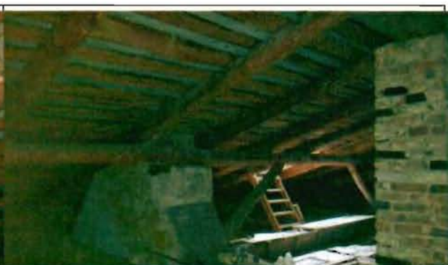
Фото 63. Конструкции крыши. Общий вид.
