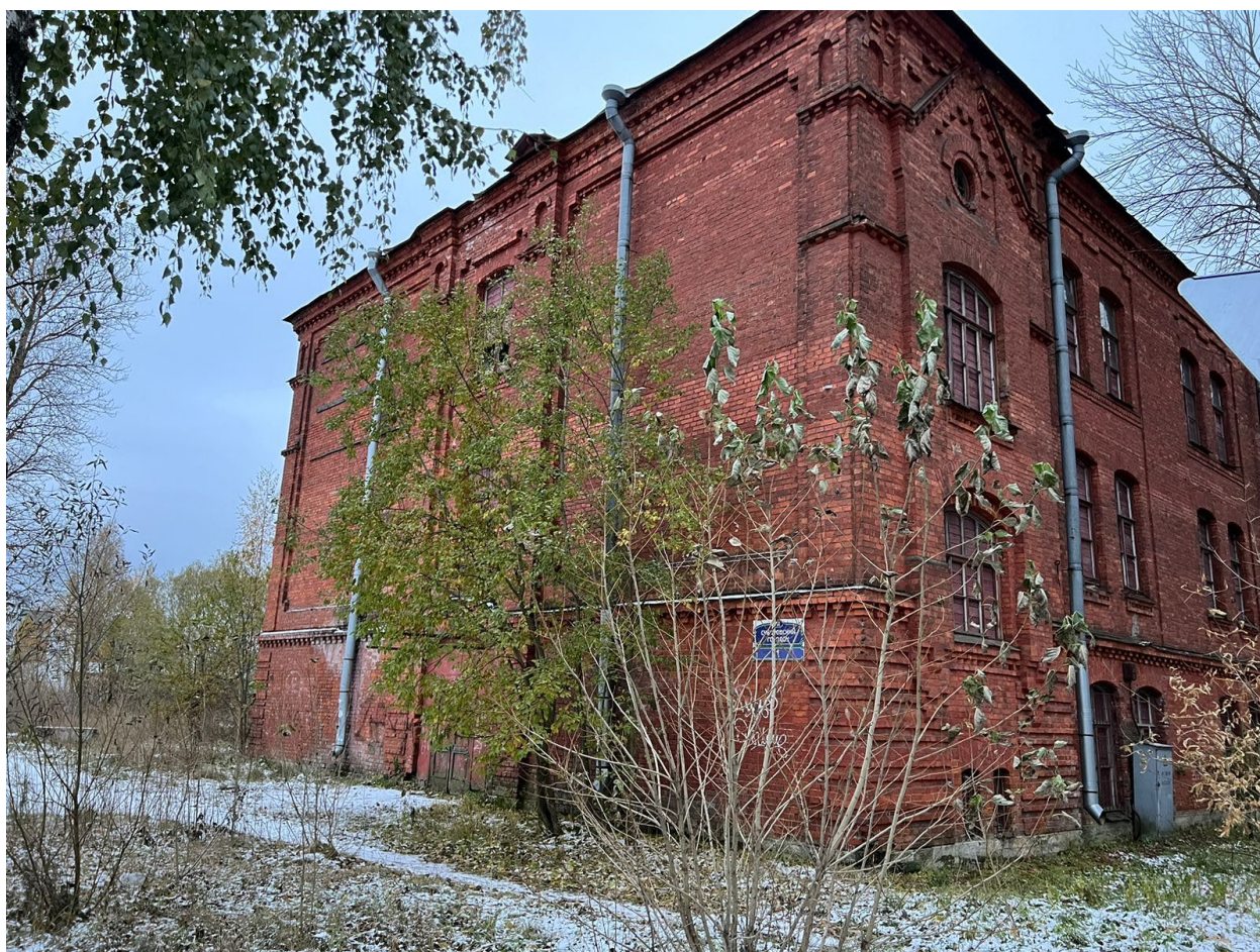
6. Вид на северо-восточный фасад в сторону объект культурного наследия регионального значения «Казармы 148-го пехотного Каспийского полка (с территорией). Казарма» по адресу: Санкт-Петербург, г. Петергоф, Суворовский городок, д. 1, литера А, от зоны производства работ.
