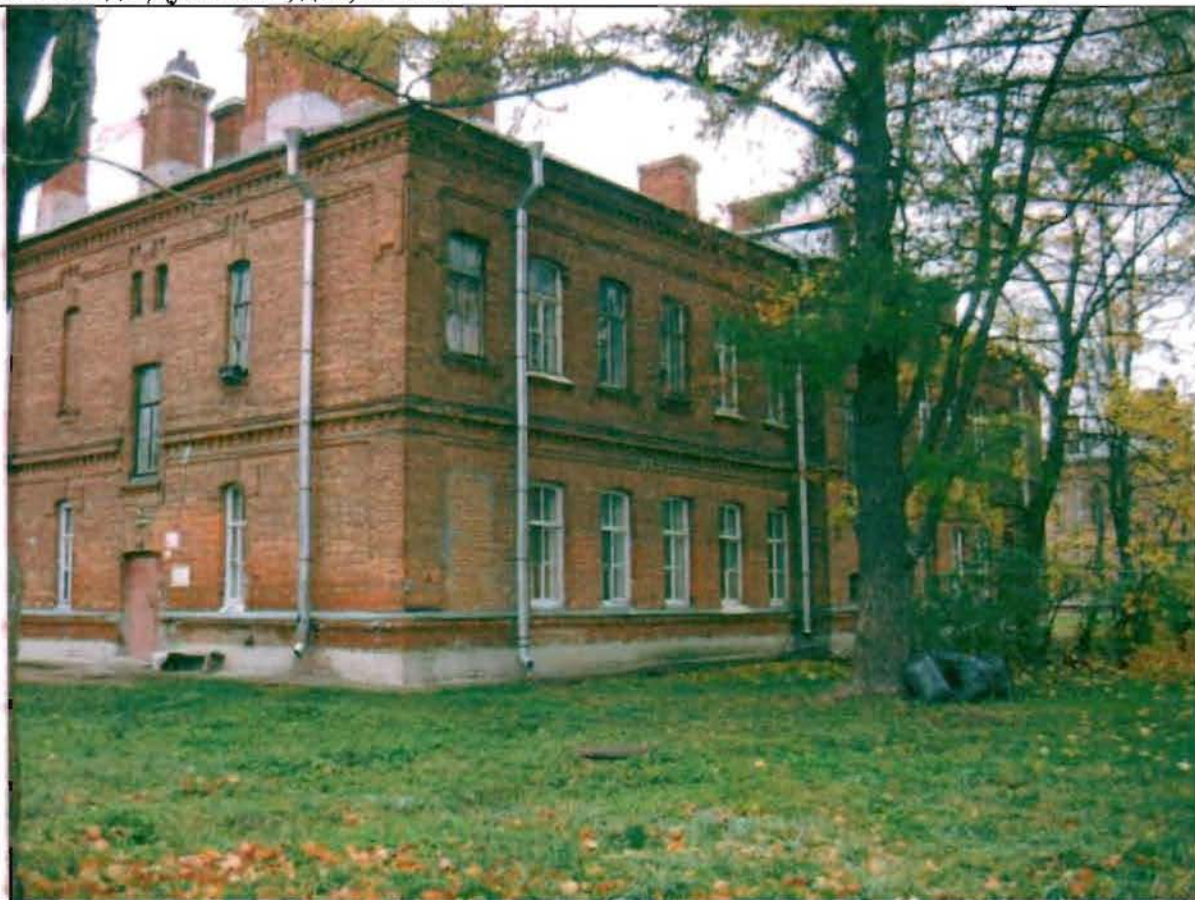
Фото 145. Восточный фасад. Общий вид.
