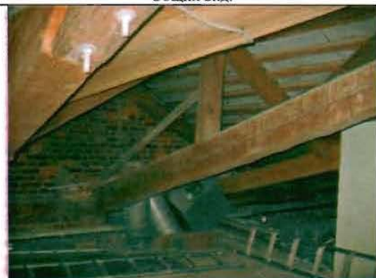
Фото 77. Конструкции крыши. Общий вид.
