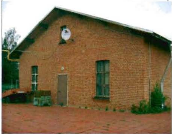
Фото 21. Южный фасад. Общий вид.
