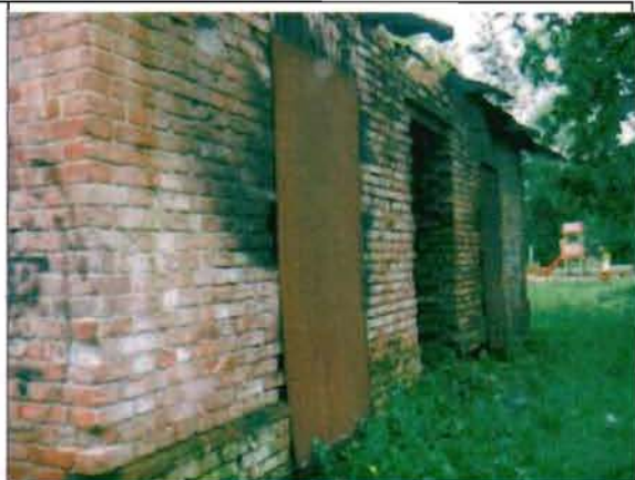
Фото 95. Северный фасад. Общий вид.
