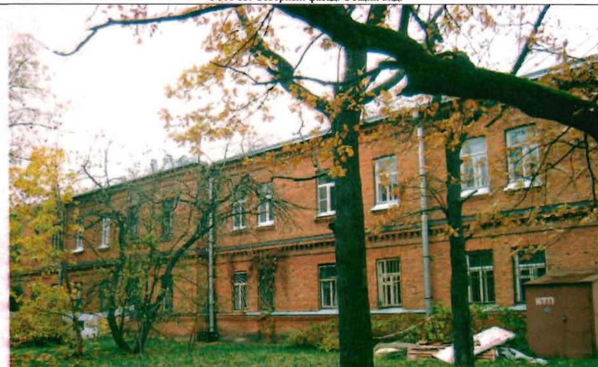
Фото 84. Южный фасад. Общий вид.
