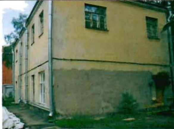
Фото 45. Южный, западный фасад. Общий вид.
