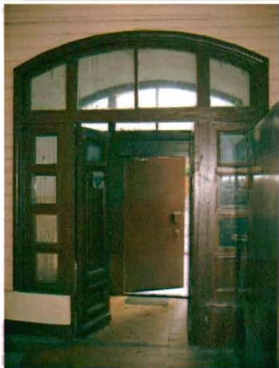
Фото 107. Дверной проем тамбура. Общий вид.
