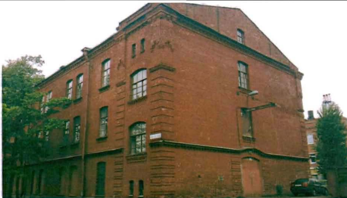
Фото 30. Северный фасад. Общий вид.
