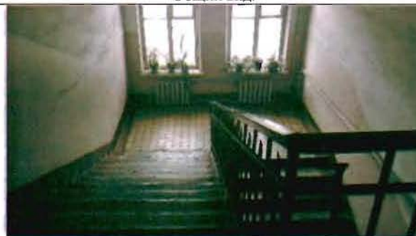
Фото 34. Интерьер. Лестница. Общий вид.
