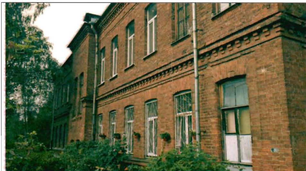
Фото 171. Восточный фасад. Общий вид.
