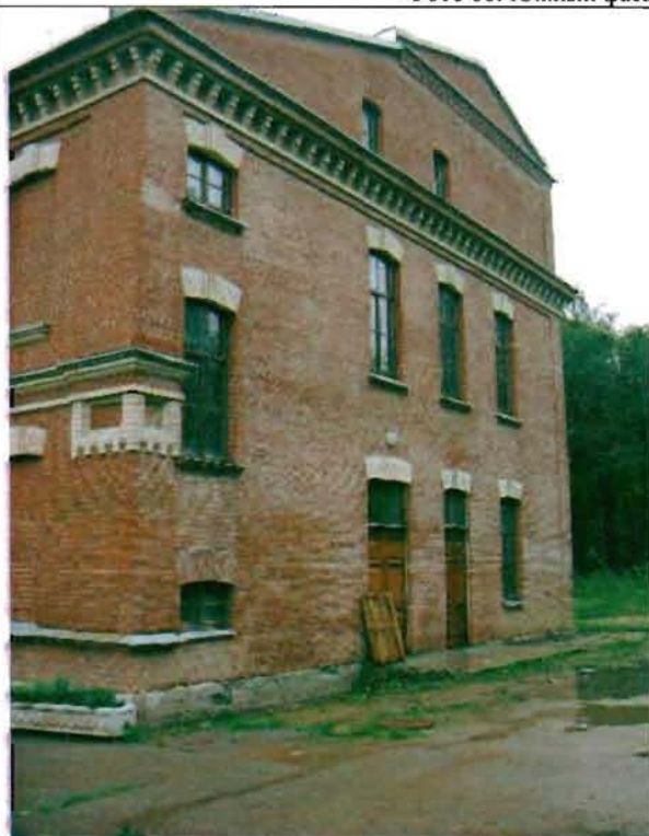
Фото 67. Западный фасад. Общий вид.
