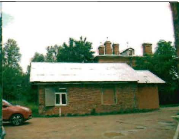
Фото 154. Южный фасад. Общий вид.
