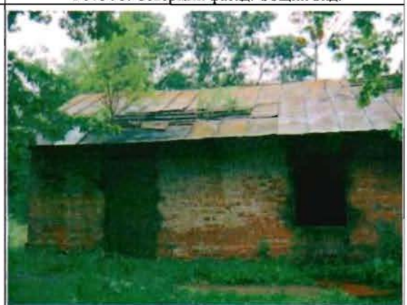
Фото 97. Южный фасад. Общий вид.
