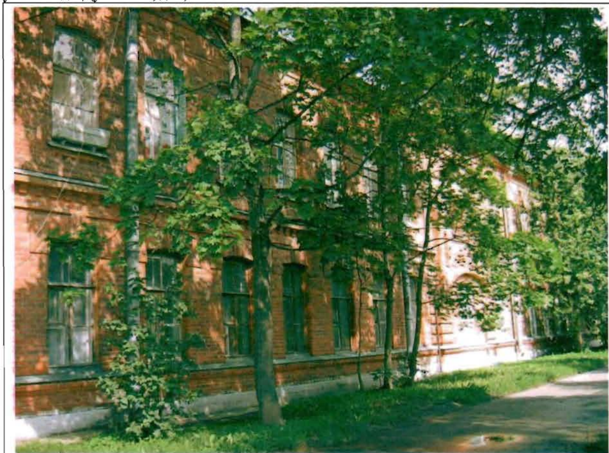
Фото 136. Восточный фасад. Общий вид.
