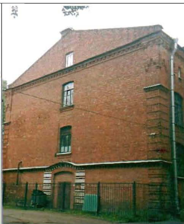
Фото 50. Южный фасад. Общий вид.
