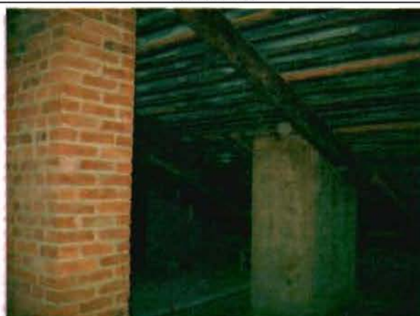
Фото 152. Конструкции крыши. Фрагмент.
