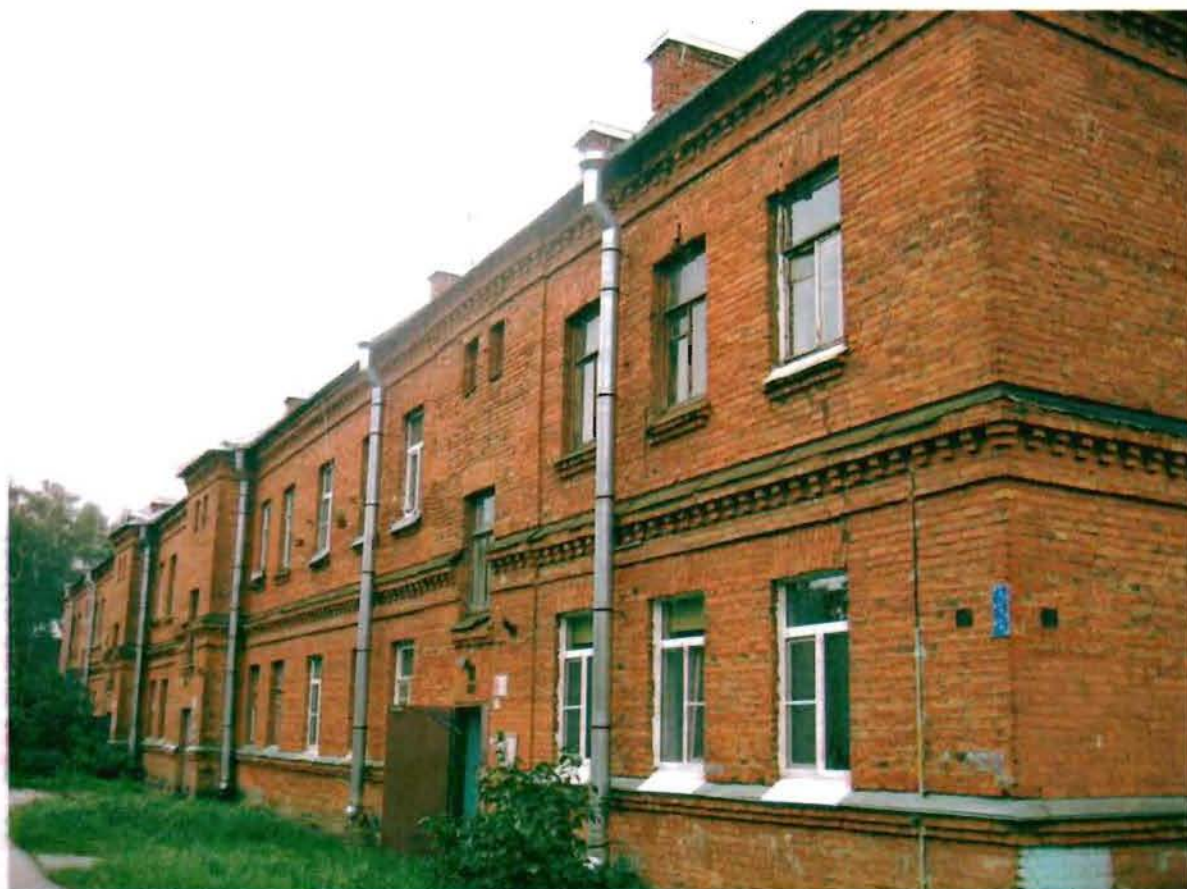
Фото 83. Северный фасад. Общий вид.
