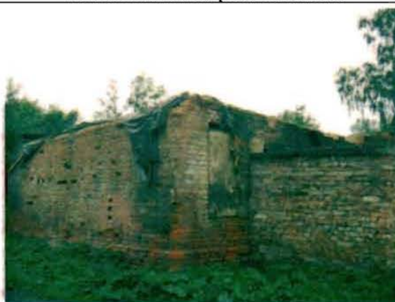
Фото 187. Северный фасад. Общий вид.
