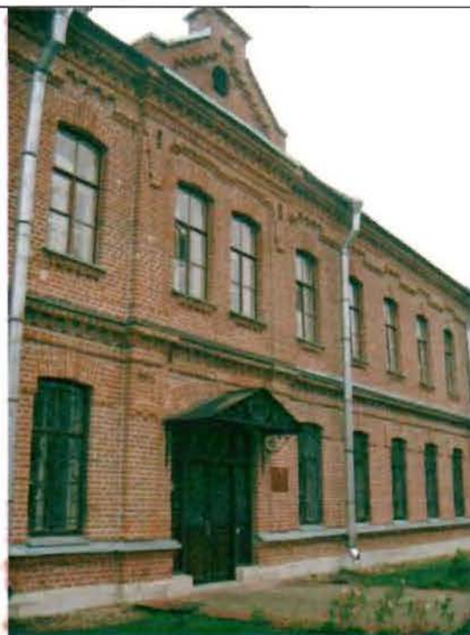
Фото 135. Западный фасад. Фрагмент центральной части фасада.
