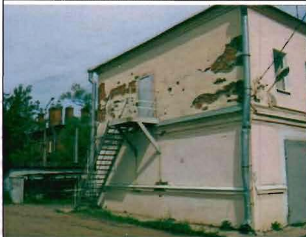
Фото 112. Южный фасад. Общий вид.
