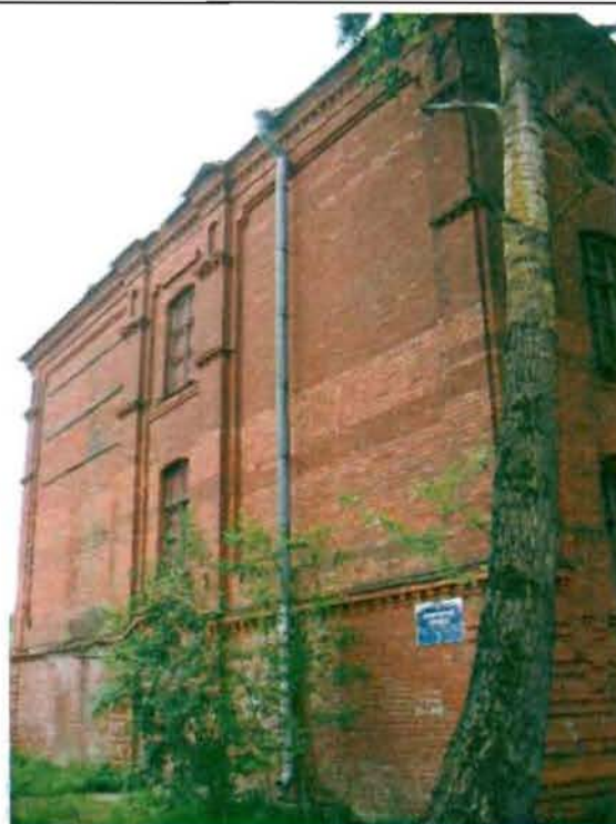
Фото 6. Северный фасад. Общий вид.
