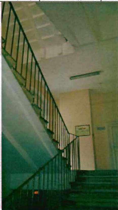
Фото 60. Интерьер. Лестница в южной части здания. Фрагмент.
