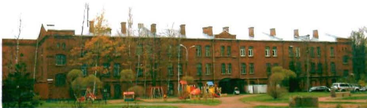
Фото 28. Восточный фасад. Общий вид.
