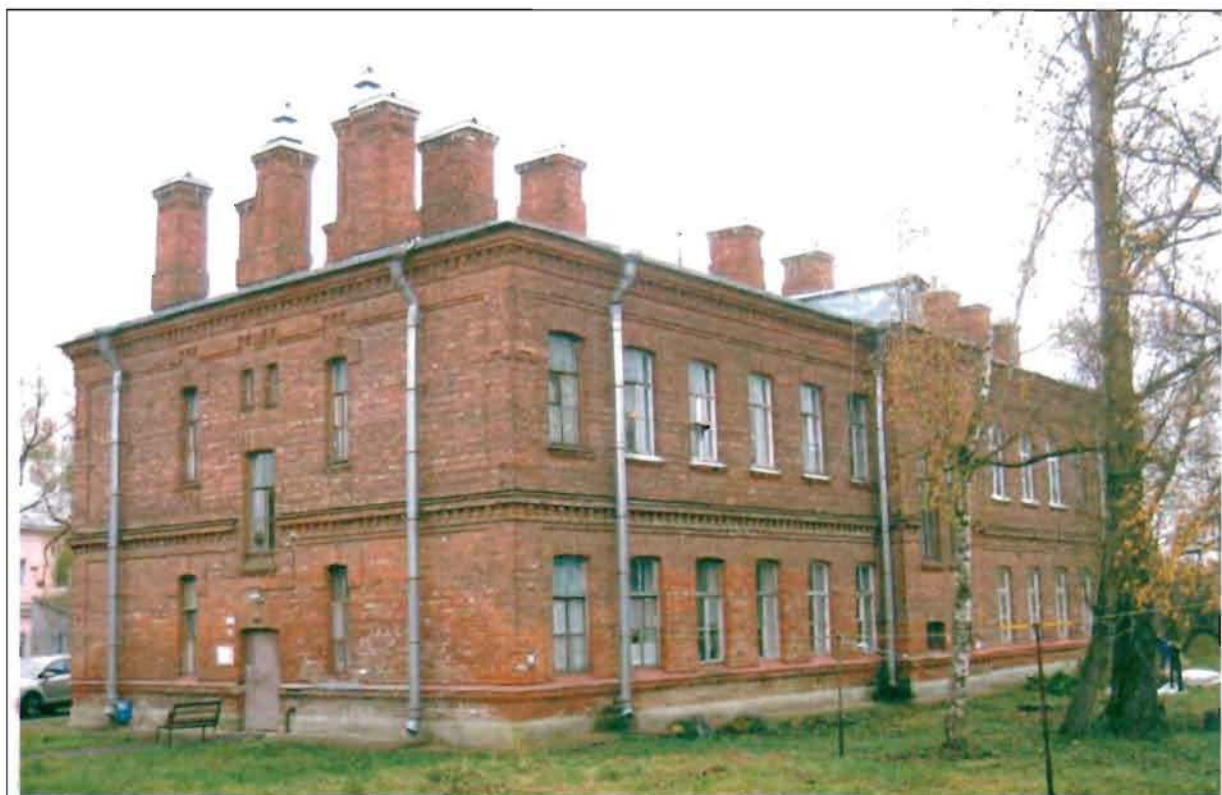
Фото 129. Западный, северный фасады. Общий вид.
