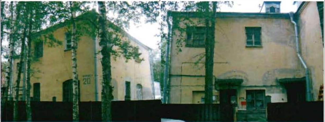
Фото 43. Северный, восточный фасады. Общий вид.
