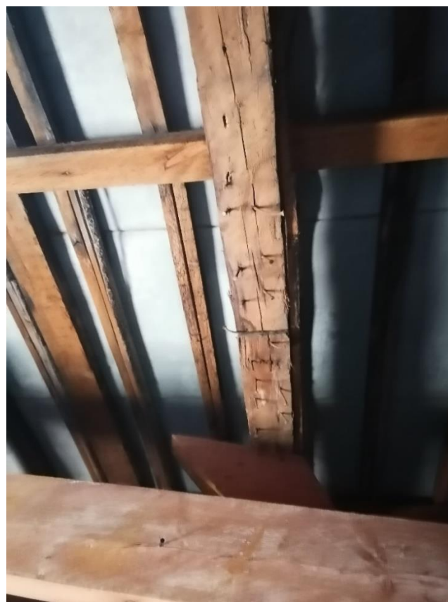
Илл.35. Балка-прогон и обрешетка кровли. 05.07.2021г.
