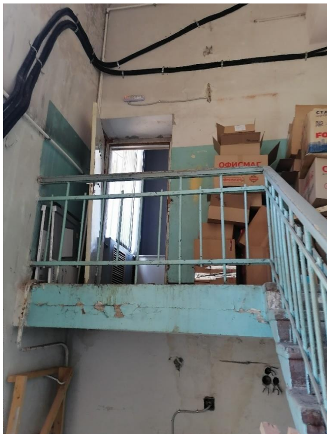
Илл.28. Лестничная клетка в части здания со стороны Кондратьевского проспекта. Верхняя площадка. 05.07.2021г.
