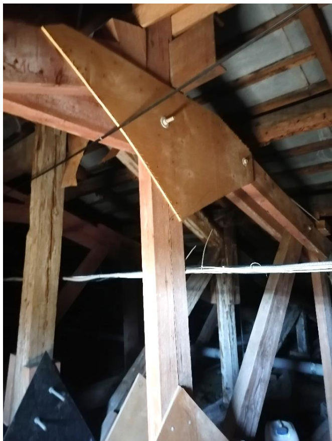
Илл.36. Фрагмент деревянных ферм чердачных перекрытий. 05.07.2021г.
