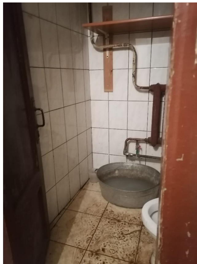
Илл.52.1. Санузел. Помещение №31. 05.07.2021г.
