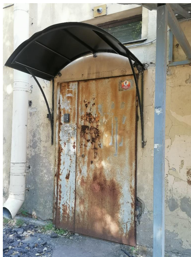
Илл.10.1. Вход со стороны дворового фасада. 05.07.2021г.
