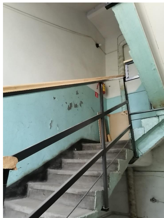
Илл.31. Лестничная клетка в части здания со стороны Полуостровского проспекта. Лестничный марш. 05.07.2021г.
