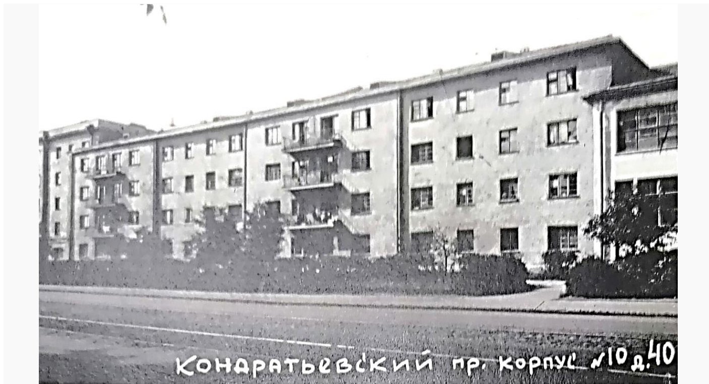
Илл.34. Корпус 10 в примыкании к угловому универмагу. Вид со стороны улицы. 1949г. ЦГА КФФД СПб. Гр 83200.
