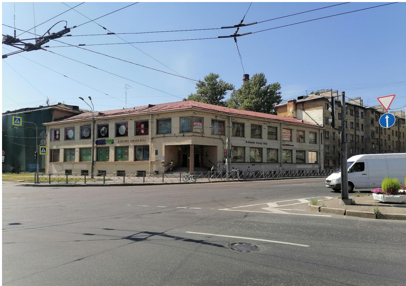
Илл.1 Фасад здания Калининского универмага на пересечении Кондратьевского и Полюстровского проспектов. Общий вид. 05.07.2021г.
