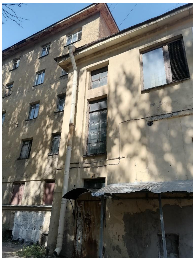
Илл.10. Фрагмент дворового фасада. 05.07.2021г.
