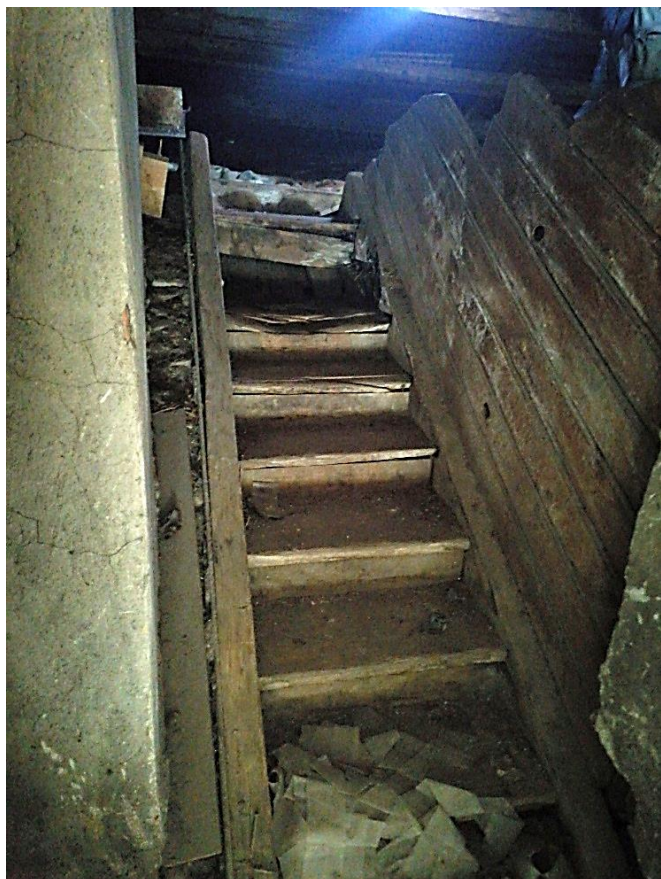
Илл.32. Деревянная лестница на чердак в части здания со стороны Полкустровского проспекта. 05.07.2021г.
