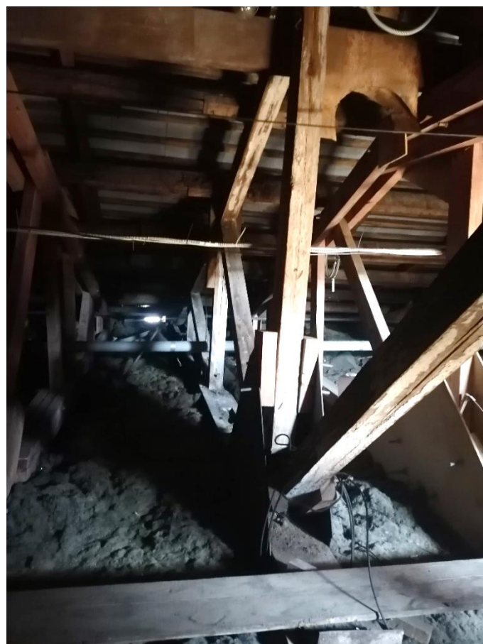
Илл.39. Фрагмент деревянных ферм чердачных перекрытий. 05.07.2021г.
