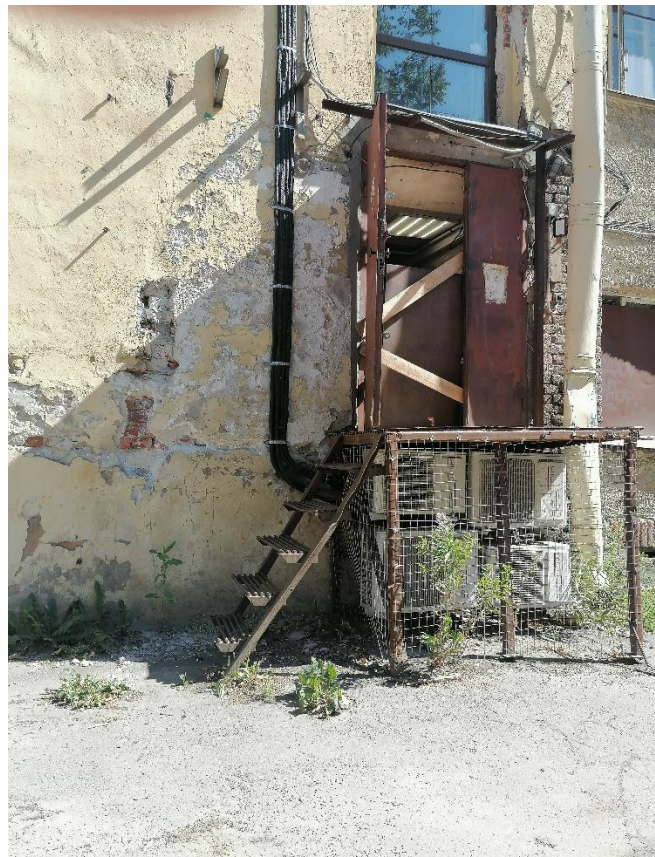
Илл.11.1. Вход со стороны дворового фасада. 05.07.2021г.
