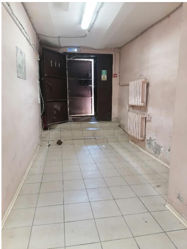
Илл.40. Подвал. Вход в подвал в части здания со стороны Полюстровского проспекта. 05.07.2021г.
