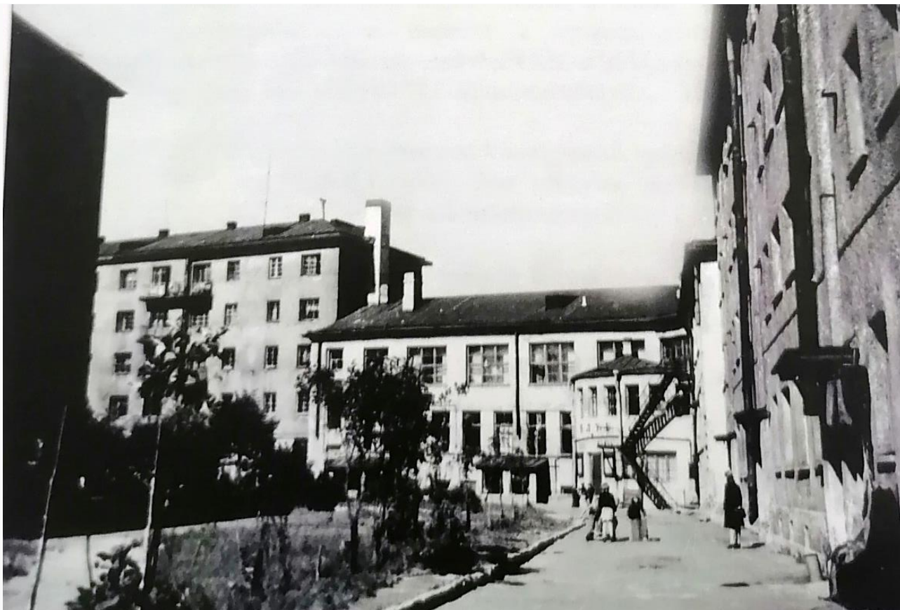
Илл.36. Вид на универмаг Кондратьевского жилмассива. Дворовая территория (1950-ые гг.). ЦГАКФФД СПб, Бр 46923.
