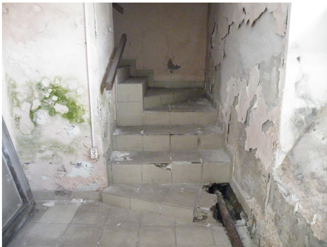
Илл.45. Подвал. Помещение №4 с лестницей в части здания со стороны Полюстровского проспекта. 05.07.2021г.
