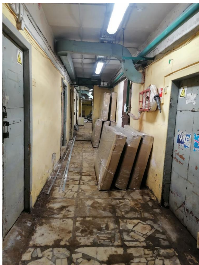
Илл.48. Подвал. Коридор (помещение №14) в части здания со стороны Кондратьевского проспекта. 05.07.2021г.
