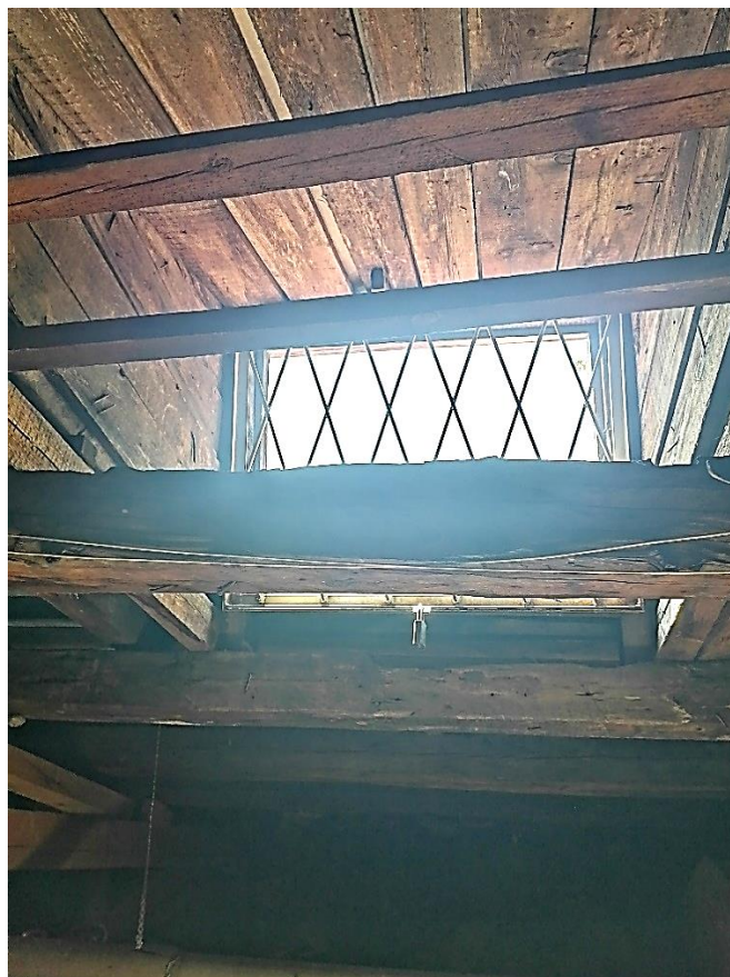
Илл.33. Продух в центральной части чердака выходит на дворовый фасад. 05.07.2021г.
