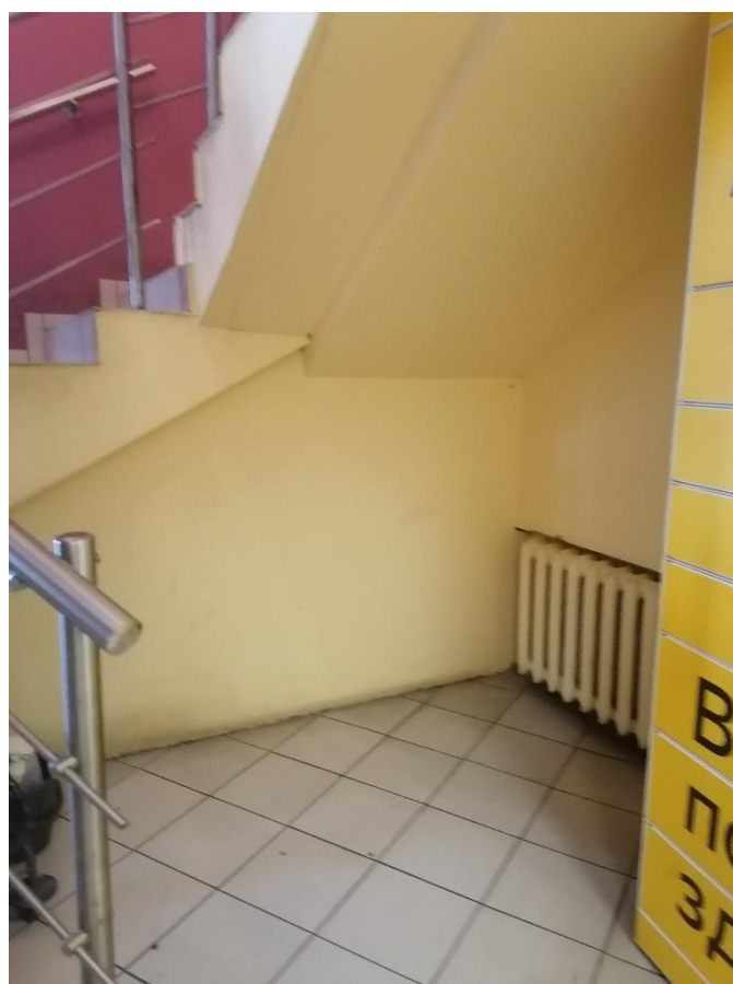
Илл.16. Подлестничное пространство (помещение №7). 05.07.2021г.
