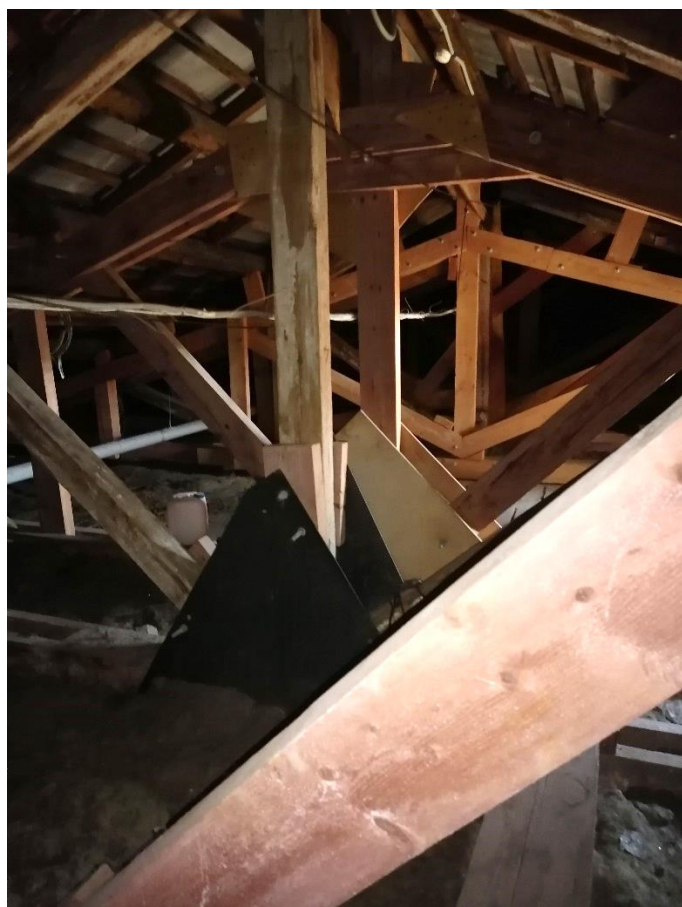
Илл.38. Фрагмент деревянных ферм чердачных перекрытий. 05.07.2021г.
