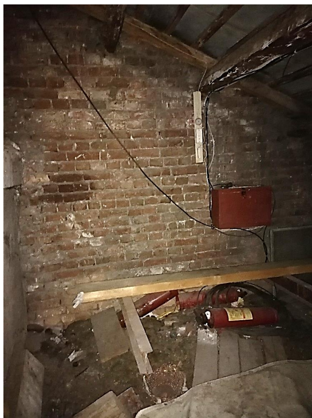
Илл.34. Торцевая стена на чердаке. №11. 05.07.2021г.
