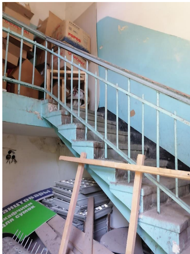
Илл.29. Лестничная клетка в части здания со стороны Кондратьевского проспекта. Лестничный марш. 05.07.2021г.
