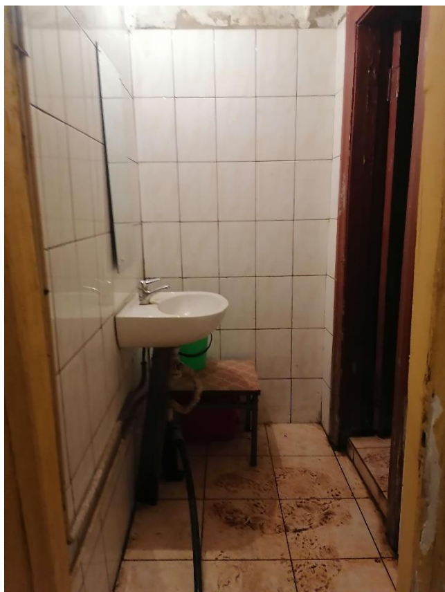
Илл.52. Подвал. Санузел. Помещение №31. 05.07.2021г.
