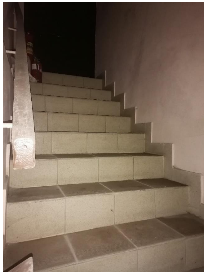
Илл.44. Подвал. Лестница из помещения №4 в части здания со стороны Полюстровского проспекта. 05.07.2021г.
