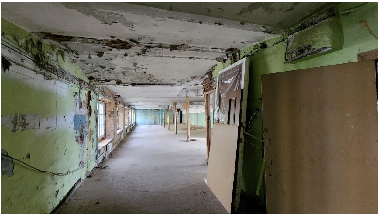
Фото 10. Помещение № 18. 5-Н. 1 этаж.
