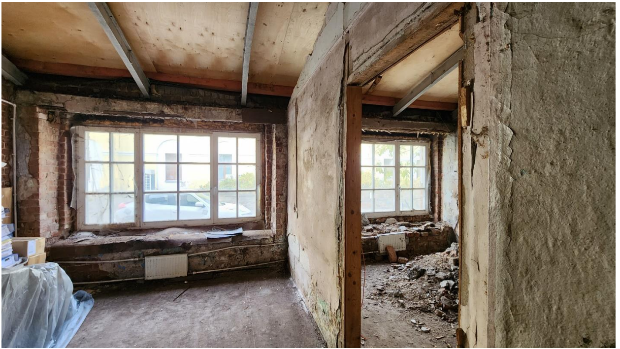
Фото 11. Помещения №№ 15, 16. 5-Н. 1 этаж.
