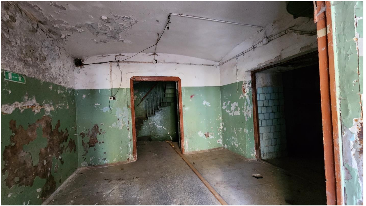
Фото 7. Помещение № 14. 5-Н. 1 этаж.
