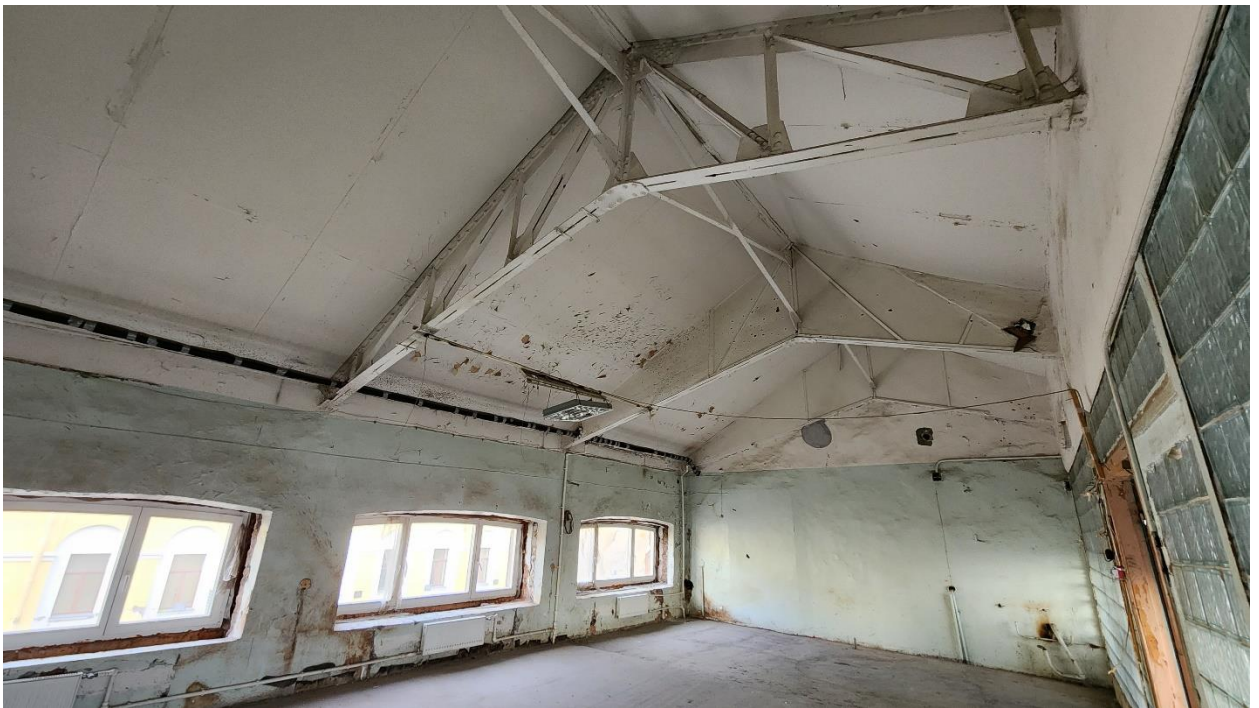
Фото 33. Помещение № 7. 30-Н. 2 этаж.
