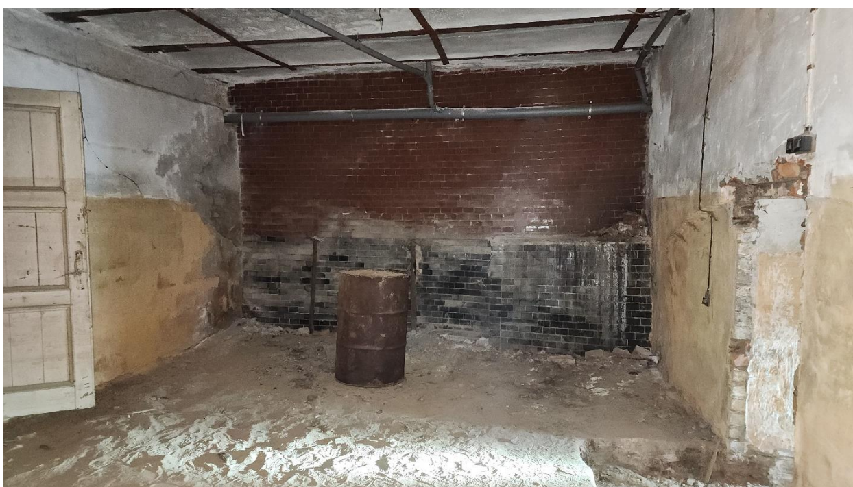
Фото 40. Помещение № 26. 22-Н. Подвал.
