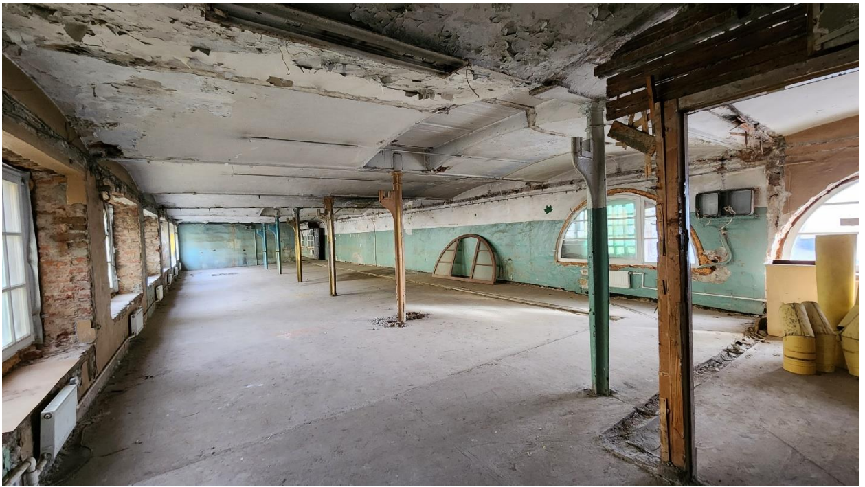
Фото 13. Помещение №№ 6, 18-21. 5-Н. 1 этаж.
