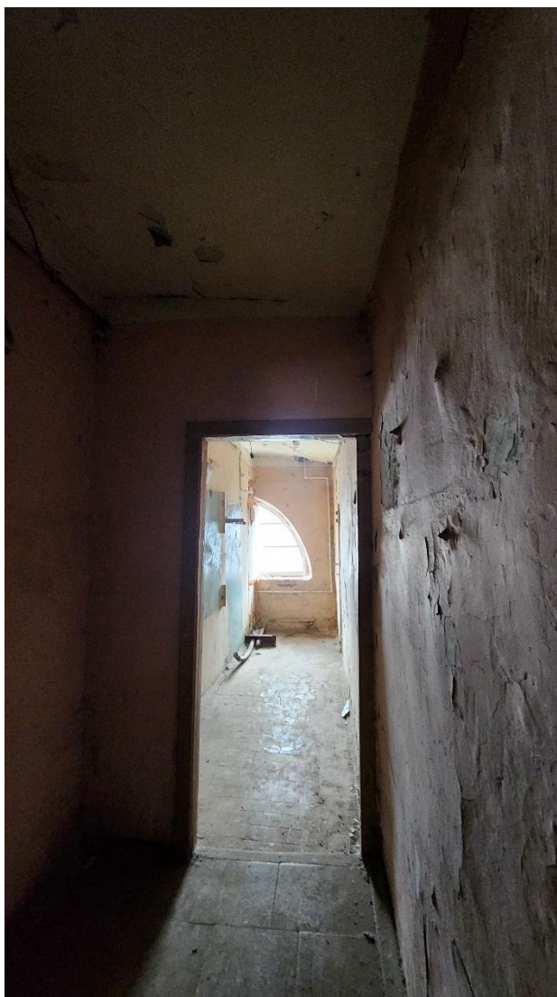
Фото 9. Помещение № 17. 5-Н. 1 этаж.
