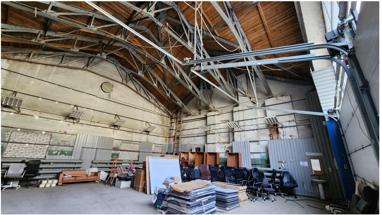
Фото 16. Помещение № 1. 6-Н. 1 этаж.
