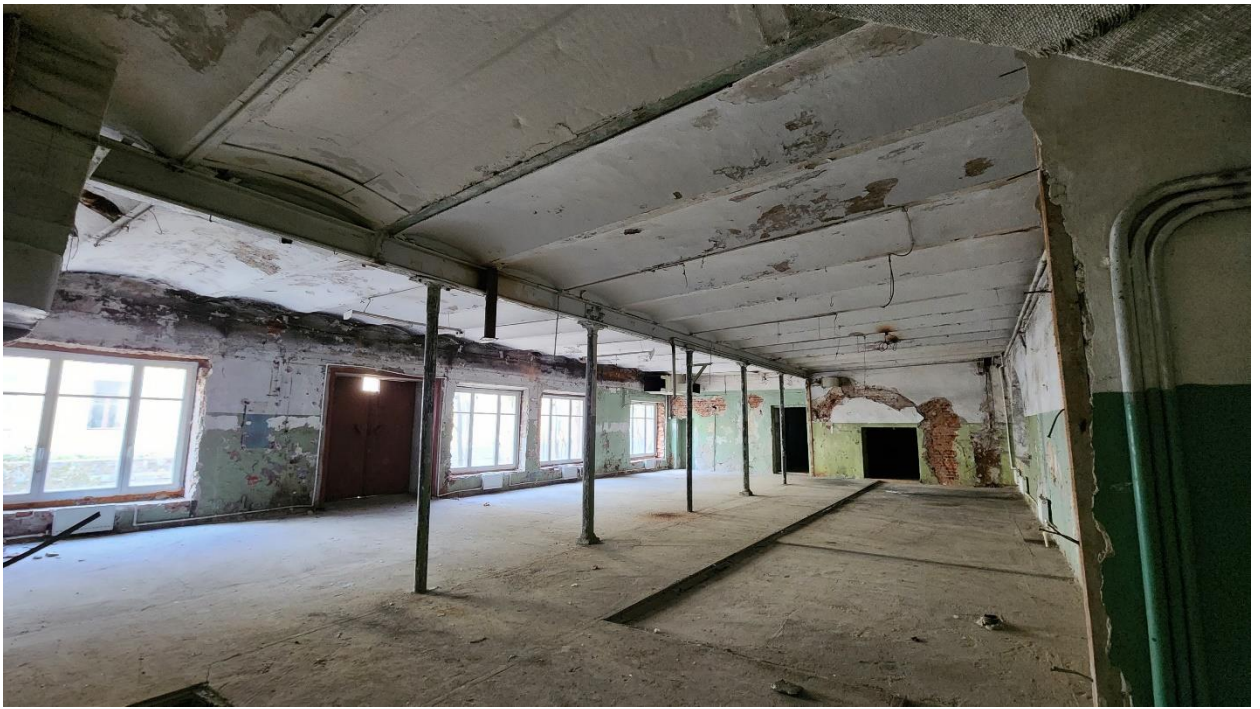
Фото 15. Помещения №№ 4, 5, 27, 29. 5-Н. 1 этаж.
