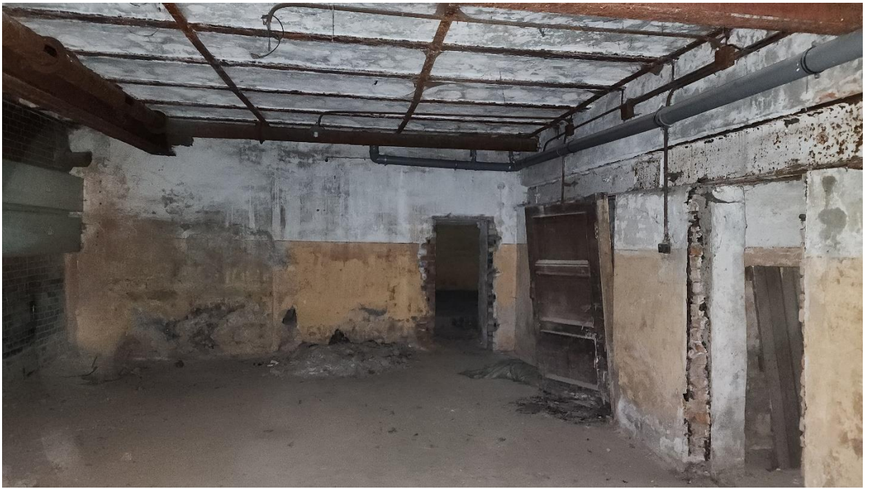
Фото 41. Помещение № 28. 22-Н. Подвал.
