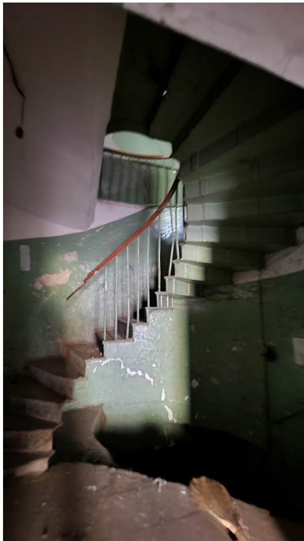
Фото 8. Помещение № 12. 5-Н. 1 этаж.
