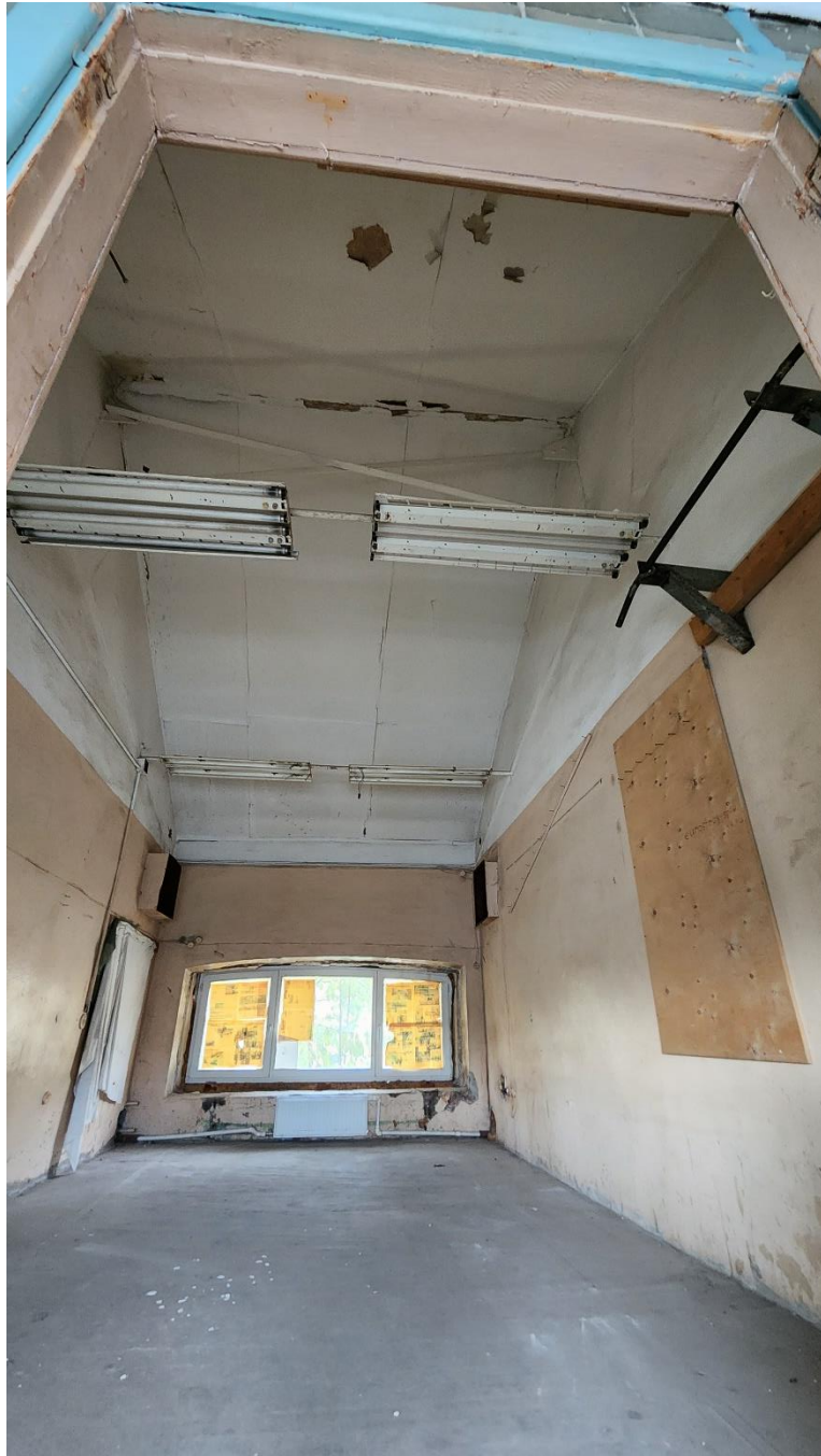
Фото 30. Помещение № 10. 30-Н. 2 этаж.
