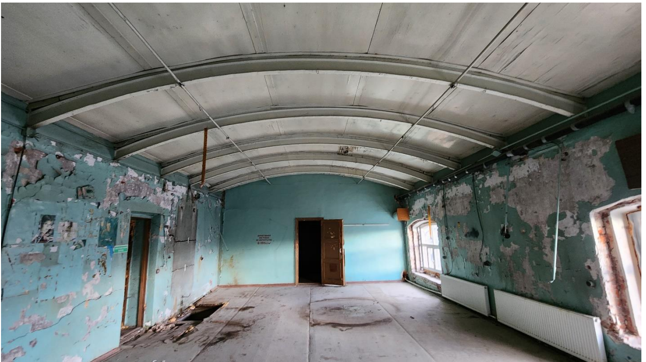
Фото 35. Помещение № 3. 30-Н. 2 этаж.
