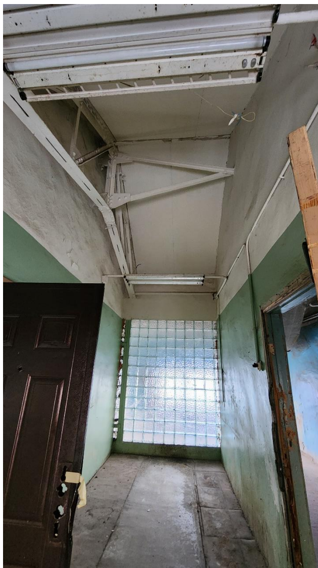
Фото 27. Помещение № 13. 30-Н. 2 этаж.
