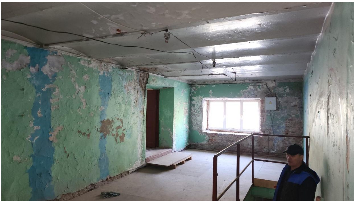
Фото 36. Помещение № 1. 31-Н. 2 этаж.
