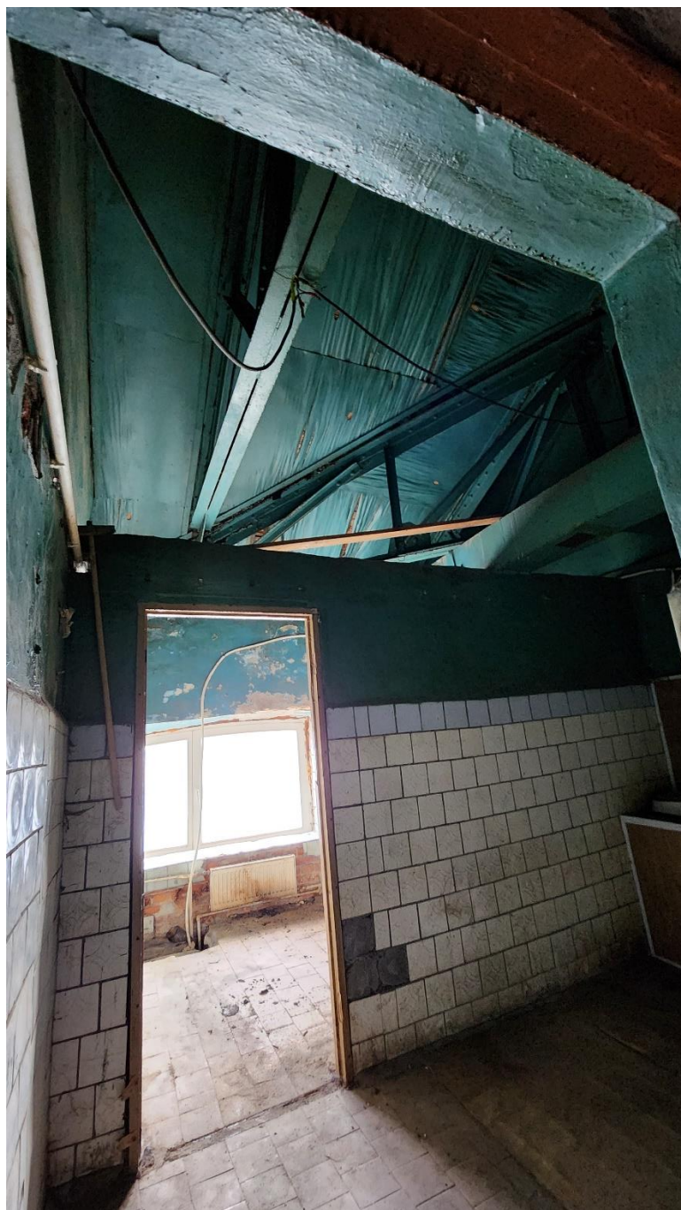
Фото 25. Помещение № 16. 30-Н. 2 этаж.
