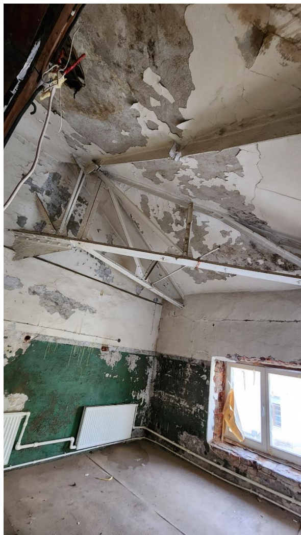
Фото 24. Помещение № 15. 30-Н. 2 этаж.
