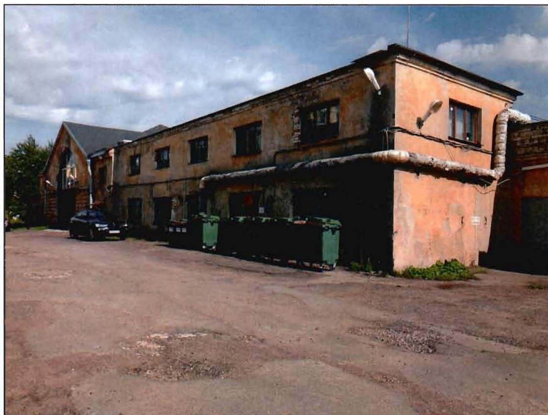
2. Общий вид с юго-запада.
