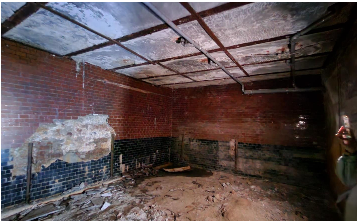
Фото 39. Помещение № 27. 22-Н. Подвал.
