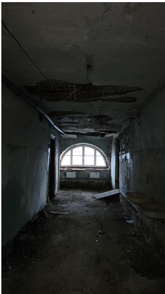
Фото 18. Помещения №№ 2,5,8. 7-Н. 1 этаж.
