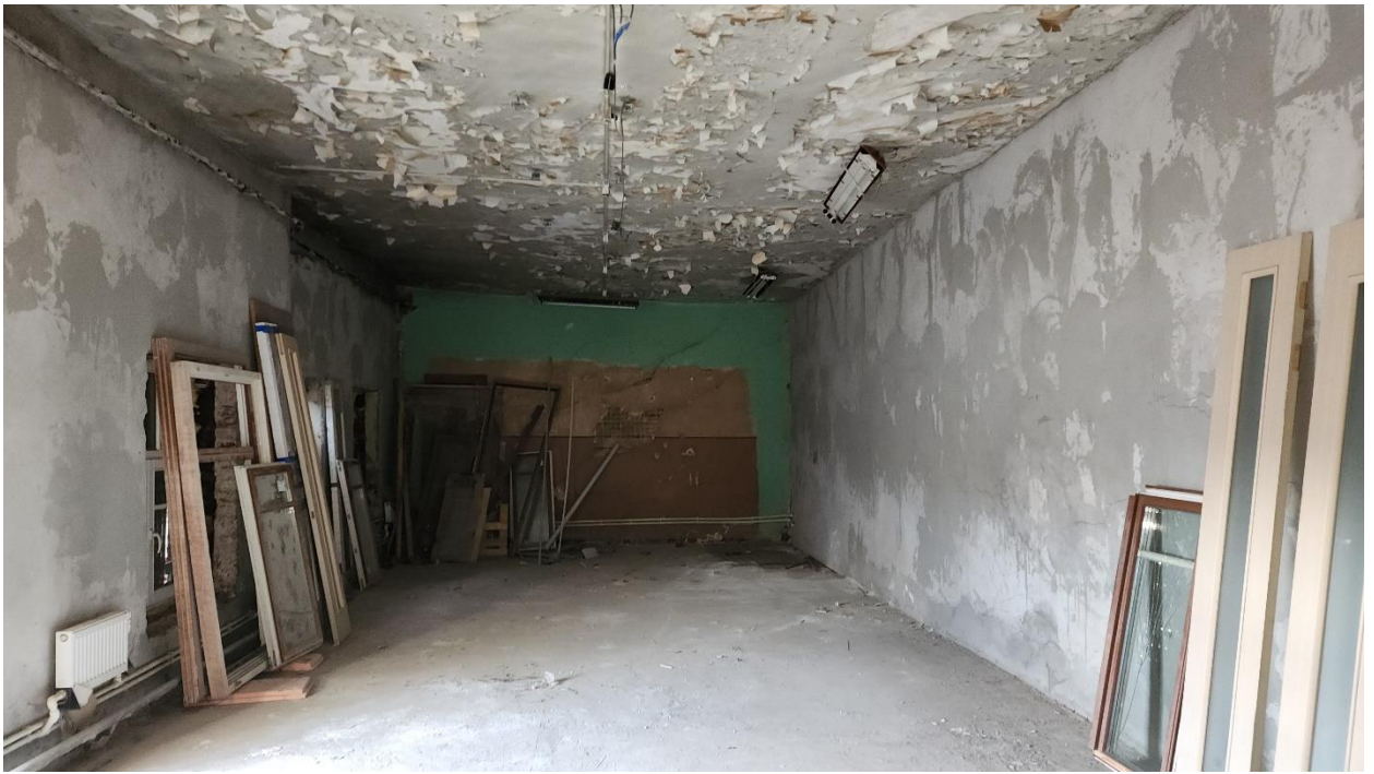
Фото 20. Помещение № 6. 7-Н. 1 этаж.
