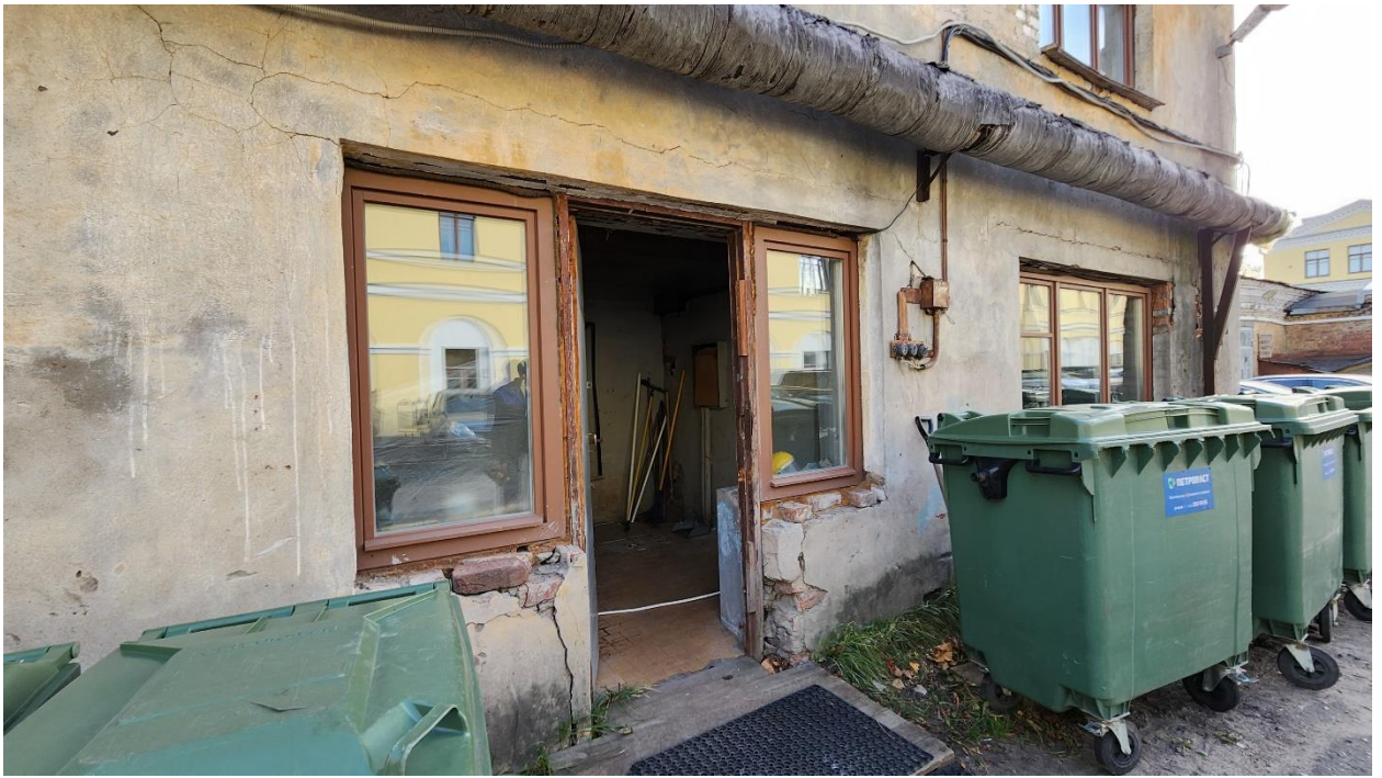
Фото 22. Помещение № 1. 9-Н. 1 этаж.
