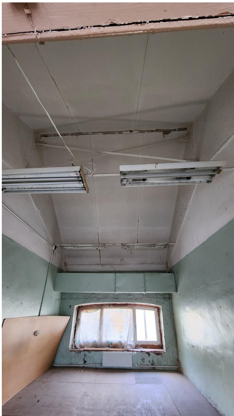
Фото 31. Помещение № 9. 30-Н. 2 этаж.
