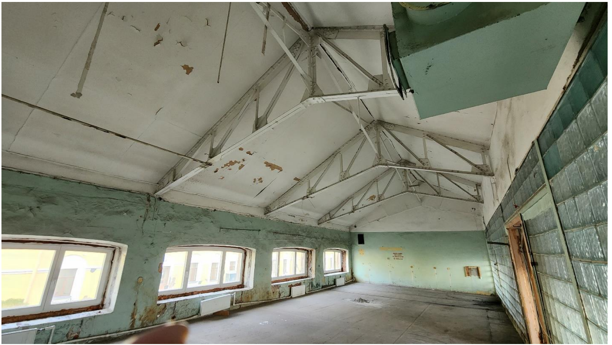
Фото 32. Помещение № 8. 30-Н. 2 этаж.
