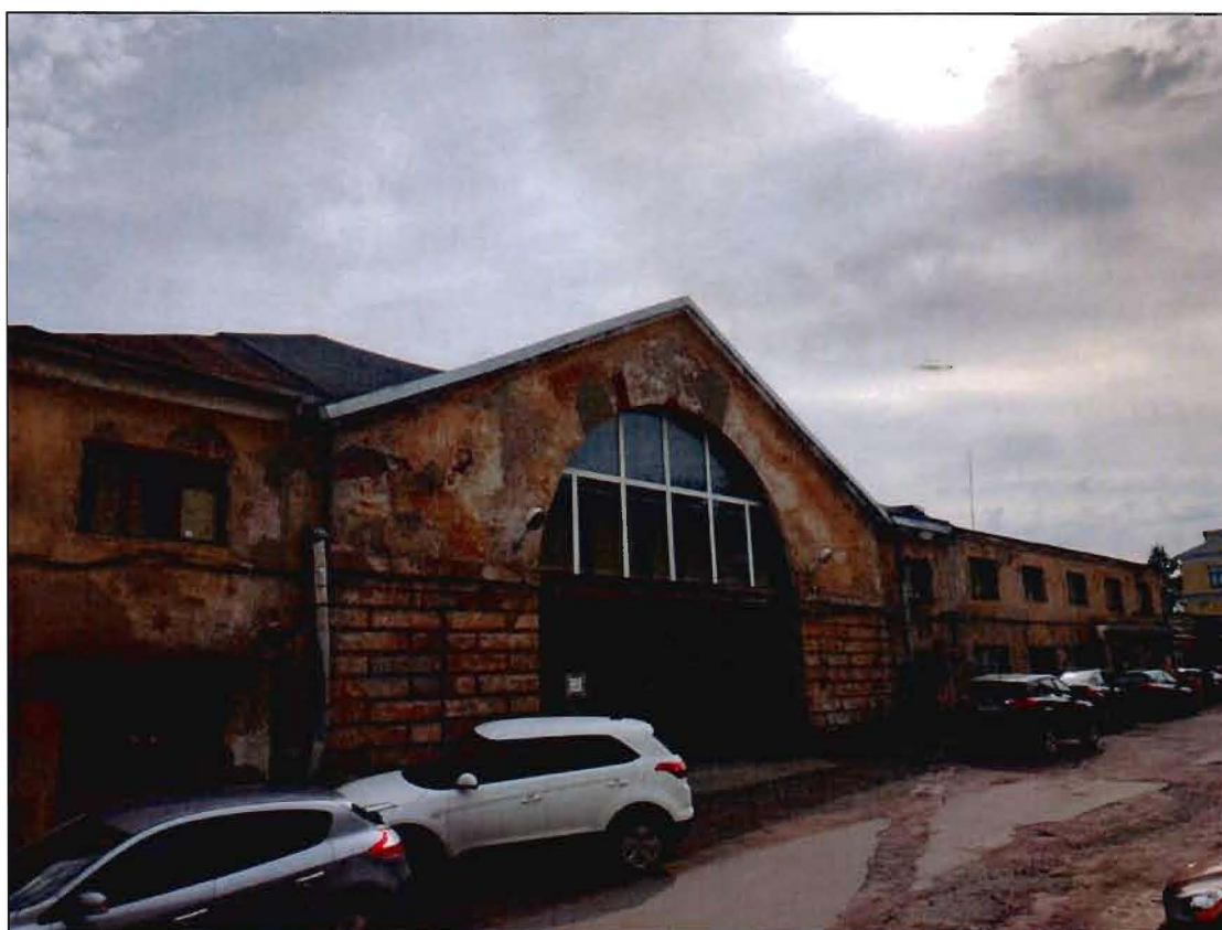
1. Общий вид с северо-запада.
