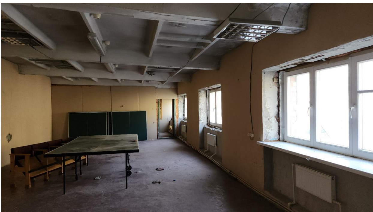
Фото 37. Помещение № 2. 31-Н. 2 этаж.
