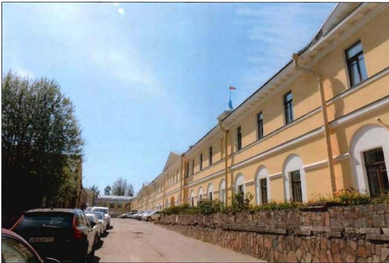
4. Восточный дворовый фасад объекта культурного наследия. Общий вид с северо-востока.
