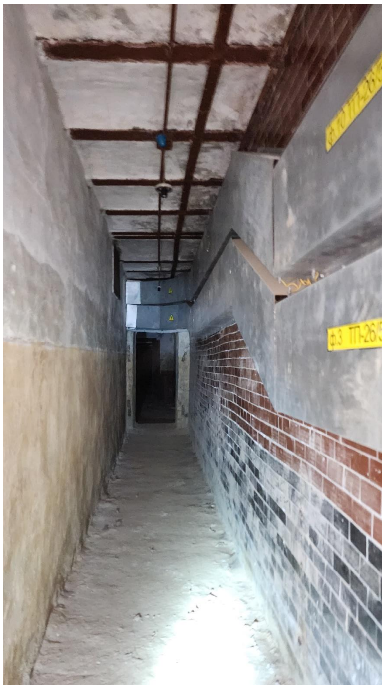
Фото 42. Помещение № 18. 22-Н. Подвал.
