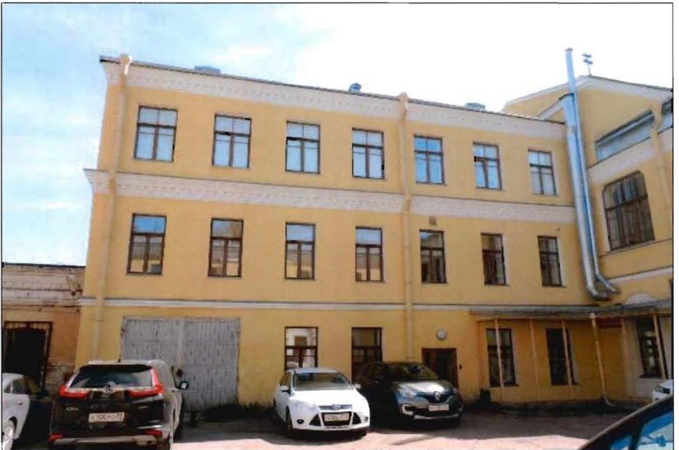
7. Западный дворовый фасад объекта культурного наследия.
