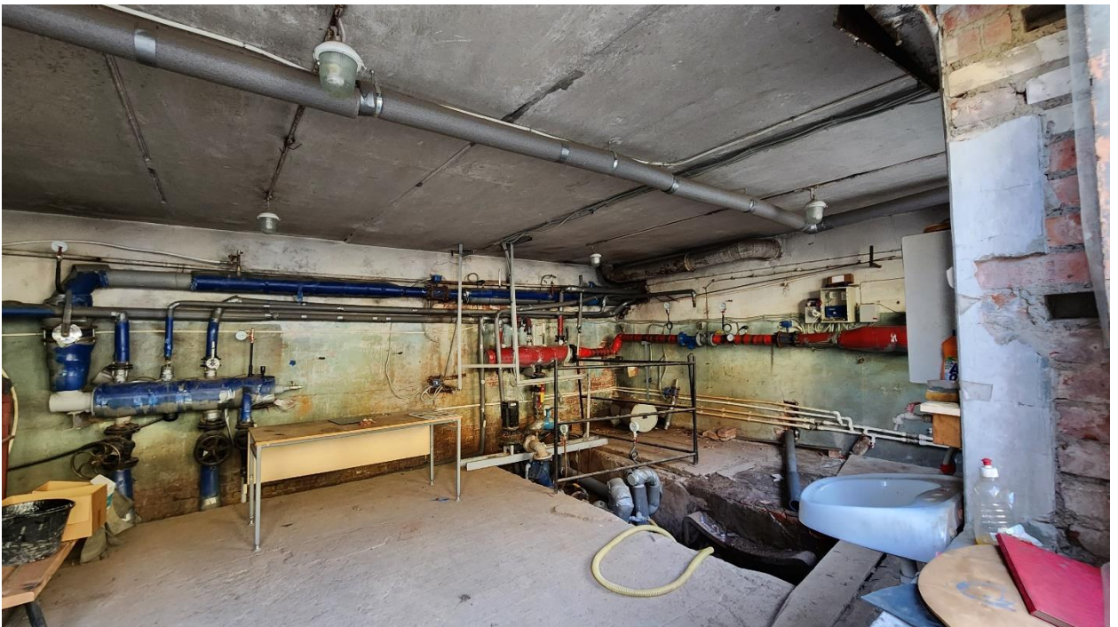
Фото 21. Помещение № 1. 8-Н. 1 этаж.
