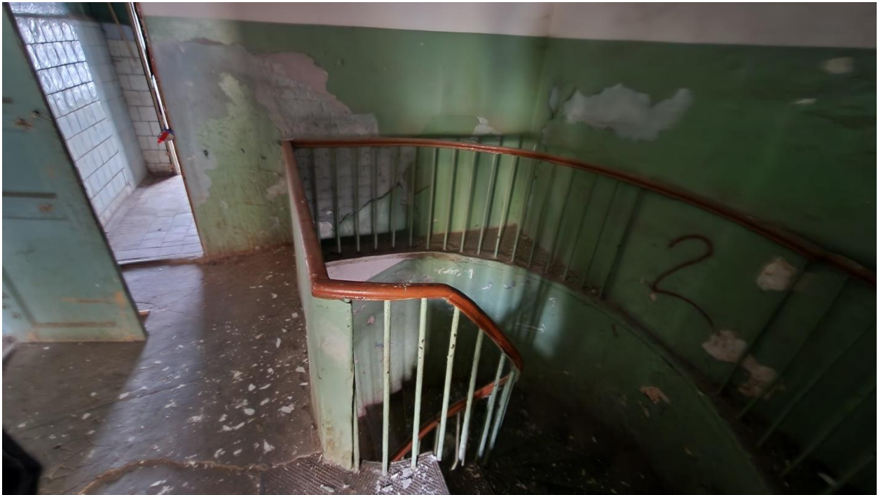
Фото 23. Помещение № 14. 30-Н. 2 этаж.
