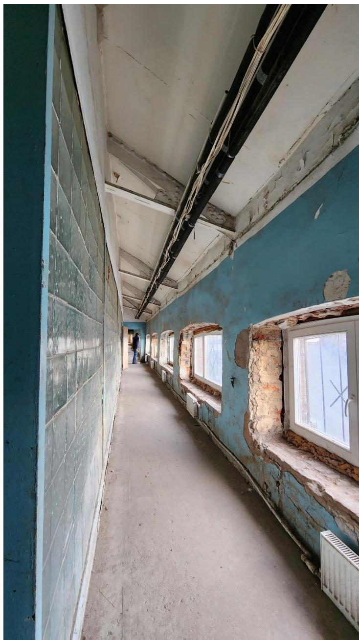
Фото 29. Помещение № 12. Коридор. 30-Н. 2 этаж.
