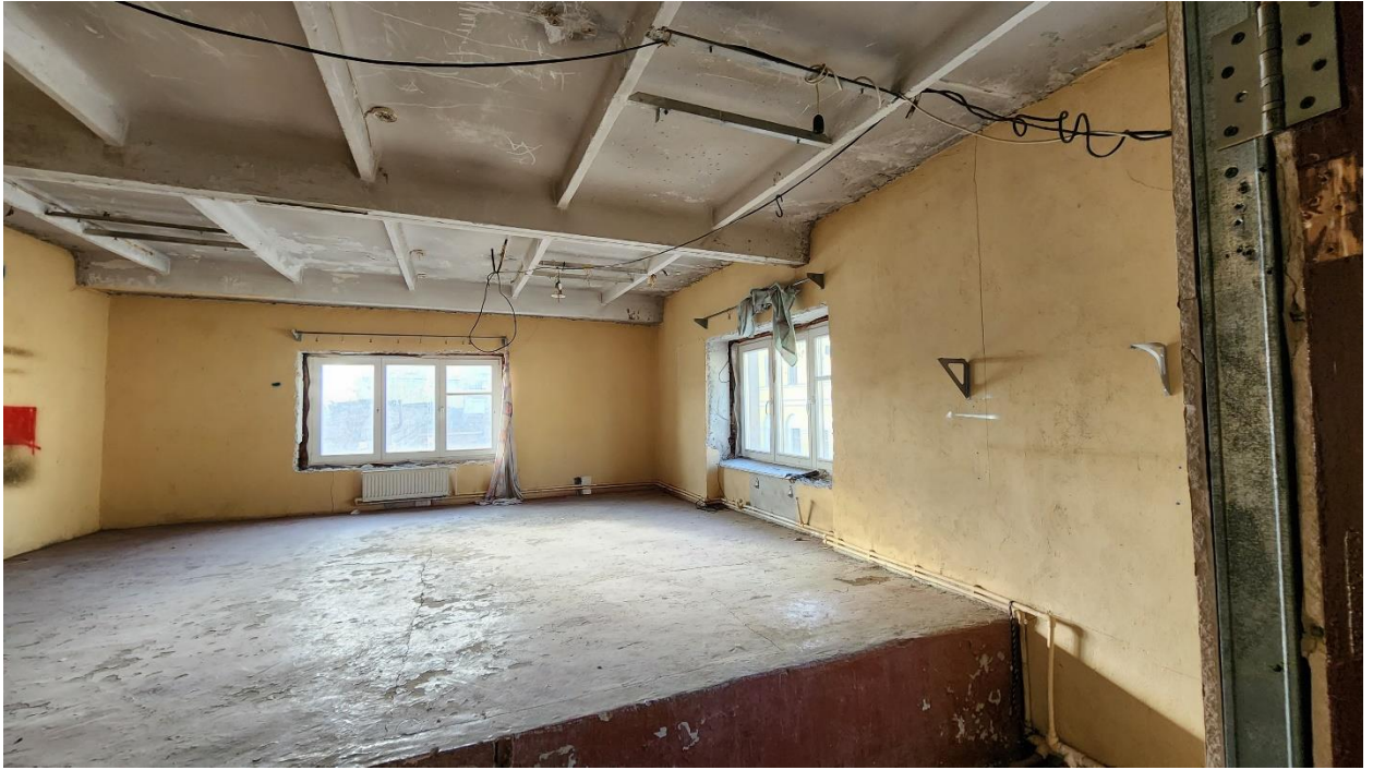
Фото 38. Помещение № 2. 31-Н. 2 этаж.
