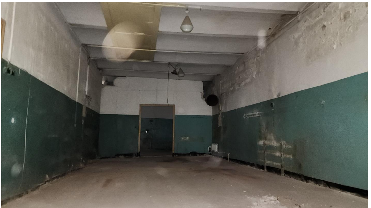
Фото 15. Помещение № 3. 5-Н. 1 этаж.
