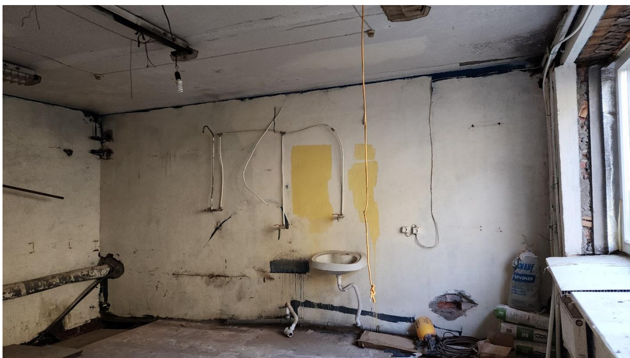
Фото 19. Помещение № 7. 7-Н. 1 этаж.
