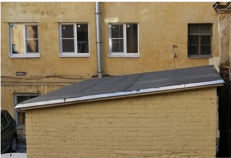
Фото 37. Общий вид кровли здания подстанции.
