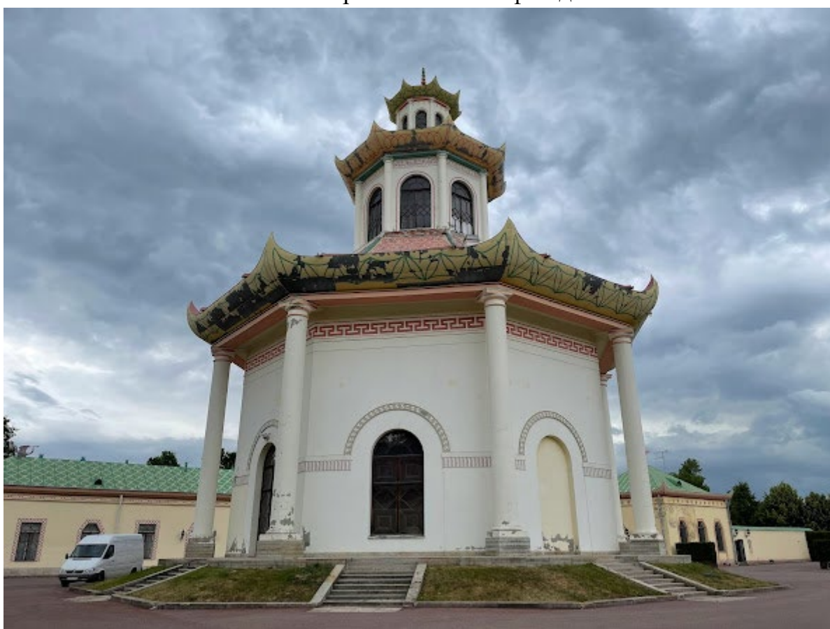
6. Вид на юго-западный фасад
