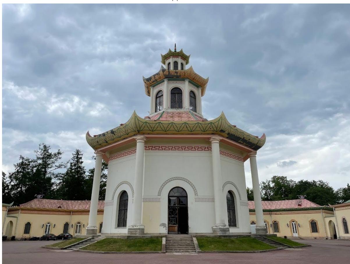
2. Вид на восточный фасад
