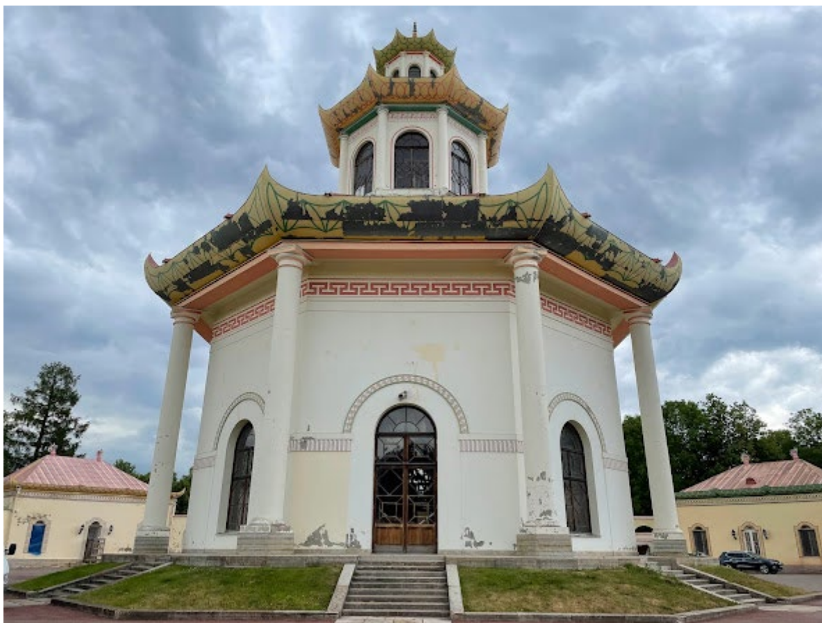
7. Вид на западный фасад
