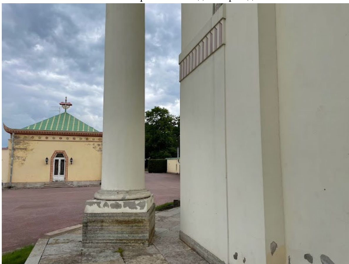
30. Фрагмент северо-западного фасада
