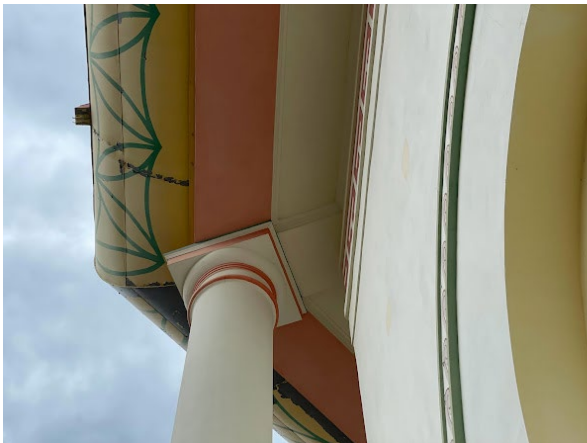
27. Фрагмент южного фасада
