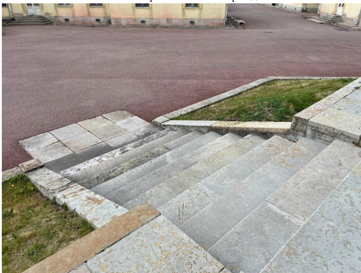
28. Лестница на юго-западном фасаде
