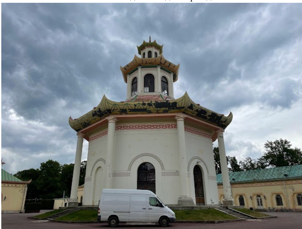
8. Вид на северо-западный фасад
