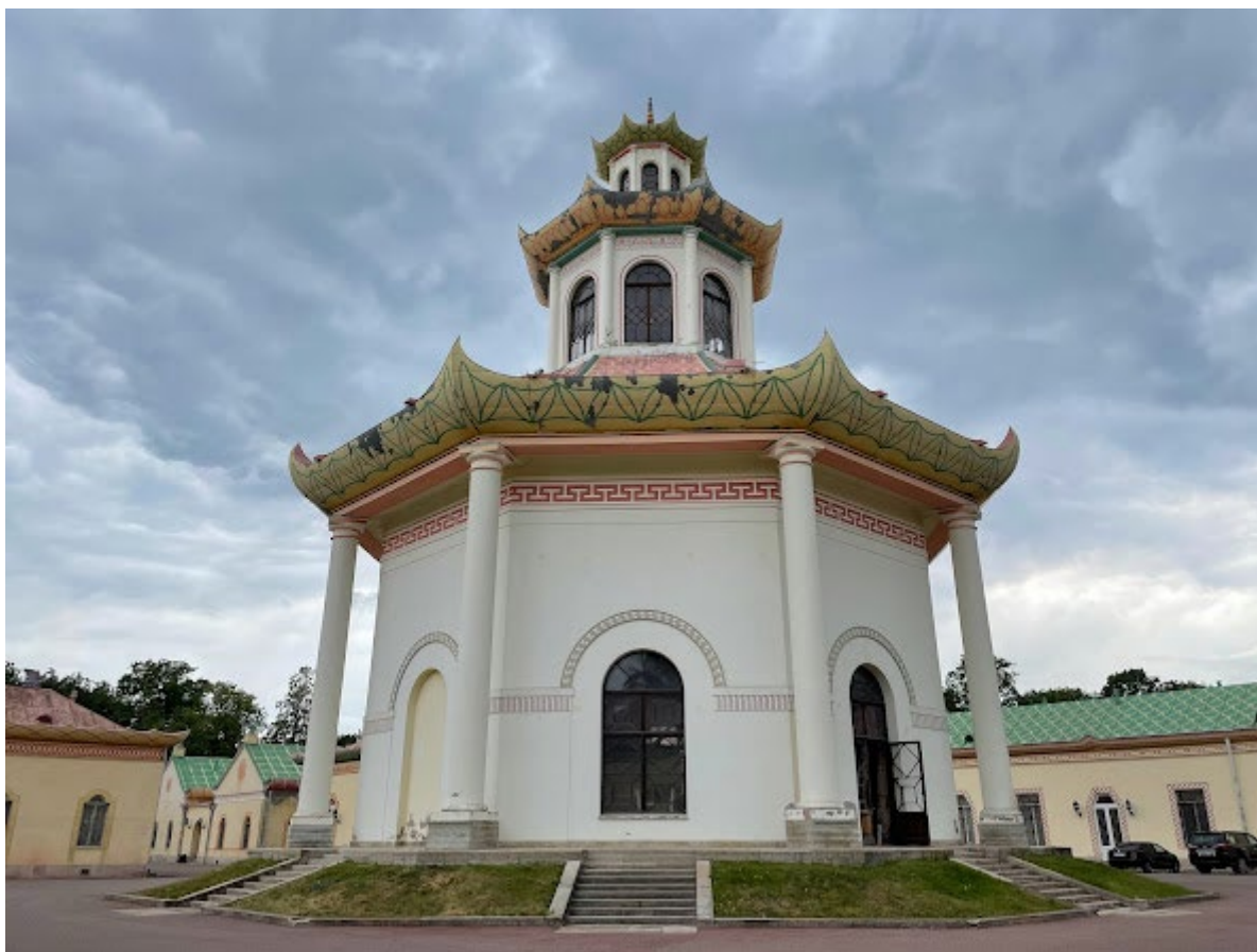
3. Вид на юго-восточный фасад
