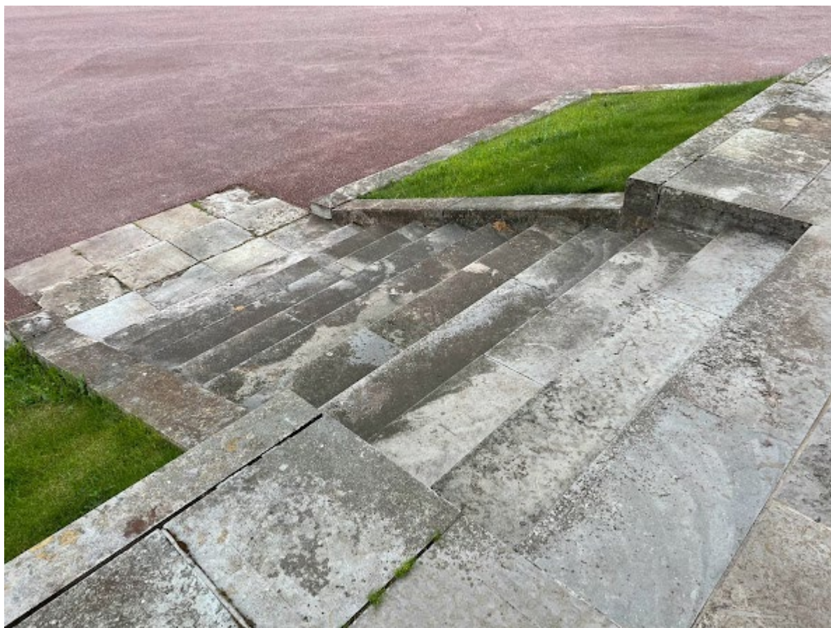
31. Лестница на северном фасаде
