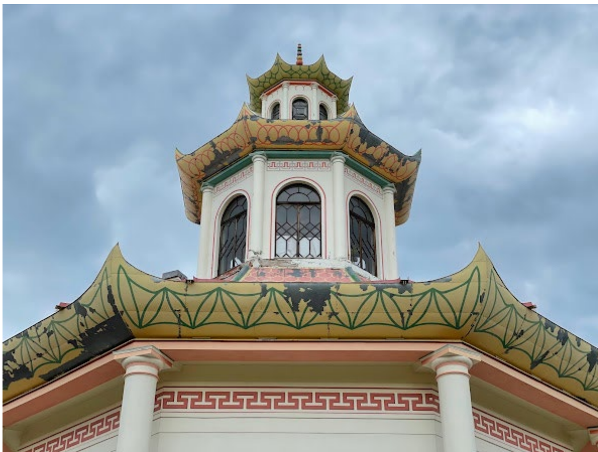
5. Фрагмент юного фасада
