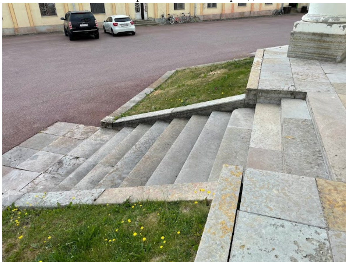
26. Лестница на юго-восточном фасаде
