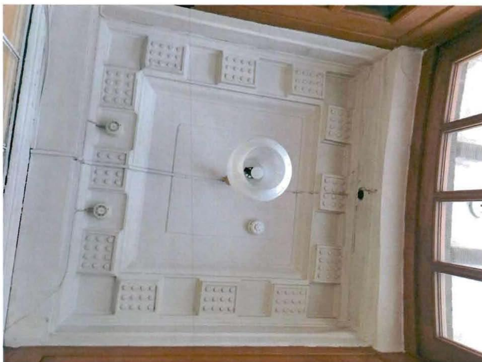
Фото 21. Потолок входного тамбура.
