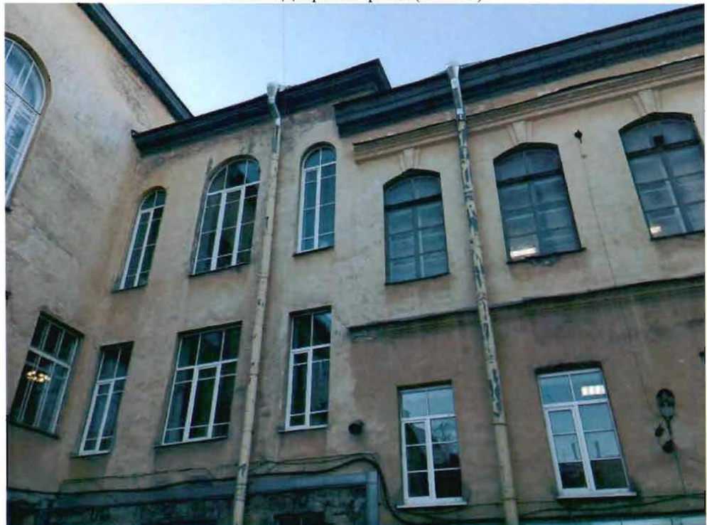
Фото 10. Часть дворового фасада (западный).
