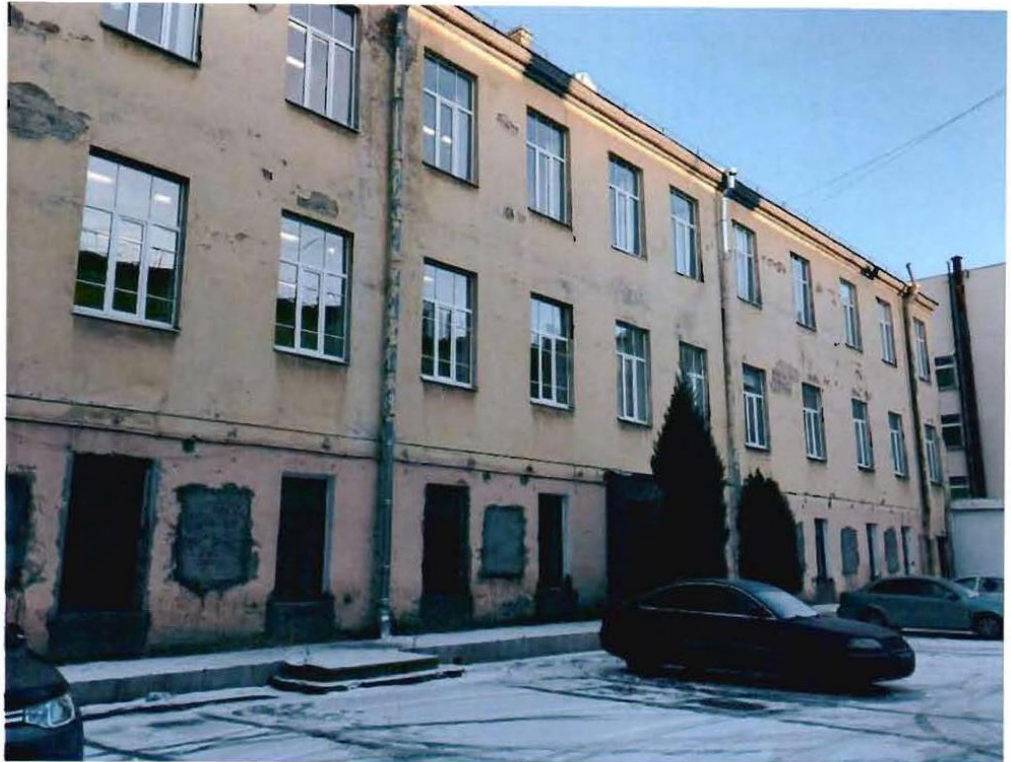
Фото 11. Дворовый фасад (северный).
