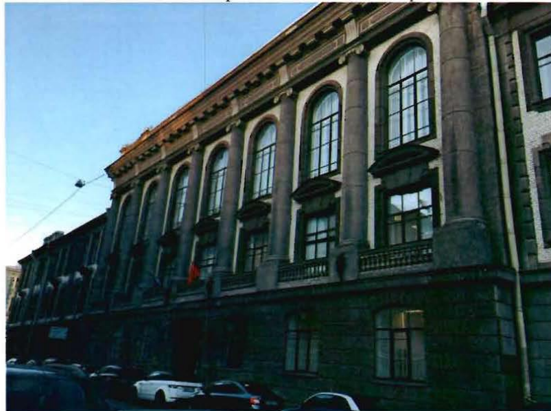
Фото 2. Часть южного фасада.
