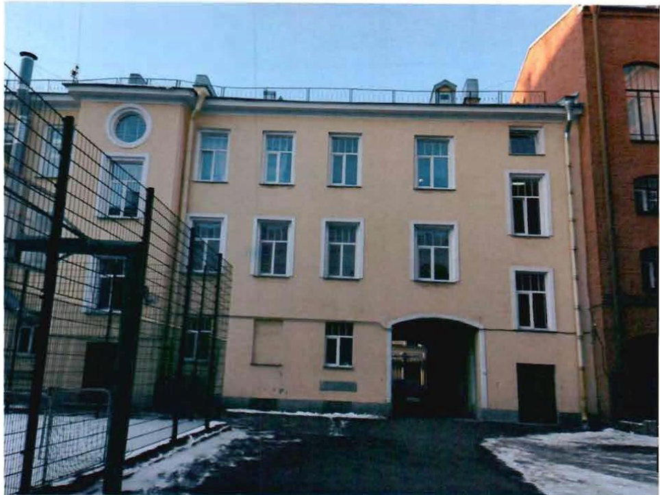
Фото 7. Дворовый фасад (западный).
