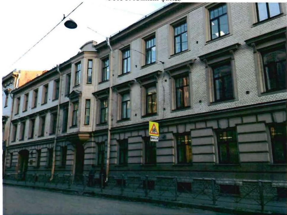
Фото 4. Часть западного фасада.
