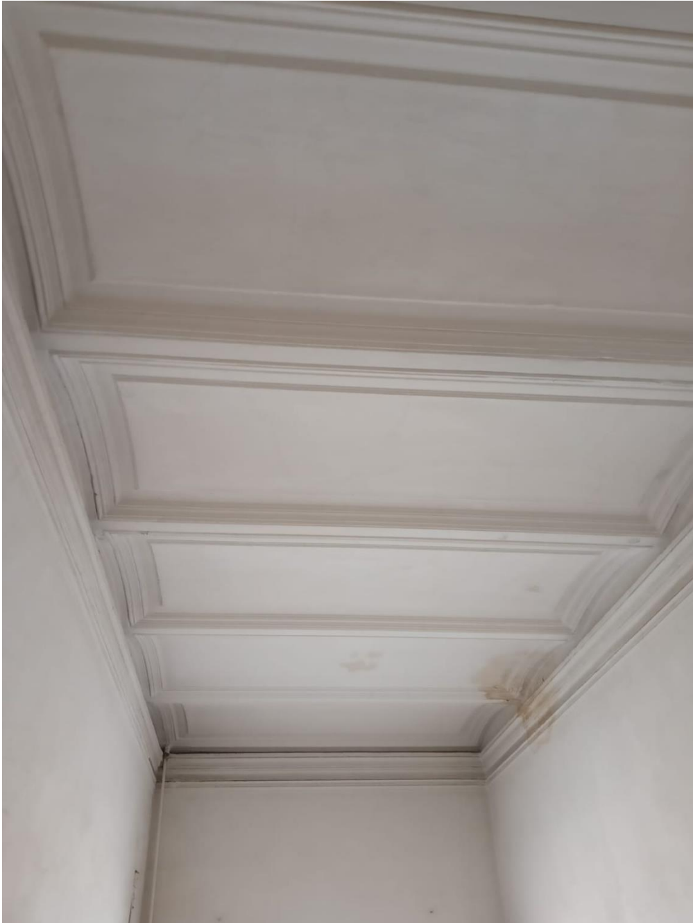
Фото 6. Выявленный объект культурного наследия «Здание Александрo-Мариинского детского приюта Ивана Базилевского», расположенный по адресу: Санкт-Петербург, Большой Сампсониевский проспект, дом 34, лит.А. Главная лестница, чердачное перекрытие.
