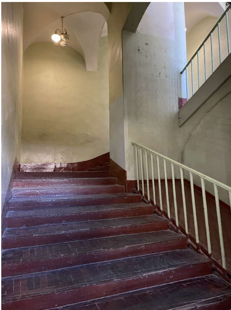
Фото 59. Интерьеры. Дата съемки 09.10.2023
