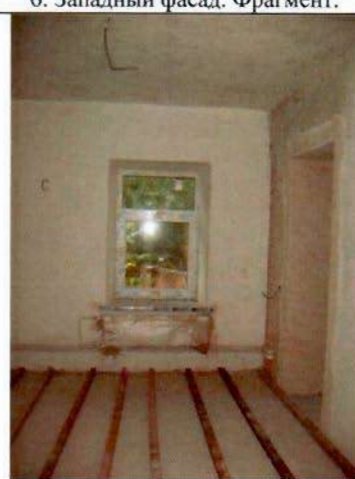
8. Помещение 1-го этажа. Общий вид.
