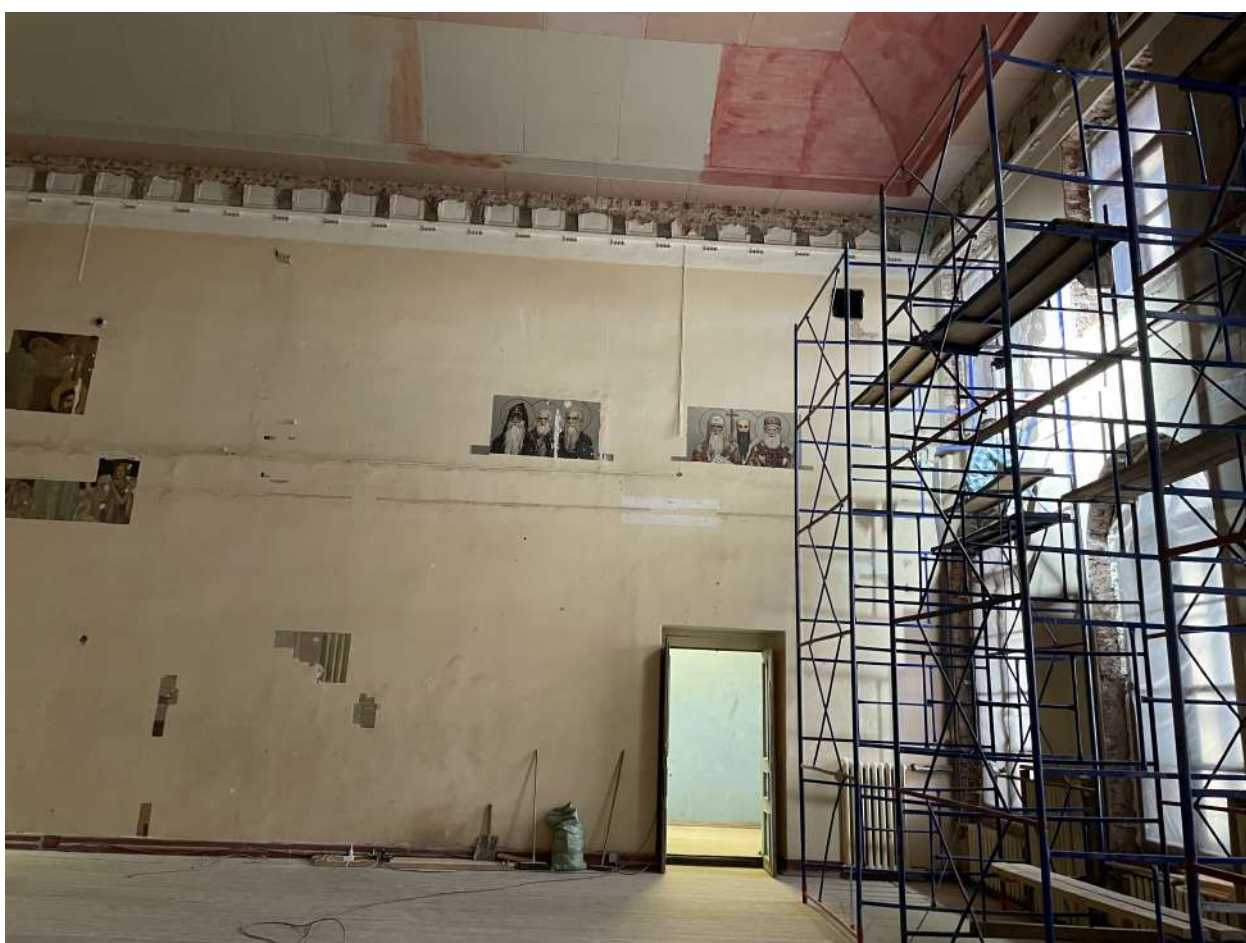
Фото 89. Интерьеры. Дата съемки 09.10.2023
