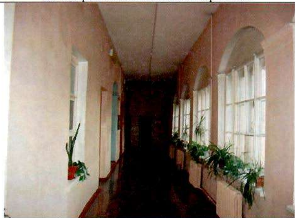
26. Коридор в уровне 3-го этажа. Общий вид.
