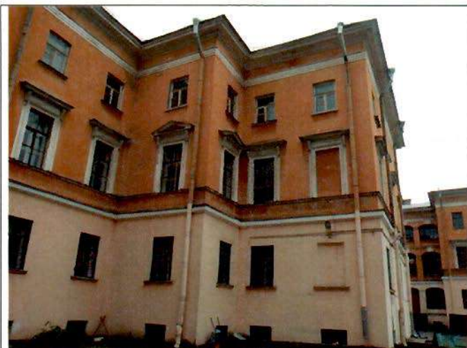
12. Дворовые фасады северного флигеля.
