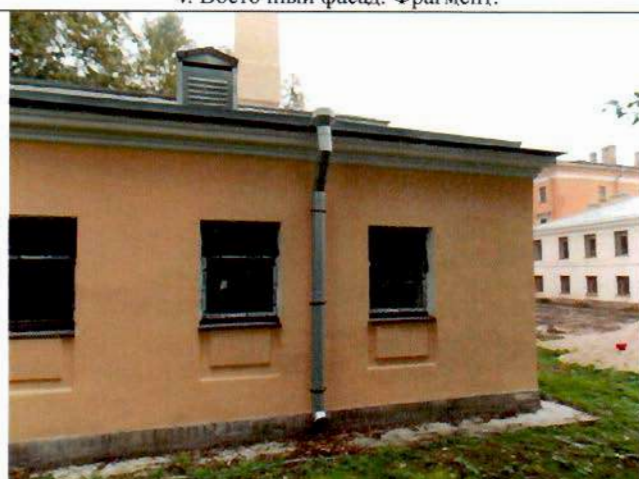
6. Западный фасад. Фрагмент.
