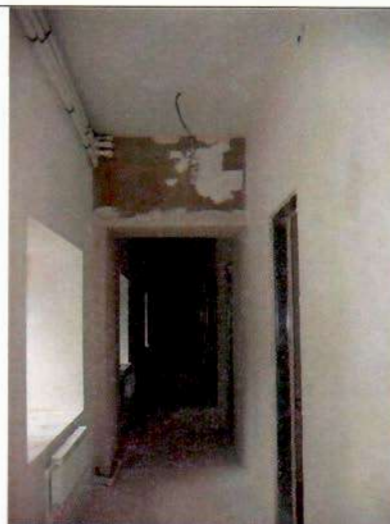
10. Коридор 2-го этажа. Общий вид.
