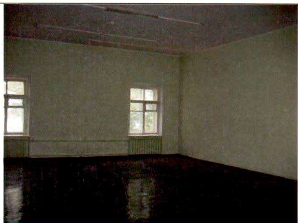
25. Помещения в уровне 2-го этажа. Общий вид.
