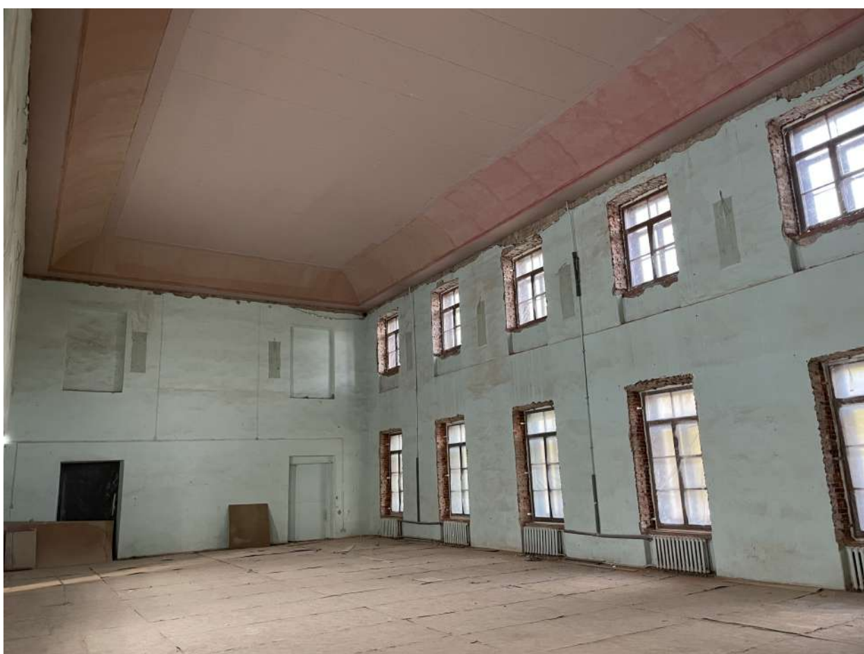
Фото 113. Интерьеры. Дата съёмки 09.10.2023
