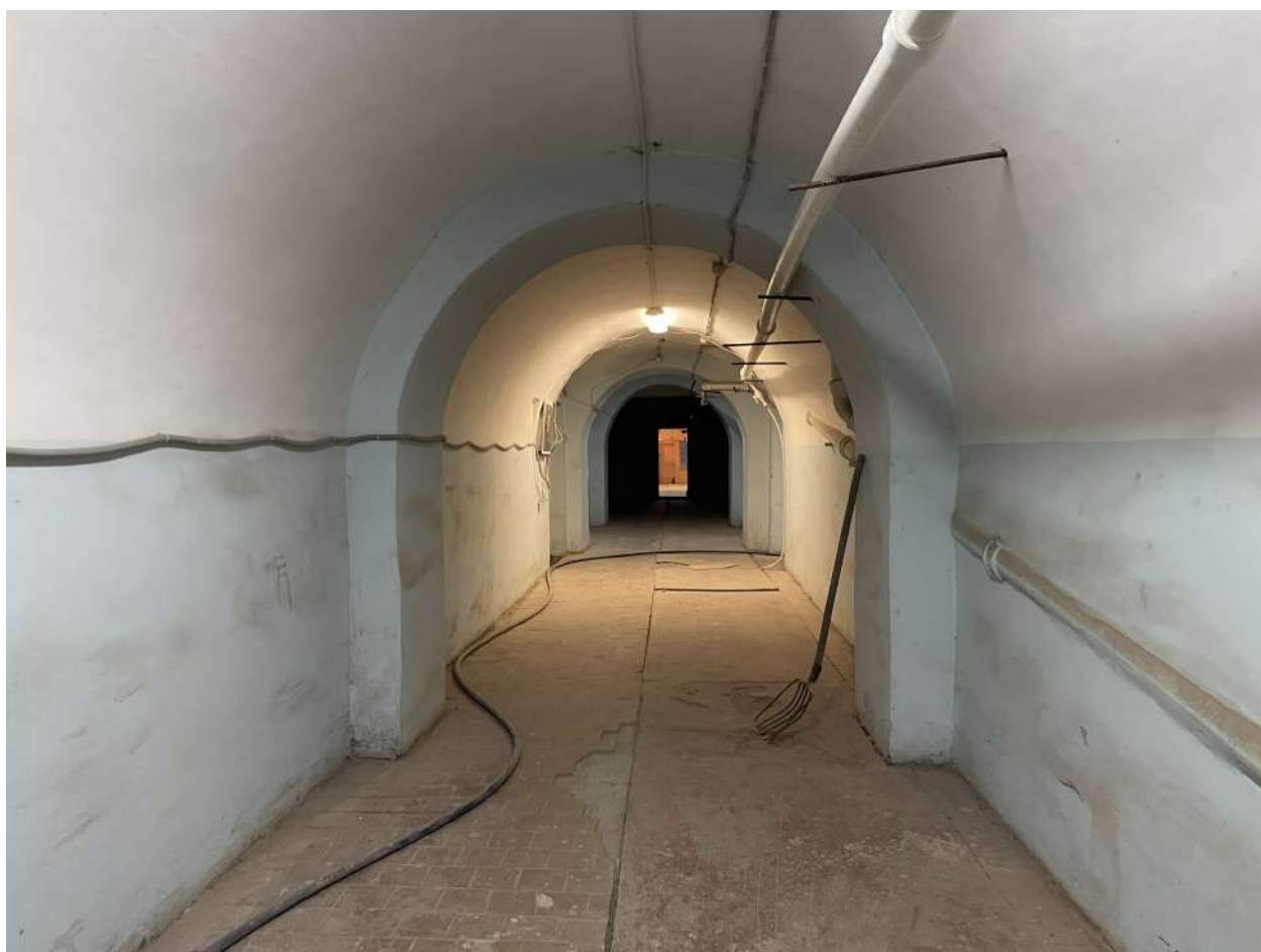
Фото 15. Интерьеры. Дата съёмки 09.10.2023
