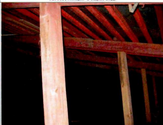
14. Конструкции крыши. Общий вид.
