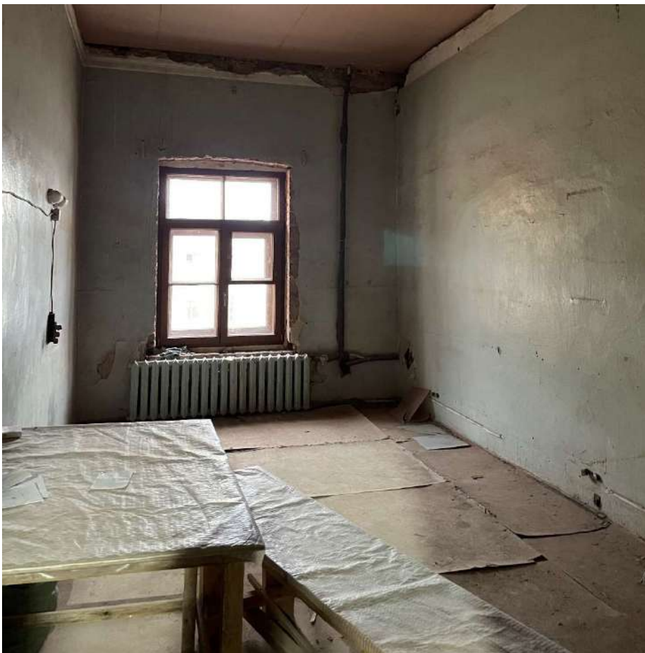
Фото 153. Интерьеры. Дата съемки 09.10.2023
