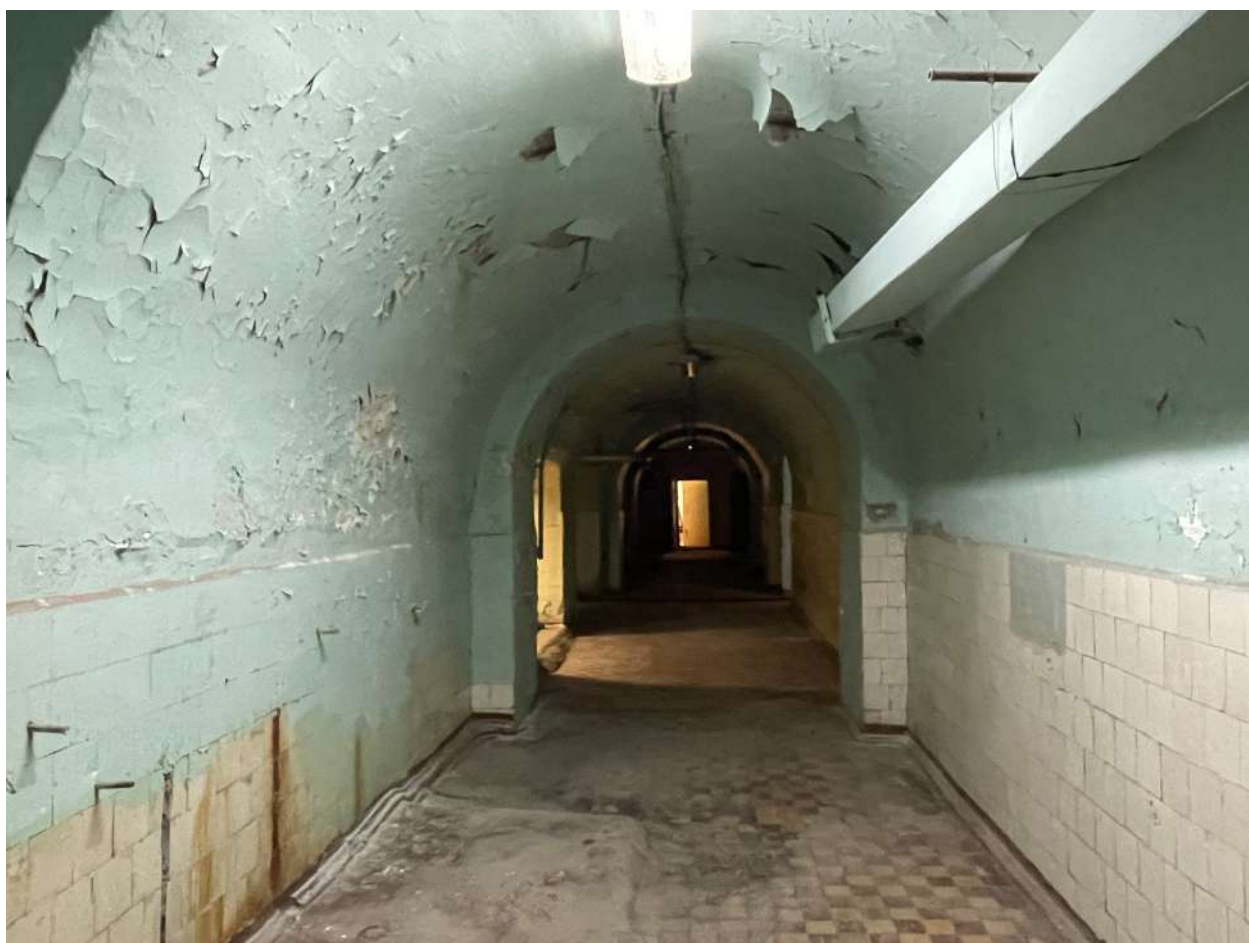
Фото 33. Интерьеры. Дата съёмки 09.10.2023
