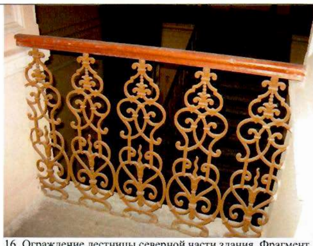
16. Ограждение лестницы северной части здания. Фрагмент.
