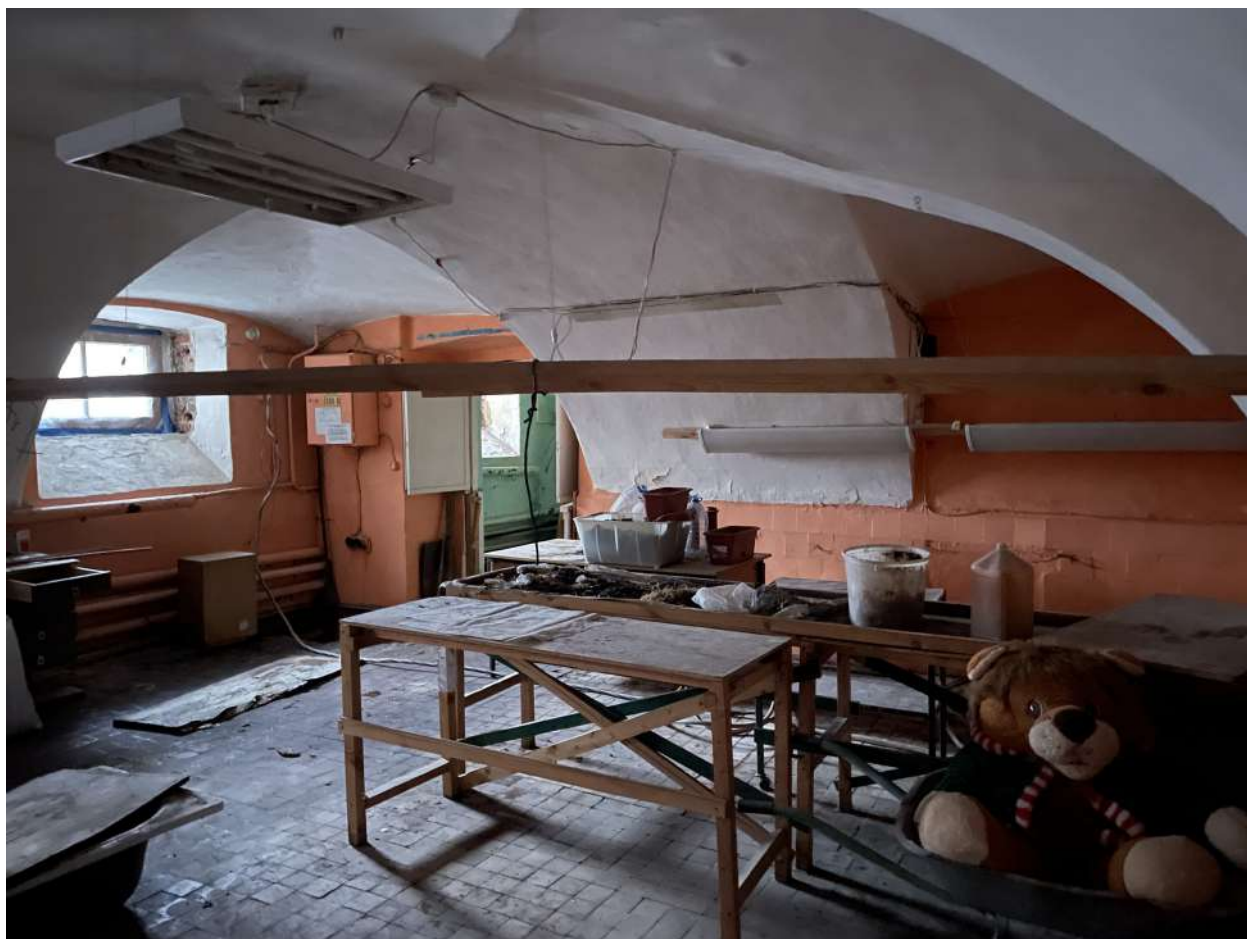
Фото 28. Интерьеры. Дата съёмки 09.10.2023
