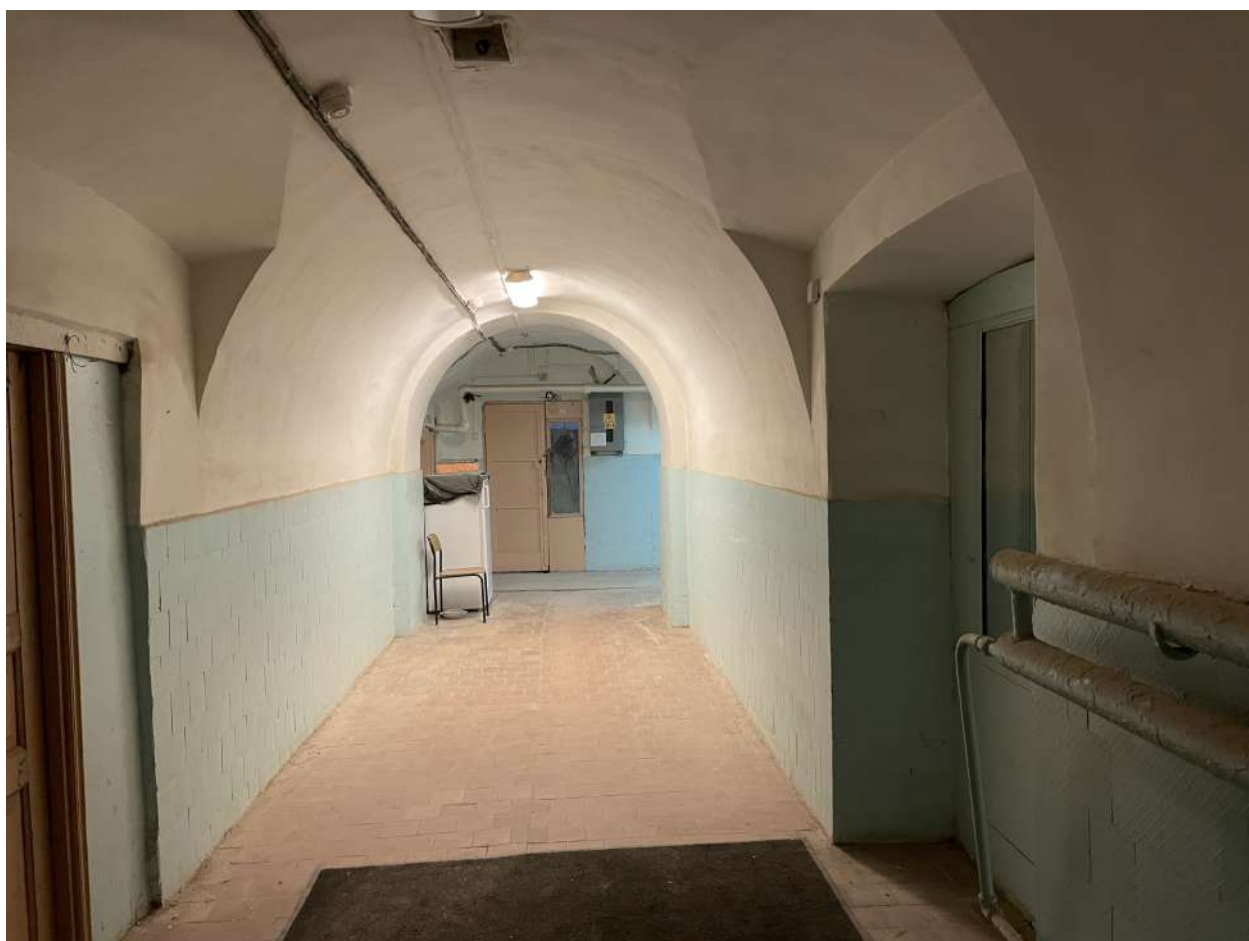
Фото 11. Интерьеры. Дата съёмки 09.10.2023
