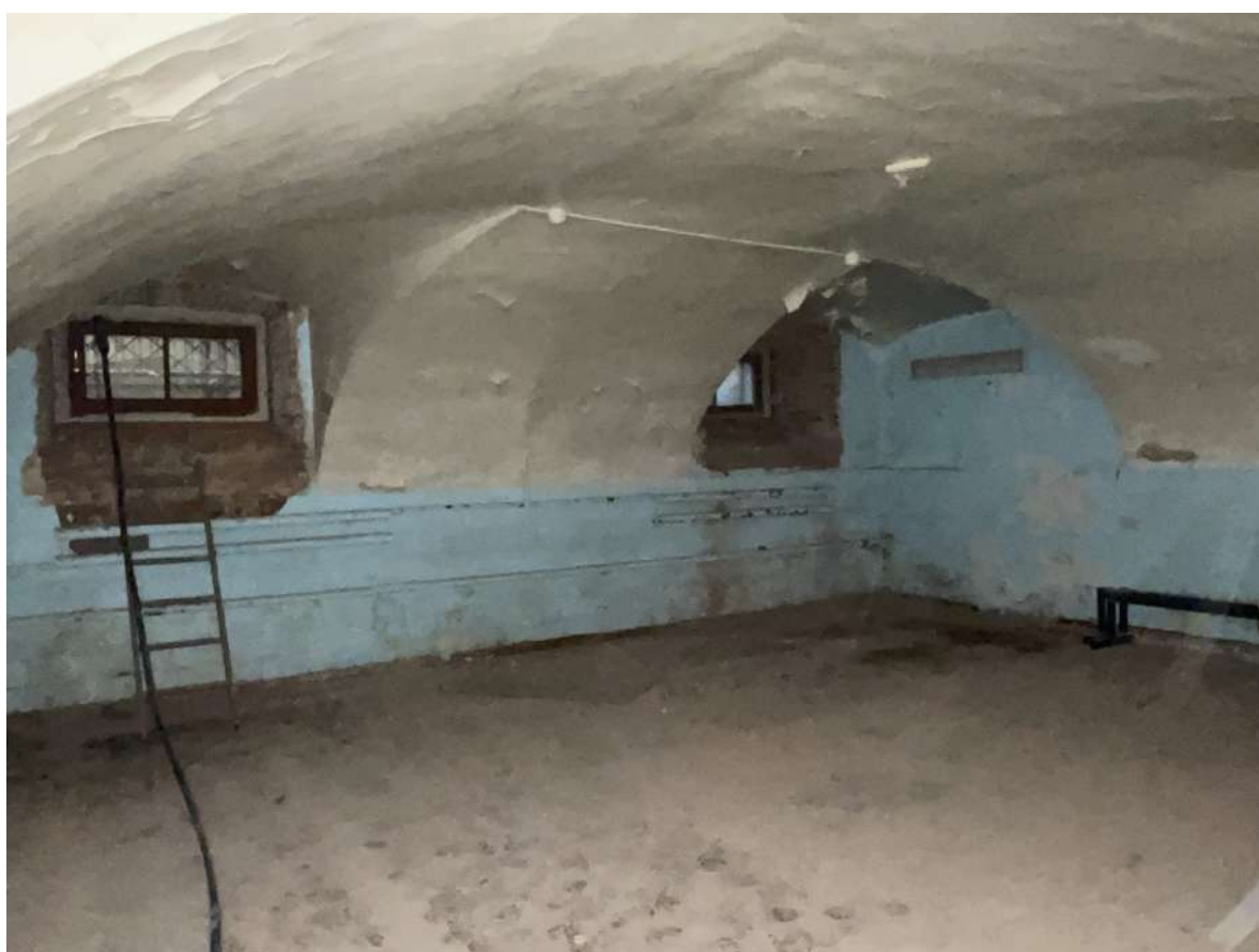
Фото 29. Интерьеры. Дата съёмки 09.10.2023
