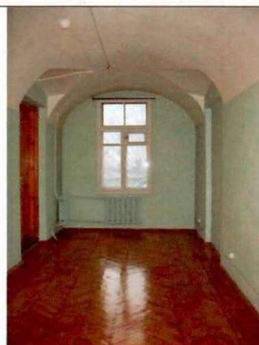
35. Коридор 1-го этажа.
