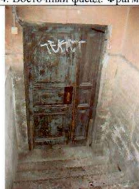
6. Входной проем восточного фасада. Общий вид.
