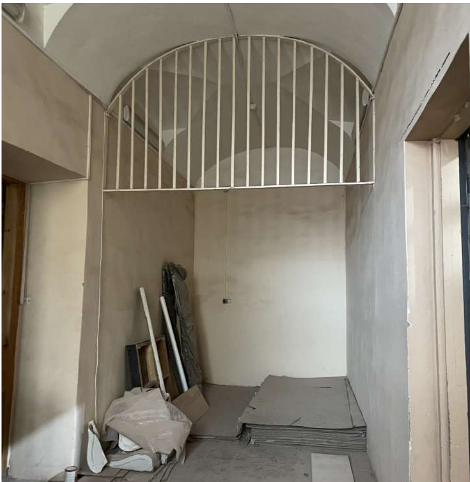
Фото 92. Интерьеры. Дата съемки 09.10.2023
