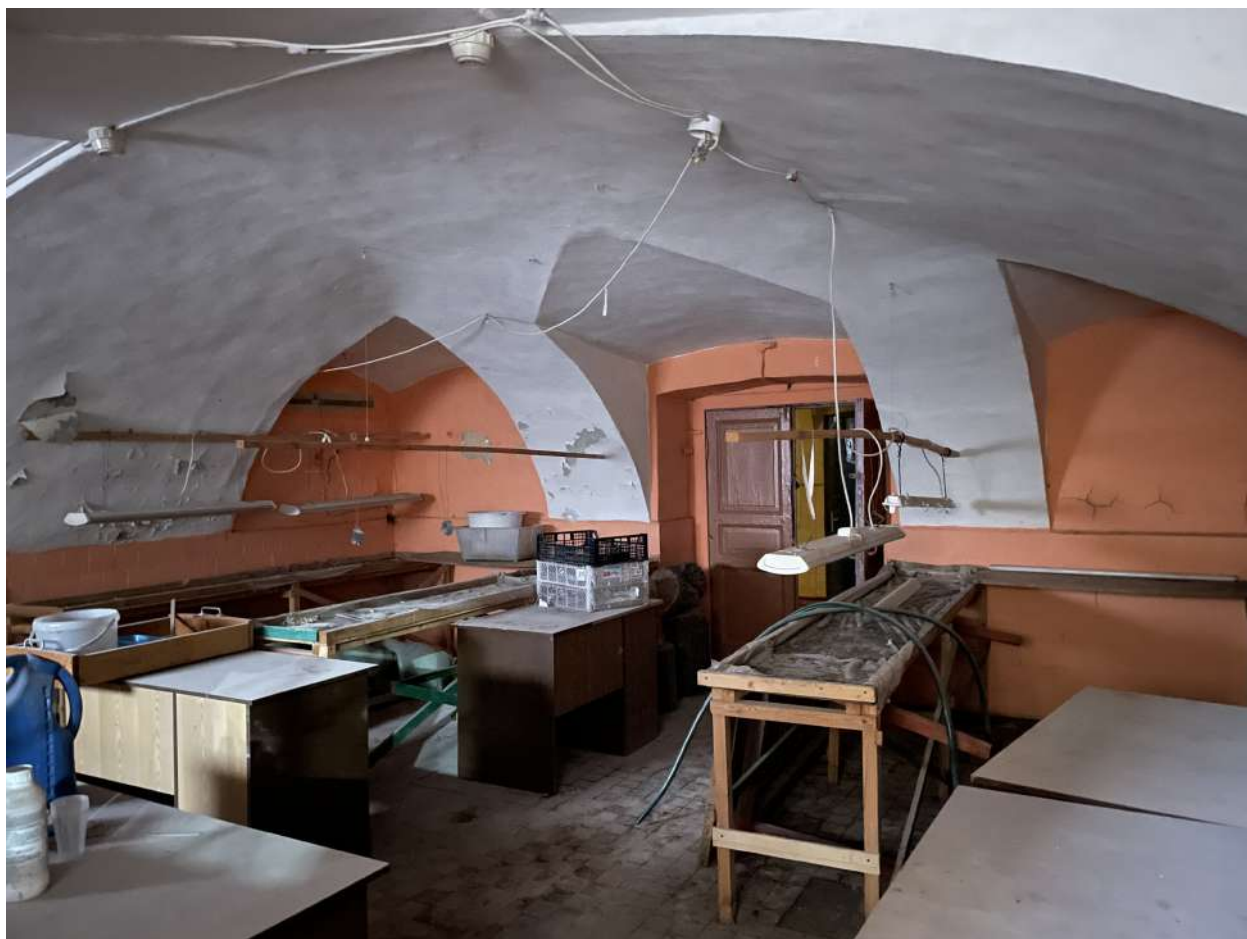
Фото 26. Интерьеры. Дата съёмки 09.10.2023
