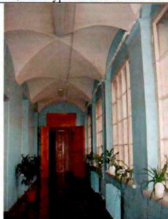
27. Коридор в уровне 2-го этажа. Общий вид.
