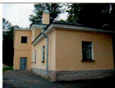
2. Южный фасад. Фрагмент.
