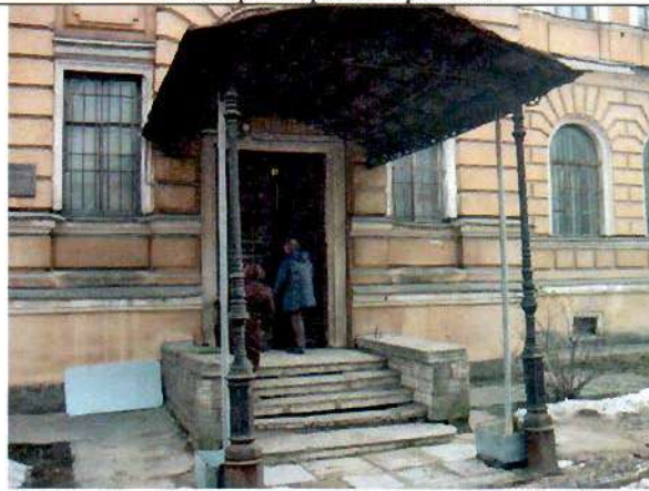
10. Входная группа северного фасада. Общий вид.
