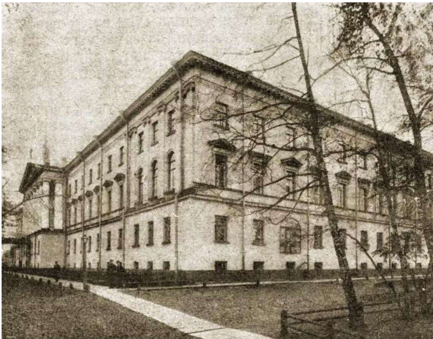
Илл. 23. Главный и северный фасады здания Духовной Академии. 1909 г. ЦГАКФФД СПб. Е-11561.
