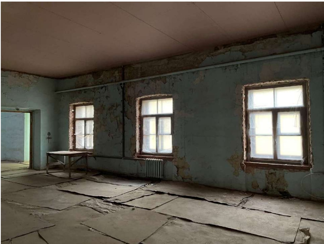
Фото 161. Интерьеры. Дата съемки 09.10.2023
