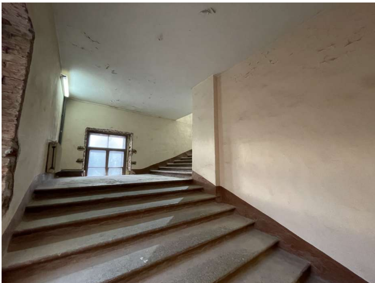
Фото 130. Интерьеры. Дата съемки 09.10.2023
