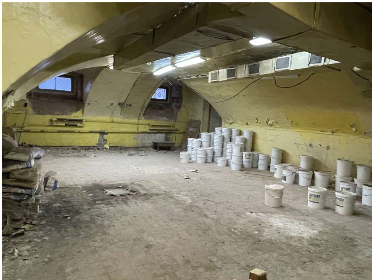
Фото 30. Интерьеры. Дата съёмки 09.10.2023
