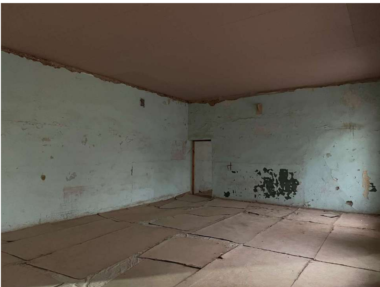
Фото 160. Интерьеры. Дата съемки 09.10.2023
