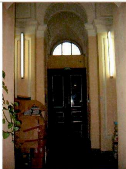
22. Помещение 1-го этажа. Фрагмент.
