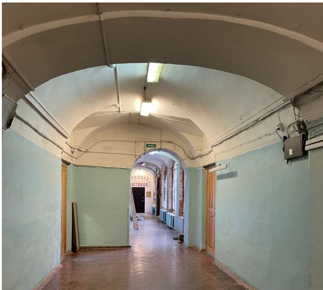
Фото 56. Интерьеры. Дата съемки 09.10.2023
