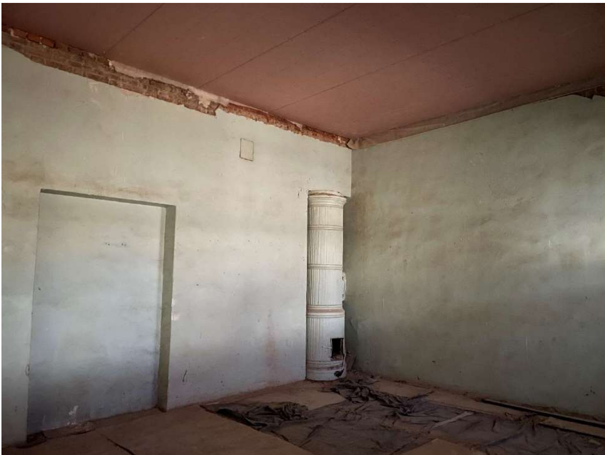
Фото 149. Интерьеры. Дата съемки 09.10.2023
