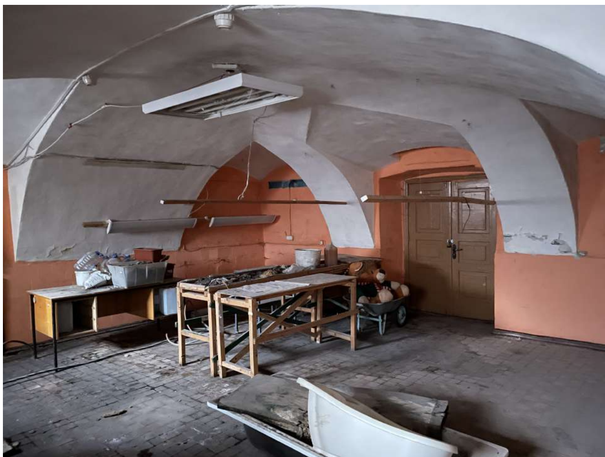
Фото 27. Интерьеры. Дата съёмки 09.10.2023
