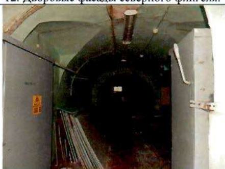
14. Коридор в уровне подвала. Общий вид.
