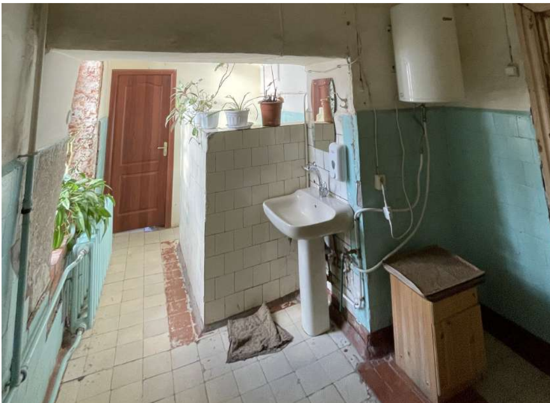
Фото 100. Интерьеры. Дата съемки 09.10.2023
