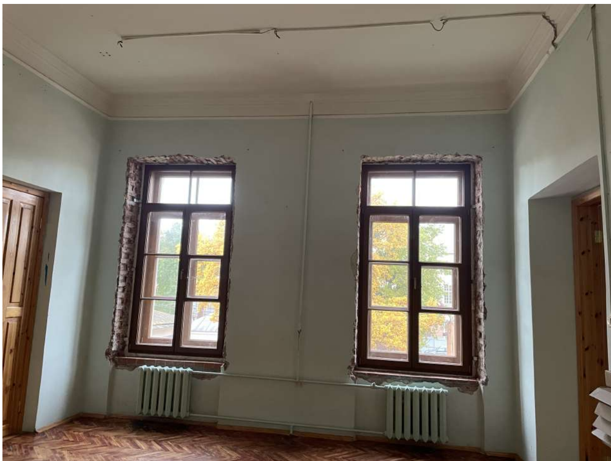
Фото 127. Интерьеры. Дата съемки 09.10.2023
