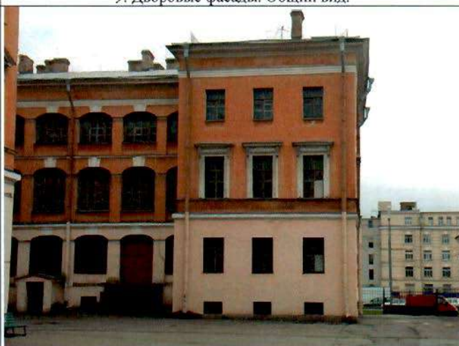
11. Дворовые фасады южного флигеля. Общий вид.
