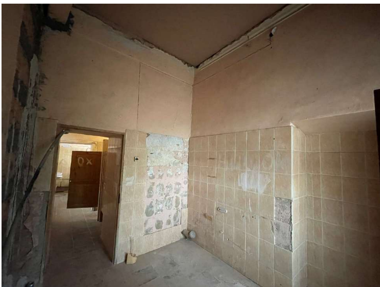
Фото 152. Интерьеры. Дата съёмки 09.10.2023
