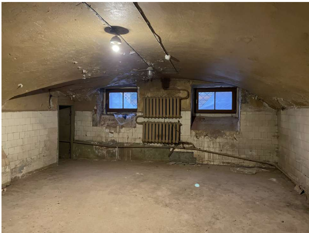
Фото 42. Интерьеры. Дата съёмки 09.10.2023
