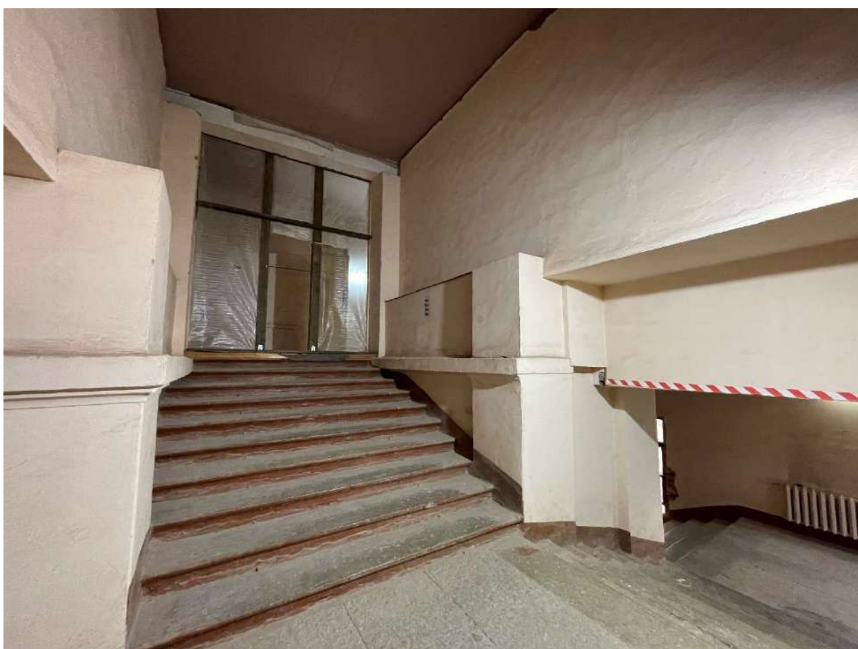
Фото 132. Интерьеры. Дата съемки 09.10.2023
