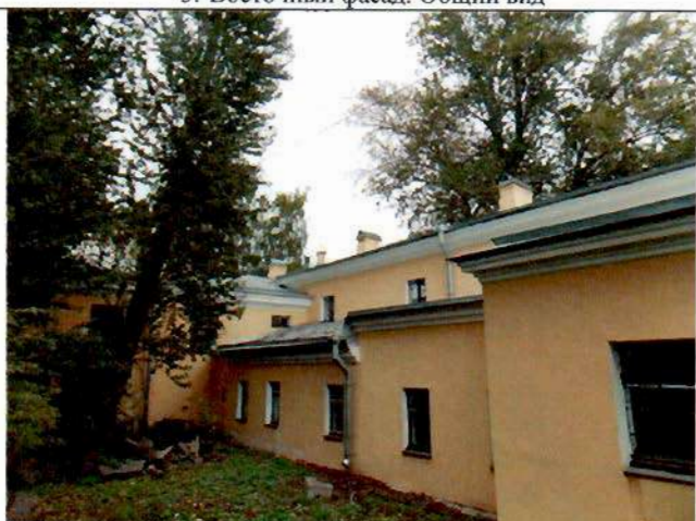
5. Западный фасад. Общий вид.
