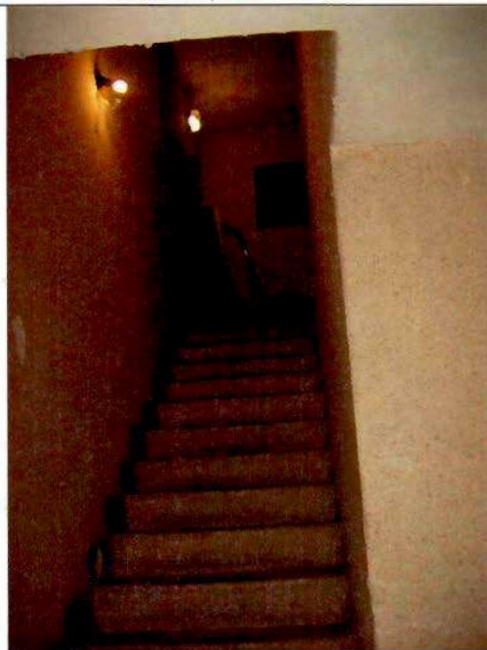
10. Лестница. Общий вид.
