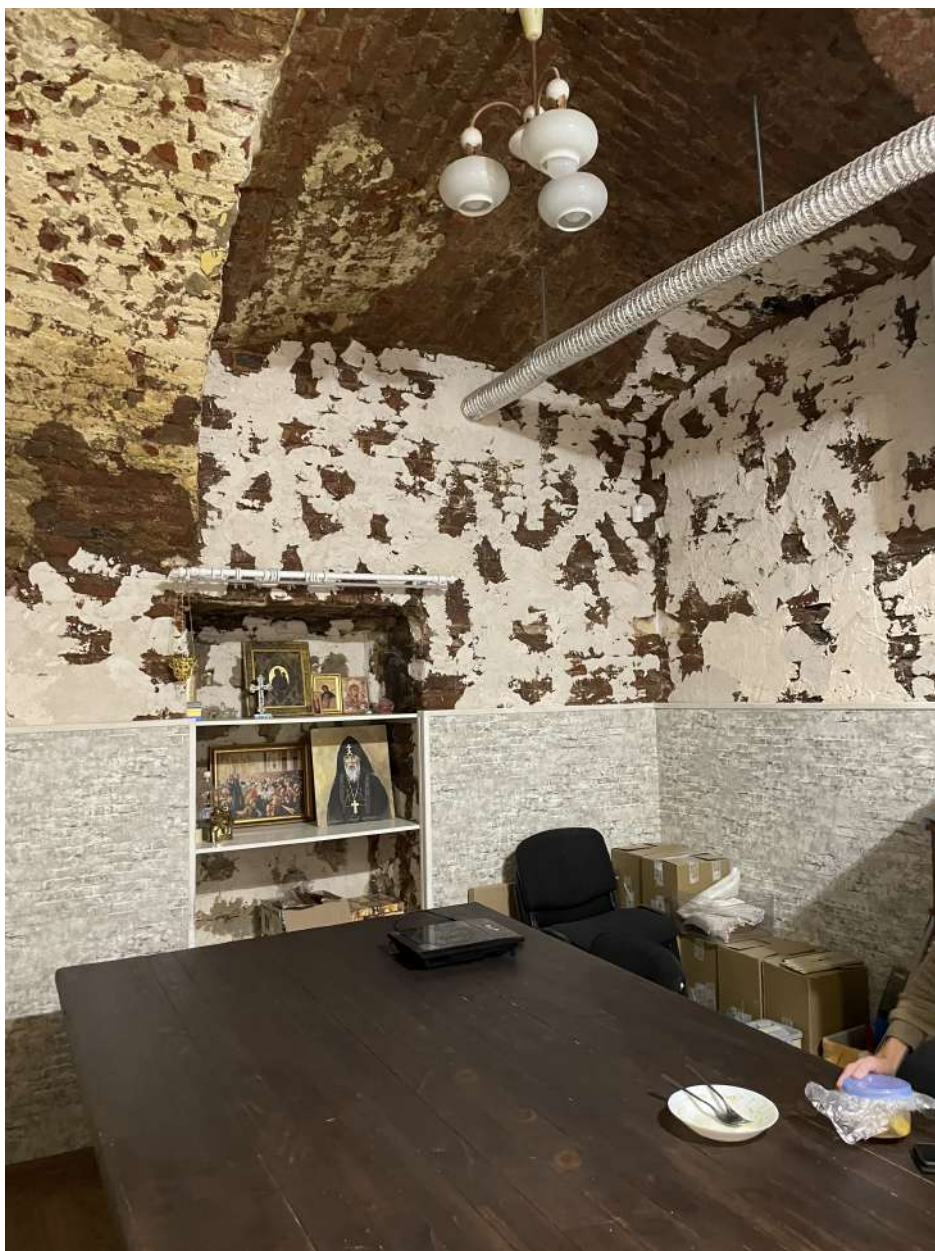
Фото 79. Интерьеры. Дата съемки 09.10.2023
