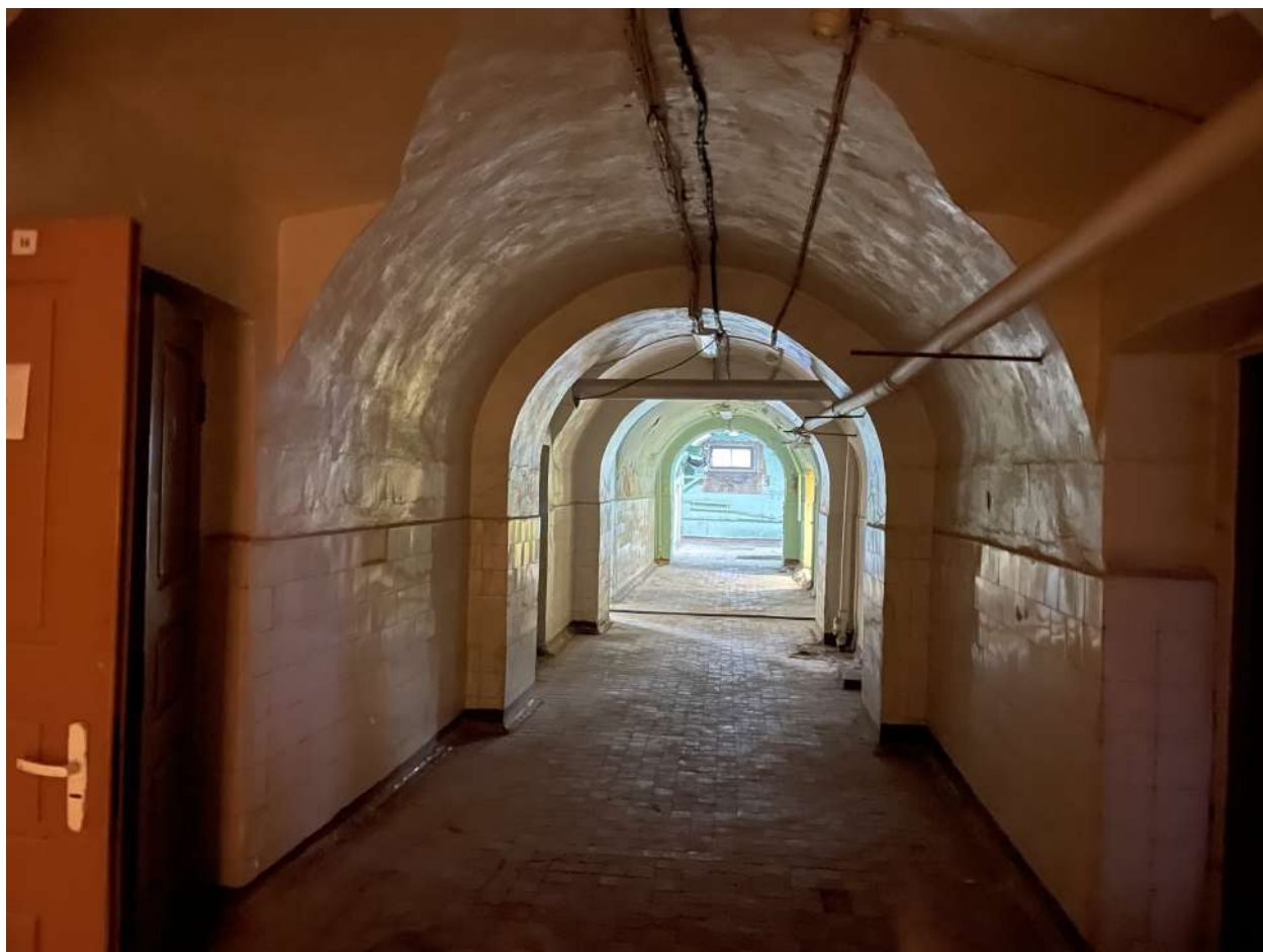
Фото 10. Интерьеры. Дата съёмки 09.10.2023
