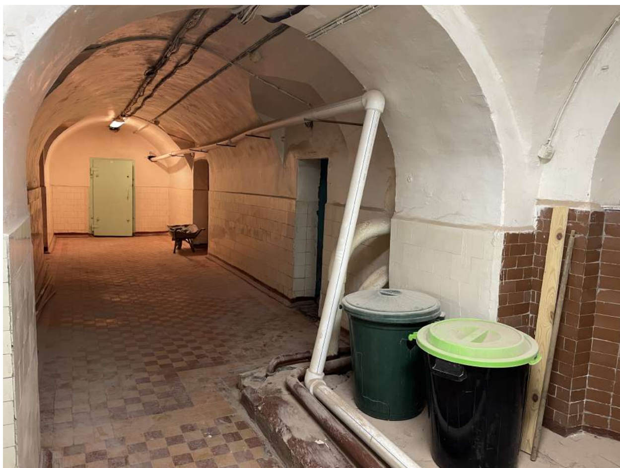
Фото 23. Интерьеры. Дата съёмки 09.10.2023
