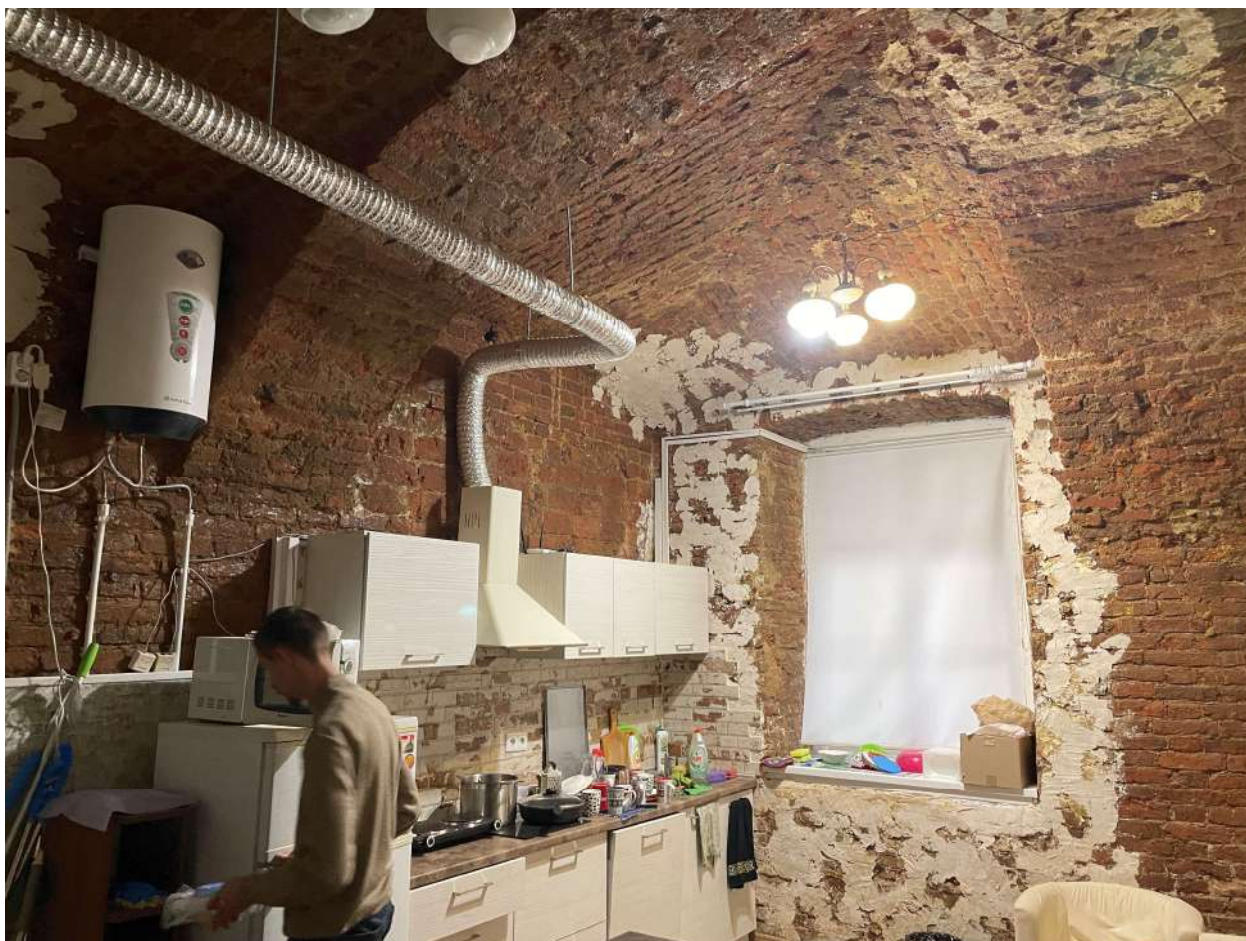
Фото 80. Интерьеры. Дата съемки 09.10.2023
