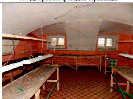
15. Помещение в уровне подвала. Общий вид.
