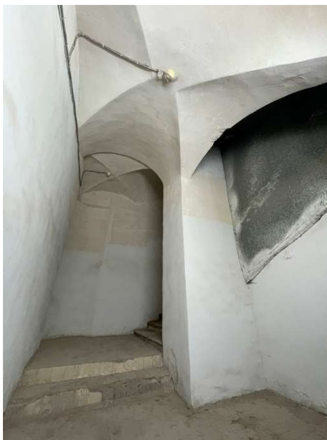
Фото 43. Интерьеры. Дата съёмки 09.10.2023
