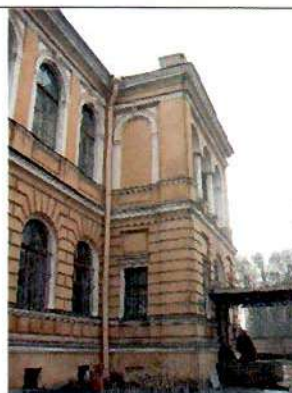
8. Северный фасад. Фрагмент.
