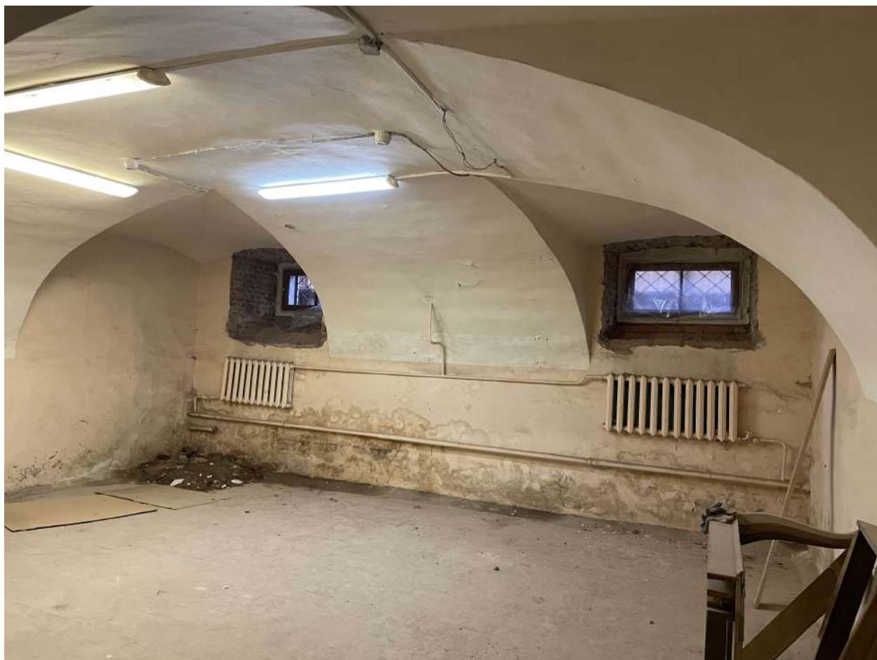
Фото 14. Интерьеры. Дата съёмки 09.10.2023
