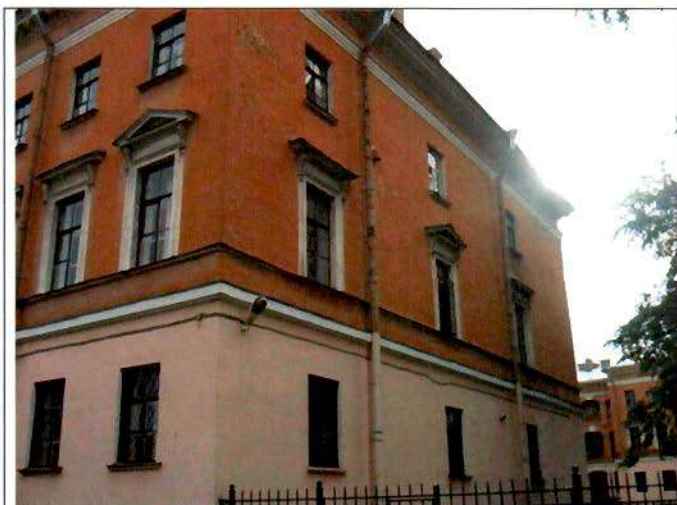
8. Западный торцевой фасад северного флигеля. Общий вид.
