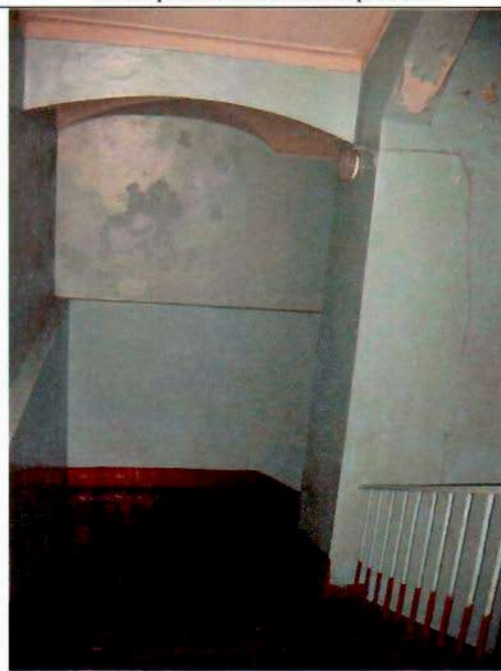
39. Лестница в южном крыле. Фрагмент.
