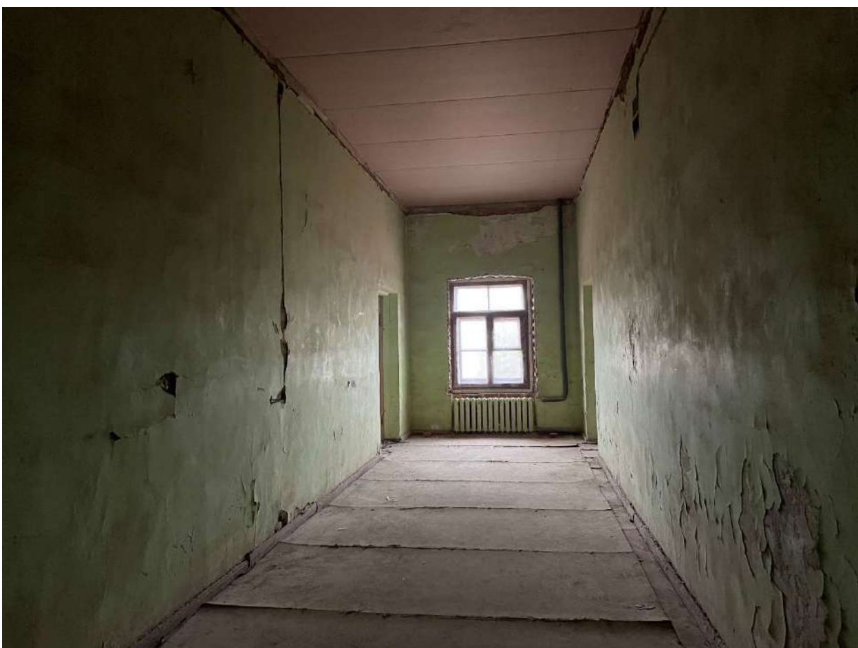
Фото 140. Интерьеры. Дата съёмки 09.10.2023
