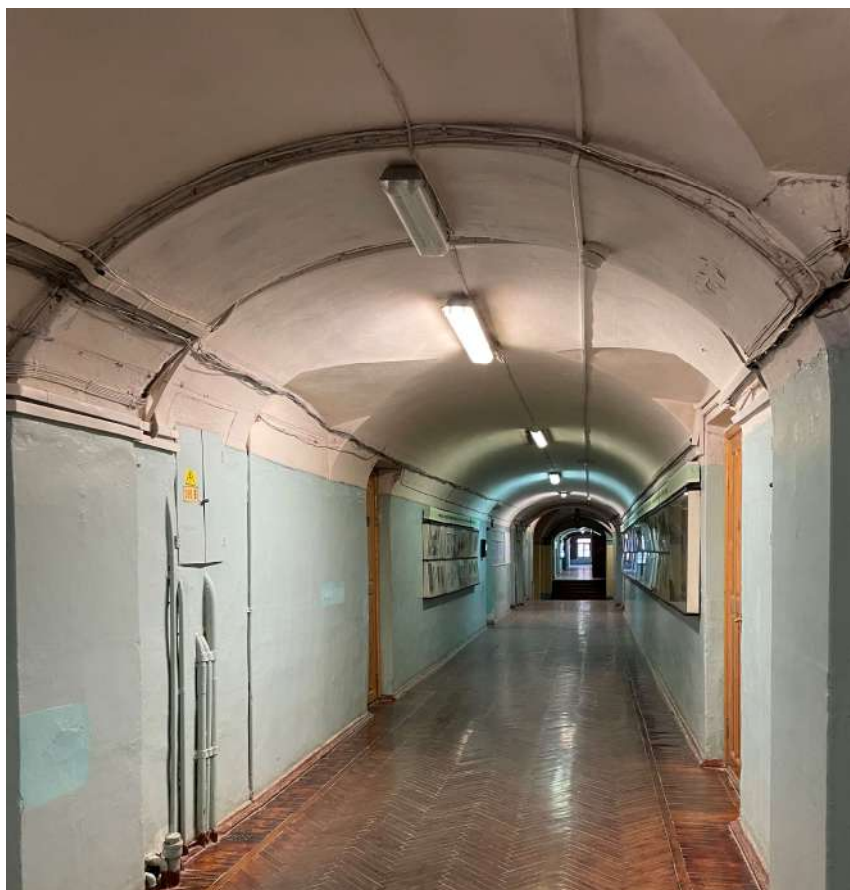
Фото 55. Интерьеры. Дата съёмки 09.10.2023
