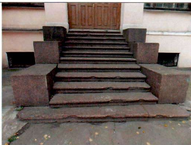
13. Дворовые фасады. Крыльца.
