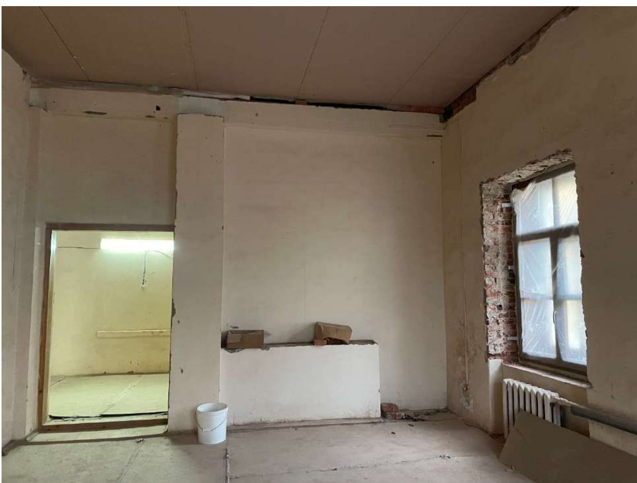
Фото 156. Интерьеры. Дата съемки 09.10.2023
