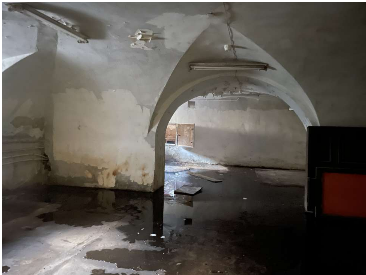
Фото 20. Интерьеры. Дата съёмки 09.10.2023
