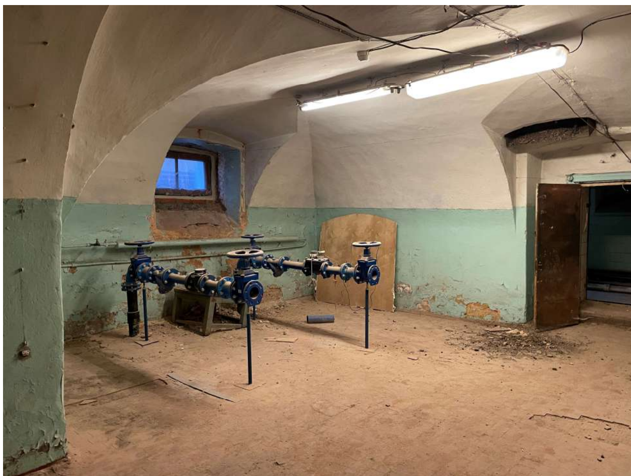
Фото 39. Интерьеры. Дата съёмки 09.10.2023
