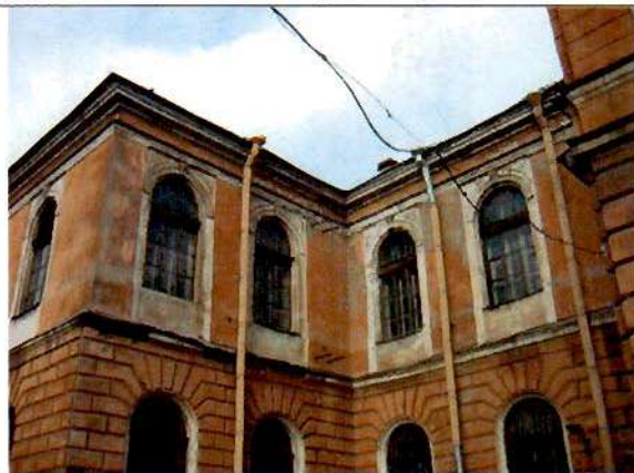
13. Западный фасад. Фрагмент.
