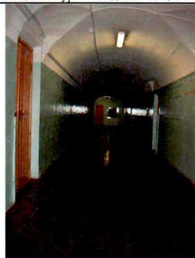
17. Коридор 1-го этажа. Общий вид.
