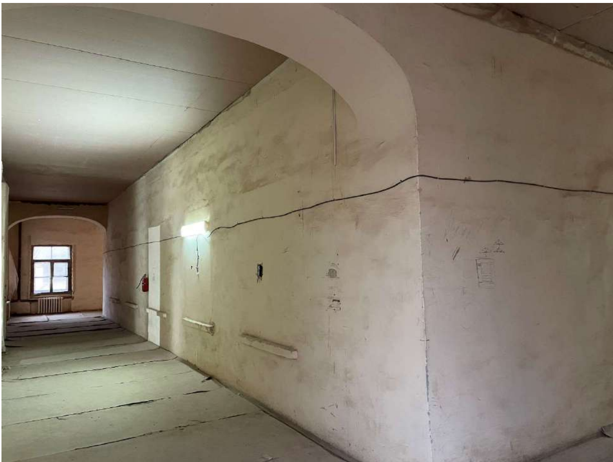
Фото 157. Интерьеры. Дата съёмки 09.10.2023
