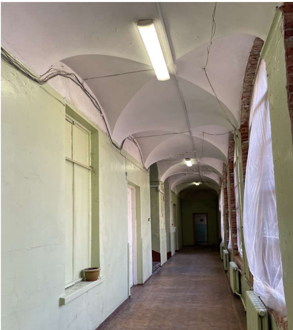
Фото 101. Интерьеры. Дата съемки 09.10.2023
