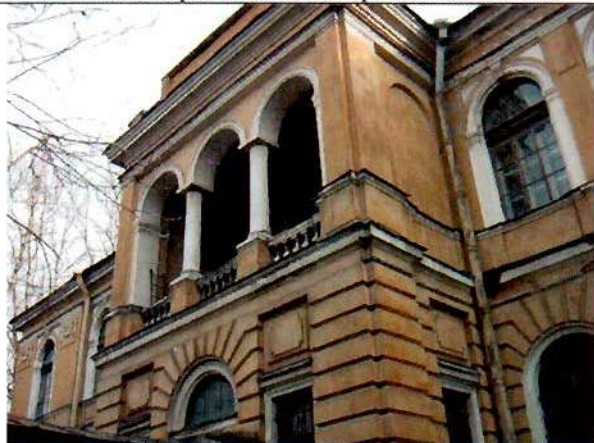
9. Северный фасад. Фрагмент.
