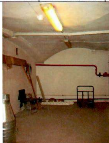
25. Помещение подвала. Общий вид.
