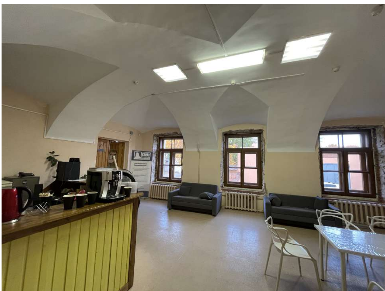
Фото 72. Интерьеры. Дата съемки 09.10.2023
