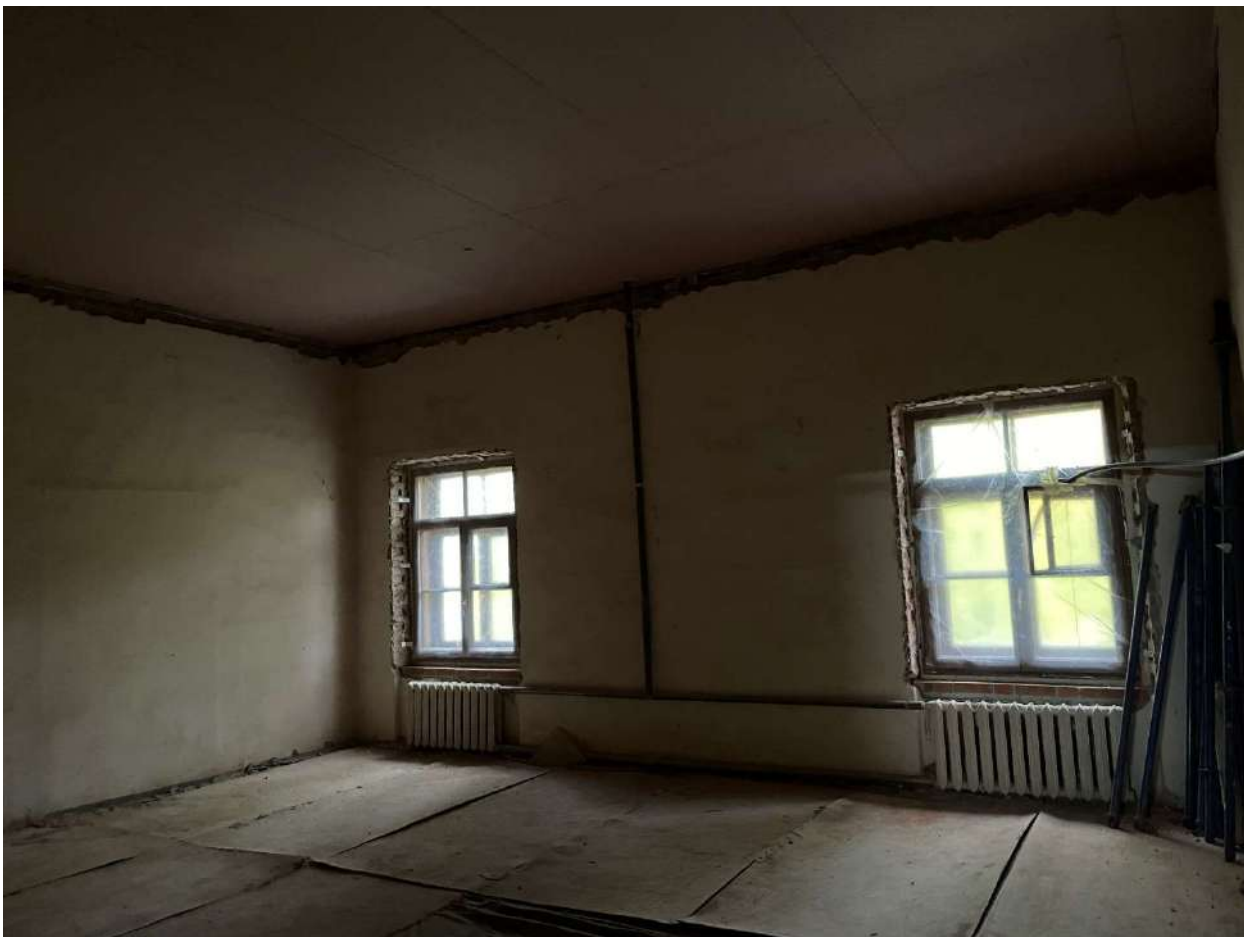
Фото 141. Интерьеры. Дата съёмки 09.10.2023
