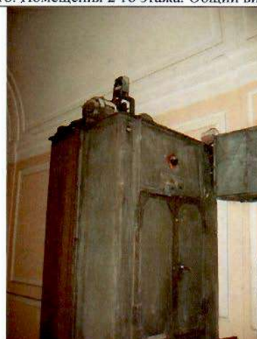
20. Лифтовая шахта. Фрагмент.
