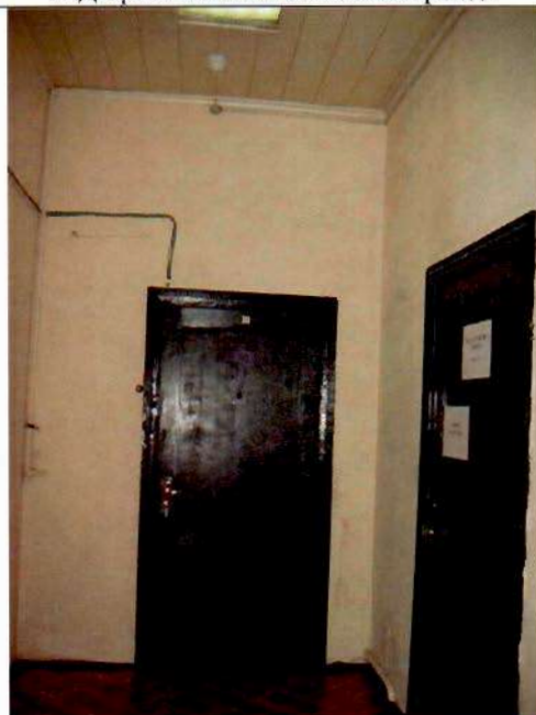
9. Коридор 1-го этажа.
