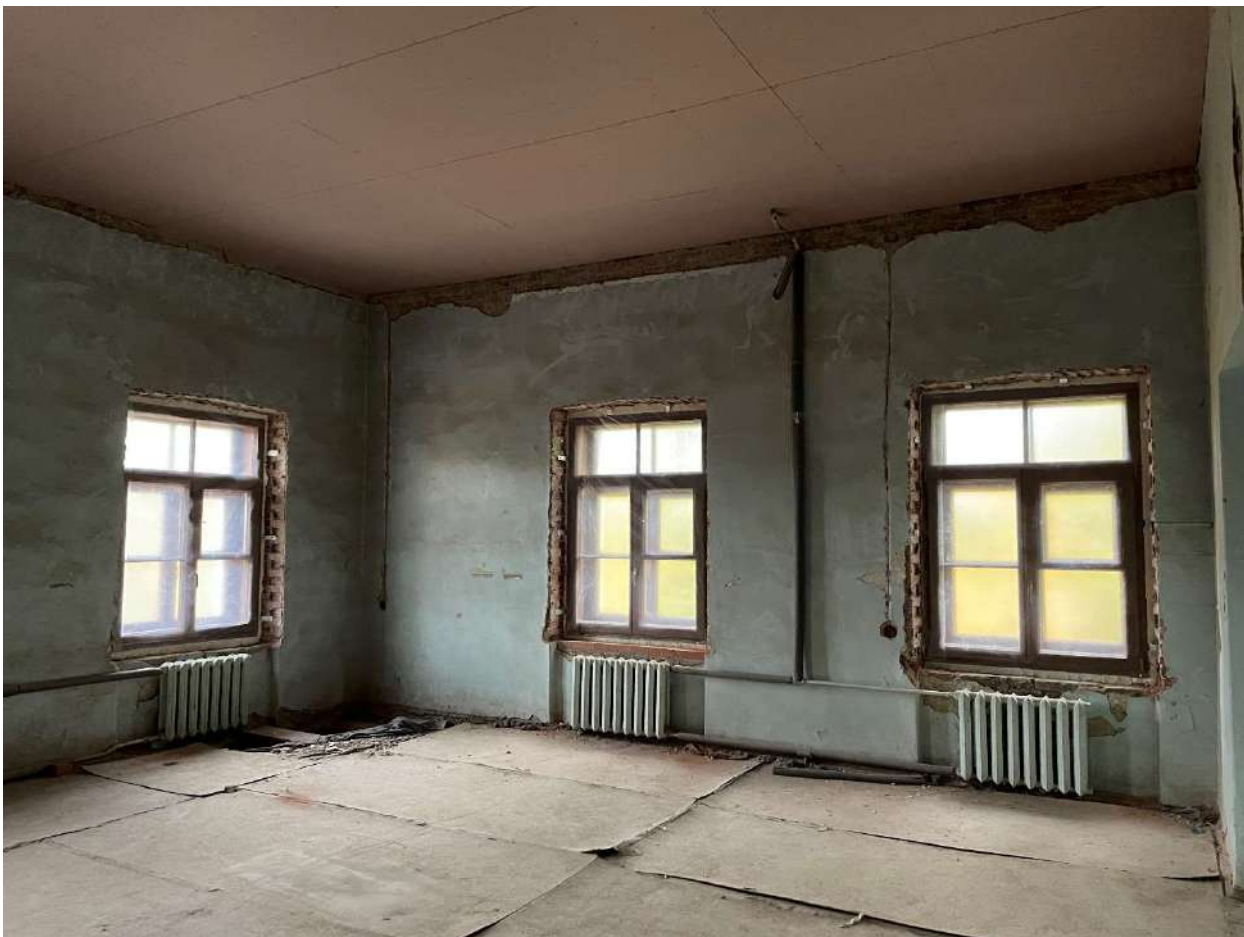
Фото 143. Интерьеры. Дата съемки 09.10.2023
