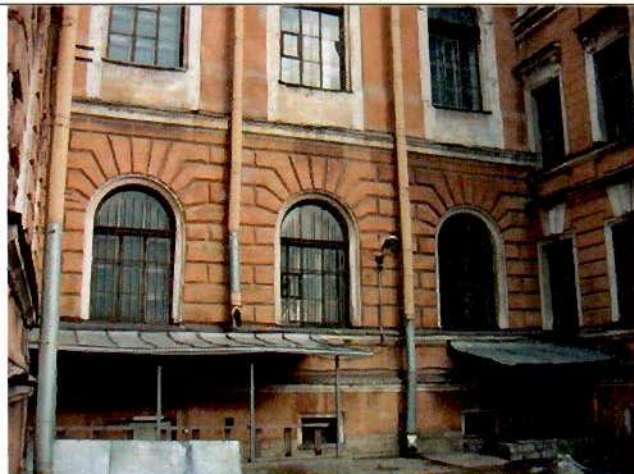
12. Западный фасад. Фрагмент.
