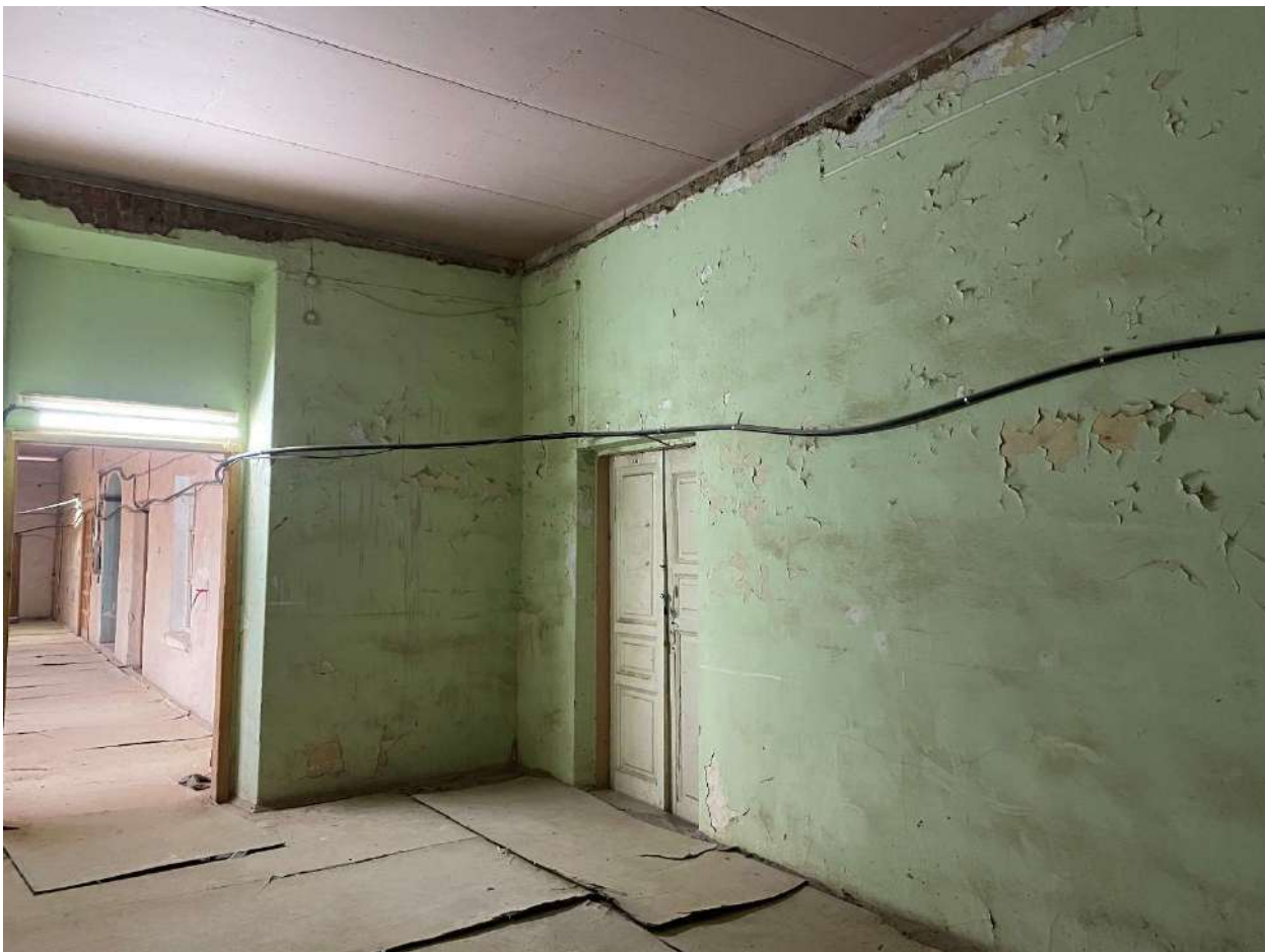
Фото 139. Интерьеры. Дата съёмки 09.10.2023
