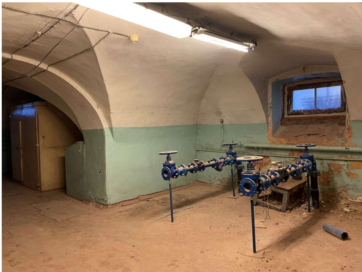
Фото 40. Интерьеры. Дата съемки 09.10.2023
