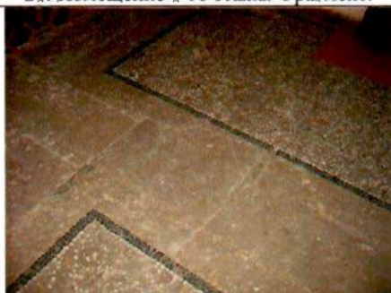
23. Напольное покрытие помещений. Фрагмент.
