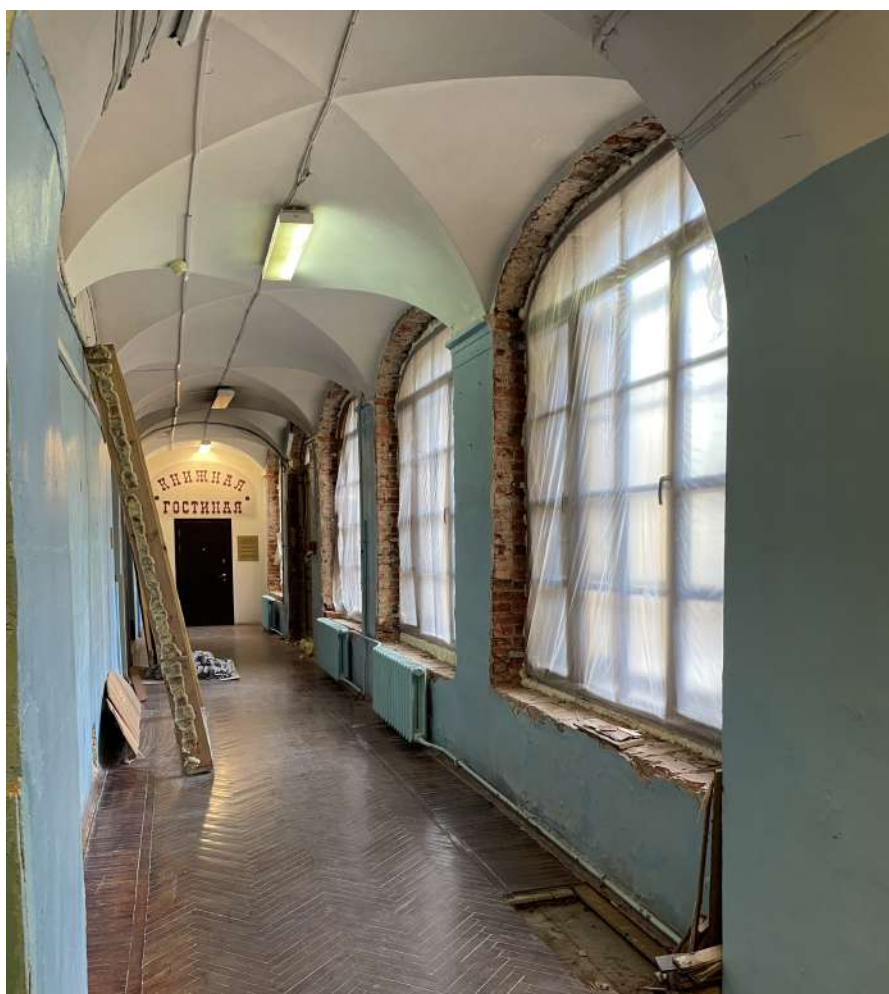
Фото 57. Интерьеры. Дата съемки 09.10.2023
