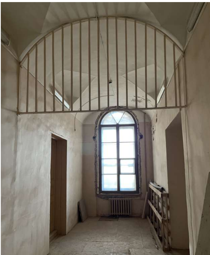
Фото 93. Интерьеры. Дата съемки 09.10.2023
