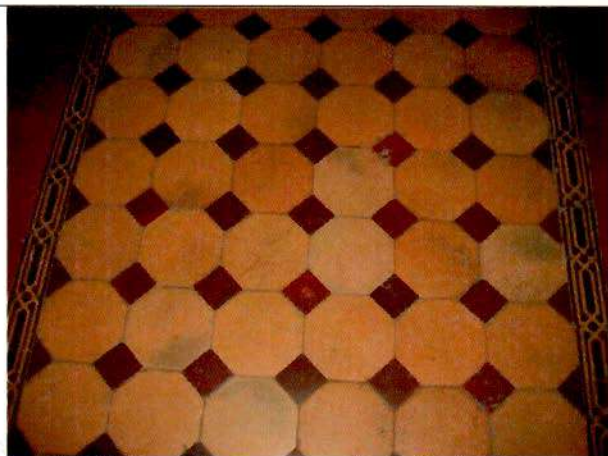
24. Покрытие пола вестибюля. Фрагмент.
