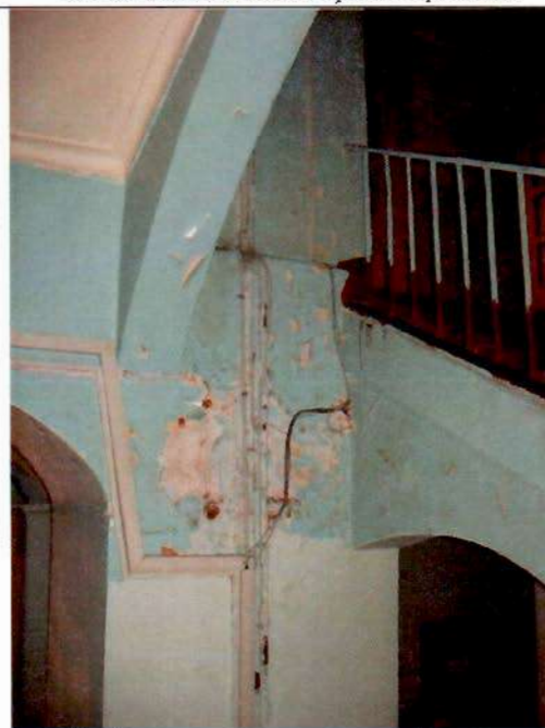
41. Лестница в южном крыле. Фрагмент.
