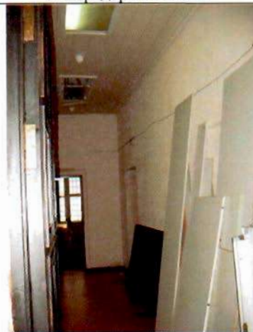
11. Коридор 1-го этажа. Общий вид.
