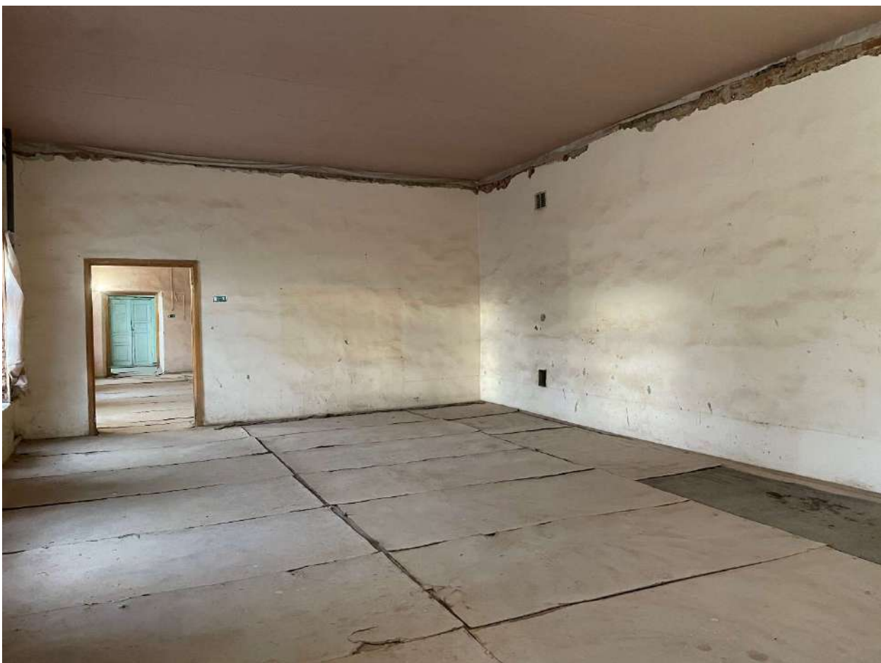
Фото 136. Интерьеры. Дата съемки 09.10.2023
