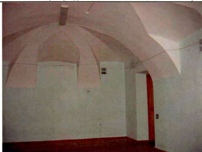
16. Помещения 1-го этажа. Общий вид.
