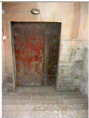
7. Входной проем восточного фасада. Общий вид.
