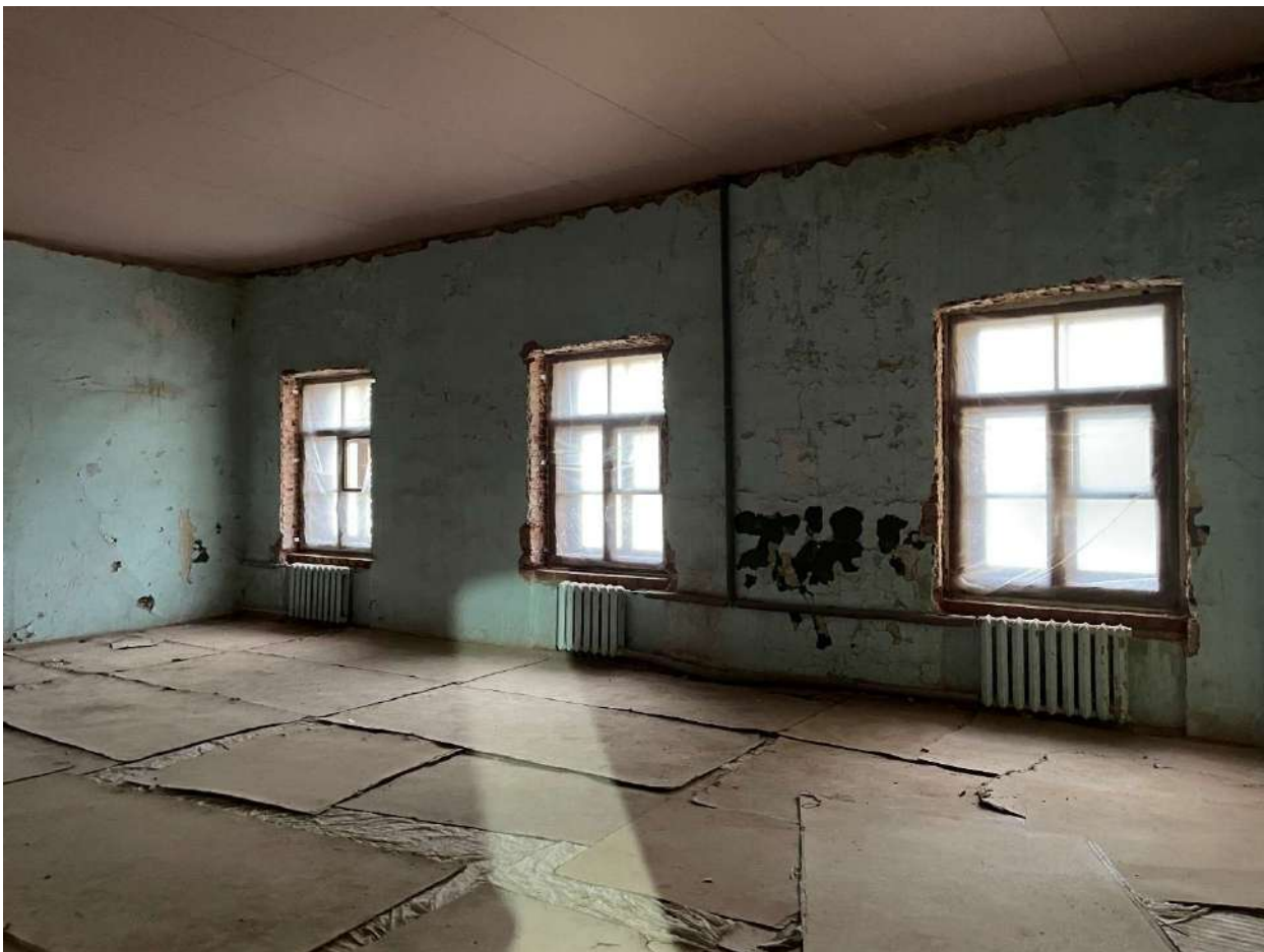
Фото 159. Интерьеры. Дата съемки 09.10.2023
