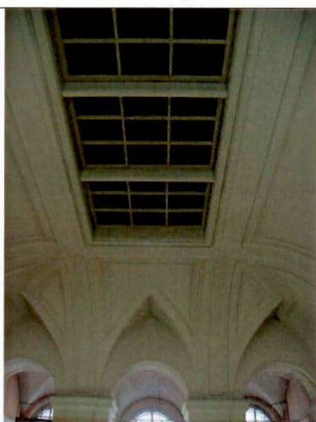
18. Помещения 2-го этажа. Общий вид.
