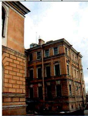
11. Западный фасад. Фрагмент.
