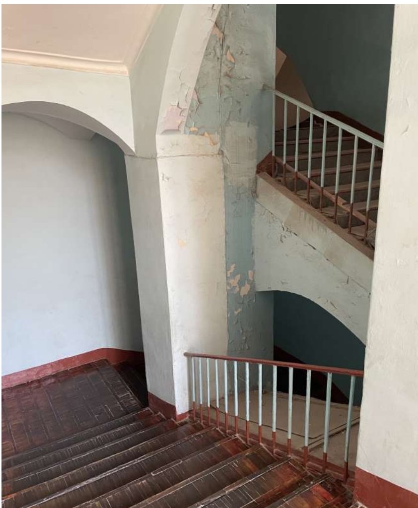
Фото 114. Интерьеры. Дата съемки 09.10.2023
