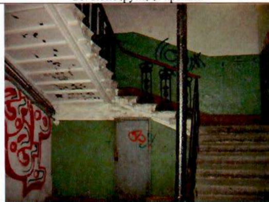
28. Лестница в южной части здания. Общий вид.
