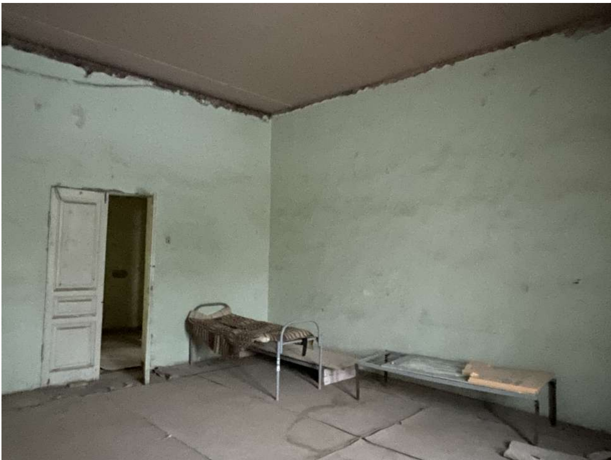
Фото 169. Интерьеры. Дата съёмки 09.10.2023
