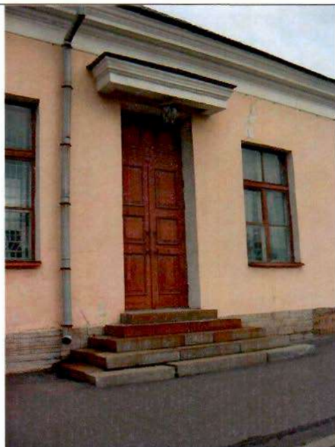
7. Дверное заполнение. Южный фасад.
