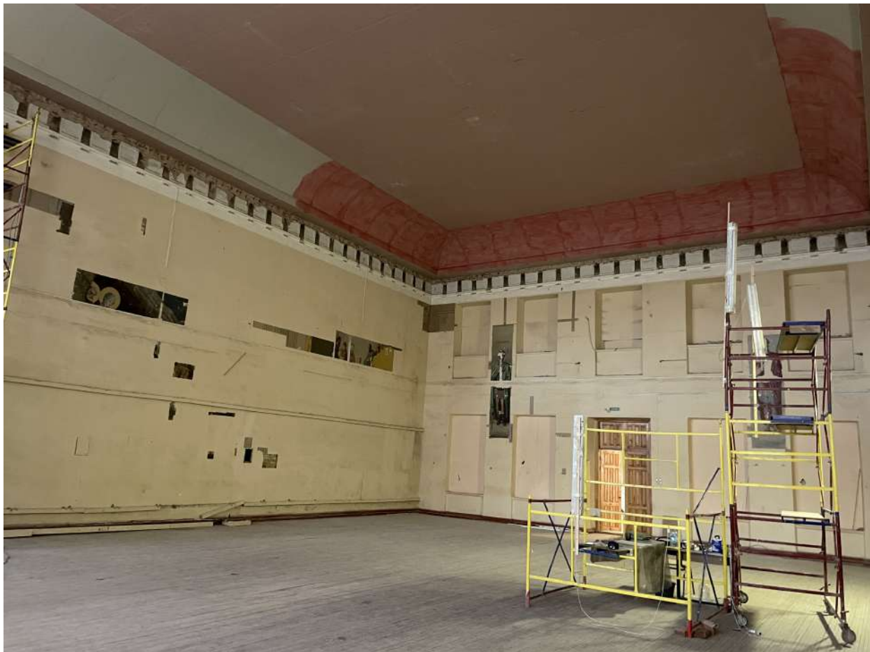
Фото 87. Интерьеры. Дата съемки 09.10.2023
