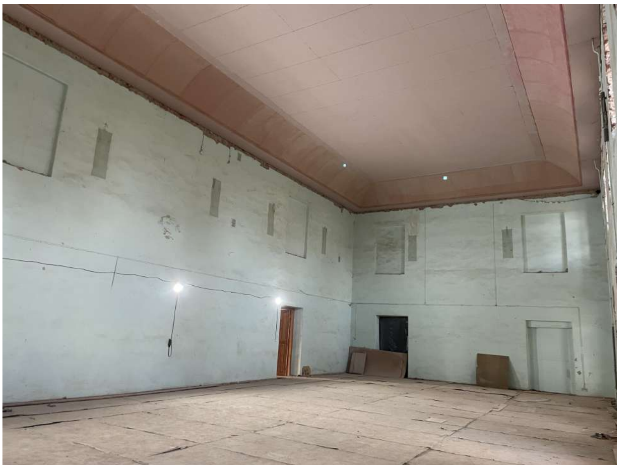
Фото 112. Интерьеры. Дата съёмки 09.10.2023
