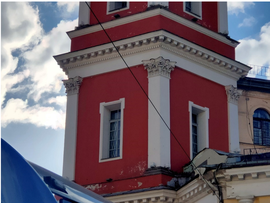
28. «Дума городская с башней (1752-1753 г.г., 1799-1804 г.г., арх. Феррари Д. 1848-1852 г.г., арх. Ефимов Н.Е., 1913-1914 г.г., арх. Кенель А.В.)», ул. Думская, д 1-3, Невский просп. лит. А. Башня. Фрагмент. Фото 17.10.2023г.
