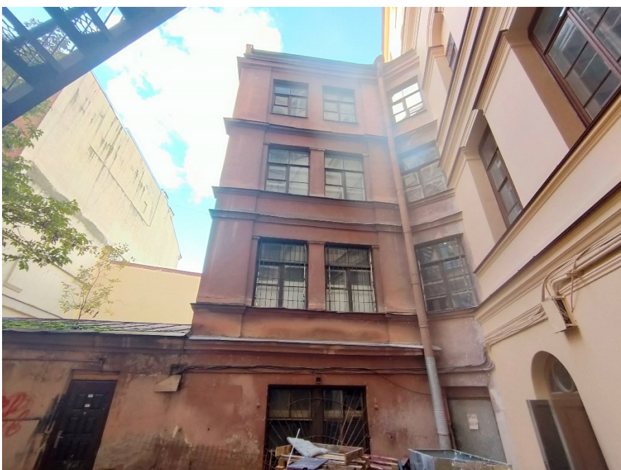
48. «Дума городская с башней (1752-1753 г.г., 1799-1804 г.г., арх. Феррари Д. 1848-1852 г.г., арх. Ефимов Н.Е., 1913-1914 г.г., арх. Кенель А.В.)», ул. Думская, д 1-3, Невский просп. лит. А. Дворовый фасад. Фрагмент. Фото 17.10.2023г.
