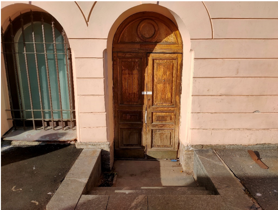
9. «Дума городская с башней (1752-1753 г.г., 1799-1804 г.г., арх. Феррари Д. 1848-1852 г.г., арх. Ефимов Н.Е., 1913-1914 г.г., арх. Кенель А.В.)», ул. Думская, д 1-3, Невский просп. лит. А. Восточный фасад. Входная группа. Общий вид. Фото 17.10.2023г.
