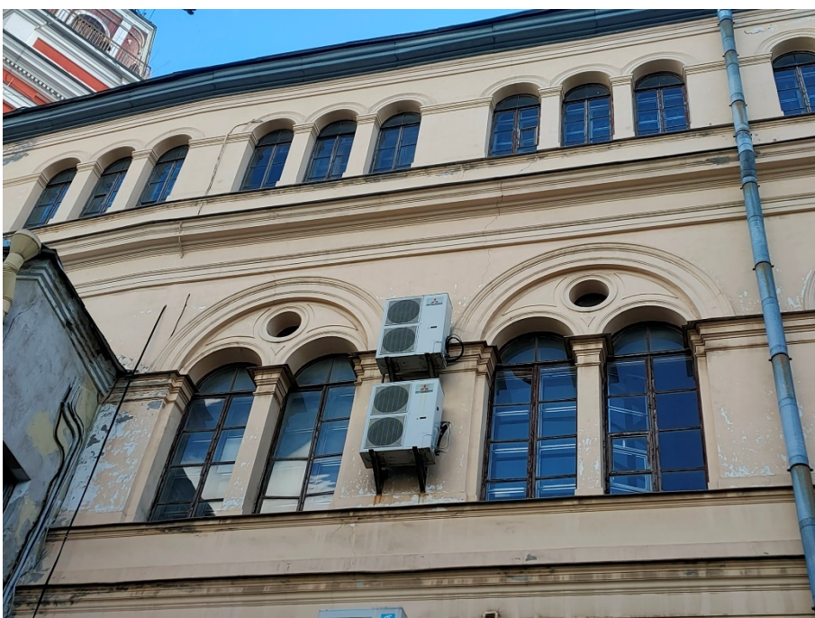
44. «Дума городская с башней (1752-1753 г.г., 1799-1804 г.г., арх. Феррари Д. 1848-1852 г.г., арх. Ефимов Н.Е., 1913-1914 г.г., арх. Кенель А.В.)», ул. Думская, д 1-3, Невский просп. лит. А. Дворовый фасад. Фрагмент. Фото 17.10.2023г.
