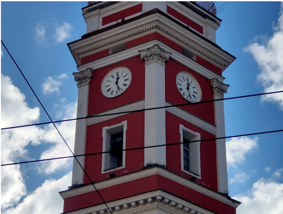
27. «Дума городская с башней (1752-1753 г.г., 1799-1804 г.г., арх. Феррари Д. 1848-1852 г.г., арх. Ефимов Н.Е., 1913-1914 г.г., арх. Кенель А.В.)», ул. Думская, д 1-3, Невский просп. лит. А. Башня. Фрагмент. Фото 17.10.2023г.
