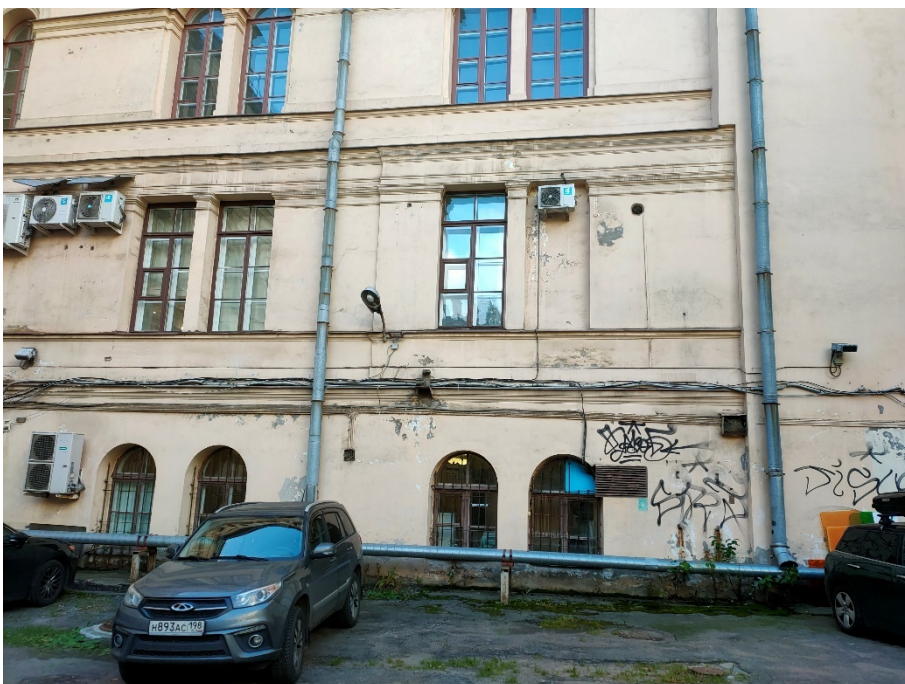
35. «Дума городская с башней (1752-1753 г.г., 1799-1804 г.г., арх. Феррари Д. 1848-1852 г.г., арх. Ефимов Н.Е., 1913-1914 г.г., арх. Кенель А.В.)», ул. Думская, д 1-3, Невский просп. лит. А. Дворовый фасад. Фрагмент. Фото 17.10.2023г.
