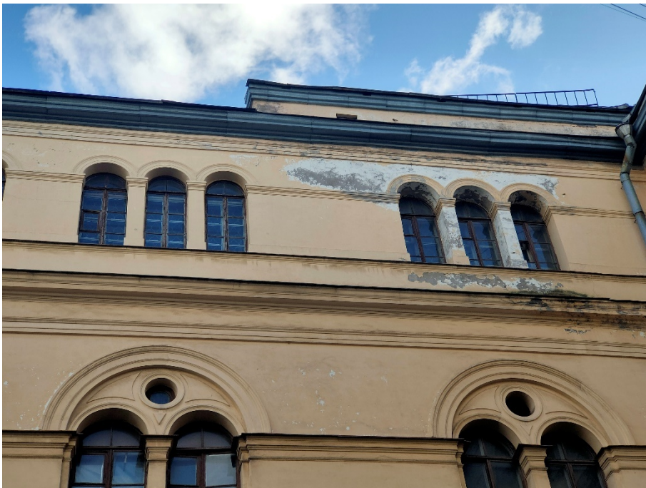
38. «Дума городская с башней (1752-1753 г.г., 1799-1804 г.г., арх. Феррари Д. 1848-1852 г.г., арх. Ефимов Н.Е., 1913-1914 г.г., арх. Кенель А.В.)», ул. Думская, д 1-3, Невский просп. лит. А. Дворовый фасад. Фрагмент. Фото 17.10.2023г.
