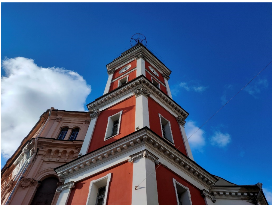
23. «Дума городская с башней (1752-1753 г.г., 1799-1804 г.г., арх. Феррари Д. 1848-1852 г.г., арх. Ефимов Н.Е., 1913-1914 г.г., арх. Кенель А.В.)», ул. Думская, д 1-3, Невский просп. лит. А. Башня. Фрагмент. Фото 17.10.2023г.
