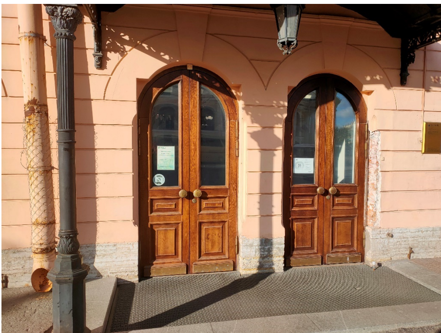
17. «Дума городская с башней (1752-1753 г.г., 1799-1804 г.г., арх. Феррари Д. 1848-1852 г.г., арх. Ефимов Н.Е., 1913-1914 г.г., арх. Кенель А.В.)», ул. Думская, д 1-3, Невский просп. лит. А. Восточный фасад. Входная группа. Общий вид. Фото 17.10.2023г.
