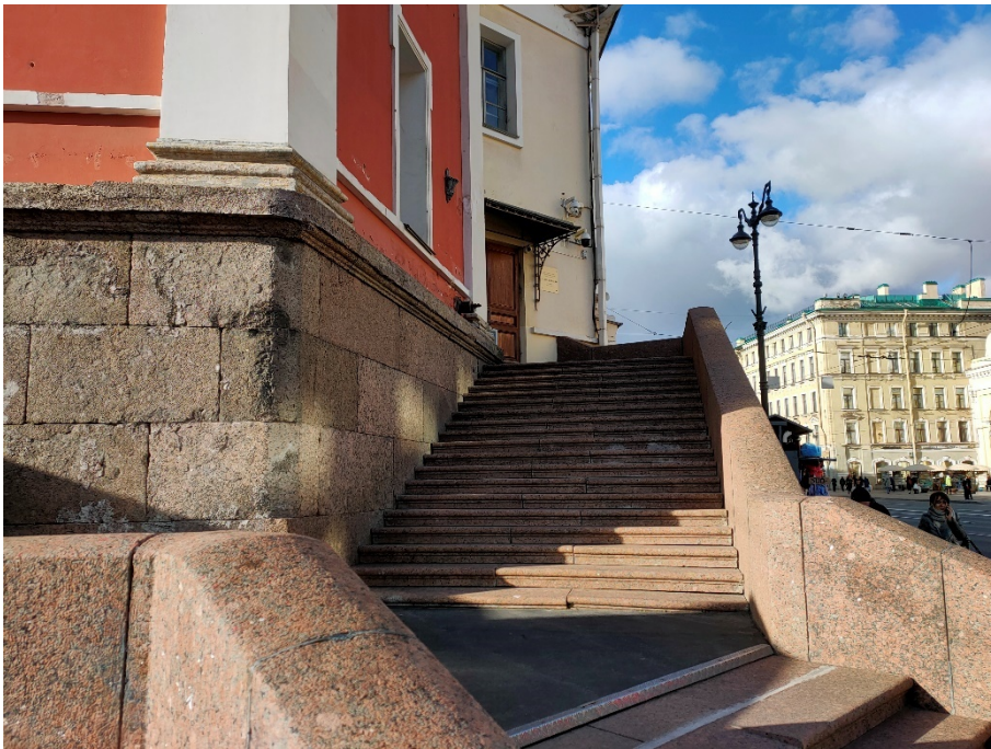
21. «Дума городская с башней (1752-1753 г.г., 1799-1804 г.г., арх. Феррари Д. 1848-1852 г.г., арх. Ефимов Н.Е., 1913-1914 г.г., арх. Кенель А.В.)», ул. Думская, д 1-3, Невский просп. лит. А. Восточный фасад. Фрагмент. Фото 17.10.2023г.
