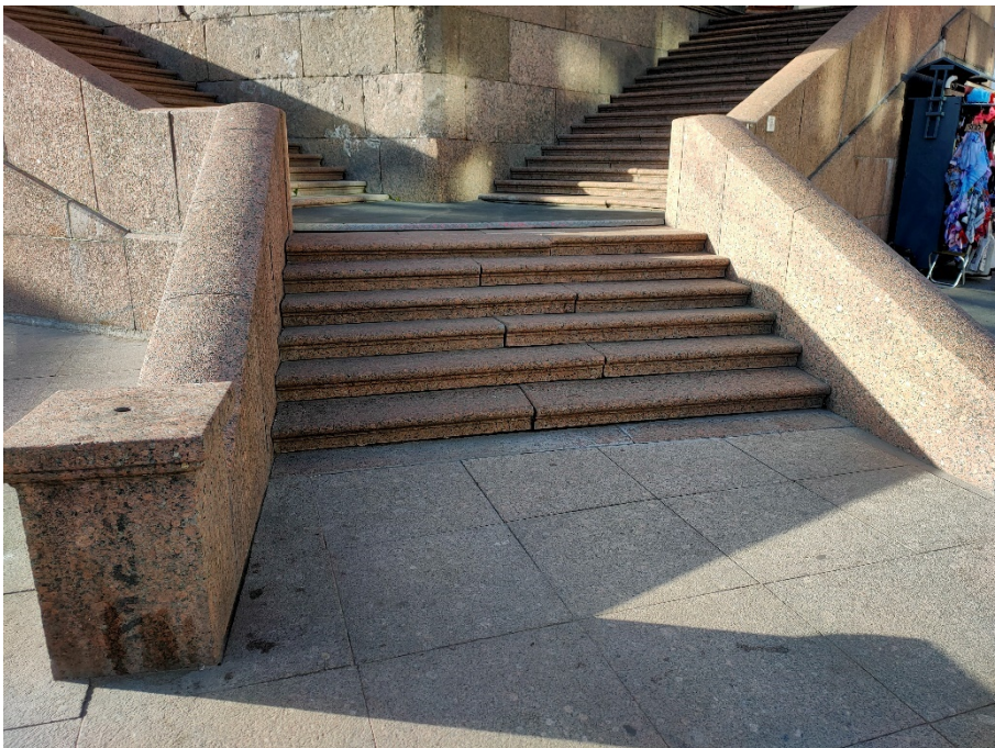
22. «Дума городская с башней (1752-1753 г.г., 1799-1804 г.г., арх. Феррари Д. 1848-1852 г.г., арх. Ефимов Н.Е., 1913-1914 г.г., арх. Кенель А.В.)», ул. Думская, д 1-3, Невский просп. лит. А. Восточный фасад. Фрагмент. Фото 17.10.2023г.
