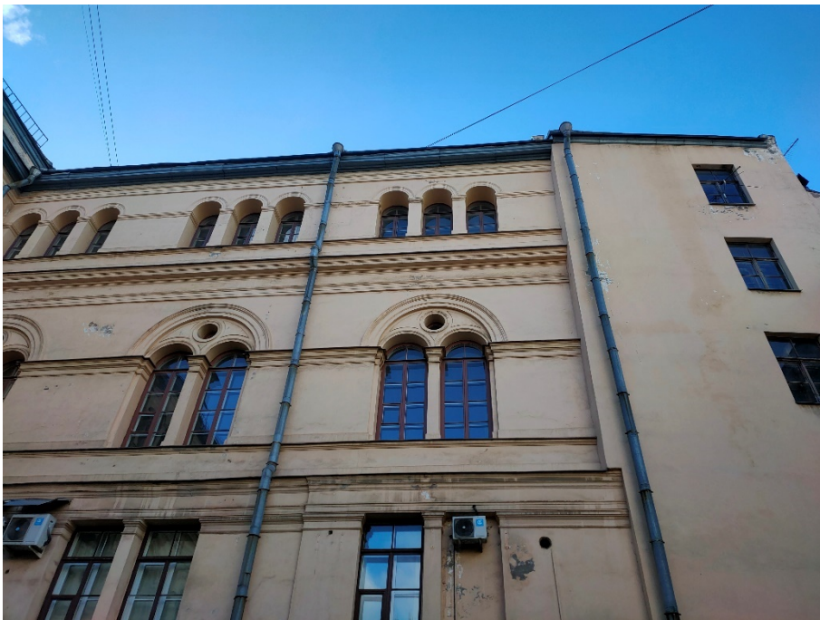
34. «Дума городская с башней (1752-1753 г.г., 1799-1804 г.г., арх. Феррари Д. 1848-1852 г.г., арх. Ефимов Н.Е., 1913-1914 г.г., арх. Кенель А.В.)», ул. Думская, д 1-3, Невский просп. лит. А. Дворовый фасад. Фрагмент. Фото 17.10.2023г.
