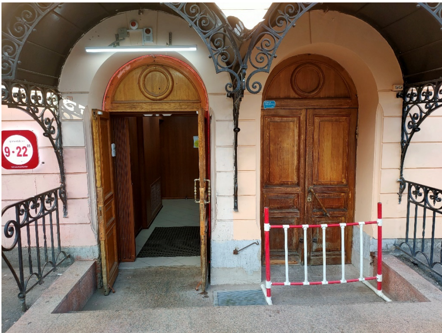
6. «Дума городская с башней (1752-1753 г.г., 1799-1804 г.г., арх. Феррари Д. 1848-1852 г.г., арх. Ефимов Н.Е., 1913-1914 г.г., арх. Кенель А.В.)», ул. Думская, д 1-3, Невский просп. лит. А. Восточный фасад. Входная группа. Общий вид. Фото 17.10.2023г.
