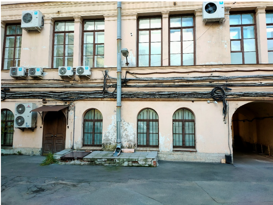
42. «Дума городская с башней (1752-1753 г.г., 1799-1804 г.г., арх. Феррари Д. 1848-1852 г.г., арх. Ефимов Н.Е., 1913-1914 г.г., арх. Кенель А.В.)», ул. Думская, д 1-3, Невский просп. лит. А. Дворовый фасад. Фрагмент. Фото 17.10.2023г.
