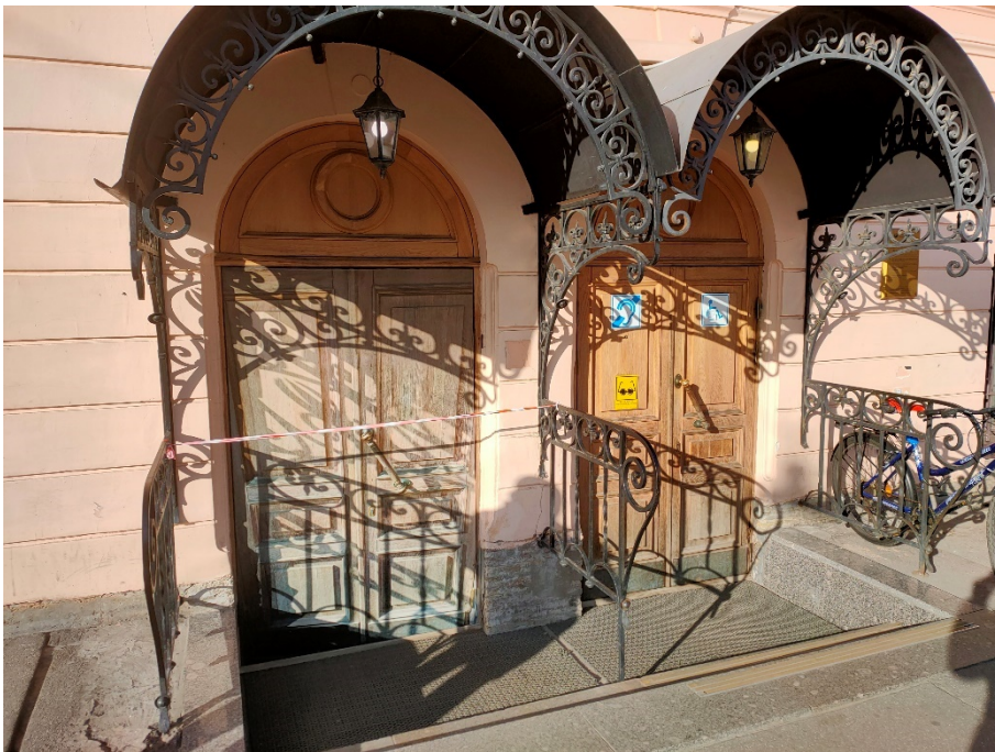
10. «Дума городская с башней (1752-1753 г.г., 1799-1804 г.г., арх. Феррари Д. 1848-1852 г.г., арх. Ефимов Н.Е., 1913-1914 г.г., арх. Кенель А.В.)», ул. Думская, д 1-3, Невский просп. лит. А. Восточный фасад. Входная группа. Общий вид. Фото 17.10.2023г.
