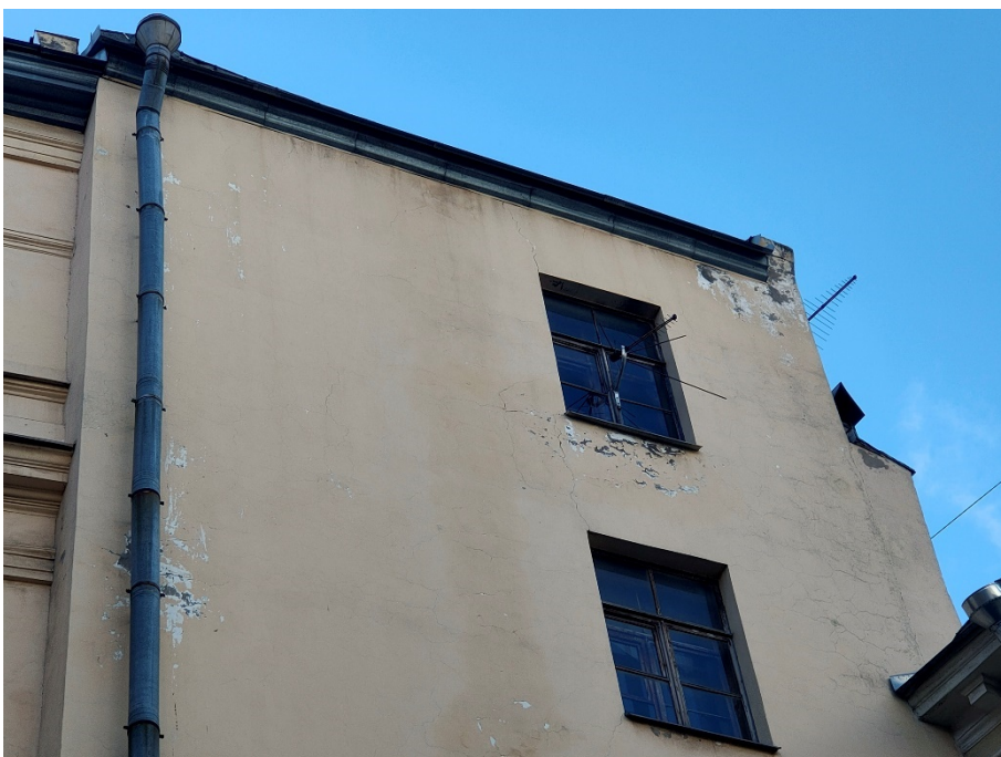
31. «Дума городская с башней (1752-1753 г.г., 1799-1804 г.г., арх. Феррари Д. 1848-1852 г.г., арх. Ефимов Н.Е., 1913-1914 г.г., арх. Кенель А.В.)», ул. Думская, д 1-3, Невский просп. лит. А. Дворовый фасад. Фрагмент. Фото 17.10.2023г.
