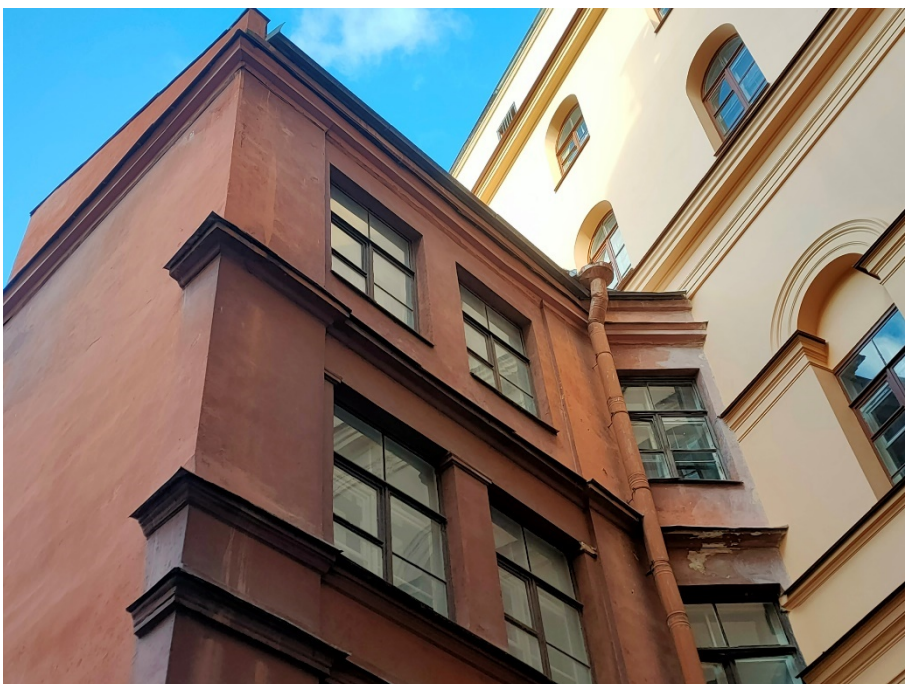
49. «Дума городская с башней (1752-1753 г.г., 1799-1804 г.г., арх. Феррари Д. 1848-1852 г.г., арх. Ефимов Н.Е., 1913-1914 г.г., арх. Кенель А.В.)», ул. Думская, д 1-3, Невский просп. лит. А. Дворовый фасад. Фрагмент. Фото 17.10.2023г.
