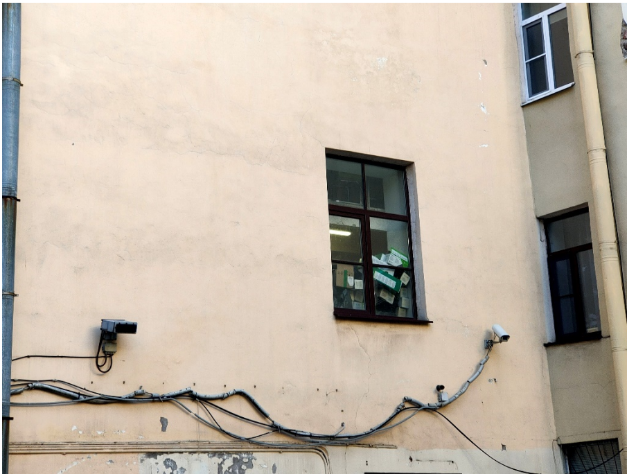
33. «Дума городская с башней (1752-1753 г.г., 1799-1804 г.г., арх. Феррари Д. 1848-1852 г.г., арх. Ефимов Н.Е., 1913-1914 г.г., арх. Кенель А.В.)», ул. Думская, д 1-3, Невский просп. лит. А. Дворовый фасад. Фрагмент. Фото 17.10.2023г.
