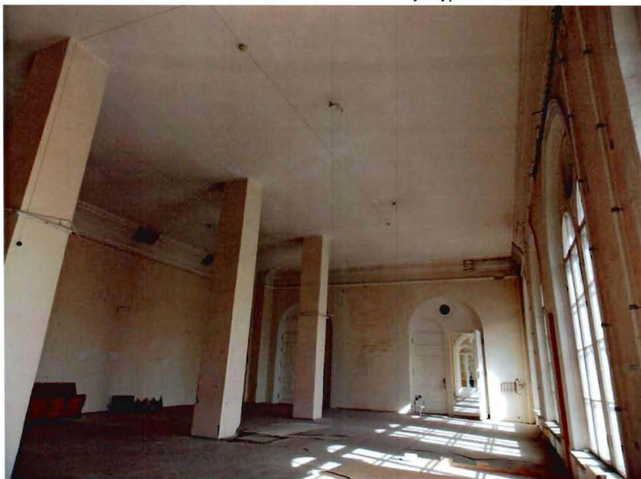
6. Помещение 3 этажа (41-Н).
