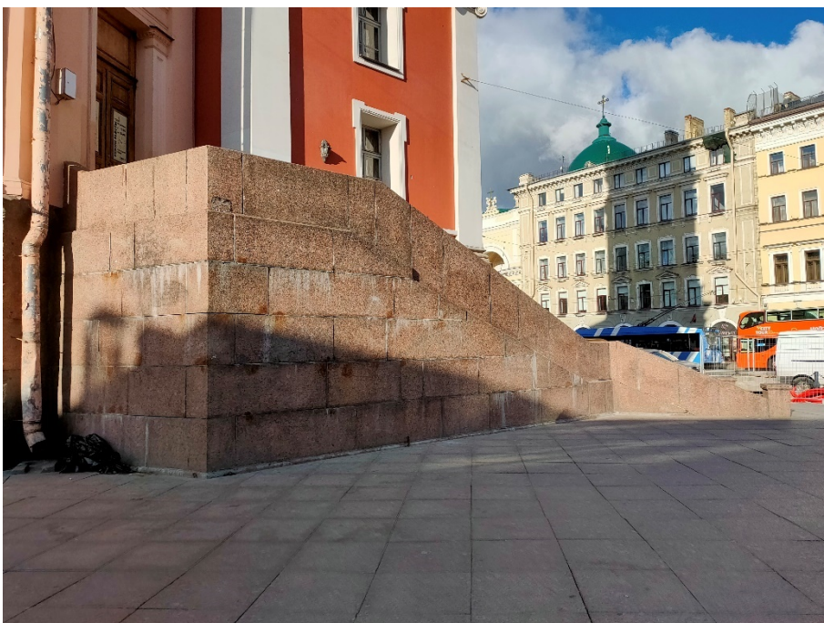
19. «Дума городская с башней (1752-1753 г.г., 1799-1804 г.г., арх. Феррари Д. 1848-1852 г.г., арх. Ефимов Н.Е., 1913-1914 г.г., арх. Кенель А.В.)», ул. Думская, д 1-3, Невский просп. лит. А. Восточный фасад. Фрагмент. Фото 17.10.2023г.
