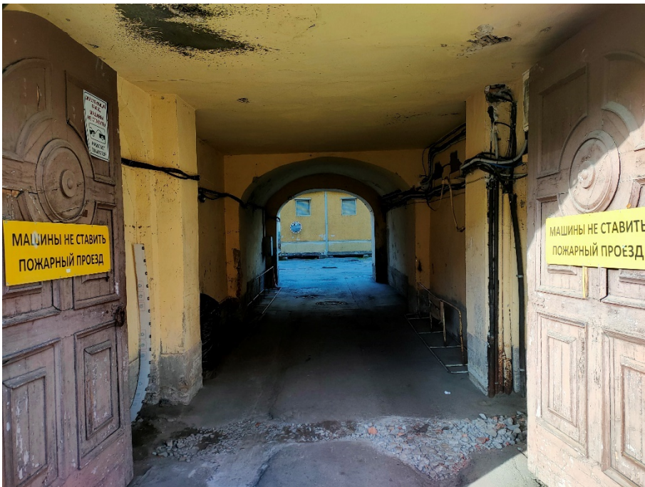
12. «Дума городская с башней (1752-1753 г.г., 1799-1804 г.г., арх. Феррари Д. 1848-1852 г.г., арх. Ефимов Н.Е., 1913-1914 г.г., арх. Кенель А.В.)», ул. Думская, д 1-3, Невский просп. лит. А. Восточный фасад. Проезд во двор. Общий вид. Фото 17.10.2023г.
