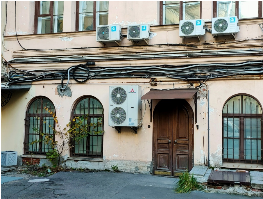
45. «Дума городская с башней (1752-1753 г.г., 1799-1804 г.г., арх. Феррари Д. 1848-1852 г.г., арх. Ефимов Н.Е., 1913-1914 г.г., арх. Кенель А.В.)», ул. Думская, д 1-3, Невский просп. лит. А. Дворовый фасад. Фрагмент. Фото 17.10.2023г.
