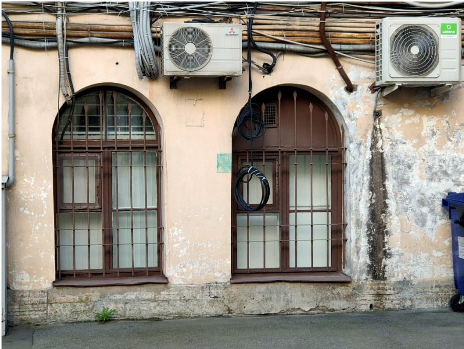
40. «Дума городская с башней (1752-1753 г.г., 1799-1804 г.г., арх. Феррари Д. 1848-1852 г.г., арх. Ефимов Н.Е., 1913-1914 г.г., арх. Кенель А.В.)», ул. Думская, д 1-3, Невский просп. лит. А. Дворовый фасад. Фрагмент. Фото 17.10.2023г.
