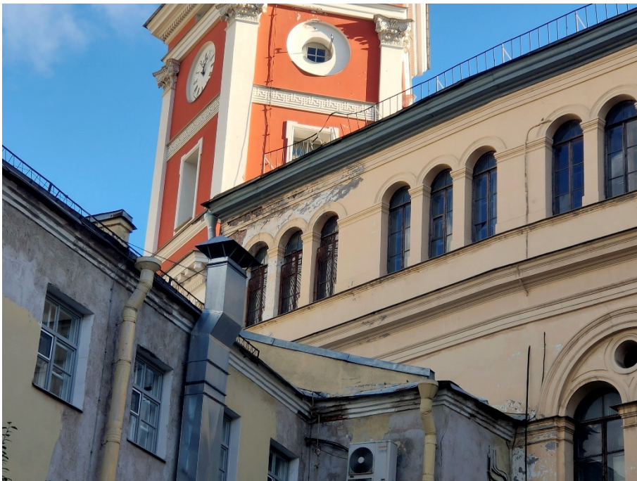
46. «Дума городская с башней (1752-1753 г.г., 1799-1804 г.г., арх. Феррари Д. 1848-1852 г.г., арх. Ефимов Н.Е., 1913-1914 г.г., арх. Кенель А.В.)», ул. Думская, д 1-3, Невский просп. лит. А. Дворовый фасад. Фрагмент. Фото 17.10.2023г.
