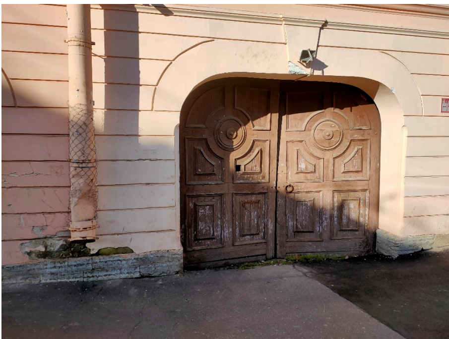
8. «Дума городская с башней (1752-1753 г.г., 1799-1804 г.г., арх. Феррари Д. 1848-1852 г.г., арх. Ефимов Н.Е., 1913-1914 г.г., арх. Кенель А.В.)», ул. Думская, д 1-3, Невский просп. лит. А. Восточный фасад. Входная группа. Общий вид. Фото 17.10.2023г.
