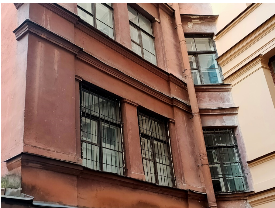
50. «Дума городская с башней (1752-1753 г.г., 1799-1804 г.г., арх. Феррари Д. 1848-1852 г.г., арх. Ефимов Н.Е., 1913-1914 г.г., арх. Кенель А.В.)», ул. Думская, д 1-3, Невский просп. лит. А. Дворовый фасад. Фрагмент. Фото 17.10.2023г.
