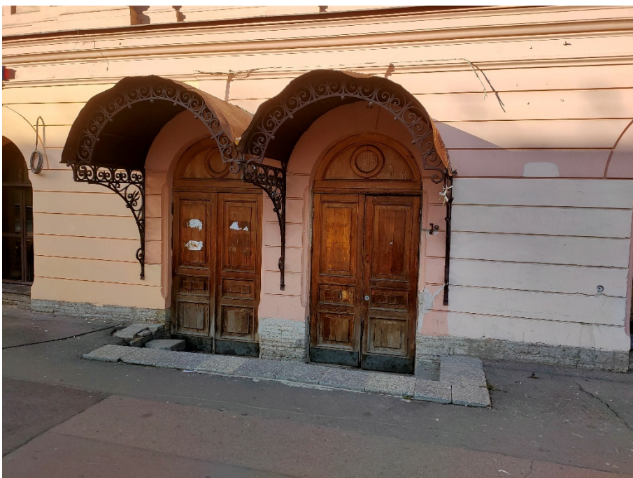
7. «Дума городская с башней (1752-1753 г.г., 1799-1804 г.г., арх. Феррари Д. 1848-1852 г.г., арх. Ефимов Н.Е., 1913-1914 г.г., арх. Кенель А.В.)», ул. Думская, д 1-3, Невский просп. лит. А. Восточный фасад. Входная группа. Общий вид. Фото 17.10.2023г.
