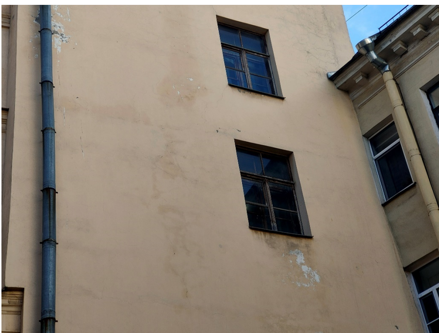
32. «Дума городская с башней (1752-1753 г.г., 1799-1804 г.г., арх. Феррари Д. 1848-1852 г.г., арх. Ефимов Н.Е., 1913-1914 г.г., арх. Кенель А.В.)», ул. Думская, д 1-3, Невский просп. лит. А. Дворовый фасад. Фрагмент. Фото 17.10.2023г.
