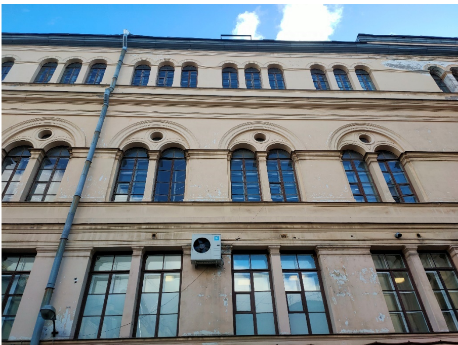
43. «Дума городская с башней (1752-1753 г.г., 1799-1804 г.г., арх. Феррари Д. 1848-1852 г.г., арх. Ефимов Н.Е., 1913-1914 г.г., арх. Кенель А.В.)», ул. Думская, д 1-3, Невский просп. лит. А. Дворовый фасад. Фрагмент. Фото 17.10.2023г.
