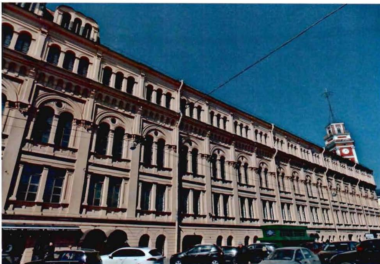
2. Вид на восточный фасад объекта культурного наследия.
