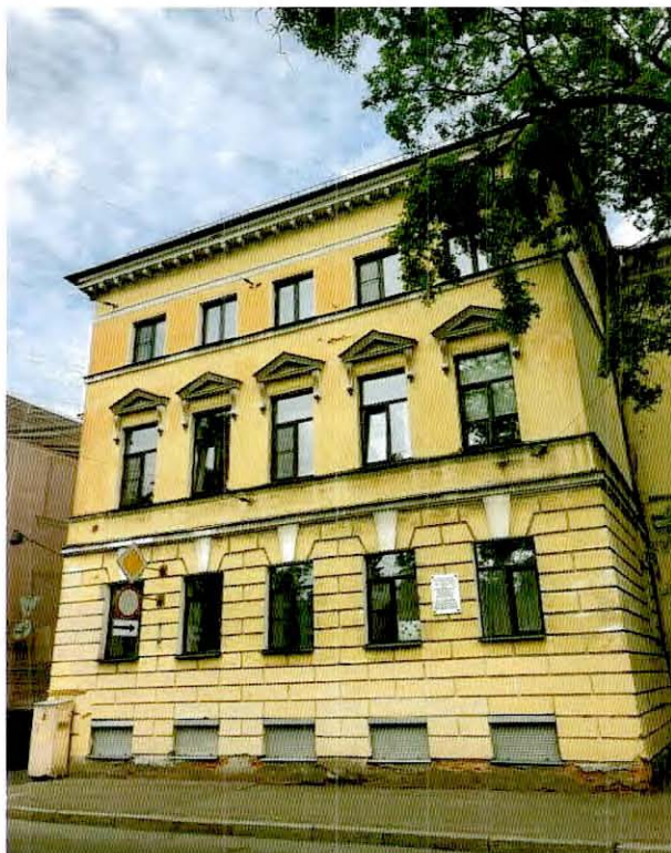
24. Южный лицевой фасад объекта культурного наследия.
