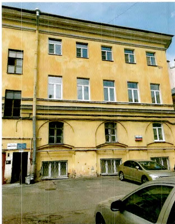
29. Фрагмент южного дворового фасада объекта культурного наследия.
