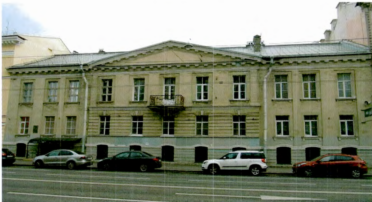
19. Восточный фасад объекта культурного наследия.
