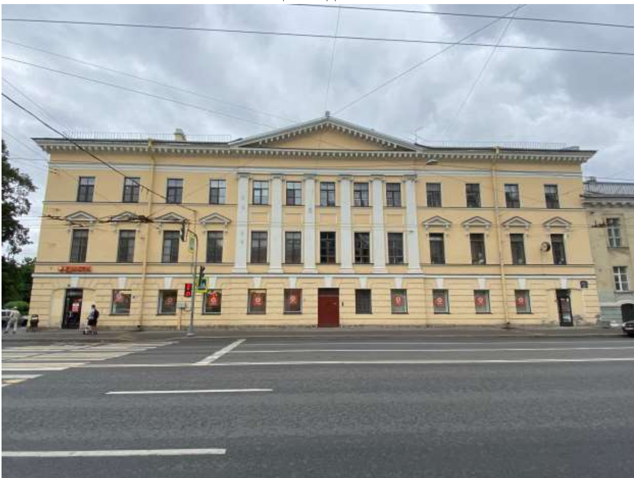
Фото 2. Лицевой северо-восточный фасад. Вид с востока.
