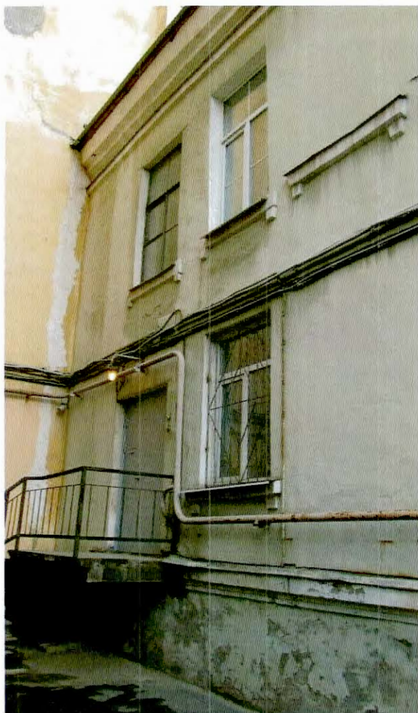
21. Фрагмент западного фасада объекта культурного наследия.
