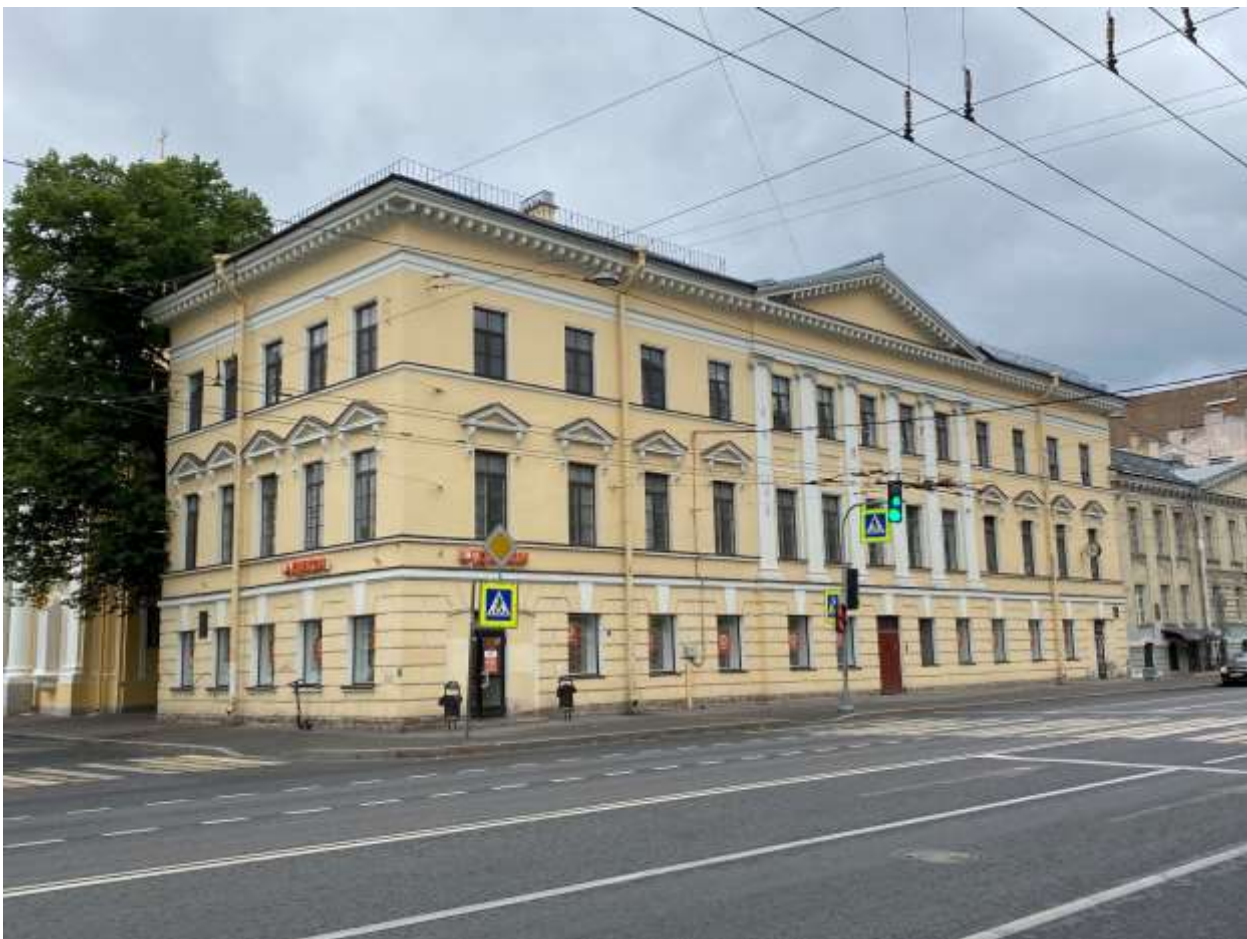
Фото 1. Общий вид с юго-востока.
