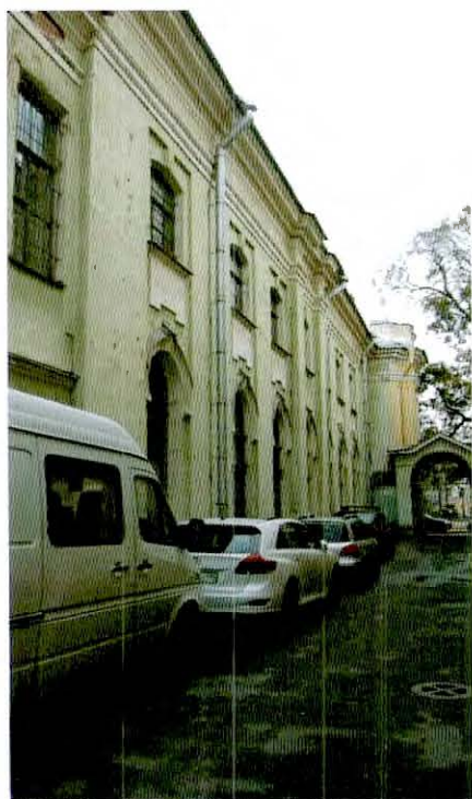
4. Фрагмент западного фасада объекта культурного наследия.
