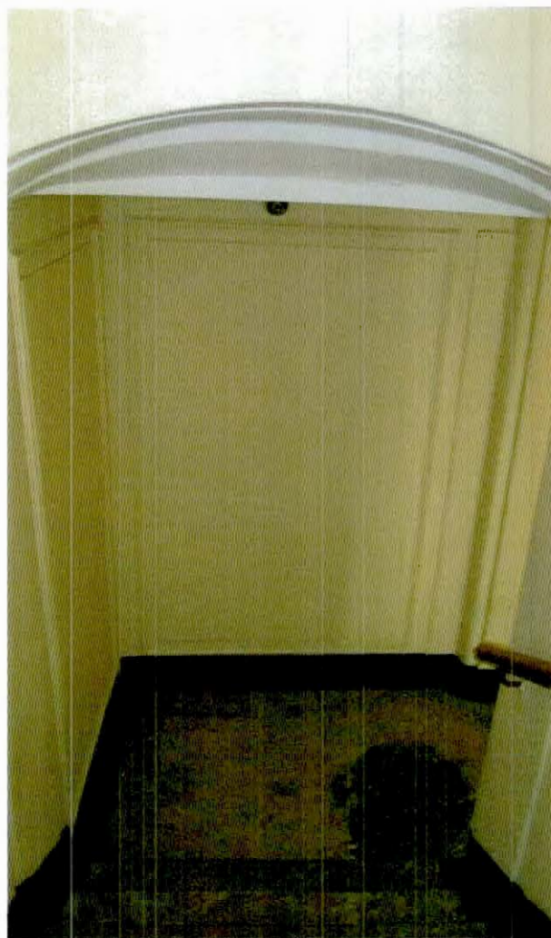
22. Внутренняя планировочная структура объекта культурного наследия. Лестничная клетка южной парадной.
