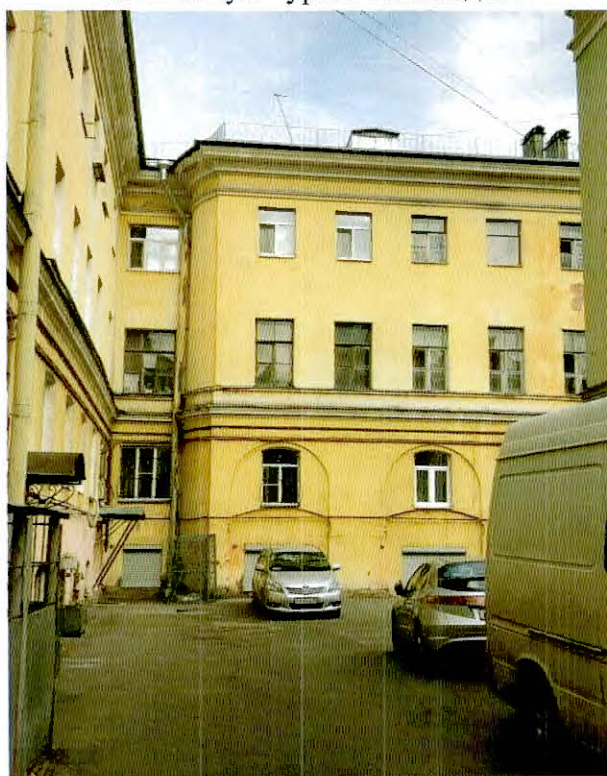
30. Фрагмент южного дворового фасада объекта культурного наследия.
