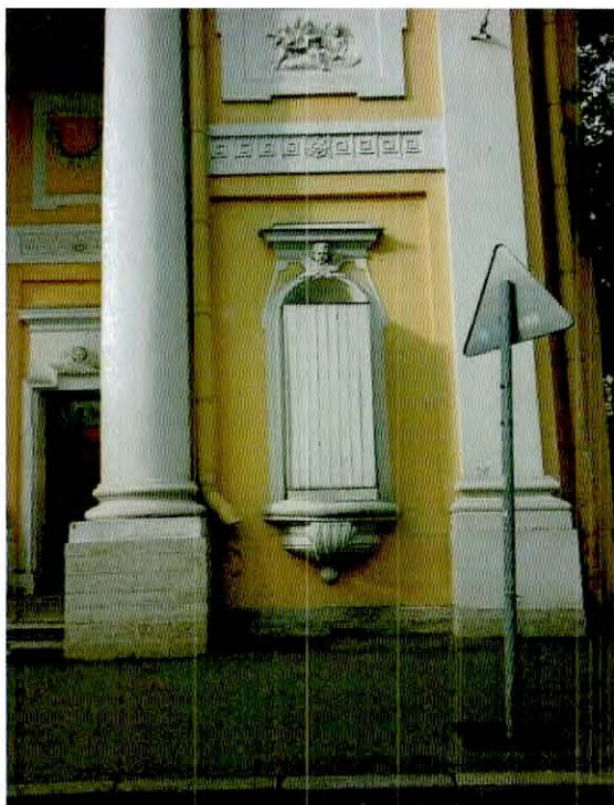
2. Фрагмент южного фасада объекта культурного наследия.
