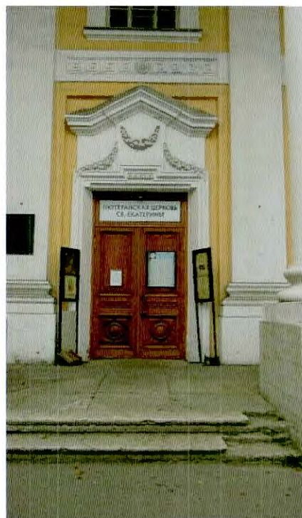
3. Фрагмент южного фасада объекта культурного наследия.
