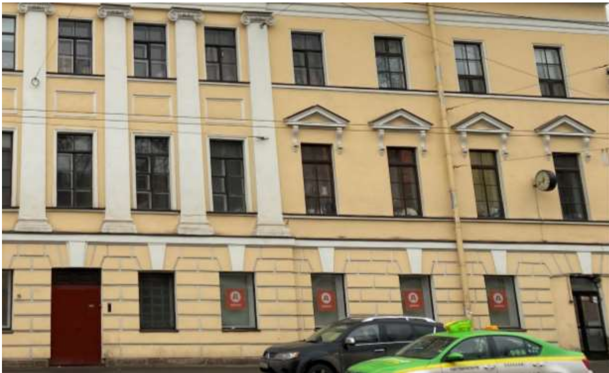
Фото 3. Лицевой северо-восточный фасад. Место предполагаемой установки мемориальной доски – в уровне 1-го этажа между оконными проемами по 1-й и 2-й световым осям от раскреповки. Вид с востока.
