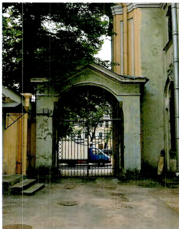
12. Восточные часть объекта культурго наследия. Северный фасад.
