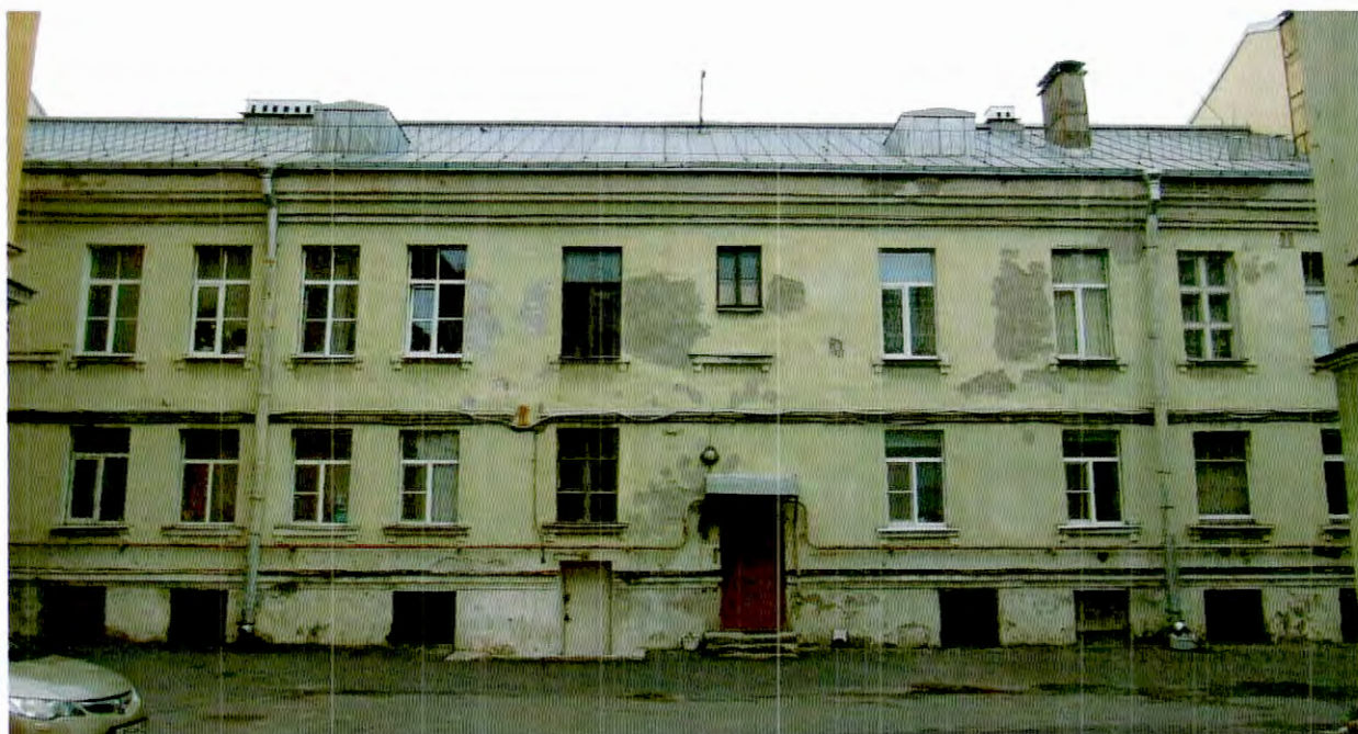
20. Фрагмент западного фасада объекта культурного наследия.
