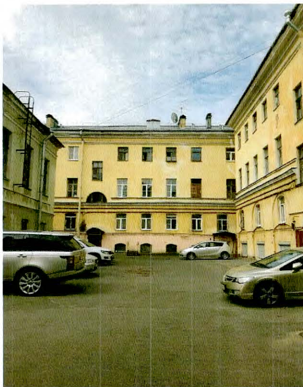
28. Фрагмент восточного дворового фасада объекта культурного наследия.
