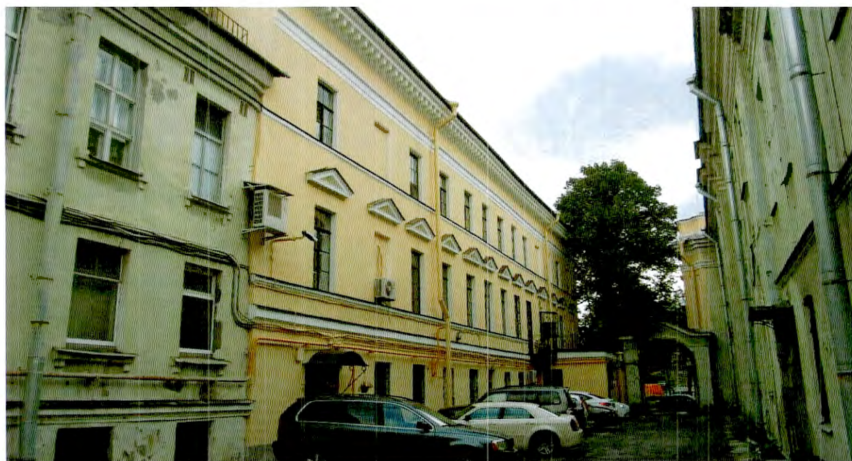
16. Западный фасад объекта культурного наследия.
