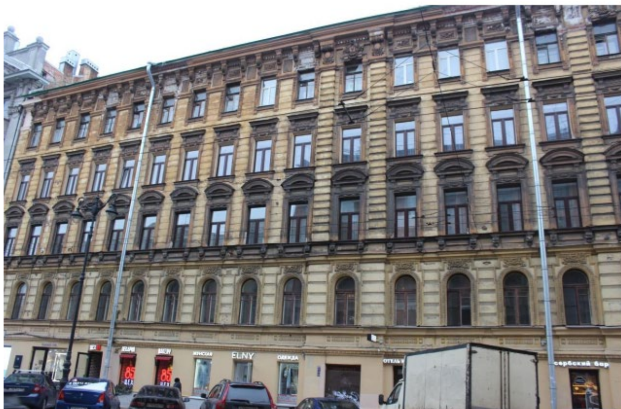
1. Юго-восточный лицевой фасад объекта культурного наследия федерального значения «Дом, где в 1887-1891 гг. жил композитор Рубинштейн А.Г. Здесь в 1905-1906 гг. проходили заседания ЦК РСДРП», расположенного по адресу: г. Санкт-Петербург, Загородный пр., д. 9, литера А. 15.09.2022
