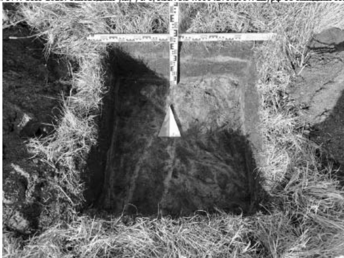
Рис. 178. СПб-2023. Заповедная ул., уч. 6, КН:78:34:0004270:8507. Шурф 18, фиксация по уровню материковой поверхности, вид на север.
