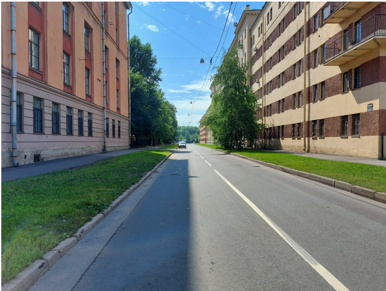
Точка фотофиксации 13. Северная часть участка обследования. Вид с С.
