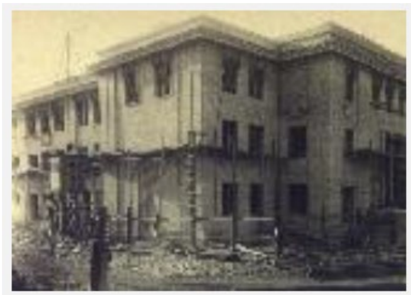
Илл. 32. Строительство новой школы №28 Ленинского района на Бумажной улице. 1935 г. //ЦГАКФФД СПб Гр.43908.
