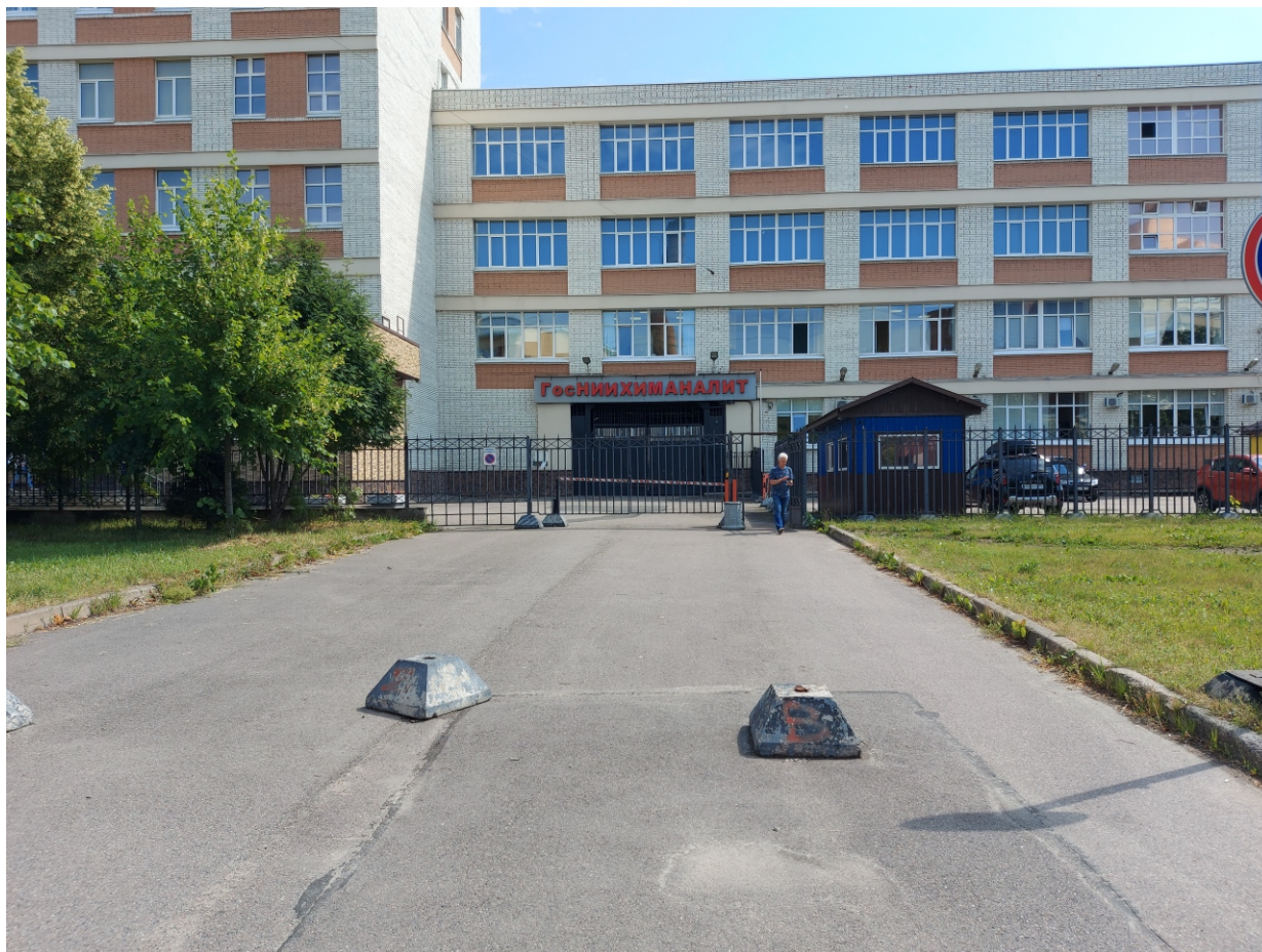
Точка фотофиксации 11. Северная часть участка обследования, проезд к д. 17 по Бумажной ул. Вид с З.
