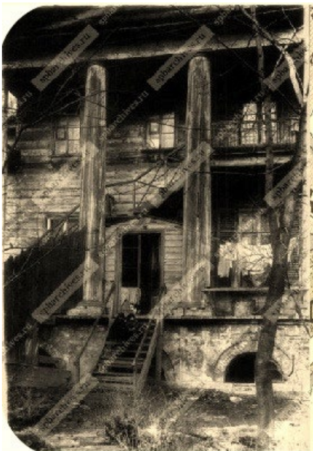
Илл. 28. Март 1927 г. Вид части фасада с колоннами жилого дома №12 на Бумажной улице - бывшей дачи купца Матвея Сутугина (построена в 1815 г.). ЦГАКФФД СПб Гр. 66020.
