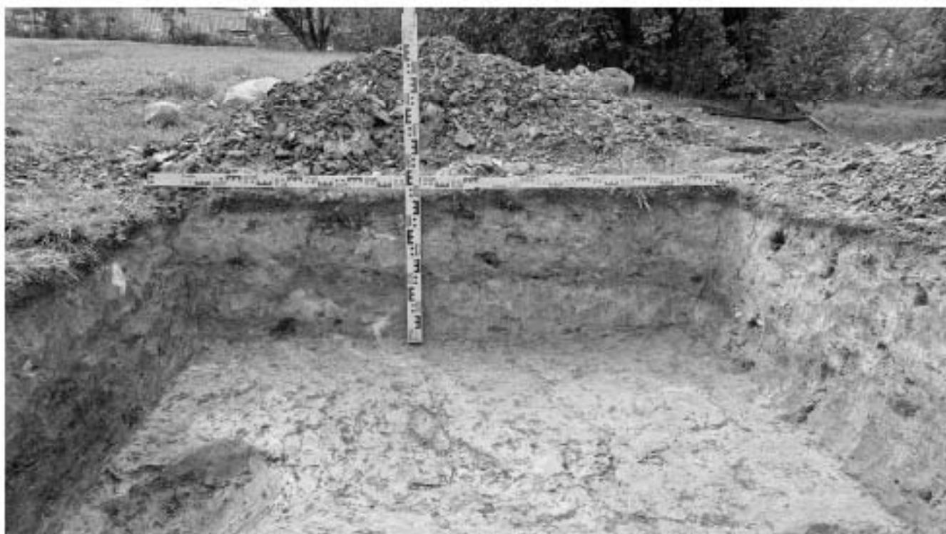
Рис.39. СПб., муниципальный округ №75, улица Олеко Дундича, участок 151 (кадастровый номер: 78:13:0007443:7347). Шурф 1. Фиксация южной стенки.
