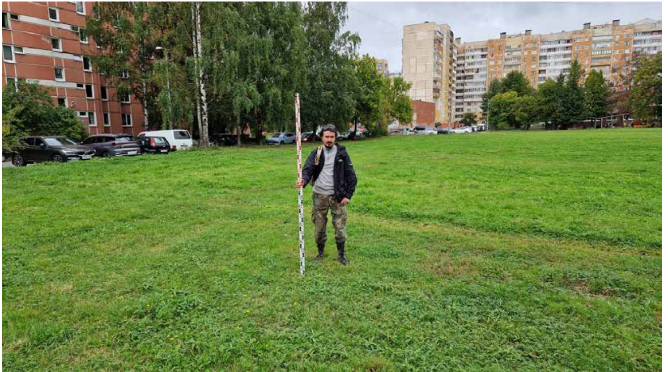
Рис. 25. Санкт-Петербург, Красносельский район, проспект Кузнецова, земельный участок 78 (кадастровый номер: 78:40:0008313:9526). Шурф 1. Общий вид до начала работ. Вид на север.
