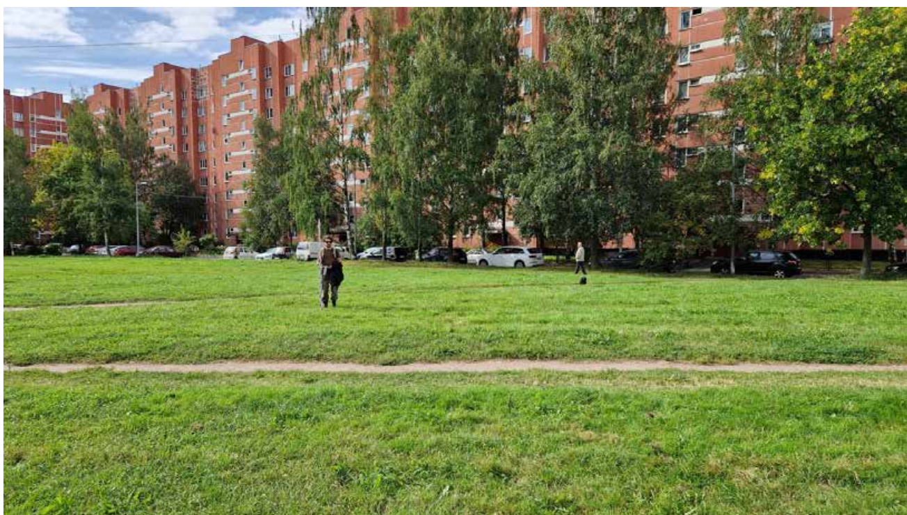
Рис. 24. Санкт-Петербург, Красносельский район, проспект Кузнецова, земельный участок 78 (кадастровый номер: 78:40:0008313:9526). Точка съёмки №3. Вид на запад.
