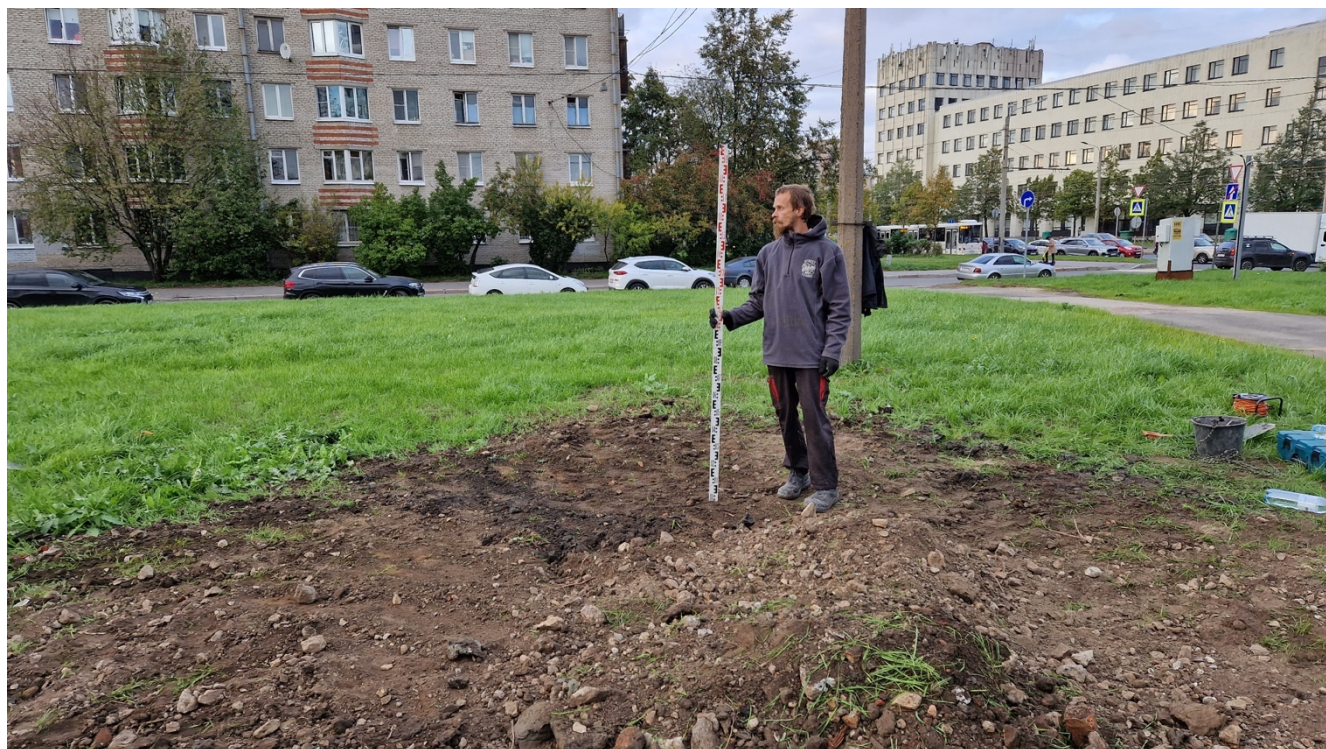
Рис.38. СПб., Фрунзенский район, Козловский переулок. Шурф 1. Фиксация общего вида шурфа после рекультивации. Вид на север.
