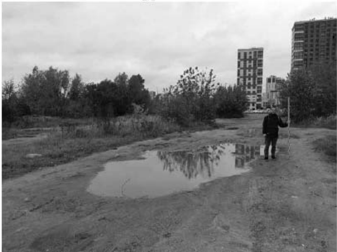
Рис. 117. Санкт-Петербург, «Строительство Красносельско-Калининской линии от станции «Кзаковская» до станции «Обводный канал-2» с электродепо «Красносельское». Участок обследования «Строительная площадка вестибюля №1 станции «Черниговская». Общие виды.
