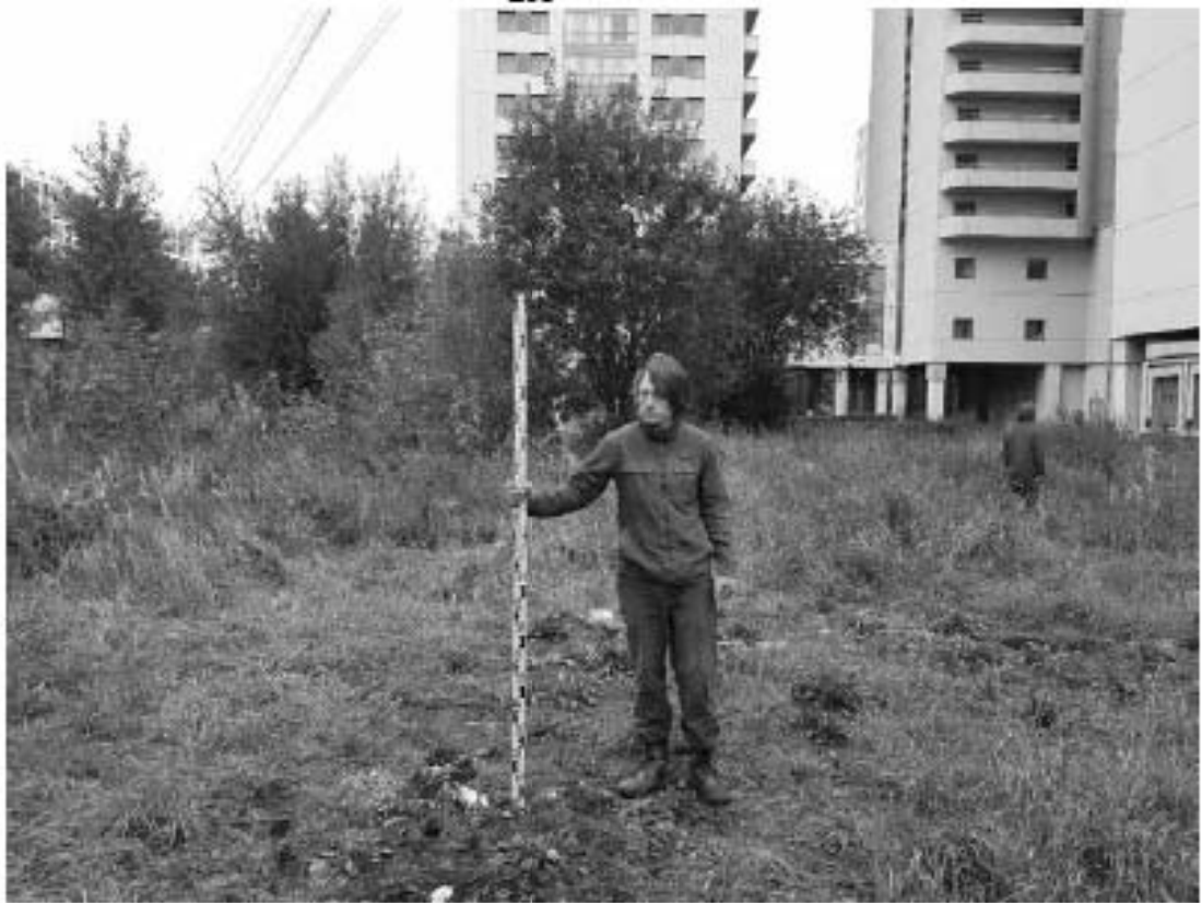
Рис. 141 Санкт-Петербург, «Строительство Красносельско-Калининской линии от станции «Казаковская» до станции «Обводный канал-2» с электродепо «Красносельское». Участок обследования «Строительная площадка шахты 848. Рабочий ствол». Общие виды.
