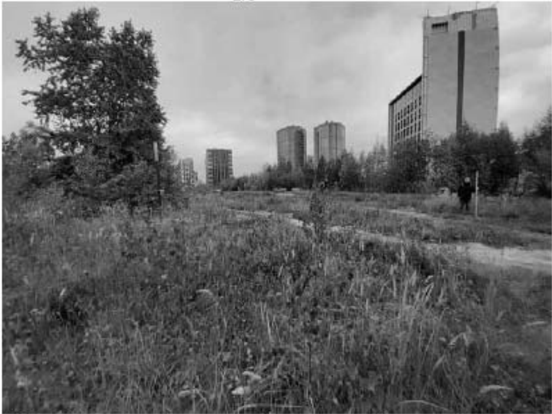
Рис. 113 Санкт-Петербург, «Строительство Красносельско-Калининской линии от станции «Казакская» до станции «Обводный канал-2» с электродепо «Красносельское». Участок обследования «Строительная площадка вестибюля №1 станции «Черниговская». Общие виды.
