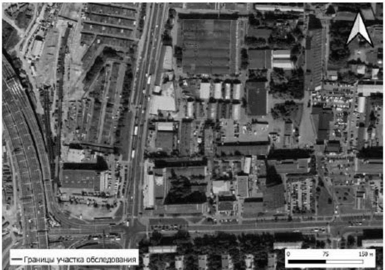
Рис. 27 Санкт-Петербург, «Строительство Красносельско-Калининской линии от станции «Казаковская» до станции «Обводный канал-2» с электродепо «Красносельское». Участок обследования «Строительная площадка шахты №846. Рабочий ствол, Строительная площадка вестибюля №1 станции «Броневая»» на спутниковом снимке (слева)
