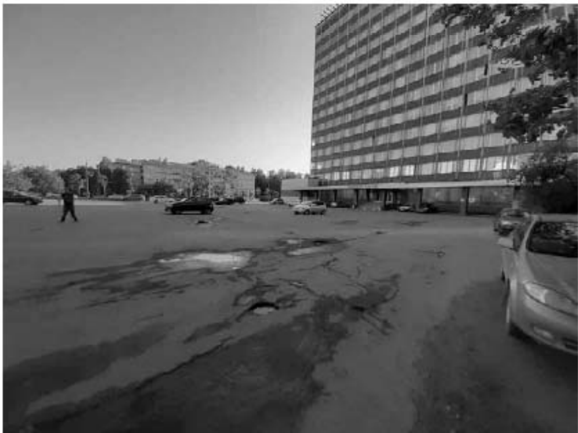
Рис. 70. Санкт-Петербург, «Строительство Красносельско-Калининской линии от станции «Казаковская» до станции «Обводный канал-2» с электродепо «Красносельское». Участок обследования «Строительная площадка вестибюля станции «Броневая». Общие виды.
