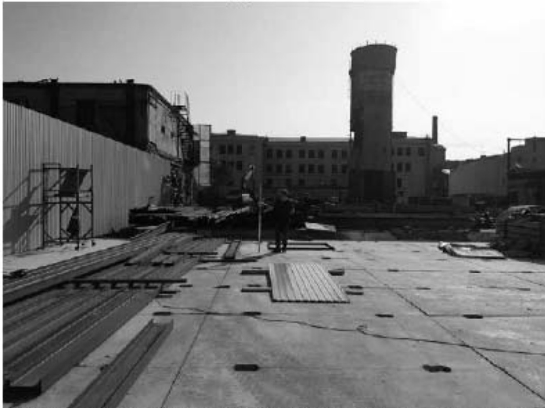
Рис. 283 Санкт-Петербург. «Строительство Красносельско-Калининской линии от станции «Казаковская» до станции «Обводный канал-2» с электродепо «Красносельское». Участок от станции «Путиловская» до станции «Каретная». Участок обследования «Строительная площадка шахты 852 по адресу: Фрунзенский район, западнее здания по адресу ул. Тамбовская, дом 17, литер Б». Общие виды.
