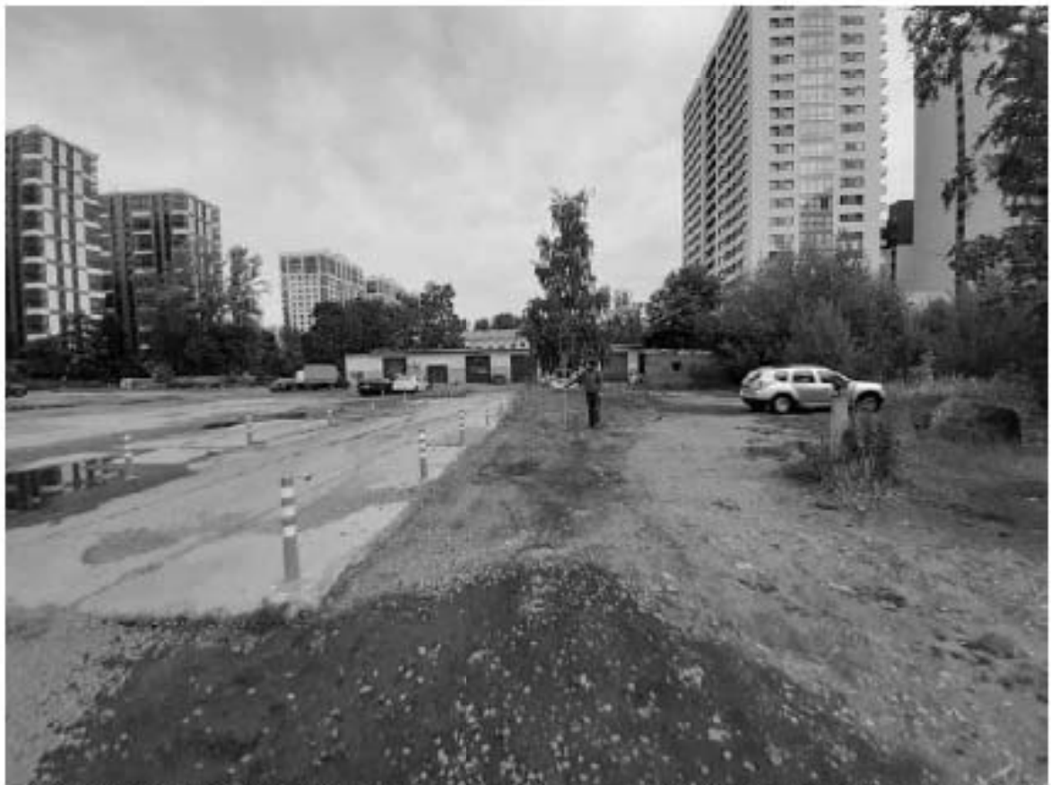
Рис. 148. Санкт-Петербург, «Строительство Красносельско-Калининской линии от станции «Казаковская» до станции «Обводный канал-2» с электродепо «Красносельское». Участок обследования «Строительная площадка шахты 848. Рабочий ствол». Общие виды.
