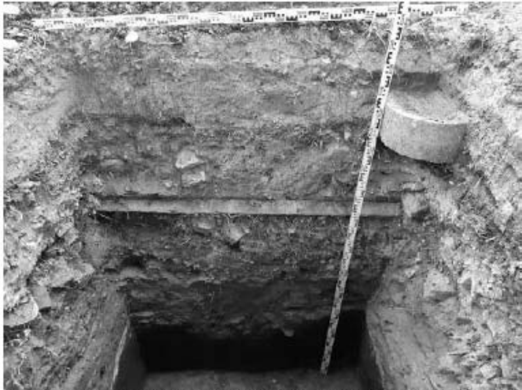
Рис. 271 Санкт-Петербург. «Строительство Красносельско-Калининской линии от станции «Казаконская» до станции «Обводный канал-2» с электродепо «Красносельское». Участок от станции «Путиловская» до станции «Каретная». Участок обследования «Строительная площадка вестибюля № 1 станции «Каретная». Шурф 1. Фотофиксация стратиграфии северо-западной стенки.
