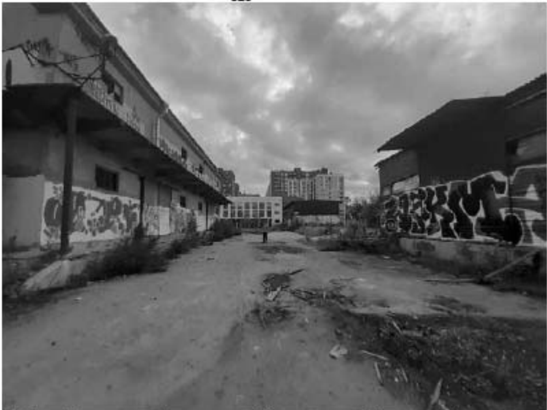
Рис. 198 Санкт-Петербург, «Строительство Красносельско-Калининской линии от станции «Казаковская» до станции «Обводный канал-2» с электродепо «Красносельское». Участок обследования «Строительная площадка вестибюля № 2 станции «Боровая». Строительная площадка шахты № 850 по адресу: Фрунзенский район, Лиговский проспект, дом 26, литера И». Общие виды.
