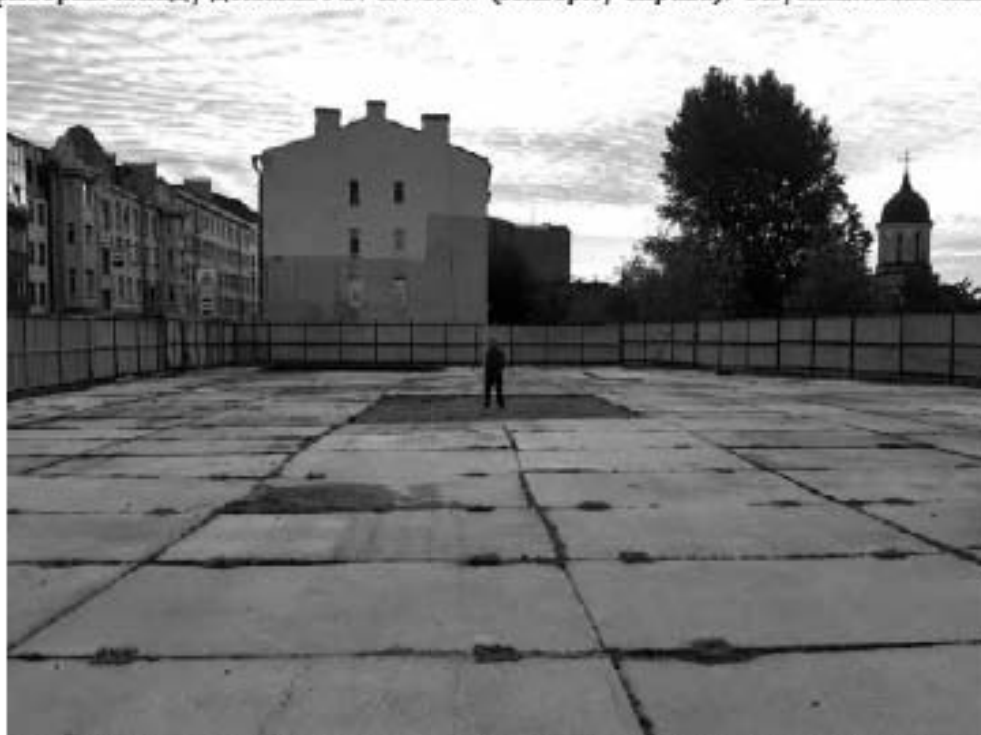
Рис. 220 Санкт-Петербург. «Строительство Красносельско-Калининской линии от станции «Казаконская» до станции «Обводный канал-2» с электродепо «Красносельское». Участок от станции «Путиловская» до станции «Жаретная». Участок обследования «Строительная площадка шахты № 851 по адресу: Фрунзенский район, Расстанная улица на свободной территории между домами №7 и №13». Общие виды
