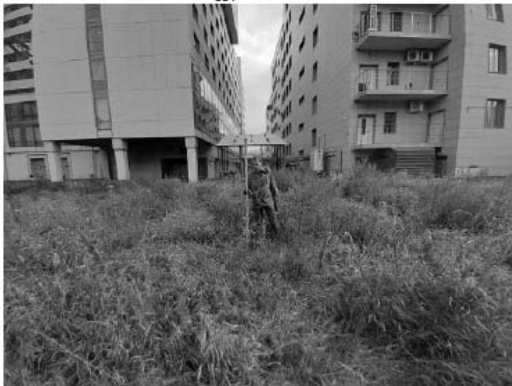
Рис. 152 Санкт-Петербург, «Строительство Красносельско-Калининской линии от станции «Казаковская» до станции «Обводный канал-2» с электродепо «Красносельское». Участок обследования «Строительная площадка шахты 848. Рабочий ствол» Шурф 1. Фотофиксация до начала работ. Вид на восток.
