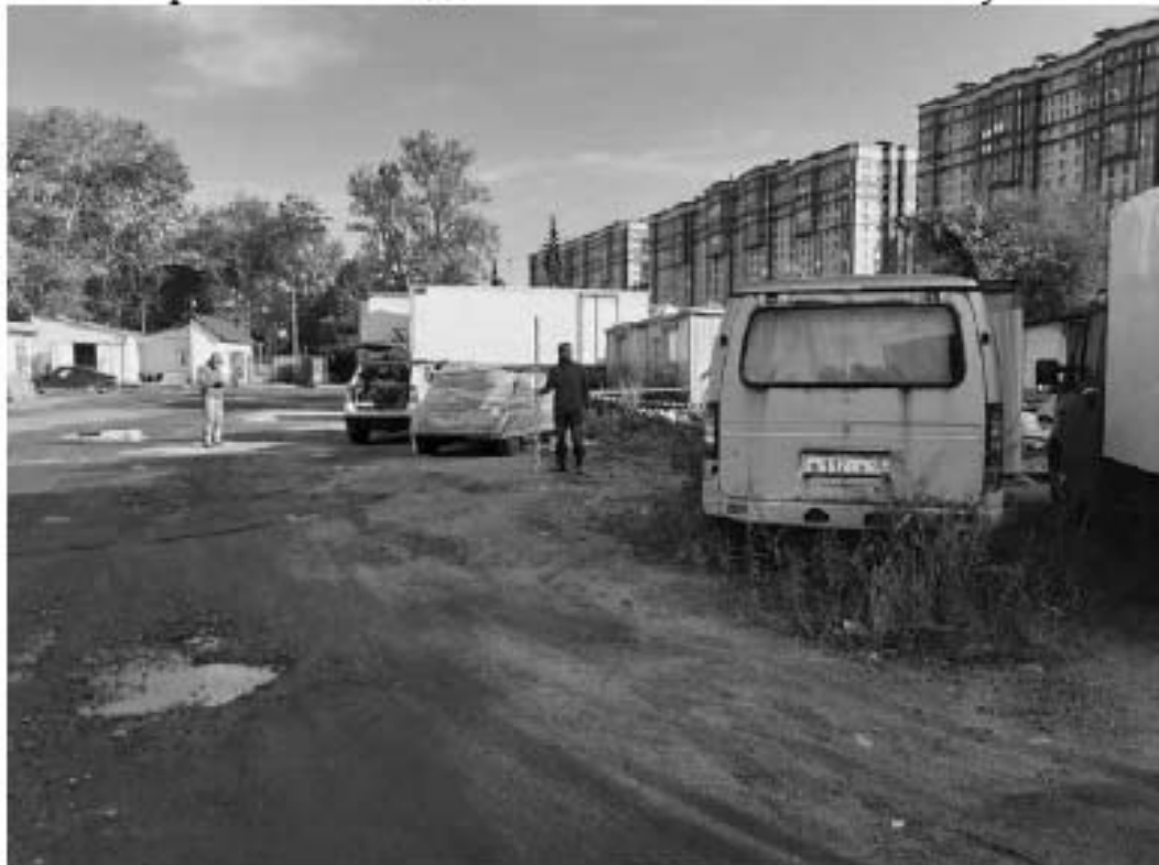
Рис. 89 Санкт-Петербург, «Строительство Красносельско-Калининской линии от станции «Казаковская» до станции «Обводный канал-2» с электродепо «Красносельское». Участок обследования «Строительная площадка шахты 847. Рабочий ствол». Общие виды.
