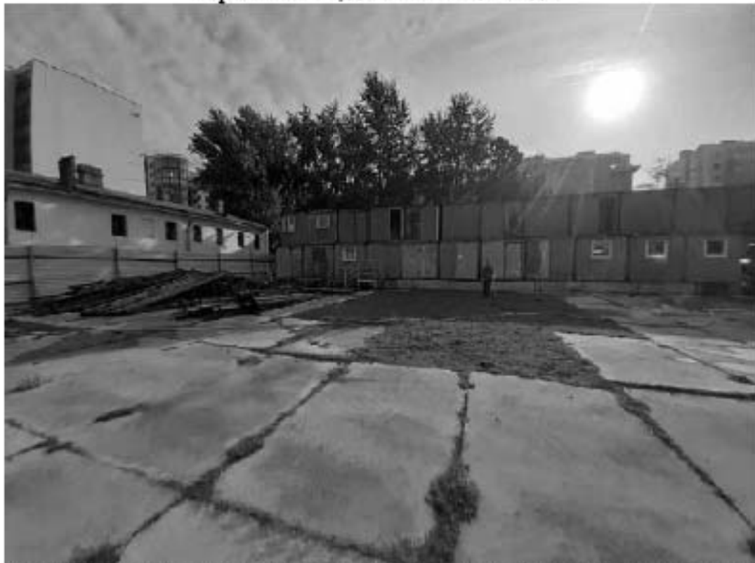
Рис. 304 Санкт-Петербург. «Строительство Красносельско-Калининской линии от станции «Казаковская» до станции «Обводный канал-2» с электродепо «Красносельское». Участок от станции «Путиловская» до станции «Каретная». Участок обследования «Строительная площадка шахты №853 по адресу: Центральный район, южнее здания по адресу ул. Черняховского, дом 19». Общие виды.
