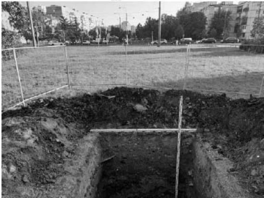
Рис. 86. Санкт-Петербург, «Строительство Красносельско-Калининской линии от станции «Казаковская» до станции «Обводный канал-2» с электродепо «Красносельское». Участок обследования «Строительная площадка вестибюля станции «Броневая». Шурф 1. Фотофиксация после окончания работ. Общий вид на юг.
