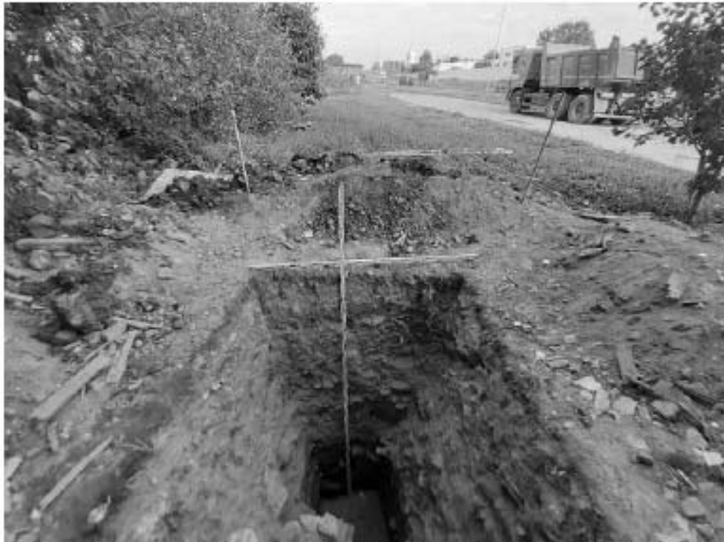
Рис. 63 Санкт-Петербург, «Строительство Красносельско-Калининской линии от станции «Казаковская» до станции «Обводный канал-2» с электродепо «Красносельское». Участок обследования «Строительная площадка шахты №846. Рабочий ствол; Строительная площадка вестибюля №1 станции «Броневая»». Шурф 1. Уровень остановки работ. Общий вид на север.
