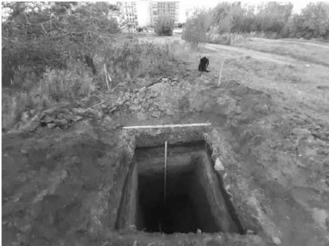
Рис. 137 Санкт-Петербург, «Строительство Красносельско-Калининской линии от станции «Казаковская» до станции «Обводный канал-2» с электродепо «Красносельское». Участок обследования «Строительная площадка вестибюля №1 станции «Черниговская». Шурф 1. Фотофиксация после окончания работ. Общий вид на север.
