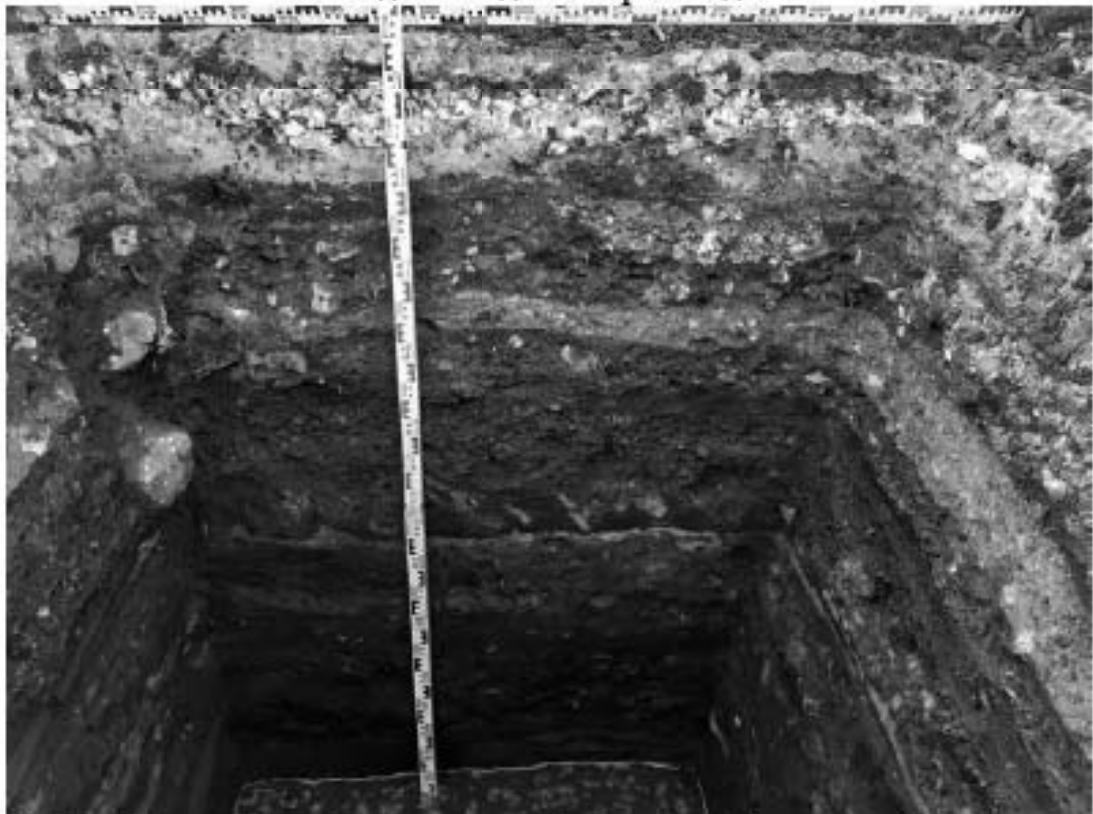
Рис. 211. Санкт-Петербург, «Строительство Красносельско-Калининской линии от станции «Казаковская» до станции «Обводный канал-2» с электродепо «Красносельское». Участок обследования «Строительная площадка вестибюля № 2 станции «Боровая». Строительная площадка шахты № 850 по адресу: Фрунзенский район, Лиговский проспект, дом 26, литера И». Шурф 1. Фотофиксация стратиграфии северо-западной стенки.
