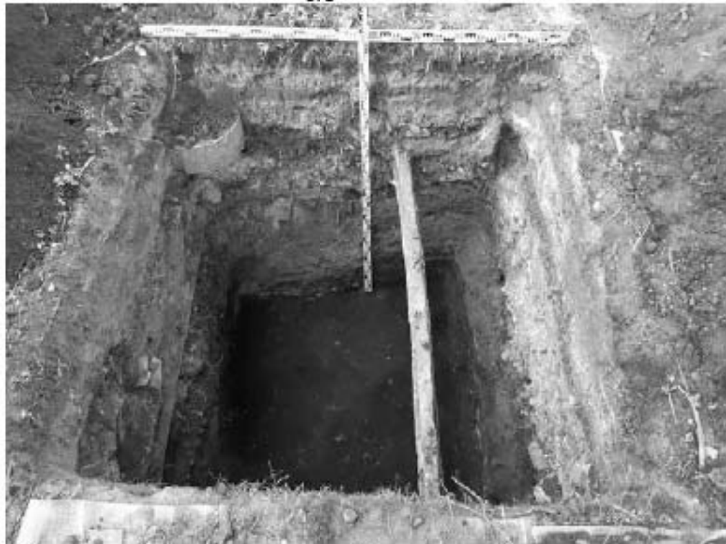
Рис. 259. Санкт-Петербург. «Строительство Красносельско-Калининской линии от станции «Казаконская» до станции «Обводный канал-2» с электродепо «Красносельское». Участок от станции «Путиловская» до станции «Каретная». Участок обследования «Строительная площадка вестибюля № 1 станции «Каретная». Шурф 1. Фотофиксация по слою темно-коричневой гумусированной супеси. Вид на северо-восток.
