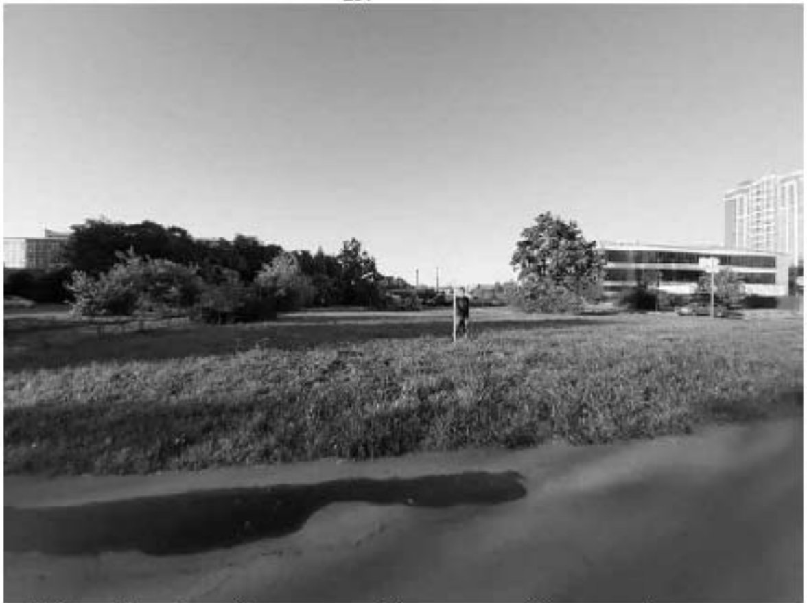
Рис. 73 Санкт-Петербург, «Строительство Красносельско-Калининской линии от станции «Казакская» до станции «Обводный канал-2» с электродепо «Красносельское». Участок обследования «Строительная площадка вестибюля станции «Броневая». Общие виды.
