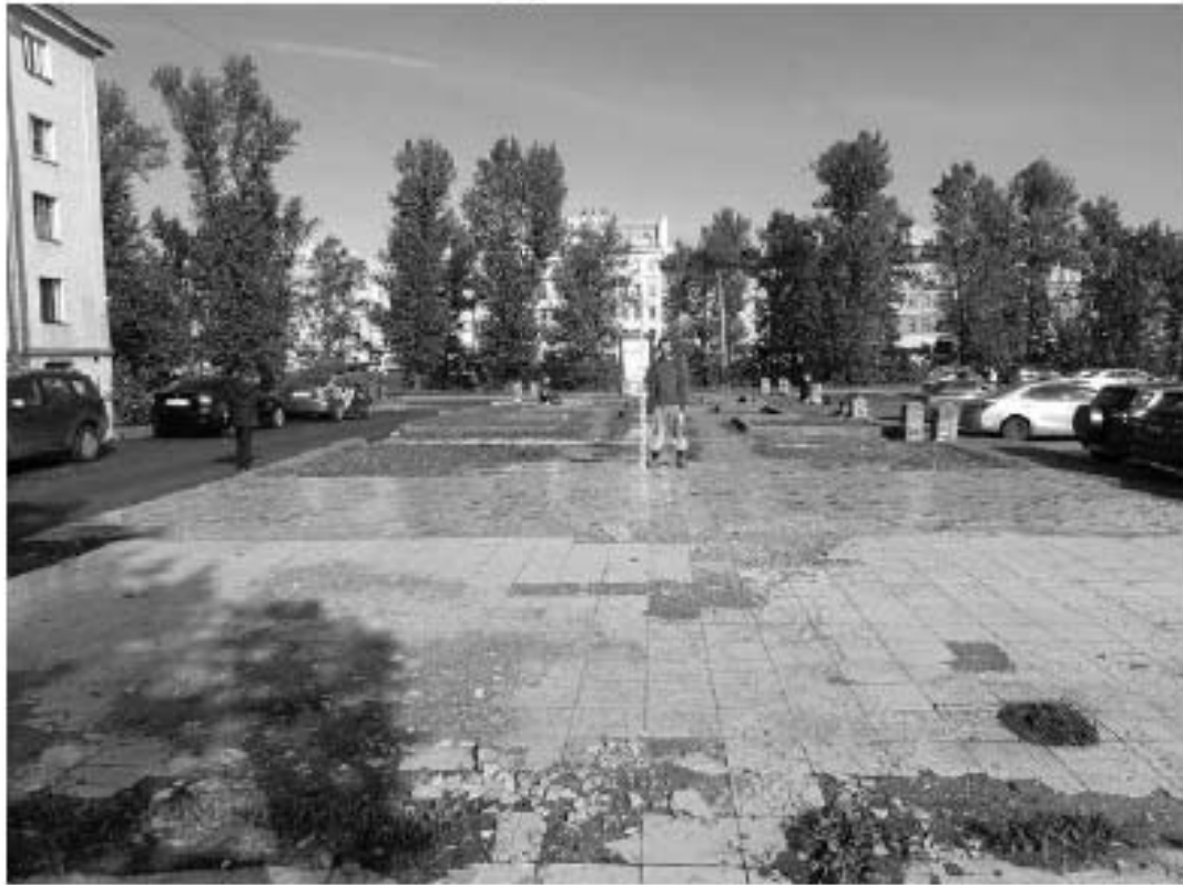
Рис. 246 Санкт-Петербург. «Строительство Красносельско-Калининской линии от станции «Казаковская» до станции «Обводный канал-2» с электродепо «Красносельское». Участок от станции «Путиловская» до станции «Каретная». Участок обследования «Строительная площадка вестибюля № 1 станции «Каретная». Общие виды.
