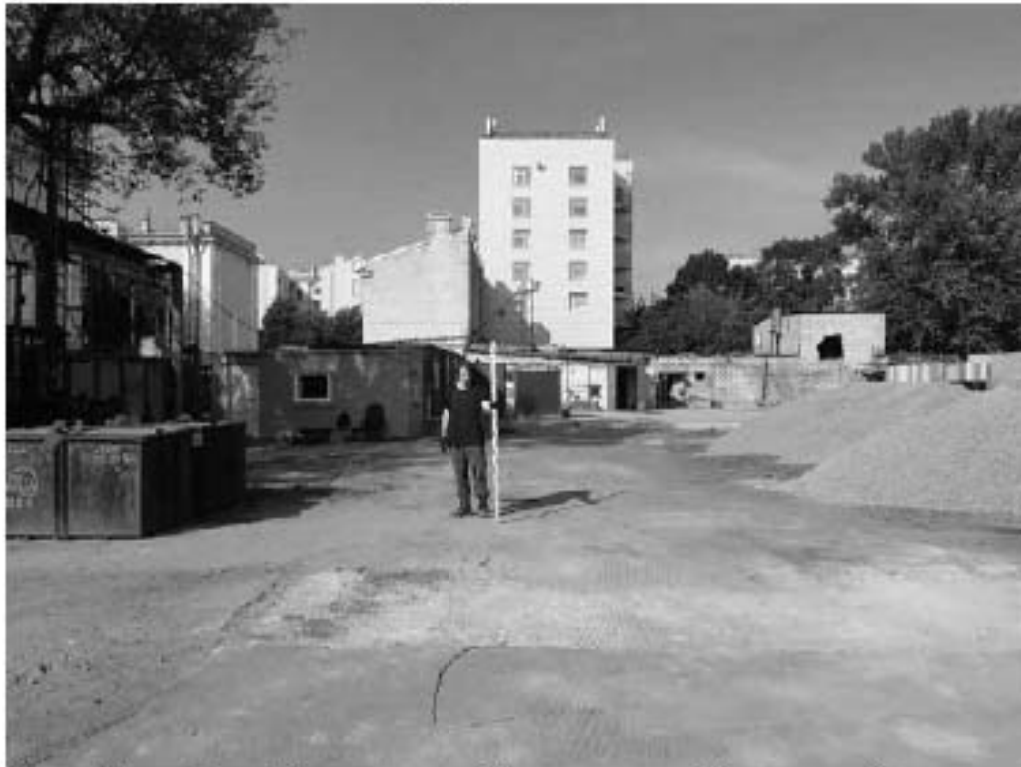
Рис. 285 Санкт-Петербург. «Строительство Красносельско-Калининской линии от станции «Казиковская» до станции «Обводный канал-2» с электродепо «Красносельское». Участок от станции «Путиловская» до станции «Каретная». Участок обследования «Строительная площадка шахты 852 по адресу: Фрунзенский район, западнее здания по адресу ул. Тамбовская, дом 17, литер Б». Общие виды.
