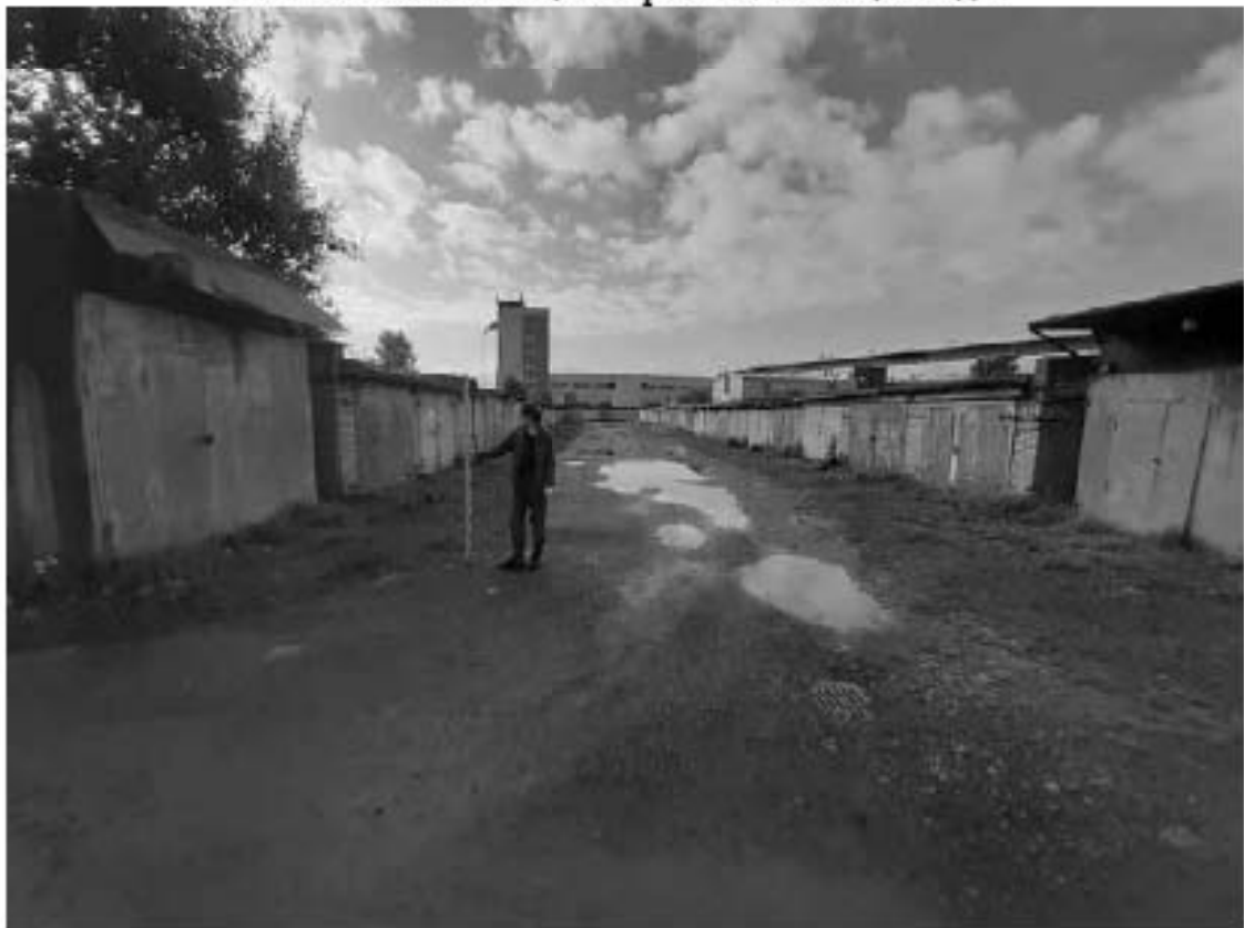
Рис. 39. Санкт-Петербург, «Строительство Красносельско-Калининской линии от станции «Казаковская» до станции «Обводный канал-2» с электродепо «Красносельское». Участок обследования «Строительная площадка шахты №846. Рабочий ствол; Строительная площадка вестибюля №1 станции «Броневая»» Общие виды.
