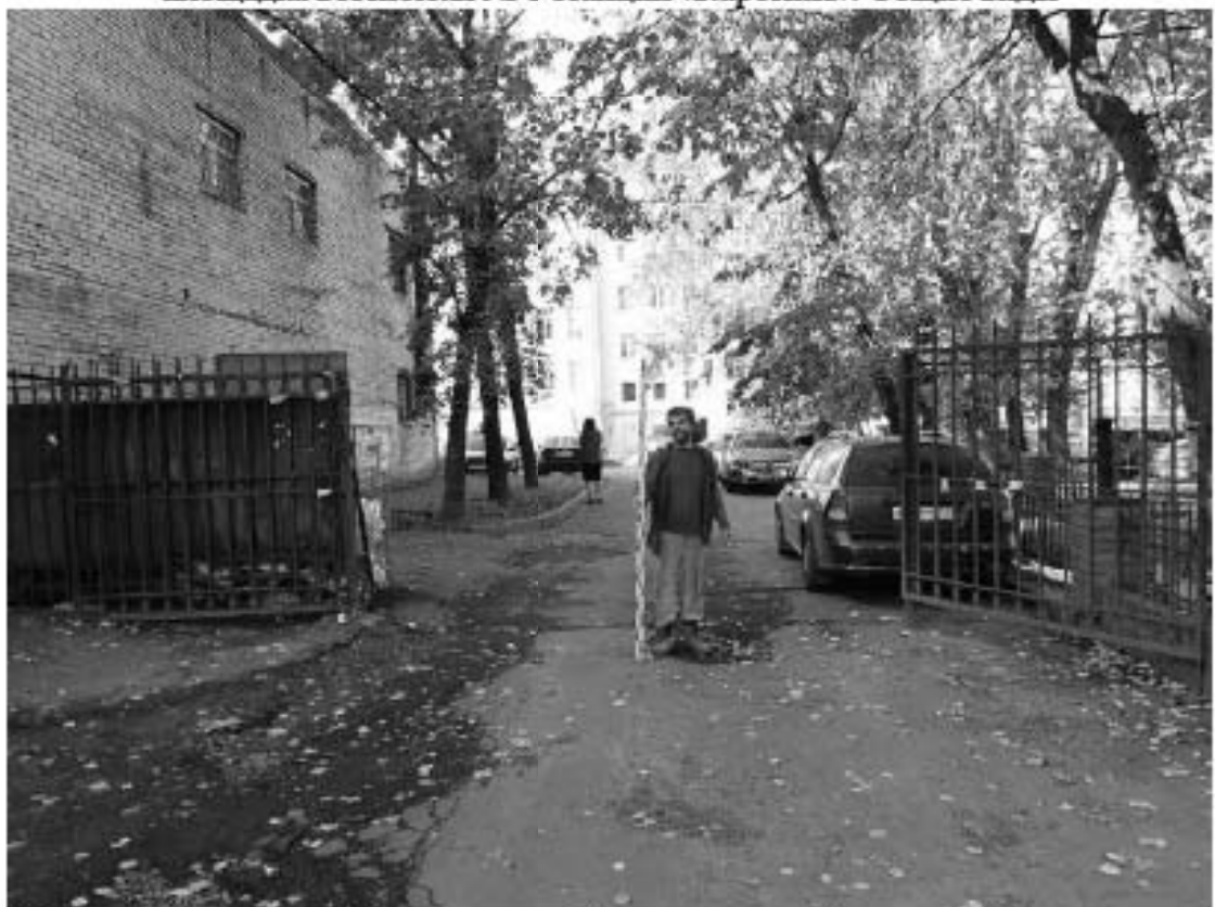
Рис. 241 Санкт-Петербург. «Строительство Красносельско-Калининской линии от станции «Казаковская» до станции «Обводный канал-2» с электродепо «Красносельское». Участок от станции «Путиловская» до станции «Каретная». Участок обследования «Строительная площадка вестибюля № 1 станции «Каретная». Общие виды
