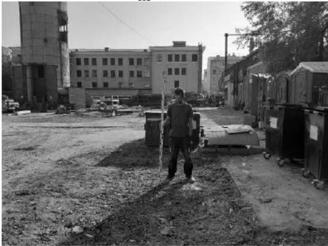
Рис. 291 Санкт-Петербург. «Строительство Красносельско-Калининской линии от станции «Казакская» до станции «Обводный канал-2» с электродепо «Красносельское». Участок от станции «Путиловская» до станции «Каретная». Участок обследования «Строительная площадка шахты 852 по адресу: Фрунзенский район, западнее здания по адресу ул. Тамбовская, дом 17, литер Б». Шурф 1. Фотофиксация до начала работ. Вид на юго-восток.
