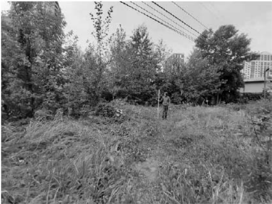
Рис. 146 Санкт-Петербург, «Строительство Красносельско-Калининской линии от станции «Казаковская» до станции «Обводный канал-2» с электродепо «Красносельское». Участок обследования «Строительная площадка шахты 848. Рабочий ствол». Общие виды.
