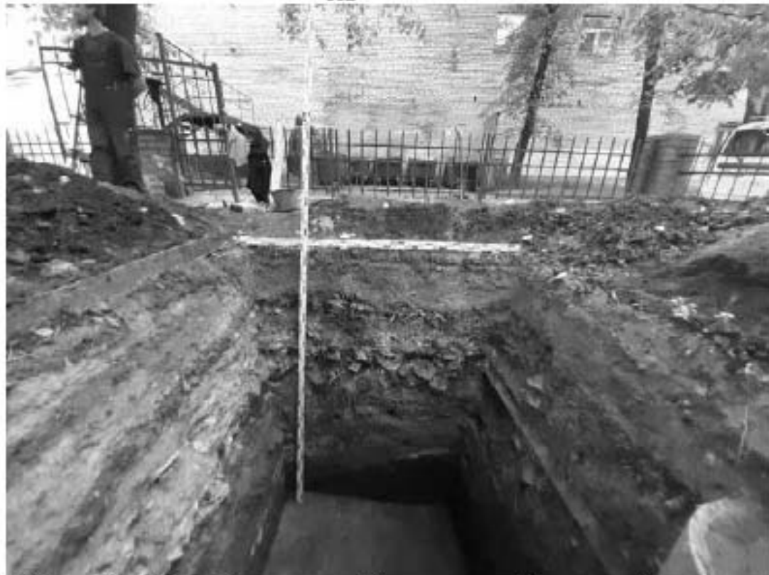
Рис. 277 Санкт-Петербург. «Строительство Красносельско-Калининской линии от станции «Казаковская» до станции «Обводный канал-2» с электродепо «Красносельское». Участок от станции «Путиловская» до станции «Каретная». Участок обследования «Строительная площадка вестибюля № 1 станции «Каретная». Шурф 1. Фотофиксация после окончания работ. Общий вид на юго-запад.
