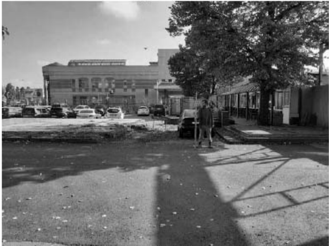
Рис. 242 Санкт-Петербург. «Строительство Красносельско-Калининской линии от станции «Казаковская» до станции «Обводный канал-2» с электродепо «Красносельское». Участок от станции «Путиловская» до станции «Каретная». Участок обследования «Строительная площадка вестибюля № 1 станции «Каретная». Общие виды
