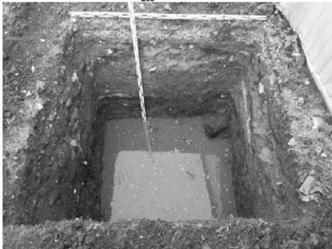
Рис. 99. Санкт-Петербург, «Строительство Красносельско-Калининской линии от станции «Казаковская» до станции «Обводный канал-2» с электродепо «Красносельское». Участок обследования «Строительная площадка шахты 847. Рабочий ствол». Шурф 1. Фотофиксация по светло-серому суглинку (материк), затопленному водой. Вид на север.
