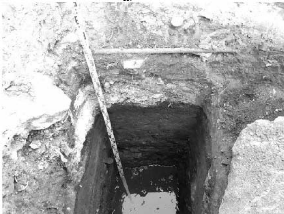
Рис. 161. Санкт-Петербург, «Строительство Красносельско-Калининской линии от станции «Казаковская» до станции «Обводный канал-2» с электродепо «Красносельское». Участок обследования «Строительная площадка шахты 848. Рабочий ствол» Шурф 1. Фотофиксация нижней части стратиграфии восточной стенки.
