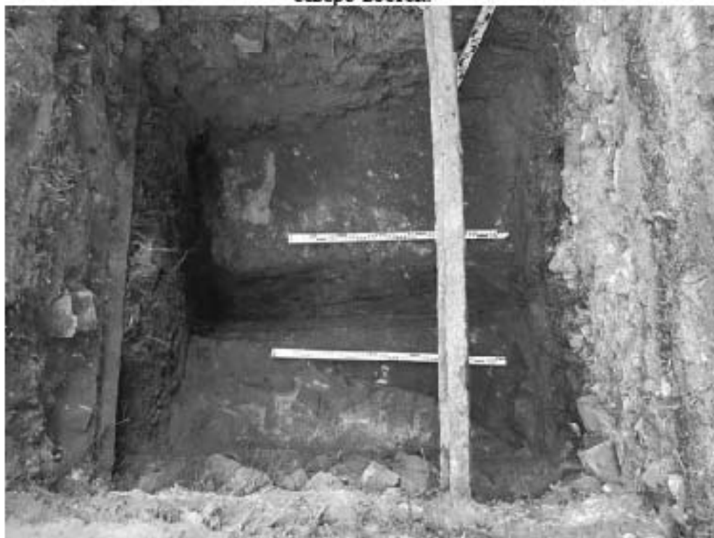
Рис. 255 Санкт-Петербург. «Строительство Красносельско-Калининской линии от станции «Казаковская» до станции «Обводный канал-2» с электродепо «Красносельское». Участок от станции «Путиловская» до станции «Каретная». Участок обследования «Строительная площадка вестибюля № 1 станции «Каретная». Шурф 1. Фотофиксация по уровню темно-серой супеси мешаной со светлой супесью с включениями мелкого строительного мусора. Вид на северо-восток.
