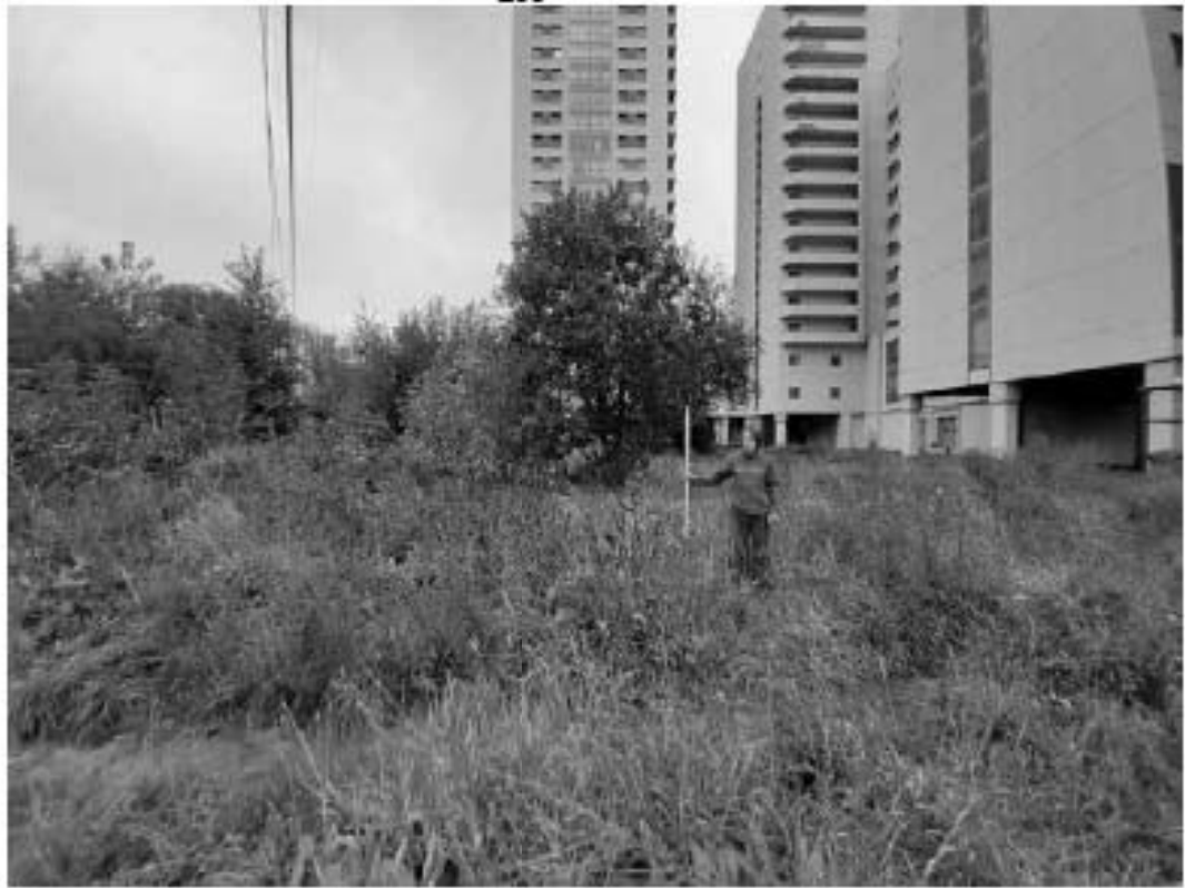
Рис. 143. Санкт-Петербург, «Строительство Красносельско-Калининской линии от станции «Казаковская» до станции «Обводный канал-2» с электродепо «Красносельское». Участок обследования «Строительная площадка шахты 848. Рабочий ствол». Общие виды.
