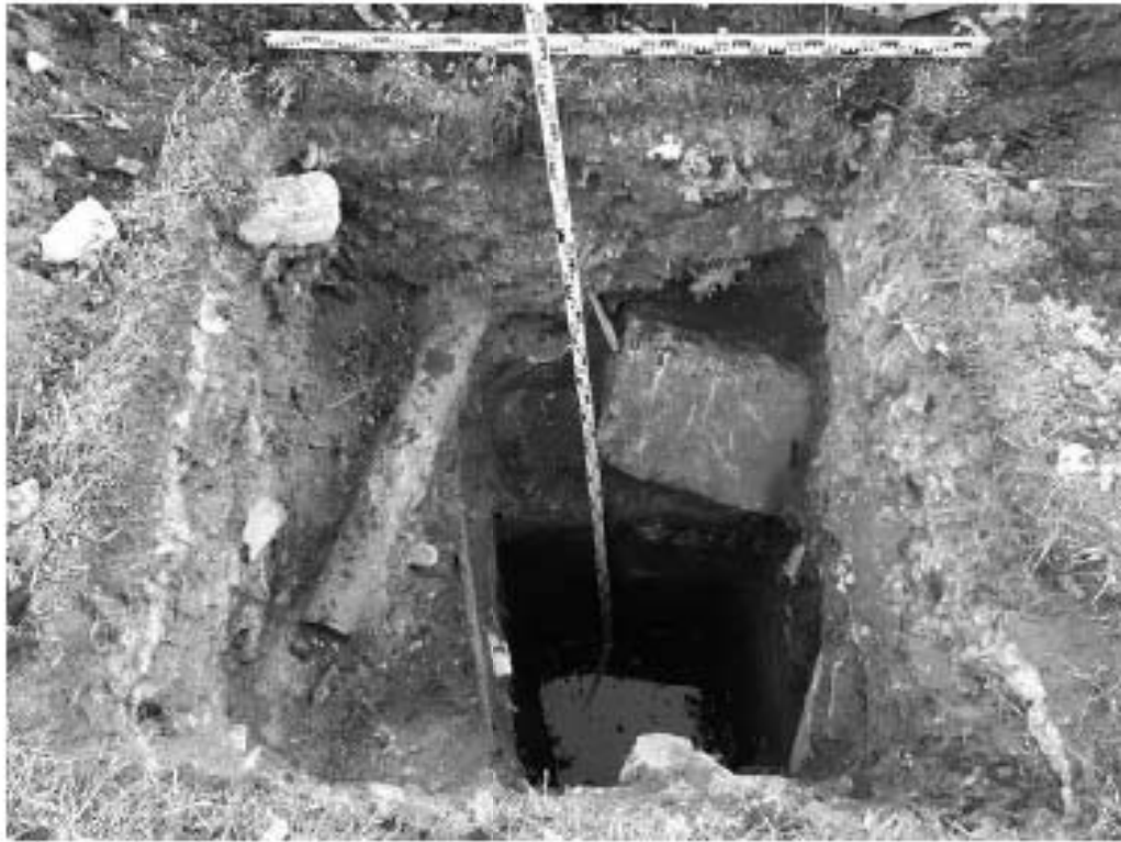
Рис. 157. Санкт-Петербург, «Строительство Красносельско-Калининской линии от станции «Казаконская» до станции «Обводный канал-2» с электродепо «Красносельское». Участок обследования «Строительная площадка шахты 848. Рабочий ствол». Шурф 1. Финальная фотофиксация по светло-серой супеси (материку), затопленной грунтовыми водами. Вид на юг.
