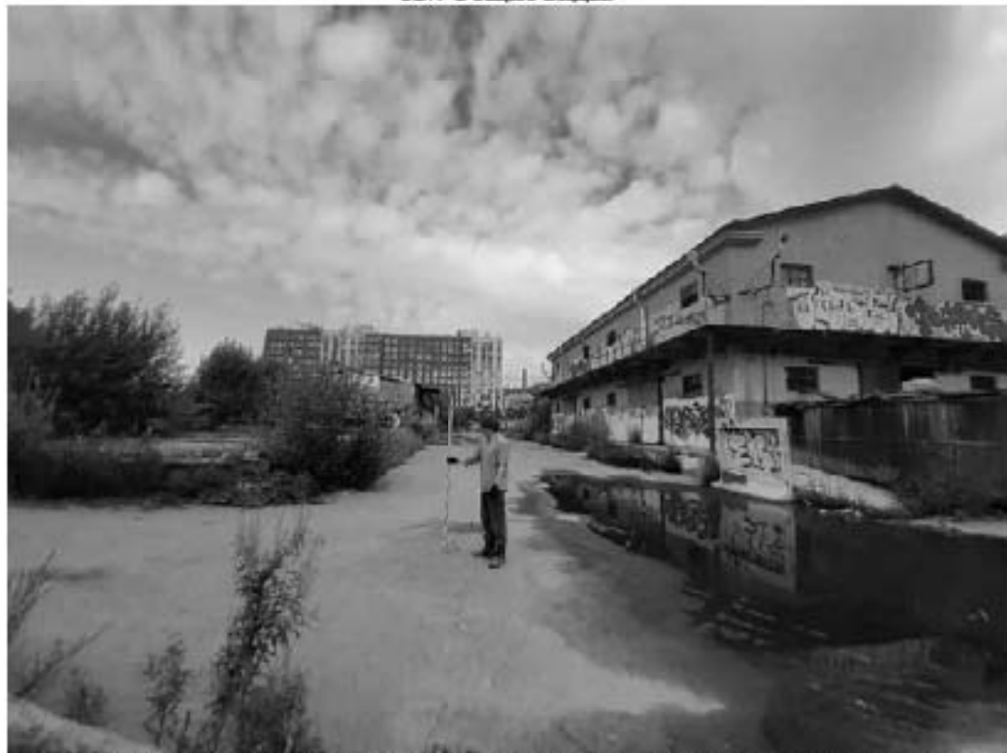
Рис. 195 Санкт-Петербург, «Строительство Красносельско-Калининской линии от станции «Казаковская» до станции «Обводный канал-2» с электродепо «Красносельское». Участок обследования «Строительная площадка вестибюля № 2 станции «Боровая». Строительная площадка шахты № 850 по адресу: Фрунзенский район, Лиговский проспект, дом 26, литера И». Общие виды.
