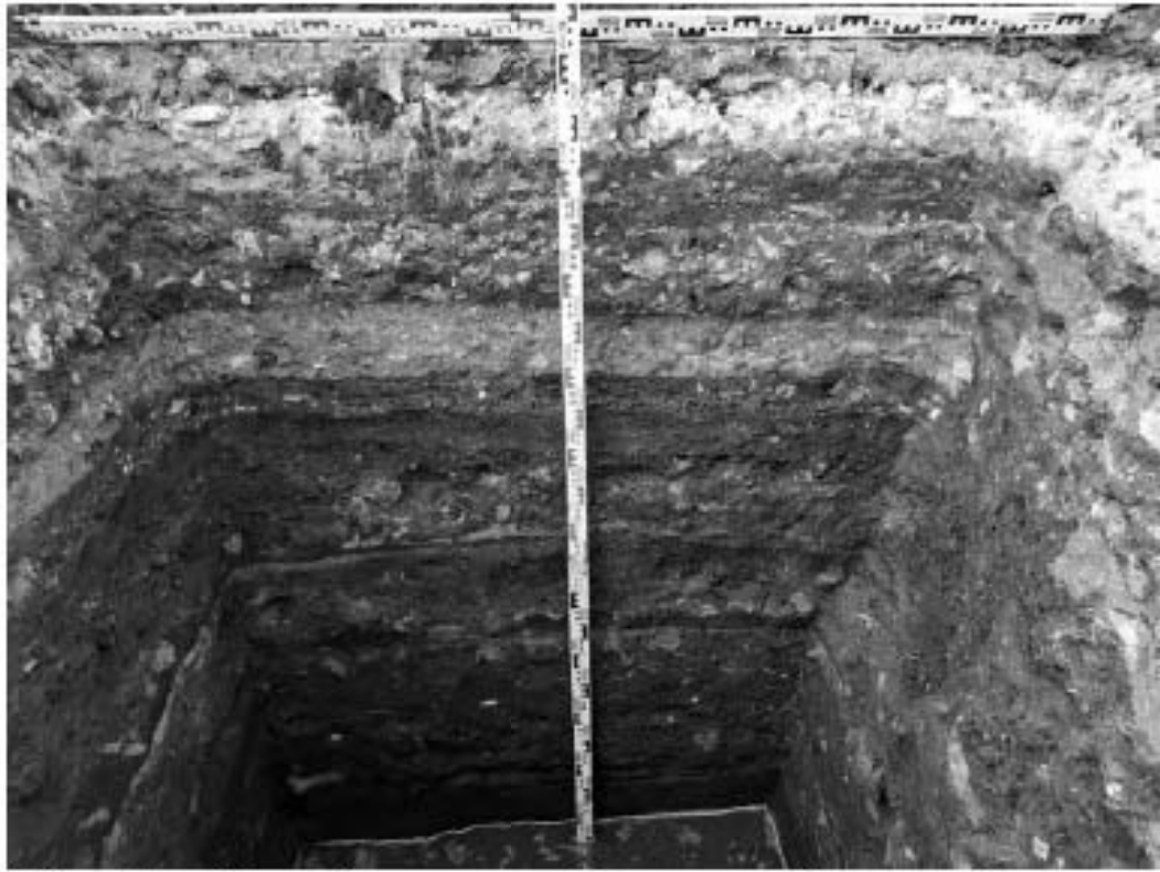
Рис. 212. Санкт-Петербург, «Строительство Красносельско-Калининской линии от станции «Казакская» до станции «Обводный канал-2» с электродепо «Красносельское». Участок обследования «Строительная площадка вестибюля № 2 станции «Боровая». Строительная площадка шахты № 850 по адресу: Фрунзенский район, Лиговский проспект, дом 26, литера И». Шурф 1. Фотофиксация стратиграфии северо-восточной стенки.
