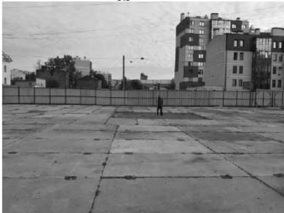
Рис. 223 Санкт-Петербург. «Строительство Красносельско-Калининской линии от станции «Казаковская» до станции «Обводный канал-2» с электродепо «Красносельское». Участок от станции «Путиловская» до станции «Каретная». Участок обследования «Строительная площадка шахты № 851 по адресу: Фрунзенский район, Расстанная улица на свободной территории между домами №7 и №13». Общие виды.
