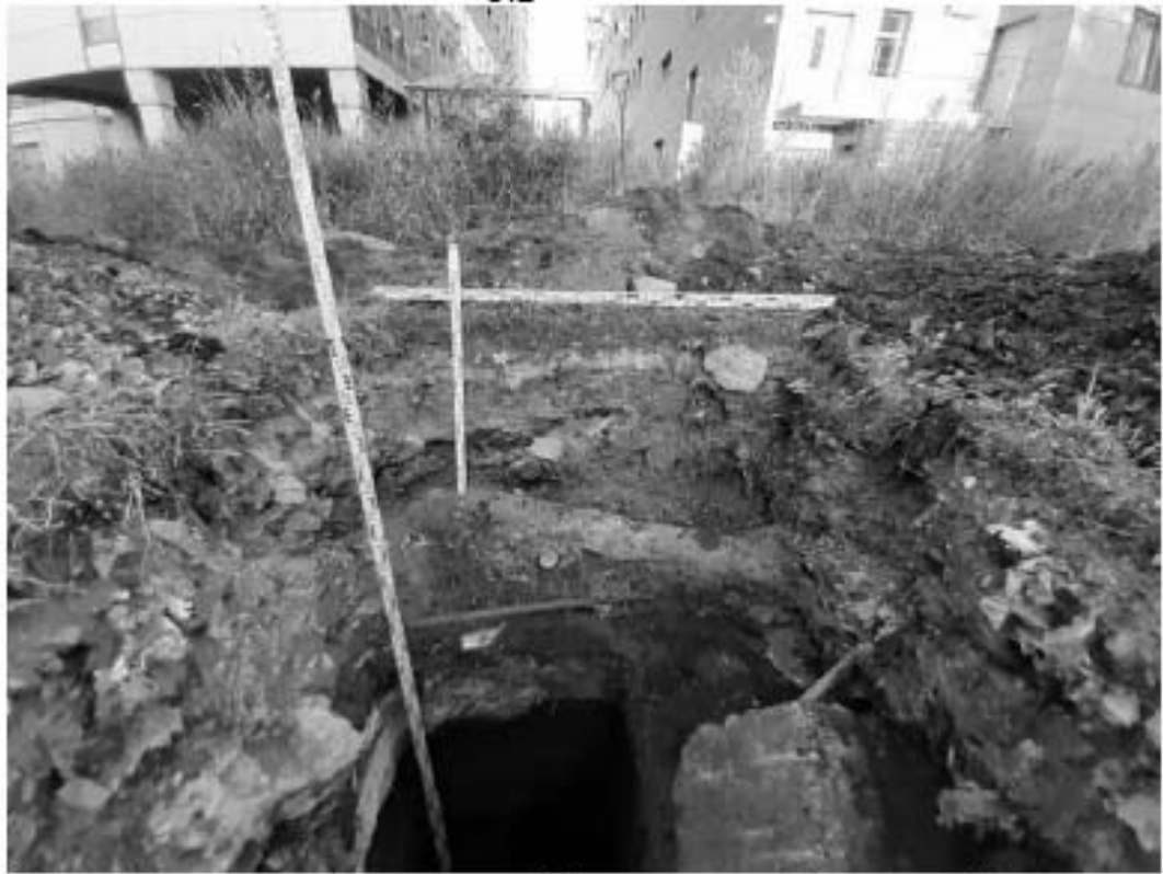
Рис. 168 Санкт-Петербург, «Строительство Красносельско-Калининской линии от станции «Казаковская» до станции «Обводный канал-2» с электродепо «Красносельское». Участок обследования «Строительная площадка шахты 848. Рабочий ствол». Шурф 1. Фотофиксация после окончания работ. Общий вид на восток.
