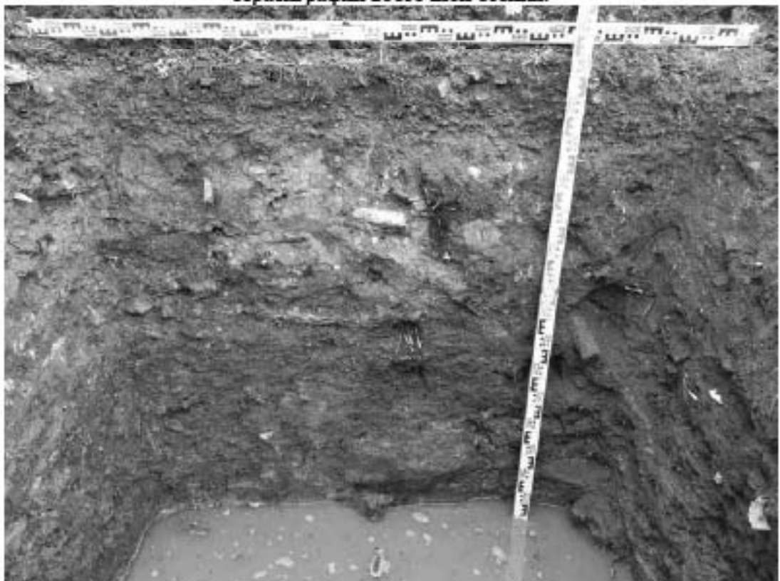
Рис. 102 Санкт-Петербург, «Строительство Красносельско-Калининской линии от станции «Казакowsкая» до станции «Обводный канал-2» с электродепо «Красносельское». Участок обследования «Строительная площадка шахты 847. Рабочий ствол». Шурф 1. Фотофиксация стратиграфии южной стенки.
