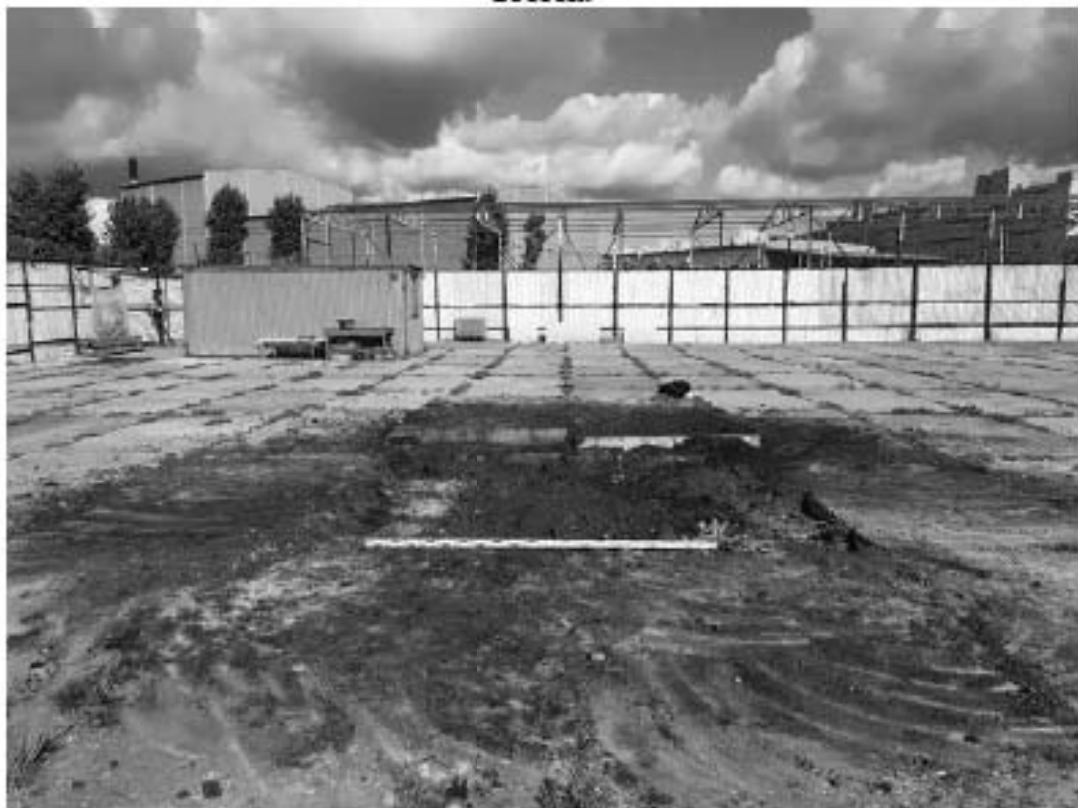
Рис. 187 Санкт-Петербург, «Строительство Красносельско-Калининской линии от станции «Казаковская» до станции «Обводный канал-2» с электродепо «Красносельское». Участок обследования «Строительная площадка шахты 849 по адресу: Московский район, Киевская ул., дом 5, литера Е». Шурф 1. Фотофиксация после рекультивации. Вид на северо-восток.
