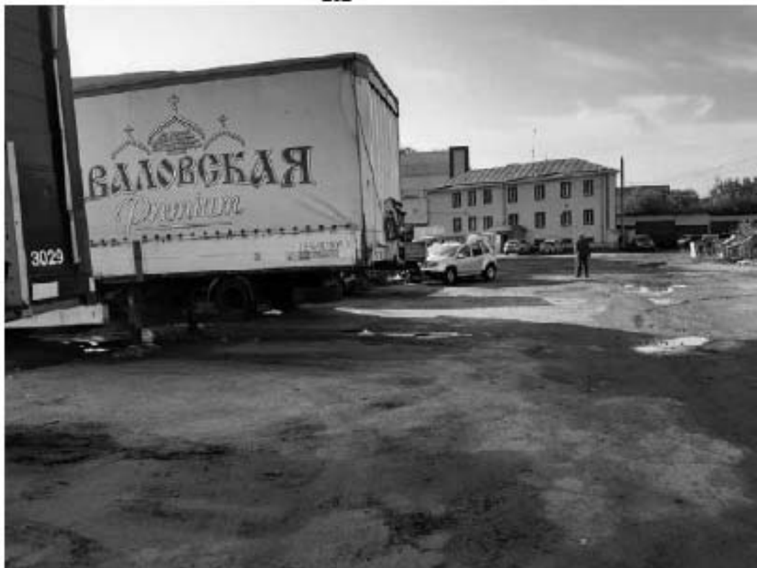
Рис. 90 Санкт-Петербург, «Строительство Красносельско-Калининской линии от станции «Казакоская» до станции «Обводный канал-2» с электродепо «Красносельское». Участок обследования «Строительная площадка шахты 847. Рабочий ствол». Общие виды.
