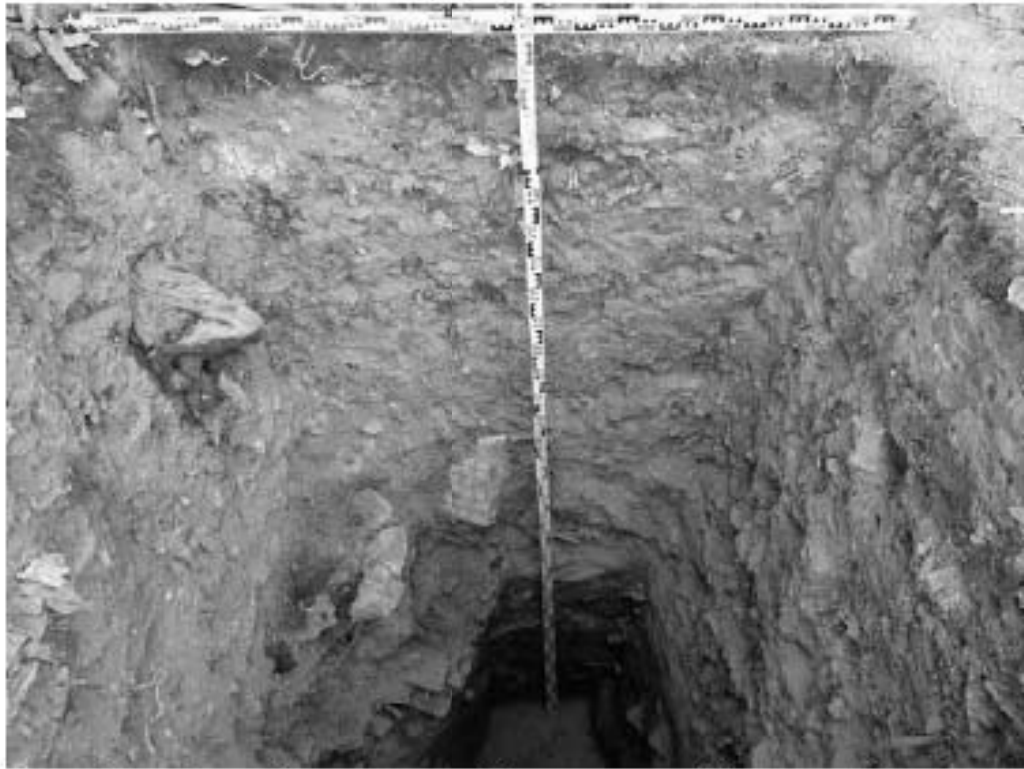
Рис. 60. Санкт-Петербург, «Строительство Красносельско-Калининской линии от станции «Казаковская» до станции «Обводный канал-2» с электродепо «Красносельское». Участок обследования «Строительная площадка шахты №846. Рабочий ствол; Строительная площадка вестибюля №1 станции «Броневая»». Шурф 1. Фотофиксация стратиграфии западной стенки.
