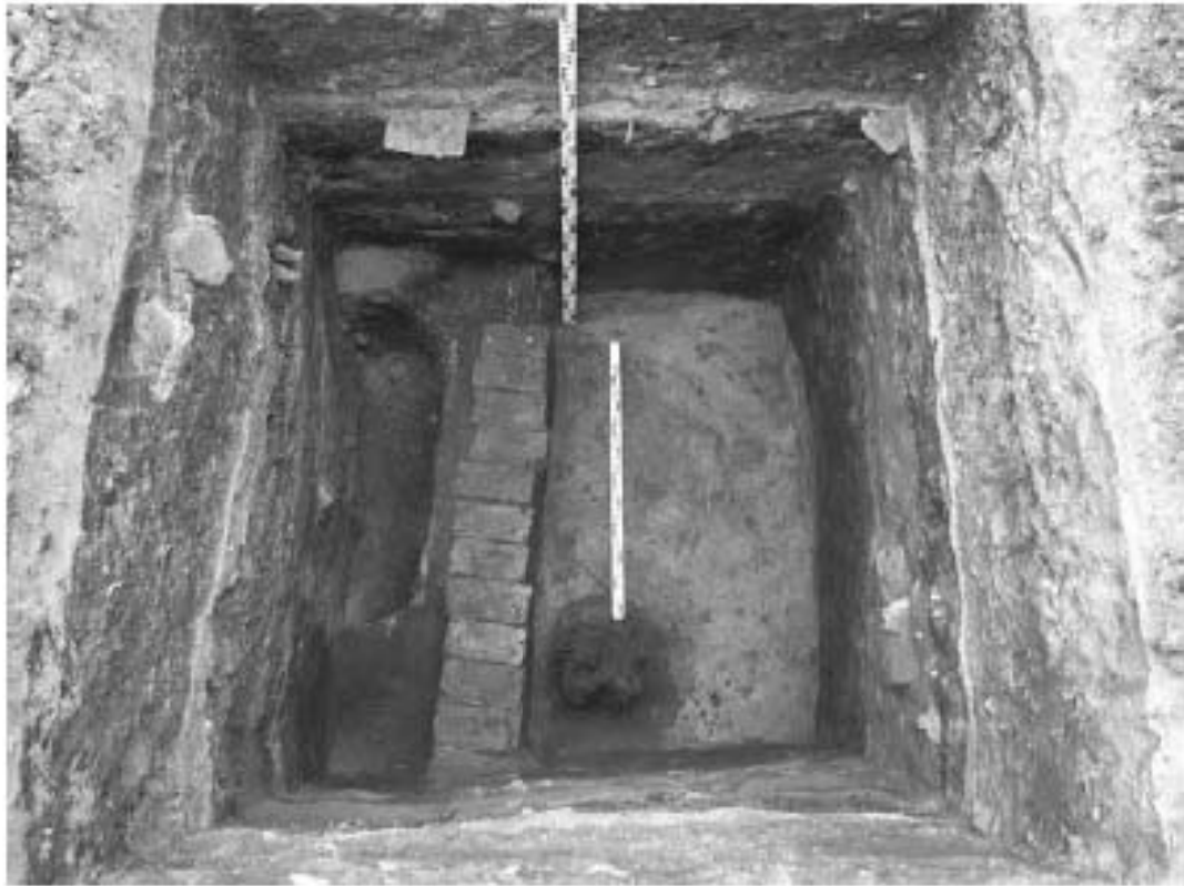
Рис. 321 Санкт-Петербург. «Строительство Красносельско-Калининской линии от станции «Казаковская» до станции «Обводный канал-2» с электродепо «Красносельское». Участок от станции «Путиловская» до станции «Каретная». Участок обследования «Строительная площадка шахты №853 по адресу: Центральный район, южнее здания по адресу ул. Черняховского, дом 19». Шурф 1. Фотофиксация по материковой поверхности (серовато-коричневый песок). Вид на северо-запад.
