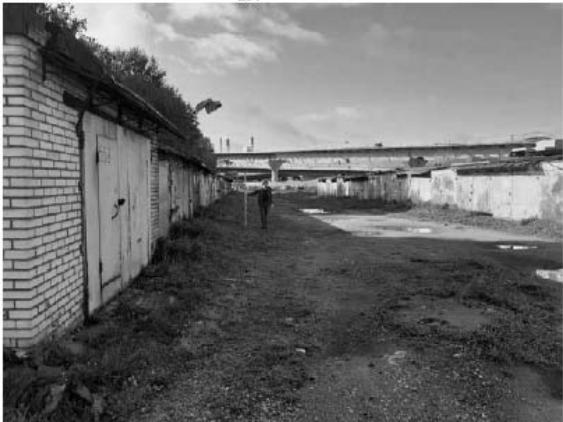
Рис. 42. Санкт-Петербург, «Строительство Красносельско-Калининской линии от станции «Казакская» до станции «Обводный канал-2» с электродепо «Красносельское». Участок обследования «Строительная площадка шахты №846. Рабочий ствол; Строительная площадка вестибюля №1 станции «Бронева»» Общие виды.
