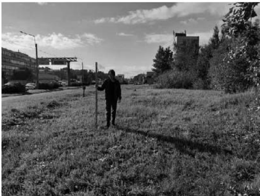
Рис. 33. Санкт-Петербург, «Строительство Красносельско-Калининской линии от станции «Казаковская» до станции «Обводный канал-2» с электродепо «Красносельское». Участок обследования «Строительная площадка шахты №846. Рабочий ствол, Строительная площадка вестибюля №1 станции «Броневая»» Общие виды.
