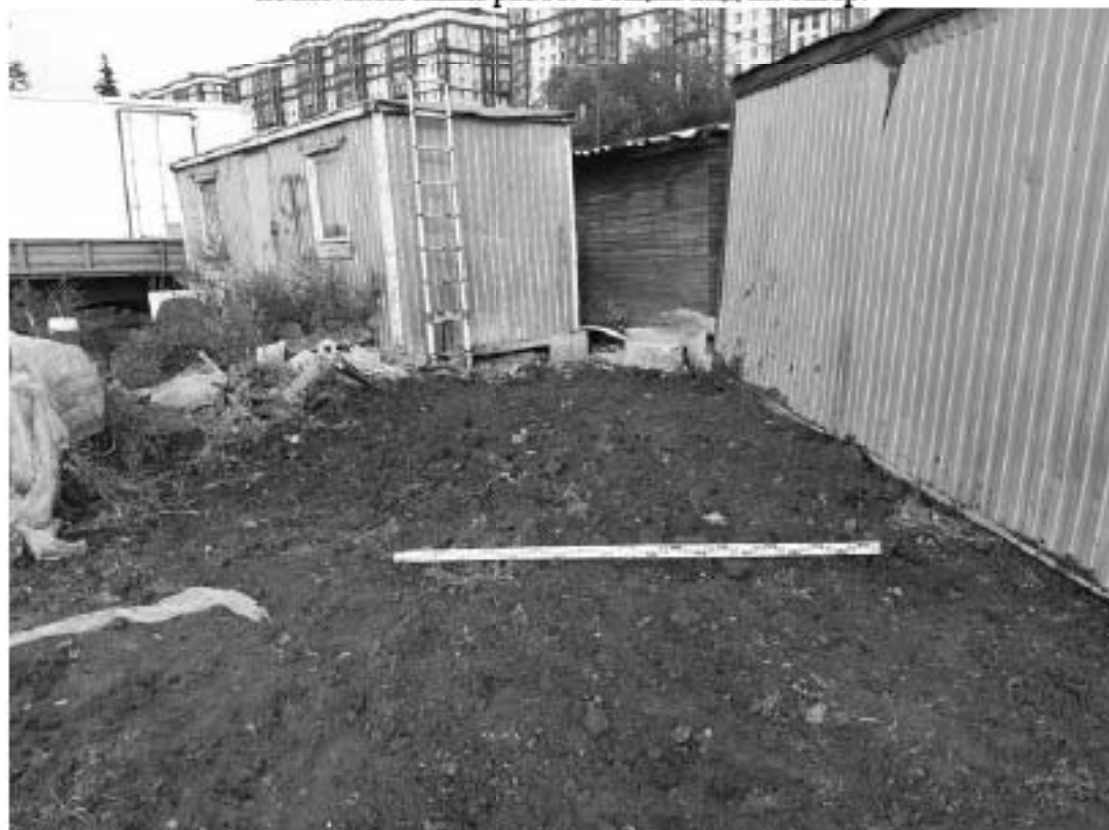
Рис. 106. Санкт-Петербург, «Строительство Красносельско-Калининской линии от станции «Казаковская» до станции «Обводный канал-2» с электродепо «Красносельское». Участок обследования «Строительная площадка шахты 847. Рабочий ствол». Шурф 1. Фотофиксация послерекультивации. Вид на север.
