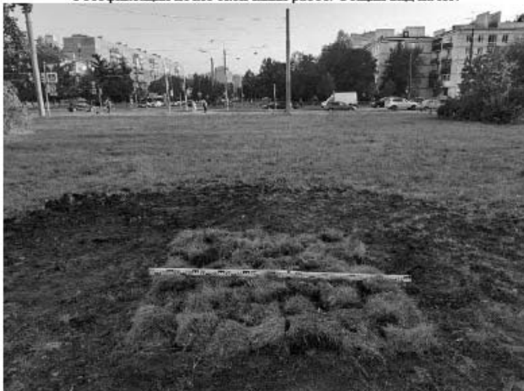
Рис. 87. Санкт-Петербург, «Строительство Красносельско-Калининской линии от станции «Казаковская» до станции «Обводный канал-2» с электродепо «Красносельское». Участок обследования «Строительная площадка вестибюля станции «Броневая». Шурф 1. Фотофиксация после рекультивации. Вид на юг.
