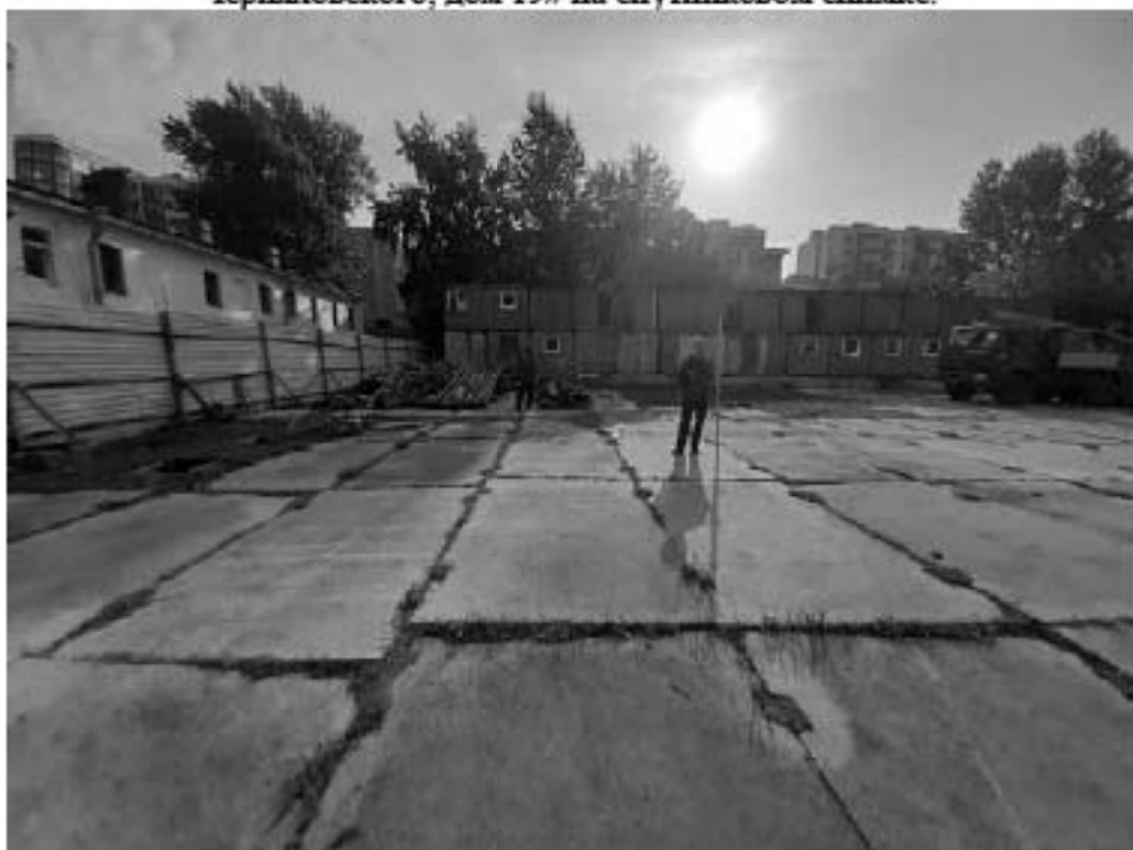
Рис. 302. Санкт-Петербург. «Строительство Красносельско-Калининской линии от станции «Казаковская» до станции «Обводный канал-2» с электродепо «Красносельское». Участок от станции «Путиловская» до станции «Каретная». Участок обследования «Строительная площадка шахты №853 по адресу: Центральный район, южнее здания по адресу ул. Черняховского, дом 19». Общие виды.
