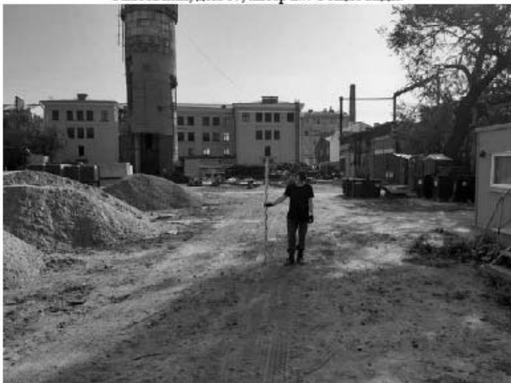
Рис. 284 Санкт-Петербург. «Строительство Красносельско-Калининской линии от станции «Казаковская» до станции «Обводный канал-2» с электродепо «Красносельское». Участок от станции «Путиловская» до станции «Каретная». Участок обследования «Строительная площадка шахты 852 по адресу: Фрунзенский район, западнее здания по адресу ул. Тамбовская, дом 17, литер Б». Общие виды.
