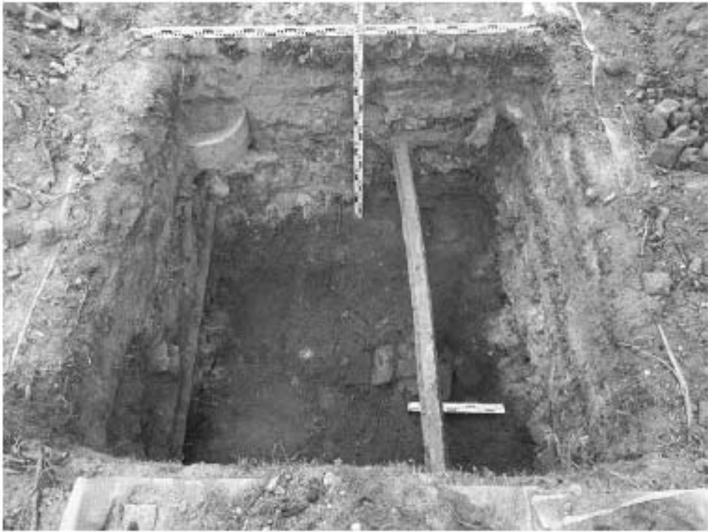
Рис. 252. Санкт-Петербург. «Строительство Красносельско-Калининской линии от станции «Казаковская» до станции «Обводный канал-2» с электродепо «Красносельское». Участок от станции «Путиловская» до станции «Каретная». Участок обследования «Строительная площадка вестибюля № 1 станции «Каретная». Шурф 1. Фотофиксация по слою темной супеси мешаной со строительным мусором. Вид на северо-восток.
