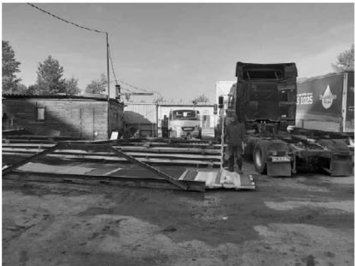
Рис. 93. Санкт-Петербург, «Строительство Красносельско-Калининской линии от станции «Казаковская» до станции «Обводный канал-2» с электродепо «Красносельское». Участок обследования «Строительная площадка шахты 847. Рабочий ствол». Общие виды.
