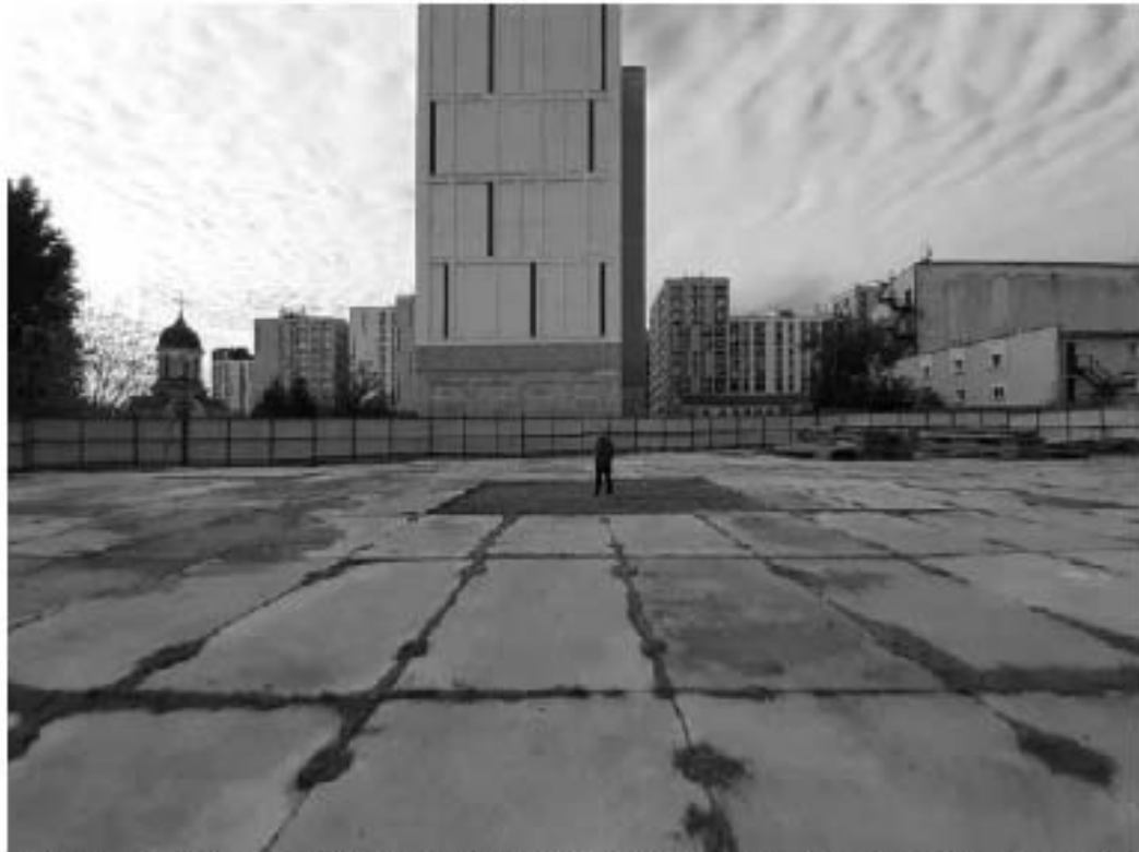
Рис. 221 Санкт-Петербург. «Строительство Красносельско-Калининской линии от станции «Казаконская» до станции «Обводный канал-2» с электродепо «Красносельское». Участок от станции «Путиловская» до станции «Каретная». Участок обследования «Строительная площадка шахты № 851 по адресу: Фрунзенский район, Расстанная улица на свободной территории между домами №7 и №13». Общие виды
