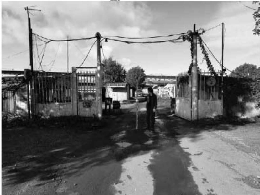
Рис. 32. Санкт-Петербург, «Строительство Красносельско-Калининской линии от станции «Казаковская» до станции «Обводный канал-2» с электродепо «Красносельское». Участок обследования «Строительная площадка шахты №846. Рабочий ствол, Строительная площадка вестибюля №1 станции «Броневая»» Общие виды.
