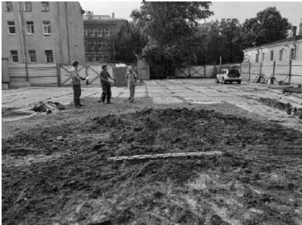
Рис. 324. Санкт-Петербург. «Строительство Красносельско-Калининской линии от станции «Казаковская» до станции «Обводный канал-2» с электродепо «Красносельское». Участок от станции «Путиловская» до станции «Каретная». Участок обследования «Строительная площадка шахты №853 по адресу: Центральный район, южнее здания по адресу ул. Черняховского, дом 19». Шурф 1. Фотофиксация после рекультивации. Вид на северо-запад
