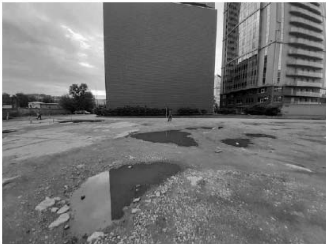
Рис. 150 Санкт-Петербург, «Строительство Красносельско-Калининской линии от станции «Казаковская» до станции «Обводный канал-2» с электродепо «Красносельское». Участок обследования «Строительная площадка шахты 848. Рабочий ствол». Общие виды.
