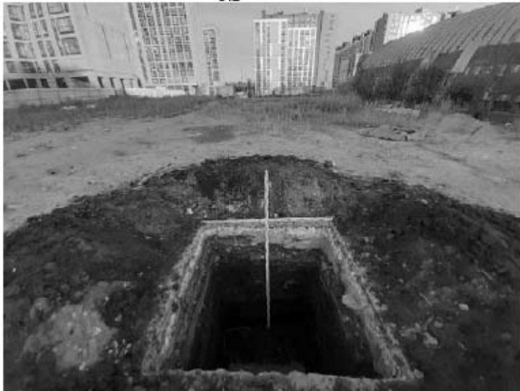
Рис. 217. Санкт-Петербург, «Строительство Красносельско-Калининской линии от станции «Казаковская» до станции «Обводный канал-2» с электродепо «Красносельское». Участок обследования «Строительная площадка вестибюля № 2 станции «Боровая». Строительная площадка шахты № 850 по адресу: Фрунзенский район, Лиговский проспект, дом 26, литера И». Шурф 1. Фотофиксация после окончания работ. Общий вид на северо-восток.
