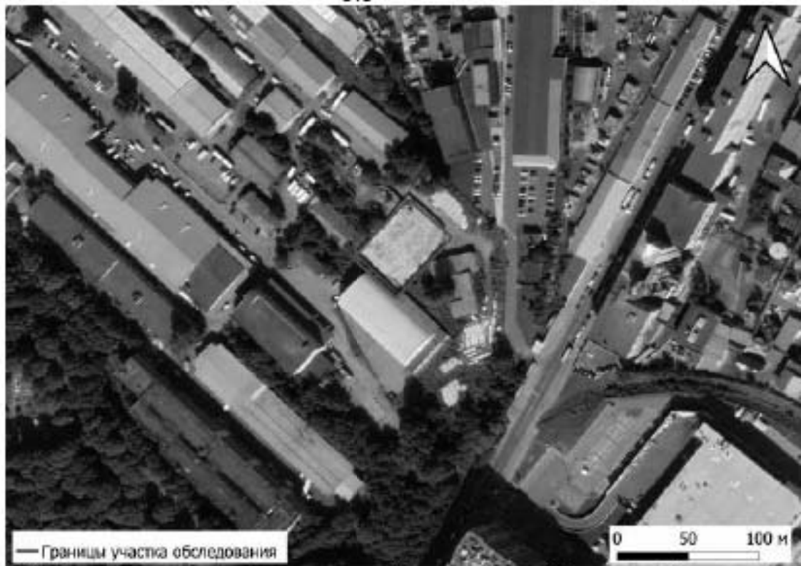
Рис. 170. Санкт-Петербург, «Строительство Красносельско-Калининской линии от станции «Казаковская» до станции «Обводный канал-2» с электродепо «Красносельское». Участок обследования «Строительная площадка шахты 849 по адресу: Московский район, Киевская ул., дом 5, литера Е» на спутниковом снимке.
