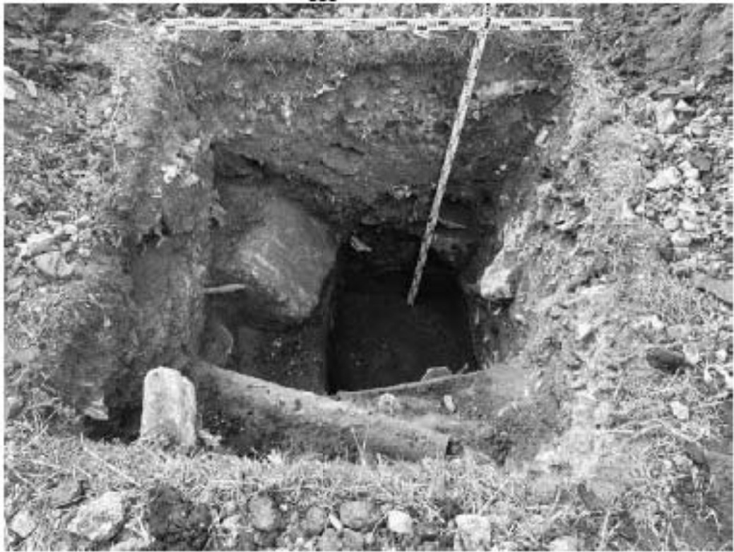
Рис. 154 Санкт-Петербург, «Строительство Красносельско-Калининской линии от станции «Казаковская» до станции «Обводный канал-2» с электродепо «Красносельское». Участок обследования «Строительная площадка шахты 848. Рабочий ствол». Шурф 1. Фотофиксация по слою темно-коричневой супеси, мешаной со щепой. Вид на север.
