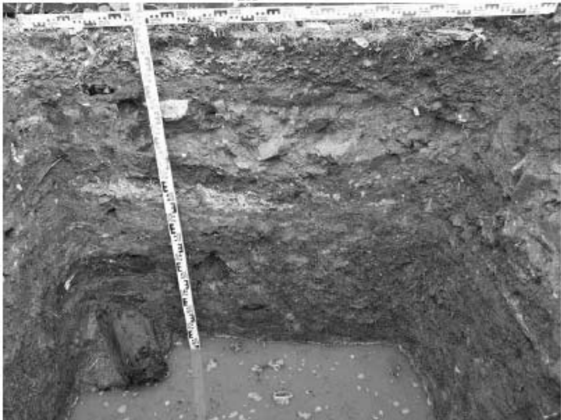
Рис. 101 Санкт-Петербург, «Строительство Красносельско-Калининской линии от станции «Казакowsкая» до станции «Обводный канал-2» с электродепо «Красносельское». Участок обследования «Строительная площадка шахты 847. Рабочий ствол». Шурф 1. Фотофиксация стратиграфии восточной стенки.
