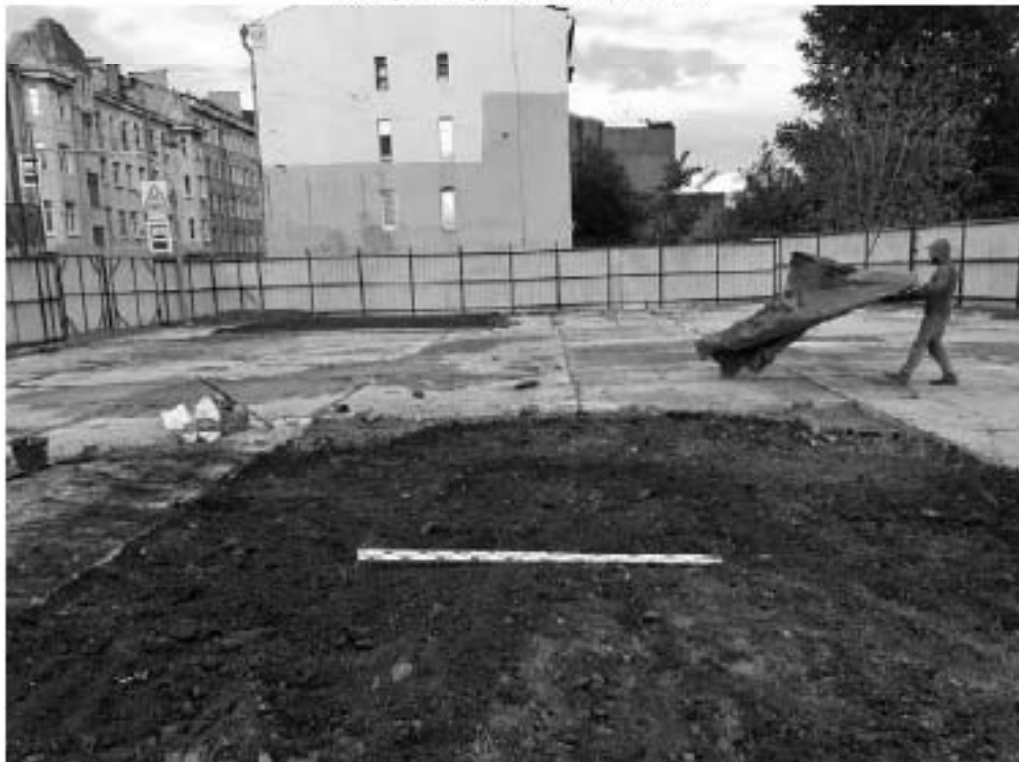
Рис. 237. Санкт-Петербург. «Строительство Красносельско-Калининской линии от станции «Казаковская» до станции «Обводный канал-2» с электродепо «Красносельское». Участок от станции «Путиловская» до станции «Каретная». Участок обследования «Строительная площадка шахты № 851 по адресу: Фрунзенский район, Расстанная улица на свободной территории между домами №7 и №13». Шурф 1. Фотофиксация после рекультивации. Вид на юго-восток.
