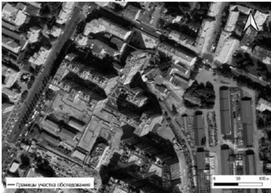
Рис. 188. Санкт-Петербург, «Строительство Красносельско-Калининской линии от станции «Казаконская» до станции «Обводный канал-2» с электродепо «Красносельское». 1 - Участок обследования «Строительная площадка вестибюля № 2 станции «Боровая». Строительная площадка шахты № 850 по адресу: Фрунзенский район, Лиговский проспект, дом 26, литера И». Спутниковый снимок.
