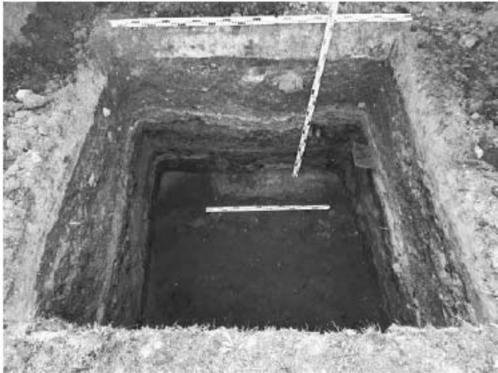
Рис. 312. Санкт-Петербург. «Строительство Красносельско-Калининской линии от станции «Казаковская» до станции «Обводный канал-2» с электродепо «Красносельское». Участок от станции «Путиловская» до станции «Каретная». Участок обследования «Строительная площадка шахты №853 по адресу: Центральный район, южнее здания по адресу ул. Черняховского, дом 19». Шурф 1. Фотофиксация по слою темно-коричневой супеси. Вид на юго-запад.
