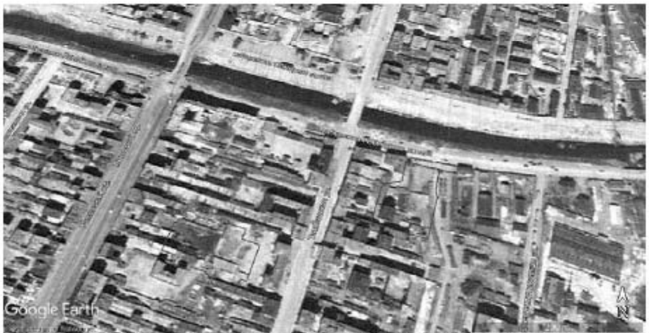
Рис. 25. Санкт-Петербург, «Строительство Красносельско-Калининской линии от станции «Казаковская» до станции «Обводный канал-2» с электродепо «Красносельское». Участок от станции «Путиловская» до станции «Каретная». Расположение участков обследования на немецкой аэрофотосъемке 1942 г. Внизу слева: «Строительная площадка шахты 852 по адресу: Фрунзенский район, западнее здания по адресу ул. Тамбовская, дом 17, литер Б» Внизу справа: «Строительная площадка вестибюля № 1 станции «Каретная».
