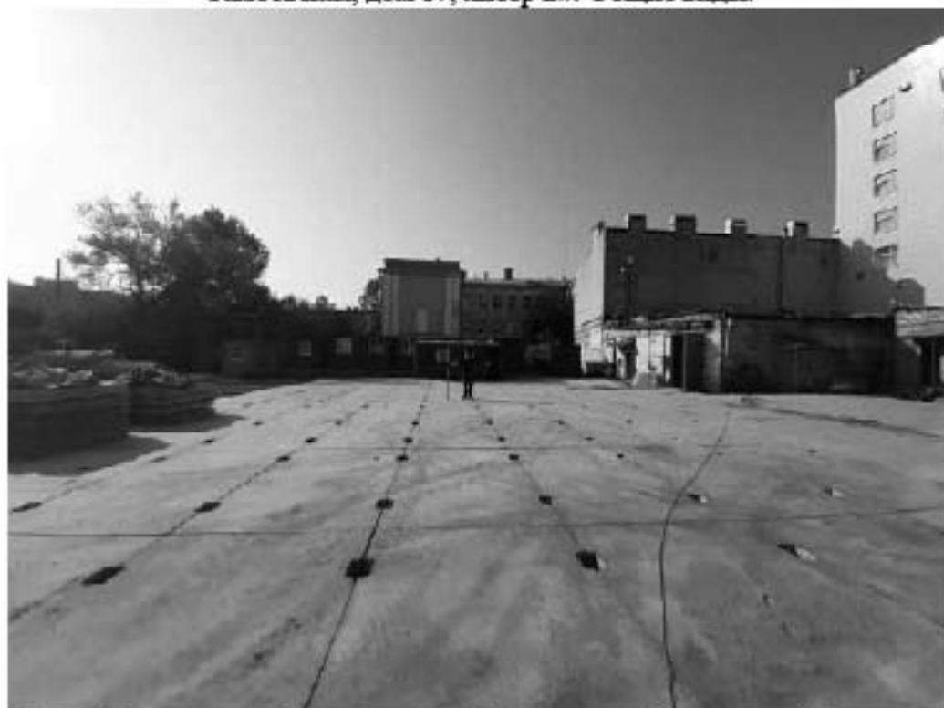
Рис. 282 Санкт-Петербург. «Строительство Красносельско-Калининской линии от станции «Казаконская» до станции «Обводный канал-2» с электродепо «Красносельское». Участок от станции «Путиловская» до станции «Каретная». Участок обследования «Строительная площадка шахты 852 по адресу: Фрунзенский район, западнее здания по адресу ул. Тамбовская, дом 17, литер Б». Общие виды.
