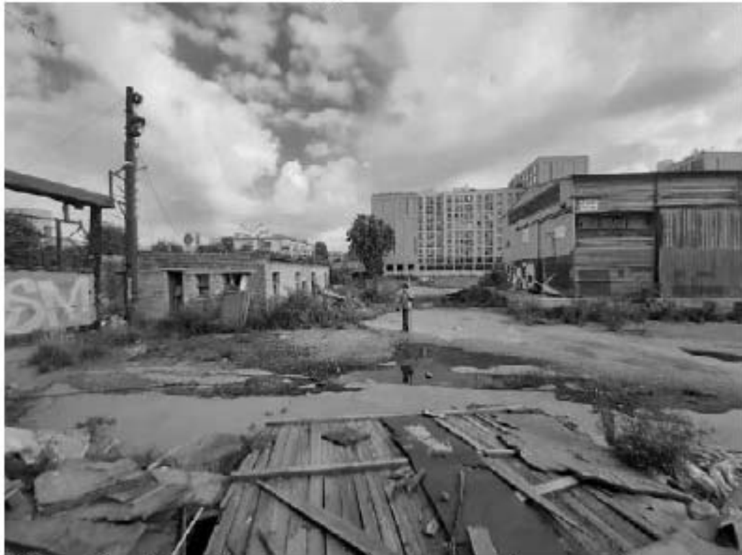
Рис. 200 Санкт-Петербург, «Строительство Красносельско-Калининской линии от станции «Казаковская» до станции «Обводный канал-2» с электродепо «Красносельское». Участок обследования «Строительная площадка вестибюля № 2 станции «Боровая». Строительная площадка шахты № 850 по адресу: Фрунзенский район, Лиговский проспект, дом 26, литера И». Общие виды.
