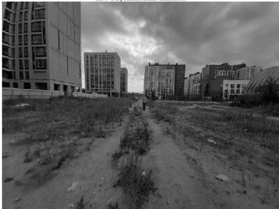
Рис. 189. Санкт-Петербург, «Строительство Красносельско-Калининской линии от станции «Казаконская» до станции «Обводный канал-2» с электродепо «Красносельское». Участок обследования «Строительная площадка вестибюля № 2 станции «Боровая». Строительная площадка шахты № 850 по адресу: Фрунзенский район, Лиговский проспект, дом 26, литера И». Общие виды.
