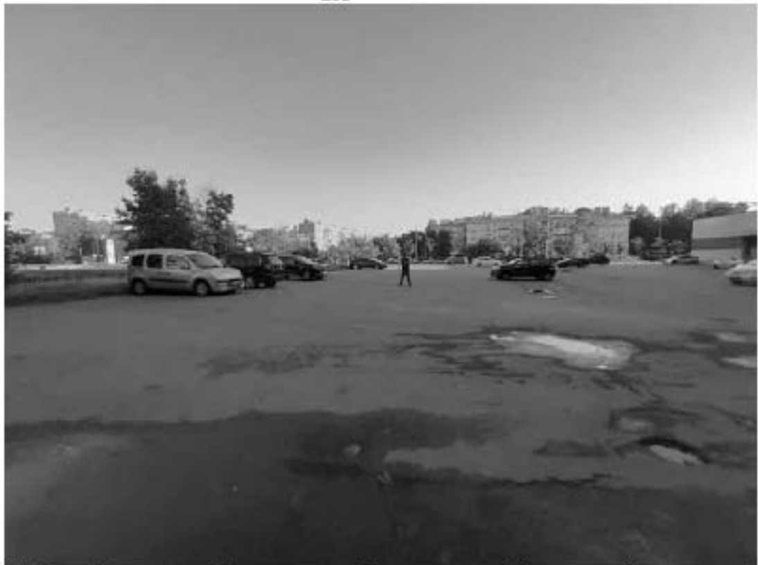
Рис. 71. Санкт-Петербург, «Строительство Красносельско-Калининской линии от станции «Казаковская» до станции «Обводный канал-2» с электродепо «Красносельское». Участок обследования «Строительная площадка вестибюля станции «Бронева». Общие виды.
