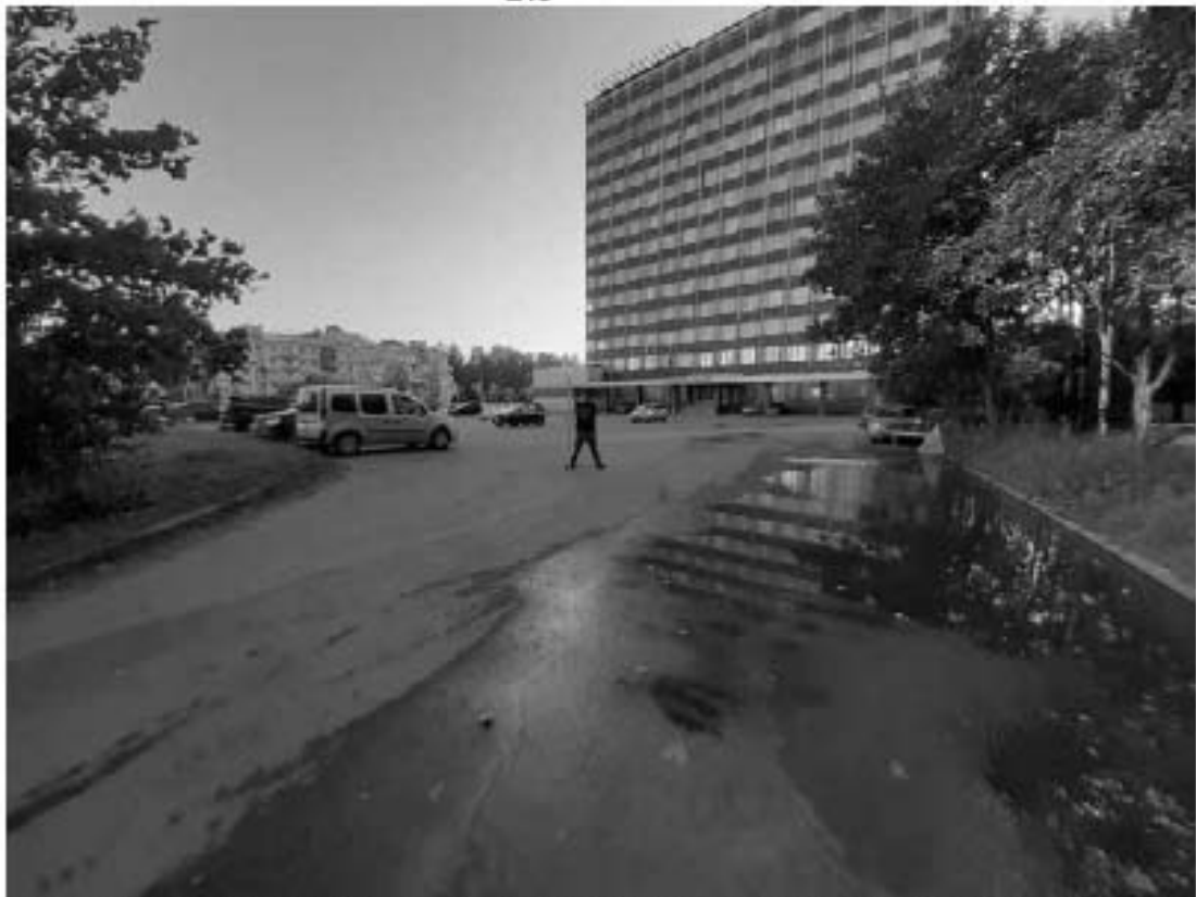
Рис. 69 Санкт-Петербург, «Строительство Красносельско-Калининской линии от станции «Казаковская» до станции «Обводный канал-2» с электродепо «Красносельское». Участок обследования «Строительная площадка вестибюля станции «Броневая». Общие виды.
