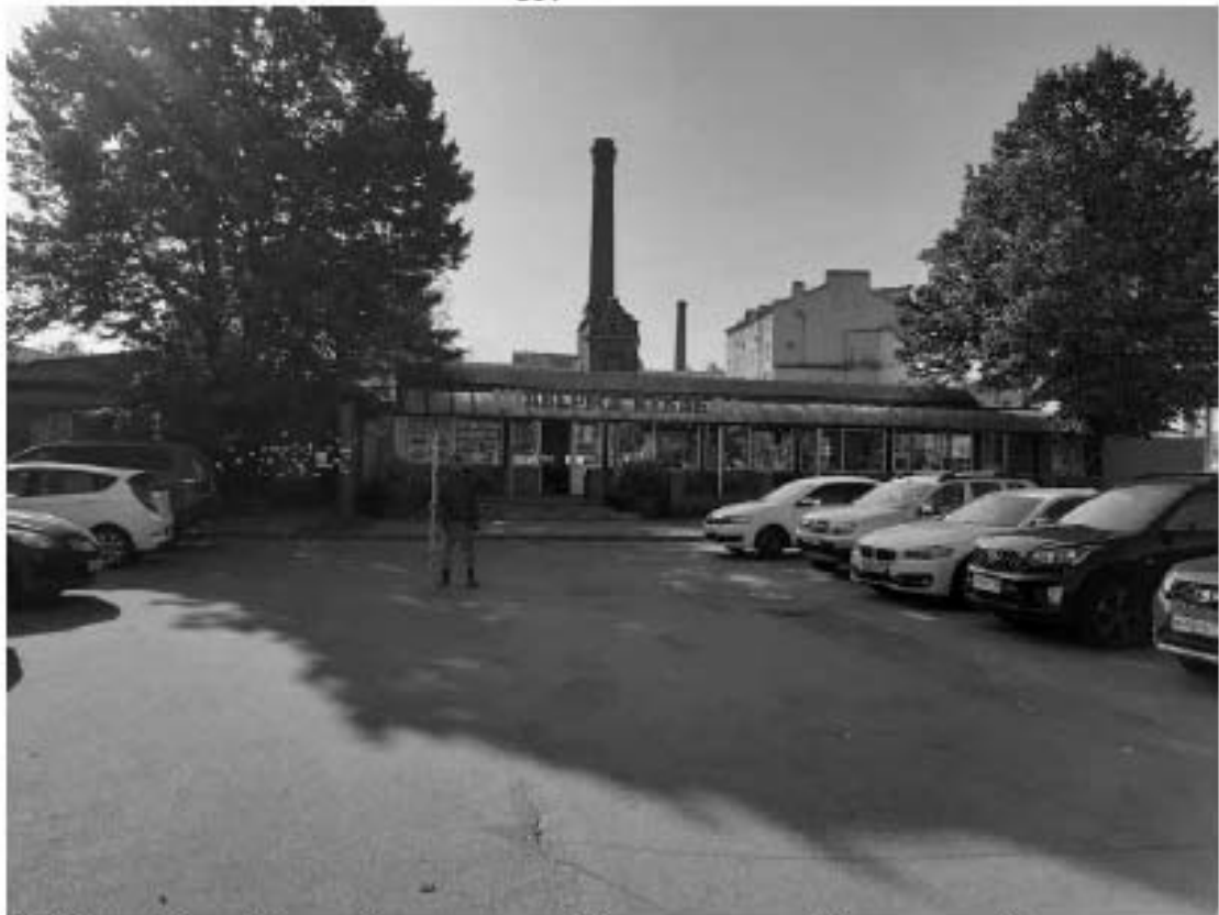
Рис. 248 Санкт-Петербург. «Строительство Красносельско-Калининской линии от станции «Казаковская» до станции «Обводный канал-2» с электродепо «Красносельское». Участок от станции «Путиловская» до станции «Каретная». Участок обследования «Строительная площадка вестибюля № 1 станции «Каретная». Общие виды.
