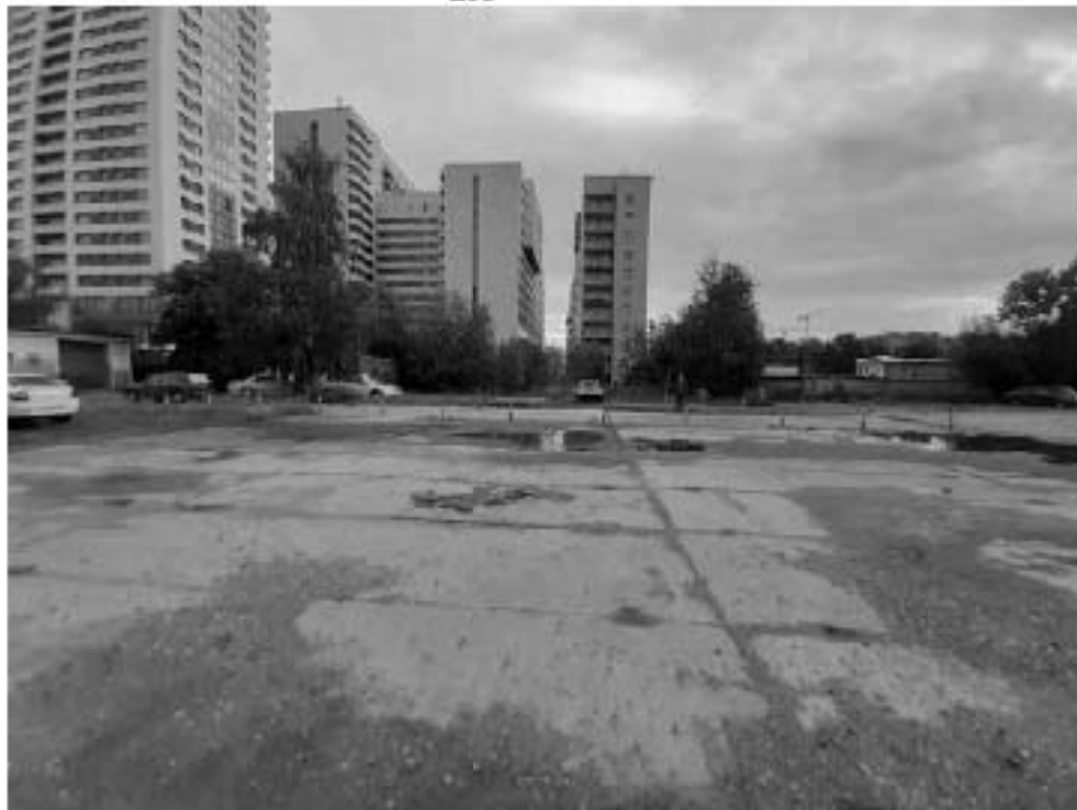
Рис. 149 Санкт-Петербург, «Строительство Красносельско-Калининской линии от станции «Казаковская» до станции «Обводный канал-2» с электродепо «Красносельское». Участок обследования «Строительная площадка шахты 848. Рабочий ствол». Общие виды.
