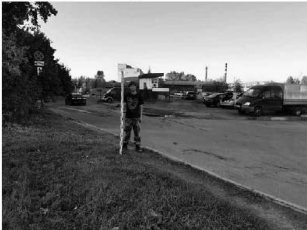
Рис. 67. Санкт-Петербург, «Строительство Красносельско-Калининской линии от станции «Казаковская» до станции «Обводный канал-2» с электродепо «Красносельское». Участок обследования «Строительная площадка вестибюля станции «Броневая». Общие виды.
