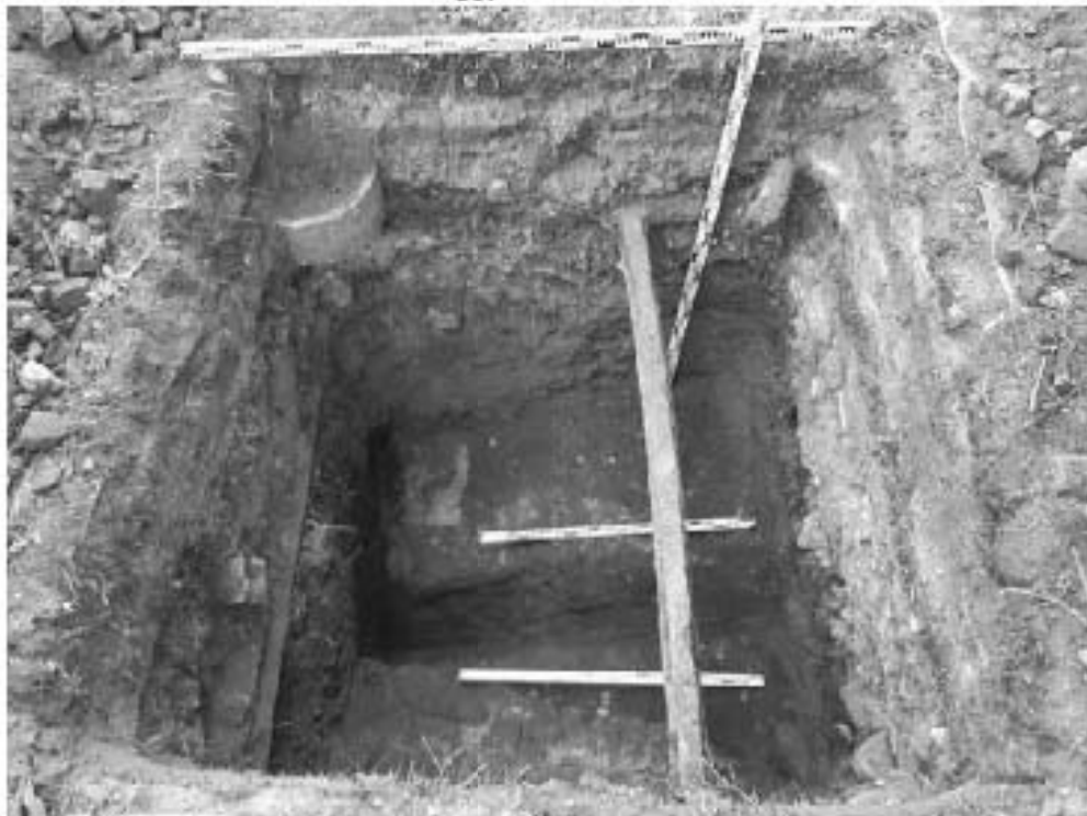
Рис. 254 Санкт-Петербург. «Строительство Красносельско-Калининской линии от станции «Казаковская» до станции «Обводный канал-2» с электродепо «Красносельское». Участок от станции «Путиловская» до станции «Каретная». Участок обследования «Строительная площадка вестибюля № 1 станции «Каретная». Шурф 1. Фотофиксация по уровню темно-серой супеси мешаной со светлой супесью с включениями мелкого строительного мусора. Вид на северо-восток.
