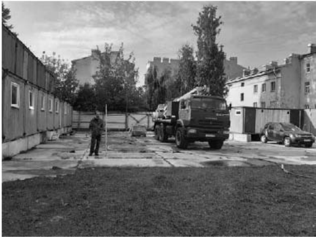
Рис. 305 Санкт-Петербург. «Строительство Красносельско-Калининской линии от станции «Казаконская» до станции «Обводный канал-2» с электродепо «Красносельское». Участок от станции «Путиловская» до станции «Каретная». Участок обследования «Строительная площадка шахты №853 по адресу: Центральный район, южнее здания по адресу ул. Черняховского, дом 19». Общие виды.
