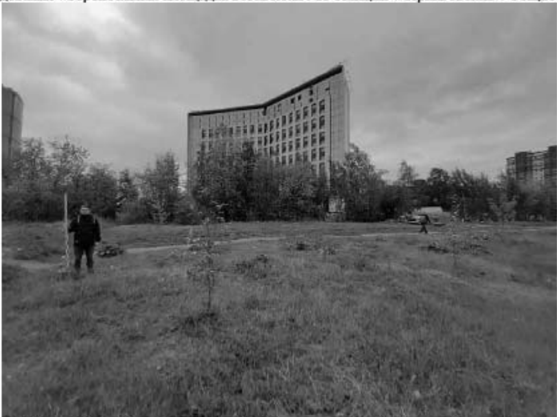
Рис. 110 Санкт-Петербург, «Строительство Красносельско-Калининской линии от станции «Казаковская» до станции «Обводный канал-2» с электродепо «Красносельское». Участок обследования «Строительная площадка вестибюля №1 станции «Черниговская». Общие виды.
