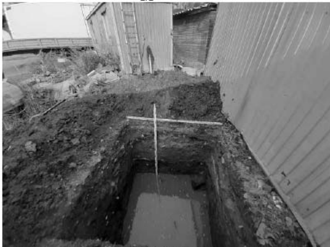
Рис. 105. Санкт-Петербург, «Строительство Красносельско-Калининской линии от станции «Казаковская» до станции «Обводный канал-2» с электродепо «Красносельское». Участок обследования «Строительная площадка шахты 847. Рабочий ствол». Шурф 1. Фотофиксация после окончания работ. Общий вид на север.
