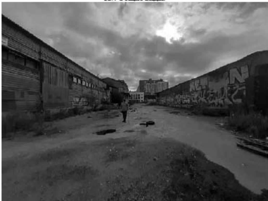
Рис. 199. Санкт-Петербург, «Строительство Красносельско-Калининской линии от станции «Казаковская» до станции «Обводный канал-2» с электродепо «Красносельское». Участок обследования «Строительная площадка вестибюля № 2 станции «Боровая». Строительная площадка шахты № 850 по адресу: Фрунзенский район, Лиговский проспект, дом 26, литера И». Общие виды.
