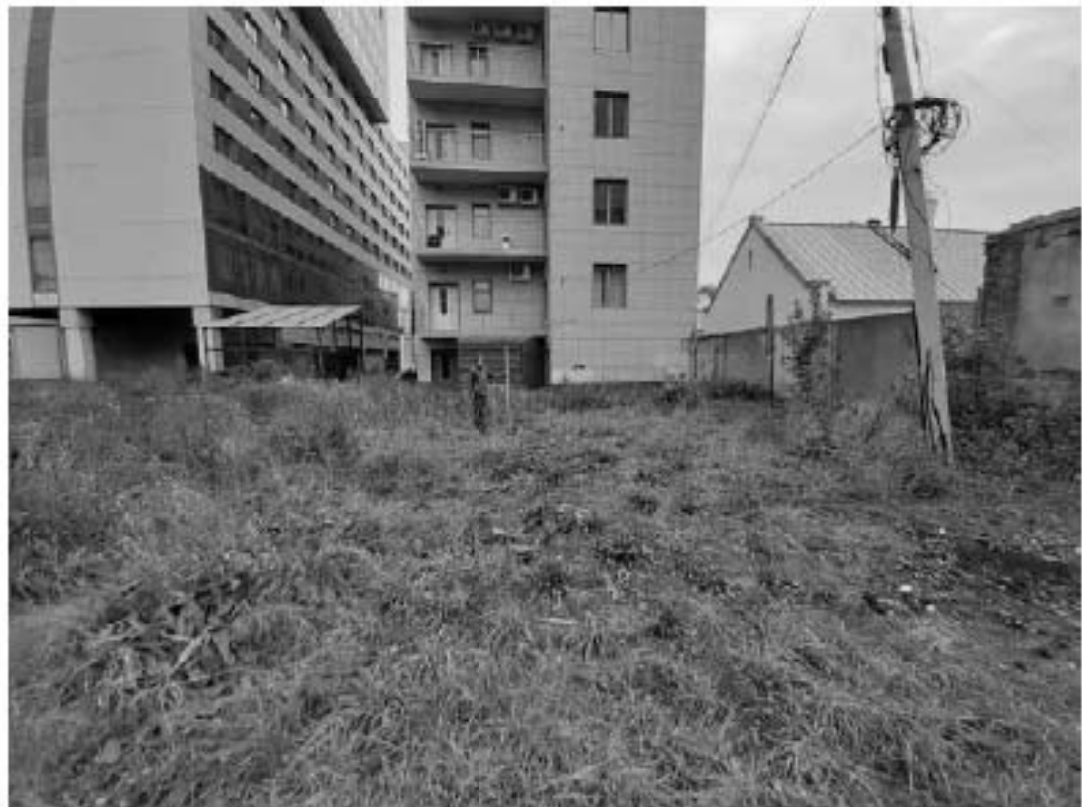
Рис. 144 Санкт-Петербург, «Строительство Красносельско-Калининской линии от станции «Казаковская» до станции «Обводный канал-2» с электродепо «Красносельское». Участок обследования «Строительная площадка шахты 848. Рабочий ствол». Общие виды.
