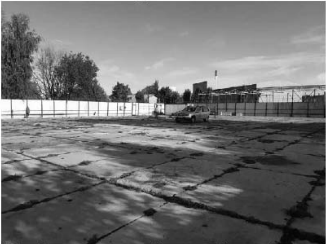
Рис. 174 Санкт-Петербург, «Строительство Красносельско-Калининской линии от станции «Казаковская» до станции «Обводный канал-2» с электродепо «Красносельское». Участок обследования «Строительная площадка шахты 849 по адресу: Московский район, Киевская ул., дом 5, литера Е». Общие виды.
