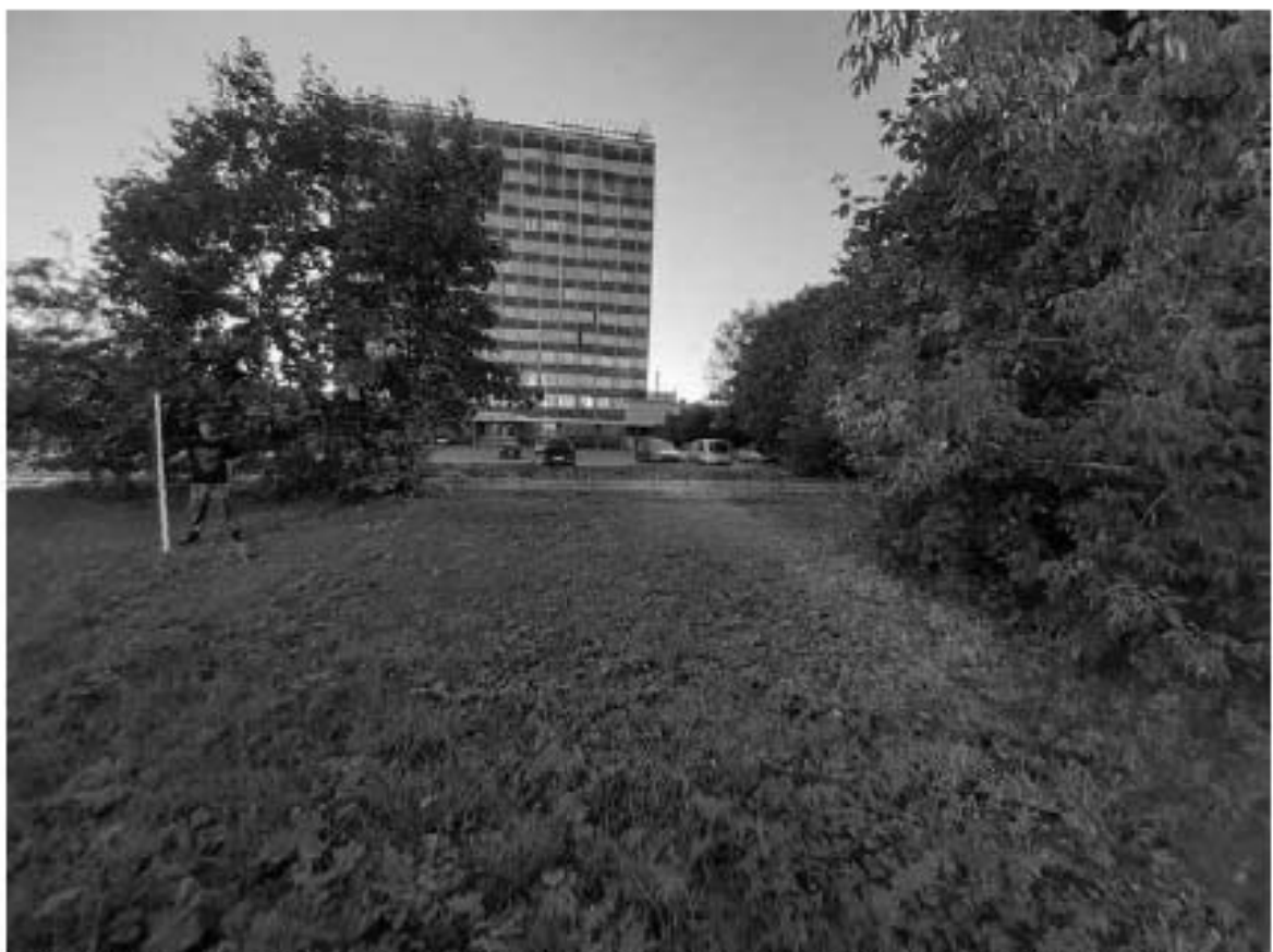
Рис. 68 Санкт-Петербург, «Строительство Красносельско-Калининской линии от станции «Казаковская» до станции «Обводный канал-2» с электродепо «Красносельское». Участок обследования «Строительная площадка вестибюля станции «Броневая». Общие виды.
