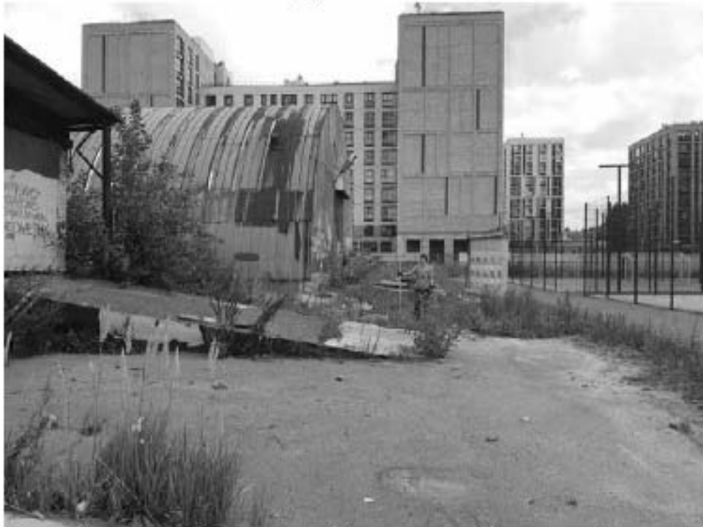
Рис. 194 Санкт-Петербург, «Строительство Красносельско-Калининской линии от станции «Казаковская» до станции «Обводный канал-2» с электродепо «Красносельское». Участок обследования «Строительная площадка вестибюля № 2 станции «Боровая». Строительная площадка шахты № 850 по адресу: Фрунзенский район, Лиговский проспект, дом 26, литера И». Общие виды.
