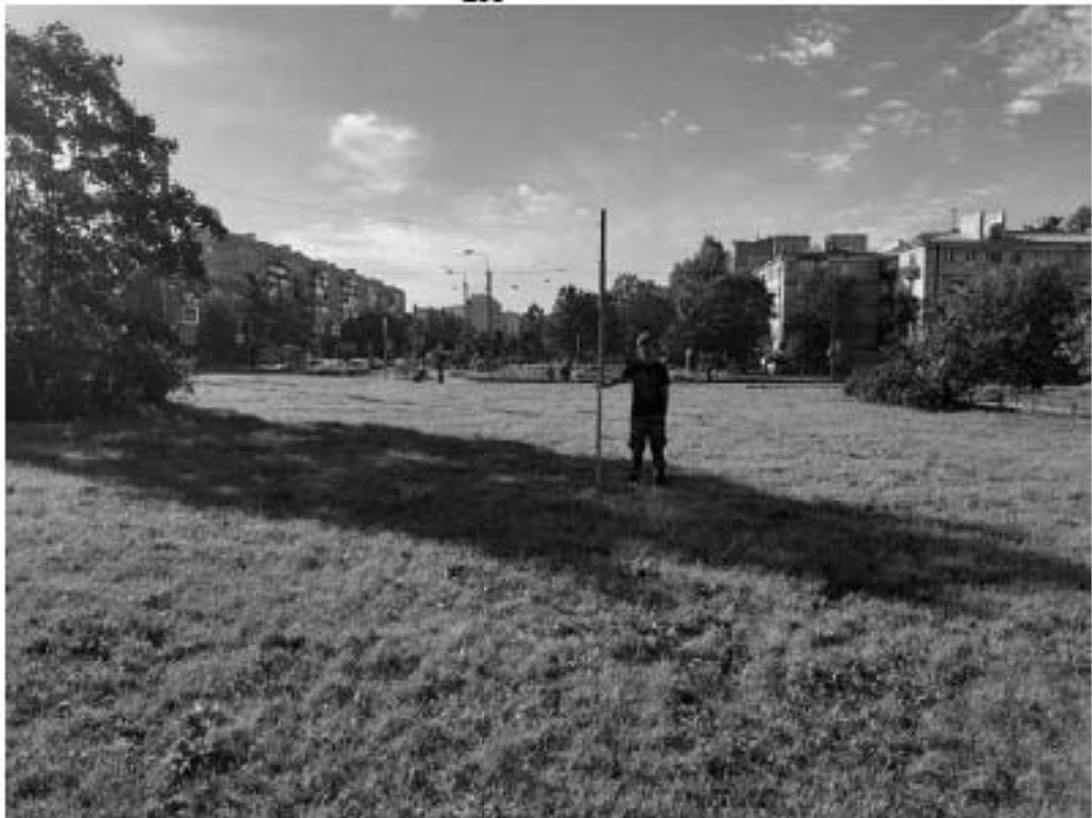
Рис. 75. Санкт-Петербург, «Строительство Красносельско-Калининской линии от станции «Казаковская» до станции «Обводный канал-2» с электродепо «Красносельское». Участок обследования «Строительная площадка вестибюля станции «Броневая». Шурф 1. Фотофиксация до начала работ. Вид на юг.
