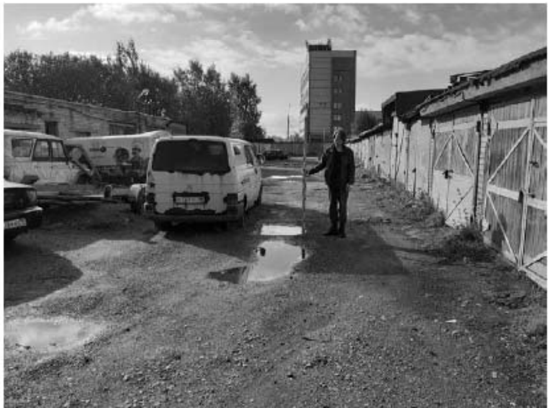
Рис. 35. Санкт-Петербург, «Строительство Красносельско-Калининской линии от станции «Казаковская» до станции «Обводный канал-2» с электродепо «Красносельское». Участок обследования «Строительная площадка шахты №846. Рабочий ствол, Строительная площадка вестибюля №1 станции «Бронева»» Общие виды.
