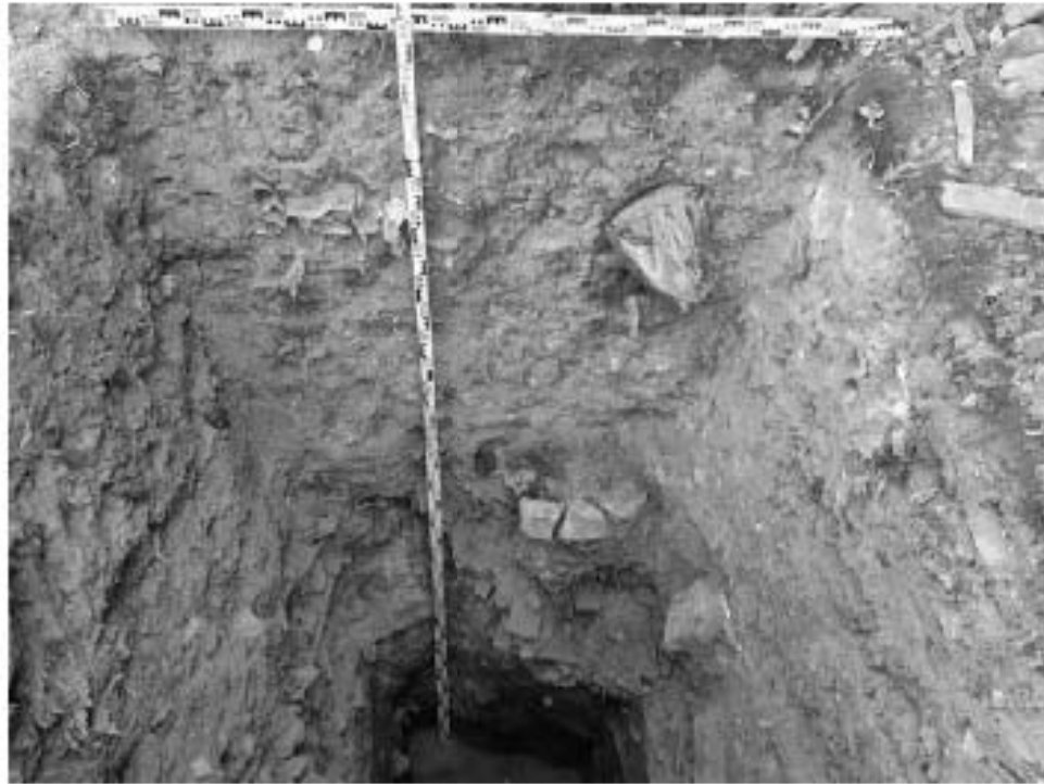
Рис. 58. Санкт-Петербург, «Строительство Красносельско-Калининской линии от станции «Казакская» до станции «Обводный канал-2» с электродепо «Красносельское». Участок обследования «Строительная площадка шахты №846. Рабочий ствол; Строительная площадка вестибюля №1 станции «Броневая»». Шурф 1. Фотофиксация стратиграфии южной стенки.
