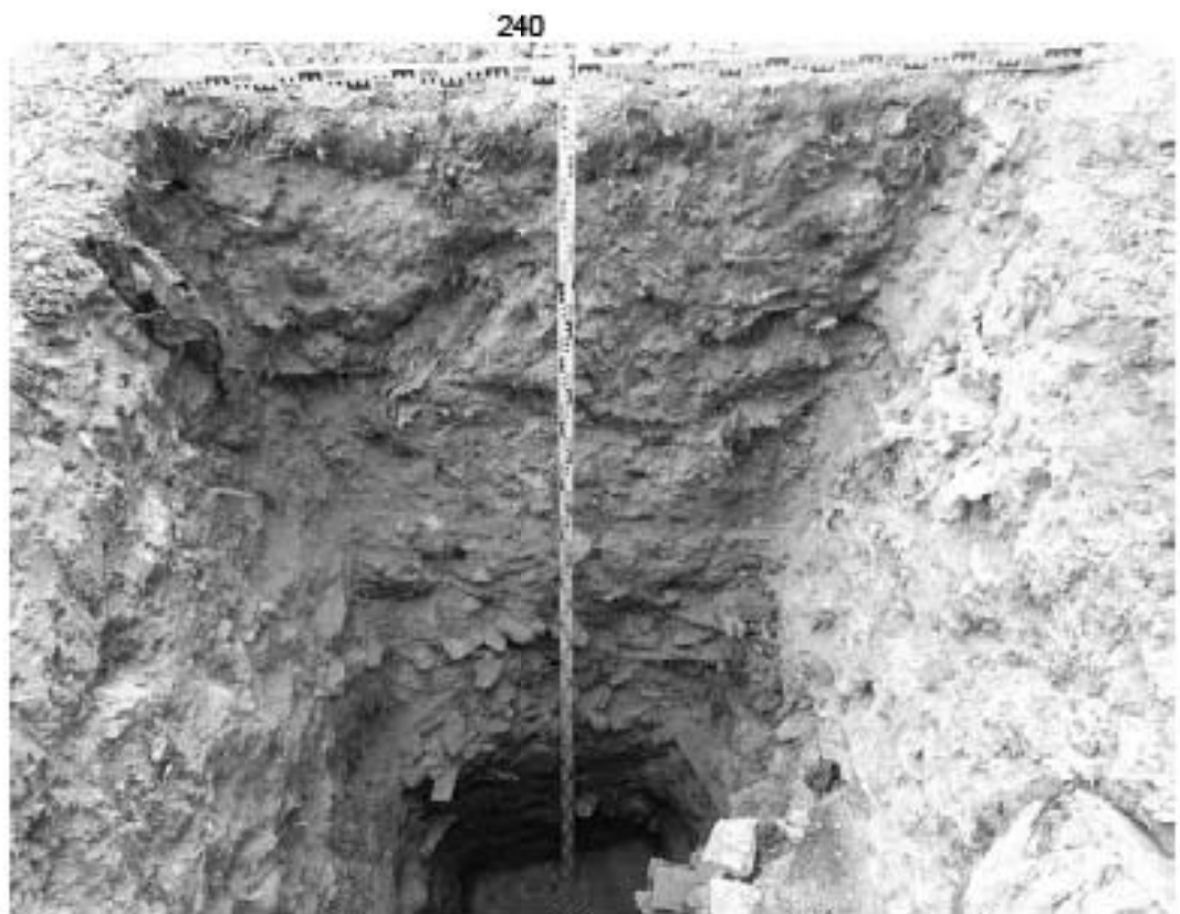
Рис. 53. Санкт-Петербург, «Строительство Красносельско-Калининской линии от станции «Казаковская» до станции «Обводный канал-2» с электродепо «Красносельское». Участок обследования «Строительная площадка шахты №846. Рабочий ствол; Строительная площадка вестибюля №1 станции «Броневая»». Шурф 1. Фотофиксация стратиграфии восточной стенки.
