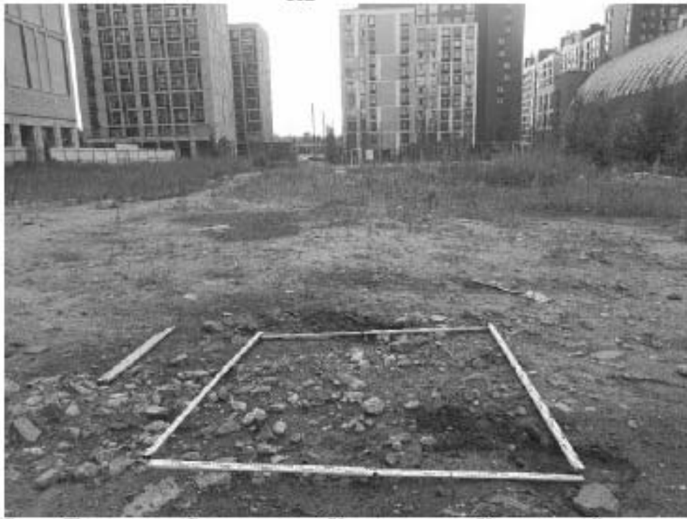
Рис. 203 Санкт-Петербург, «Строительство Красносельско-Калининской линии от станции «Казаковская» до станции «Обводный канал-2» с электродепо «Красносельское». Участок обследования «Строительная площадка вестибюля № 2 станции «Боровая». Строительная площадка шахты № 850 по адресу: Фрунзенский район, Лиговский проспект, дом 26, литера И». Шурф 1. Фотофиксация дневной поверхности до начала работ. Вид на северо-восток.
