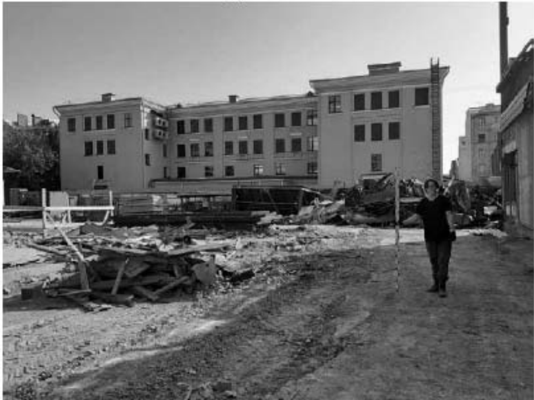
Рис. 287 Санкт-Петербург. «Строительство Красносельско-Калининской линии от станции «Казакская» до станции «Обводный канал-2» с электродепо «Красносельское». Участок от станции «Путиловская» до станции «Каретная». Участок обследования «Строительная площадка шахты 852 по адресу: Фрунзенский район, западнее здания по адресу ул. Тамбовская, дом 17, литер Б». Общие виды.
