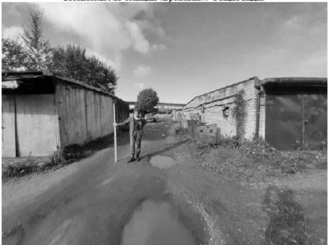
Рис. 37. Санкт-Петербург, «Строительство Красносельско-Калининской линии от станции «Казаковская» до станции «Обводный канал-2» с электродепо «Красносельское». Участок обследования «Строительная площадка шахты №846. Рабочий ствол, Строительная площадка вестибюля №1 станции «Бронева»» Общие виды.
