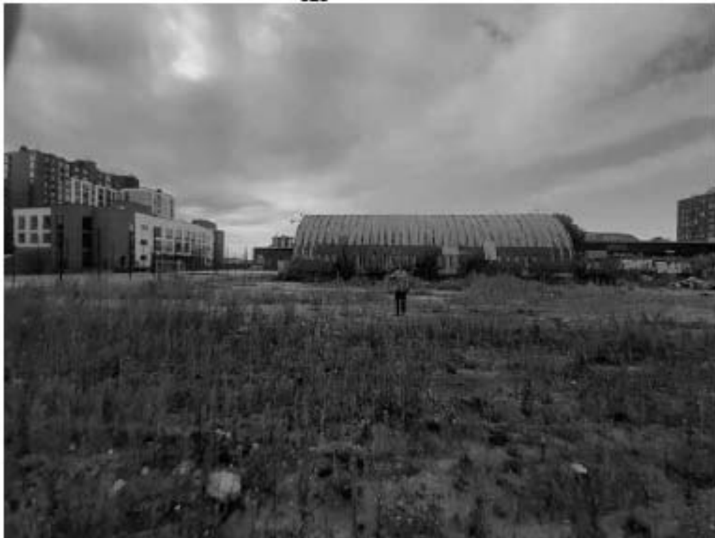
Рис. 190. Санкт-Петербург, «Строительство Красносельско-Калининской линии от станции «Казаковская» до станции «Обводный канал-2» с электродепо «Красносельское». Участок обследования «Строительная площадка вестибюля № 2 станции «Боровая». Строительная площадка шахты № 850 по адресу: Фрунзенский район, Лиговский проспект, дом 26, литера И». Общие виды.
