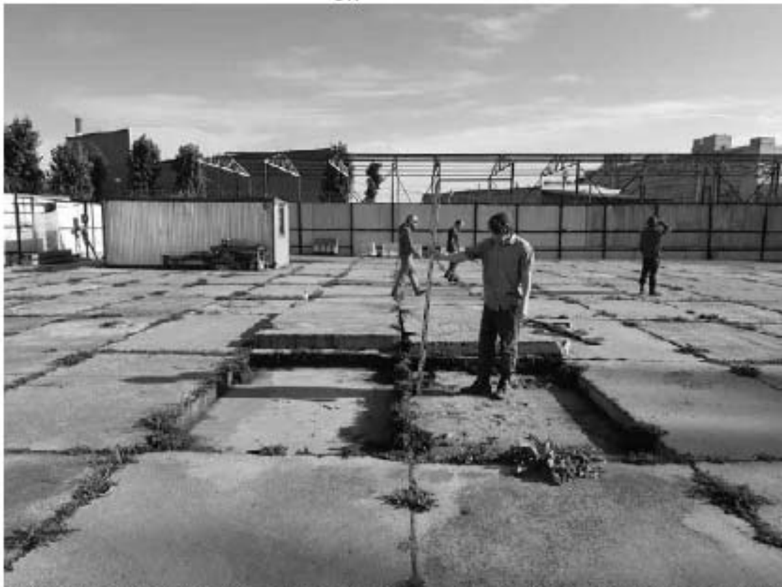
Рис. 176. Санкт-Петербург, «Строительство Красносельско-Калининской линии от станции «Казаковская» до станции «Обводный канал-2» с электродепо «Красносельское». Участок обследования «Строительная площадка шахты 849 по адресу: Московский район, Киевская ул., дом 5, литера Е». Шурф 1. Фотофиксация до начала работ. Вид на северо-восток.
