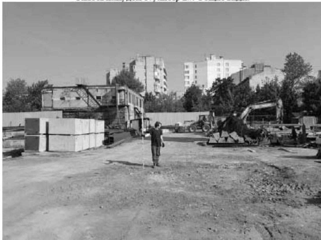
Рис. 286 Санкт-Петербург. «Строительство Красносельско-Калининской линии от станции «Казиковская» до станции «Обводный канал-2» с электродепо «Красносельское». Участок от станции «Путиловская» до станции «Каретная». Участок обследования «Строительная площадка шахты 852 по адресу: Фрунзенский район, западнее здания по адресу ул. Тамбовская, дом 17, литер Б». Общие виды.
