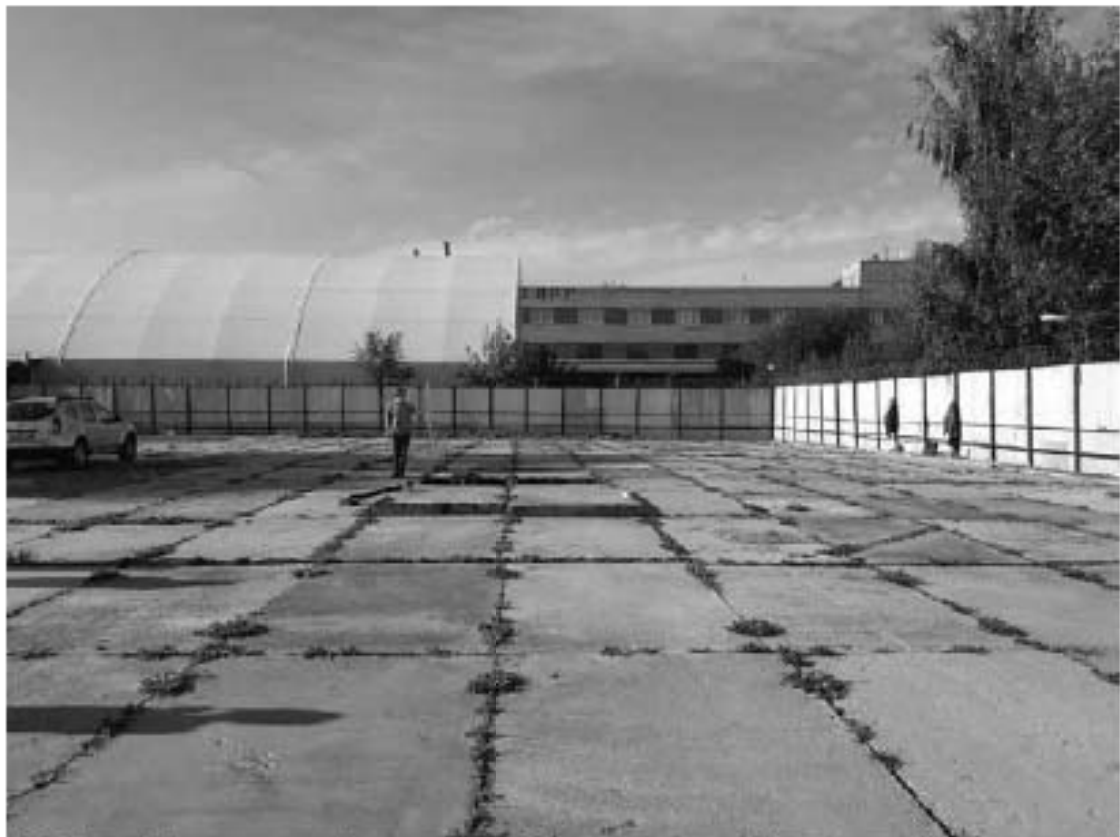
Рис. 171 Санкт-Петербург, «Строительство Красносельско-Калининской линии от станции «Казаковская» до станции «Обводный канал-2» с электродепо «Красносельское». Участок обследования «Строительная площадка шахты 849 по адресу: Московский район, Киевская ул., дом 5, литера Е». Общие виды.
