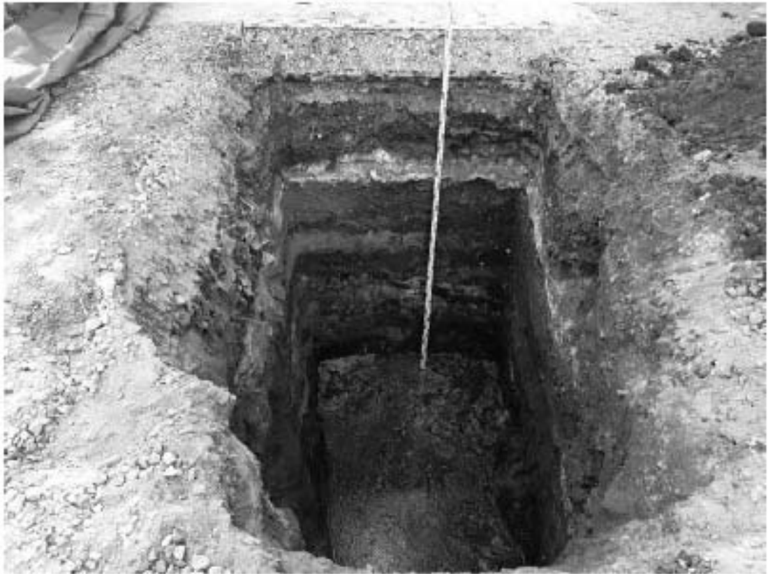
Рис. 293. Санкт-Петербург. «Строительство Красносельско-Калининской линии от станции «Казаковская» до станции «Обводный канал-2» с электродепо «Красносельское». Участок от станции «Путиловская» до станции «Каретная». Участок обследования «Строительная площадка шахты 852 по адресу: Фрунзенский район, западнее здания по адресу ул. Тамбовская, дом 17, литер Б». Шурф 1. Фотофиксация по серовато-коричневому песку (материк), затопленному грунтовыми водами. Вид на юго-запад.
