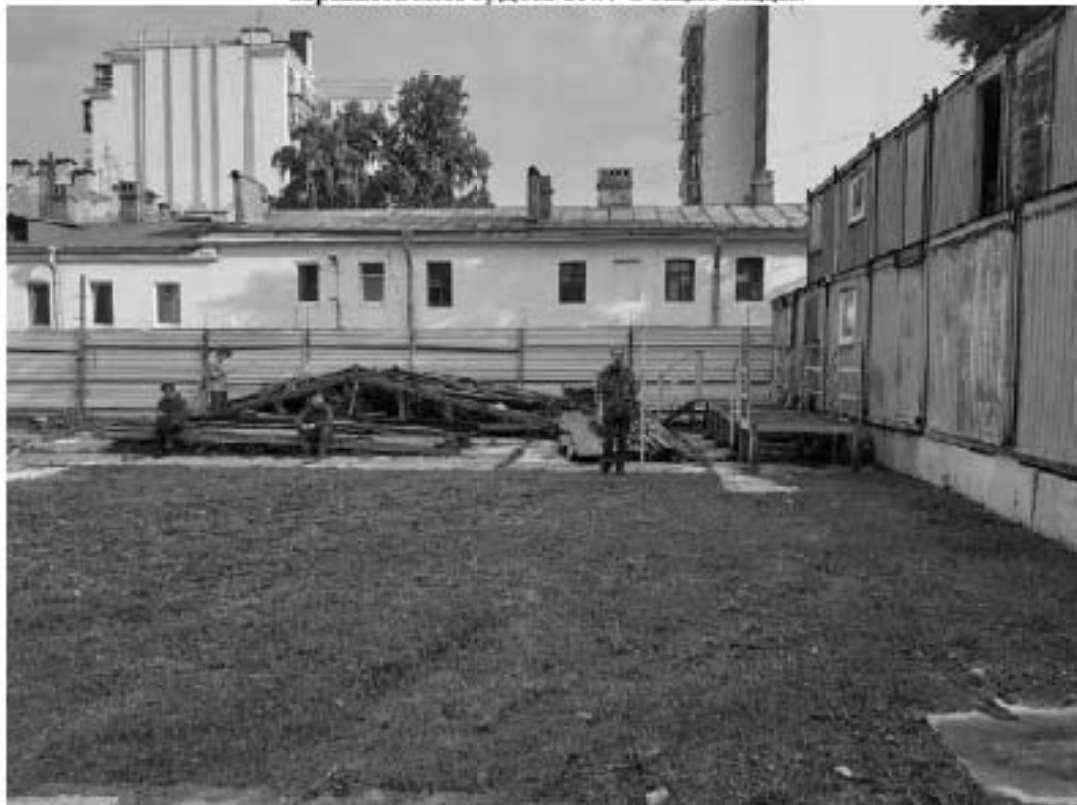
Рис. 306 Санкт-Петербург. «Строительство Красносельско-Калининской линии от станции «Казаконская» до станции «Обводный канал-2» с электродепо «Красносельское». Участок от станции «Путиловская» до станции «Каретная». Участок обследования «Строительная площадка шахты №853 по адресу: Центральный район, южнее здания по адресу ул. Черняховского, дом 19». Общие виды.
