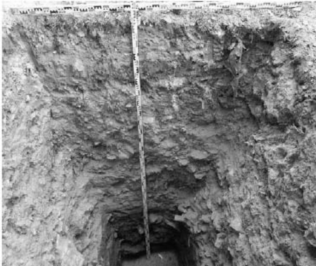
Рис. 55 Санкт-Петербург, «Строительство Красносельско-Калининской линии от станции «Казаковская» до станции «Обводный канал-2» с электродепо «Красносельское». Участок обследования «Строительная площадка шахты №846. Рабочий ствол; Строительная площадка вестибюля №1 станции «Броневая»». Шурф 1. Фотофиксация стратиграфии северной стенки.
