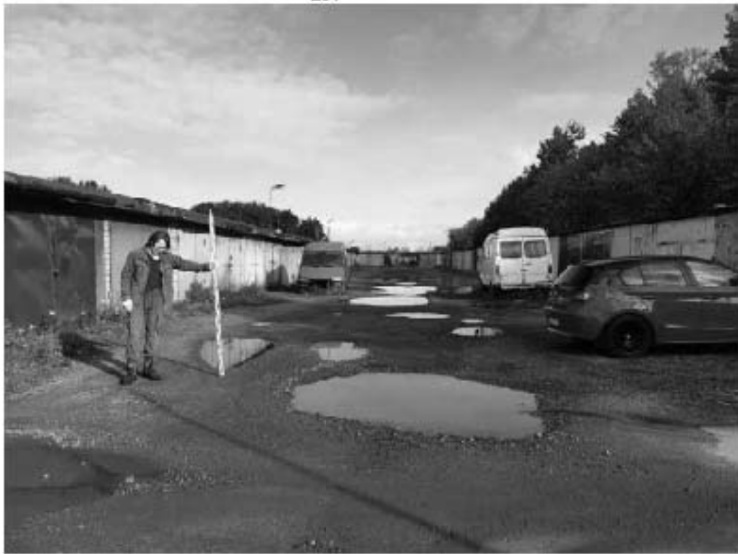
Рис. 36 Санкт-Петербург, «Строительство Красносельско-Калининской линии от станции «Казаковская» до станции «Обводный канал-2» с электродепо «Красносельское». Участок обследования «Строительная площадка шахты №846. Рабочий ствол, Строительная площадка вестибюля №1 станции «Бронева»» Общие виды.
