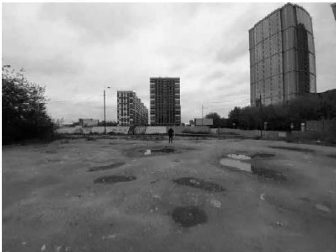
Рис. 118. Санкт-Петербург, «Строительство Красносельско-Калининской линии от станции «Кзаковская» до станции «Обводный канал-2» с электродепо «Красносельское». Участок обследования «Строительная площадка вестибюля №1 станции «Черниговская». Общие виды.
