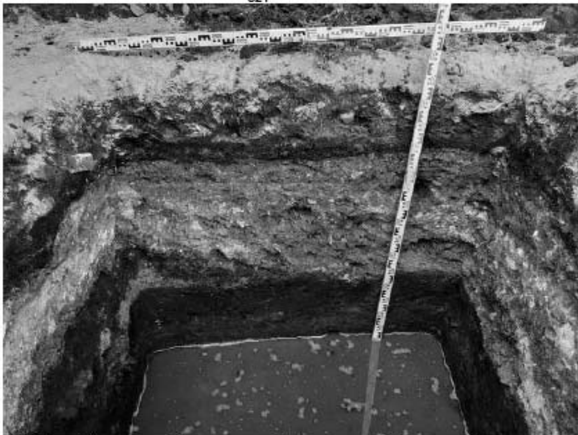
Рис. 184 Санкт-Петербург, «Строительство Красносельско-Калининской линии от станции «Казаковская» до станции «Обводный канал-2» с электродепо «Красносельское». Участок обследования «Строительная площадка шахты 849 по адресу: Московский район, Киевская ул., дом 5, литера Е». Шурф 1. Фотофиксация стратиграфии юго-западной стенки.
