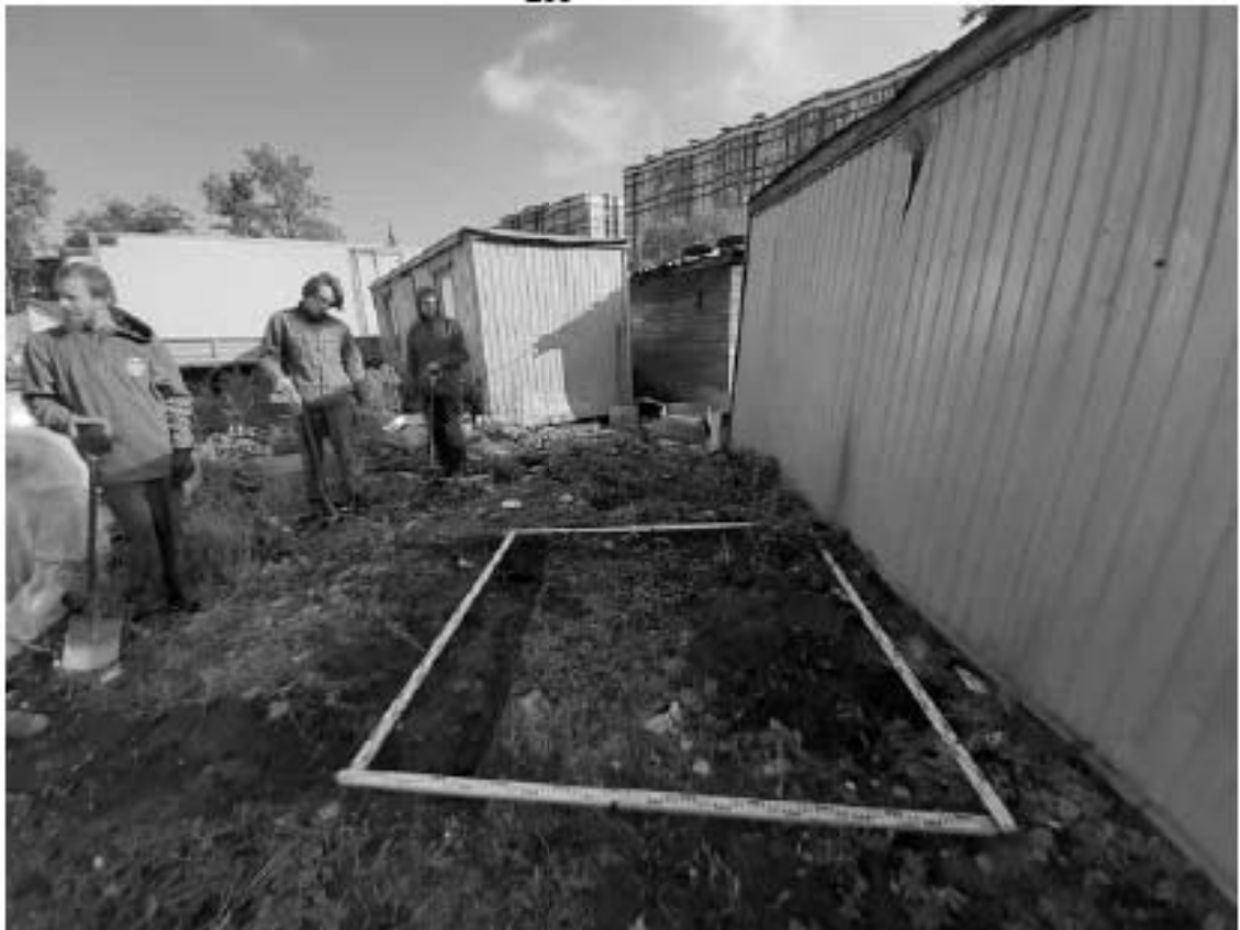
Рис. 97. Санкт-Петербург, «Строительство Красносельско-Калининской линии от станции «Казакская» до станции «Обводный канал-2» с электродепо «Красносельское». Участок обследования «Строительная площадка шахты 847. Рабочий ствол». Шурф 1. Фотофиксация до начала работ. Общий вид на север.
