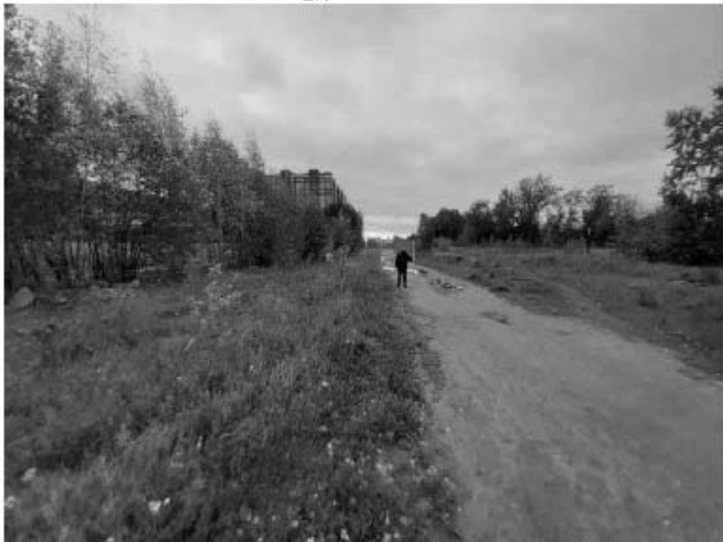
Рис. 115 Санкт-Петербург, «Строительство Красносельско-Калининской линии от станции «Казаковская» до станции «Обводный канал-2» с электродепо «Красносельское». Участок обследования «Строительная площадка вестибюля №1 станции «Черниговская». Общие виды.
