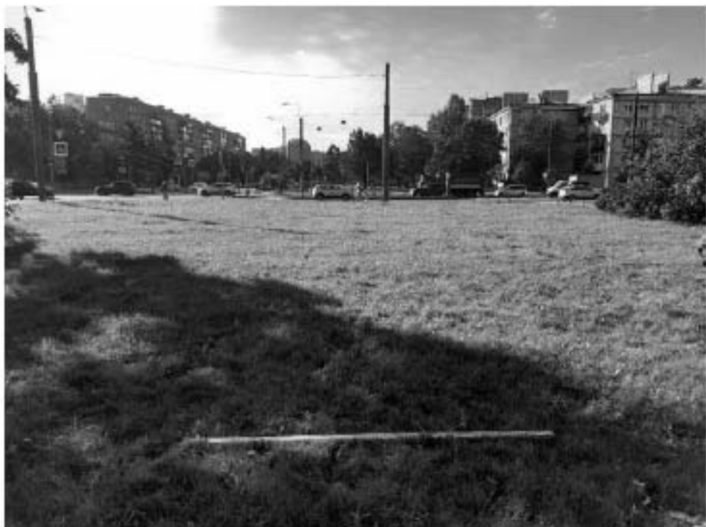
Рис. 76 Санкт-Петербург, «Строительство Красносельско-Калининской линии от станции «Казаковская» до станции «Обводный канал-2» с электродепо «Красносельское». Участок обследования «Строительная площадка вестибюля станции «Броневая». Шурф 1. Фотофиксация дневной поверхности до начала работ. Вид на юг.
