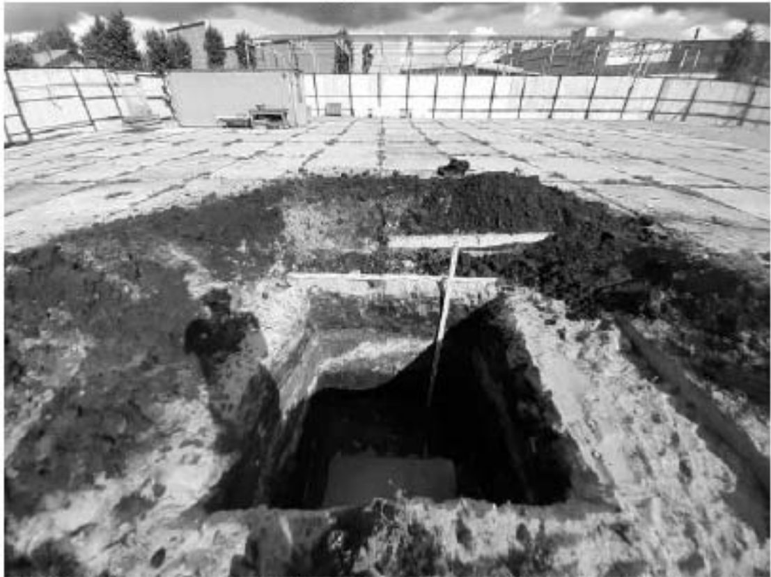
Рис. 186 Санкт-Петербург, «Строительство Красносельско-Калининской линии от станции «Казаковская» до станции «Обводный канал-2» с электродепо «Красносельское». Участок обследования «Строительная площадка шахты 849 по адресу: Московский район, Киевская ул., дом 5, литера Е». Шурф 1. Фотофиксация после окончания работ. Общий вид на северо-восток.
