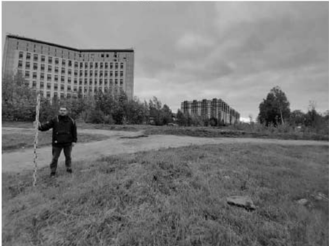
Рис. 109. Санкт-Петербург, «Строительство Красносельско-Калининской линии от станции «Казаковская» до станции «Обводный канал-2» с электродепо «Красносельское». Участок обследования «Строительная площадка вестибюля №1 станции «Черниговская». Общие виды.
