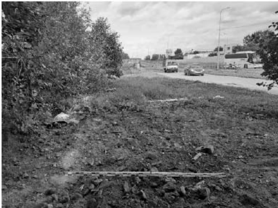
Рис. 64. Санкт-Петербург, «Строительство Красносельско-Калининской линии от станции «Казаковская» до станции «Обводный канал-2» с электродепо «Красносельское». Участок обследования «Строительная площадка шахты №846. Рабочий ствол; Строительная площадка вестибюля №1 станции «Броневая»». Шурф 1. Фотофиксация после рекультивации. Вид на север.
