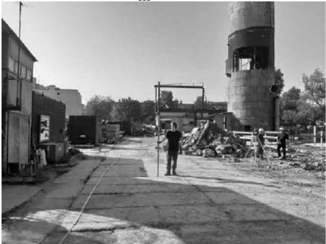
Рис. 289 Санкт-Петербург. «Строительство Красносельско-Калининской линии от станции «Казаковская» до станции «Обводный канал-2» с электродепо «Красносельское». Участок от станции «Путиловская» до станции «Каретная». Участок обследования «Строительная площадка шахты 852 по адресу: Фрунзенский район, западнее здания по адресу ул. Тамбовская, дом 17, литер Б». Общие виды.
