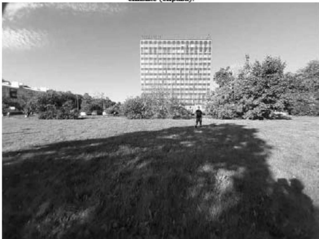
Рис. 66. Санкт-Петербург, «Строительство Красносельско-Калининской линии от станции «Казакowsкая» до станции «Обводный канал-2» с электродепо «Красносельское». Участок обследования «Строительная площадка вестибюля станции «Бронева». Общие виды.
