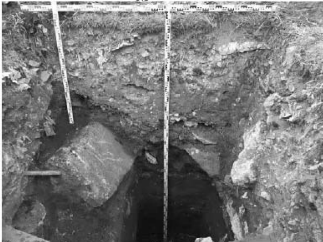
Рис. 165 Санкт-Петербург, «Строительство Красносельско-Калининской линии от станции «Казаковская» до станции «Обводный канал-2» с электродепо «Красносельское». Участок обследования «Строительная площадка шахты 848. Рабочий ствол». Шурф 1. Фотофиксация стратиграфии западной стенки.
