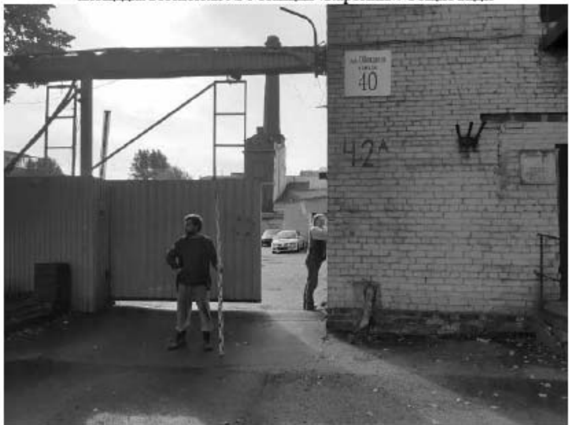
Рис. 243 Санкт-Петербург. «Строительство Красносельско-Калининской линии от станции «Казаковская» до станции «Обводный канал-2» с электродепо «Красносельское». Участок от станции «Путиловская» до станции «Каретная». Участок обследования «Строительная площадка вестибюля № 1 станции «Каретная». Общие виды.
