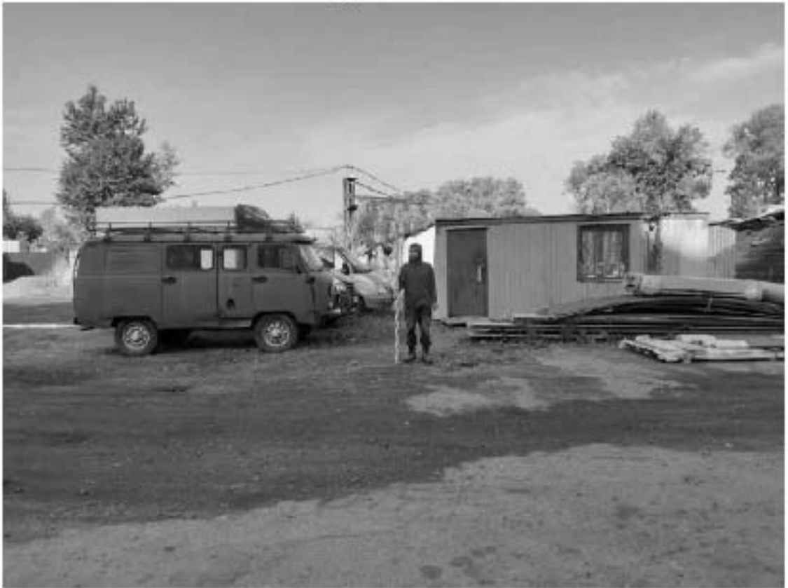
Рис. 94 Санкт-Петербург, «Строительство Красносельско-Калининской линии от станции «Казакская» до станции «Обводный канал-2» с электродепо «Красносельское». Участок обследования «Строительная площадка шахты 847. Рабочий ствол». Общие виды.
