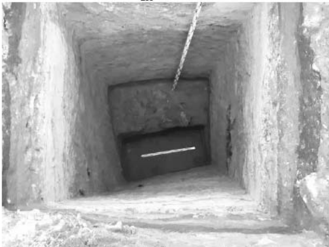
Рис. 126 Санкт-Петербург, «Строительство Красносельско-Калининской линии от станции «Казаковская» до станции «Обводный канал-2» с электродепо «Красносельское». Участок обследования «Строительная площадка вестибюля №1 станции «Черниговская». Шурф 1. Фотофиксация по материковой поверхности (Светло-серый песок). Вид на восток.
