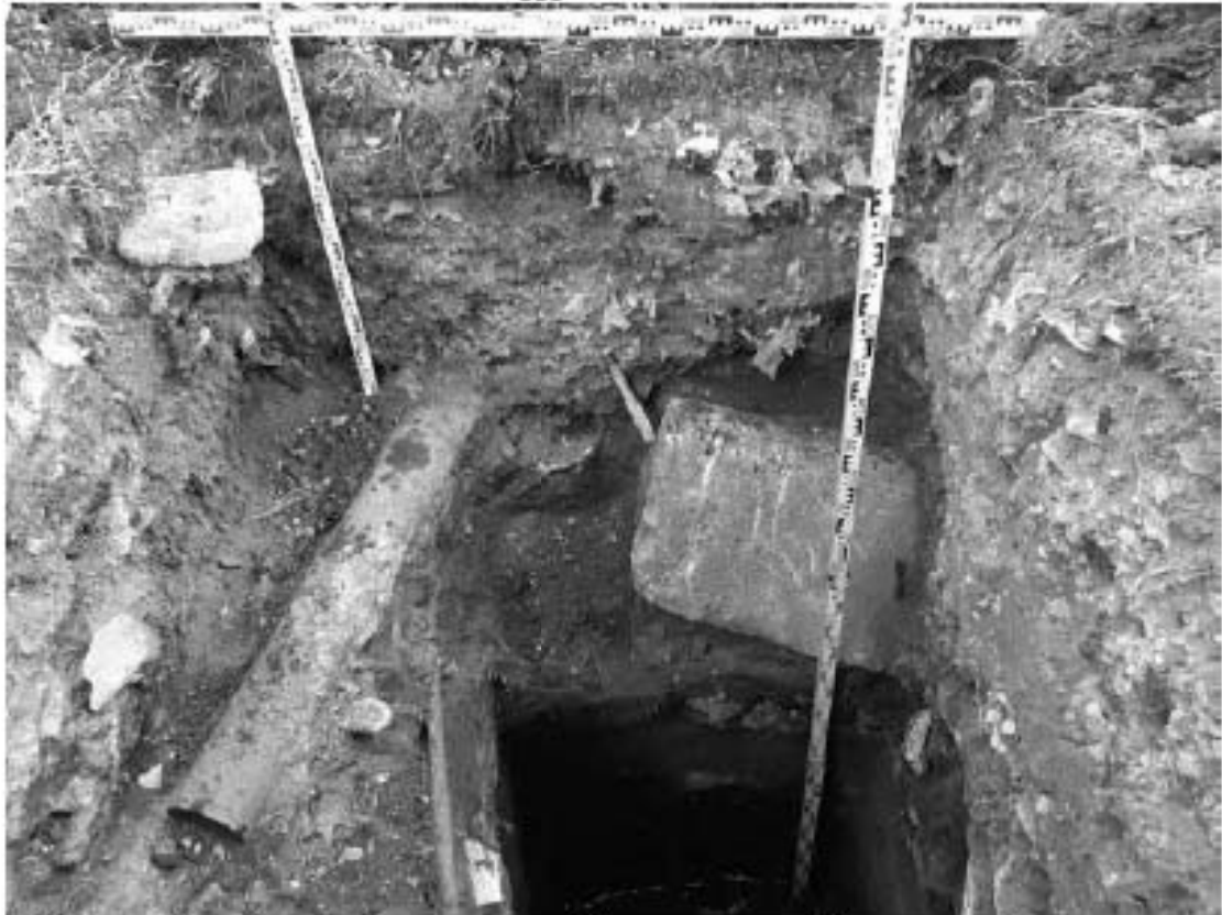
Рис. 163 Санкт-Петербург, «Строительство Красносельско-Калининской линии от станции «Казаковская» до станции «Обводный канал-2» с электродепо «Красносельское». Участок обследования «Строительная площадка шахты 848. Рабочий ствол». Шурф 1. Фотофиксация стратиграфии южной стенки.
