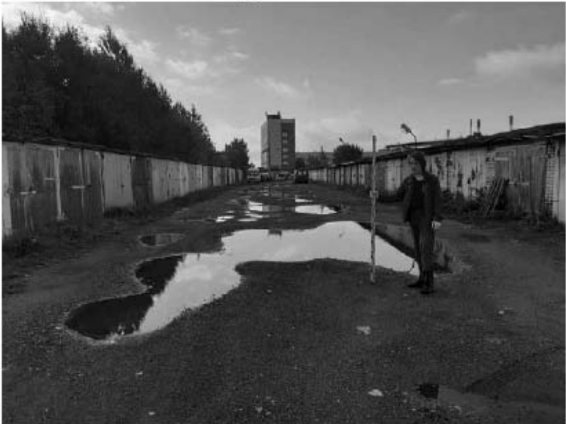
Рис. 44. Санкт-Петербург, «Строительство Красносельско-Калининской линии от станции «Казакская» до станции «Обводный канал-2» с электродепо «Красносельское». Участок обследования «Строительная площадка шахты №846. Рабочий ствол; Строительная площадка вестибюля №1 станции «Броневая»» Общие виды.
