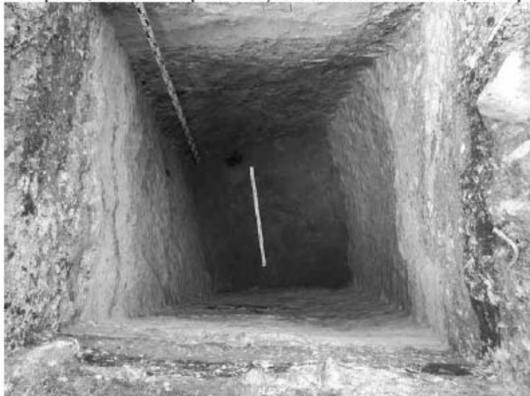
Рис. 123. Санкт-Петербург, «Строительство Красносельско-Калининской линии от станции «Казаковская» до станции «Обводный канал-2» с электродепо «Красносельское». Участок обследования «Строительная площадка вестибюля №1 станции «Черниговская». Шурф 1. Фотофиксация по темно-коричневой супеси мешаной с песком. Вид на север
