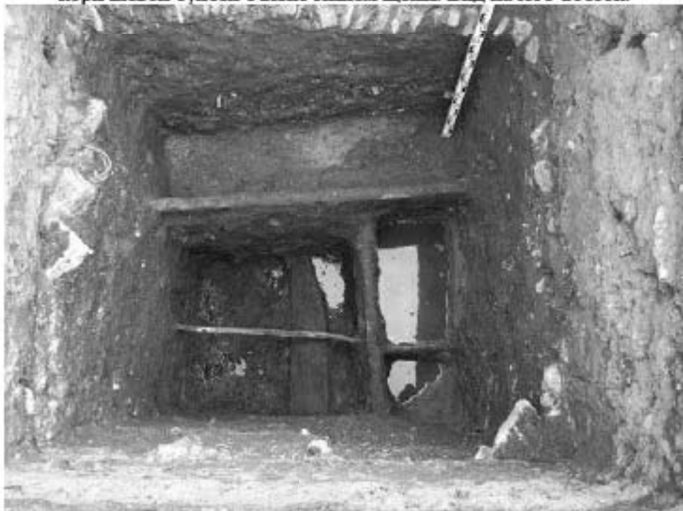
Рис. 232. Санкт-Петербург. «Строительство Красносельско-Калининской линии от станции «Казаковская» до станции «Обводный канал-2» с электродепо «Красносельское». Участок от станции «Путиловская» до станции «Каретная». Участок обследования «Строительная площадка шахты № 851 по адресу: Фрунзенский район, Расстанная улица на свободной территории между домами №7 и №13». Шурф 1. Фотофиксация по слою мешаной темно-коричневой супеси с включением щепы. Вид на юго-запад.
