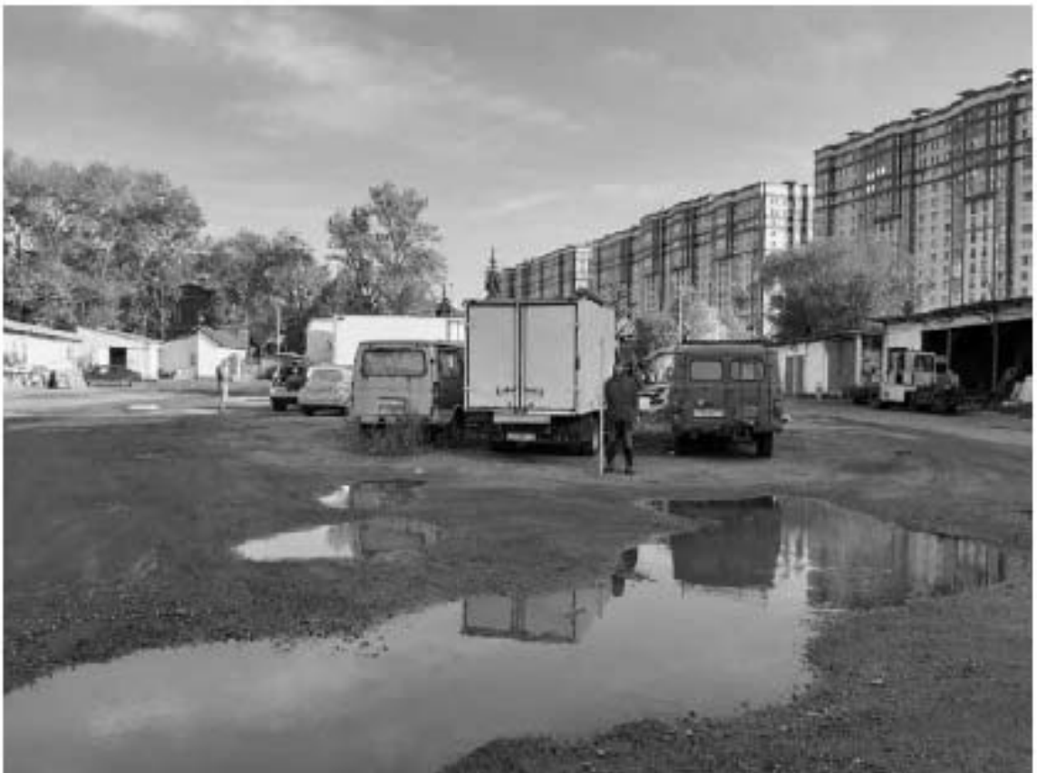
Рис. 95. Санкт-Петербург, «Строительство Красносельско-Калининской линии от станции «Казакская» до станции «Обводный канал-2» с электродепо «Красносельское». Участок обследования «Строительная площадка шахты 847. Рабочий ствол». Общие виды.
