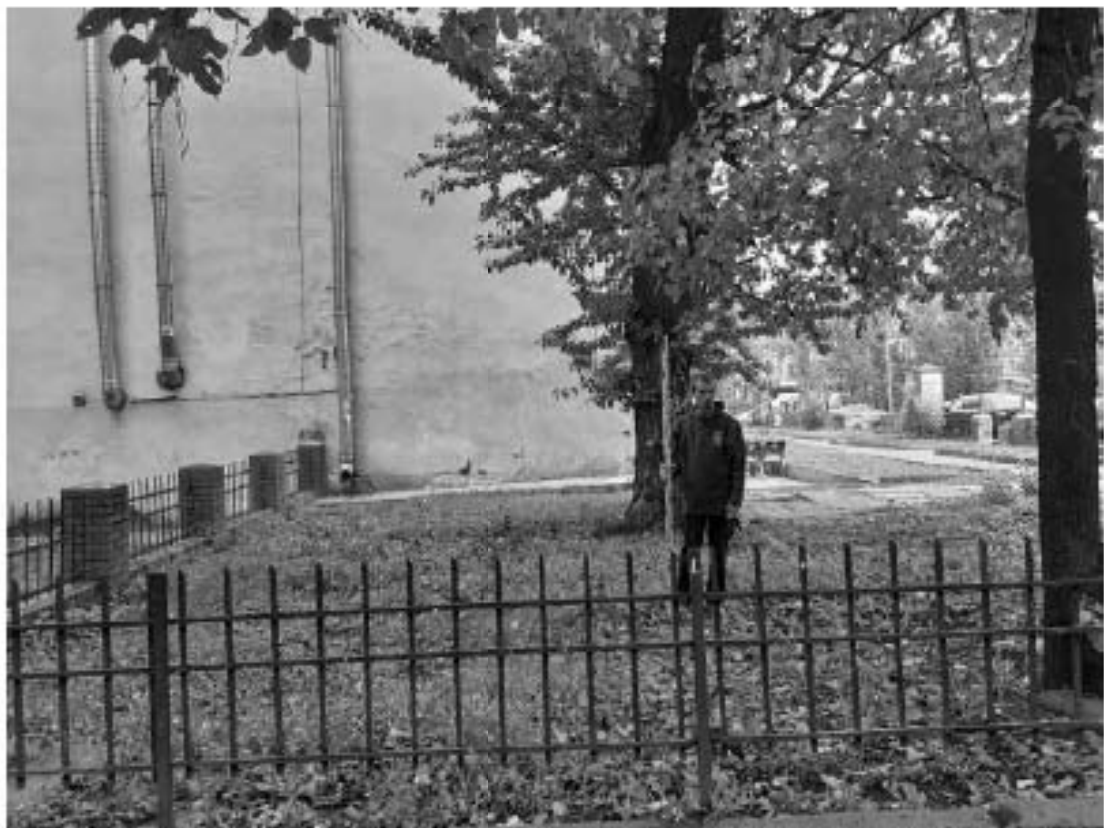
Рис. 239 Санкт-Петербург. «Строительство Красносельско-Калининской линии от станции «Казаковская» до станции «Обводный канал-2» с электродепо «Красносельское». Участок от станции «Путиловская» до станции «Каретная». Участок обследования «Строительная площадка вестибюля № 1 станции «Каретная». Общие виды
