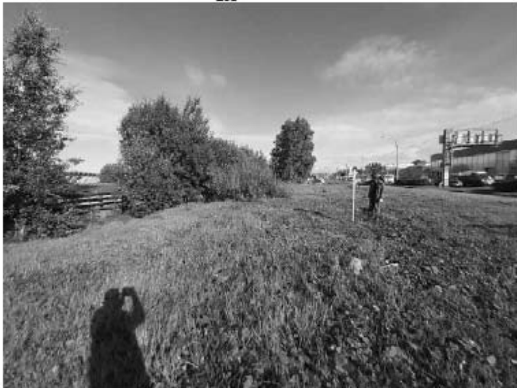
Рис. 34. Санкт-Петербург, «Строительство Красносельско-Калининской линии от станции «Казаковская» до станции «Обводный канал-2» с электродепо «Красносельское». Участок обследования «Строительная площадка шахты №846. Рабочий ствол, Строительная площадка вестибюля №1 станции «Бронева»» Общие виды.
