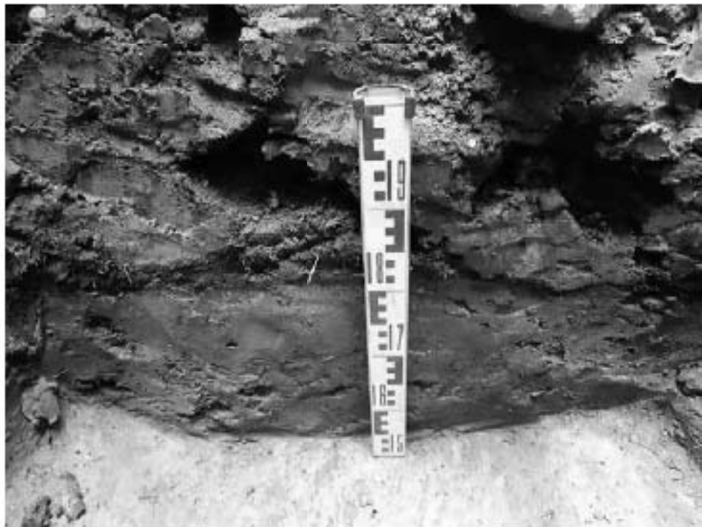
Рис. 54. Санкт-Петербург, «Строительство Красносельско-Калининской линии от станции «Казаковская» до станции «Обводный канал-2» с электродепо «Красносельское». Участок обследования «Строительная площадка шахты №846. Рабочий ствол; Строительная площадка вестибюля №1 станции «Броневая»». Шурф 1. Фотофиксация стратиграфии нижней части восточной стенки.
