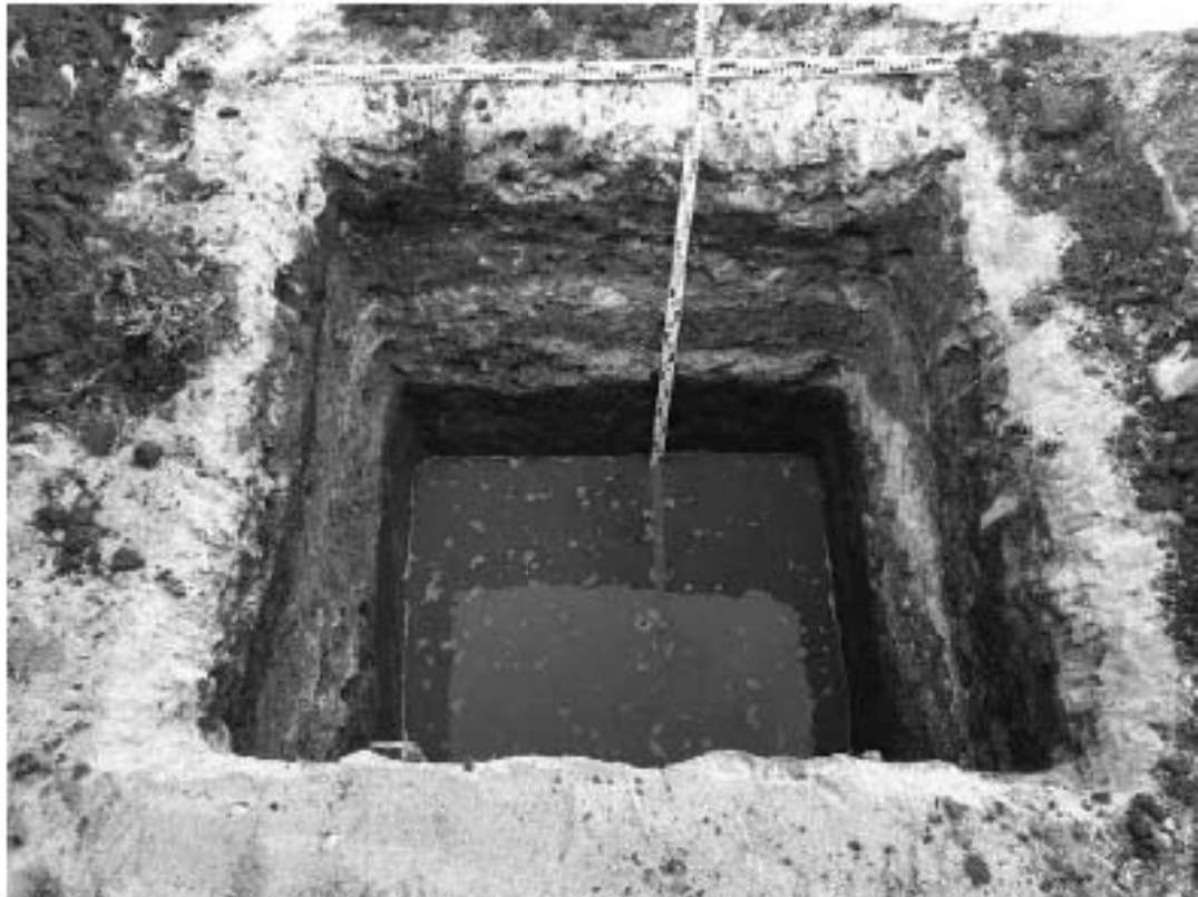
Рис. 180. Санкт-Петербург, «Строительство Красносельско-Калининской линии от станции «Казаковская» до станции «Обводный канал-2» с электродепо «Красносельское». Участок обследования «Строительная площадка шахты 849 по адресу: Московский район, Киевская ул., дом 5, литера Е». Шурф 1. Фотофиксация по светло-серой супеси затопленной грунтовыми водами. Вид на северо-запад.
