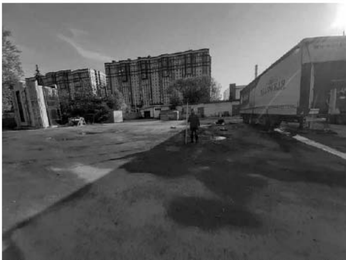
Рис. 91. Санкт-Петербург, «Строительство Красносельско-Калининской линии от станции «Казакоская» до станции «Обводный канал-2» с электродепо «Красносельское». Участок обследования «Строительная площадка шахты 847. Рабочий ствол». Общие виды.
