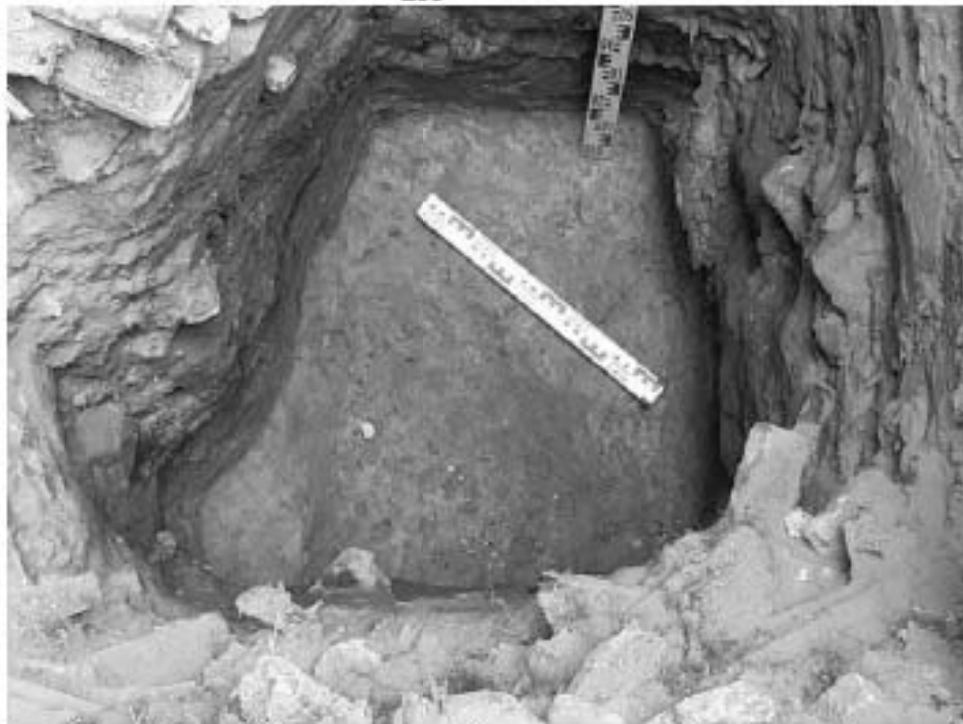
Рис. 51. Санкт-Петербург, «Строительство Красносельско-Калининской линии от станции «Казакская» до станции «Обводный канал-2» с электродепо «Красносельское». Участок обследования «Строительная площадка шахты №846. Рабочий ствол; Строительная площадка вестибюля №1 станции «Броневая»». Шурф 1. Фотофиксация материковой поверхности (светло-серый суглинок). Вид на запад.
