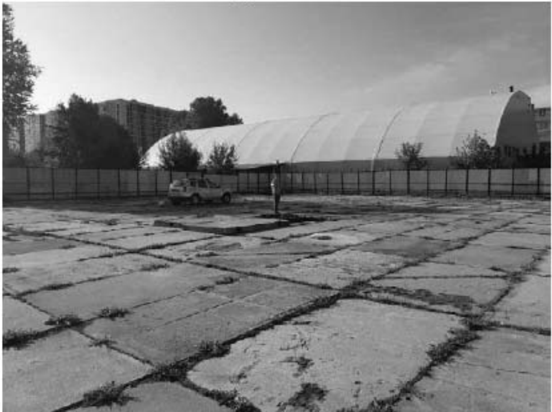
Рис. 172 Санкт-Петербург, «Строительство Красносельско-Калининской линии от станции «Казаковская» до станции «Обводный канал-2» с электродепо «Красносельское». Участок обследования «Строительная площадка шахты 849 по адресу: Московский район, Киевская ул., дом 5, литера Е». Общие виды.
