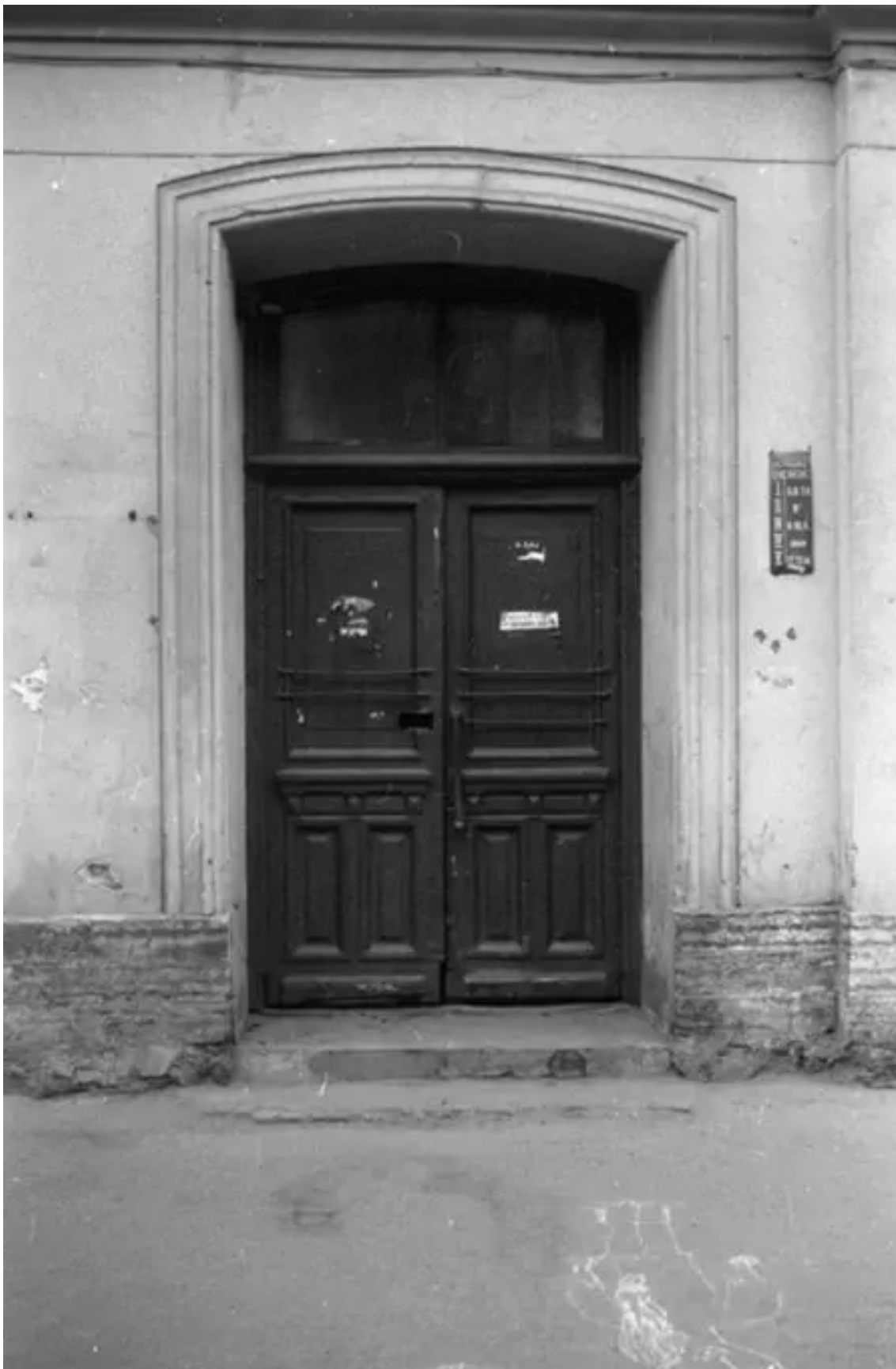
7. г. Санкт-Петербург, ул. Смольячкова, д. 15-17, литера А. Доходный дом Б.Е. Фурмана. Лицевой фасад. Парадный вход (левый). Общий вид. 1998 // Личный архив С.В. Доспехова
