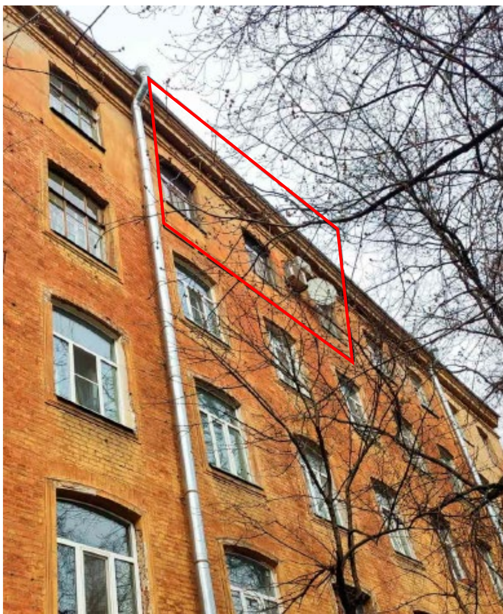
3. Оконные заполнения кв. №69 в уровне 5-го этажа дворового фасада выявленного объекта культурного наследия «Дом Б.Е. Фурмана», расположенного по адресу: г. Санкт-Петербург, ул. Смольячкова, д. 15-17, литера А. 22.03.2022
