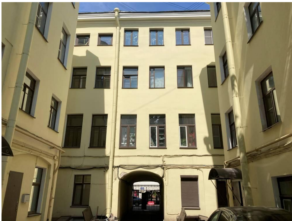
Фото 3. Фрагмент дворового фасада выявленного объекта культурного наследия «Дом Ф. Селизарова»
