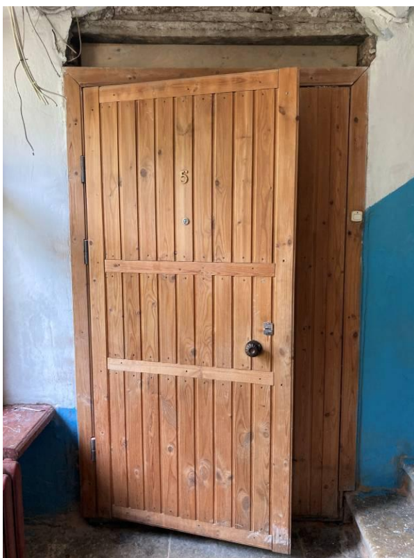
Фото 7. Интерьер квартиры № 5 выявленного объекта культурного наследия «Дом Ф. Селизарова», вход в квартиру
