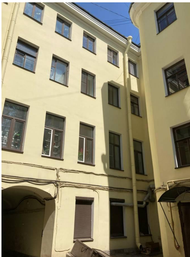
Фото 5. Фрагмент дворового фасада выявленного объекта культурного наследия «Дом Ф. Селизарова»
