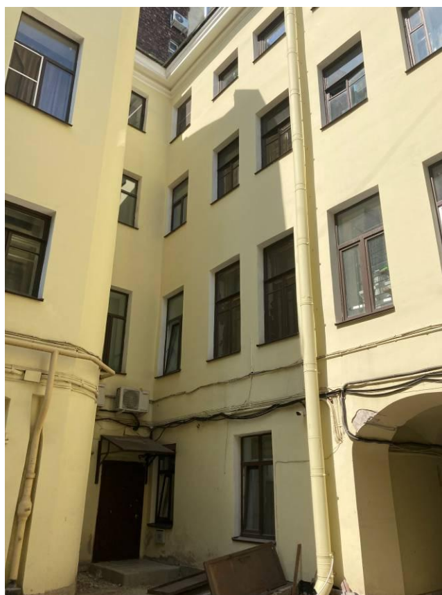
Фото 6. Фрагмент дворового фасада выявленного объекта культурного наследия «Дом Ф. Селизарова»
