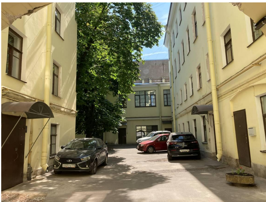
Фото 4. Фрагмент дворового фасада выявленного объекта культурного наследия «Дом Ф. Селизарова»
