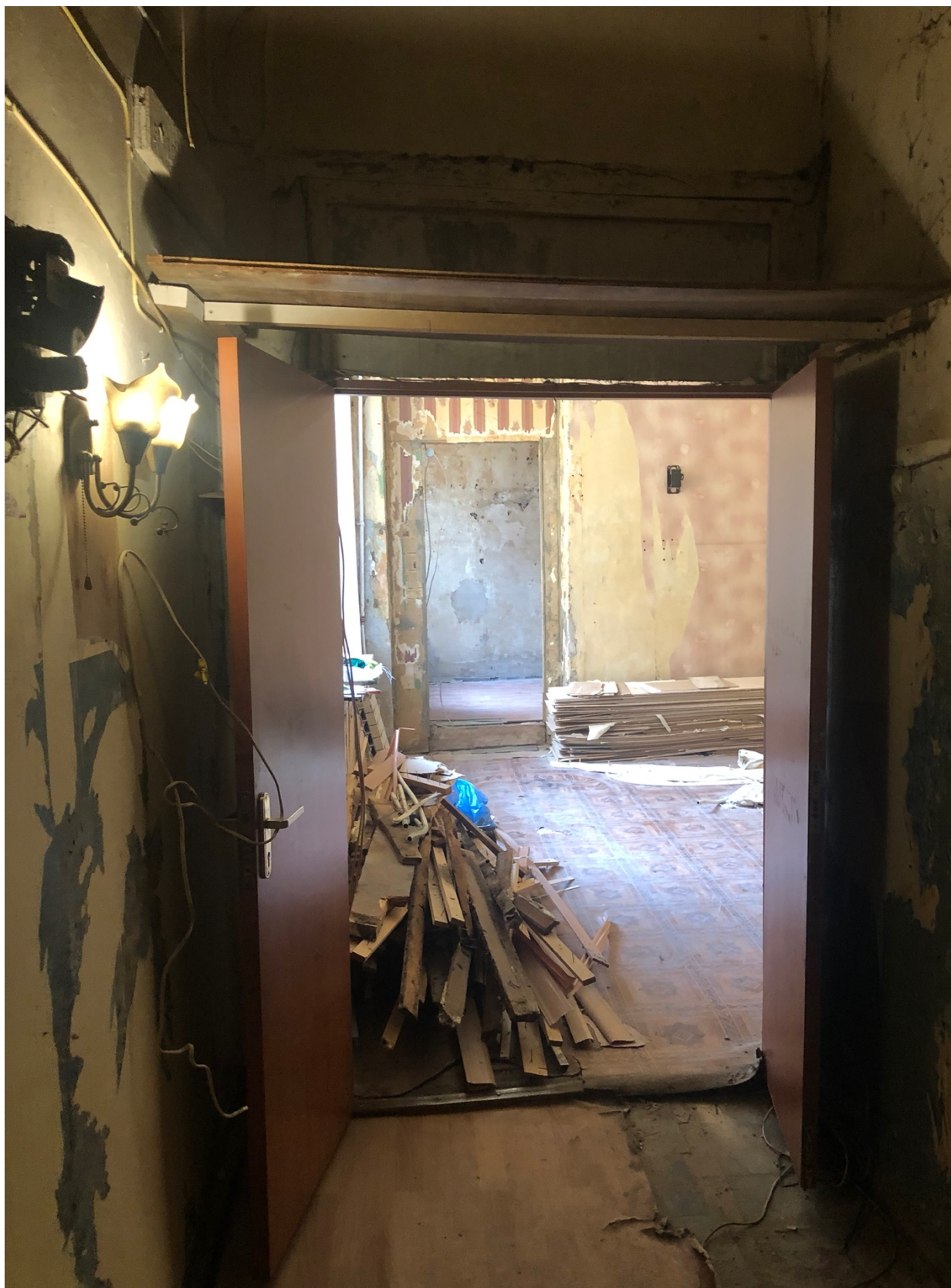
6. Фрагмент интерьера коридора (помещение 1/7.2);
