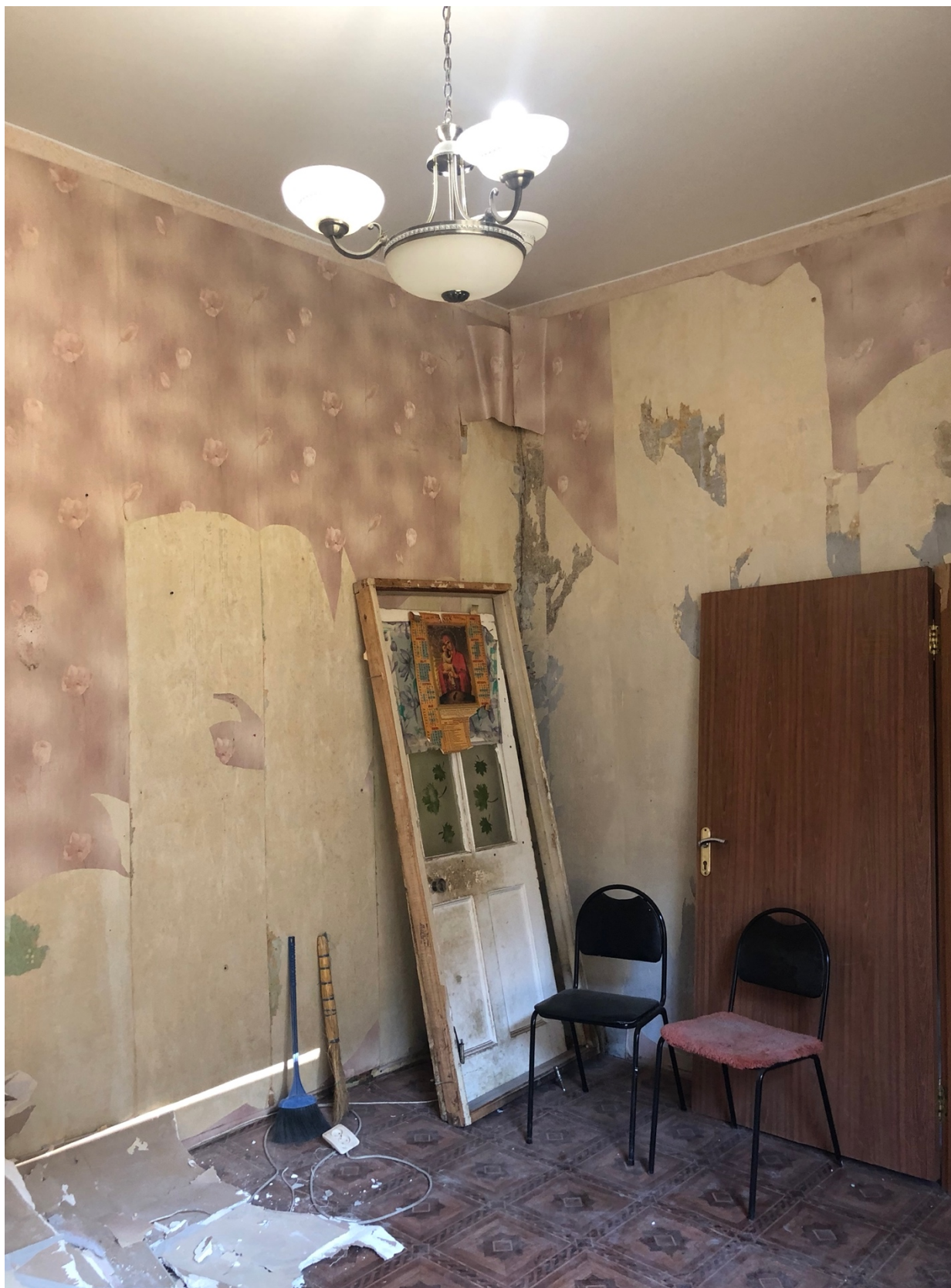
9. Фрагмент интерьера комнаты (помещение 5/17.3);
