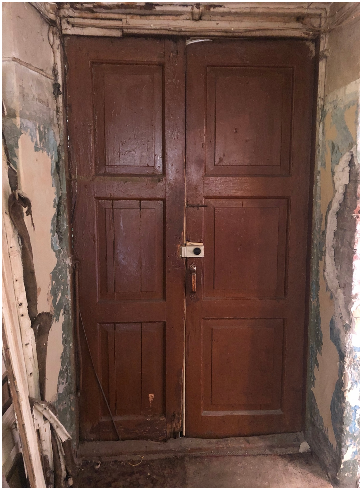
3. Вид на входную дверь в квартире;
