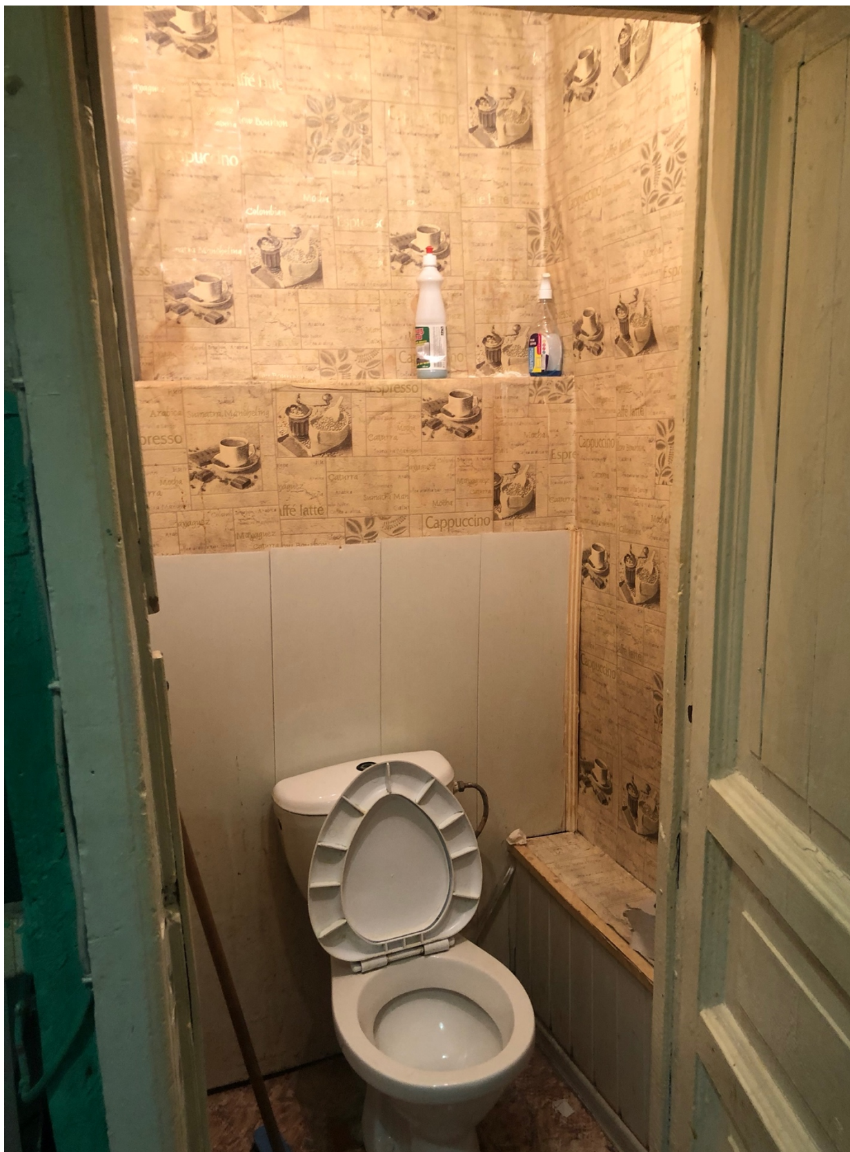
17.Фрагмент интерьера (помещение 2)
