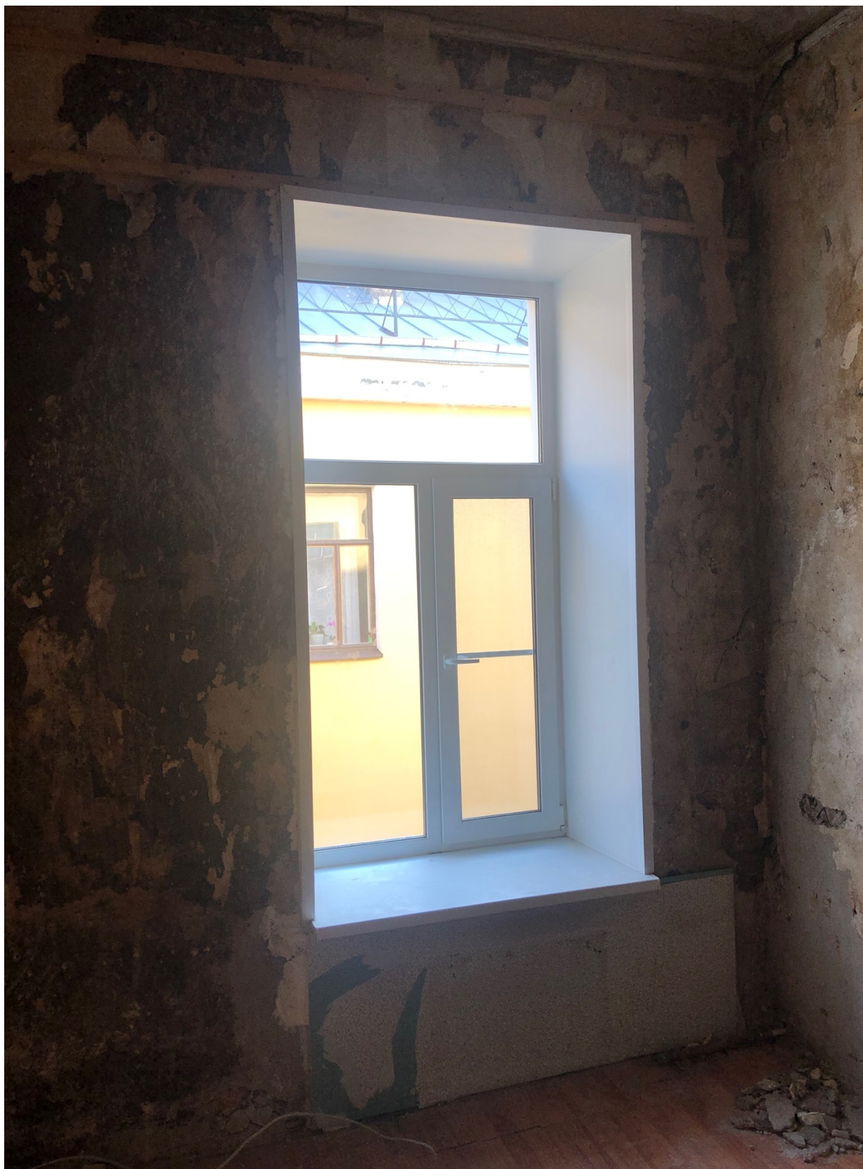
11.Фрагмент интерьера комнаты (помещение 6/10);
