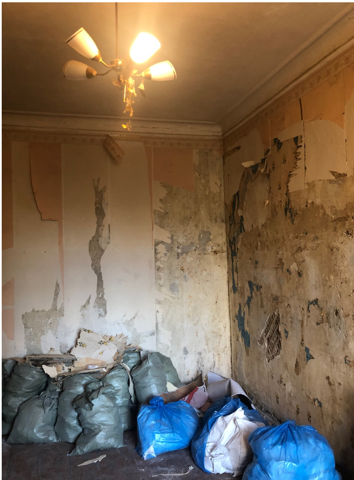
5. Фрагмент интерьера комнаты (помещение 9/19.4);
