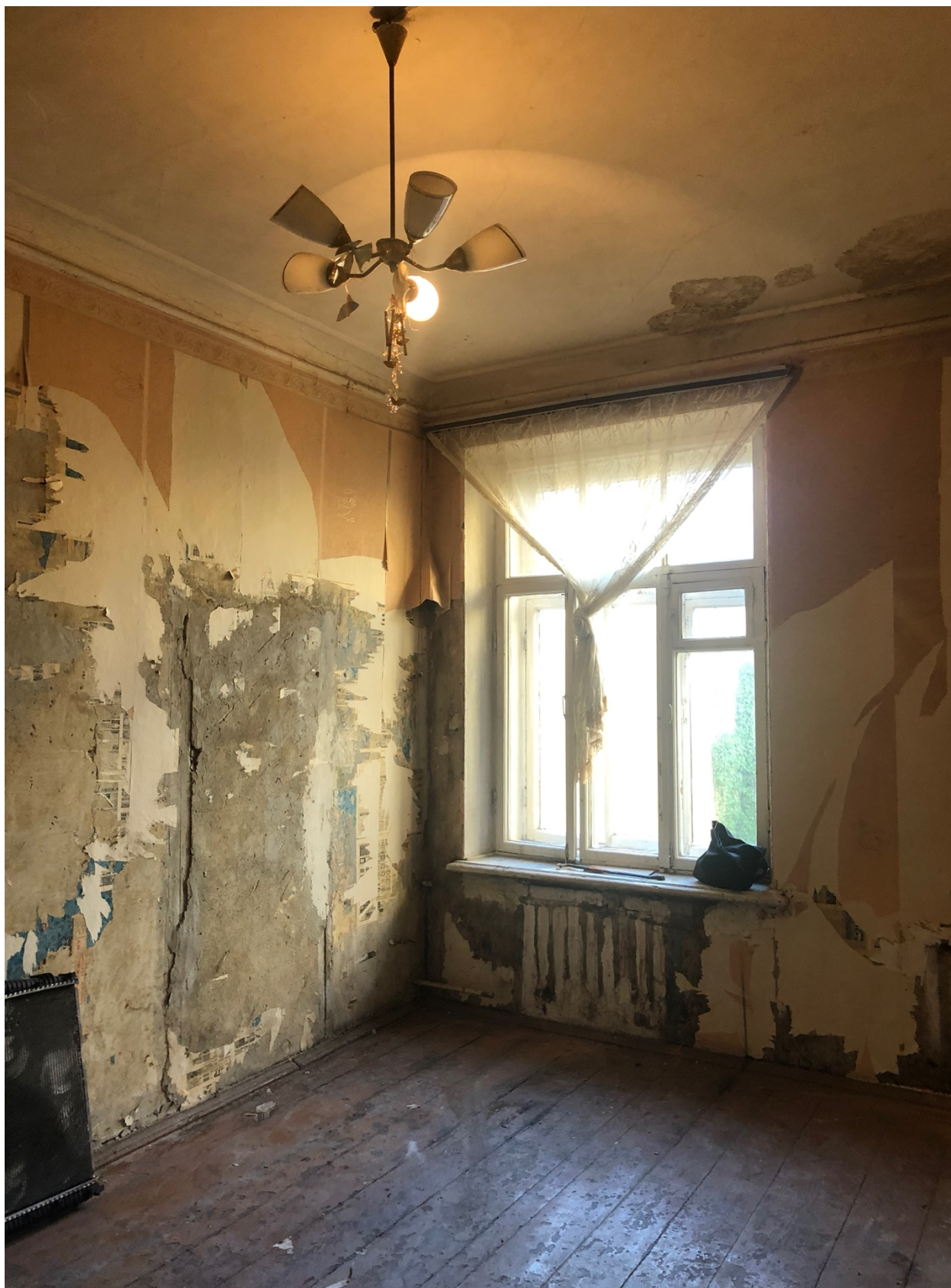
4. Фрагмент интерьера комнаты (помещение 9/19.4);
