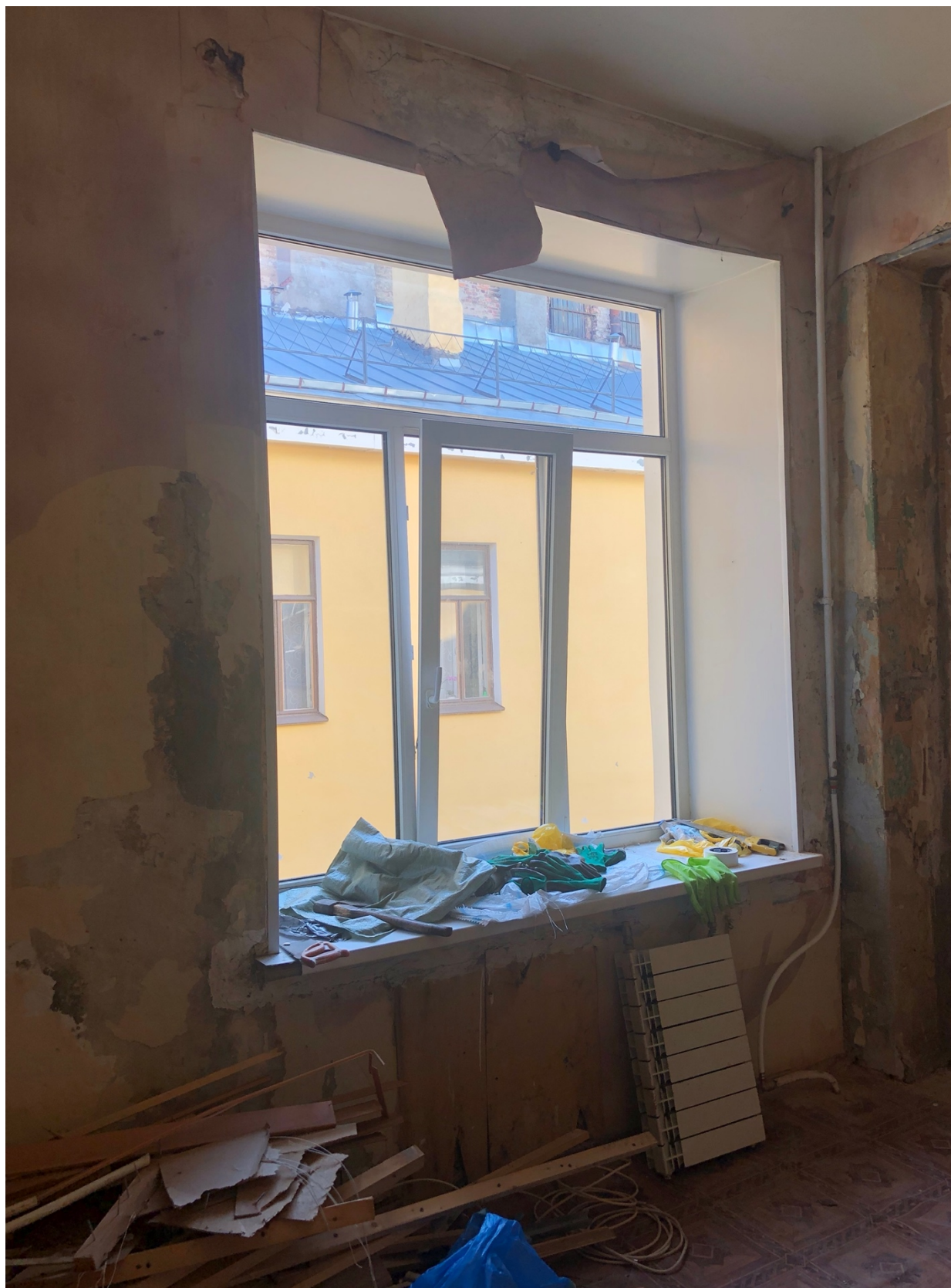
8. Фрагмент интерьера комнаты (помещение 5/17.3);
