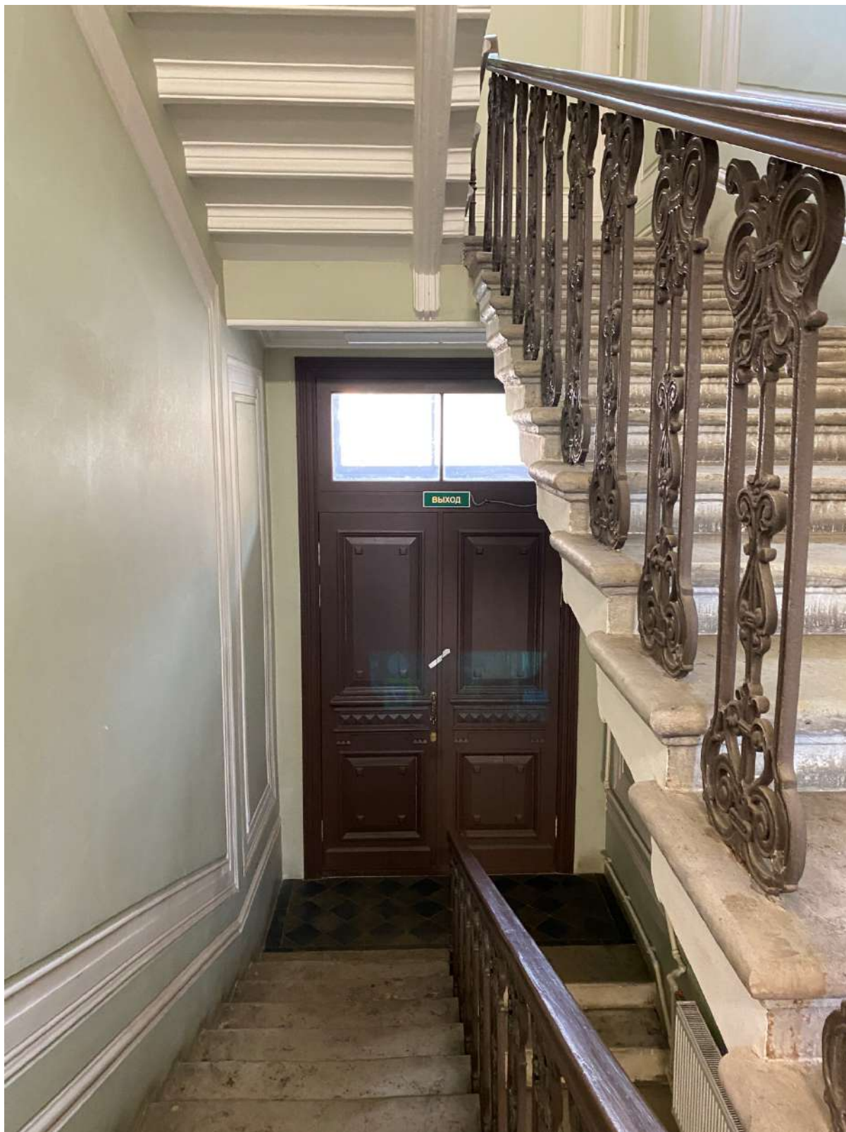
34. Вид на лестницу 2ЛК в уровне 1-го этажа
