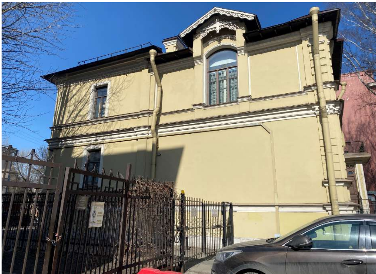
3. Общий вид южного бокового фасада
