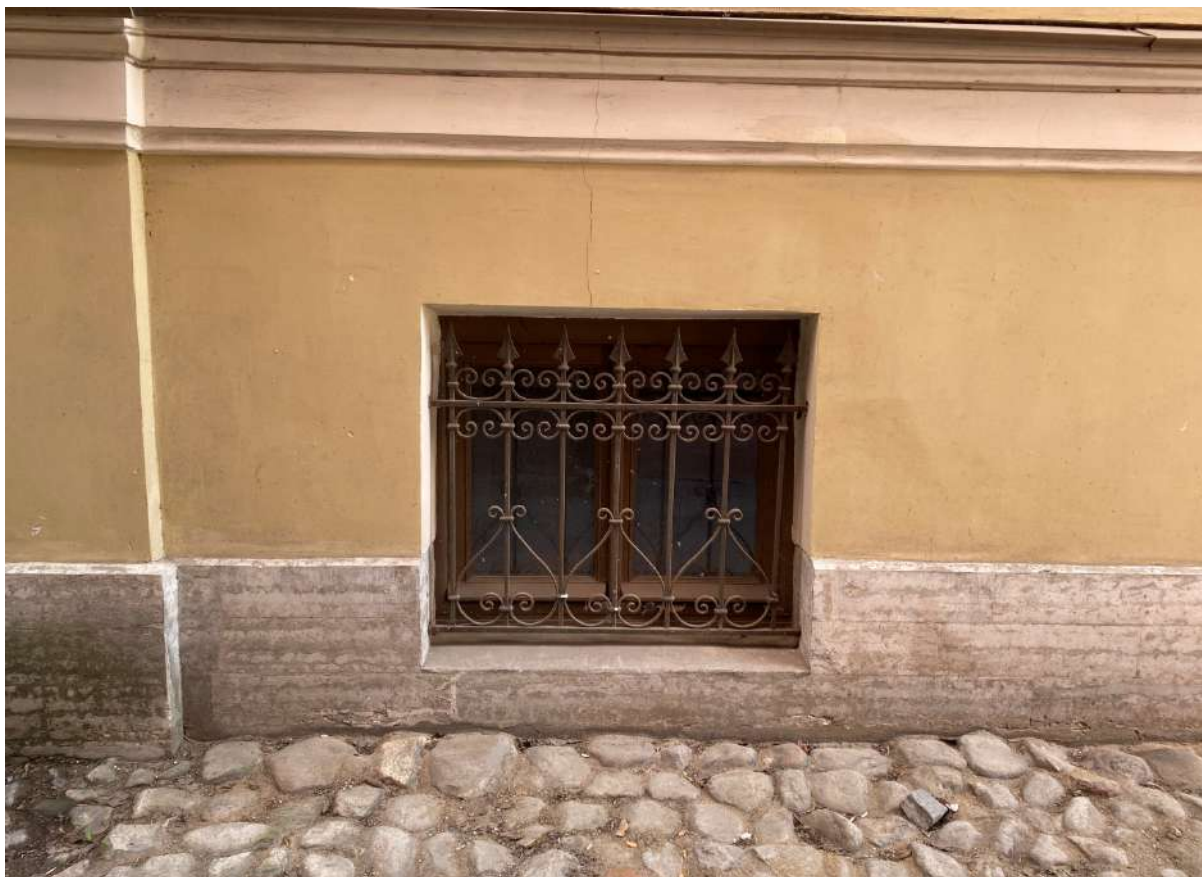
12. Фрагмент северного бокового фасада
