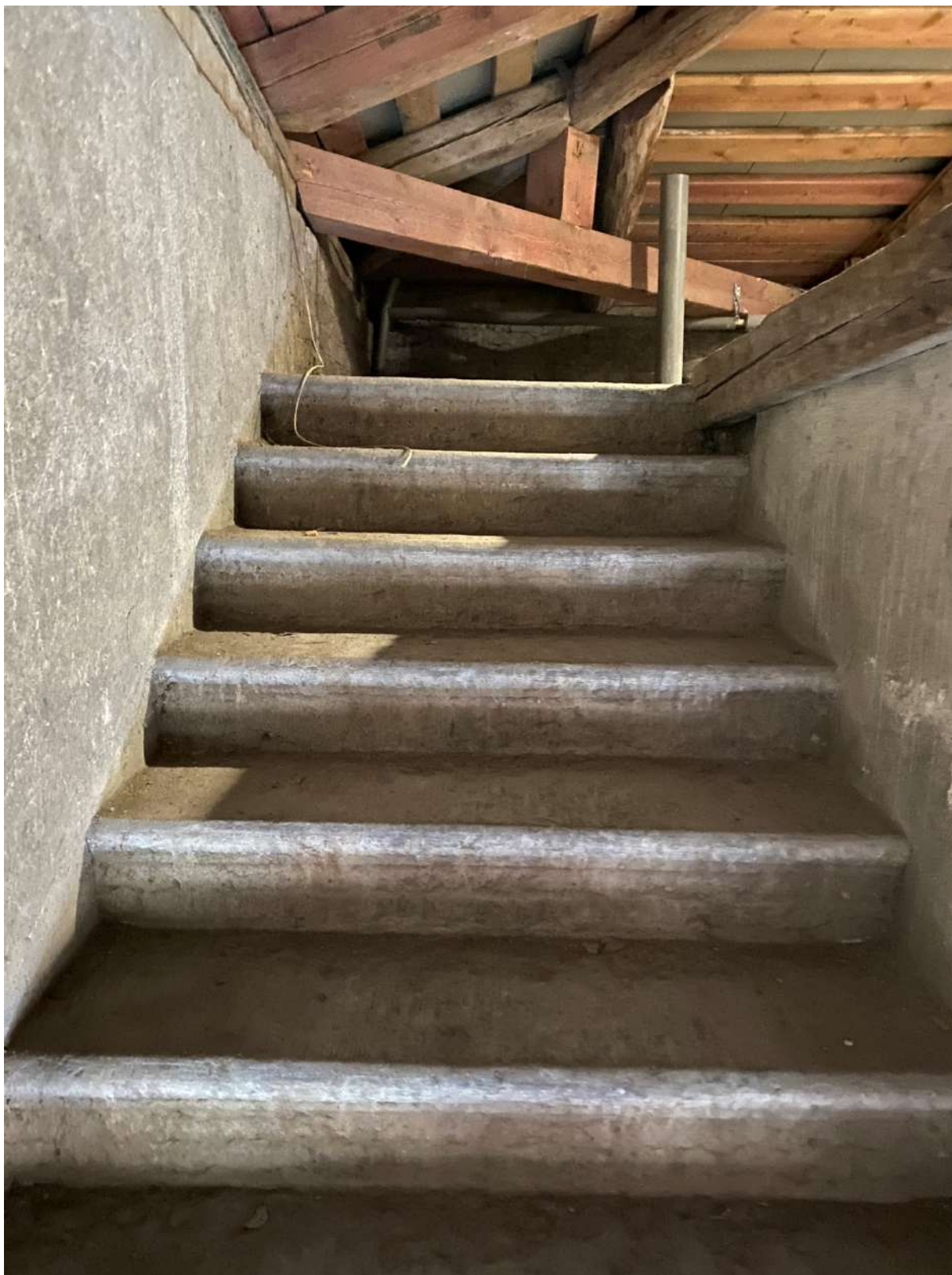
22. Лестница, ведущая на чердак с лестницы 1ЛК
