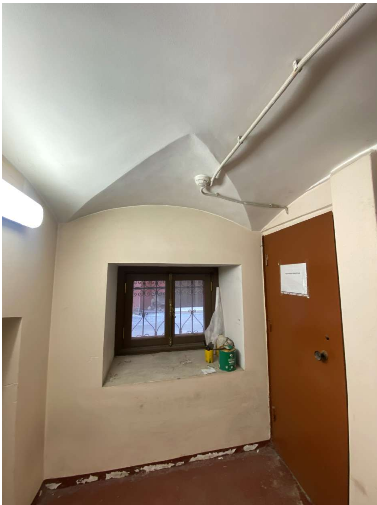
32. Общий вид помещений цокольного этажа
