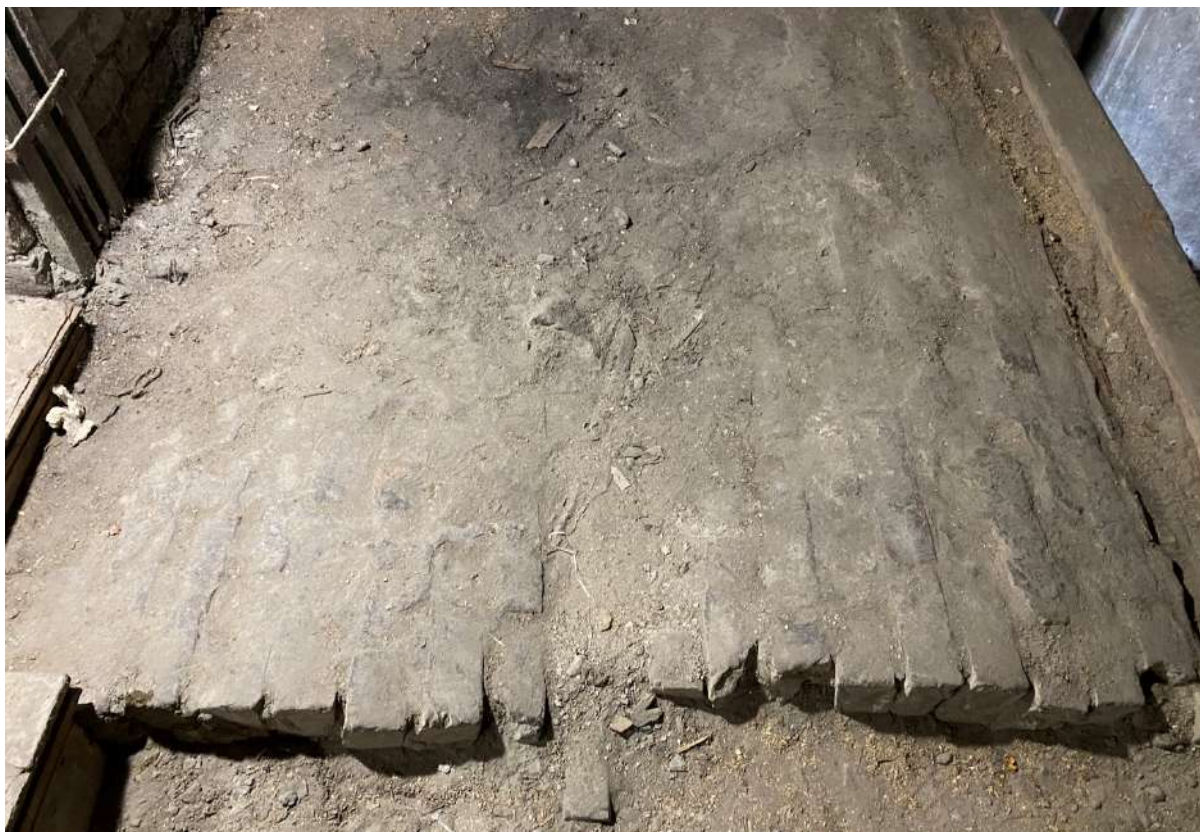
25. Вид на кирпичные своды в уровне чердака
