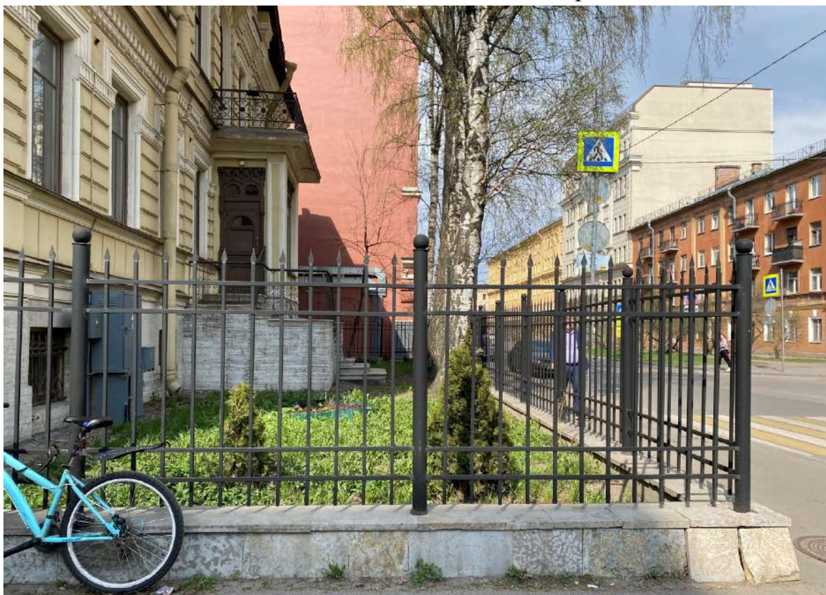
4. Фрагмент лицевого фасада и ограждения по Дровяной улице
