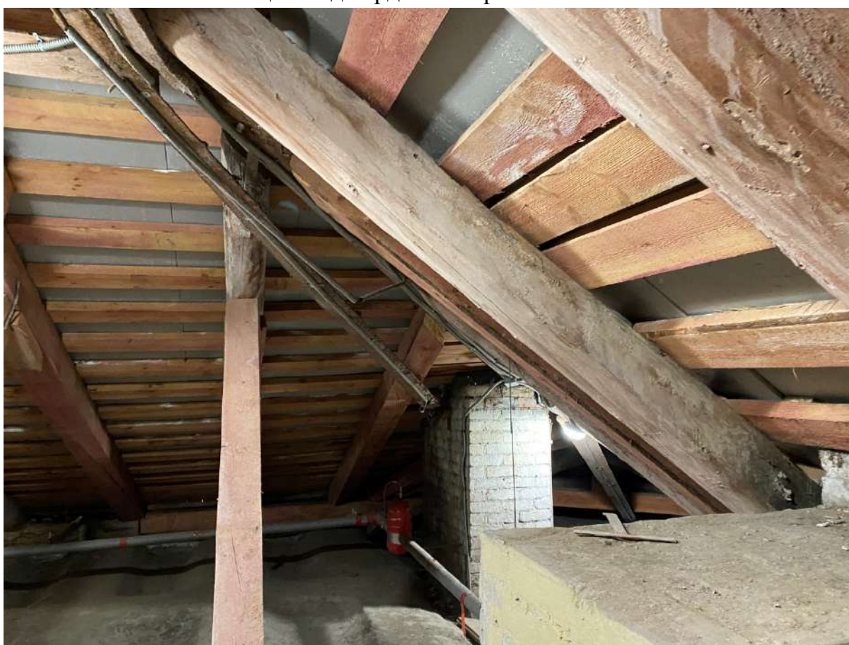
24. Фрагмент чердака и стропильной системы
