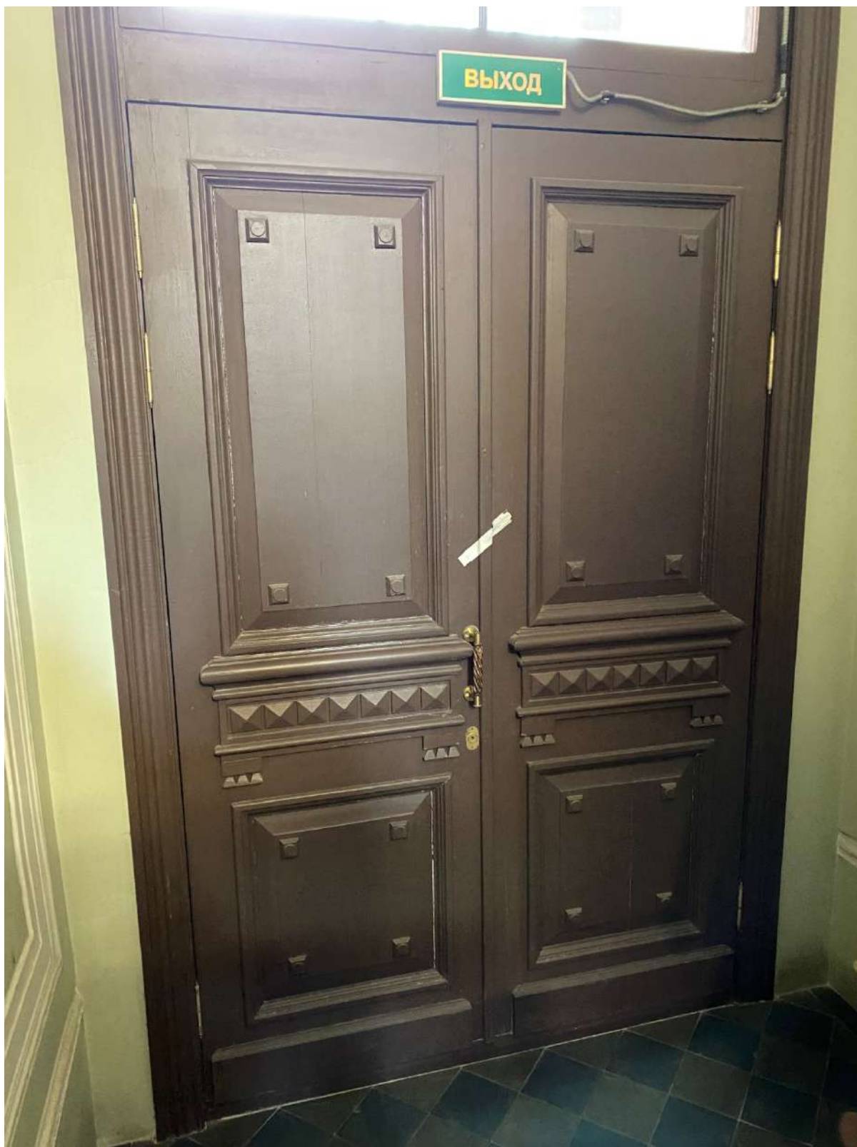
30. Вид на дверное заполнение с лестницы 2ЛК в уровне 1-го этажа
