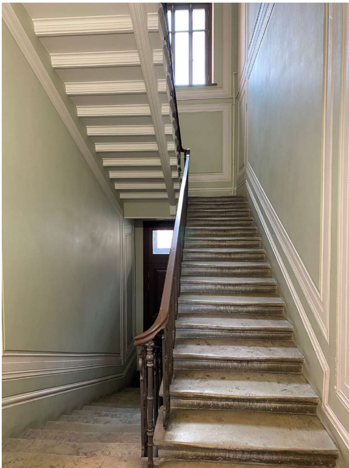
27. Лестница 2ЛК в уровне первого этажа
