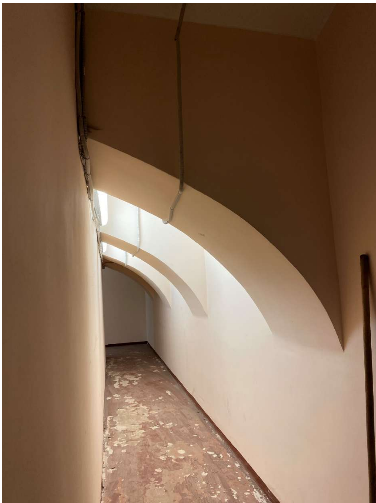
33. Общий вид помещений цокольного этажа
