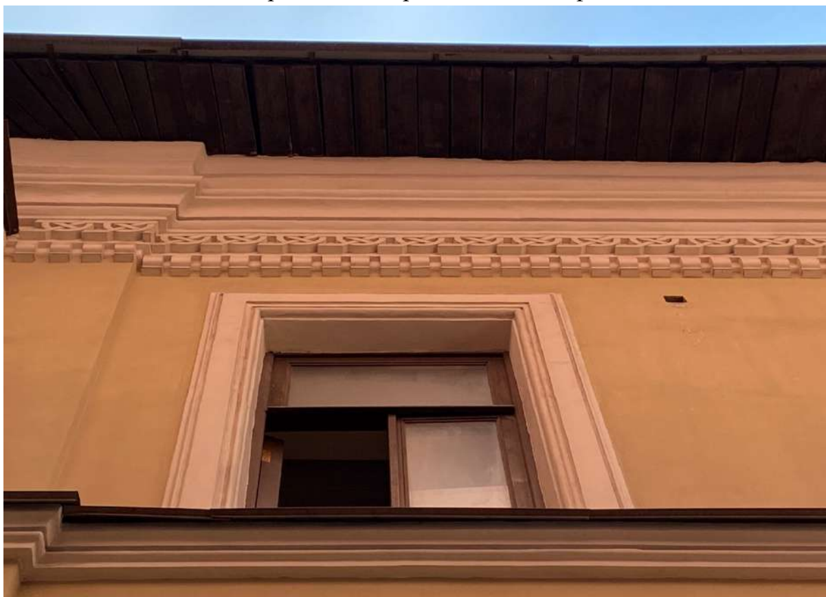
13. Фрагмент северного бокового фасада
