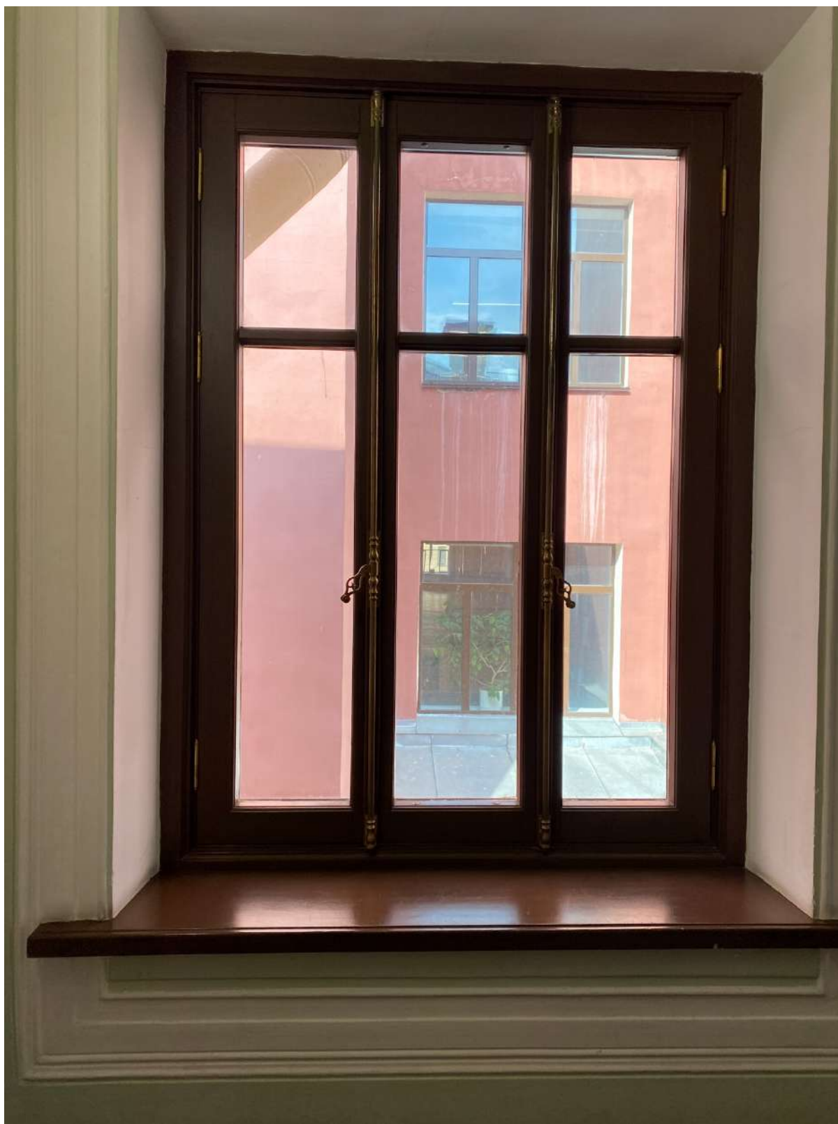
40. Оконное заполнение в части лестницы 2ЛК в уровне 2-го этажа
