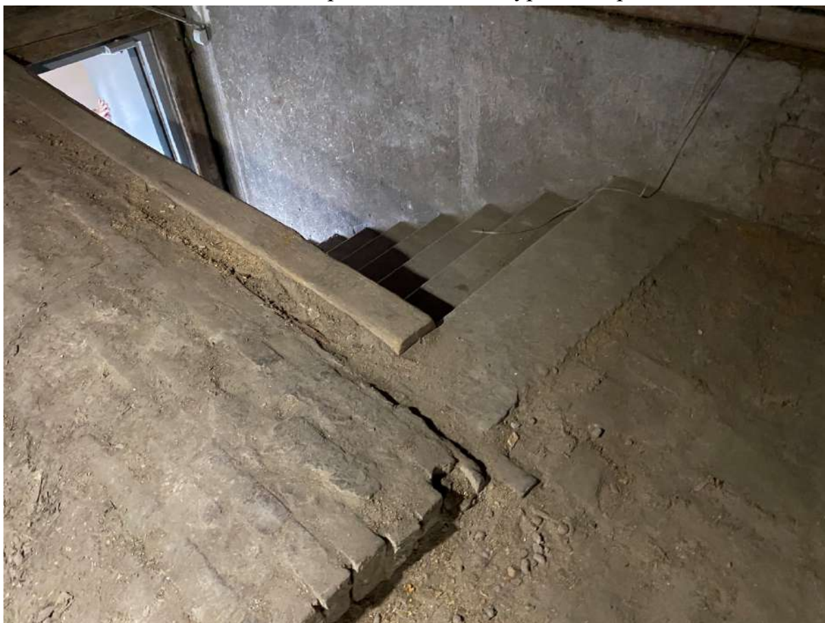
26. Лестница, ведущая с чердака на лестницу 1ЛК
