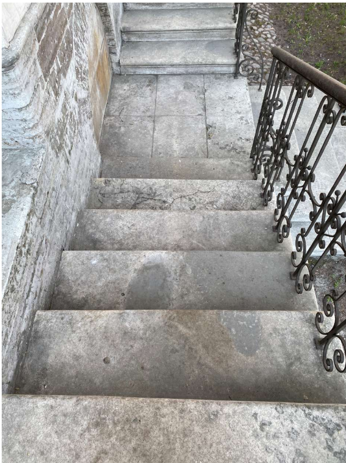
16. Вид на лестницу, расположенную на лицевом фасаде
