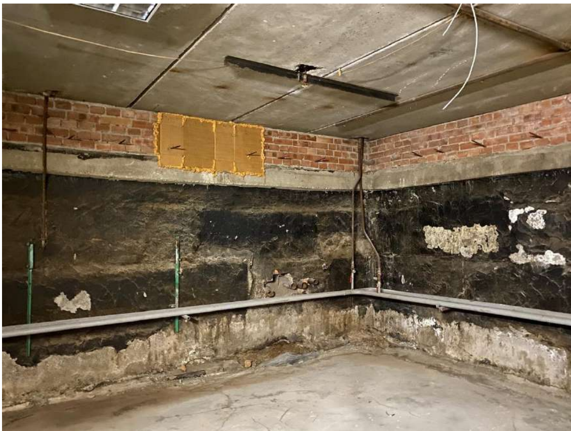
34. Общий вид помещения подвального этажа объекта культурного наследия.
