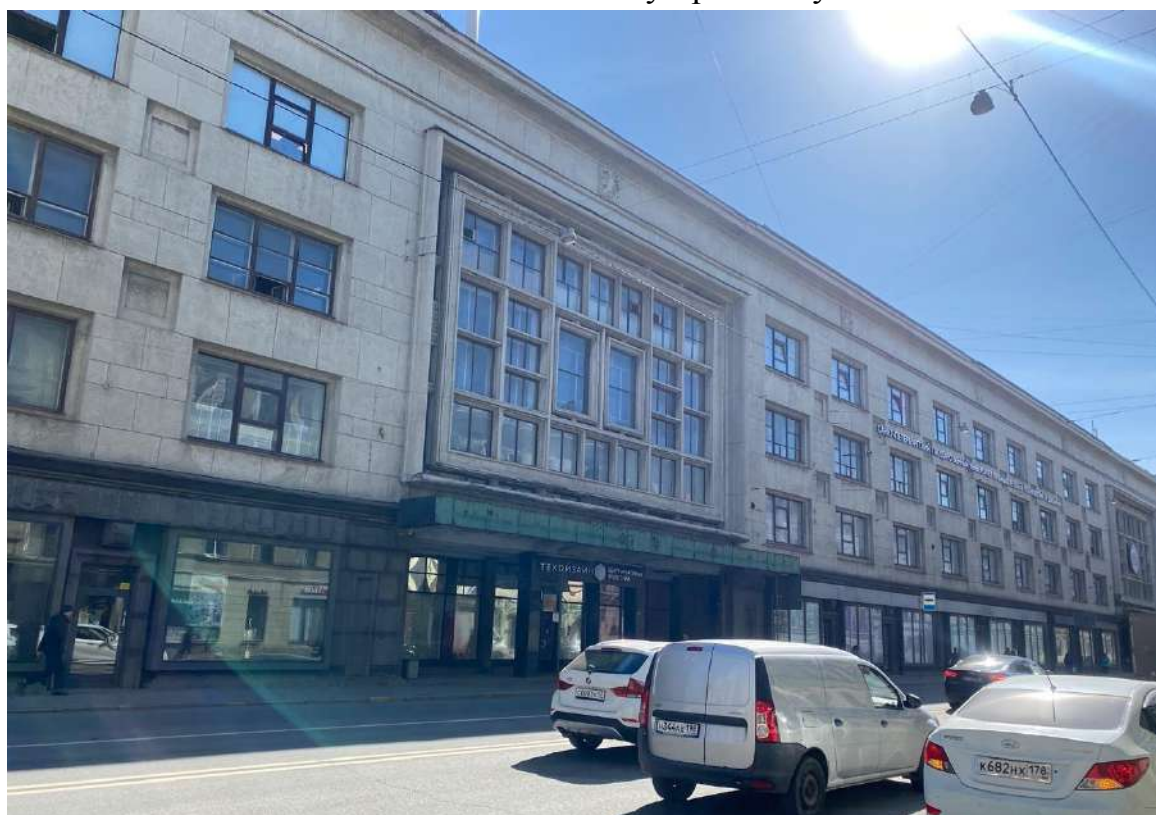
4. Фрагмент лицевого фасада объекта культурного наследия по Вознесенскому проспекту.
