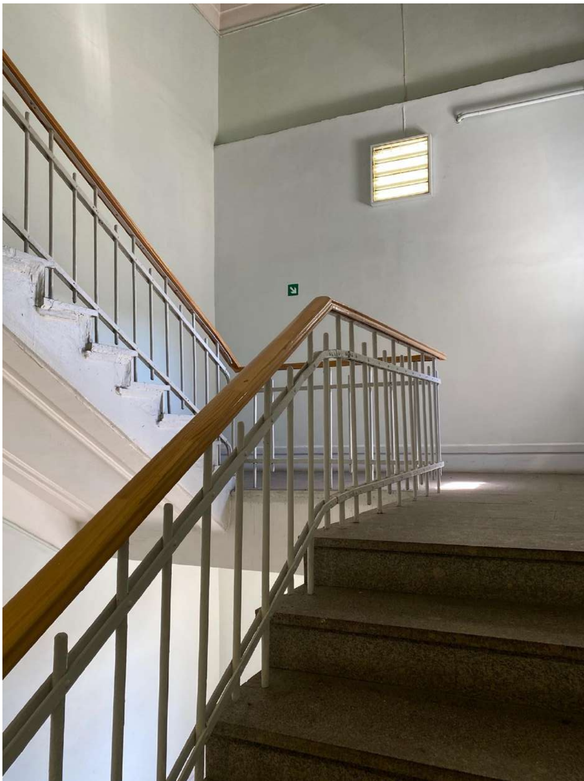
114. Общий вид лестницы объекта культурного наследия в уровне 4-го этажа.
