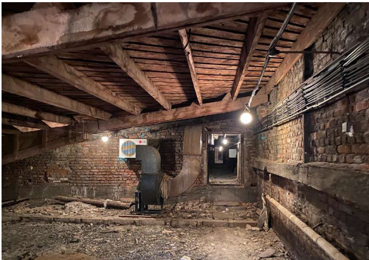
138. Общий вид помещения чердака объекта культурного наследия.
