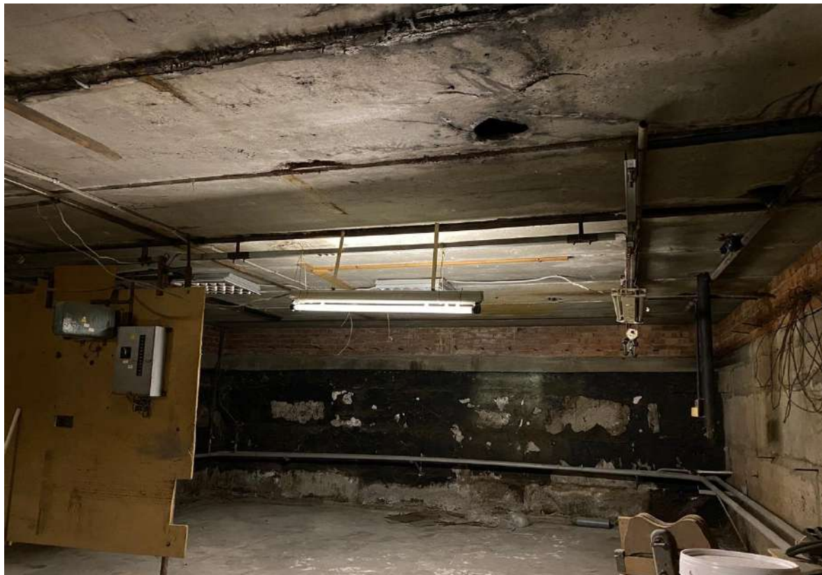
33. Общий вид помещения подвального этажа объекта культурного наследия.
