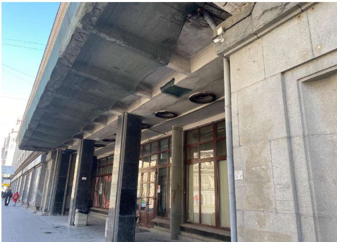
12. Входная группа лицевого фасада объекта культурного наследия по Вознесенскому проспекту.
