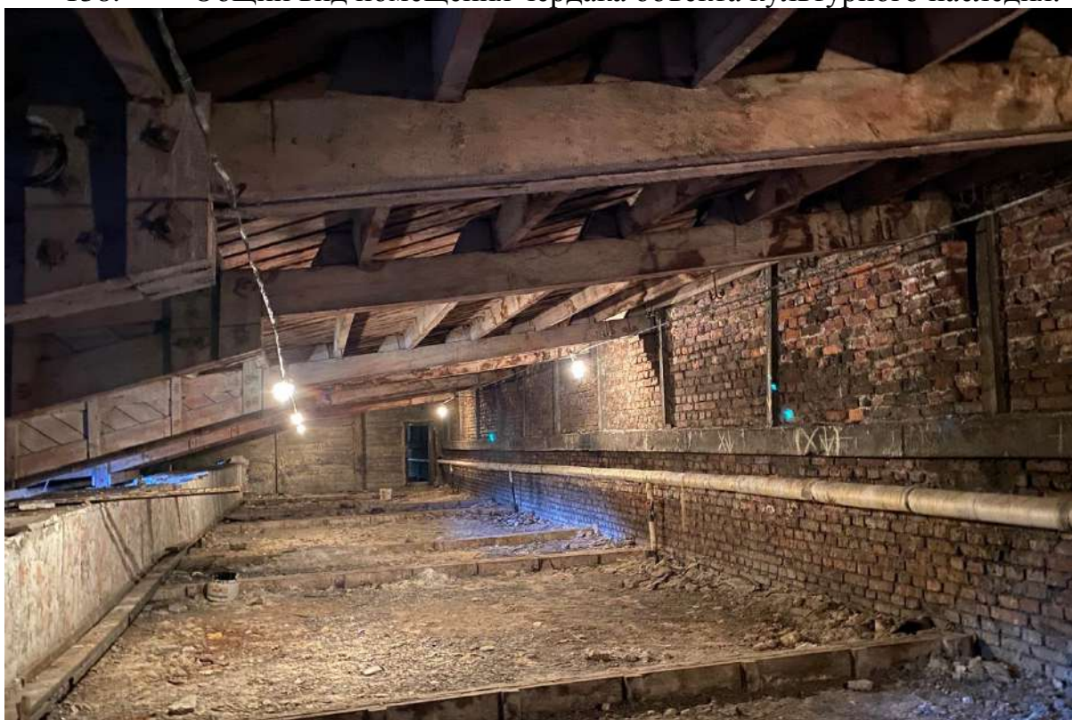
139. Общий вид помещения чердака объекта культурного наследия.
