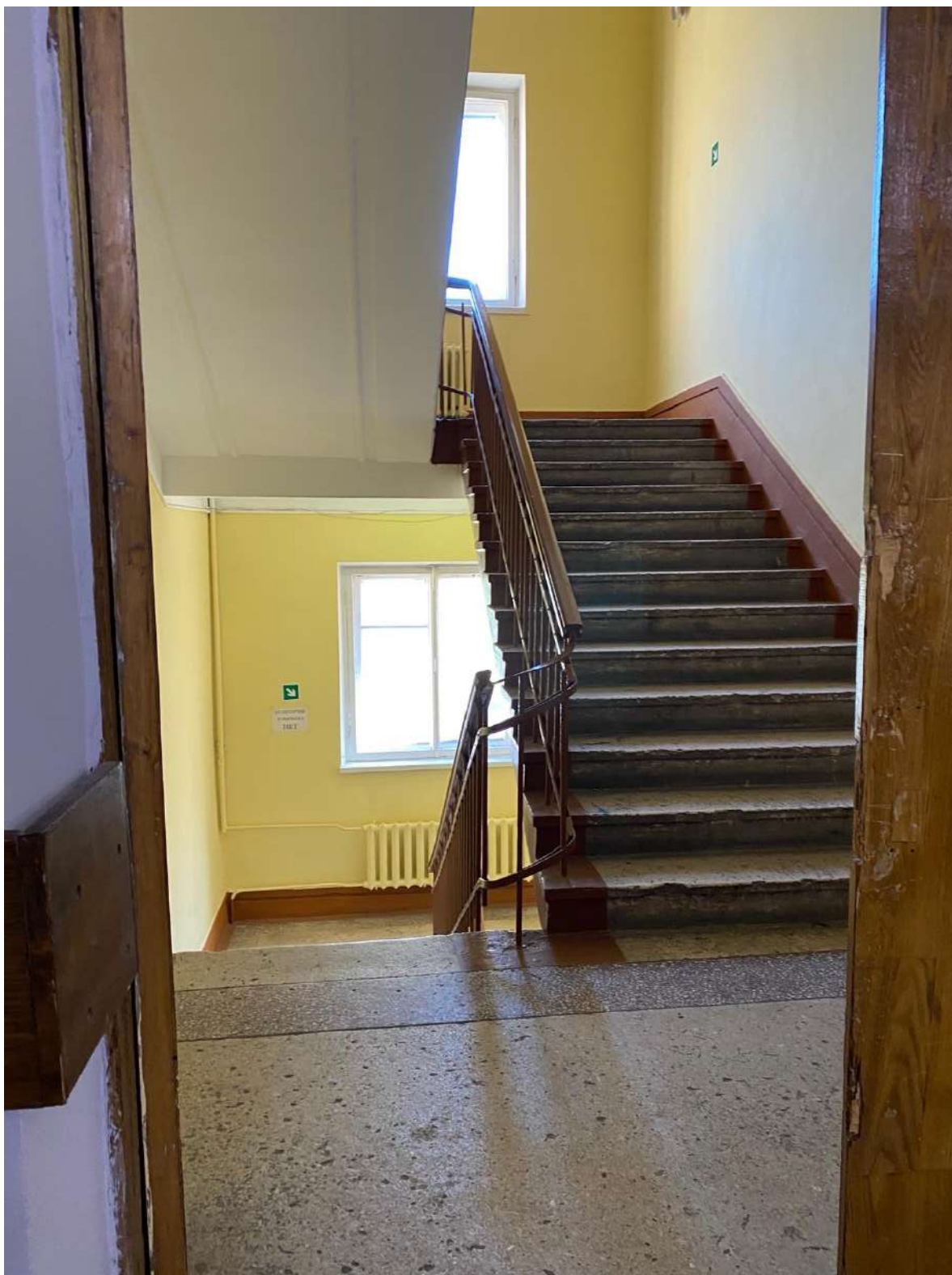
94. Общий вид лестницы объекта культурного наследия в уровне 3-го этажа.
