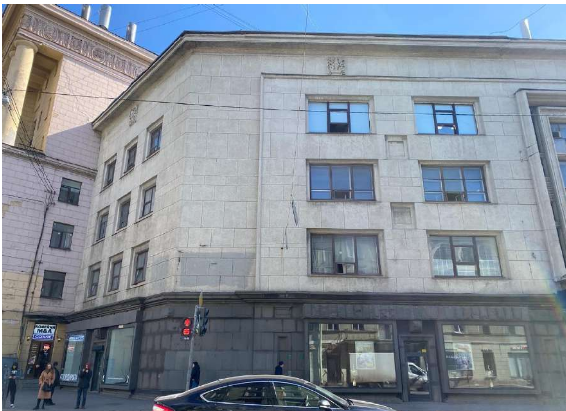
3. Фрагмент лицевого фасада объекта культурного наследия по Вознесенскому проспекту.
