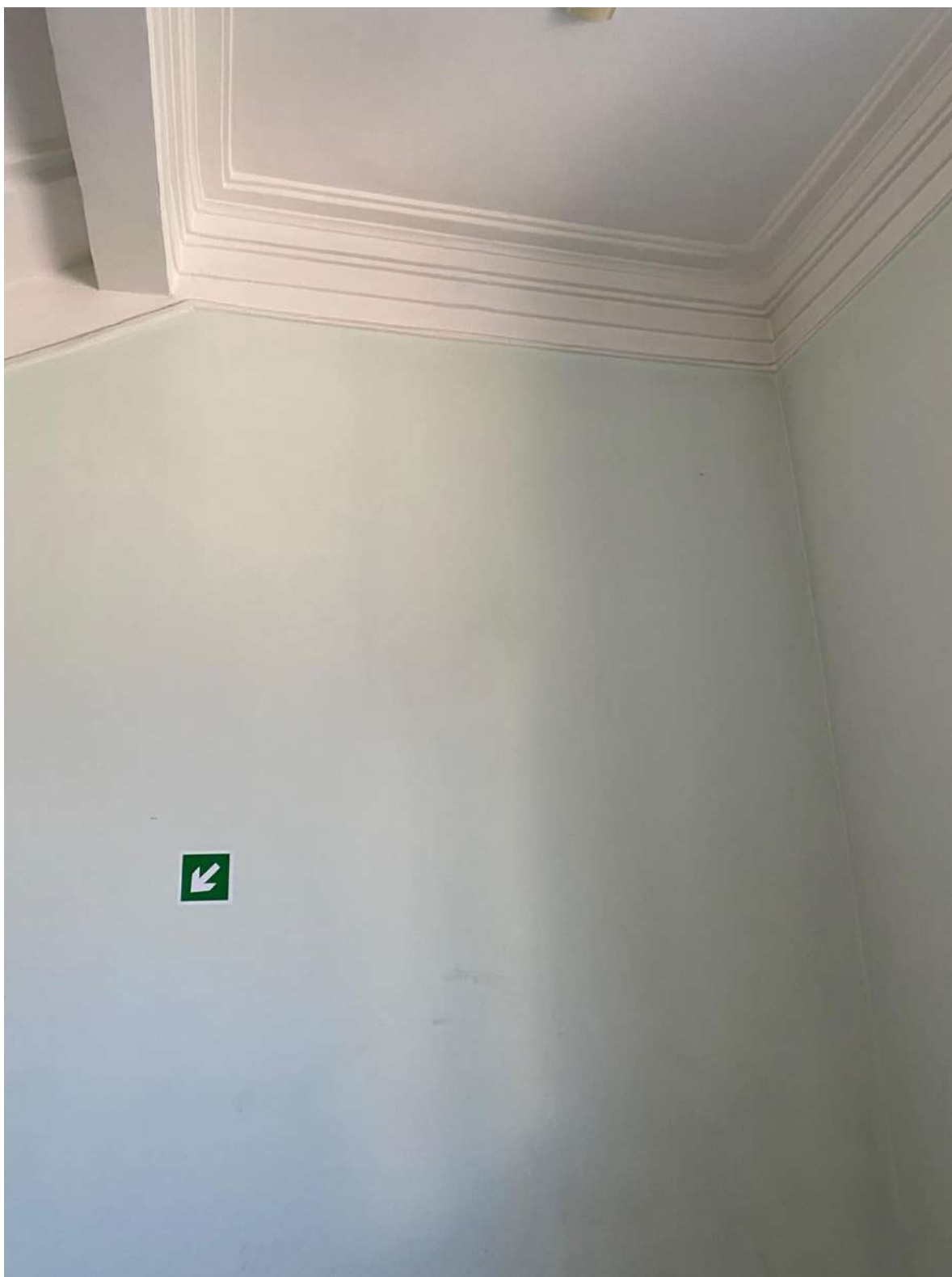
66. Фрагмент перекрытия лестницы объекта культурного наследия в уровне 2-го этажа.
