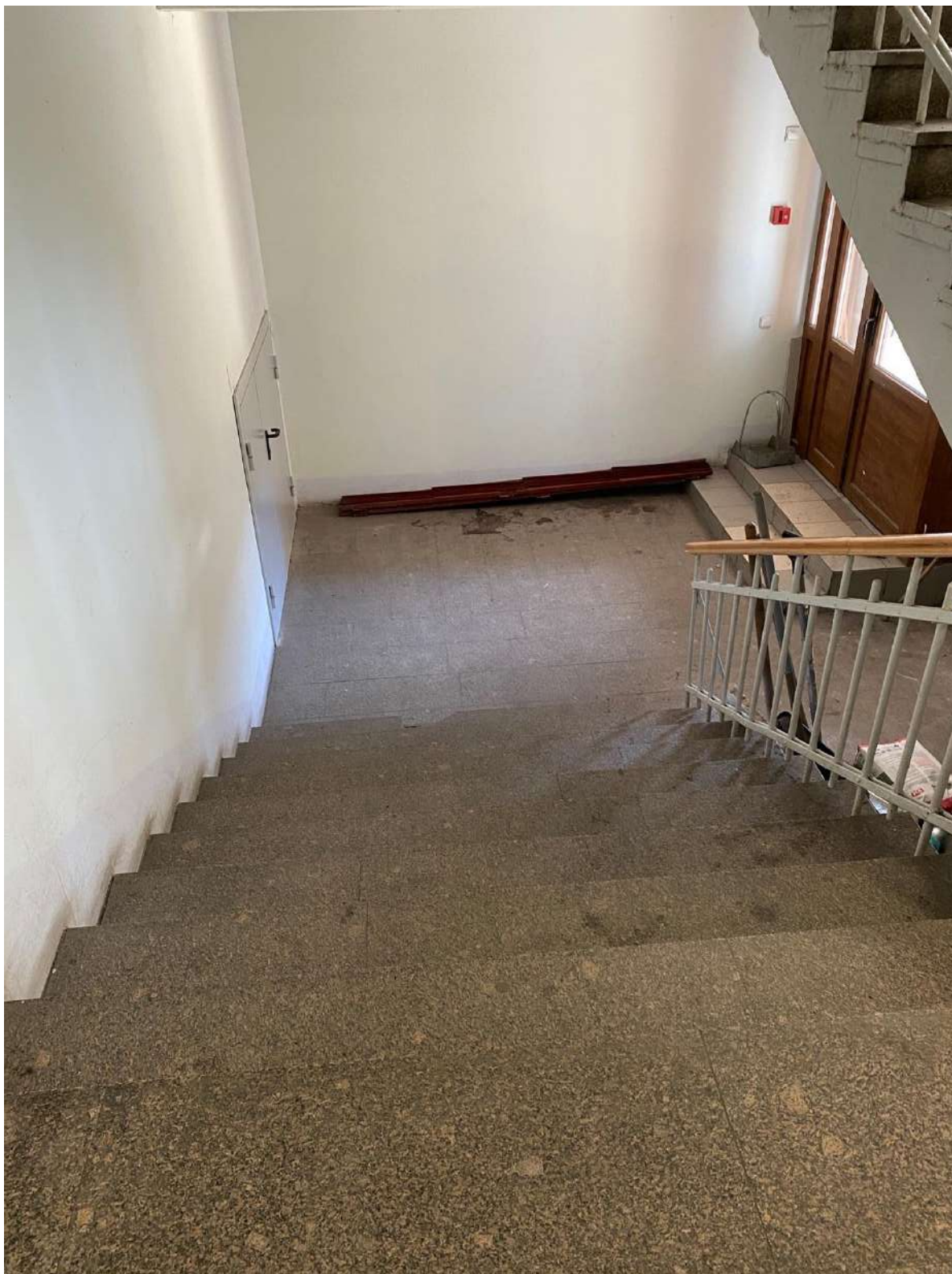
45. Общий вид лестницы объекта культурного наследия в уровне 1-го этажа.
