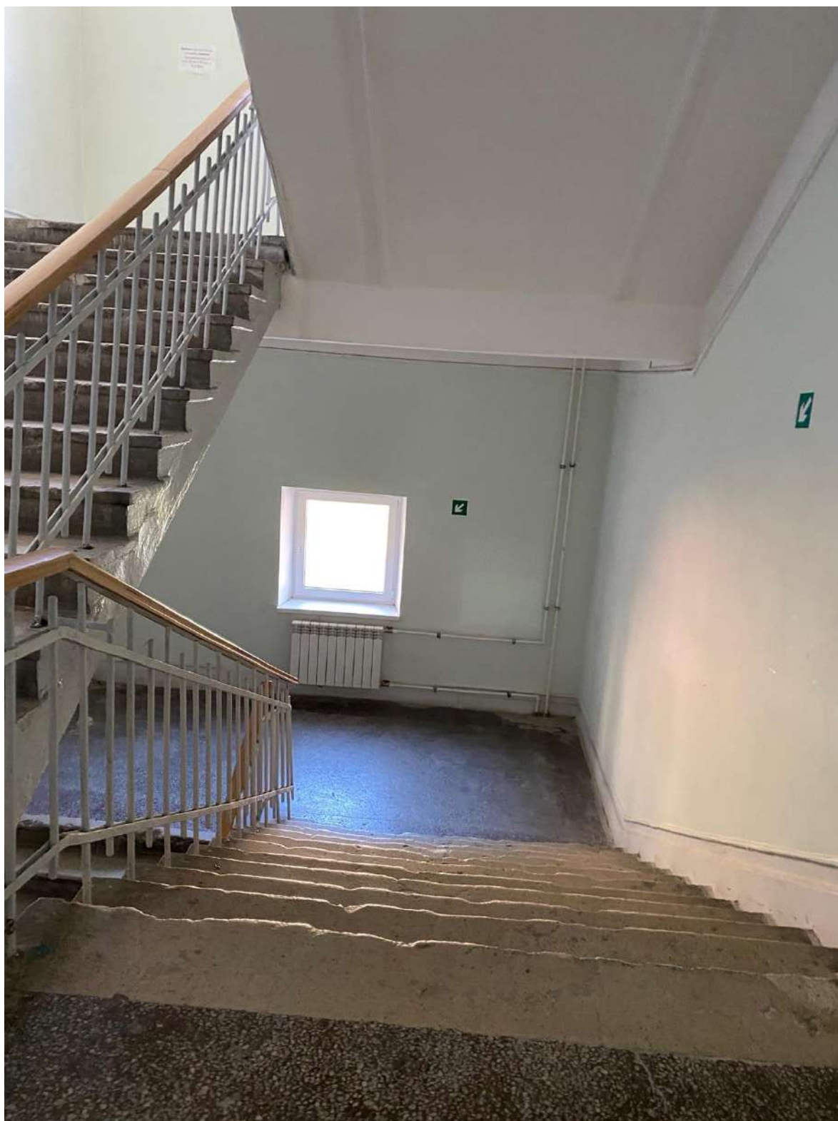
64. Общий вид лестницы объекта культурного наследия в уровне 2-го этажа.
