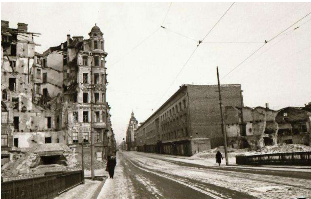
91. Разрушенные дома у Измайловского моста, 1943 г. [Электронный ресурс] URL: https://pastvu.com/p/1679577
