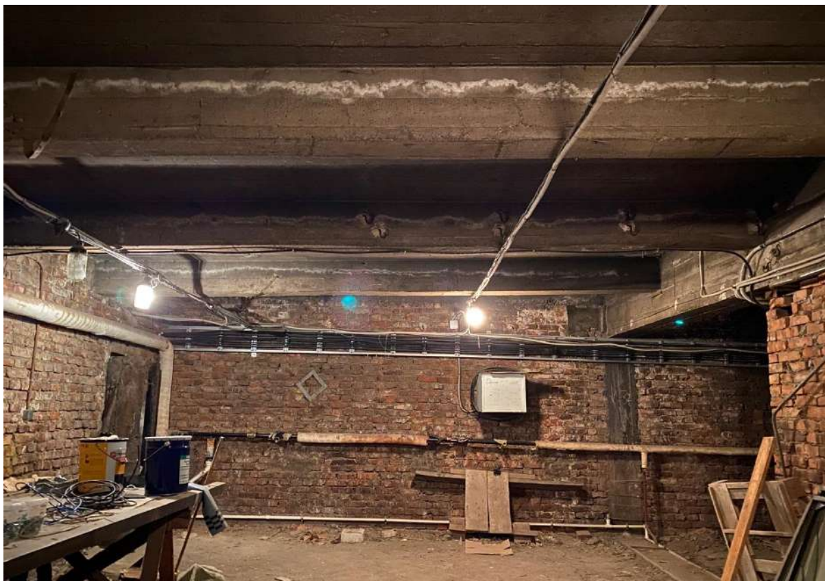
126. Общий вид помещения чердака объекта культурного наследия.
