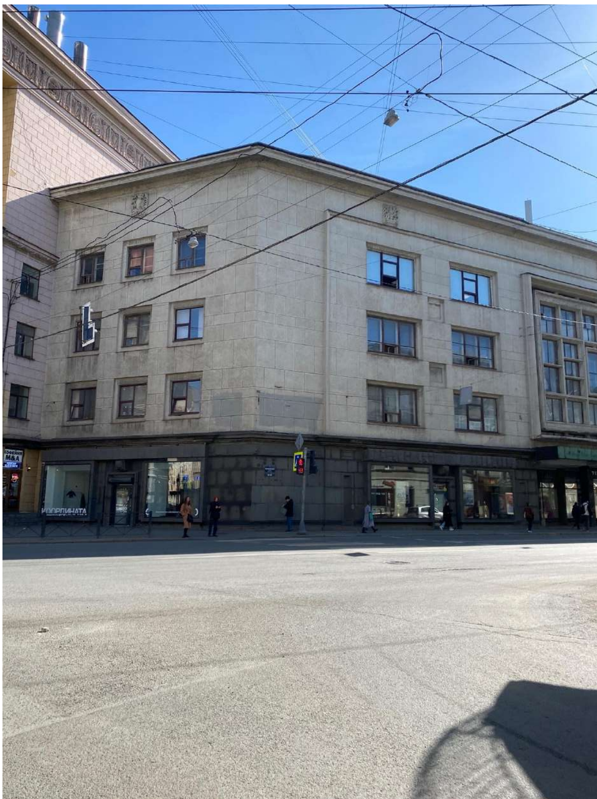
2. Фрагмент лицевого фасада объекта культурного наследия с перекрестка Садовой улицы и Вознесенского проспекта.
