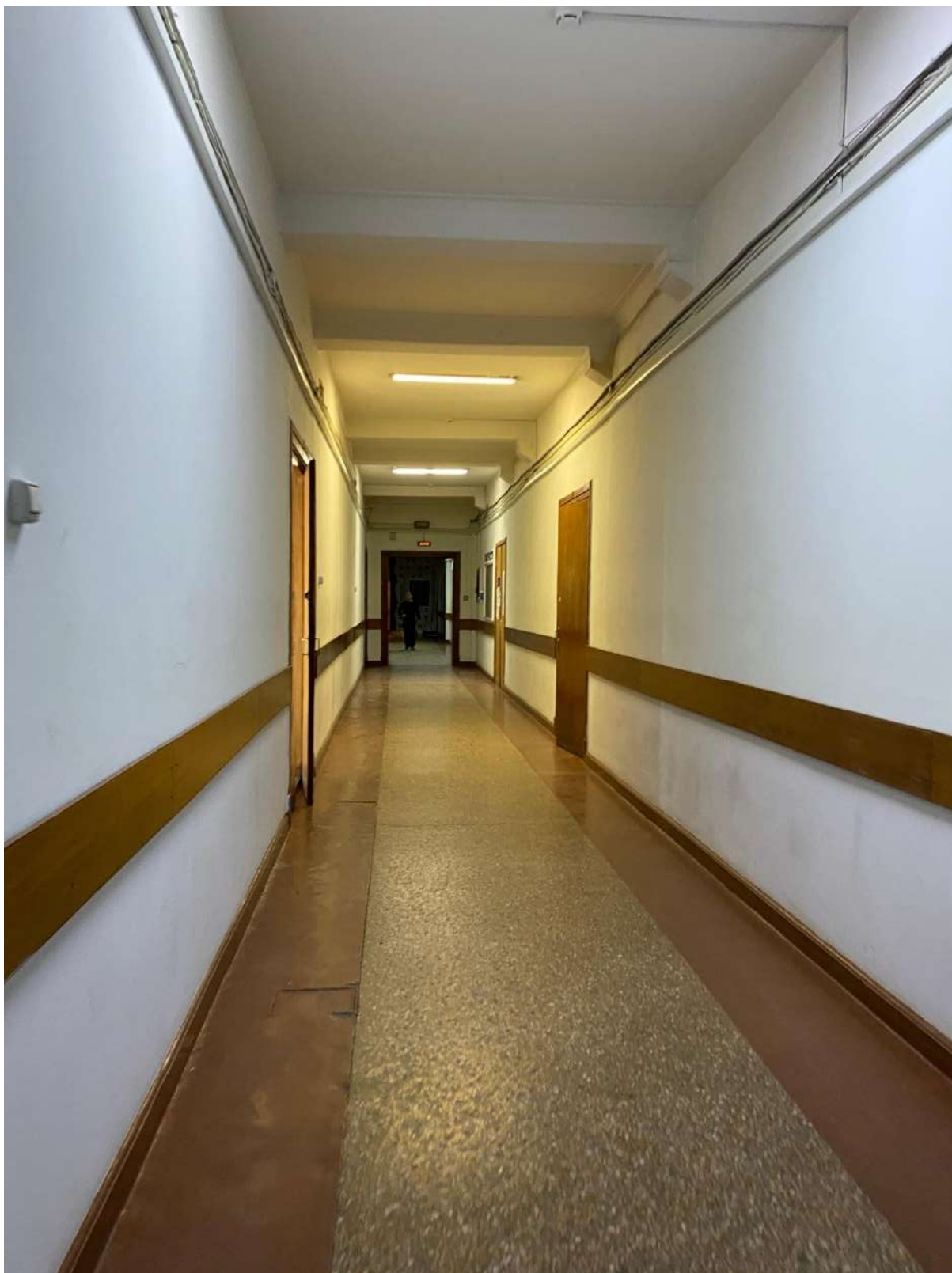
117. Интерьер помещений объекта культурного наследия в уровне 4-го этажа.
