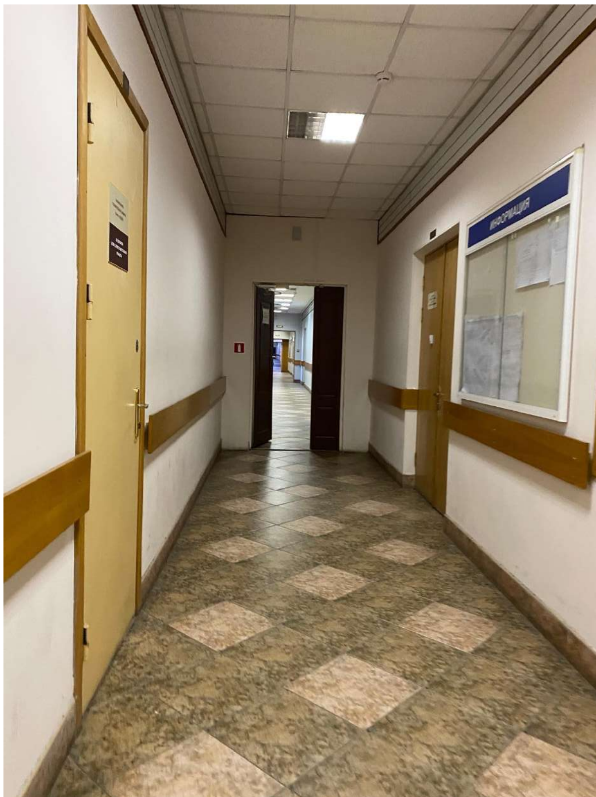
106. Интерьер помещений объекта культурного наследия в уровне 4-го этажа.
