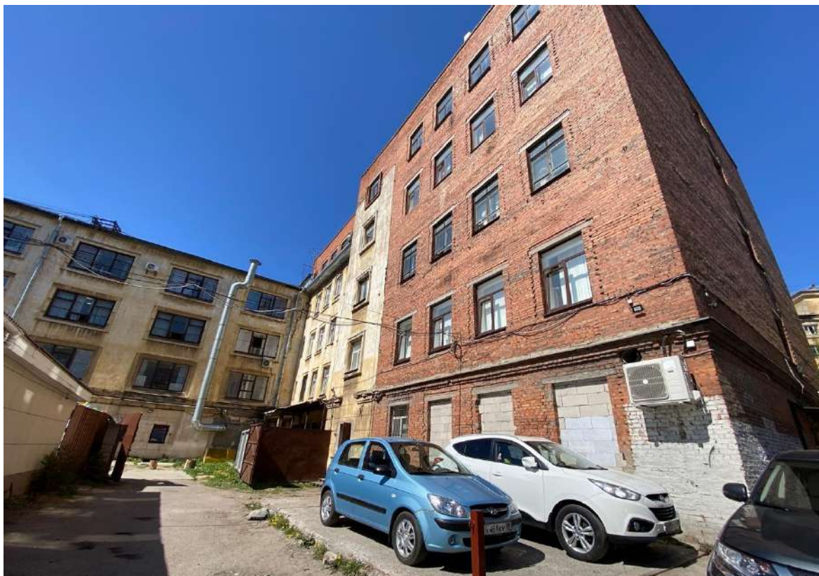
26. Общий вид дворового фасада и северного ризалита объекта культурного наследия.
