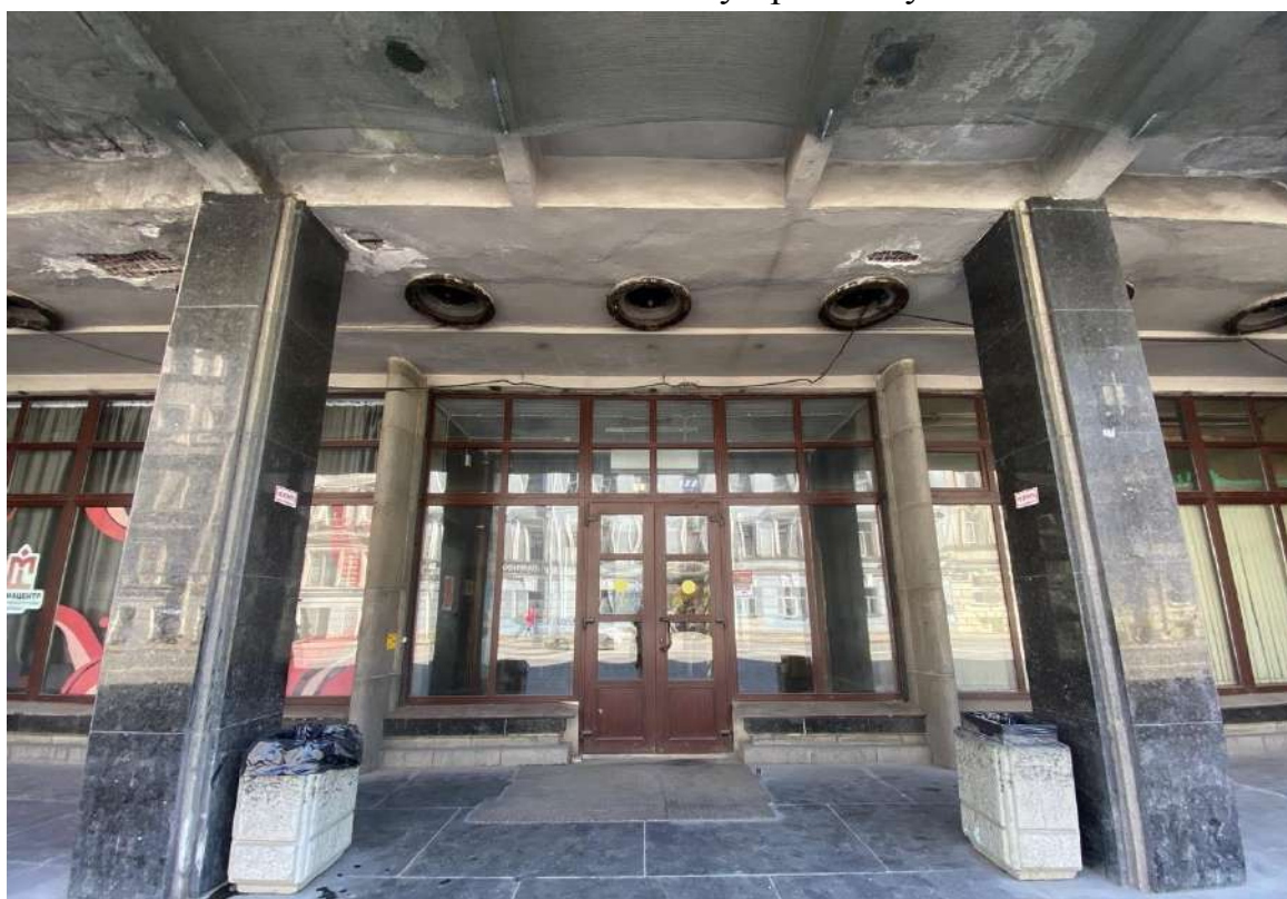
13. Входная группа лицевого фасада объекта культурного наследия по Вознесенскому проспекту.
