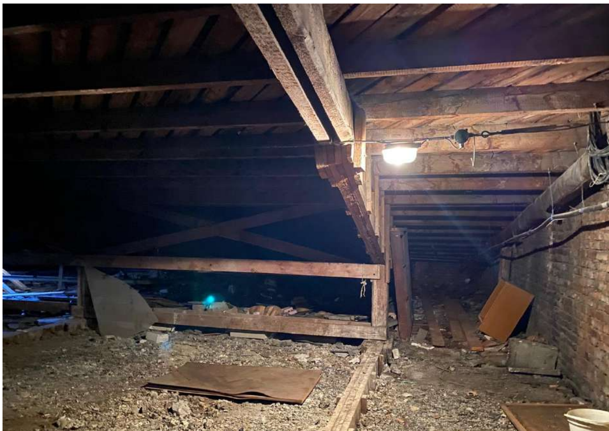
128. Общий вид помещения чердака объекта культурного наследия.
