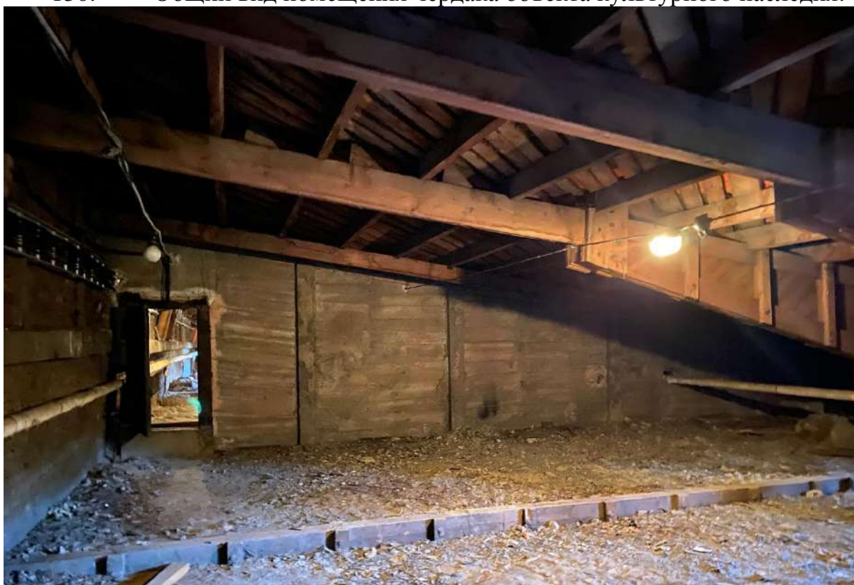
131. Общий вид помещения чердака объекта культурного наследия.
