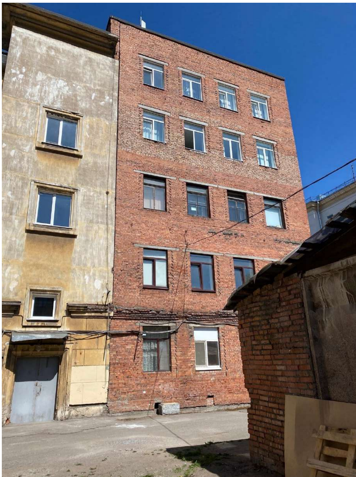
19. Фрагмент южного ризалита дворового фасада объекта культурного наследия.
