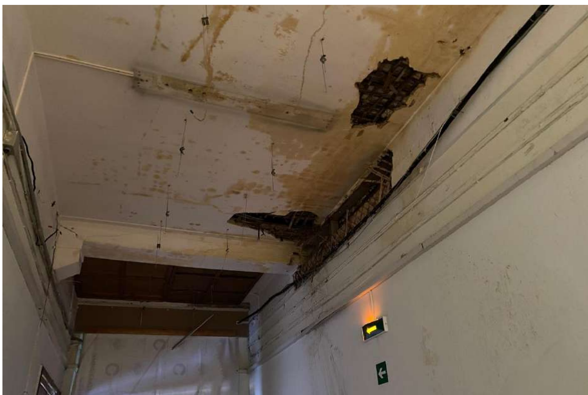
121. Перекрытие помещения объекта культурного наследия в уровне 4-го этажа.
