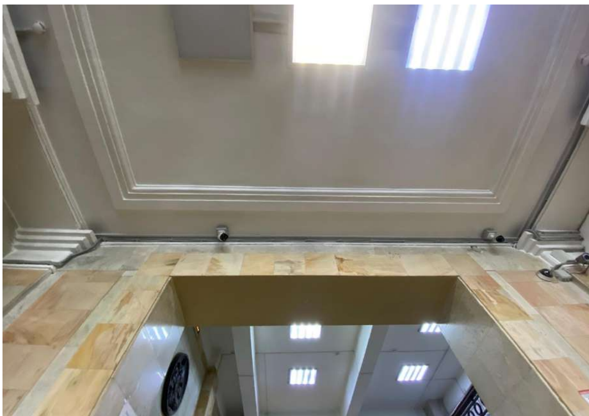
39. Фрагмент потолка вестибюля 1-го этажа объекта культурного наследия.
