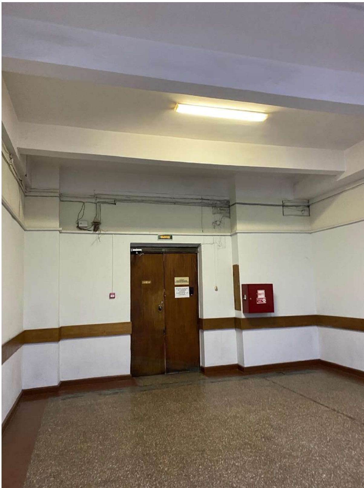
118. Интерьер помещений объекта культурного наследия в уровне 4-го этажа.
