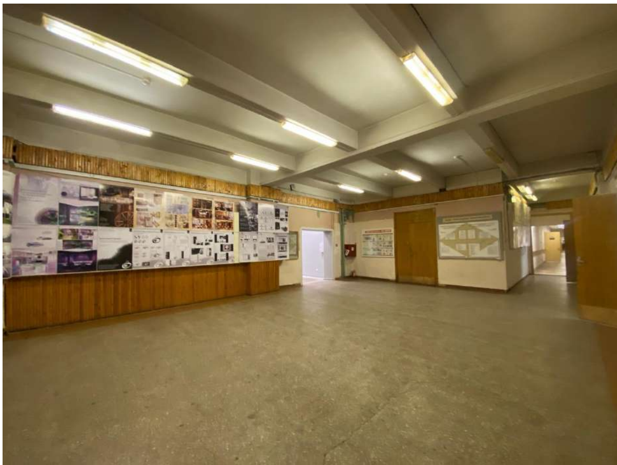
103. Интерьер помещений объекта культурного наследия в уровне 4-го этажа.
