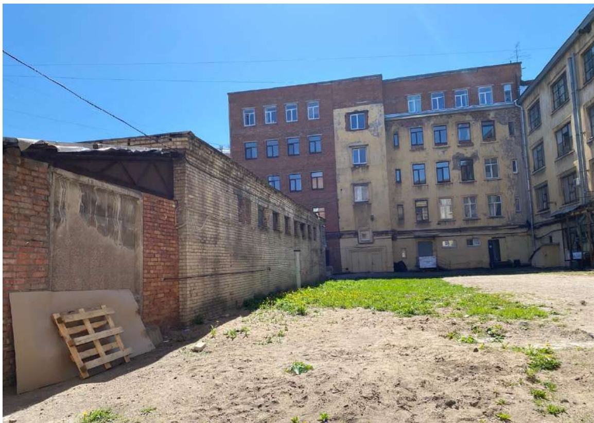
16. Фрагмент южной части дворового фасада объекта культурного наследия.
