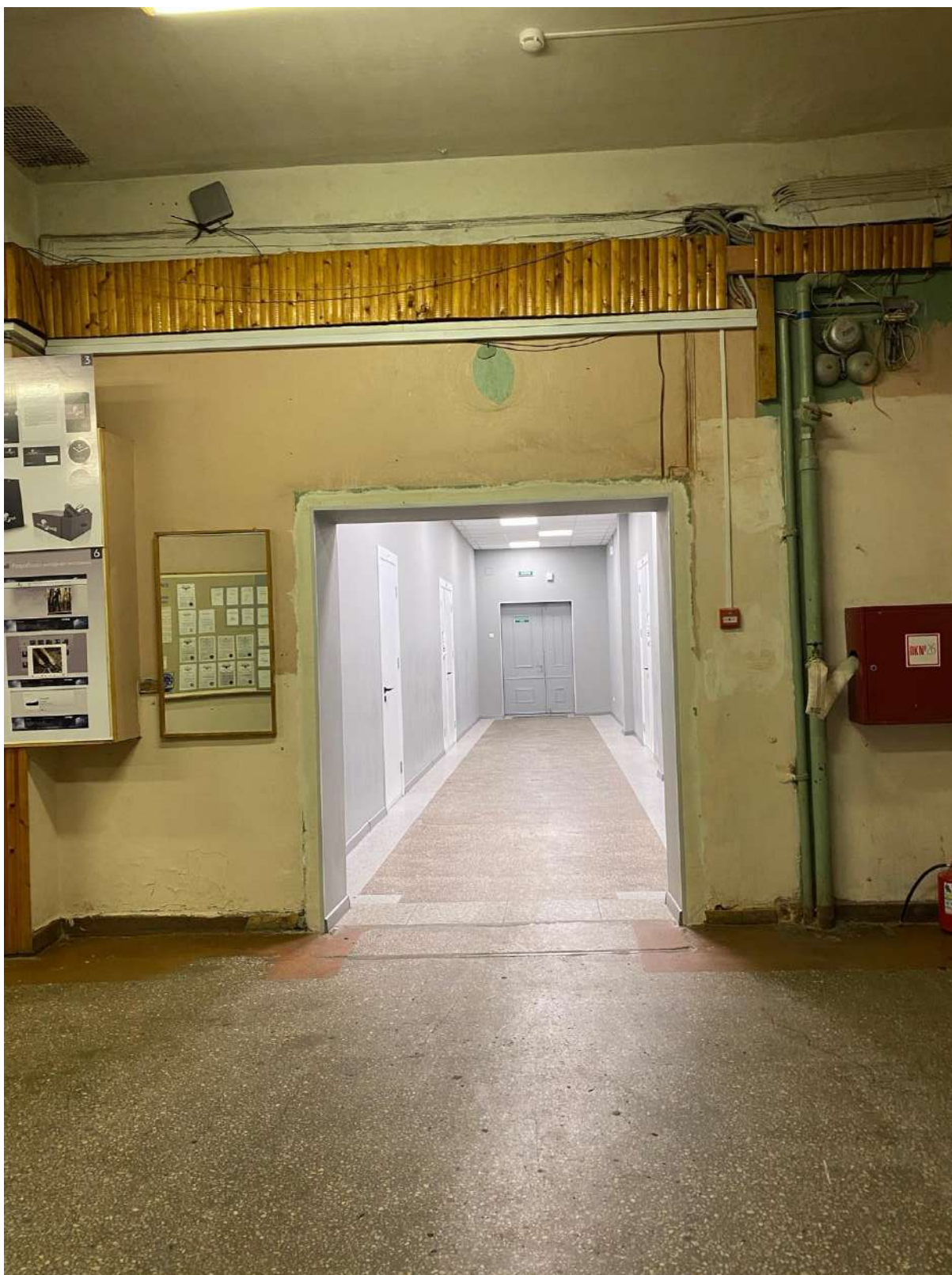
104. Интерьер помещений объекта культурного наследия в уровне 4-го этажа.
