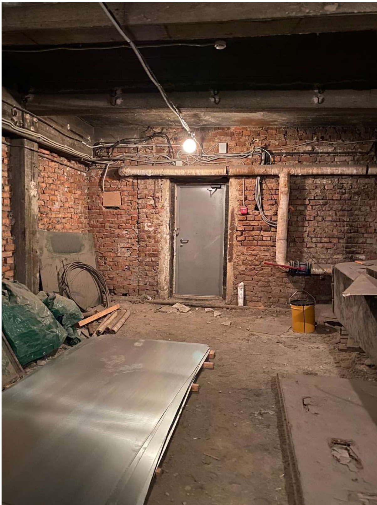
141. Общий вид помещения чердака объекта культурного наследия.
