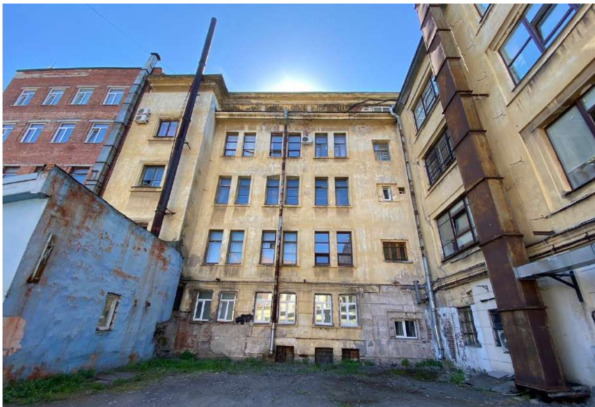
24. Общий вид дворового фасада и южного ризалита объекта культурного наследия.
