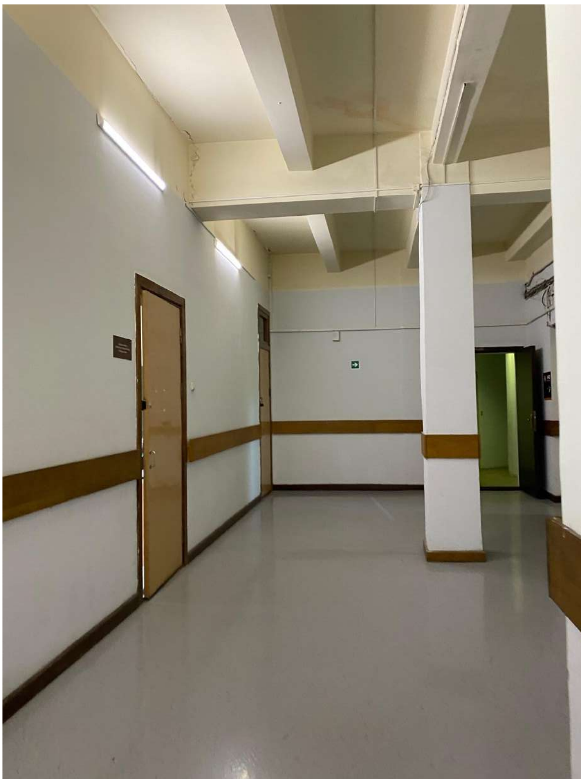
92. Интерьер помещений объекта культурного наследия в уровне 3-го этажа.
