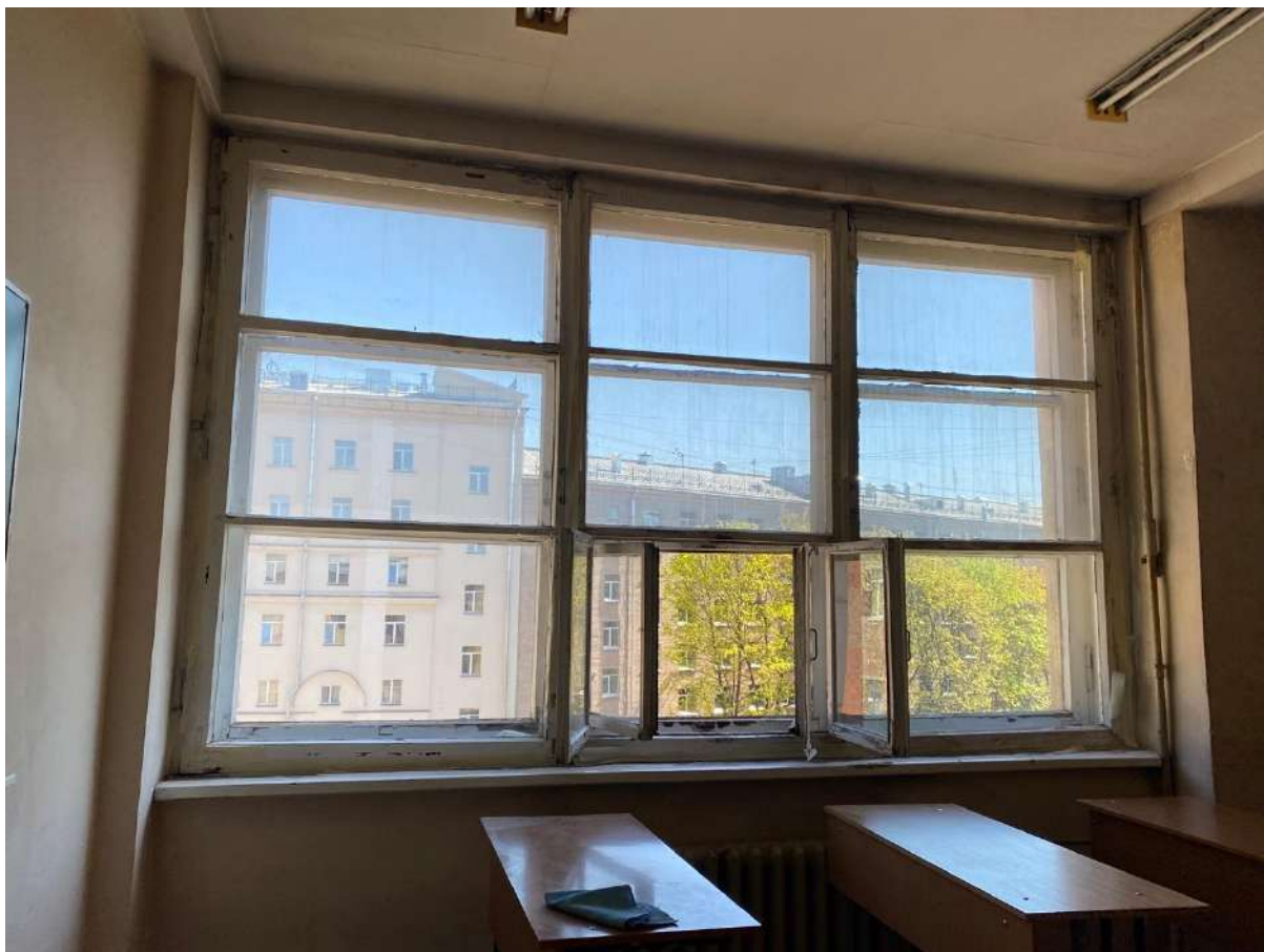
116. Оконное заполнение помещения объекта культурного наследия в уровне 4-го этажа.
