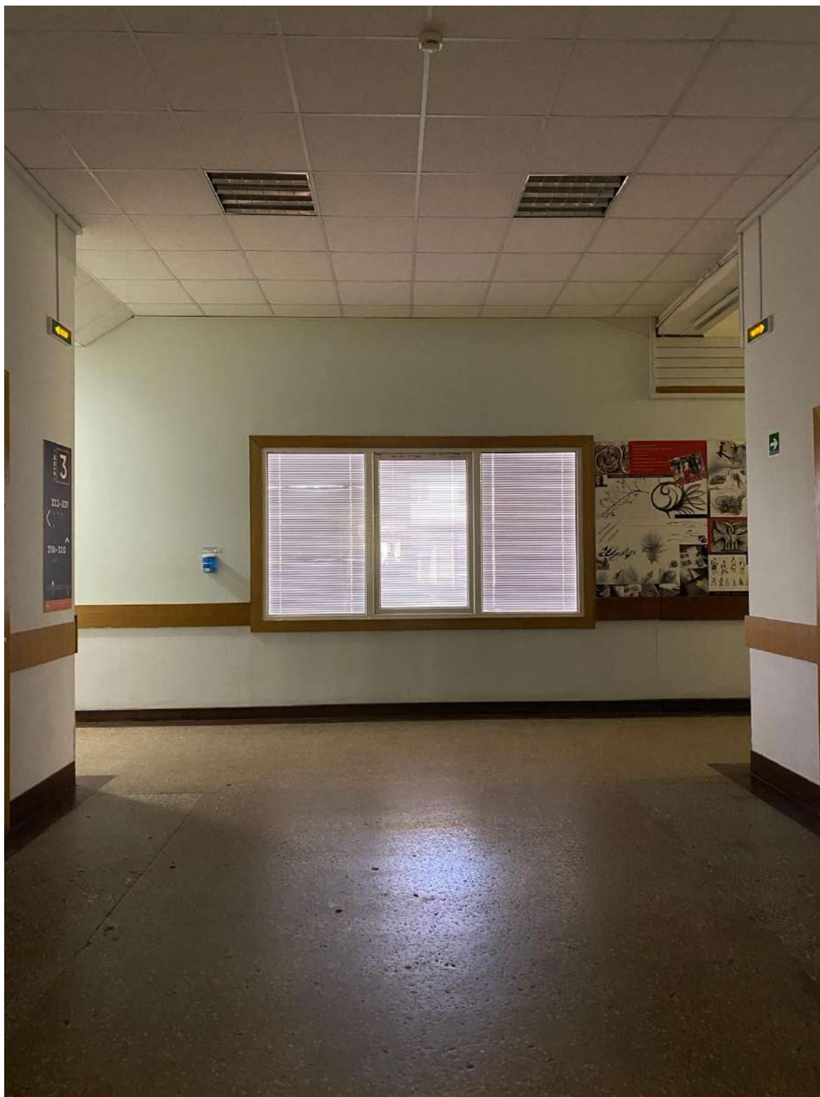
70. Интерьер помещений объекта культурного наследия в уровне 3-го этажа.
