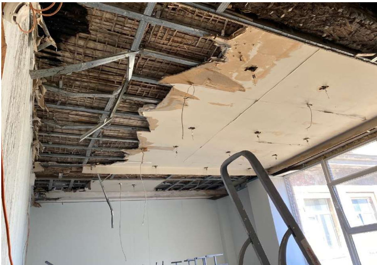
122. Перекрытие помещения объекта культурного наследия в уровне 4-го этажа.
