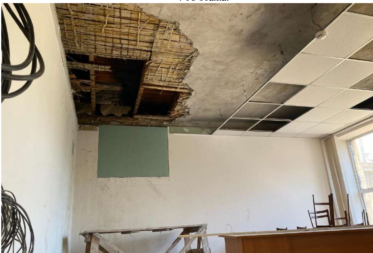
123. Перекрытие помещения объекта культурного наследия в уровне 4-го этажа.
