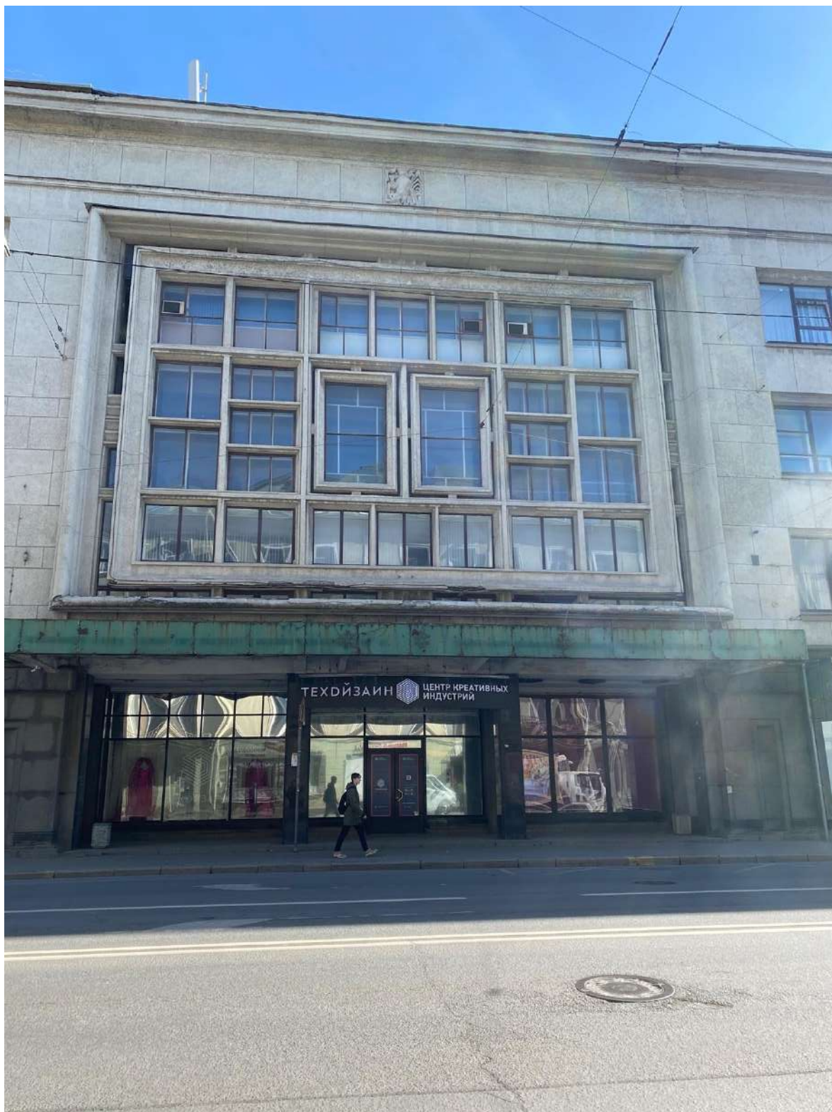
5. Фрагмент лицевого фасада объекта культурного наследия по Вознесенскому проспекту.
