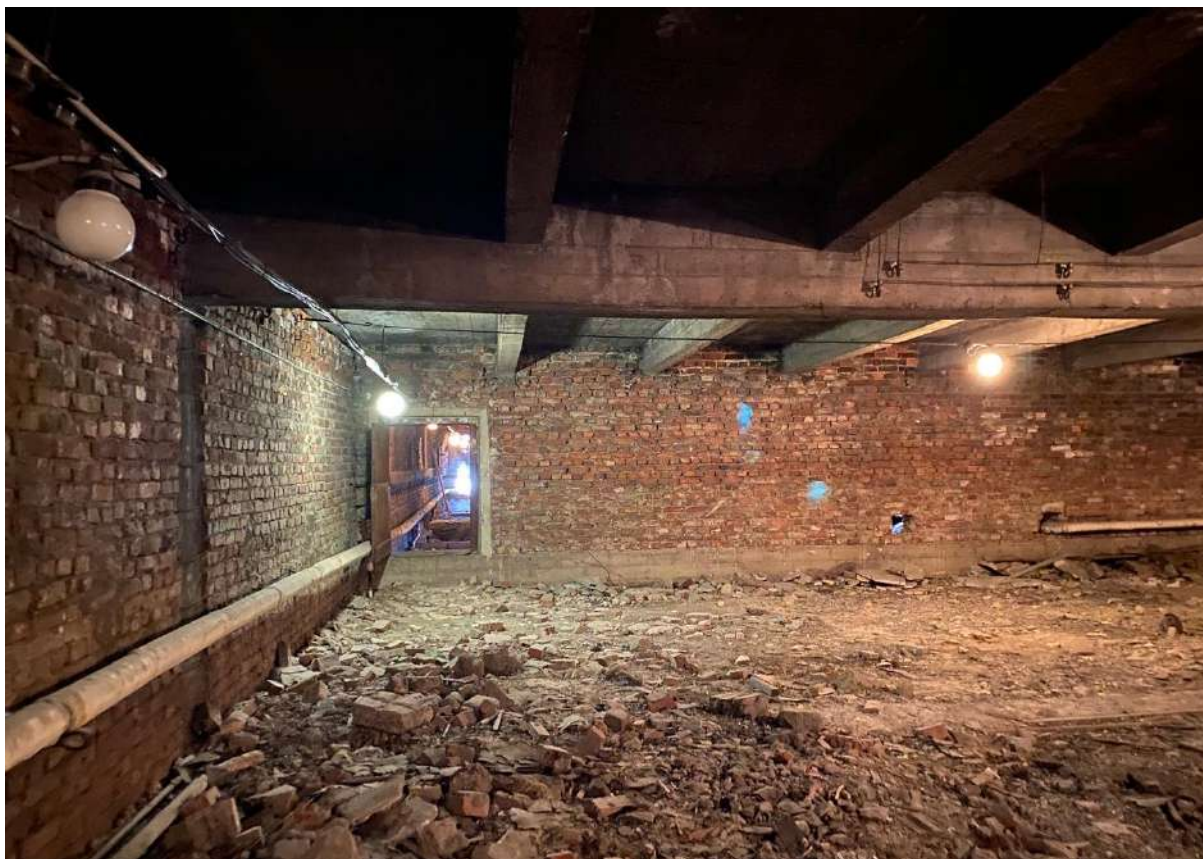
134. Общий вид помещения чердака объекта культурного наследия.
