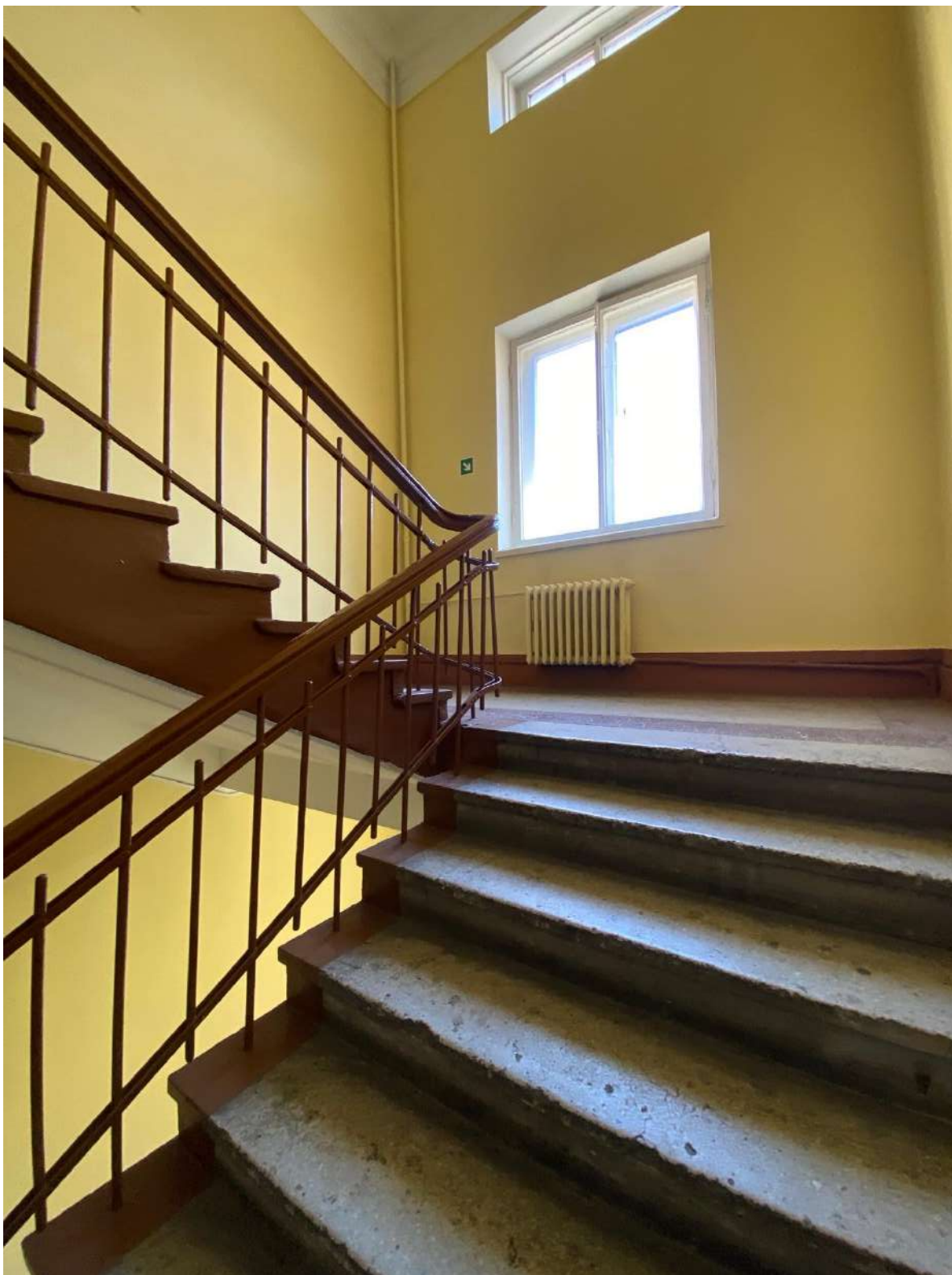
96. Общий вид лестницы объекта культурного наследия в уровне 4-го этажа.
