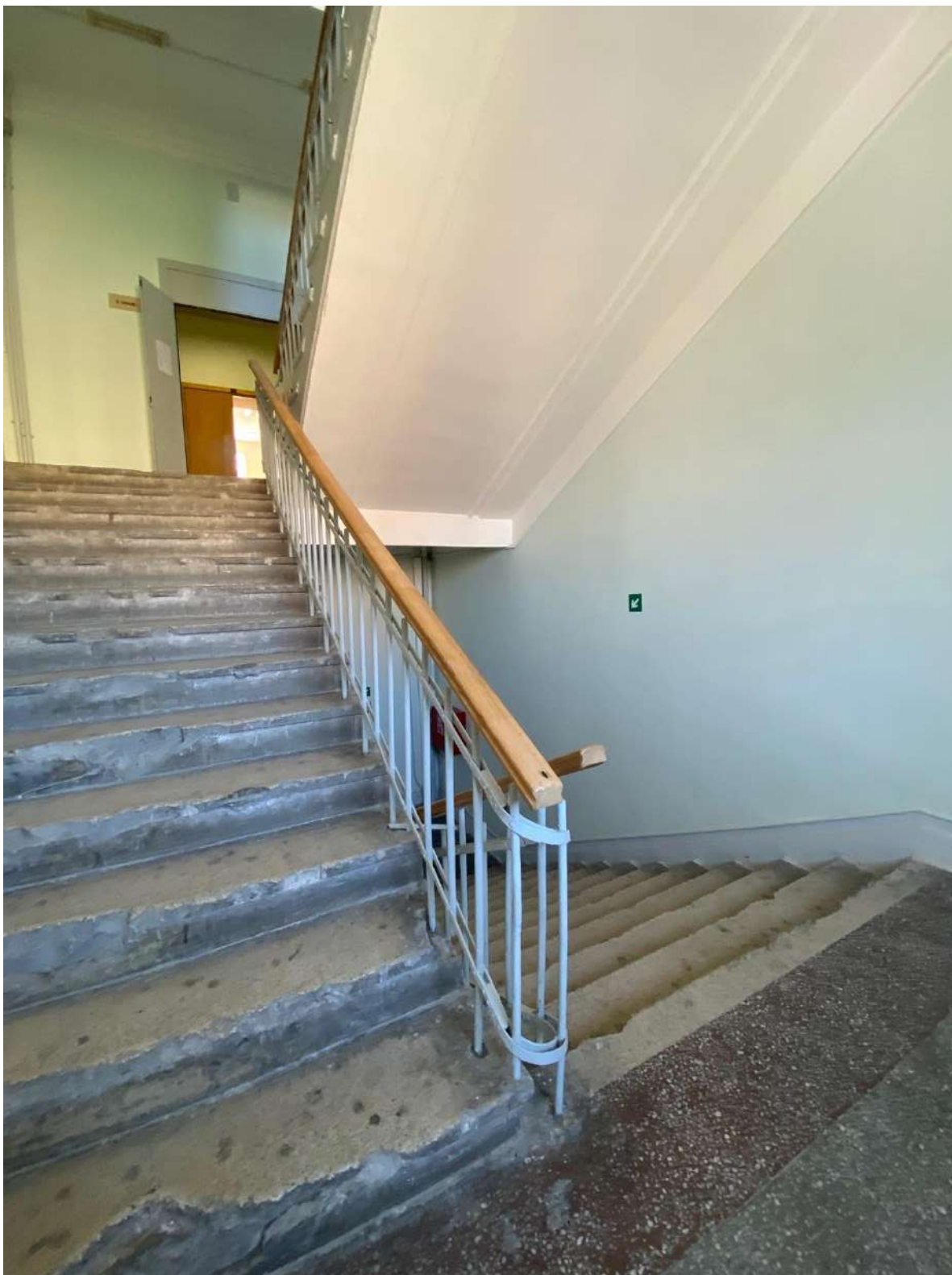
67. Общий вид лестницы объекта культурного наследия в уровне 3-го этажа.
