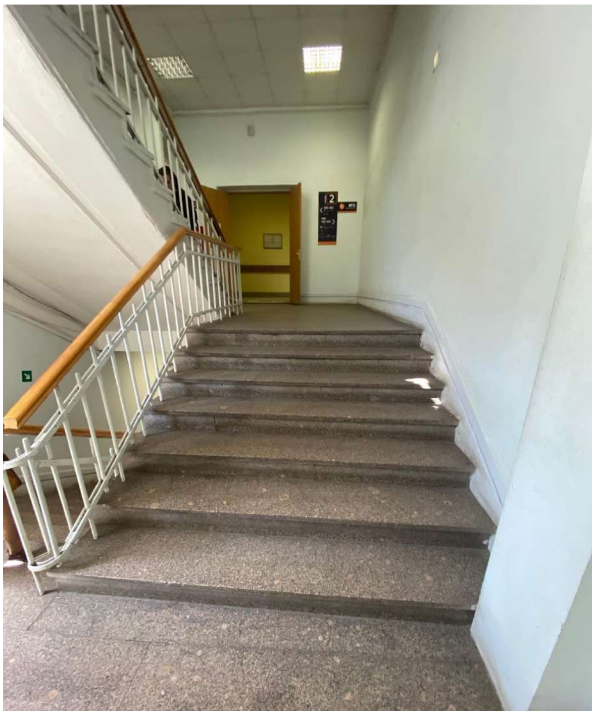
47. Общий вид лестницы объекта культурного наследия в уровне 2-го этажа.
