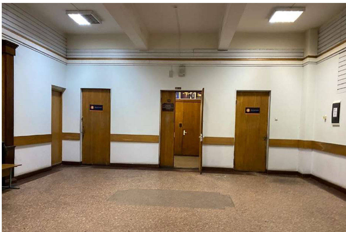
85. Интерьер помещений объекта культурного наследия в уровне 3-го этажа.
