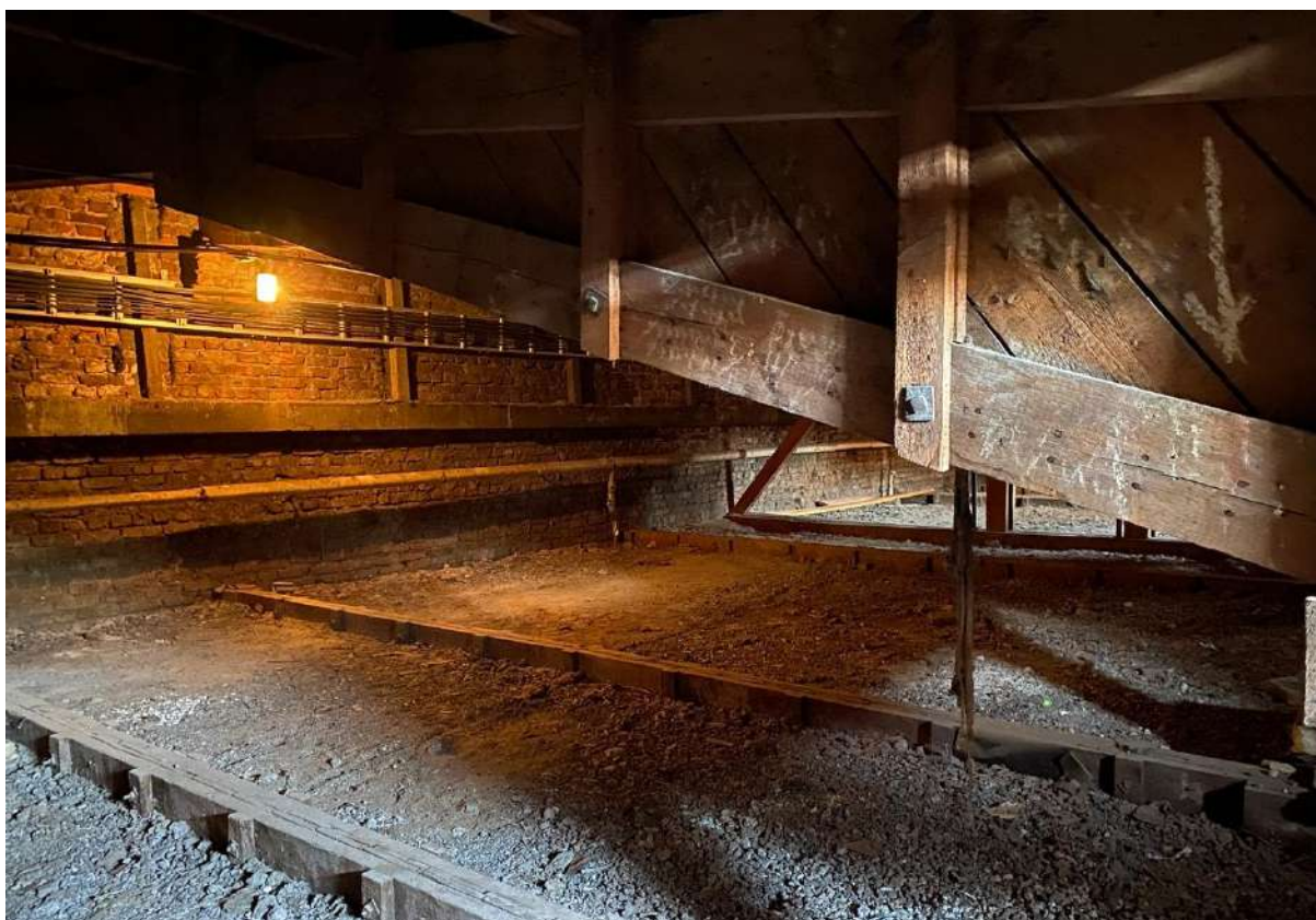
130. Общий вид помещения чердака объекта культурного наследия.
