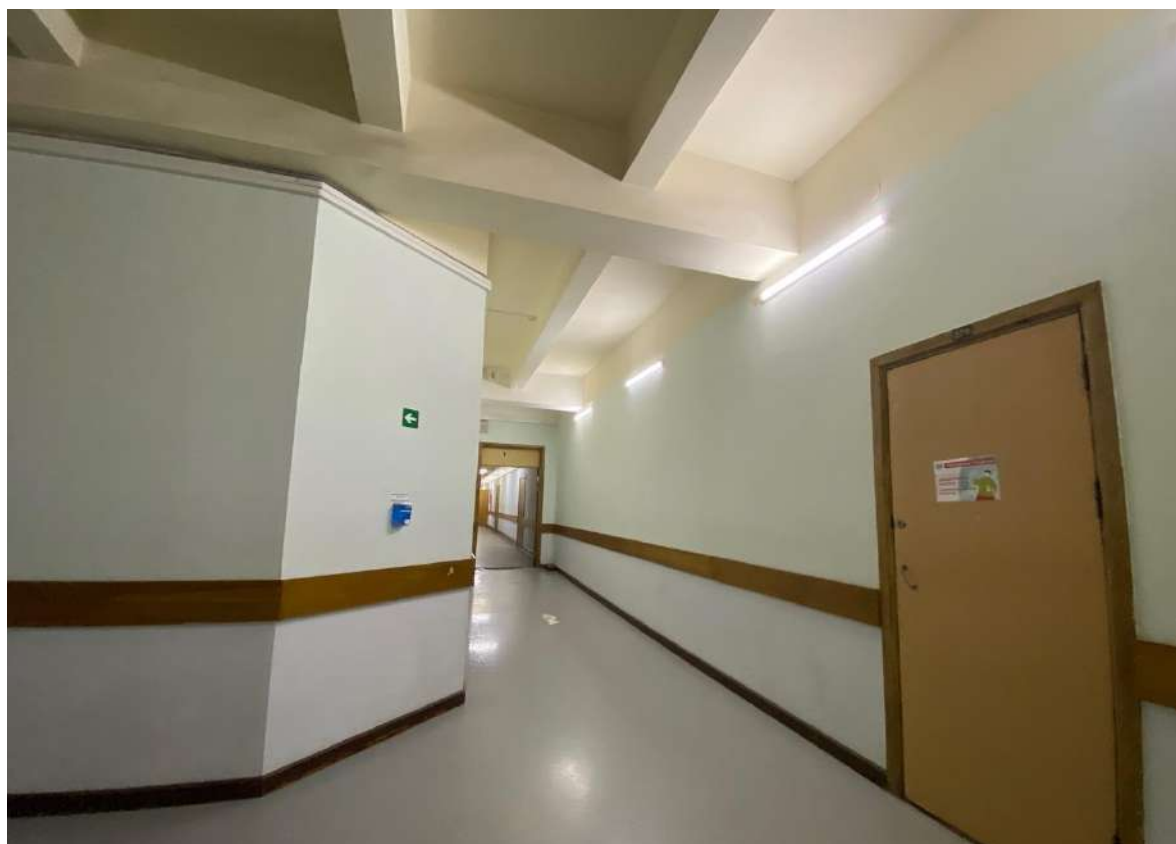
91. Интерьер помещений объекта культурного наследия в уровне 3-го этажа.
