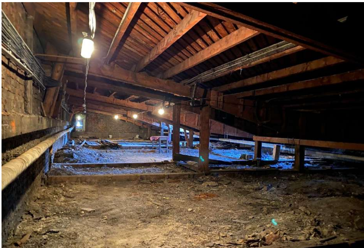
132. Общий вид помещения чердака объекта культурного наследия.
