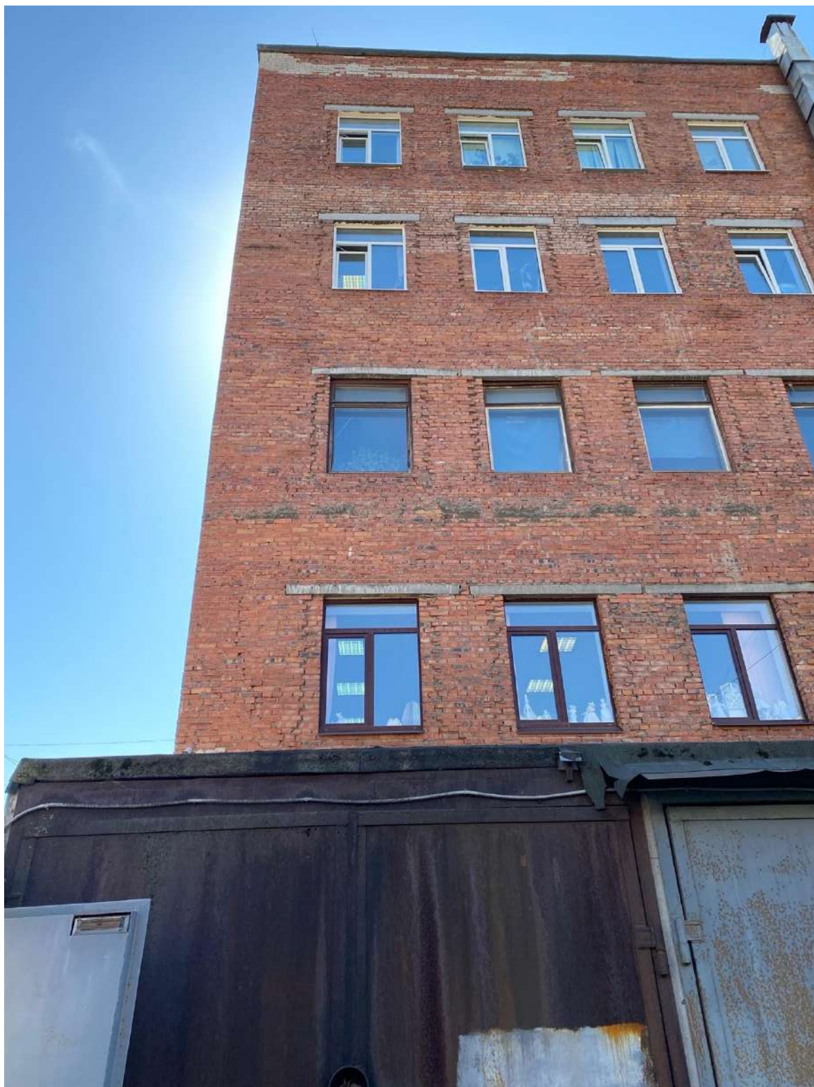
21. Пристройка к южному ризалиту объекта культурного наследия.
