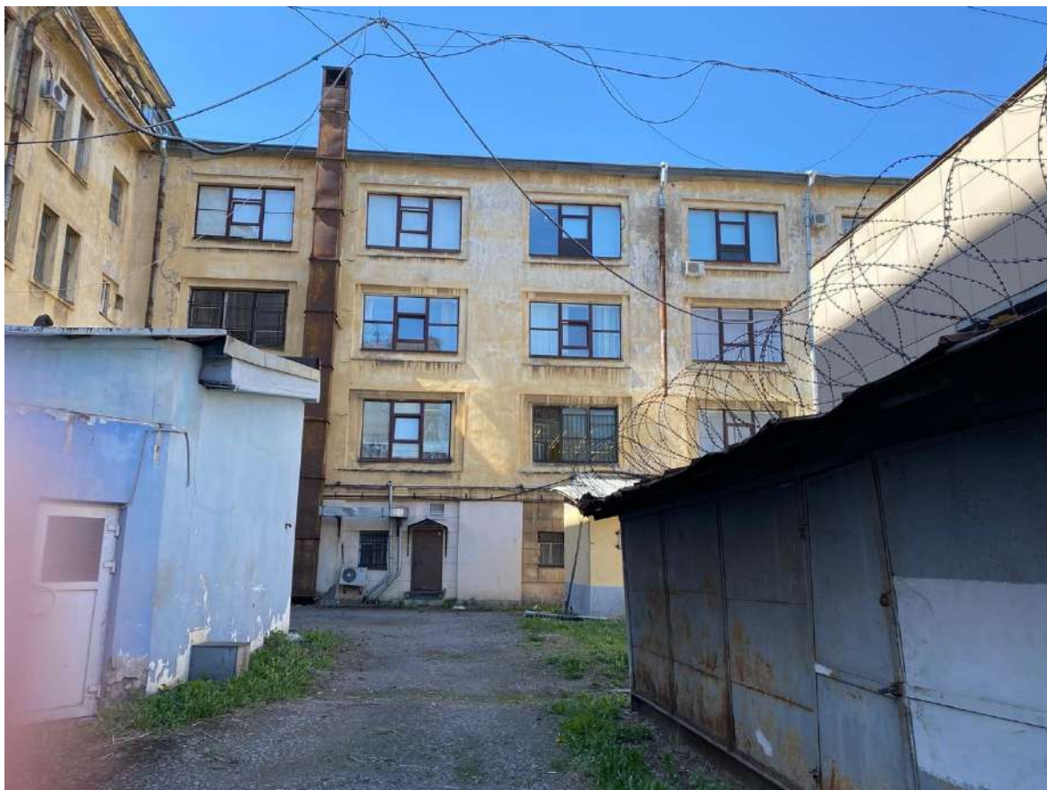
22. Фрагмент центральной части дворового фасада объекта культурного наследия.
