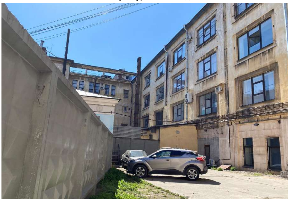
27. Общий вид дворового фасада и центрального ризалита объекта культурного наследия.
