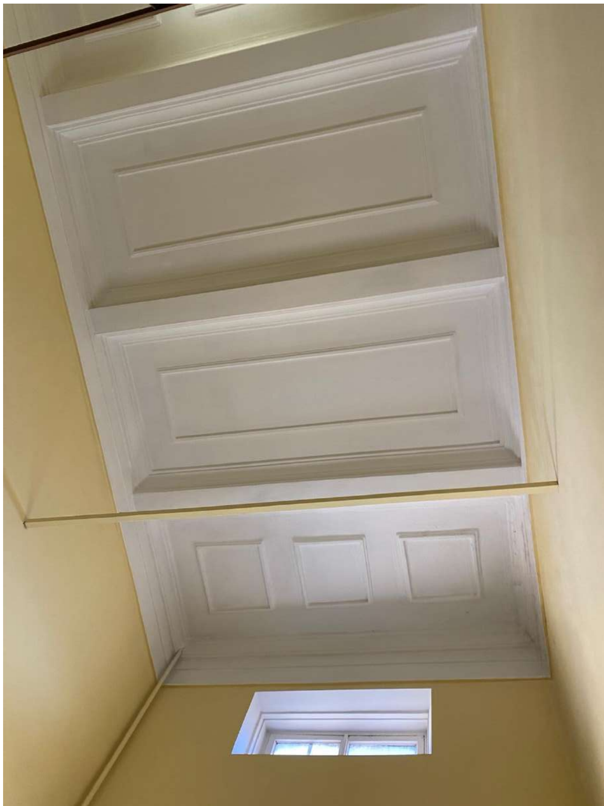
95. Верхнее перекрытие лестницы объекта культурного наследия уровне 4-го этажа.
