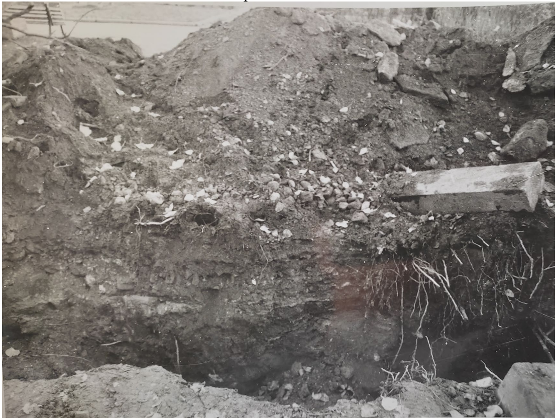
Илл. 98. Археологические работы на площади Тургенева. Известняковые плиты, выброшенные из траншеи на месте разрушенного рабочими при прокладке траншеи фундамента. Фото В. Ф. Егоровский. Октябрь 1996 // Фототека отдела охраны памятников № 941/11-Н
