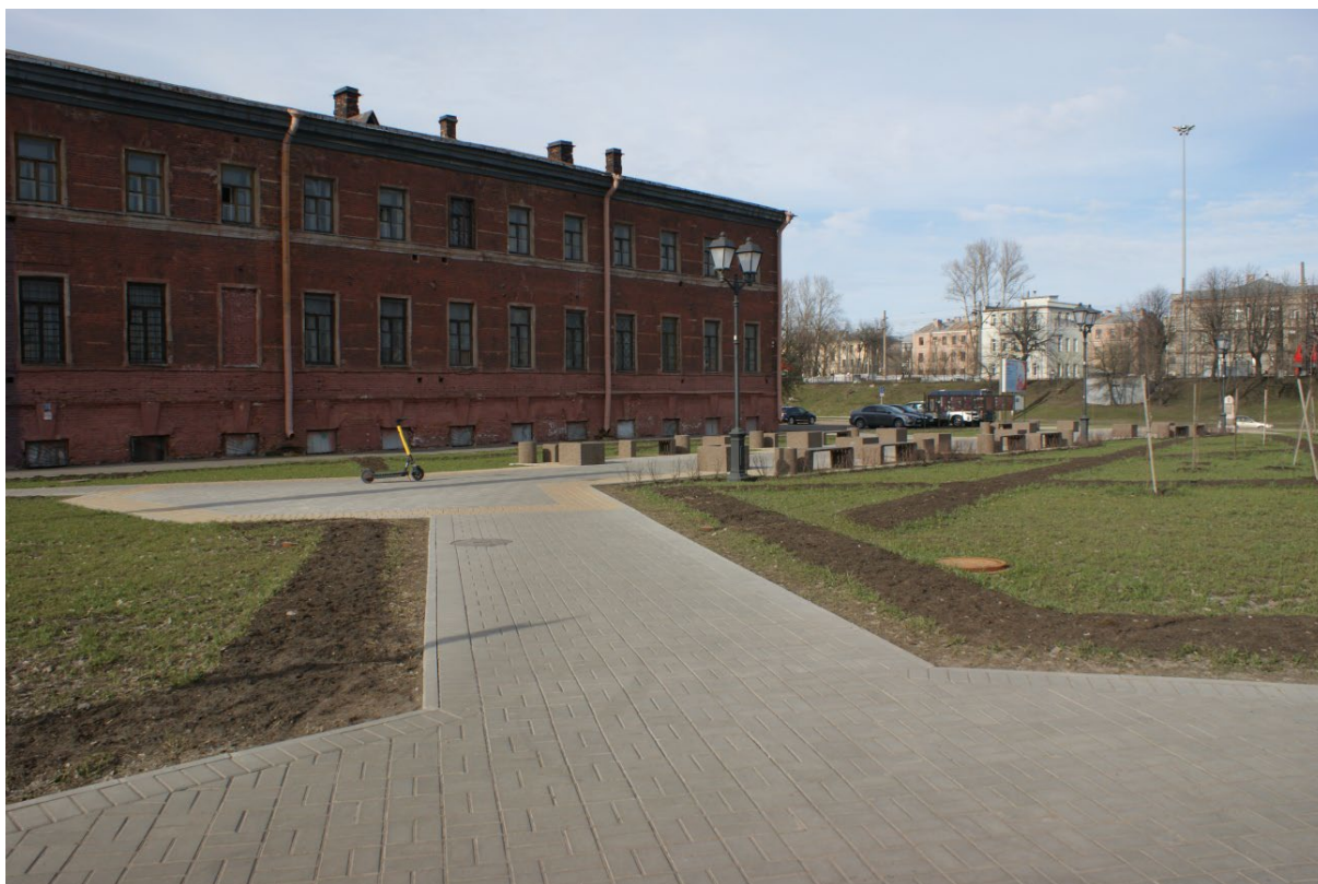
Фото 1. Выявленный объект культурного наследия «Церковь св. мученика Мирония лейб-гвардии Егерского полка (фундамент)». Юго-западная граница объекта. Съемка 17.04.2023 г. Трушковский В.Э.
