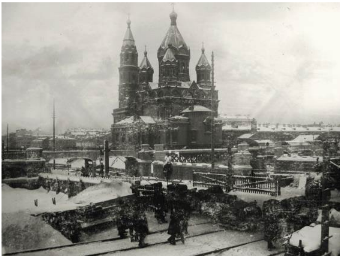
Илл. 50. Новый путепровод над Обводным каналом. Фото зима 1900-1901 г. // Citywalls. Церковь во имя св.мч. Мирония лейб-гвардии Егерского полка.URL: https://p0.citywalls.ru/photo_305-313216.jpg?mt=1512853263
