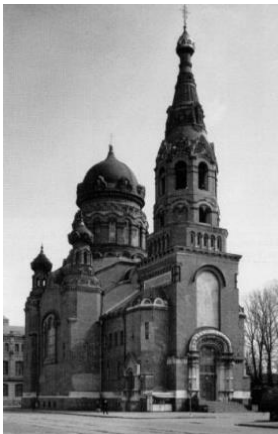
Илл. 62. Церковь Воскресения Господня на Обводном канале у Варшавского вокзала. Архитектор Г. Д. Гримм, при участии архитектора Г.Г. фон Голи // URL: http://www.ensspb.ru/object/2804010006?lc=ru
