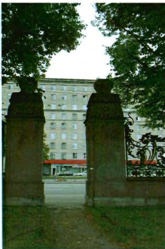
4. Пилоны бокового входа.
