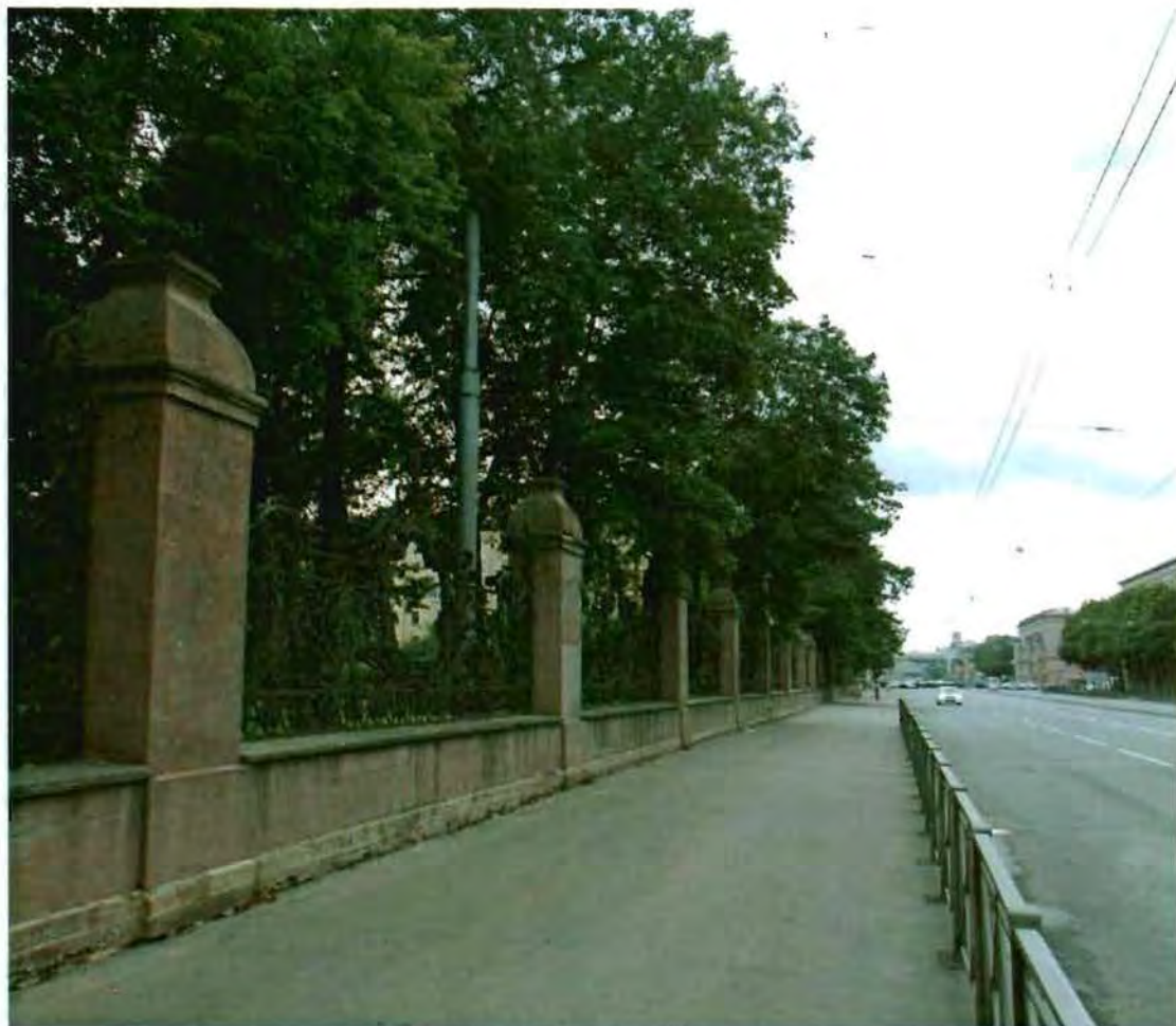
5. Опорные столбы ограды.
