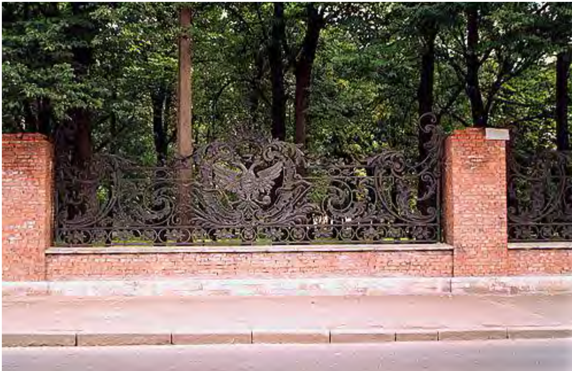
43. Ограда Сада 9 Января. 2004 г. // Источник: Citywalls. URL.: https://www.citywalls.ru/photo366729.html (дата обращения: 14.09.2023).
