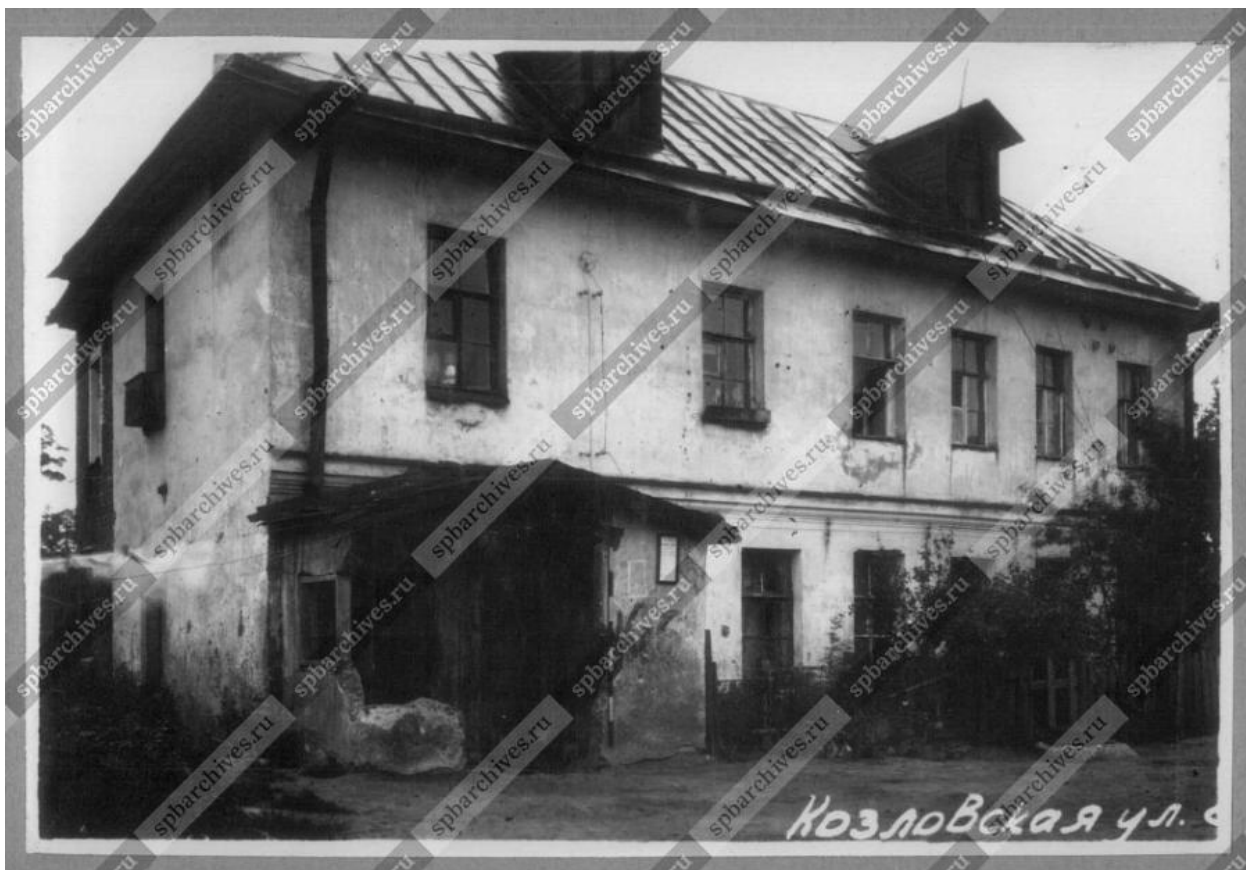
Илл. 7. Общий вид дома № 8 в Козловском переулке (источник: ЦГАКФФД. Фотодокумент Гр 70665).
