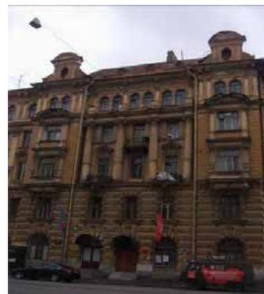
два эркера – местоположение (в уровне 3-4-го этажей), габариты, конфигурация; угловые каннелированные пилястры с лепным декором и капителями композитного ордера; междуэтажные профилированные карнизы – между 2-3-м, 3-4-м этажами; лучковые разорванные фронтоны; штукатурные фигурные кронштейны с гротескными маскаронами;
