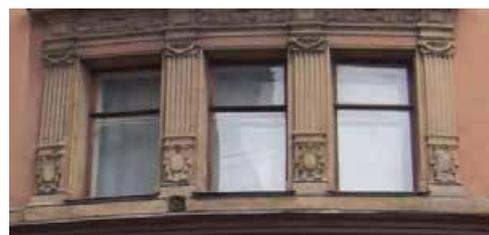
профилированные наличники оконных проемов 4-го этажа; каннелированные пилястры с капителями ионического ордера - в простенках между оконных проемов; подоконный орнаментированный фриз с композициями из львиных маскаронов;
