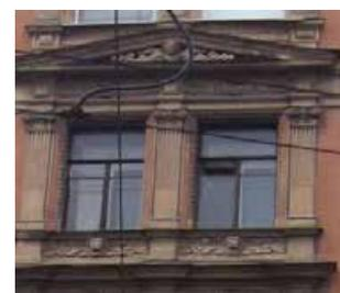
профилированные наличники оконных проемов 5-го этажа; пилястры с капителями ионического ордера, декором из пальметт и лавровых гирлянд - в простенках между оконных проемов; подоконный орнаментированный фриз;
