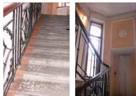
парадная лестница (по 7-й оси восточного лицевого фасада по просп. Бакунина) - местоположение, габариты, конфигурация (маршевая с поворотом), материал (каменная), ступени из лещадной плиты;
