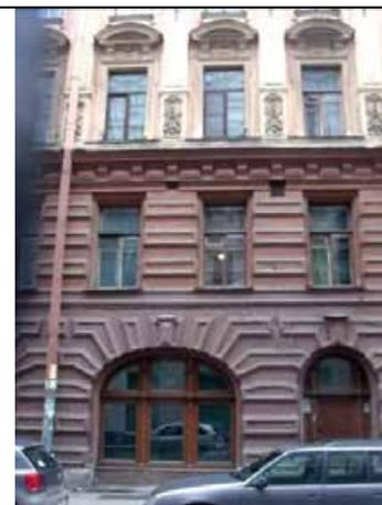
профилированные наличники, рустованное обрамление, замковые камни дверных и оконных проемов 1-го этажа;
