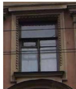
профилированные наличники оконных проемов 5-го этажа; пилястры с капителями ионического ордера, с декором из брильянтового руста, пальметт и растительных гирлянд; профилированные филенки в подоконном пространстве с орнаментом из розеток и брильянтового руста;
