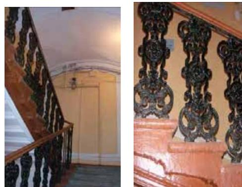
парадная лестница (по 6-й оси восточного лицевого фасада по просп. Бакунина) - местоположение, габариты, конфигурация (маршевая с поворотом), материал (каменная), ступени из лещадной плиты;
