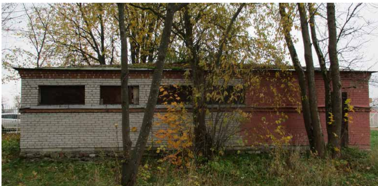
3. Юго-западный фасад здания туалета, расположенного на территории объекта культурного наследия федерального значения «Александровский парк», расположенного по адресу: Санкт-Петербург г. Пушкин, Дворцовая ул., 2. 10.10.2022
