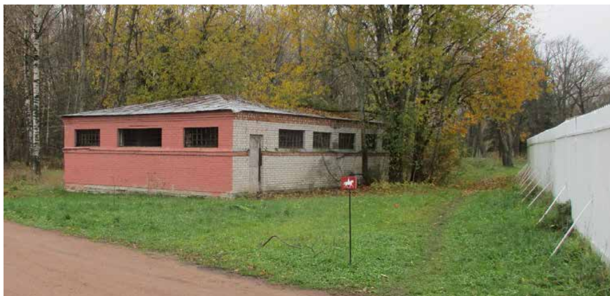
1. Северо-восточный и юго-восточный фасады здания туалета, расположенного на территории, расположенного на территории объекта культурного наследия федерального значения «Александровский парк», расположенного по адресу: Санкт-Петербург г. Пушкин, Дворцовая ул., 2. 10.10.2022
