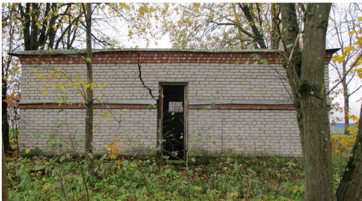
4. Северо-западный фасад здания туалета, расположенного на территории объекта культурного наследия федерального значения «Александровский парк», расположенного по адресу: Санкт-Петербург г. Пушкин, Дворцовая ул., 2. 10.10.2022
