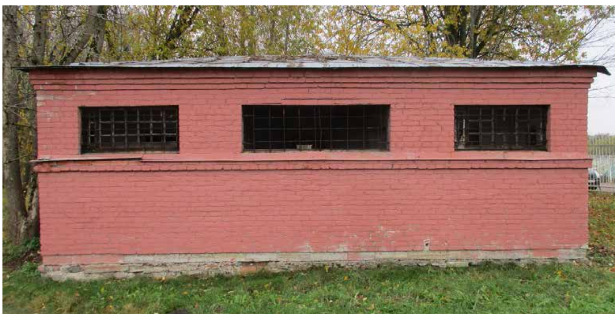
2. Юго-восточный фасад здания туалета, расположенного на территории объекта культурного наследия федерального значения «Александровский парк», расположенного по адресу: Санкт-Петербург г. Пушкин, Дворцовая ул., 2. 10.10.2022
