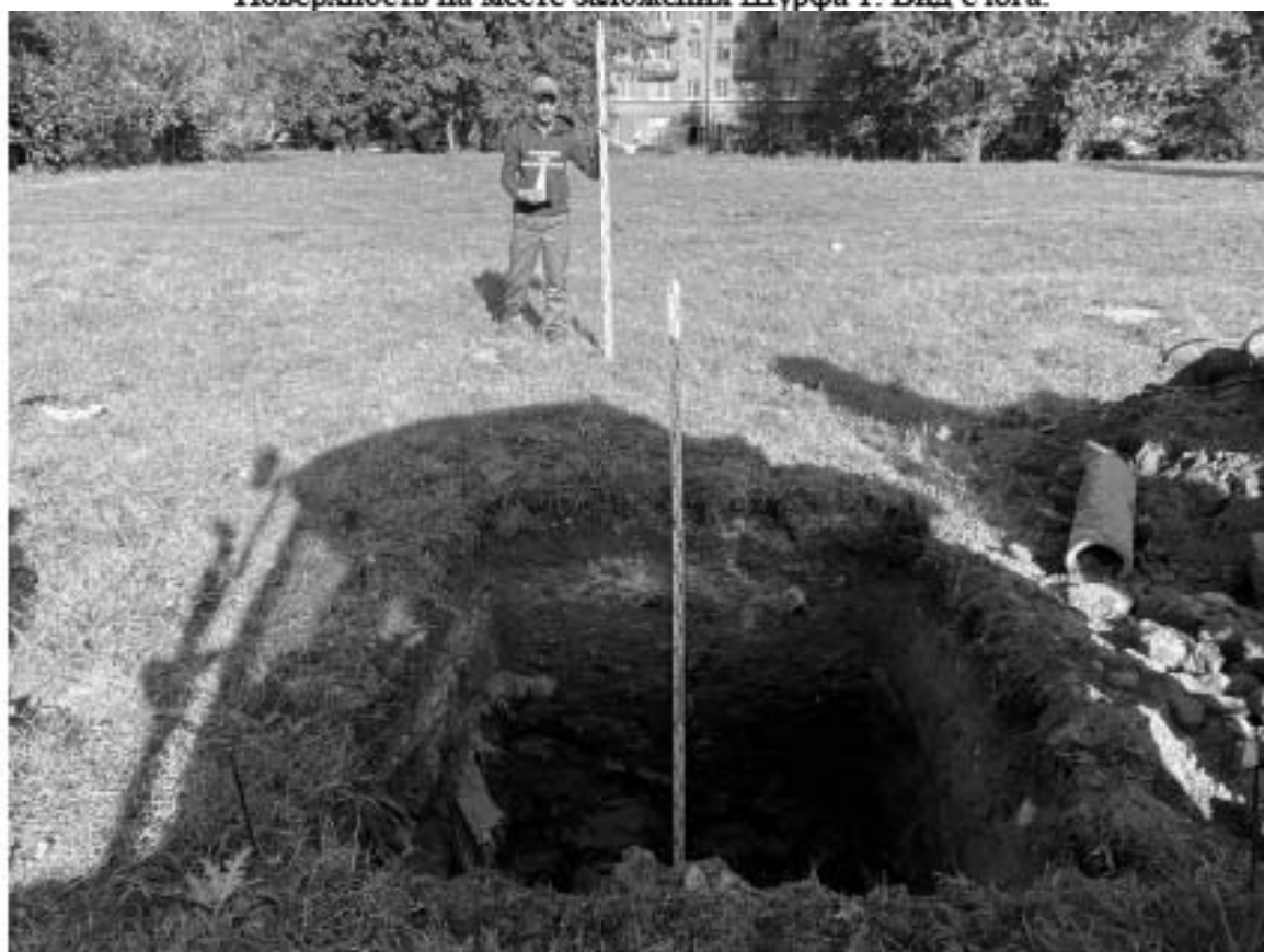
Рис. 43. СПб, внутригородское муниципальное образование Санкт-Петербурга муниципальный округ Морские ворота, Двинская улица, участок 140 (кадастровый номер: 78:15:0008103:3652). Шурф 1. Фиксация дна шурфа на уровне зачистки слоя песка. Вид с юга.
