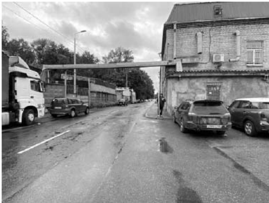
Рис. 7. СПб-2023. Красногвардейский район. «Выполнение проектно-изыскательских работ по реконструкции водопроводных магистралей и водопроводных домовых вводов по адресу: Санкт-Петербург, по ул. Дегтярева от пр. Энергетиков до пр. Металлистов». Photo 3. Общий вид трассы обследования. Вид с востока
