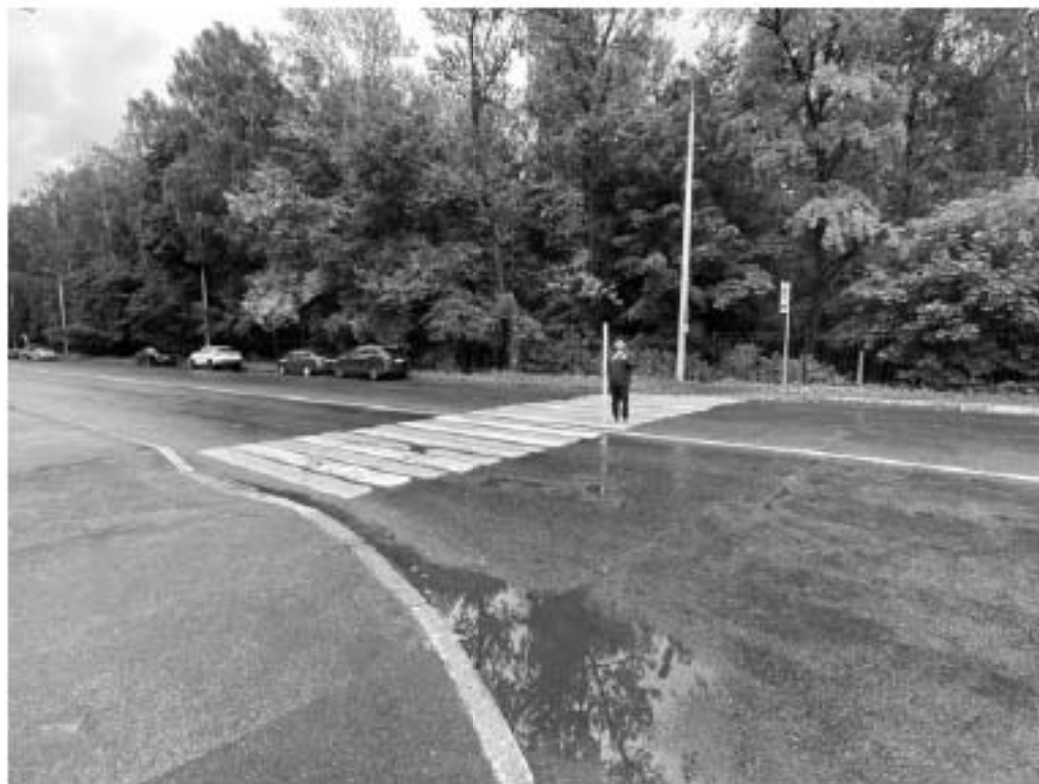
Рис. 26. СПб-2023. Красногвардейский район. «Выполнение проектно-изыскательских работ по реконструкции водопроводных магистралей и водопроводных домовых вводов по адресу: Санкт-Петербург, по ул. Дегтярева от пр. Энергетиков до пр. Metallистов». Photo 6. Общий вид трассы обследования. Вид с северо-запада
