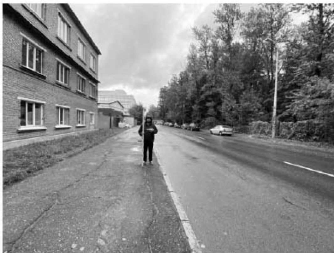
Рис. 10. СПб-2023. Красногвардейский район. «Выполнение проектно-изыскательских работ по реконструкции водопроводных магистралей и водопроводных домовых вводов по адресу: Санкт-Петербург, по ул. Дегтярева от пр. Энергетиков до пр. Металлистов». Photo 5. Общий вид трассы обследования. Вид с юго-запада
