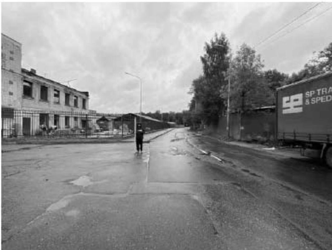
Рис. 6. СПб-2023. Красногвардейский район. «Выполнение проектно-изыскательских работ по реконструкции водопроводных магистралей и водопроводных домовых вводов по адресу: Санкт-Петербург, по ул. Дегтярева от пр. Энергетиков до пр. Металлистов». Photo 3. Общий вид трассы обследования. Вид с запада
