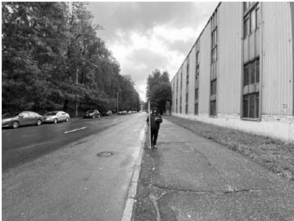
Рис. 11. СПб-2023. Красногвардейский район. «Выполнение проектно-изыскательских работ по реконструкции водопроводных магистралей и водопроводных домовых вводов по адресу: Санкт-Петербург, по ул. Дегтярева от пр. Энергетиков до пр. Металлистов». Photo 5. Общий вид трассы обследования. Вид с северо-востока
