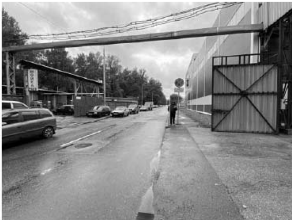
Рис. 9. СПб-2023. Красногвардейский район. «Выполнение проектно-изыскательских работ по реконструкции водопроводных магистралей и водопроводных домовых вводов по адресу: Санкт-Петербург, по ул. Дегтярева от пр. Энергетиков до пр. Металлистов». Photo 4. Общий вид трассы обследования. Вид с востока
