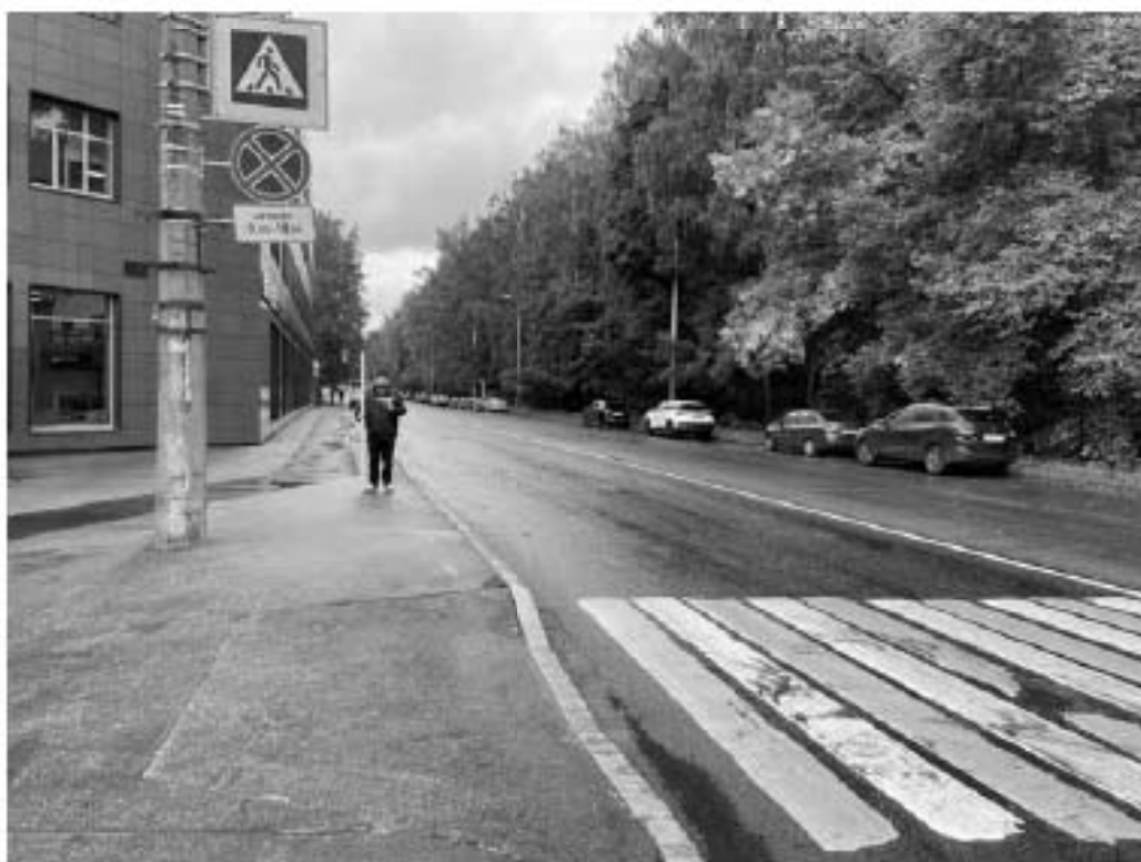
Рис. 12. СПб-2023. Красногвардейский район. «Выполнение проектно-изыскательских работ по реконструкции водопроводных магистралей и водопроводных домовых вводов по адресу: Санкт-Петербург, по ул. Дегтярева от пр. Энергетиков до пр. Металлистов». Photo 6. Общий вид трассы обследования. Вид с юго-запада
