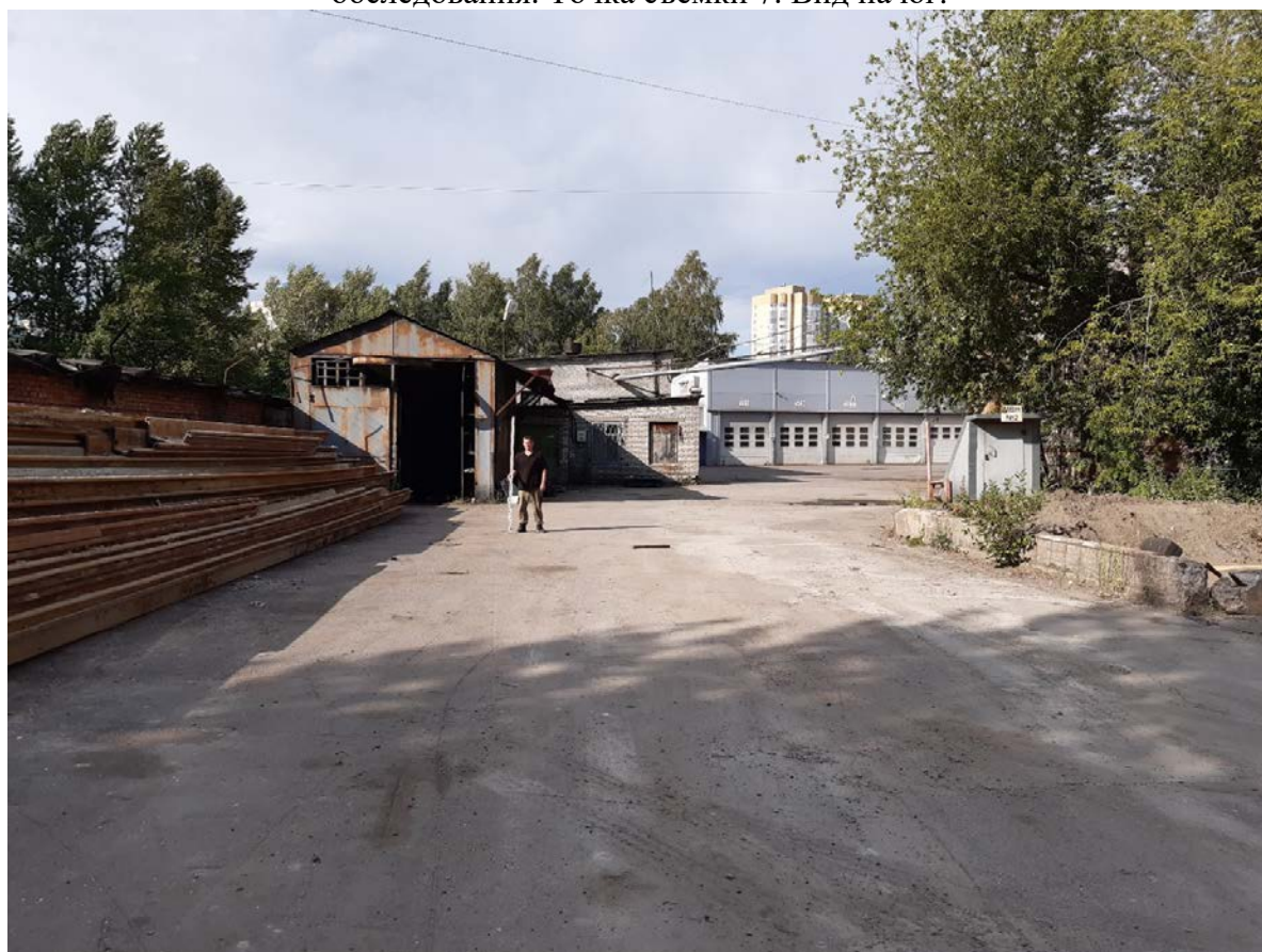
Рис. 18. Санкт-Петербург, Белоостровская улица, дом 19, литера А. Общий вид участка обследования. Точка съемки 8 Вид на север.
