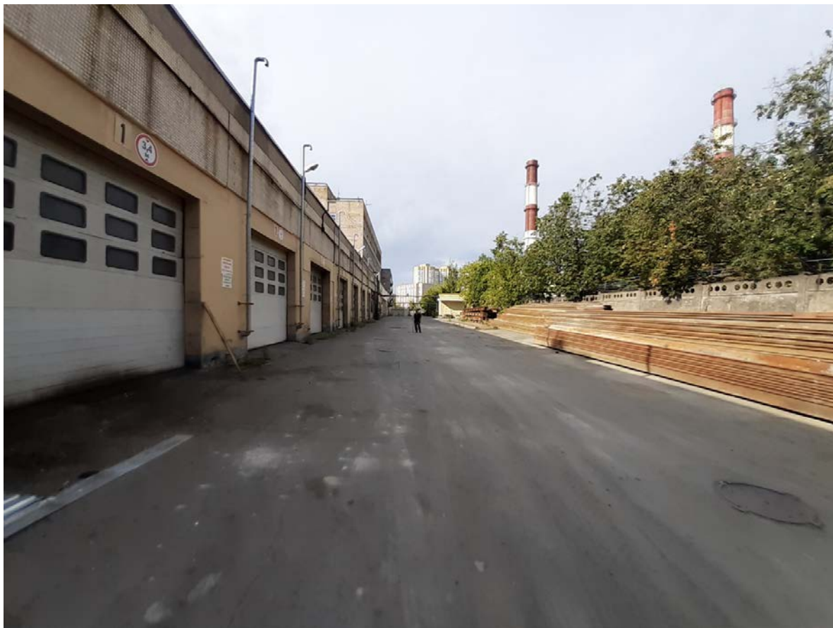
Рис.13. Санкт-Петербург, Белоостровская улица, дом 19, литера А. Общий вид участка обследования. Точка съемки 4. Вид на север.
