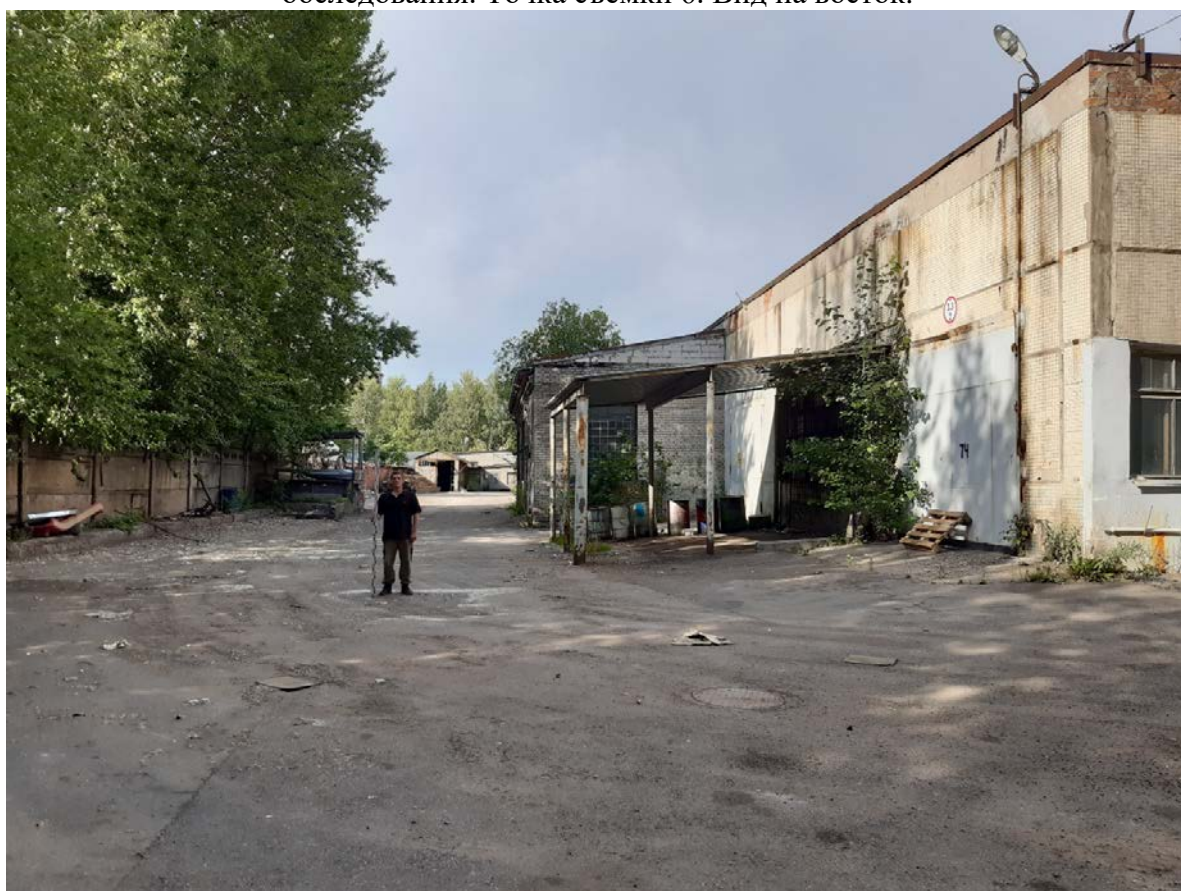
Рис. 16. Санкт-Петербург, Белоостровская улица, дом 19, литера А. Общий вид участка обследования. Точка съемки 6. Вид на север.
