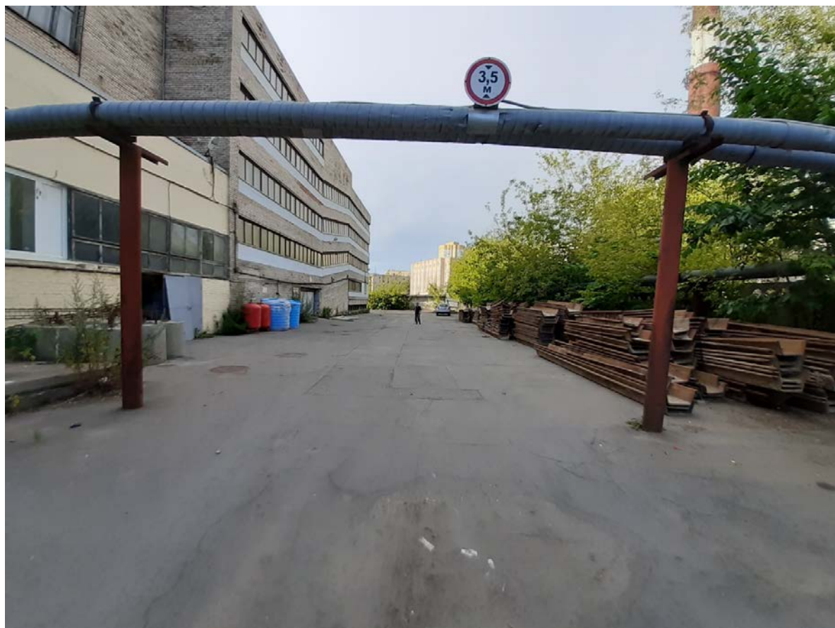
Рис.11. Санкт-Петербург, Белоостровская улица, дом 19, литера А. Общий вид участка обследования. Точка съемки 2. Вид на север.
