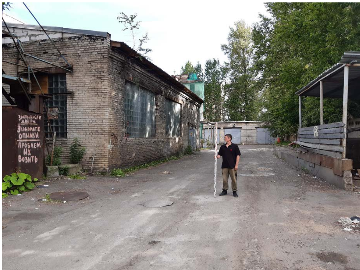
Рис. 17. Санкт-Петербург, Белоостровская улица, дом 19, литера А. Общий вид участка обследования. Точка съемки 7. Вид на юг.
