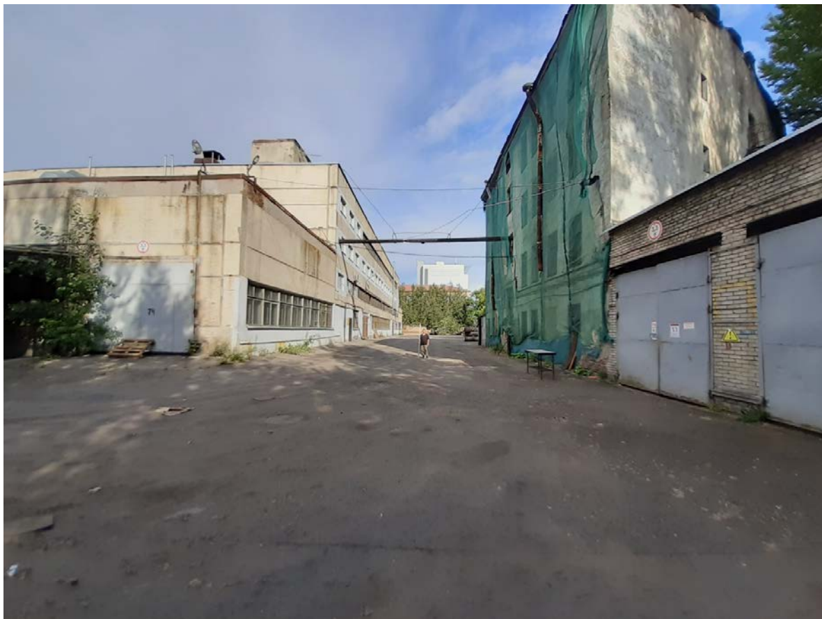
Рис. 15. Санкт-Петербург, Белоостровская улица, дом 19, литера А. Общий вид участка обследования. Точка съемки 6. Вид на восток.
