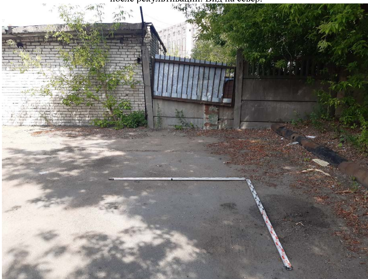
Рис. 36. Санкт-Петербург, Белоостровская улица, дом 19, литера А. Шурф 2. Фотофиксация до начала работ. Вид на север.
