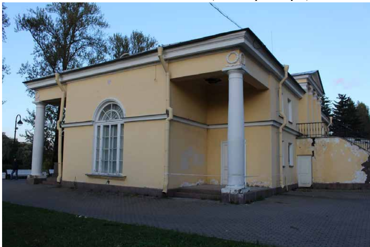
Фото 80. Юго-западная часть объекта культурного наследия федерального значения «Парк», вид на объект культурного наследия федерального значения «Павильон шахматно-шашечный (кинотеатр «Глобус»)».
