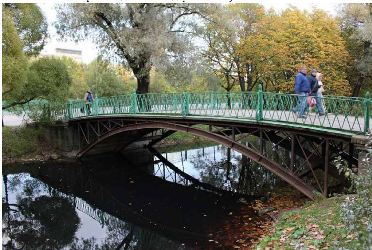
Фото 28. Северная часть объекта культурного наследия федерального значения «Парк». Вид на мост через южный канал.
