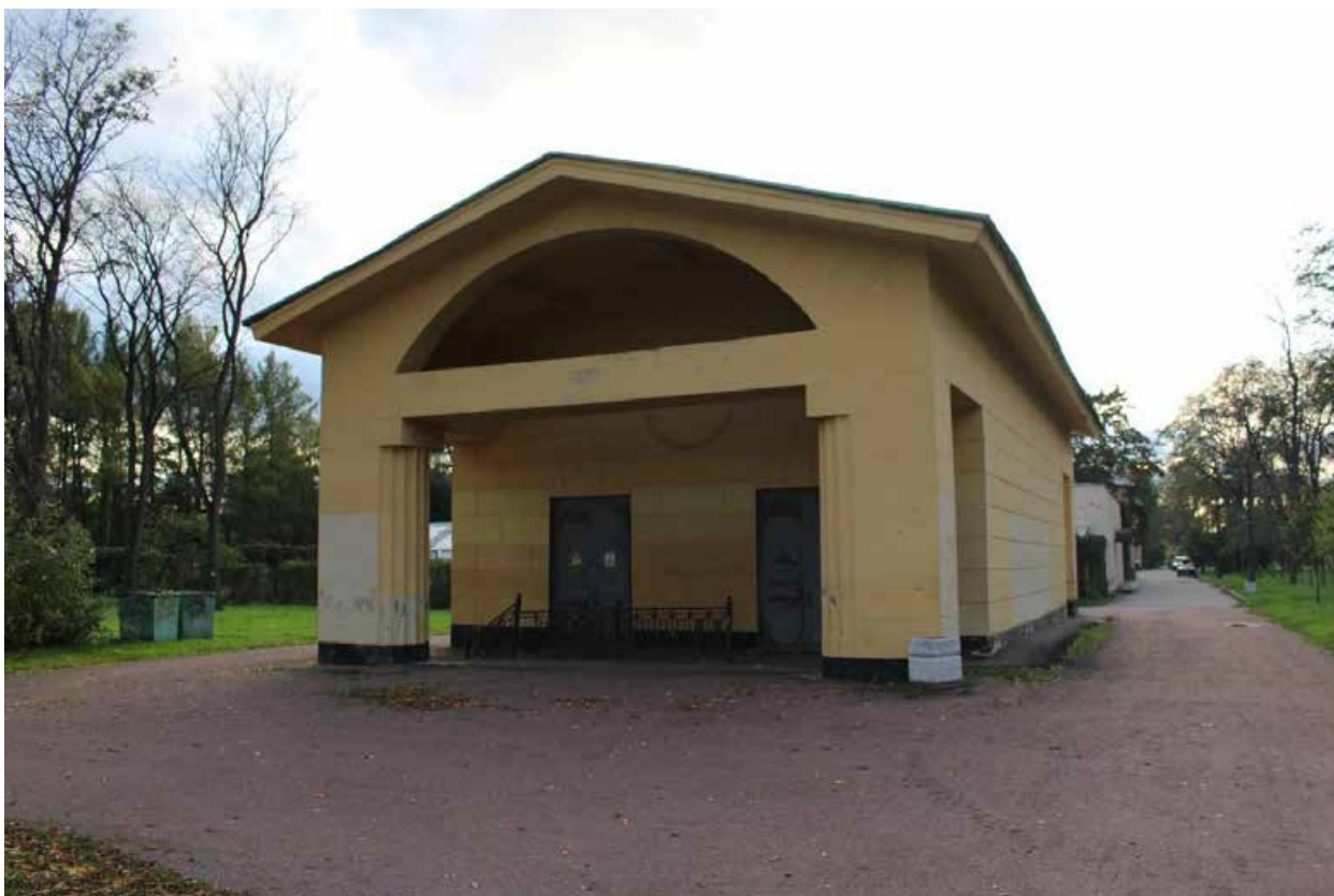
Фото 53. Северо-восточная часть объекта культурного наследия федерального значения «Парк». Вид на объект культурного наследия федерального значения «Подстанция трансформаторная».
