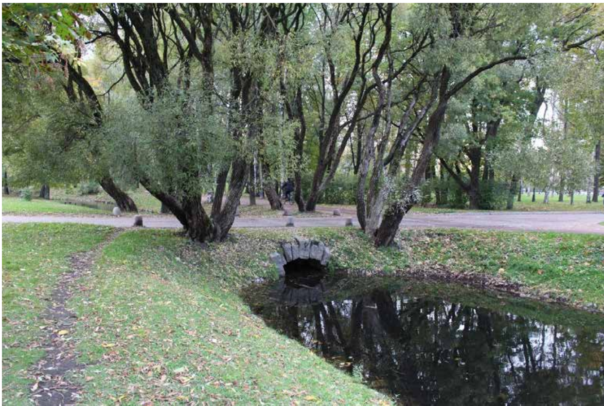
Фото 35. Северная часть объекта культурного наследия федерального значения «Парк». Вид на западный мост через северный канал.
