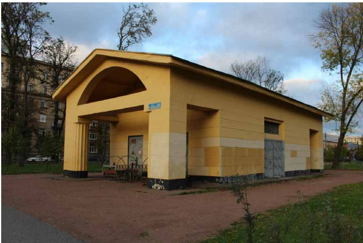
Фото 51. Северо-восточная часть объекта культурного наследия федерального значения «Парк». Вид на объект культурного наследия федерального значения «Подстанция трансформаторная».
