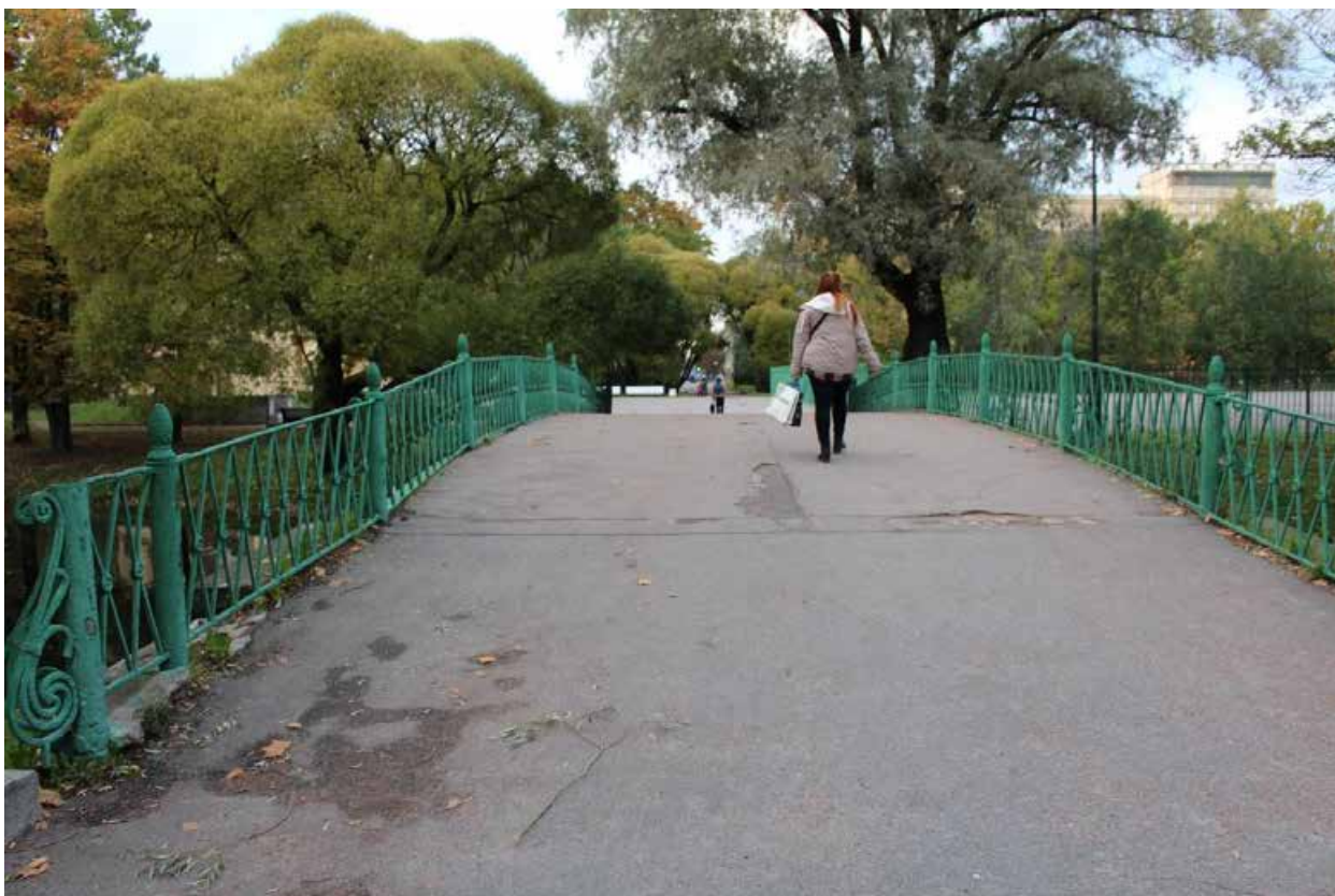
Фото 29. Северная часть объекта культурного наследия федерального значения «Парк». Вид на мост через южный канал.
