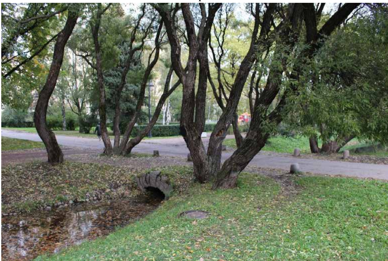
Фото 34. Северная часть объекта культурного наследия федерального значения «Парк». Вид на западный мост через северный канал.
